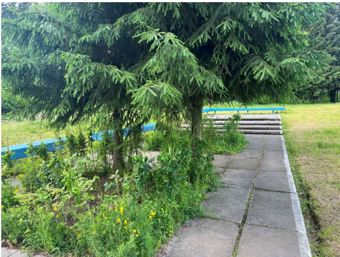
Фото 14. Территория объекта. Цветник – зарастание самосевными растениями. самосевными растениями. Пешеходная дорожка – биопоражения, просадки, трещины, деструкция наружного слоя бетона, сколы, множественные окрасы, шелушение красочного слоя. Дата съемки: июнь 2025. Автор: Козлова Е.М.
