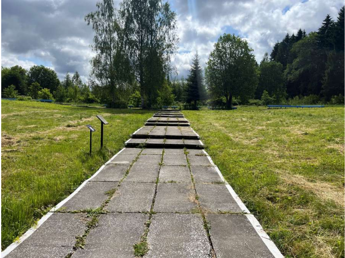
Фото 10. Пешеходная дорожка из бетонных плит. Биопоражения, просадки, трещины, разрушение наружного слоя бетона, сколы, множественные окрасы. Дата съемки: июнь 2025. Автор: Козлова Е.М.
