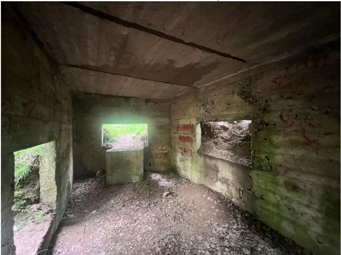
Фото 87. Пулеметный ДОТ. Внутренняя часть. Биопоражения, следы систематического намокания, антропогенные загрязнения, следы коррозии металлических балок, деструкция внешнего слоя бетона. Дата съемки: июнь 2025. Автор: Козлова Е.М.
