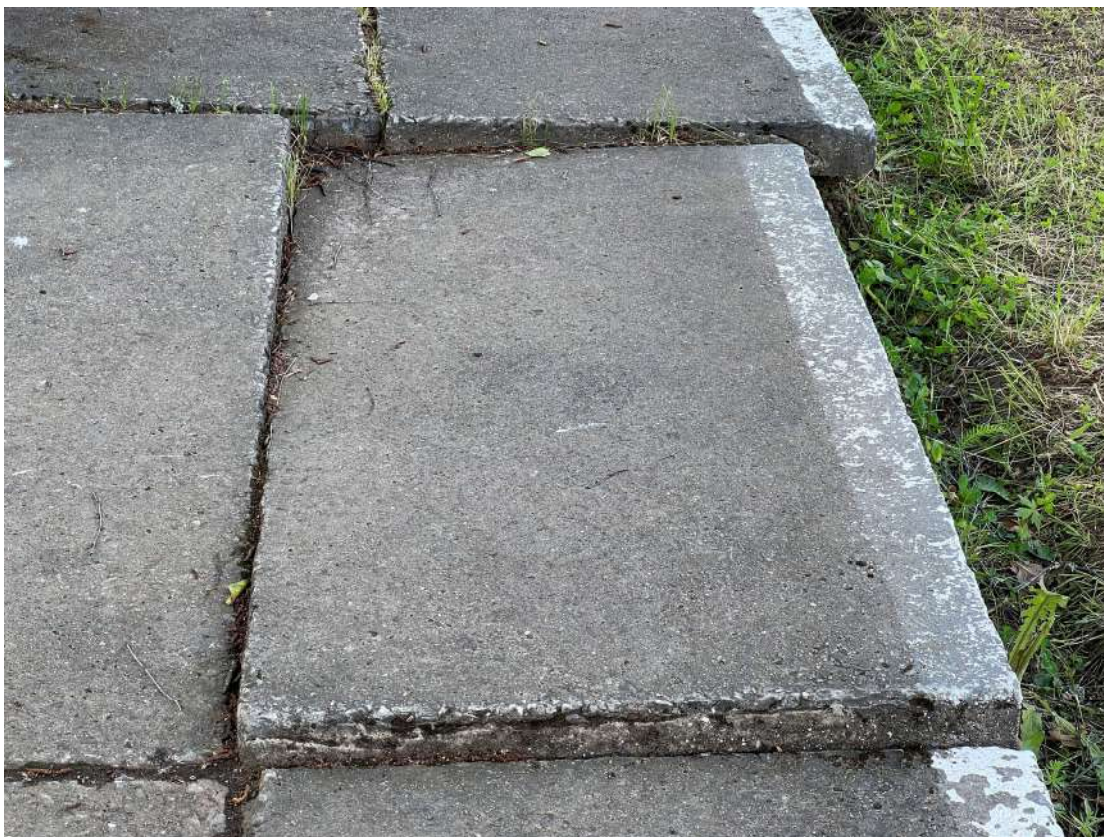
Фото 20. Пешеходная дорожка из бетонных плит, фрагмент. Биопоражения, просадки, трещины, деструкция наружного слоя бетона, сколы, множественные окрасы, шелушение красочного слоя. Дата съемки: июнь 2025. Автор: Козлова Е.М.
