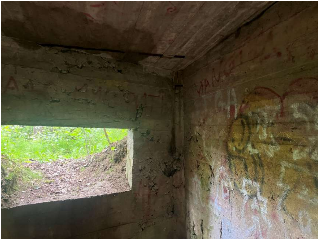
Фото 85. Пулеметный ДОТ. Внутренняя часть. Биопоражения, следы систематического намокания, антропогенные загрязнения, следы коррозии металлических балок, деструкция внешнего слоя бетона. Дата съемки: июнь 2025. Автор: Козлова Е.М.
