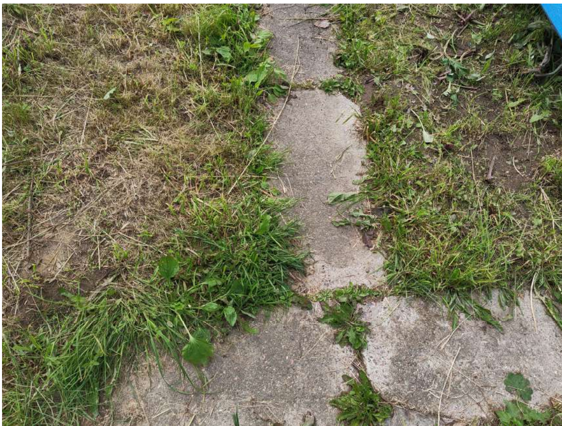
Фото 78. Территория объекта. Пешеходная дорожка к орудию – биопоражения, просадки, трещины, деструкция наружного слоя бетона. Дата съемки: июнь 2025. Автор: Козлова Е.М.
