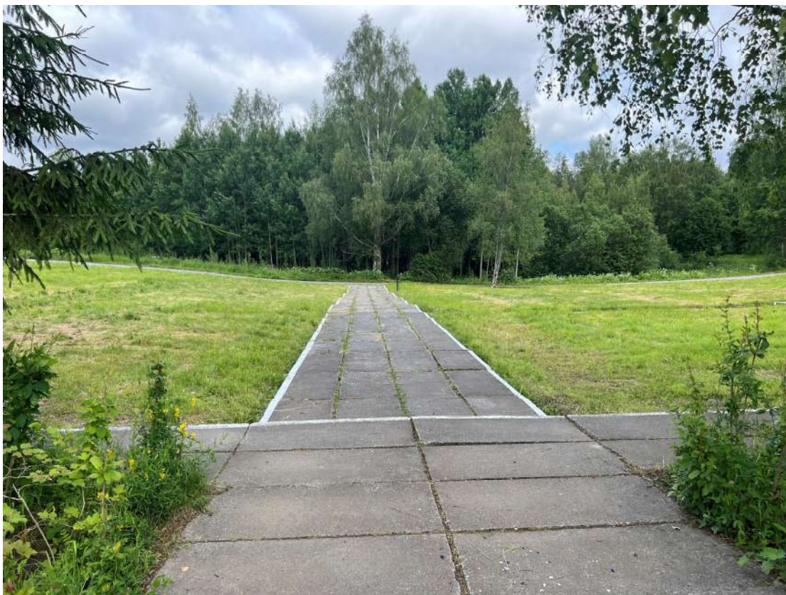
Фото 16. Пешеходная дорожка из бетонных плит. Биопоражения, просадки, трещины, деструкция наружного слоя бетона, сколы, множественные окрасы, шелушение красочного слоя. Дата съемки: июнь 2025. Автор: Козлова Е.М.
