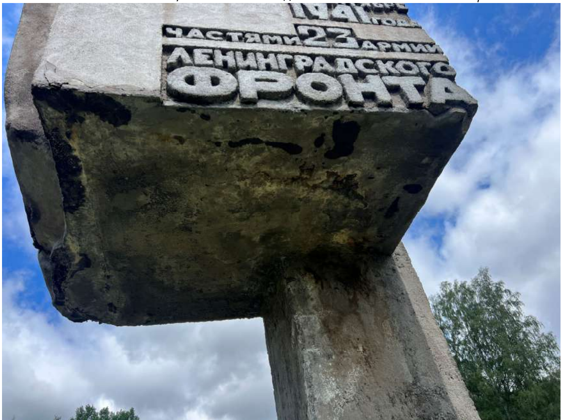
Фото 23. Вертикальная стела, фрагмент. Деструкция наружного слоя бетона, трещины, следы систематического намокания, следы высолов. Дата съемки: июнь 2025. Автор: Козлова Е.М.
