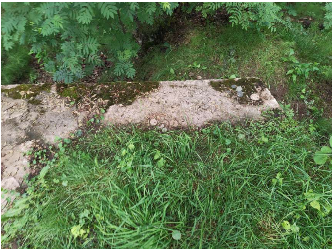
Фото 91. Пулеметный ДОТ. Биопоражения, следы систематического намокания, деструкция внешнего слоя бетона. Дата съемки: июнь 2025. Автор: Козлова Е.М.
