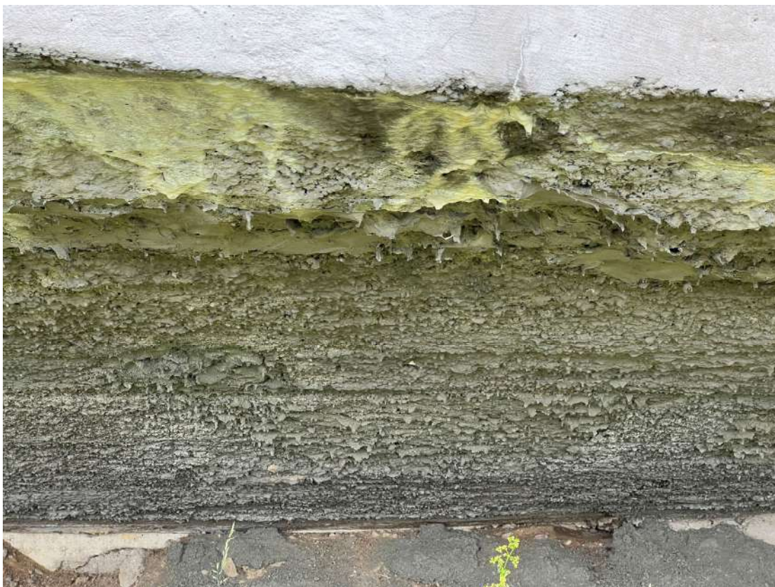
Фото 61. Горизонтальный пилон, горельеф. Фрагмент. Деструкция наружного слоя бетона, трещины, следы множественных окрасов, шелушение красочного слоя, биопоражения, следы высолов. Дата съемки: июнь 2025. Автор: Козлова Е.М.
