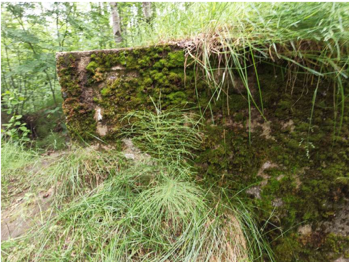
Фото 89. Пулеметный ДОТ. Биопоражения, следы систематического намокания, деструкция внешнего слоя бетона. Дата съемки: июнь 2025. Автор: Козлова Е.М.
