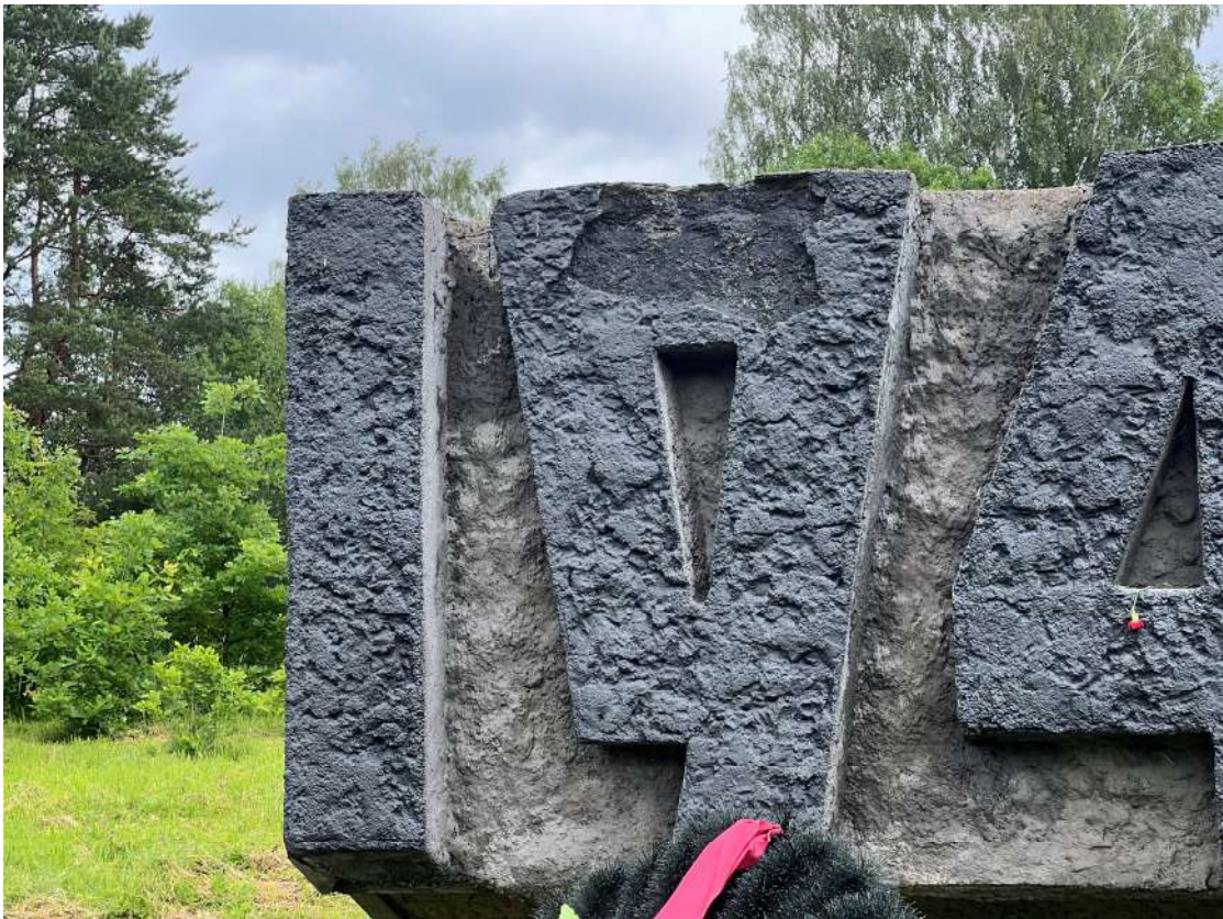
Фото 64. Горизонтальный пилон, памятные даты, фрагмент. Деструкция наружного слоя бетона, трещины, следы систематического намокания, множественных окрасов, шелушение красочного слоя, биопоражения. Дата съемки: июнь 2025. Автор: Козлова Е.М.
