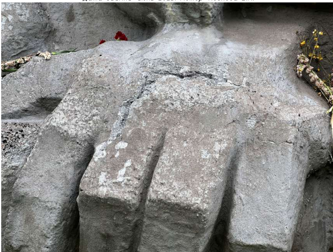
Фото 60. Горизонтальный пилон, горельеф. Фрагмент. Деструкция наружного слоя бетона, трещины, следы множественных окрасов, шелушение красочного слоя, биопоражения, следы высолов. Дата съемки: июнь 2025. Автор: Козлова Е.М.
