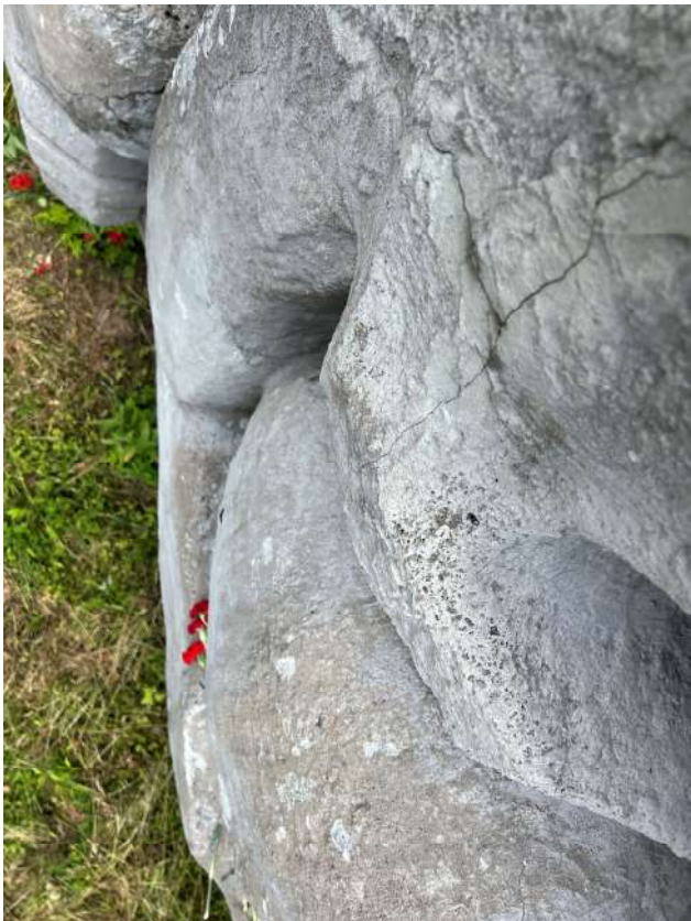
Фото 50. Горизонтальный пилон, горельеф. Фрагмент. Деструкция наружного слоя бетона, трещины. Дата съемки: июнь 2025. Автор: Козлова Е.М.
