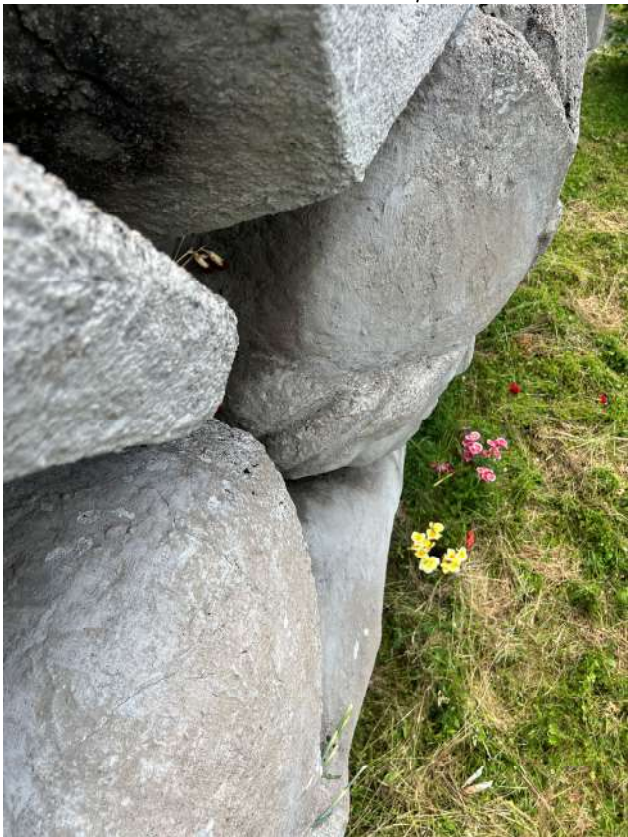
Фото 51. Горизонтальный пилон, горельеф. Фрагмент. Деструкция наружного слоя бетона, трещины. Дата съемки: июнь 2025. Автор: Козлова Е.М.
