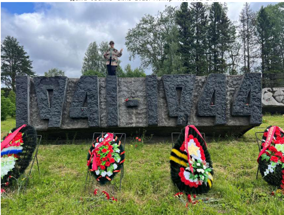
Фото 63. Горизонтальный пилон, памятные даты. Деструкция наружного слоя бетона, трещины, следы систематического намокания, множественных окрасов, шелушение красочного слоя, биопоражения. Дата съемки: июнь 2025. Автор: Козлова Е.М.
