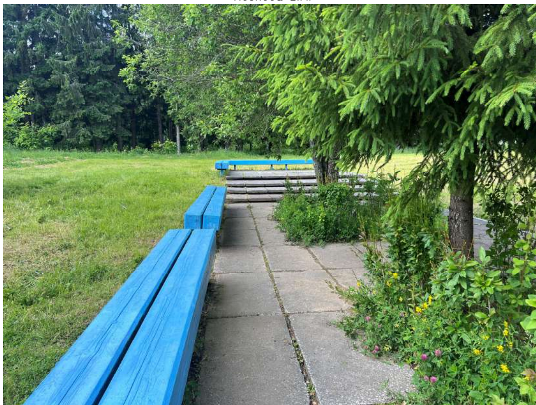
Фото 15. Территория объекта. Деревянные скамьи – крены, трещины, шелушение красочного слоя. Цветник – зарастание самосевными растениями. самосевными растениями. Пешеходная дорожка – биопоражения, просадки, трещины, деструкция наружного слоя бетона, сколы, множественные окрасы, шелушение красочного слоя. Дата съемки: июнь 2025. Автор: Козлова Е.М.
