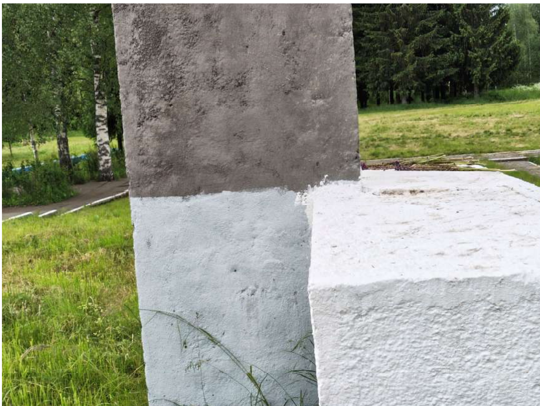
Фото 32. Вертикальная стела, фрагмент. Деструкция наружного слоя бетона, трещины, следы, следы множественных окрасов, шелушение красочного слоя. Дата съемки: июнь 2025. Автор: Козлова Е.М.
