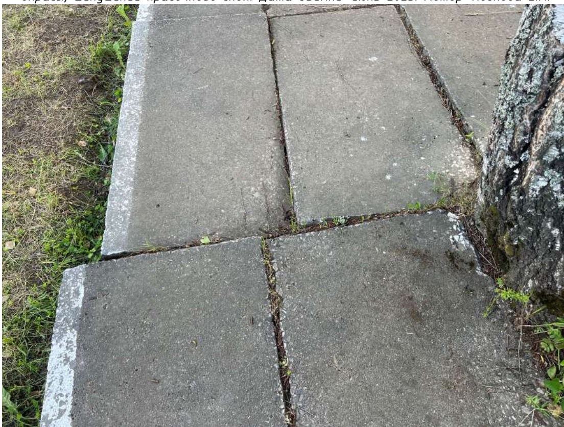
Фото 19. Пешеходная дорожка из бетонных плит, фрагмент. Биопоражения, просадки, трещины, деструкция наружного слоя бетона, сколы, множественные окрасы, шелушение красочного слоя. Дата съемки: июнь 2025. Автор: Козлова Е.М.
