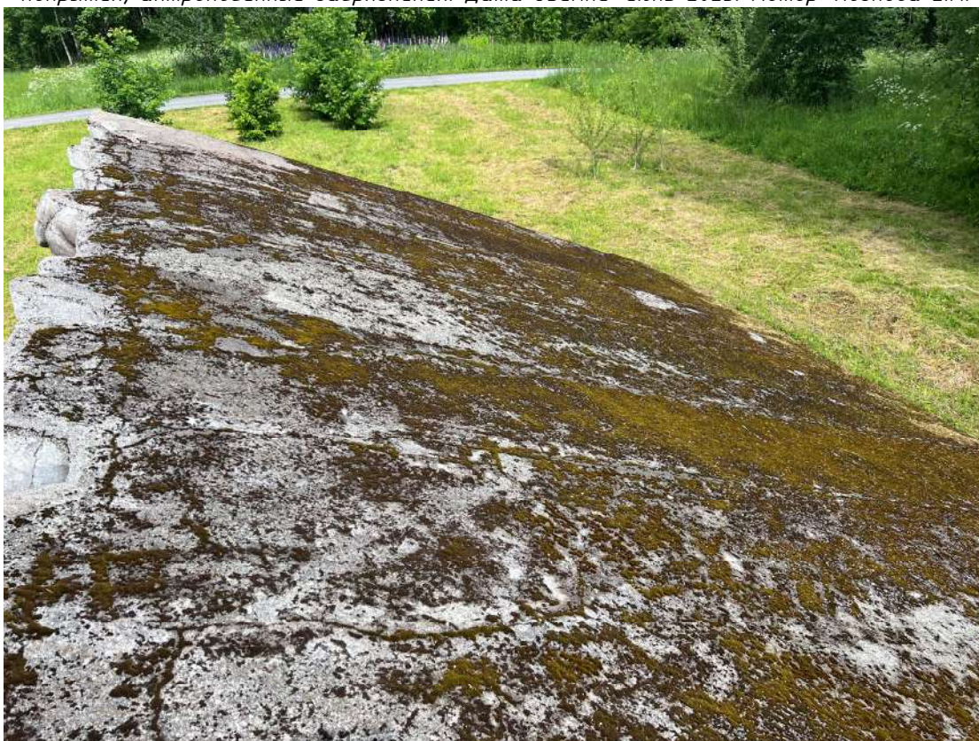
Фото 47. Горизонтальный пилон. Биопоражения, деструкция кровельного покрытия. Дата съемки: июнь 2025. Автор: Козлова Е.М.
