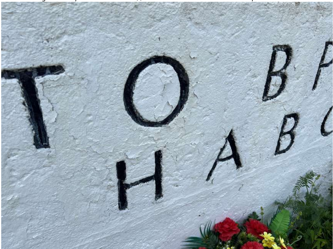
Фото 37. Горизонтальная стела, фрагмент. Деструкция наружного слоя бетона, следы множественных окрасов, шелушение красочного слоя. Дата съемки: июнь 2025. Автор: Козлова Е.М.
