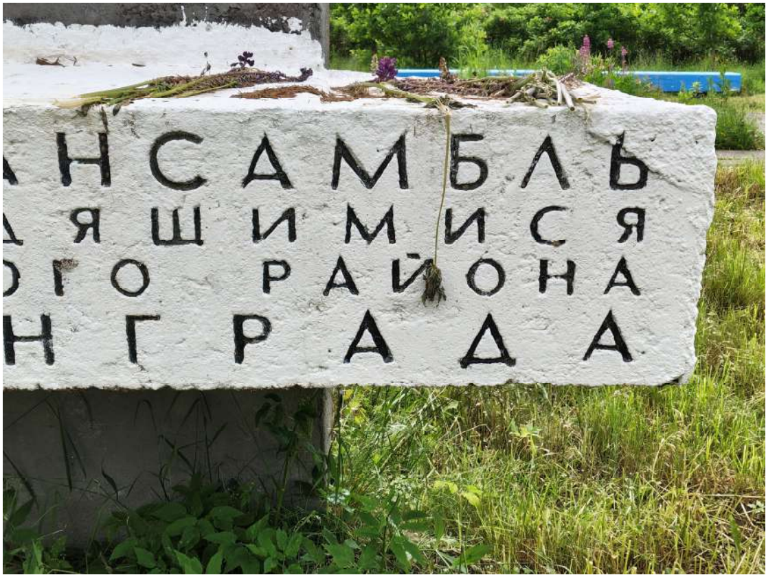
Фото 28. Вертикальная стела, фрагмент. Деструкция наружного слоя бетона, следы множественных окрасов, шелушение красочного слоя, антропогенные загрязнения. Дата съемки: июнь 2025. Автор: Козлова Е.М.
