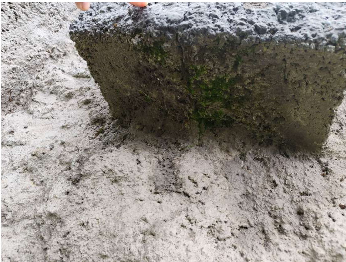
Фото 66. Горизонтальный пилон, памятные даты, фрагмент. Деструкция наружного слоя бетона, трещины, следы систематического намокания, множественных окрасов, шелушение красочного слоя, биопоражения. Дата съемки: июнь 2025. Автор: Козлова Е.М.
