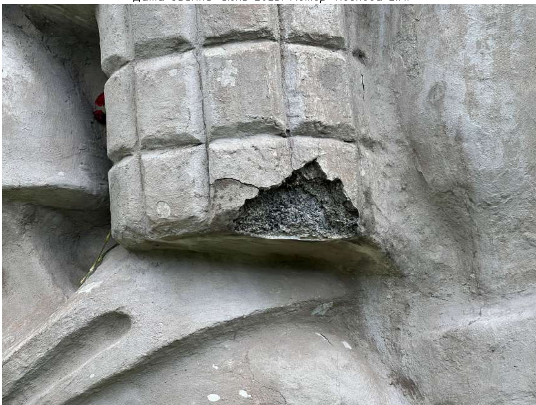
Фото 57. Горизонтальный пилон, горельеф. Фрагмент. Деструкция наружного слоя бетона, трещины, следы множественных окрасов, шелушение красочного слоя, биопоражения. Дата съемки: июнь 2025. Автор: Козлова Е.М.
