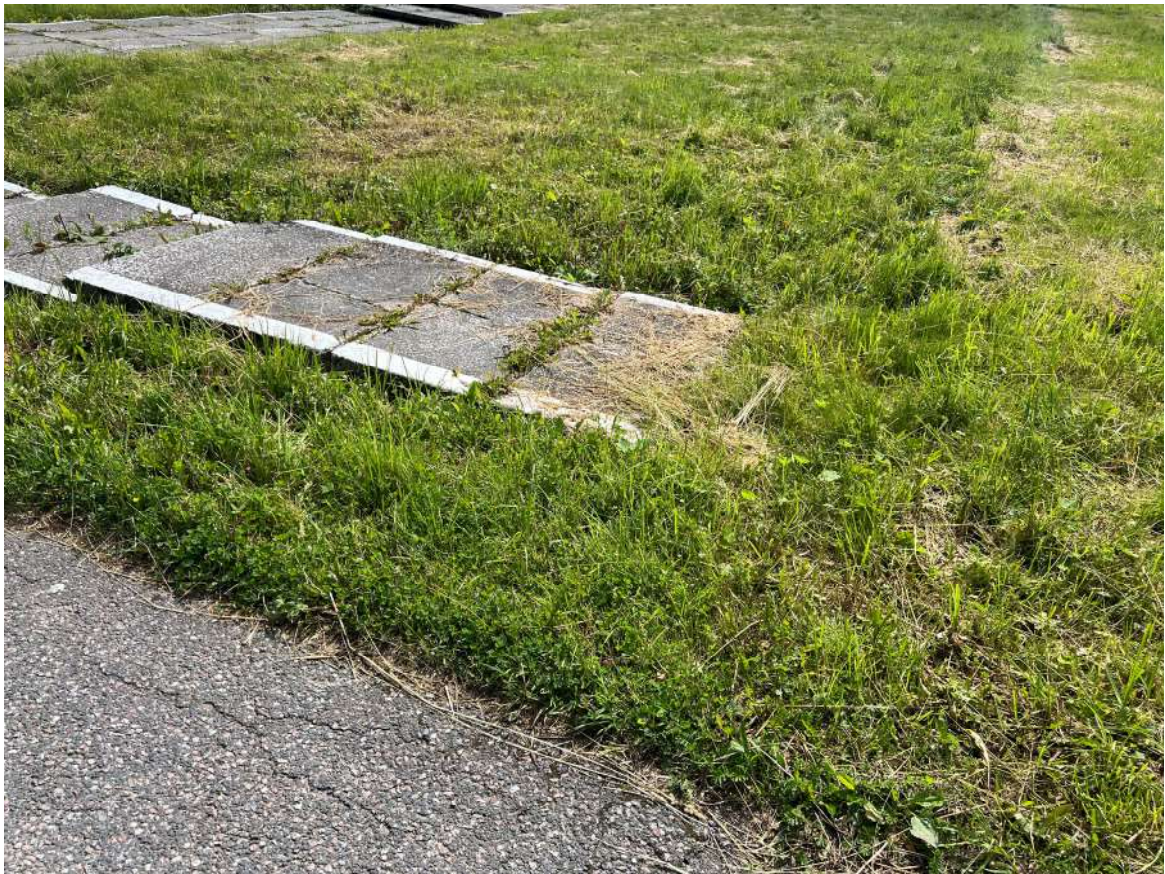
Фото 9. Пешеходная дорожка из бетонных плит. Биопоражения, просадки, трещины, разрушение наружного слоя бетона, сколы, множественные окрасы. Дата съемки: июнь 2025. Автор: Козлова Е.М.
