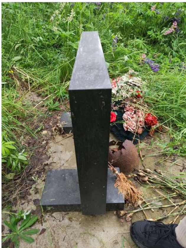
Фото 98. Мраморная памятная табличка. Бетонное основание, место крепления. Деструкция внешнего слоя бетона, биопоражения, следы систематического намокания, антропогенные загрязнения. Дата съемки: июнь 2025. Автор: Козлова Е.М.
