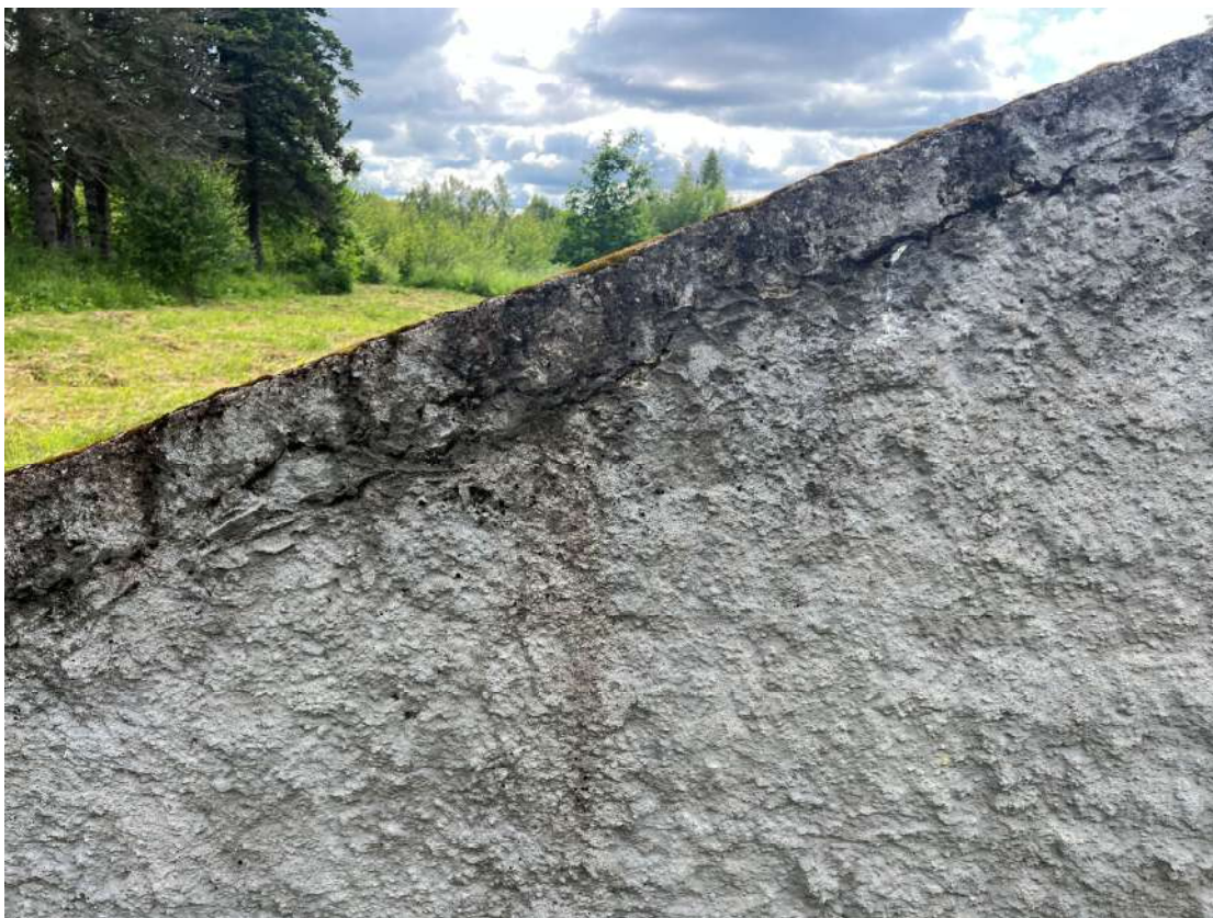
Фото 46. Горизонтальный пилон. Деструкция наружного слоя бетона, трещины, следы множественных окрасов, шелушение красочного слоя, биопоражения, деструкция кровельного покрытия, антропогенные загрязнения. Дата съемки: июнь 2025. Автор: Козлова Е.М.
