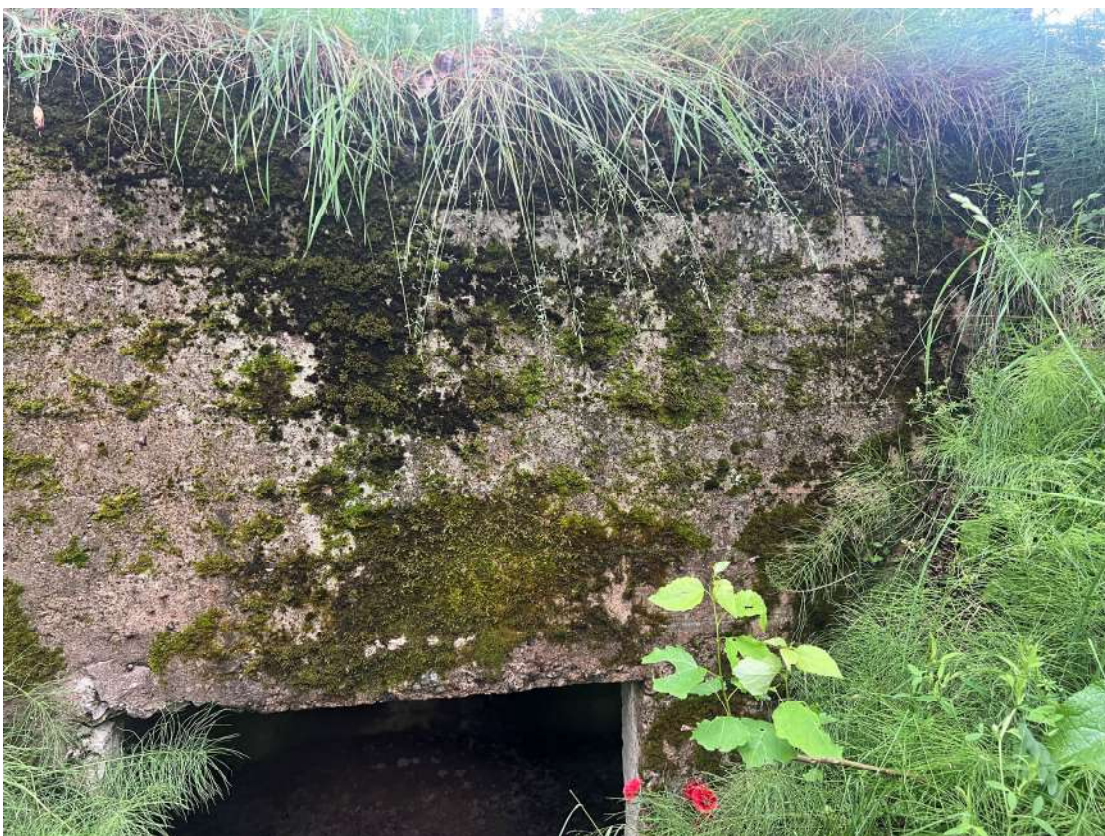
Фото 81. Пулеметный ДОТ. Следы систематического намокания, высолы, биопоражения. Дата съемки: июнь 2025. Автор: Козлова Е.М.
