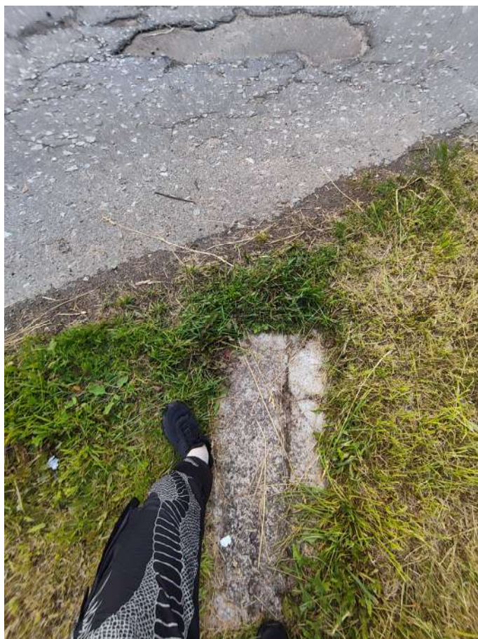
Фото 79. Территория объекта. Пешеходная дорожка к орудию – биопоражения, просадки, трещины, деструкция наружного слоя бетона. Дата съемки: июнь 2025. Автор: Козлова Е.М.
