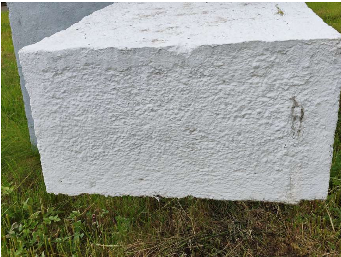
Фото 30. Вертикальная стена, фрагмент. Деструкция наружного слоя бетона, трещины, следы, следы множественных окрасов, шелушение красочного слоя. Дата съемки: июнь 2025. Автор: Козлова Е.М.
