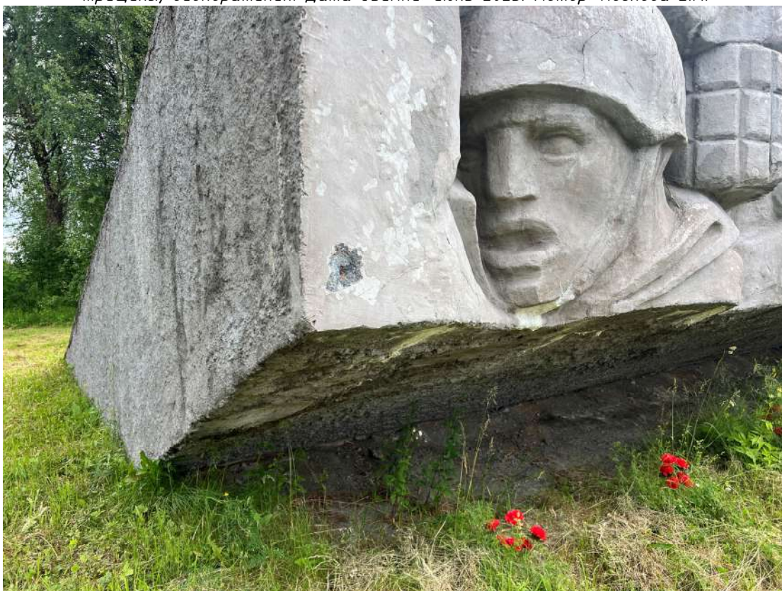
Фото 55. Горизонтальный пилон, горельеф. Фрагмент. Деструкция наружного слоя бетона, трещины, биопоражения, следы множественных окрасов, шелушение красочного слоя, следы высолов. Дата съемки: июнь 2025. Автор: Козлова Е.М.
