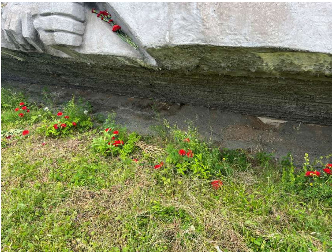
Фото 62. Горизонтальный пилон, горельеф. Фрагмент. Деструкция наружного слоя бетона, трещины, следы множественных окрасов, шелушение красочного слоя, биопоражения, следы высолов. Дата съемки: июнь 2025. Автор: Козлова Е.М.
