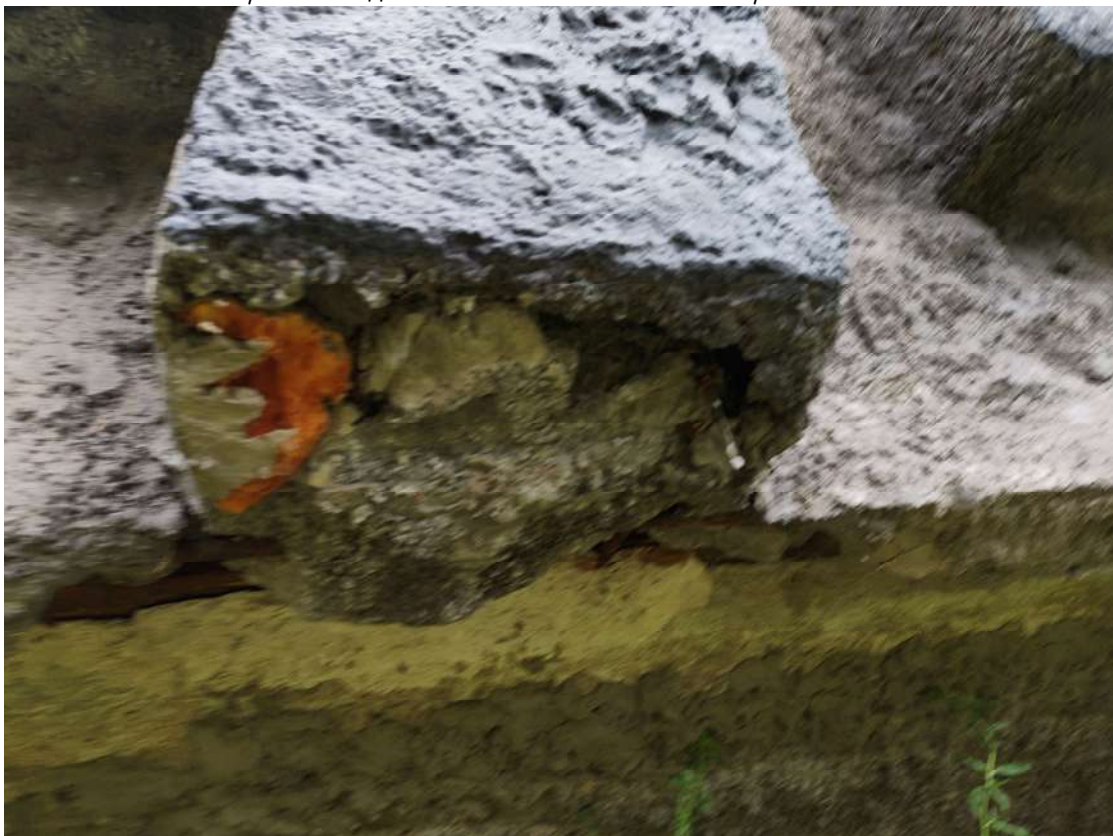
Фото 65. Горизонтальный пилон, памятные даты, фрагмент. Деструкция наружного слоя бетона. Дата съемки: июнь 2025. Автор: Козлова Е.М.
