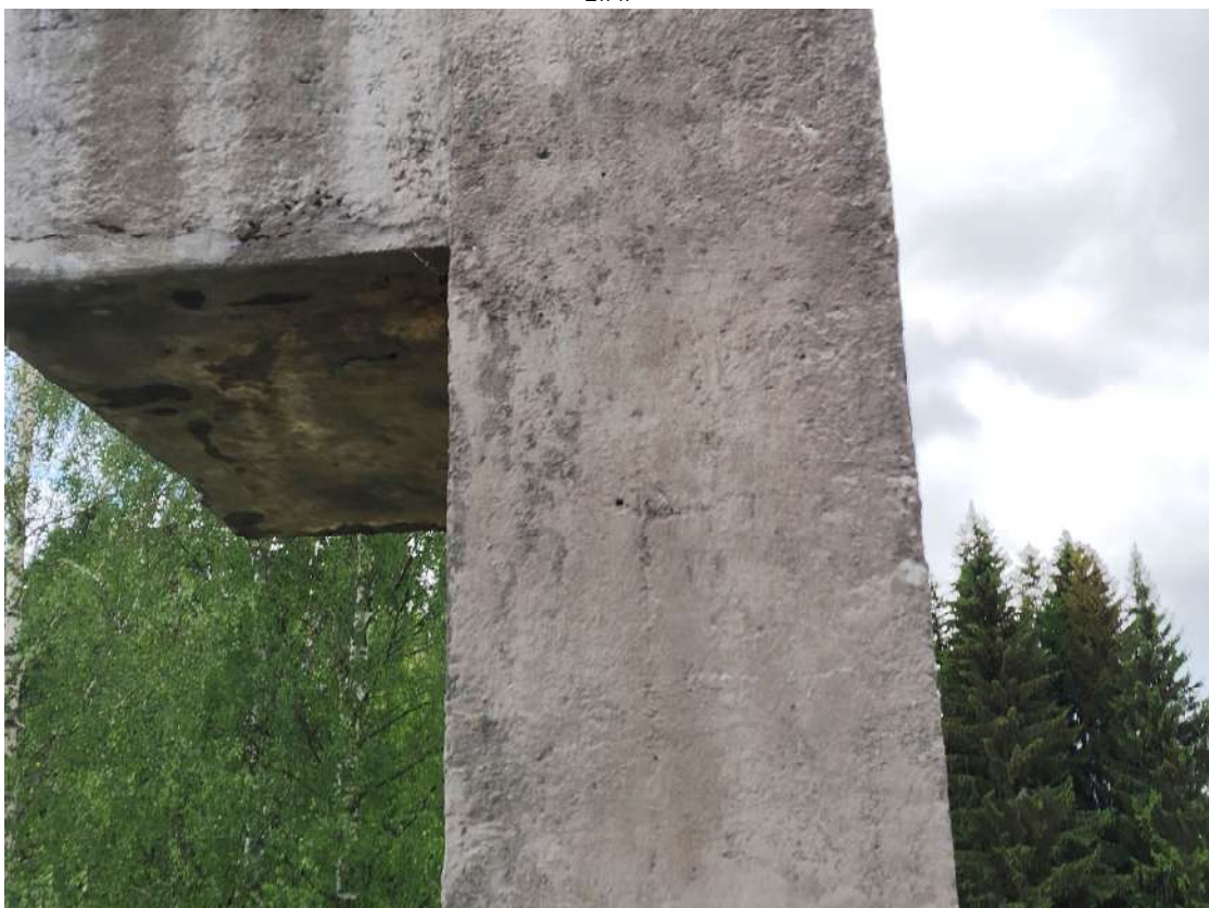
Фото 33. Вертикальная стела, фрагмент. Деструкция наружного слоя бетона, трещины, следы систематического намокания, следы высолов, следы продуктов коррозии арматуры, следы поздних ремонтов. Дата съемки: июнь 2025. Автор: Козлова Е.М.
