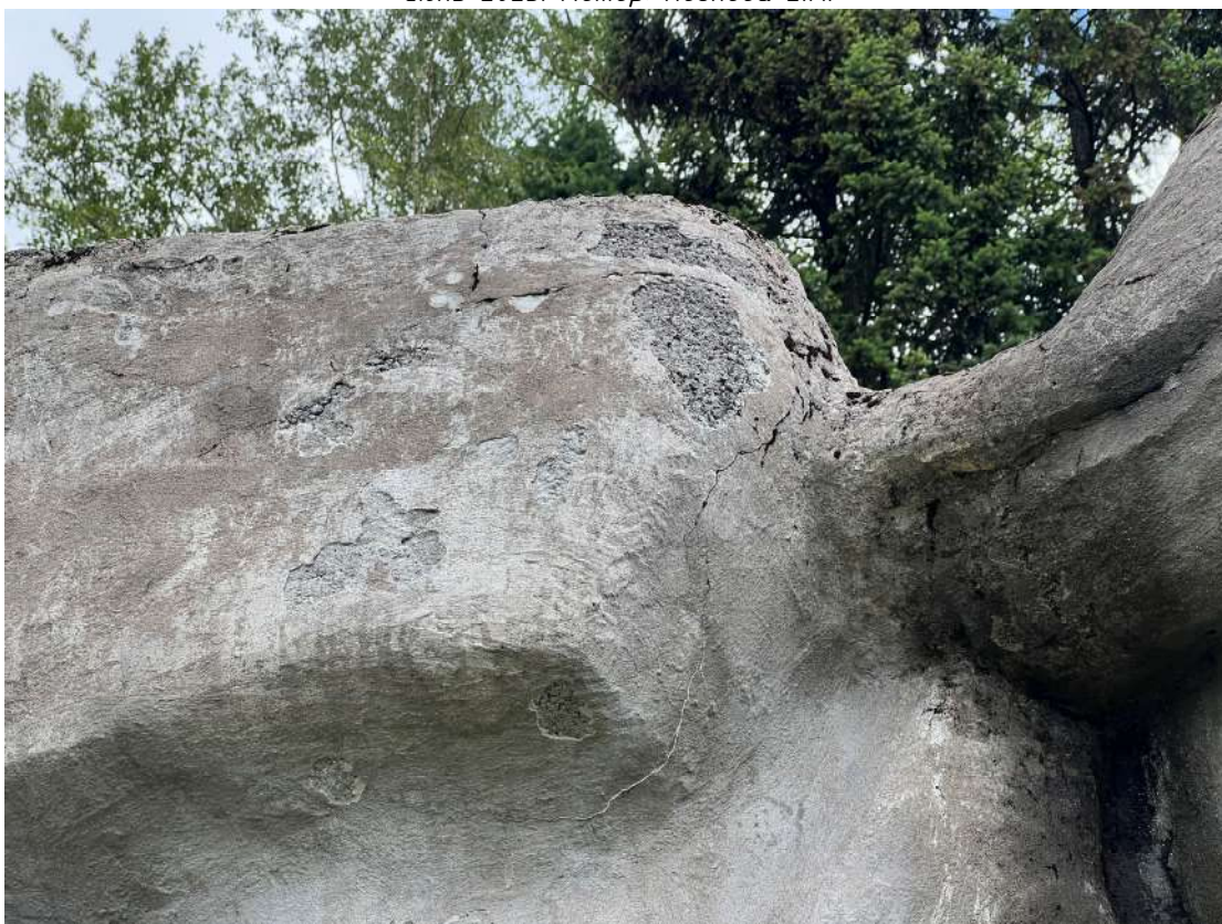
Фото 59. Горизонтальный пилон, горельеф. Фрагмент. Деструкция наружного слоя бетона, трещины, следы множественных окрасов, шелушение красочного слоя, биопоражения. Дата съемки: июнь 2025. Автор: Козлова Е.М.
