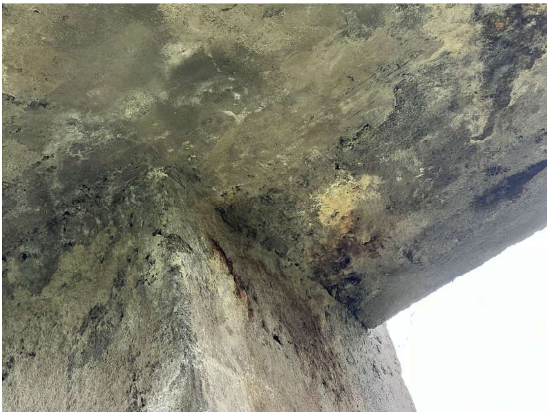
Фото 24. Вертикальная стена, фрагмент. Деструкция наружного слоя бетона, трещины, следы систематического намокания, следы высолов, следы продуктов коррозии арматуры, следы поздних ремонтов. Дата съемки: июнь 2025. Автор: Козлова Е.М.
