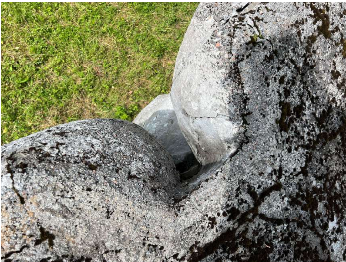
Фото 52. Горизонтальный пилон, горельеф. Фрагмент. Деструкция наружного слоя бетона, трещины, биопоражения. Дата съемки: июнь 2025. Автор: Козлова Е.М.
