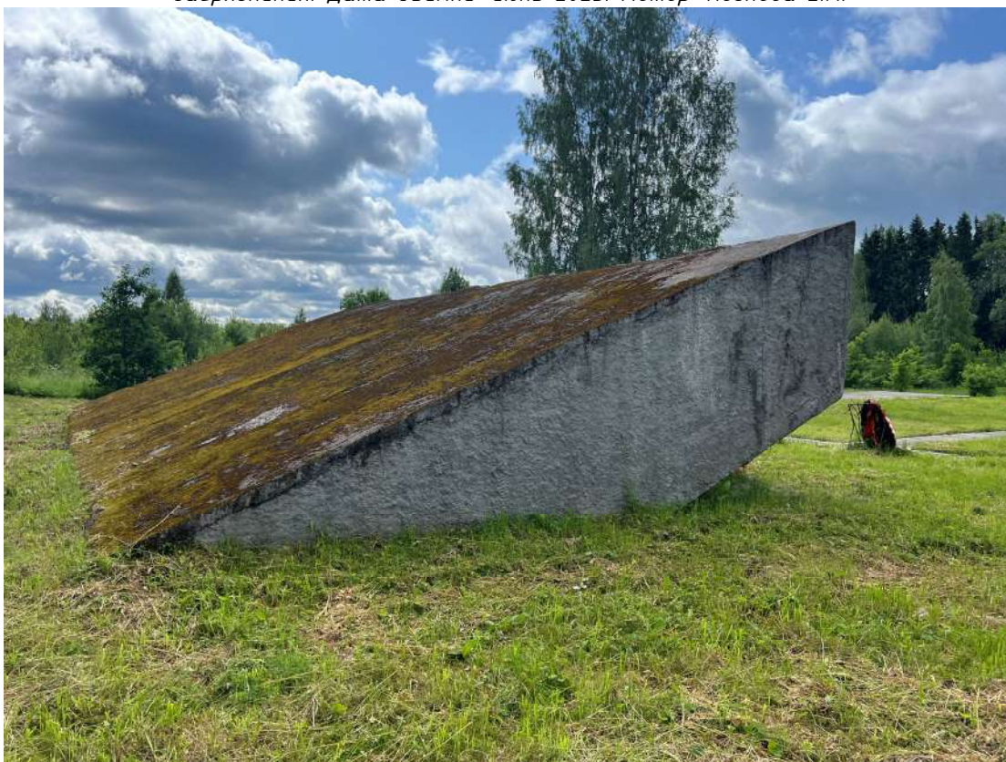
Фото 45. Горизонтальный пилон. Деструкция наружного слоя бетона, следы множественных окрасов, шелушение красочного слоя, биопоражения, деструкция кровельного покрытия, антропогенные загрязнения. Дата съемки: июнь 2025. Автор: Козлова Е.М.
