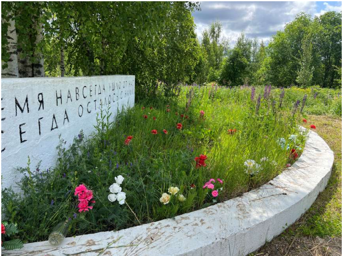
Фото 38. Горизонтальная стела, цветник. Деструкция наружного слоя бетона, следы множественных окрасов, шелушение красочного слоя. Антропогенные загрязнения. Заращение самосевными растениями. Дата съемки: июнь 2025. Автор: Козлова Е.М.
