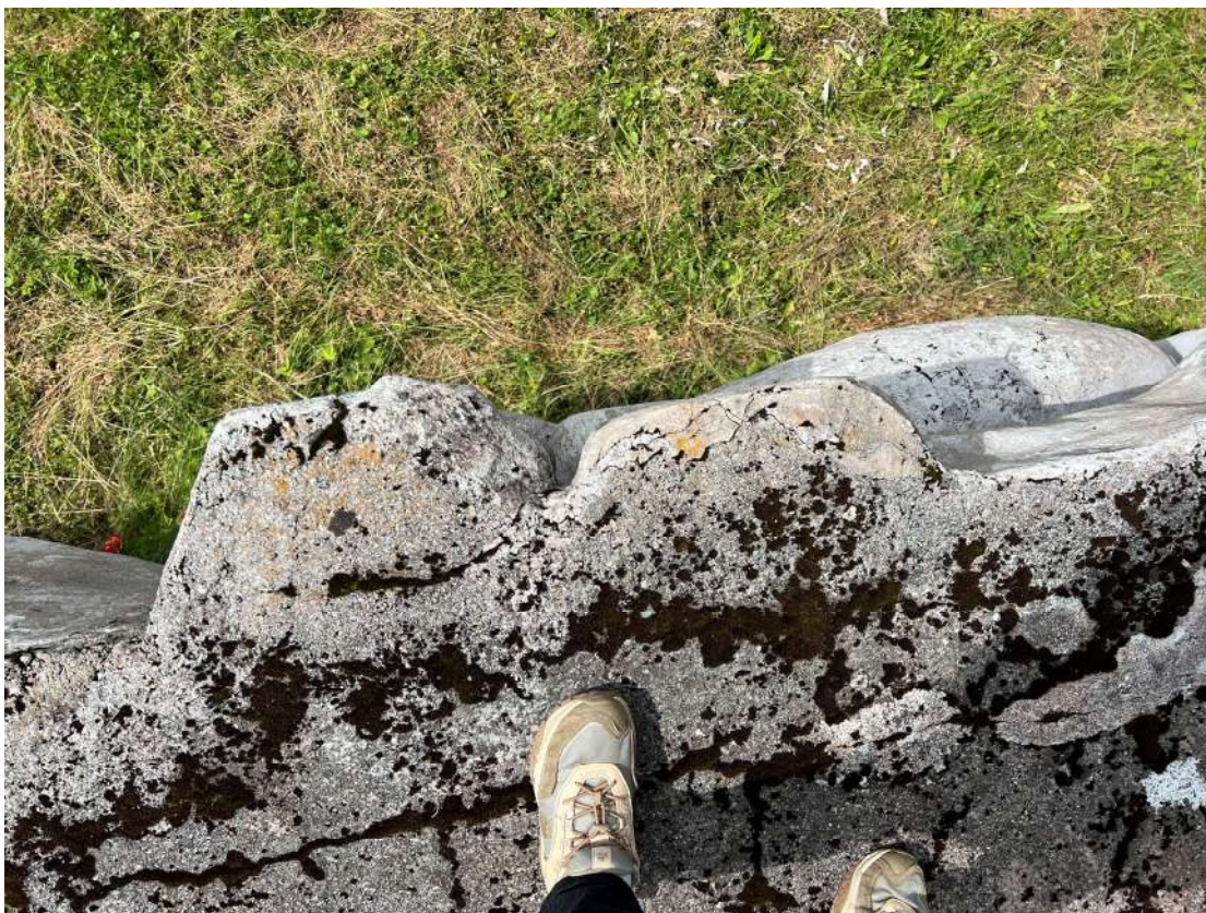
Фото 54. Горизонтальный пилон, горельеф. Фрагмент. Деструкция наружного слоя бетона, трещины, биопоражения. Дата съемки: июнь 2025. Автор: Козлова Е.М.
