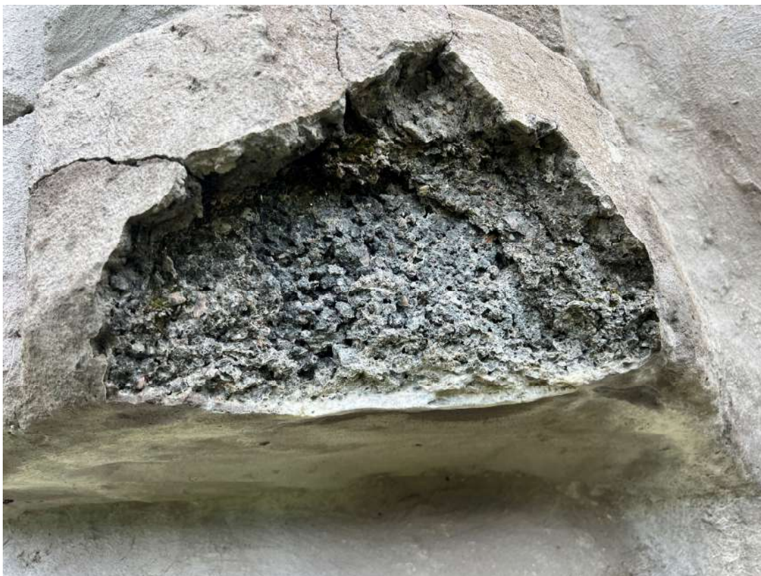
Фото 58. Горизонтальный пилон, горельеф. Фрагмент. Деструкция наружного слоя бетона, трещины, следы множественных окрасов, шелушение красочного слоя, биопоражения. Дата съемки: июнь 2025. Автор: Козлова Е.М.
