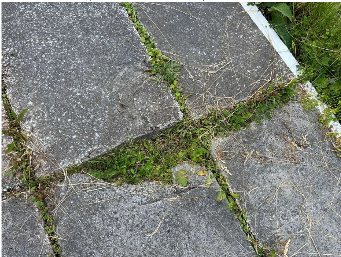
Фото 13. Пешеходная дорожка из бетонных плит, фрагмент. Биопоражения, просадки, трещины, деструкция наружного слоя бетона, сколы, множественные окрасы, шелушение красочного слоя. Дата съемки: июнь 2025. Автор: Козлова Е.М.
