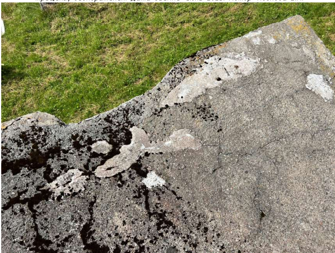
Фото 53. Горизонтальный пилон, горельеф. Фрагмент. Деструкция наружного слоя бетона, трещины, биопоражения. Дата съемки: июнь 2025. Автор: Козлова Е.М.
