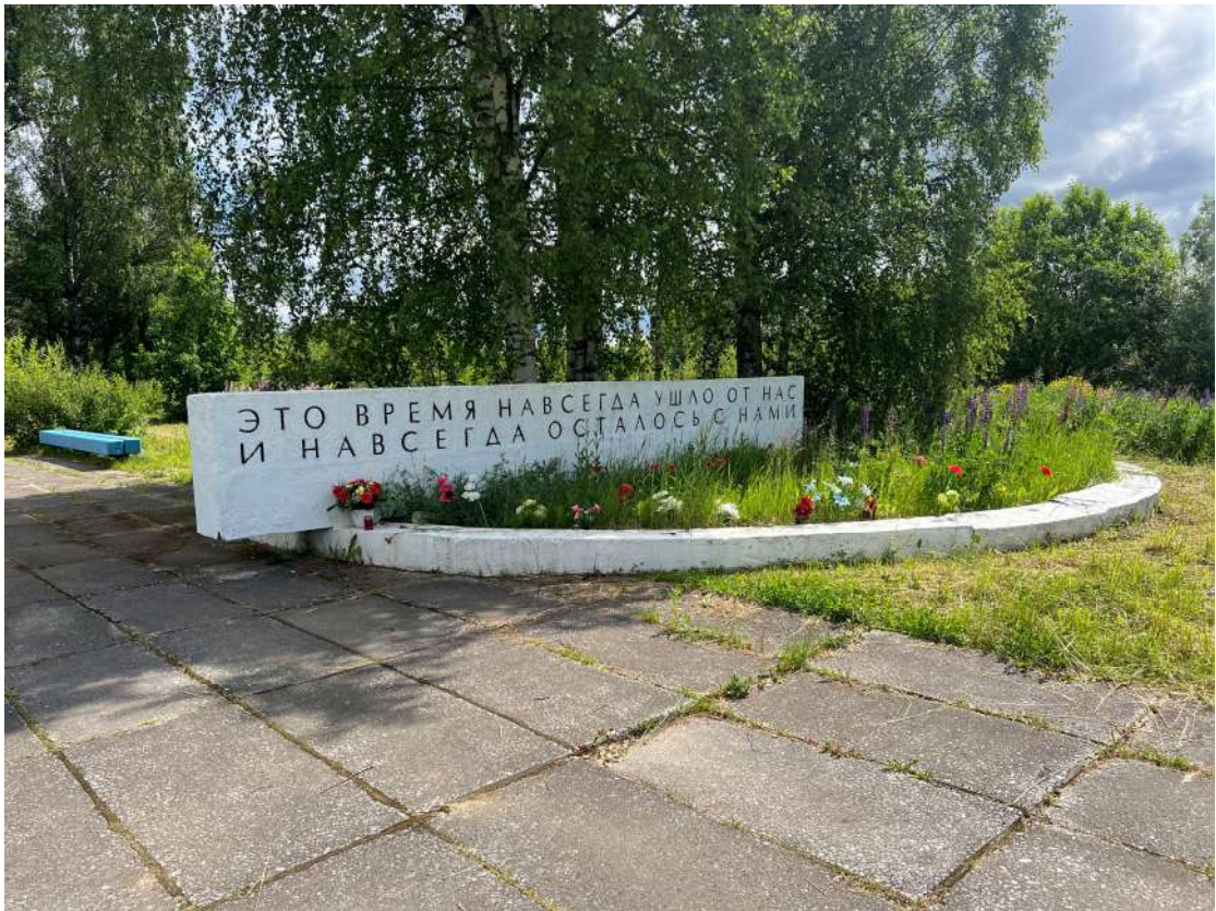
Фото 36. Горизонтальная стела. Деструкция наружного слоя бетона, следы множественных окрасов, шелушение красочного слоя. Дата съемки: июнь 2025. Автор: Козлова Е.М
