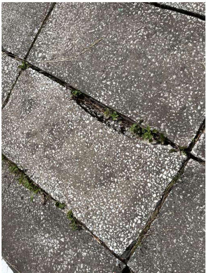
Фото 11. Пешеходная дорожка из бетонных плит, фрагмент. Биопоражения, просадки, трещины, деструкция наружного слоя бетона, сколы. Дата съемки: июнь 2025. Автор: Козлова Е.М.
