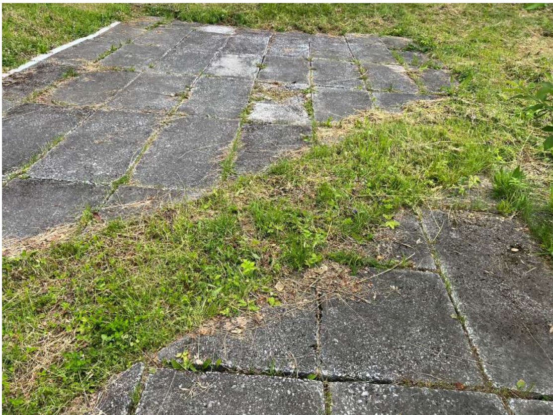
Фото 41. Пешеходная дорожка из бетонных плит. Биопоражения, просадки, трещины, деструкция наружного слоя бетона, сколы, множественные окрасы. Дата съемки: июнь 2025. Автор: Козлова Е.М.
