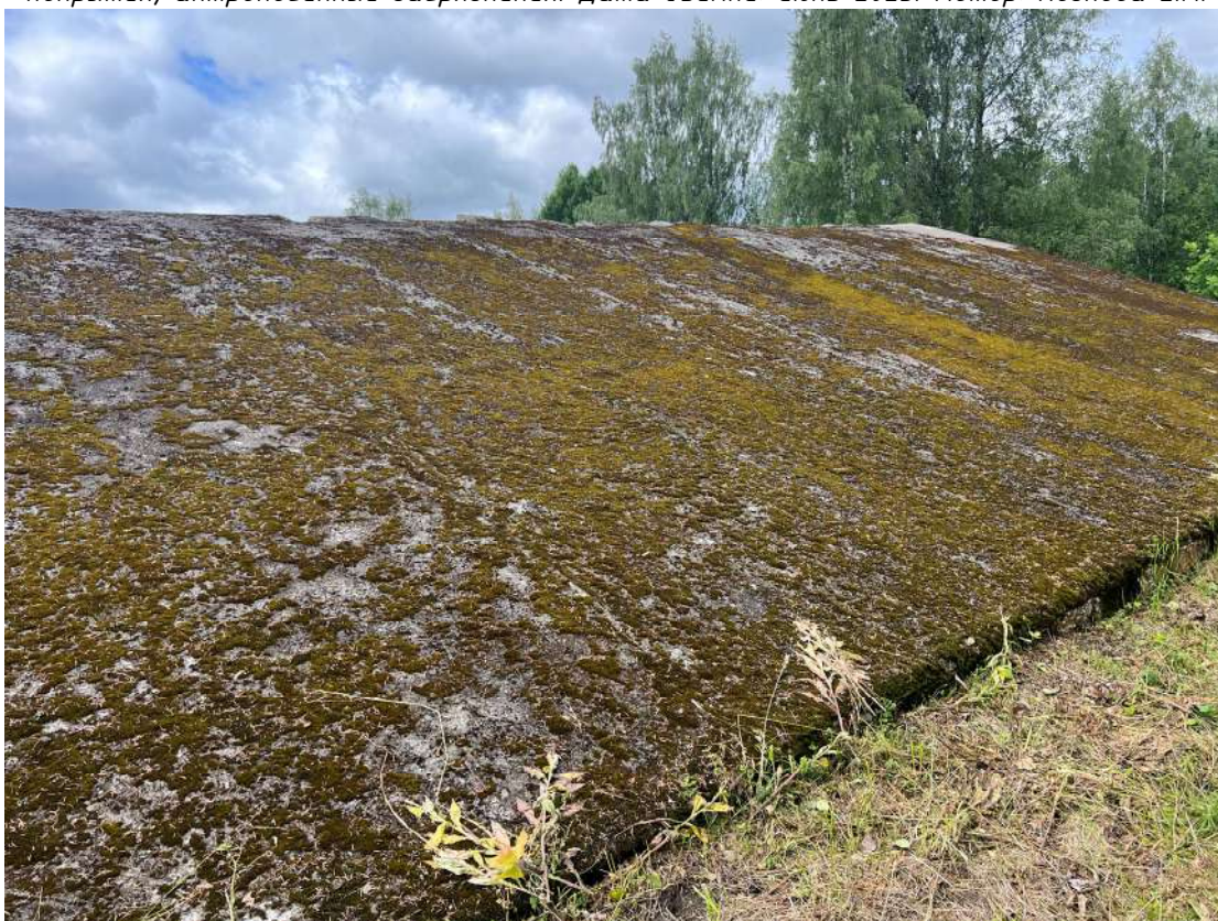
Фото 43. Горизонтальный пилон. Биопоражения, деструкция кровельного покрытия. Дата съемки: июнь 2025. Автор: Козлова Е.М.
