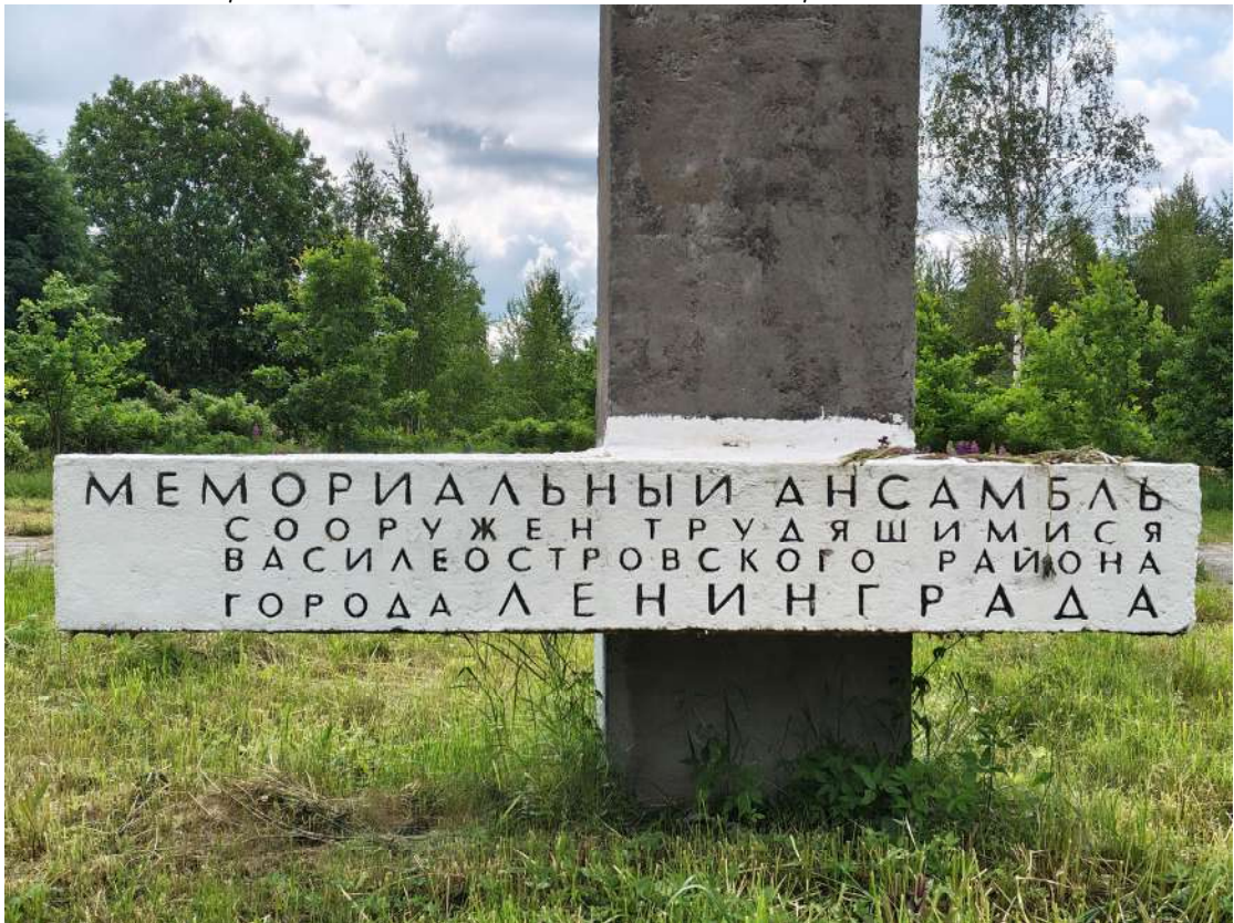
Фото 27. Вертикальная стела, фрагмент. Деструкция наружного слоя бетона, трещины, следы систематического намокания, следы поздних ремонтов, множественных окрасов, шелушение красочного слоя. Дата съемки: июнь 2025. Автор: Козлова Е.М.
