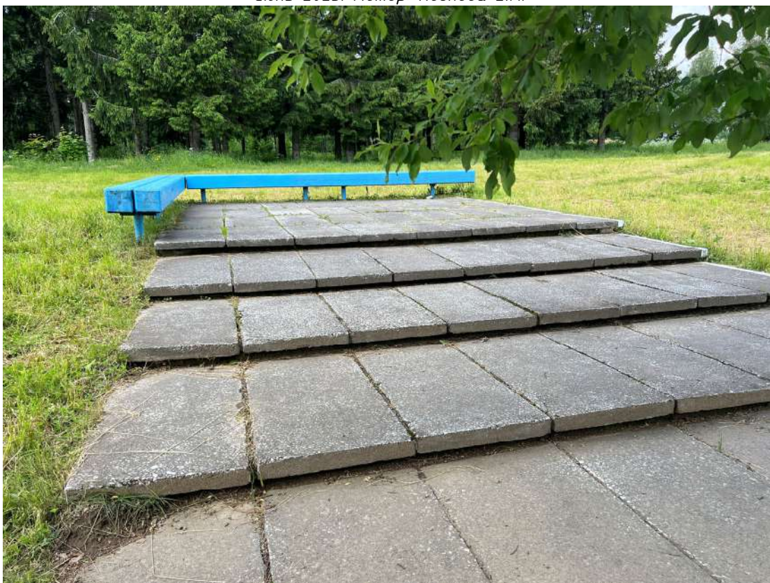
Фото 17. Лестница из бетонных плит. Биопоражения, просадки, трещины, деструкция наружного слоя бетона, сколы. Дата съемки: июнь 2025. Автор: Козлова Е.М.
