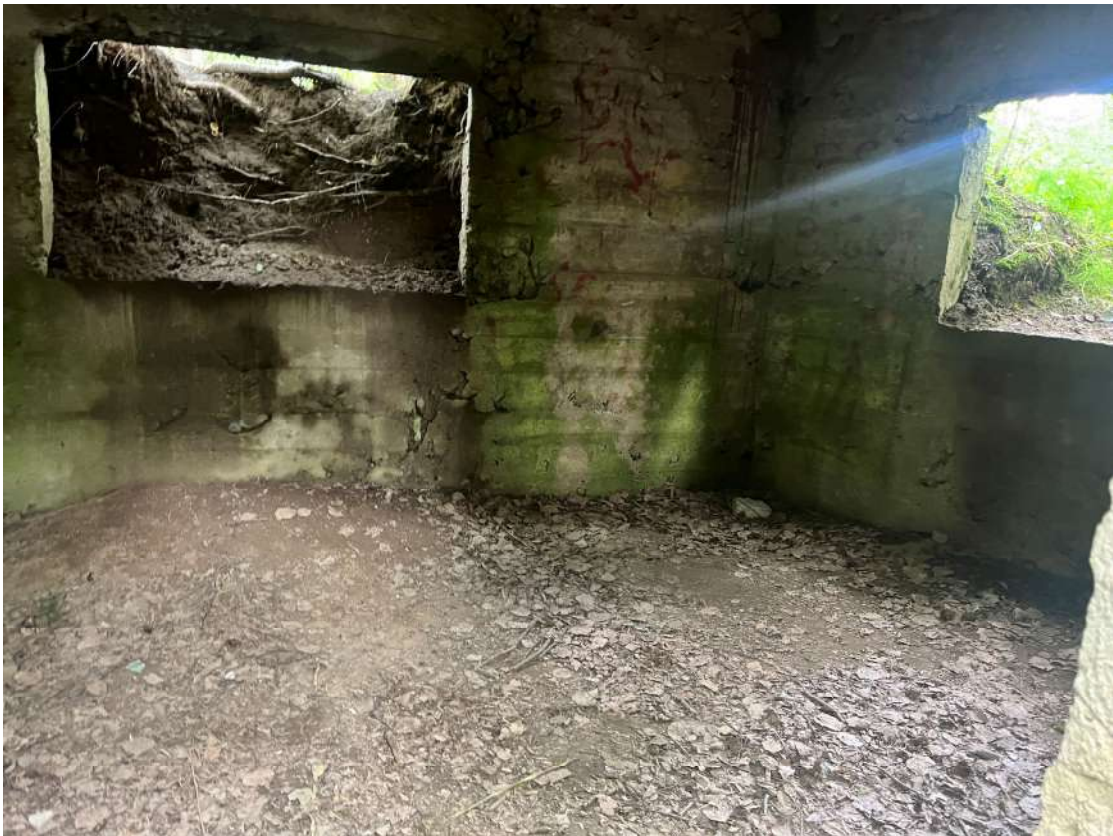
Фото 82. Пулеметный ДОТ. Внутренняя часть. Биопоражения, следы систематического намокания, антропогенные загрязнения. Дата съемки: июнь 2025. Автор: Козлова Е.М.
