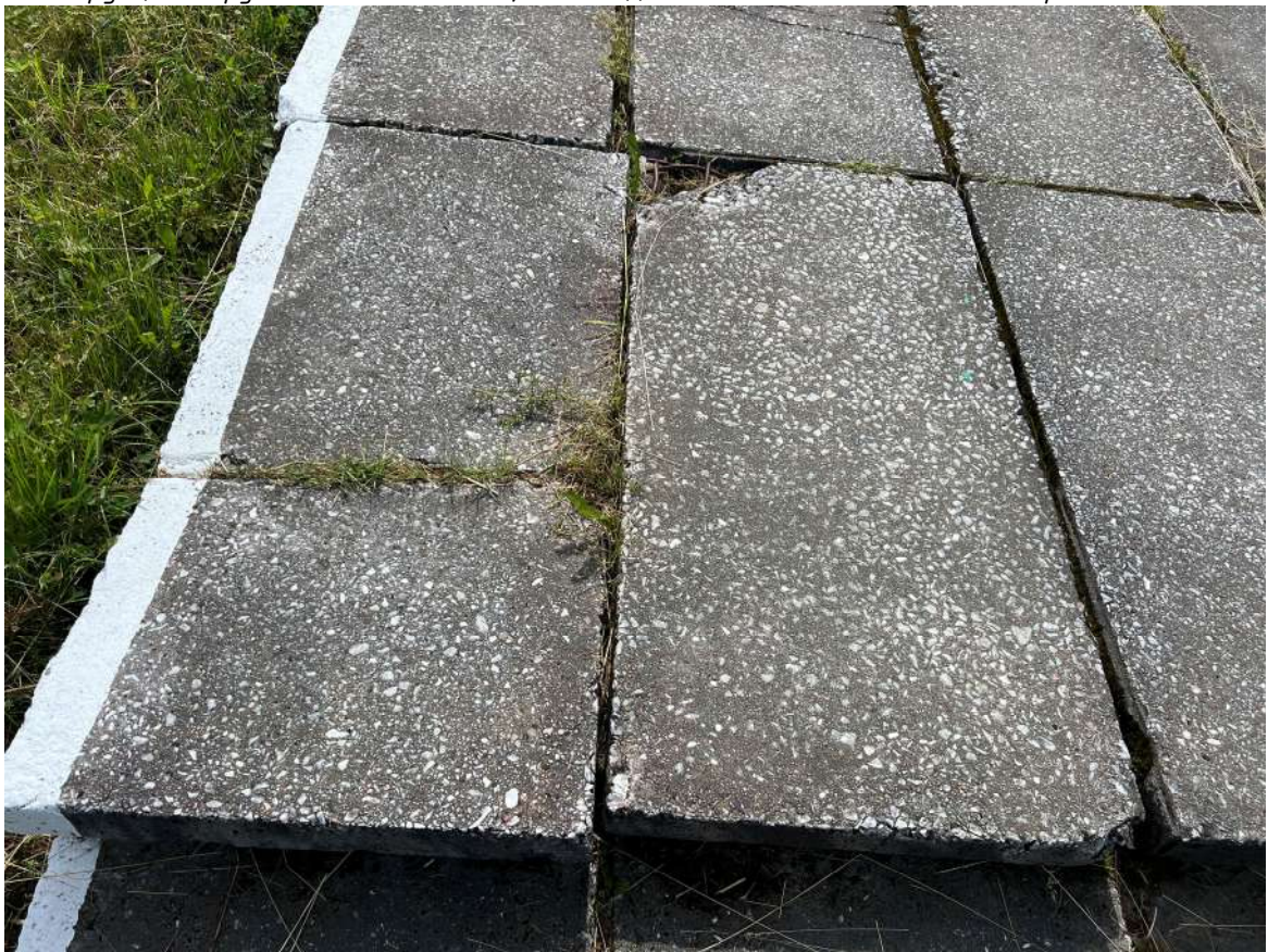
Фото 11. Пешеходная дорожка из бетонных плит, фрагмент. Биопоражения, просадки, трещины, деструкция наружного слоя бетона, сколы, множественные окрасы, шелушение красочного слоя. Дата съемки: июнь 2025. Автор: Козлова Е.М.
