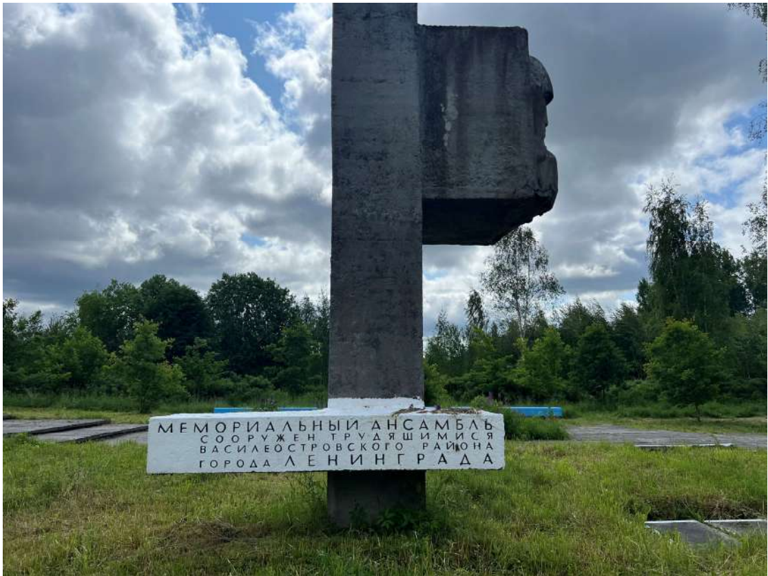
Фото 26. Вертикальная стела. Деструкция наружного слоя бетона, трещины, следы систематического намокания, следы высолов, следы продуктов коррозии арматуры, следы поздних ремонтов. Дата съемки: июнь 2025. Автор: Козлова Е.М.
