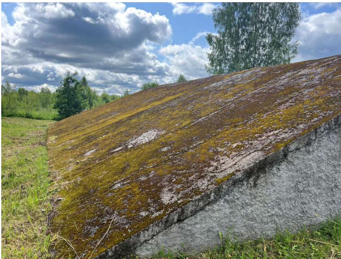
Фото 44. Горизонтальный пилон. Деструкция наружного слоя бетона, следы множественных окрасов, шелушение красочного слоя, биопоражения, деструкция кровельного покрытия, антропогенные загрязнения. Дата съемки: июнь 2025. Автор: Козлова Е.М.
