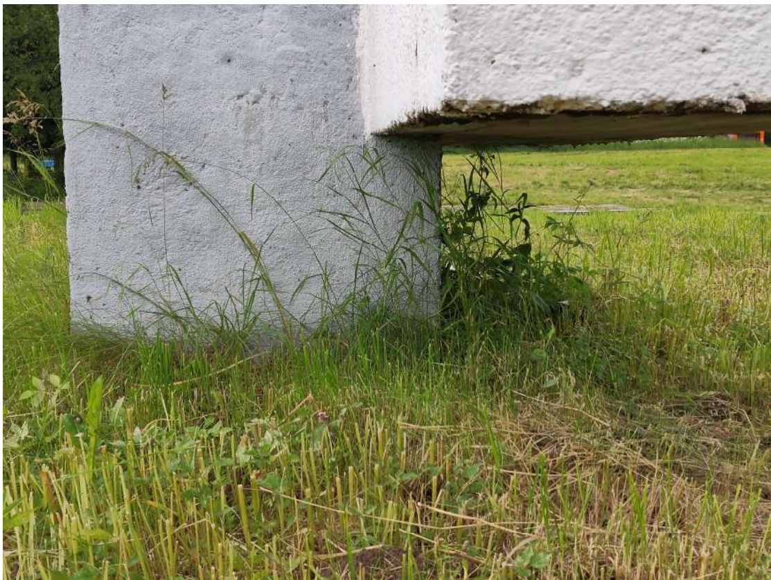
Фото 31. Вертикальная стена, фрагмент. Деструкция наружного слоя бетона, трещины, следы, следы множественных окрасов, шелушение красочного слоя. Дата съемки: июнь 2025. Автор: Козлова Е.М.
