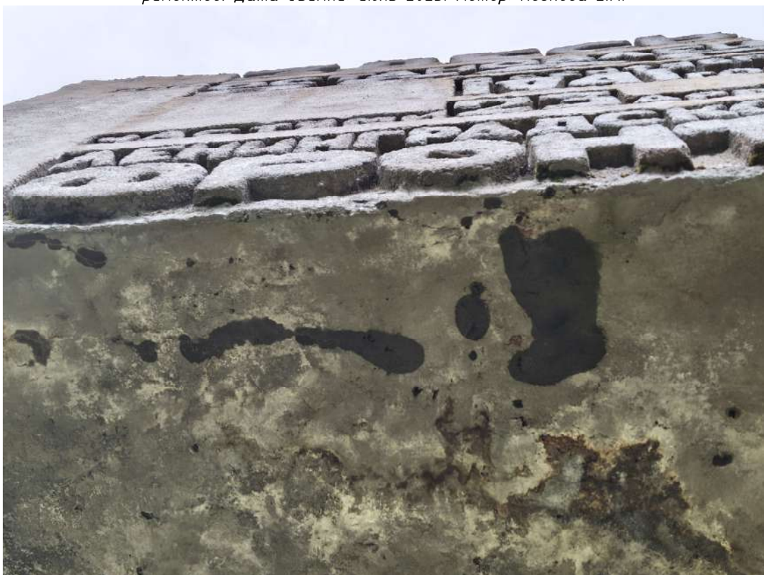
Фото 35. Вертикальная стела, фрагмент. Деструкция наружного слоя бетона, трещины, следы систематического намокания, следы высолов, следы продуктов коррозии арматуры, следы поздних ремонтов. Дата съемки: июнь 2025. Автор: Козлова Е.М.
