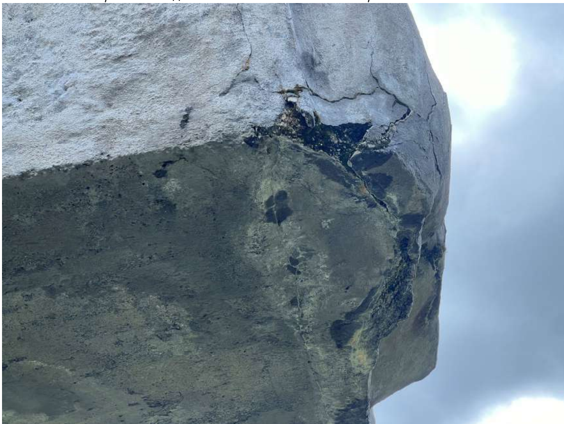
Фото 25. Вертикальная стена, фрагмент. Деструкция наружного слоя бетона, трещины, следы систематического намокания, следы высолов, следы продуктов коррозии арматуры, следы поздних ремонтов. Дата съемки: июнь 2025. Автор: Козлова Е.М.
