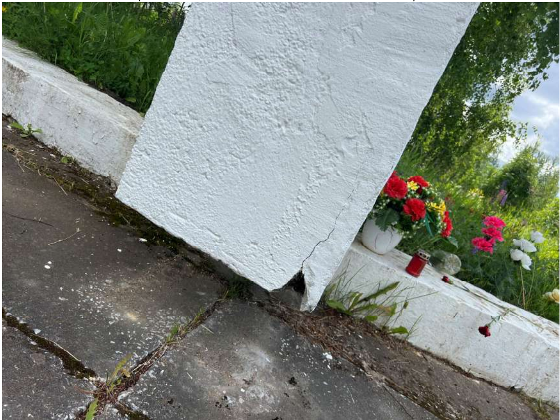
Фото 39. Горизонтальная стела, фрагмент. Деструкция наружного слоя бетона, трещины, следы множественных окрасов, шелушение красочного слоя, антропогенные загрязнения. Дата съемки: июнь 2025. Автор: Козлова Е.М.
