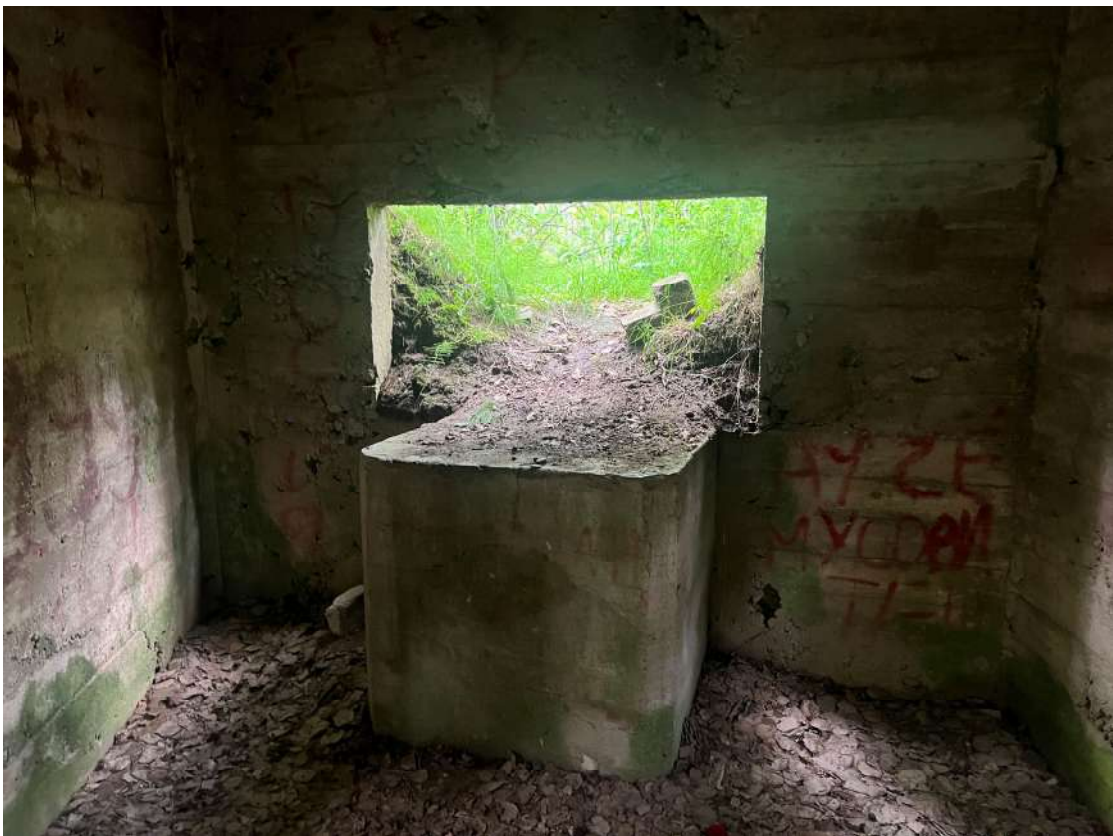
Фото 83. Пулеметный ДОТ. Внутренняя часть. Биопоражения, следы систематического намокания, антропогенные загрязнения. Дата съемки: июнь 2025. Автор: Козлова Е.М.
