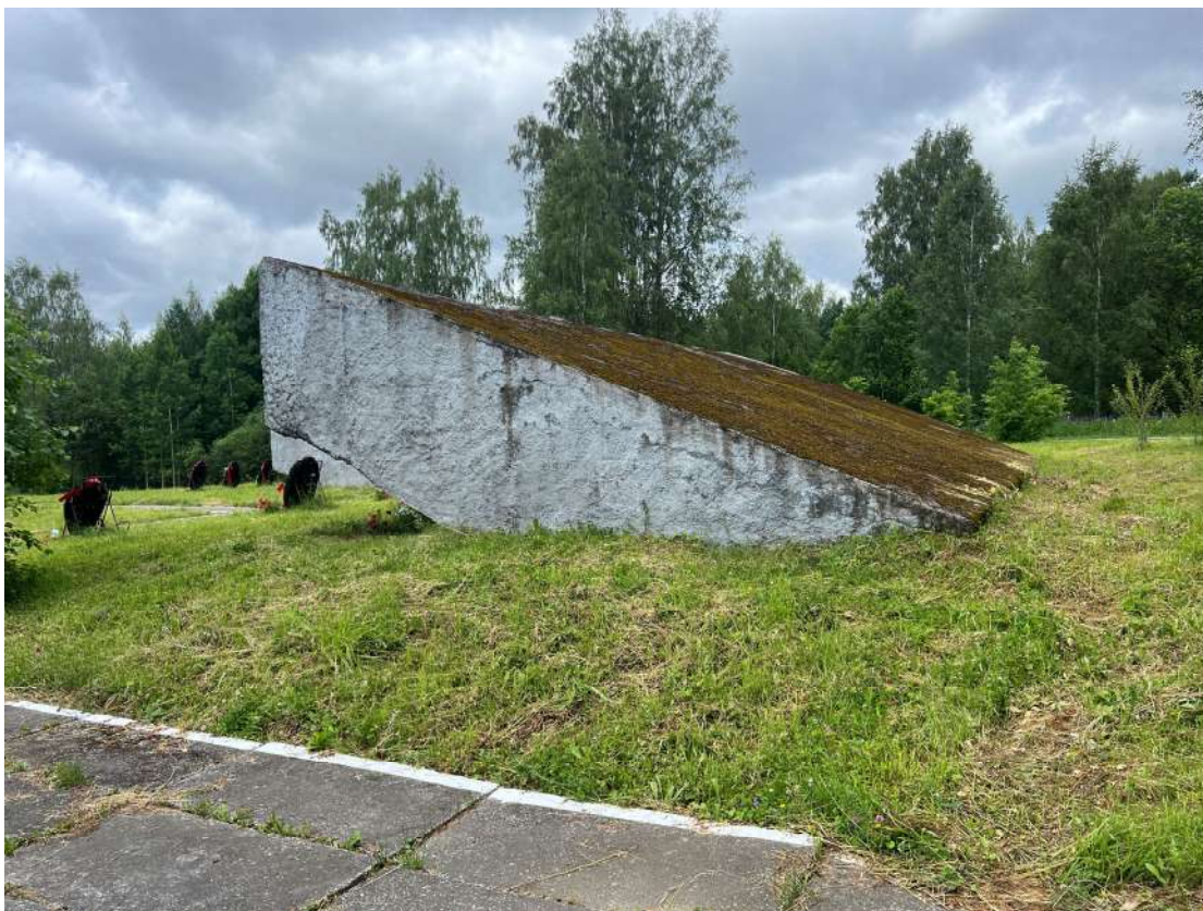
Фото 42. Горизонтальный пилон. Деструкция наружного слоя бетона, трещины, следы множественных окрасов, шелушение красочного слоя, биопоражения, деструкция кровельного покрытия, антропогенные загрязнения. Дата съемки: июнь 2025. Автор: Козлова Е.М.
