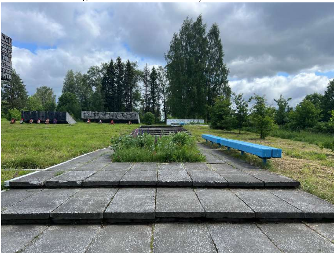
Фото 21. Территория объекта. Деревянные скамьи – крены, трещины, шелушение красочного слоя. Цветник – зарастание самосевными растениями. Лестница – биопоражения, просадки, трещины, деструкция наружного слоя бетона, сколы, множественные окрасы, шелушение красочного слоя. Дата съемки: июнь 2025. Автор: Козлова Е.М.
