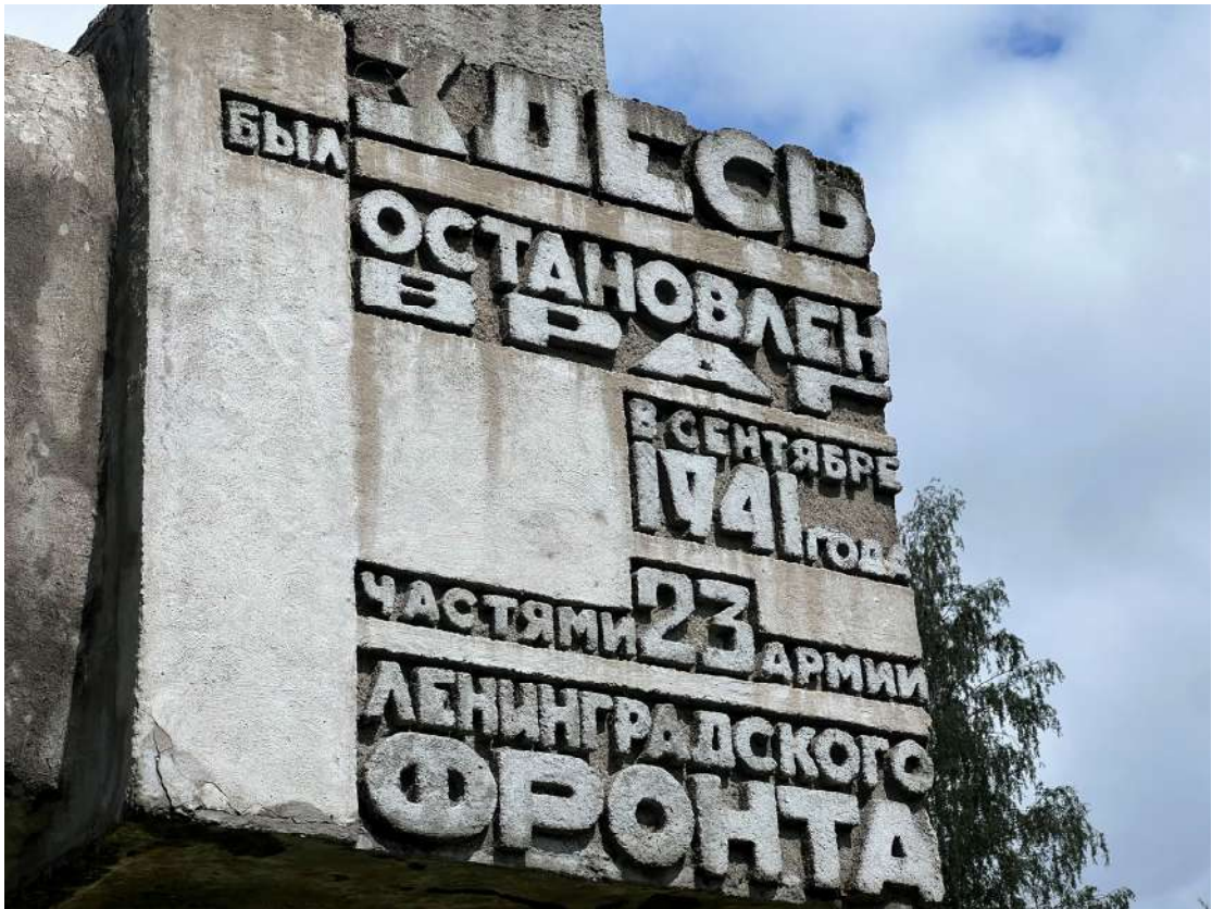
Фото 22. Вертикальная стела, фрагмент. Деструкция наружного слоя бетона, трещины, следы систематического намокания, следы высолов. Дата съемки: июнь 2025. Автор: Козлова Е.М.
