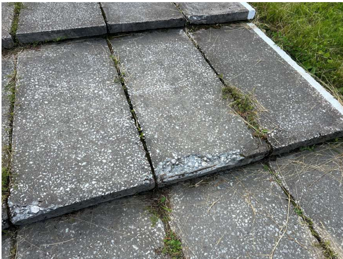
Фото 12. Пешеходная дорожка из бетонных плит, фрагмент. Биопоражения, просадки, трещины, деструкция наружного слоя бетона, сколы, множественные окрасы, шелушение красочного слоя. Дата съемки: июнь 2025. Автор: Козлова Е.М.
