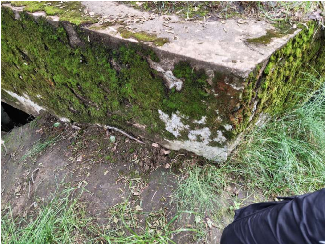
Фото 90. Пулеметный ДОТ. Биопоражения, следы систематического намокания, деструкция внешнего слоя бетона. Дата съемки: июнь 2025. Автор: Козлова Е.М.
