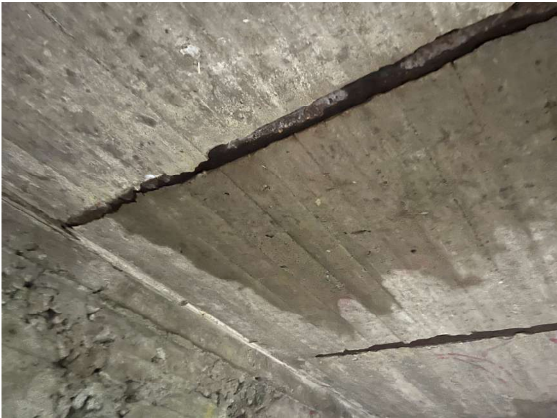
Фото 84. Пулеметный ДОТ. Внутренняя часть, перекрытие. Биопоражения, следы систематического намокания, следы коррозии металлических балок, деструкция внешнего слоя бетона. Дата съемки: июнь 2025. Автор: Козлова Е.М.
