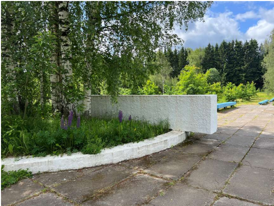
Фото 40. Горизонтальная стела. Деструкция наружного слоя бетона, следы множественных окрасов, шелушение красочного слоя, антропогенные загрязнения. Дата съемки: июнь 2025. Автор: Козлова Е.М.
