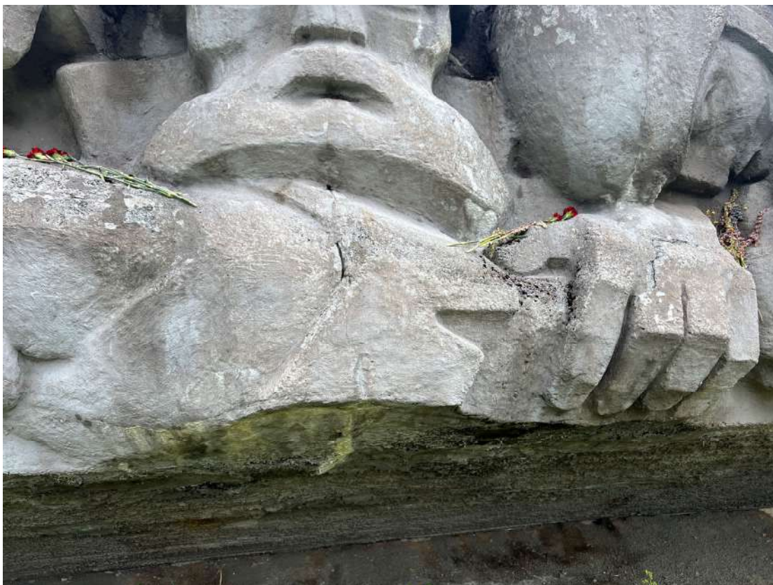
Фото 59. Горизонтальный пилон, горельеф. Фрагмент. Деструкция наружного слоя бетона, трещины, следы множественных окрасов, шелушение красочного слоя, биопоражения, следы высолов. Дата съемки: июнь 2025. Автор: Козлова Е.М.
