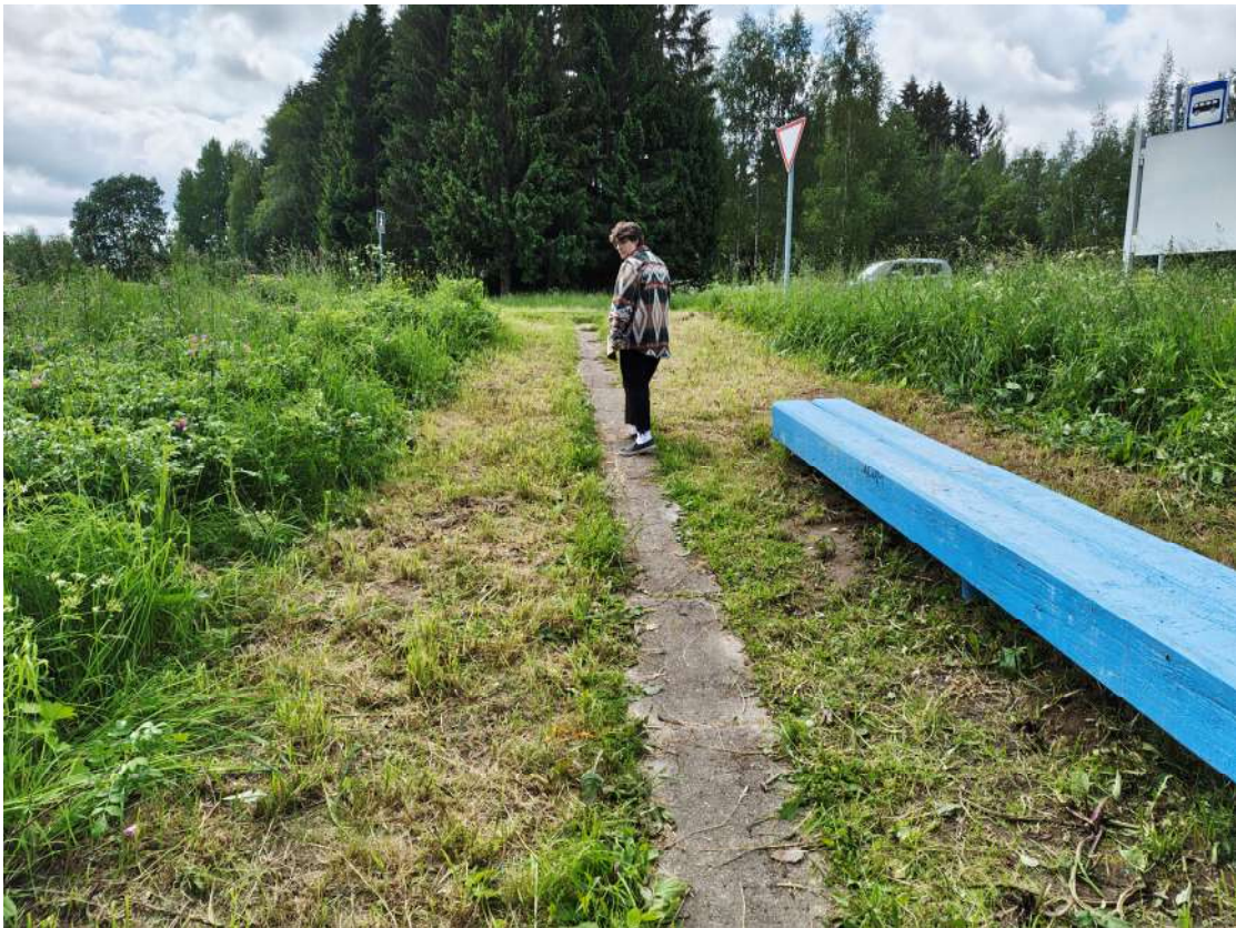
Фото 76. Территория объекта. Пешеходная дорожка к орудю – биопоражения, просадки, трещины, деструкция наружного слоя бетона. Деревянные скамьи – крены, трещины, шелушение красочного слоя. Цветник – зарастание самосевными растениями. Дата съемки: июнь 2025. Автор: Козлова Е.М.
