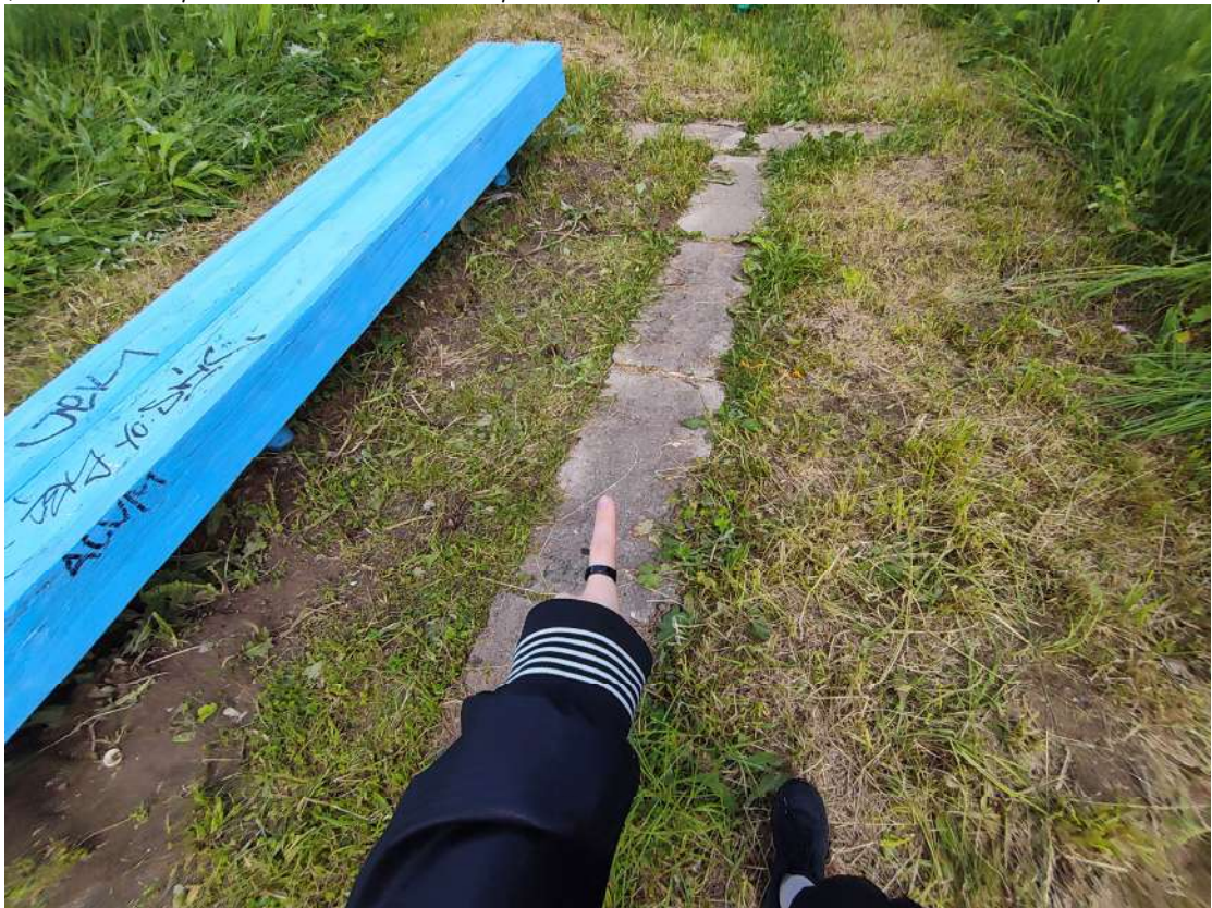
Фото 77. Территория объекта. Пешеходная дорожка к орудю – биопоражения, просадки, трещины, деструкция наружного слоя бетона. Деревянные скамьи – крены, трещины, шелушение красочного слоя. Цветник – зарастание самосевными растениями. Дата съемки: июнь 2025. Автор: Козлова Е.М.
