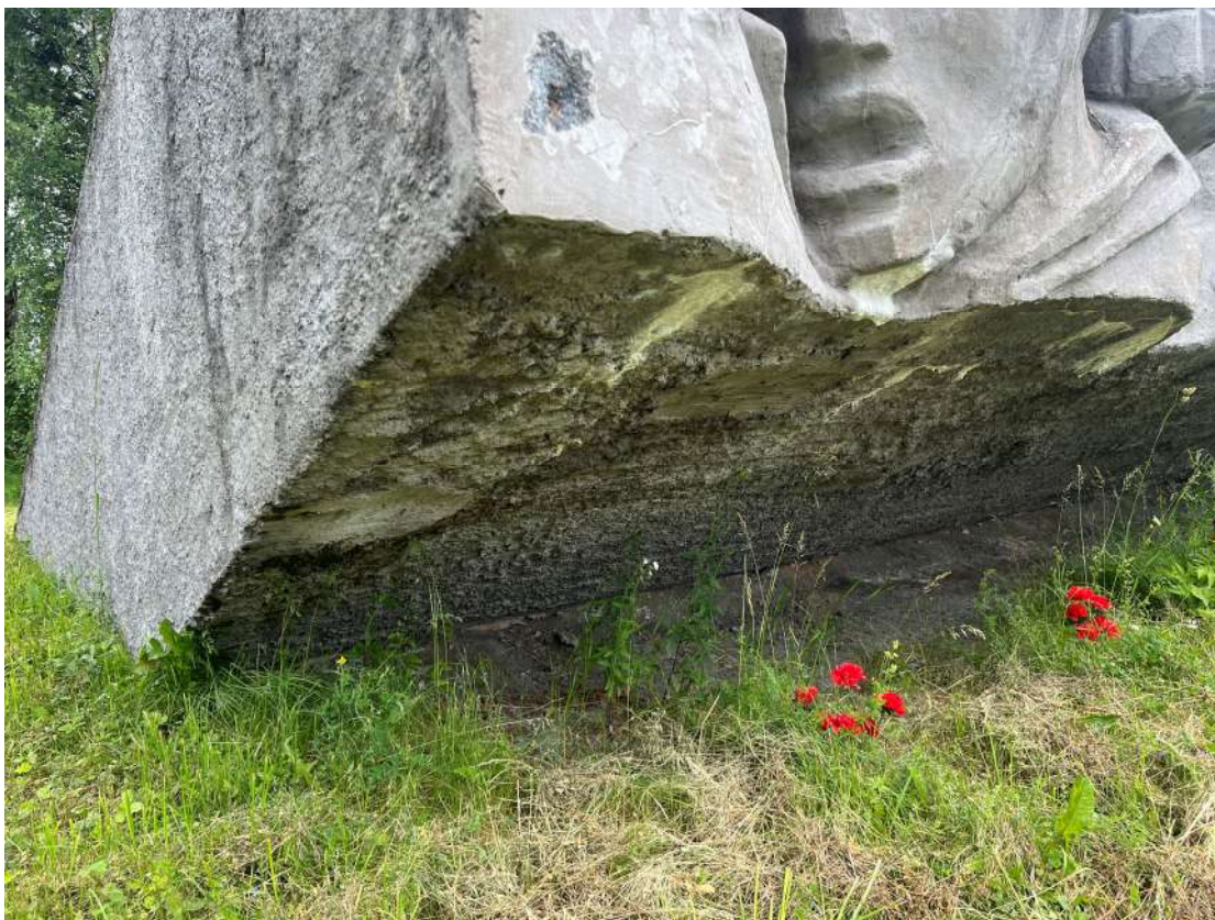
Фото 56. Горизонтальный пилон, горельеф. Фрагмент. Деструкция наружного слоя бетона, трещины, биопоражения, следы множественных окрасов, шелушение красочного слоя, следы высолов. Дата съемки: июнь 2025. Автор: Козлова Е.М.
