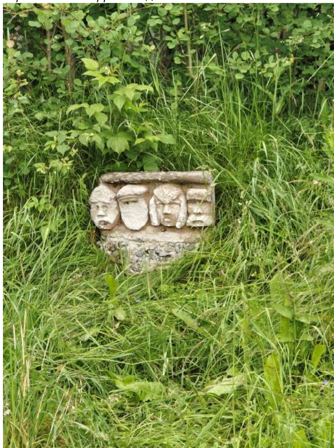
Фото 75. Памятник с горельефом. Утрата фрагментов, деструкция внешнего слоя бетона, деструкция каменной кладки. Дата съемки: июнь 2025. Автор: Козлова Е.М.
