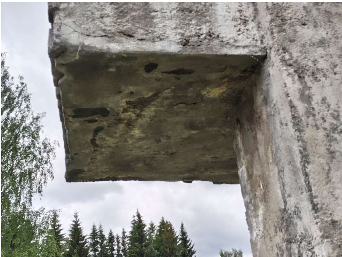
Фото 34. Вертикальная стела, фрагмент. Деструкция наружного слоя бетона, трещины, следы систематического намокания, следы высолов, следы продуктов коррозии арматуры, следы поздних ремонтов. Дата съемки: июнь 2025. Автор: Козлова Е.М.
