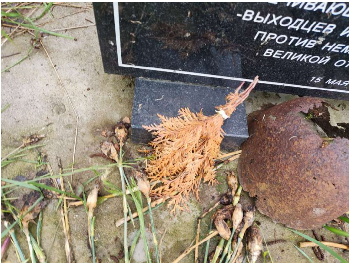
Фото 96. Мраморная памятная табличка. Бетонное основание, место крепления. Деструкция внешнего слоя бетона, биопоражения, следы систематического намокания. Дата съемки: июнь 2025. Автор: Козлова Е.М.
