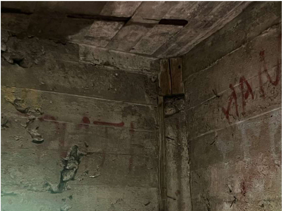
Фото 86. Пулеметный ДОТ. Внутренняя часть. Биопоражения, следы систематического намокания, антропогенные загрязнения, следы коррозии металлических балок, деструкция внешнего слоя бетона. Дата съемки: июнь 2025. Автор: Козлова Е.М.
