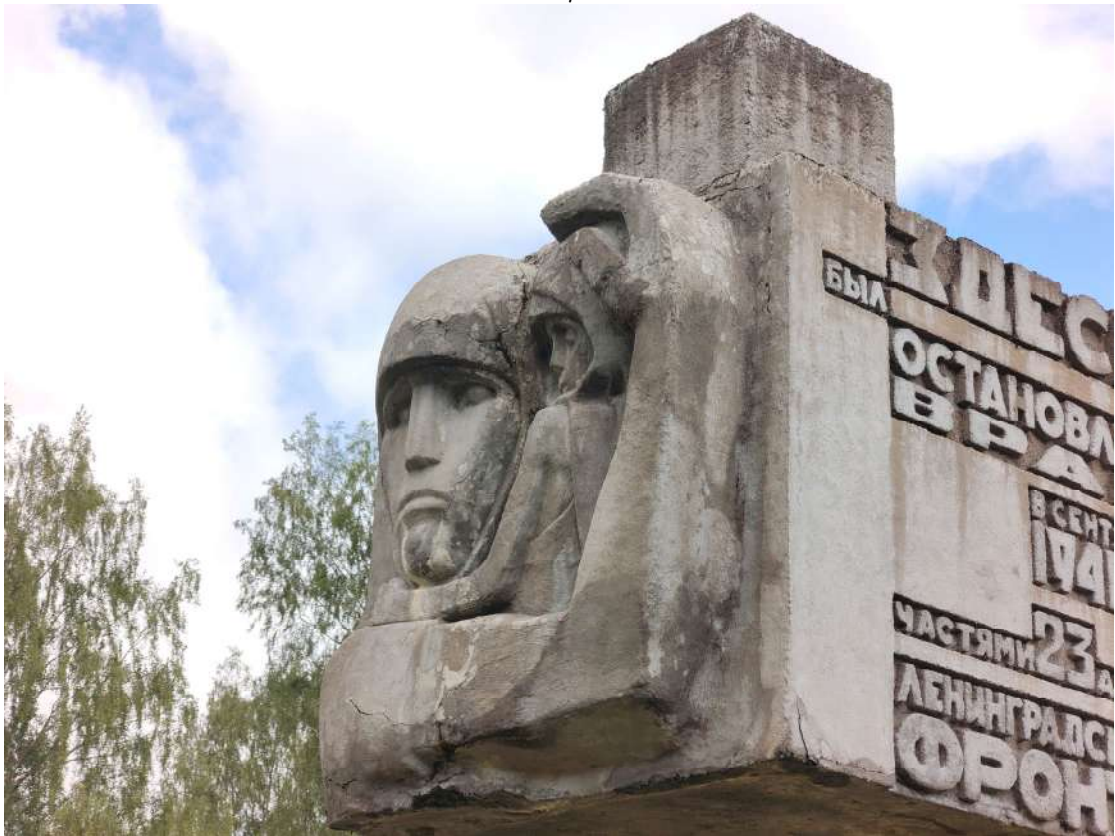
Фото 29. Вертикальная стела, фрагмент. Деструкция наружного слоя бетона, трещины, следы систематического намокания, следы высолов, следы поздних ремонтов. Дата съемки: июнь 2025. Автор: Козлова Е.М.
