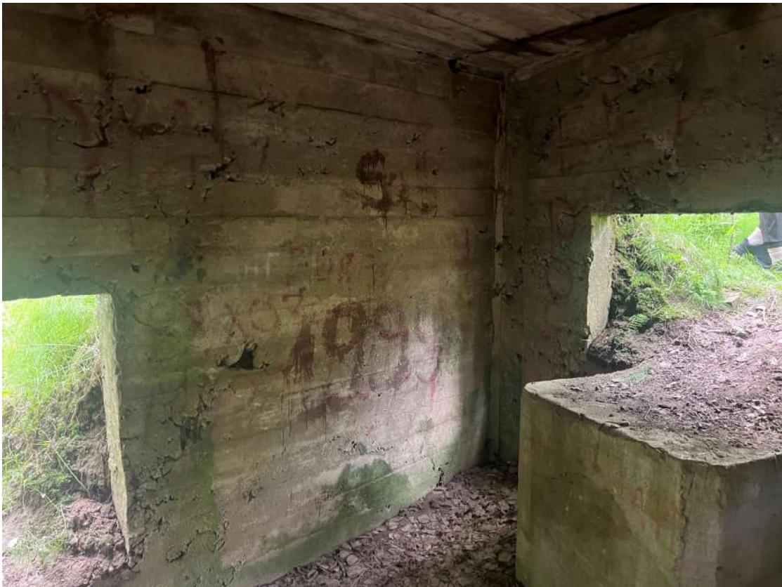
Фото 88. Пулеметный ДОТ. Внутренняя часть. Биопоражения, следы систематического намокания, антропогенные загрязнения, следы коррозии металлических балок, деструкция внешнего слоя бетона. Дата съемки: июнь 2025. Автор: Козлова Е.М.
