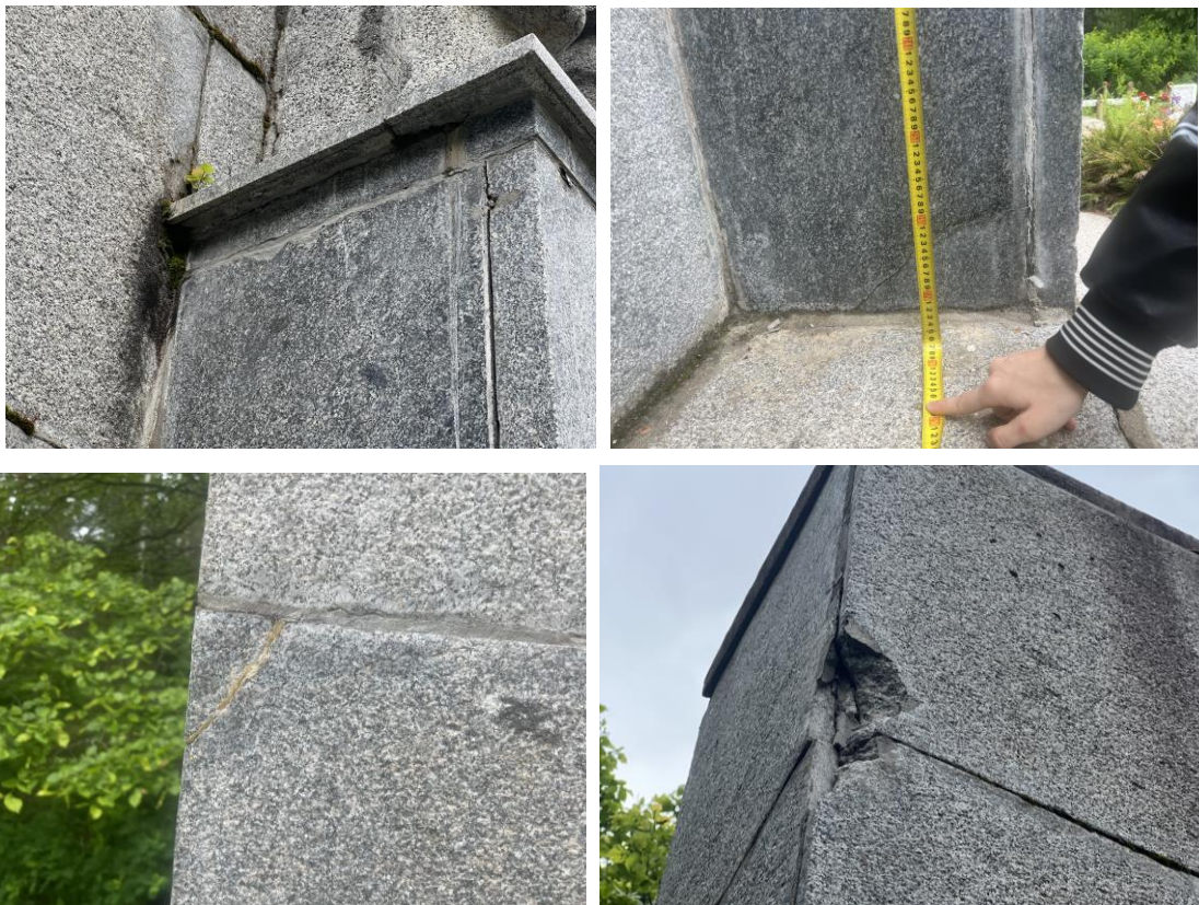
Фото 11 Стела. Гранитная отделка: сколы, антропогенные загрязнения, поздние домастиковки. Дата съемки: июнь 2025. Автор Сидоркина А.А.
