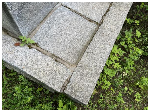
Фото 8 Основание стелы. Биопоражения, антропогенные загрязнения, деструкция шовного раствора, поздние домастиковки швов. Дата съемки: июнь 2025. Автор: Шатунова Л.А.
