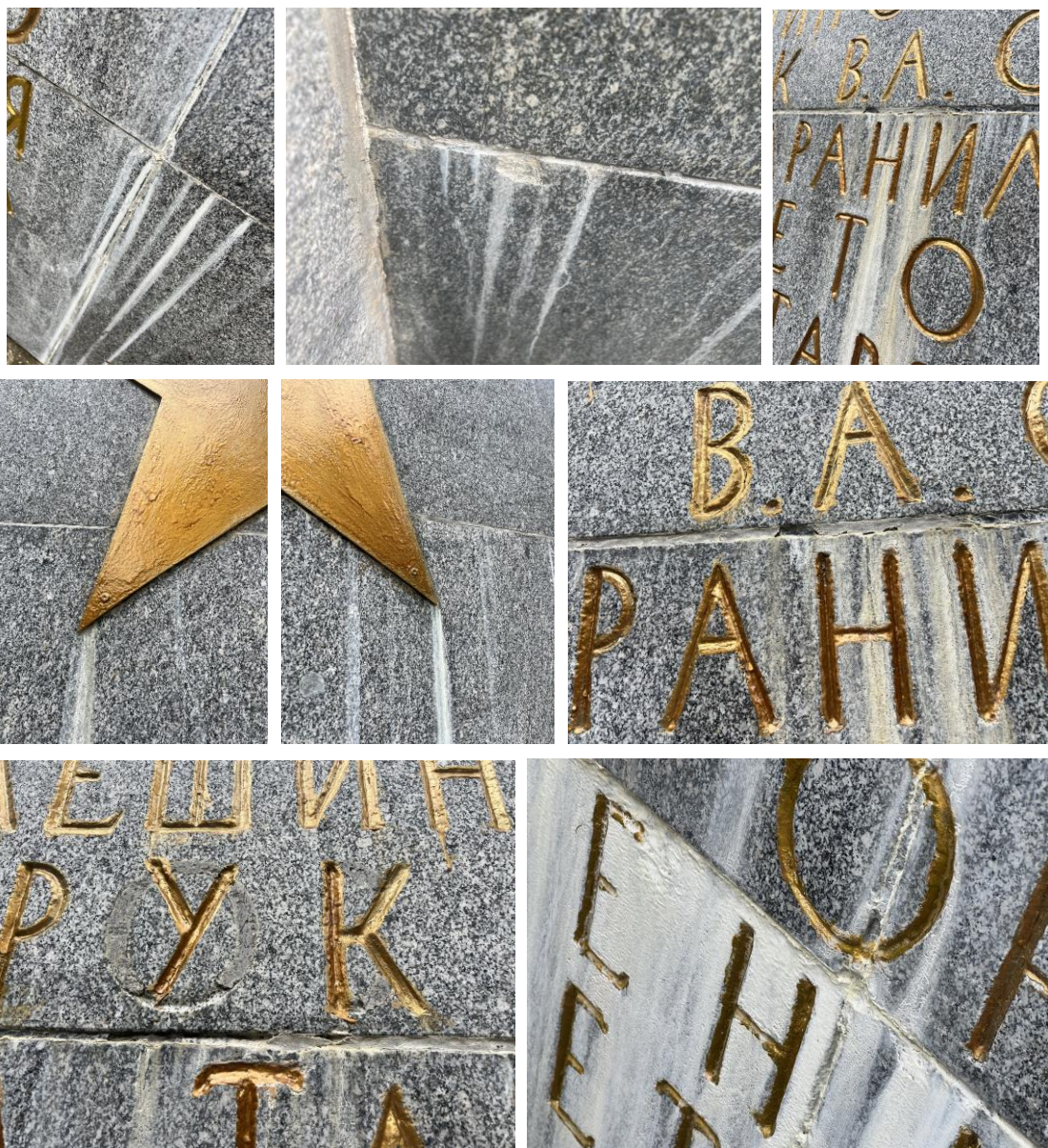
Фото 13 Отделка стелы. Высолы, антропогенные загрязнения, поздние домастиковки. Дата съемки: июнь 2025. Автор: Сидоркина
