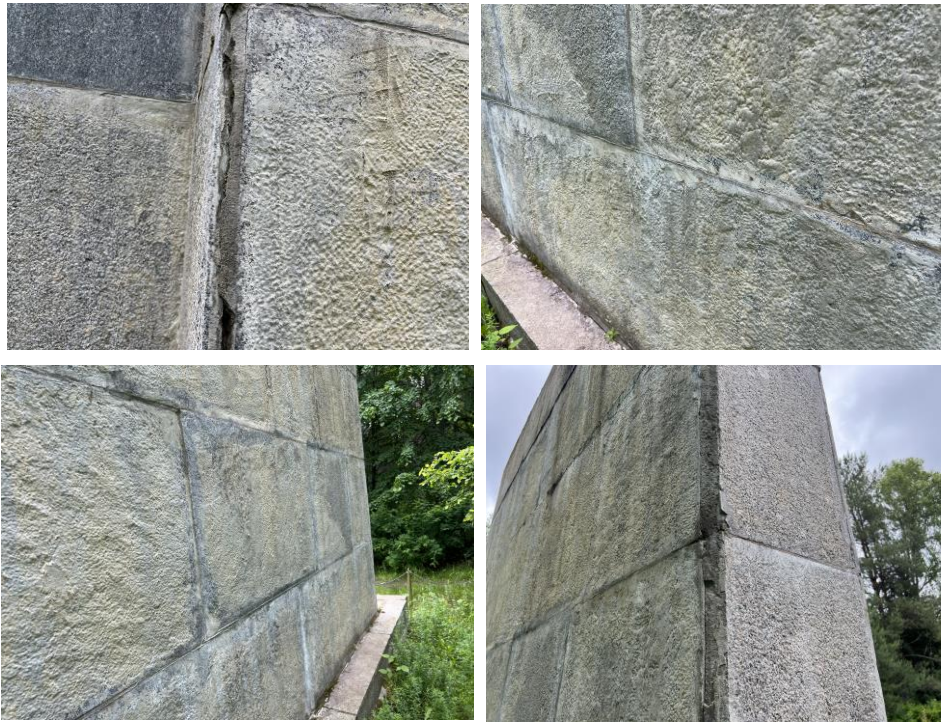
Фото 10 Стела. Обратная сторона: высолы, деструкция шовного раствора, антропогенные загрязнения. Дата съемки: июнь 2025. Автор: Сидоркина А.А.
