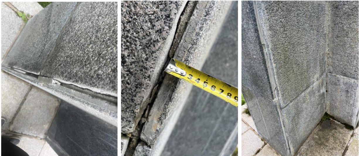
Фото 12 Отделка стелы. Деструкция шовного раствора, антропогенные загрязнения, биопоражения. Дата съемки: июнь 2025. Автор: Сидоркина А.А.
