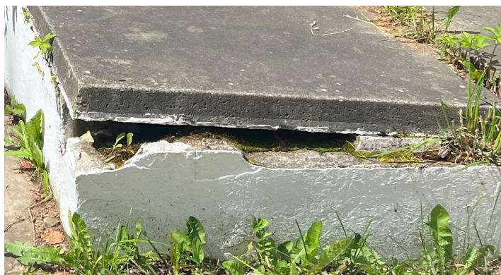
Фото 15 Подпорная стенка. Вывалы и разрушения бетонных блоков. Дата съемки: июнь 2025. Автор Сидоркина А.А.
