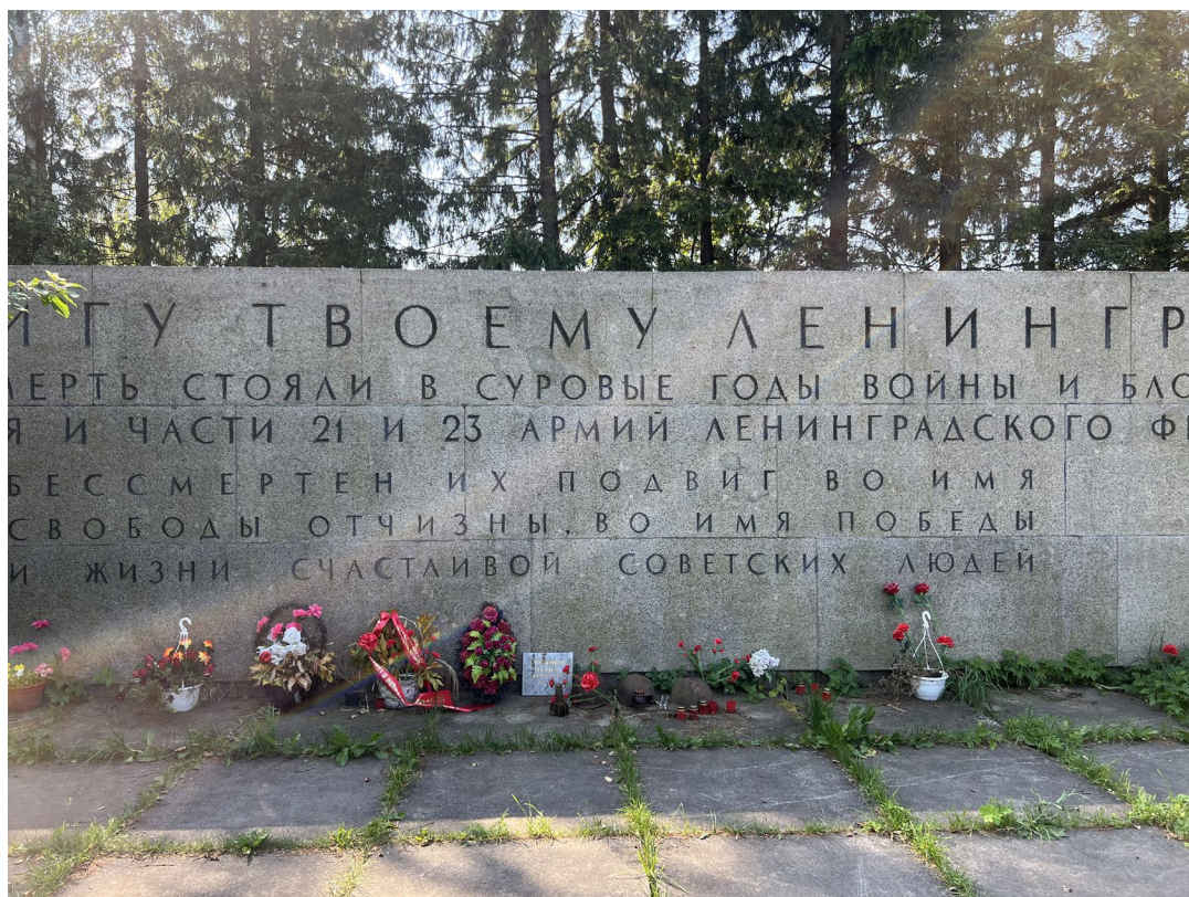
Фото 12 Стела, вид на лицевую сторону. Следы биопоражений и антропогенных загрязнений. Дата съемки: июнь 2025. Автор Сидоркина А.А.
