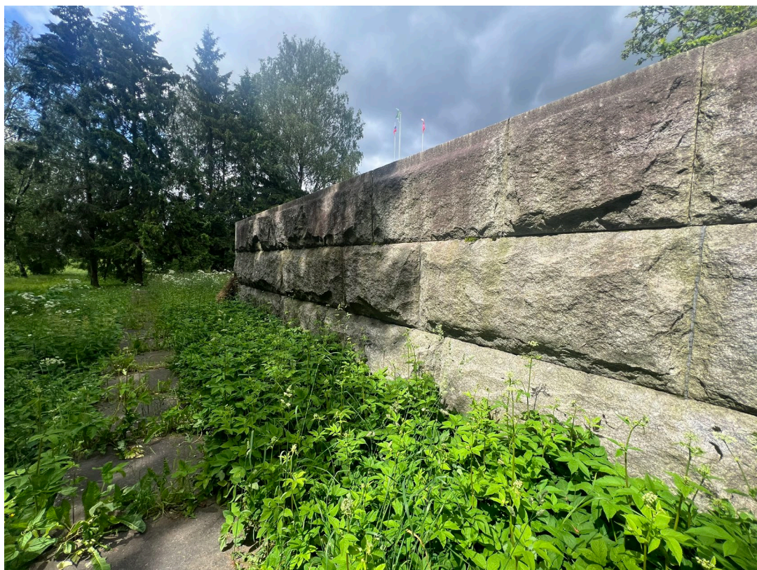
Фото 13 Стела, вид на обратную сторону. Следы биопоражений и антропогенных загрязнений. Дата съемки: июнь 2025. Автор Сидоркина А.А.
