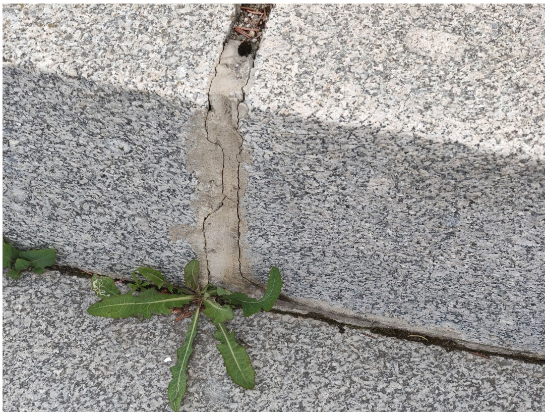
Фото 11 Ступени к стеле. Докомпоновка разрушенных швов. Дата съемки: июнь 2025. Автор: Шатунова Л.А.
