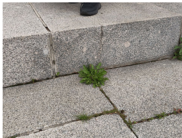
Фото 12 Ступени к стеле. Биопоражения, антропогенные загрязнения, прорастание самосевных растений. Дата съемки: июнь 2025. Автор: Шатунова Л.А.
