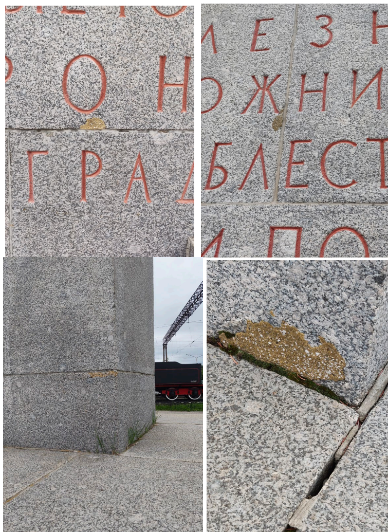
Фото 9 Стела. Следы поздних докомпоновок, антропогенные загрязнения. Дата съемки: июнь 2025. Автор: Шатунова Л.А.
