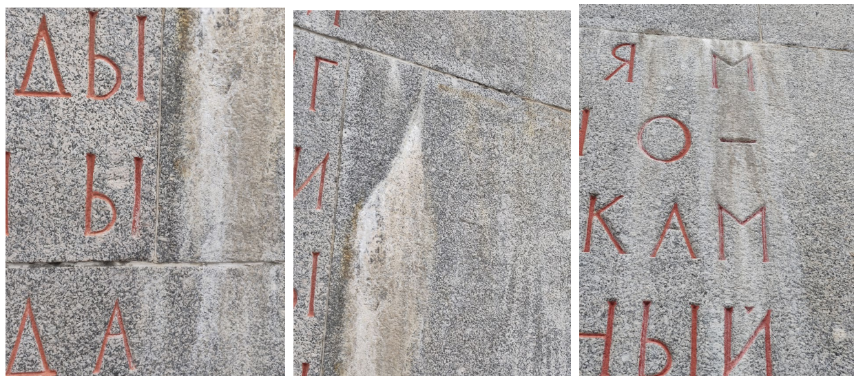
Фото 10 Стела. Следы высолов и антропогенных загрязнений. Дата съемки: июнь 2025. Автор: Шатунова Л.А.
