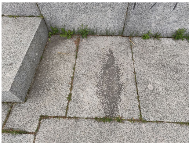
Фото 12 Ступени к стеле. Биопоражения, антропогенные загрязнения, прорастание самосевных растений. Дата съемки: июнь 2025. Автор: Шатунова Л.А.
