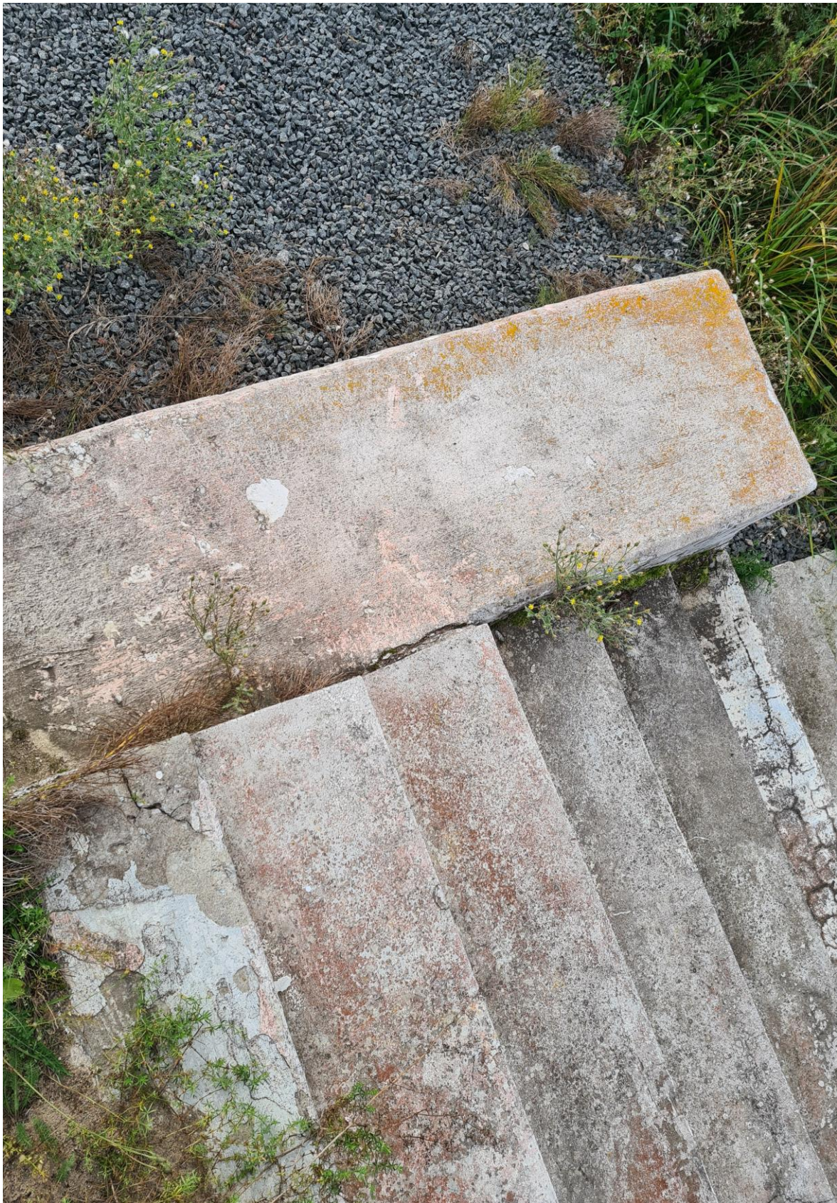
Фото 25. Вид на западный лестничный марш и подпорную стенку. На горизонтальных поверхностях наблюдаются многочисленные следы биопоражений, утраты красочного слоя, деструкция штукатурного слоя, самосевная растительность, присутствуют трещины на бетонном основании ступеней. Дата съемки: июнь 2025. Автор: Шатунова Л.А.
