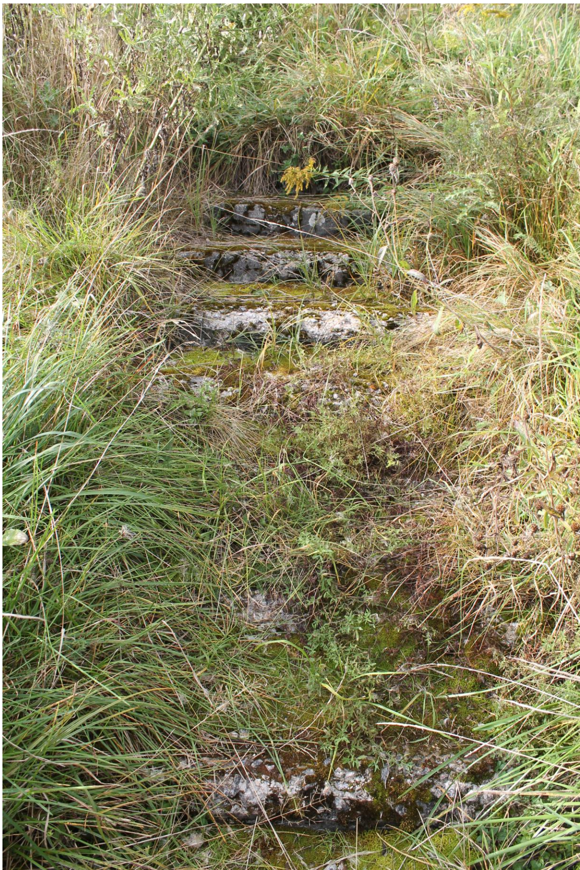
Фото 43. Вид на нижний южный марш с юго-восточной стороны. Наблюдаются трещины, сколы, каверны, деструкция бетона, следы биопоражений и самосевная растительность. Дата съемки: июнь 2025. Автор: Шатунова Л.А.
