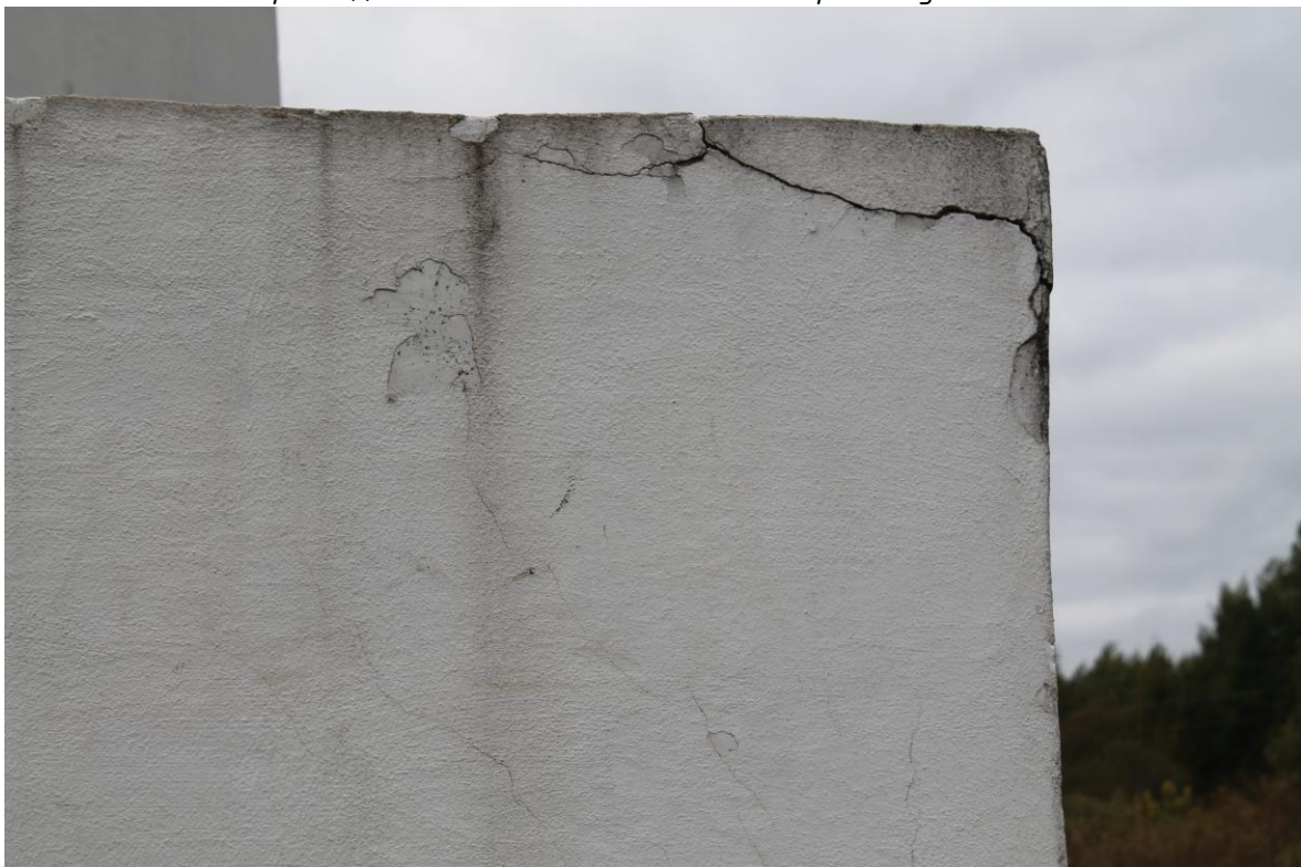
Фото 36. Вид восточный угол юго-восточной стены с юго-восточной стороны. Наблюдаются трещины, следы биопоражений, утраты красочного слоя. Дата съемки: июнь 2025. Автор: Шатунова Л.А.
