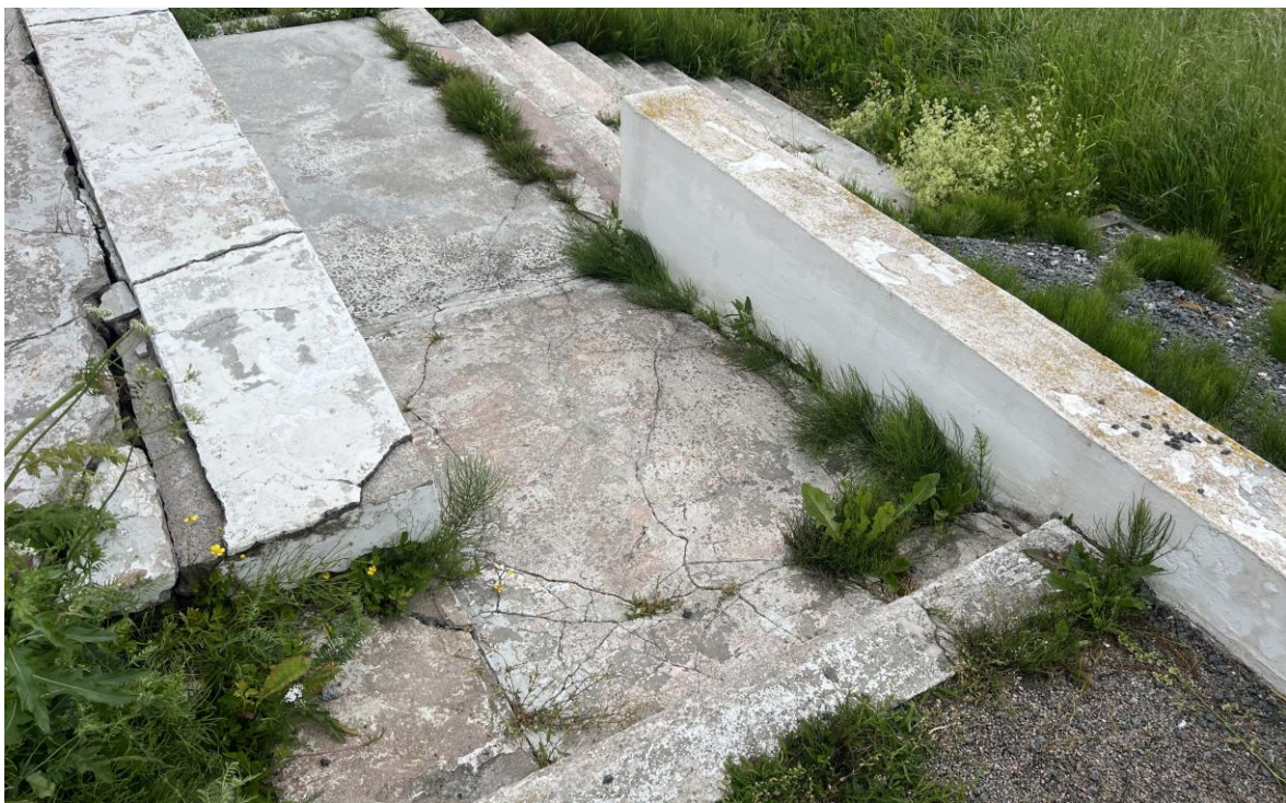
Фото 17. Вид на юго-восточный пандус и лестничные марши с северной стороны. На поверхности площадки и пандуса наблюдаются многочисленные сколы, трещины, каверны, утраты красочного слоя, следы биопоражений и антропогенных загрязнений, на поверхности стен присутствуют деструкция штукатурного слоя, трещины и биопоражения. Дата съемки: июнь 2025. Автор: Шатунова Л.А.
