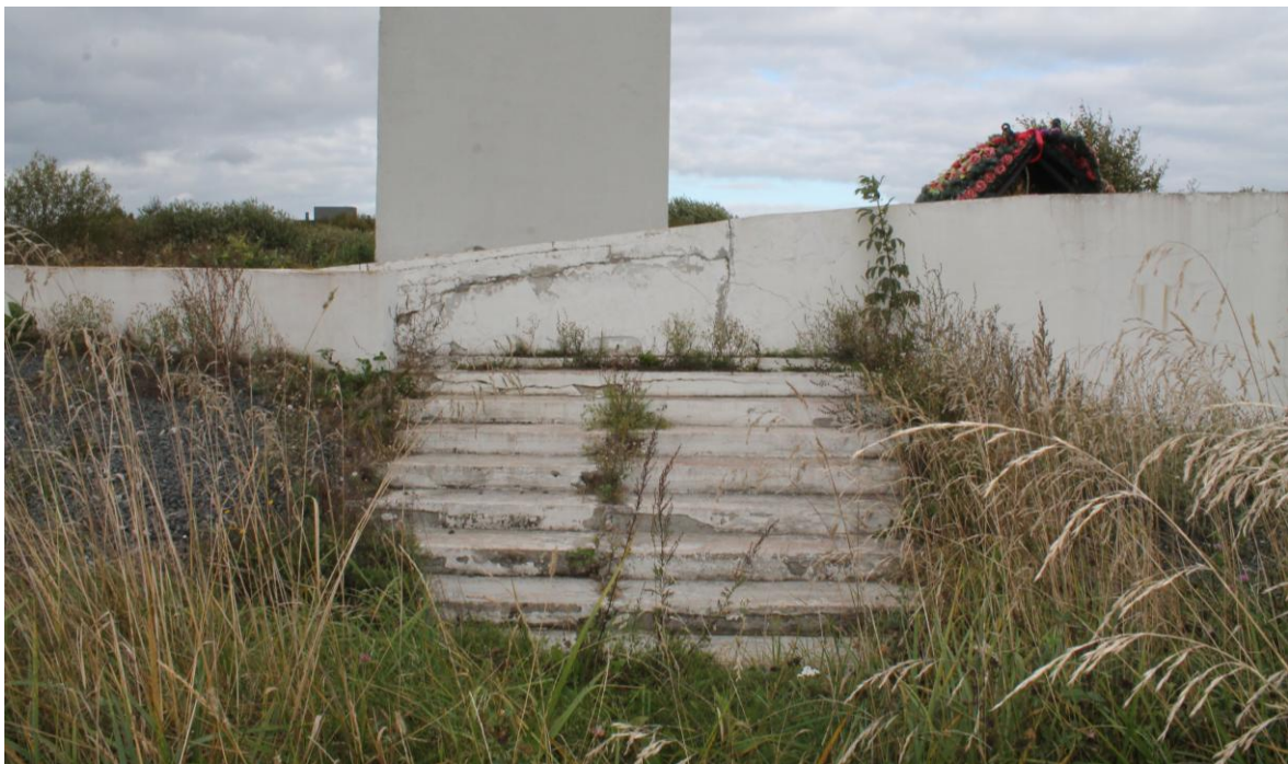
Фото 22. Вид на юго-западный лестничный марш с юго-западной стороны. Наблюдаются деструкция и утраты штукатурного слоя ступеней, многочисленные следы биопоражений, на поверхности бетонного основания ступеней присутствуют сколы и каверны, следы антропогенных загрязнений, самосевная растительность, на поверхности стен наблюдаются трещины и утраты красочного слоя. Дата съемки: июнь 2025. Автор: Шатунова Л.А.
