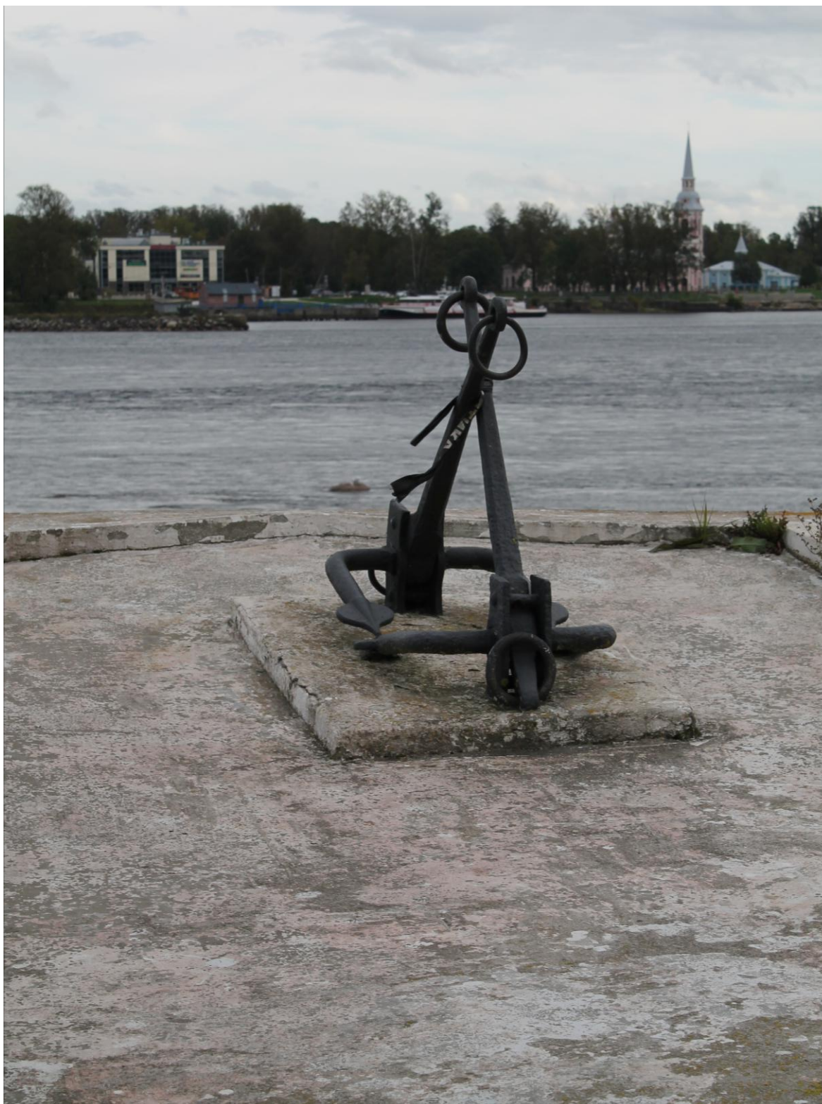
Фото 14. Вид на металлические якоря с северо-восточной стороны. Наблюдаются следы коррозии на поверхности металла, утраты красочного слоя, следы биопоражений у основания якорей, самосевная растительность в углах площадки памятника. Дата съемки: июнь 2025. Автор: Шатунова Л.А.
