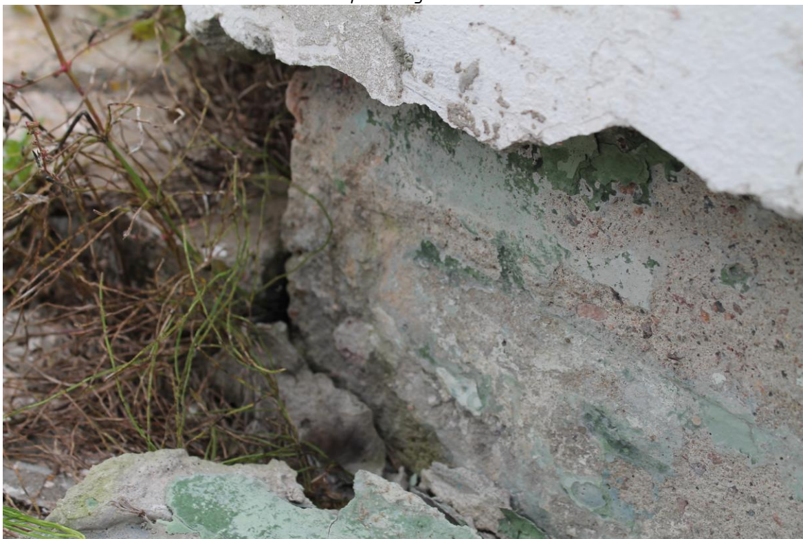
Фото 39. Вид на юго-западный угол основания стены с юго-западной стороны. Наблюдается деструкция штукатурного слоя, деструкция бетонного основания, следу биопоражений, лакокрасочных загрязнений и самосевная растительность. Дата съемки: июнь 2025. Автор: Шатунова Л.А.
