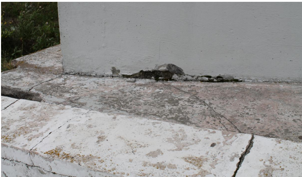
Фото 38. Вид на западный угол основания стелы с юго-западной стороны. На поверхности стелы у основания наблюдаются деструкция цементной штукатурки, незначительные утраты красочного слоя, на поверхности площадки наблюдаются многочисленные следы биопоражений, трещины у основания стелы, сколы и каверны. Дата съемки: июнь 2025. Автор: Шатунова Л.А.
