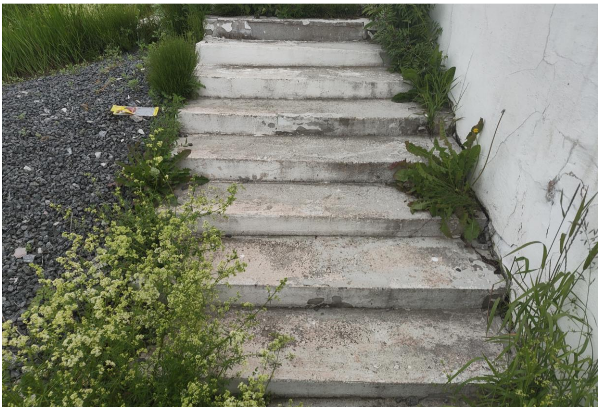
Фото 21. Вид на южный лестничный марш с юго-восточной стороны. Наблюдаются деструкция и утраты штукатурного слоя ступеней, многочисленные следы биопоражений, на поверхности бетонного основания ступеней присутствуют сколы и каверны, следы антропогенных загрязнений, самосевная растительность. Дата съемки: июнь 2025. Автор: Шатунова Л.А.
