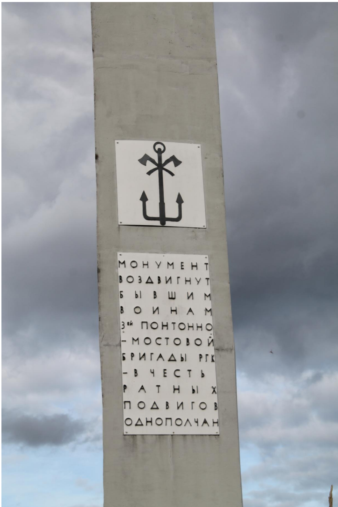
Фото 15. Вид на мемориальные доски с юго-западной стороны. Наблюдаются следы коррозии металла, незначительные изменения геометрии металлических листов. Дата съемки: июнь 2025. Автор: Шатунова Л.А.
