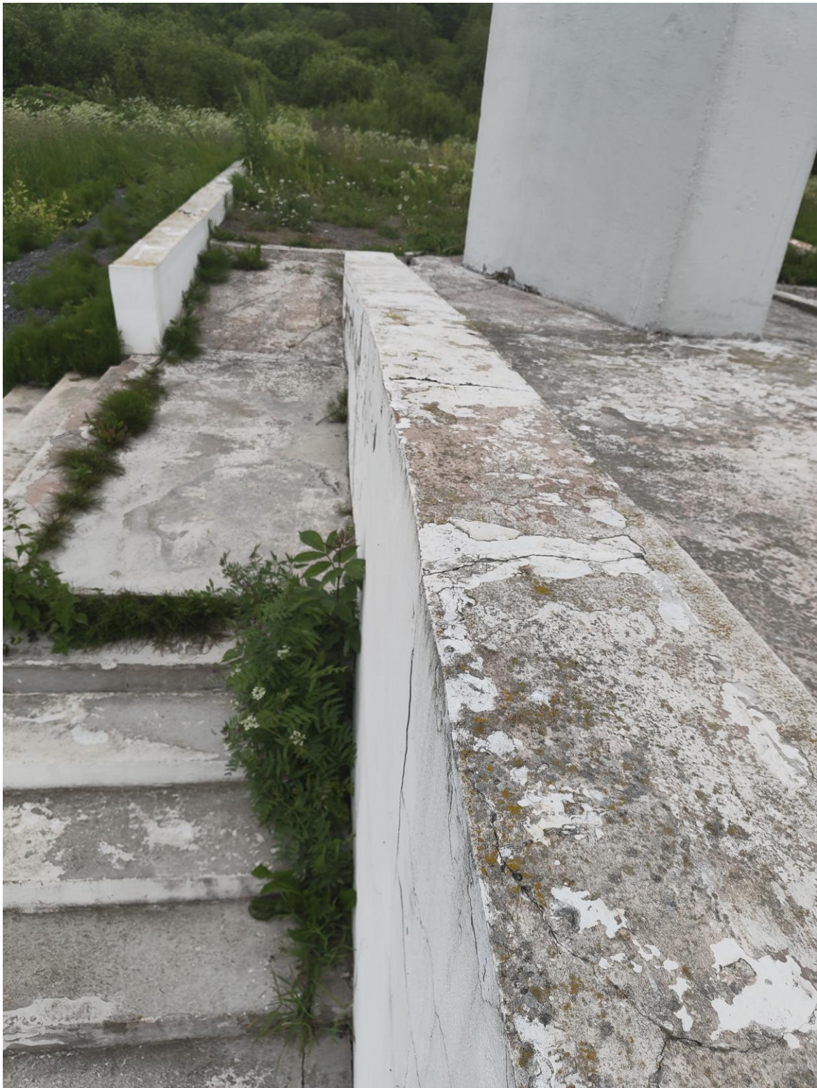
Фото 33. Вид на юго-западную стену, пандус и лестничные марши с юго-западной стороны. На горизонтальных поверхностях стены наблюдаются следы биопоражений, утраты красочного слоя, трещины и сколы, на вертикальных поверхностях – сколы, следы биопоражений. Дата съемки: июнь 2025. Автор: Шатунова Л.А.
