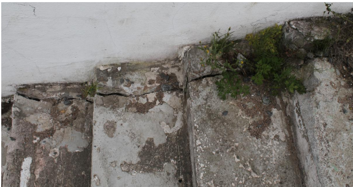
Фото 28. Вид на примыкание восточного лестничного марша к стене с северо-восточной стороны. Наблюдаются значительные утраты штукатурного слоя, трещины в бетонном основании ступеней, также на поверхности основания ступеней присутствуют сколы и каверны, утраты красочного слоя, следы биопоражений, самосевная растительность. Дата съемки: июнь 2025. Автор: Шатунова Л.А.
