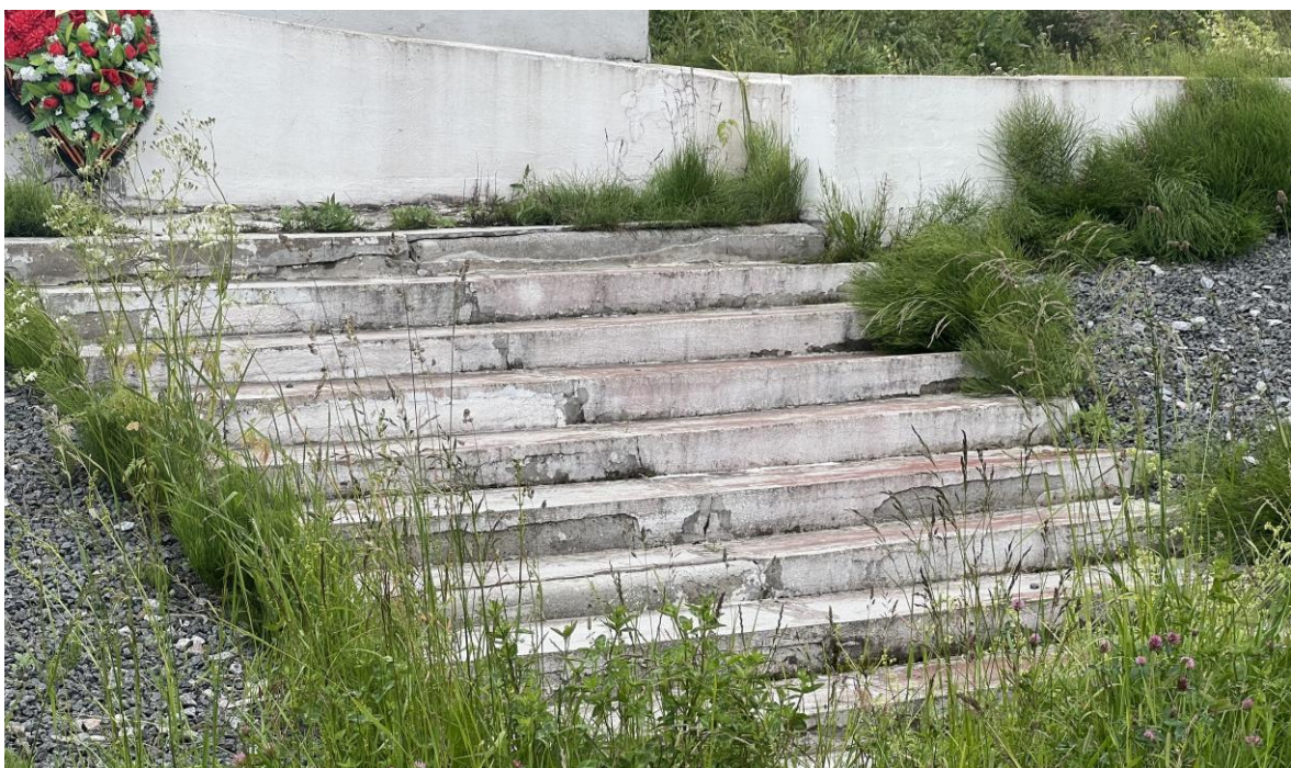
Фото 18. Вид на северо-восточный лестничный марш с восточной стороны. Наблюдаются деструкция и утраты штукатурного слоя ступеней, многочисленные следы биопоражений, на поверхности бетонного основания ступеней присутствуют сколы и каверны, следы антропогенных загрязнений, самосевная растительность. Дата съемки: июнь 2025. Автор: Шатунова Л.А.
