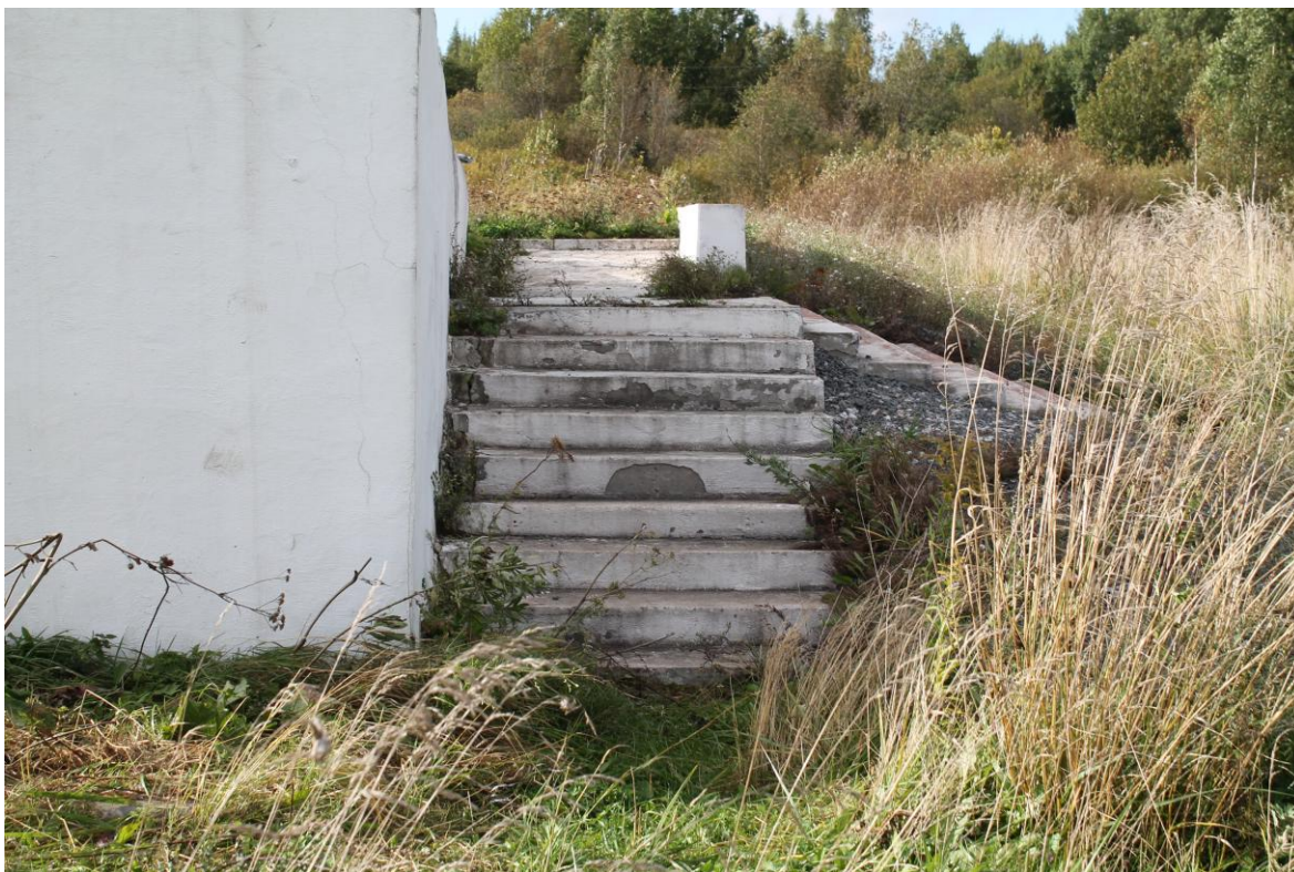
Фото 19. Вид на восточный лестничный марш с восточной стороны. Наблюдаются деструкция и утраты штукатурного слоя ступеней, многочисленные следы биопоражений, на поверхности бетонного основания ступеней присутствуют сколы и каверны, следы антропогенных загрязнений, самосевная растительность. Дата съемки: июнь 2025. Автор: Шатунова Л.А.
