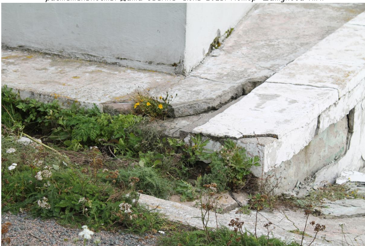
Фото 27. Вид на западный угол основания стелы с северо-восточной стороны. Наблюдается деструкция штукатурного слоя и бетонного основания памятника, следы многочисленных биопоражений, сколы и трещины, самосевная растительность. Дата съемки: июнь 2025. Автор: Шатунова Л.А.
