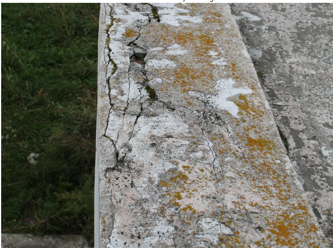
Фото 29. Вид на северо-восточную стену с северной стороны. Наблюдаются следы биопоражений, многочисленные трещины, утраты штукатурного слоя, утраты красочного слоя, сколы на гранях стены. Дата съемки: июнь 2025. Автор: Шатунова Л.А.
