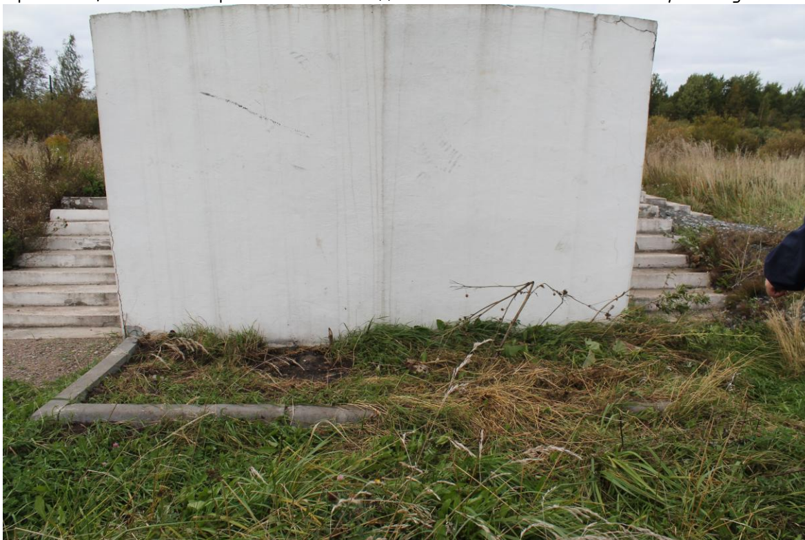
Фото 20. Вид на основание памятника и лестничные марши с юго-восточной стороны. На поверхности стены наблюдаются трещины, утраты штукатурного слоя, следы антропогенных загрязнений, биопоражения, шелушение красочного слоя, самосевная растительность у основания стены. Дата съемки: июнь 2025. Автор: Шатунова Л.А.
