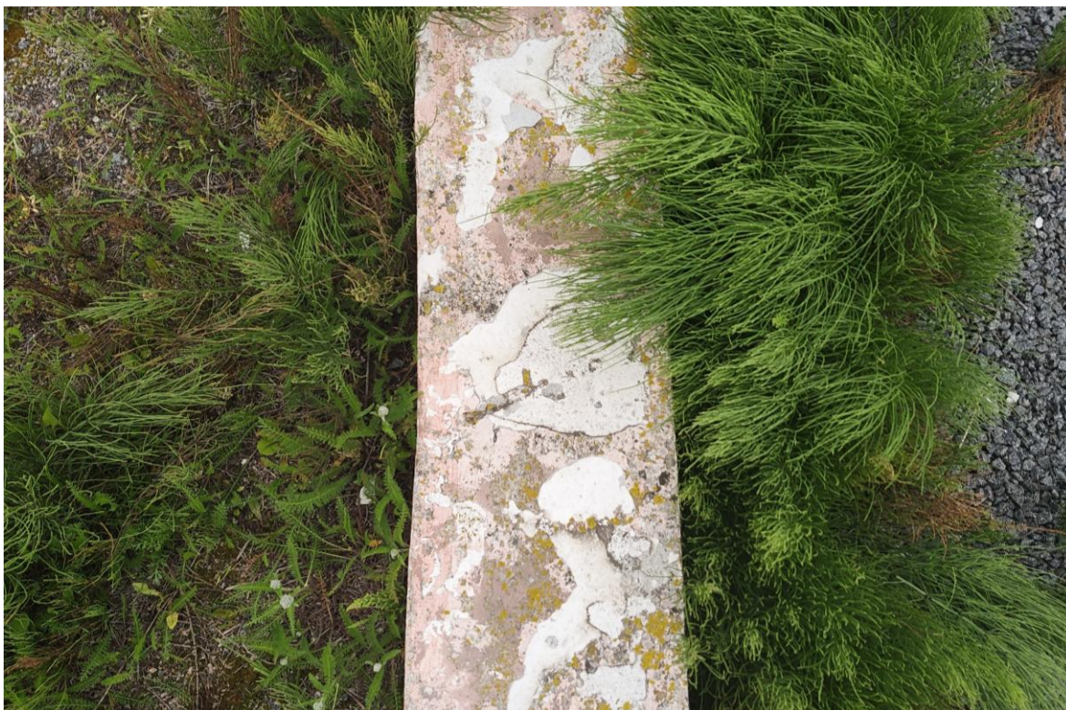
Фото 26. Вид на северо-восточную подпорную стенку с северо-восточной стороны. Наблюдаются многочисленные следы биопоражений, утраты красочного слоя, самосевная растительность. Дата съемки: июнь 2025. Автор: Шатунова Л.А.
