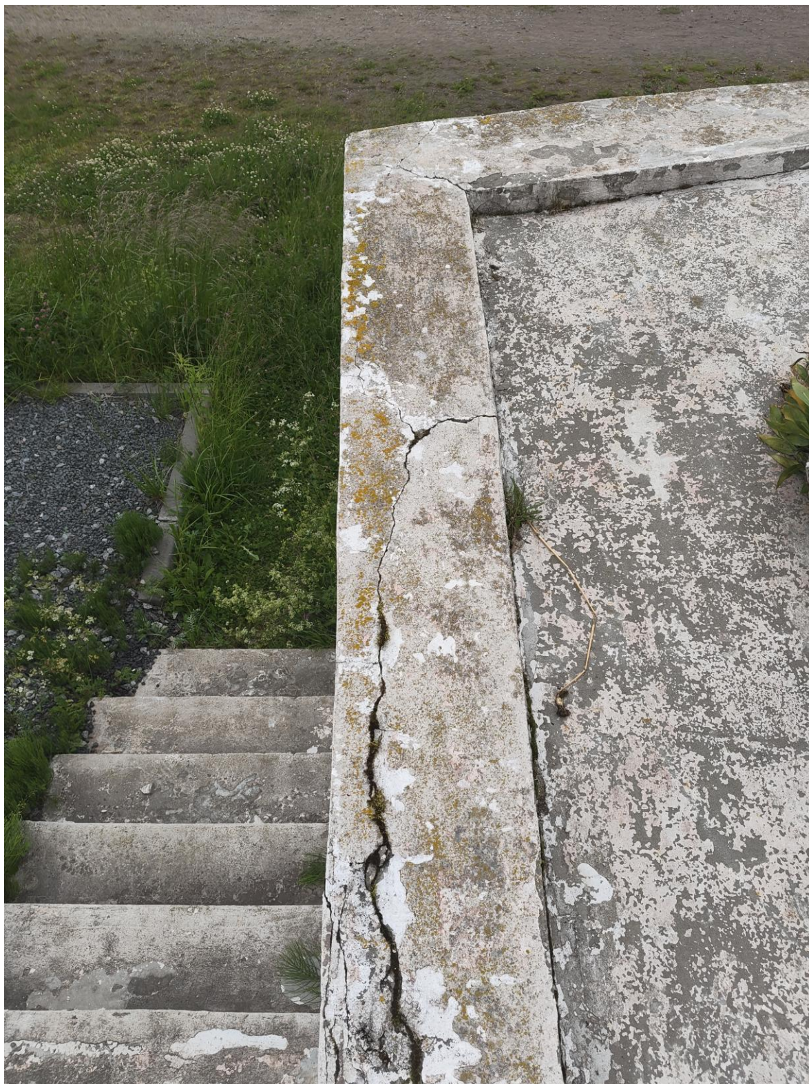
Фото 30. Вид восточный угол верхней площадки с северной стороны. Наблюдаются следы биопоражений, многочисленные трещины, утраты штукатурного слоя, утраты красочного слоя сколы на гранях стены, самосевная растительность на площадке. Дата съемки: июнь 2025. Автор: Шатунова Л.А.
