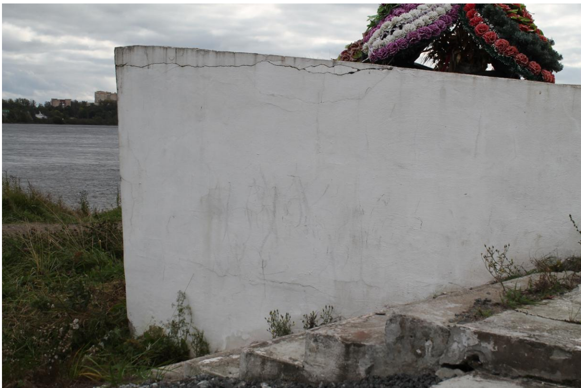
Фото 35. Вид на северо-восточную стену и лестничный марш с северной стороны. Наблюдаются следы биопоражений, антропогенных загрязнений, трещины штукатурного слоя, сколы на гранях, самосевная растительность в месте примыкания лестничного марша. Дата съемки: июнь 2025. Автор: Шатунова Л.А.
