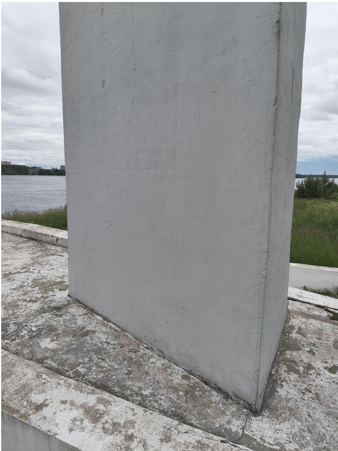
Фото 11. Вид на основание стелы с северо-западной стороны. На поверхности стелы у основания наблюдаются деструкция цементной штукатурки, незначительные утраты красочного слоя, на поверхности площадки наблюдаются многочисленные следы биопоражений, трещины у основания стелы, сколы и каверны, утраты красочного слоя, следы антропогенных загрязнений. Дата съемки: июнь 2025. Автор: Шатунова Л.А.
