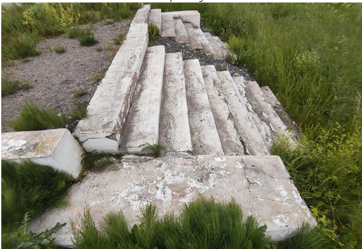
Фото 9. Вид на лестничные марши с северной стороны. Наблюдаются многочисленные сколы, трещины, следы биопоражений, деструкция цементной штукатурки, утраты красочного слоя, следы антропогенных загрязнений, самосевная растительность. Дата съемки: июнь 2025. Автор: Шатунова Л.А.
