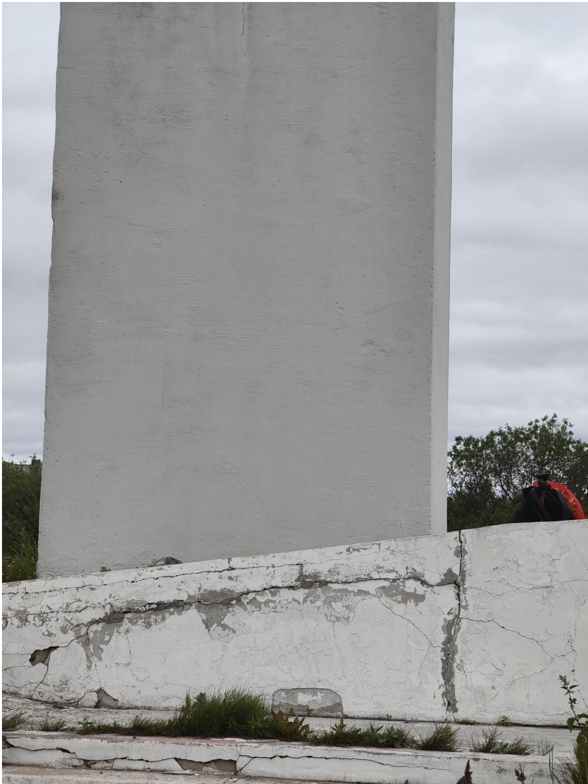
Фото 37. Вид на юго-западную стену с юго-западной стороны. На поверхности стены наблюдаются трещины, утраты штукатурного слоя, утраты и шелушение красочного слоя, сколы. Дата съемки: июнь 2025. Автор: Шатунова Л.А.
