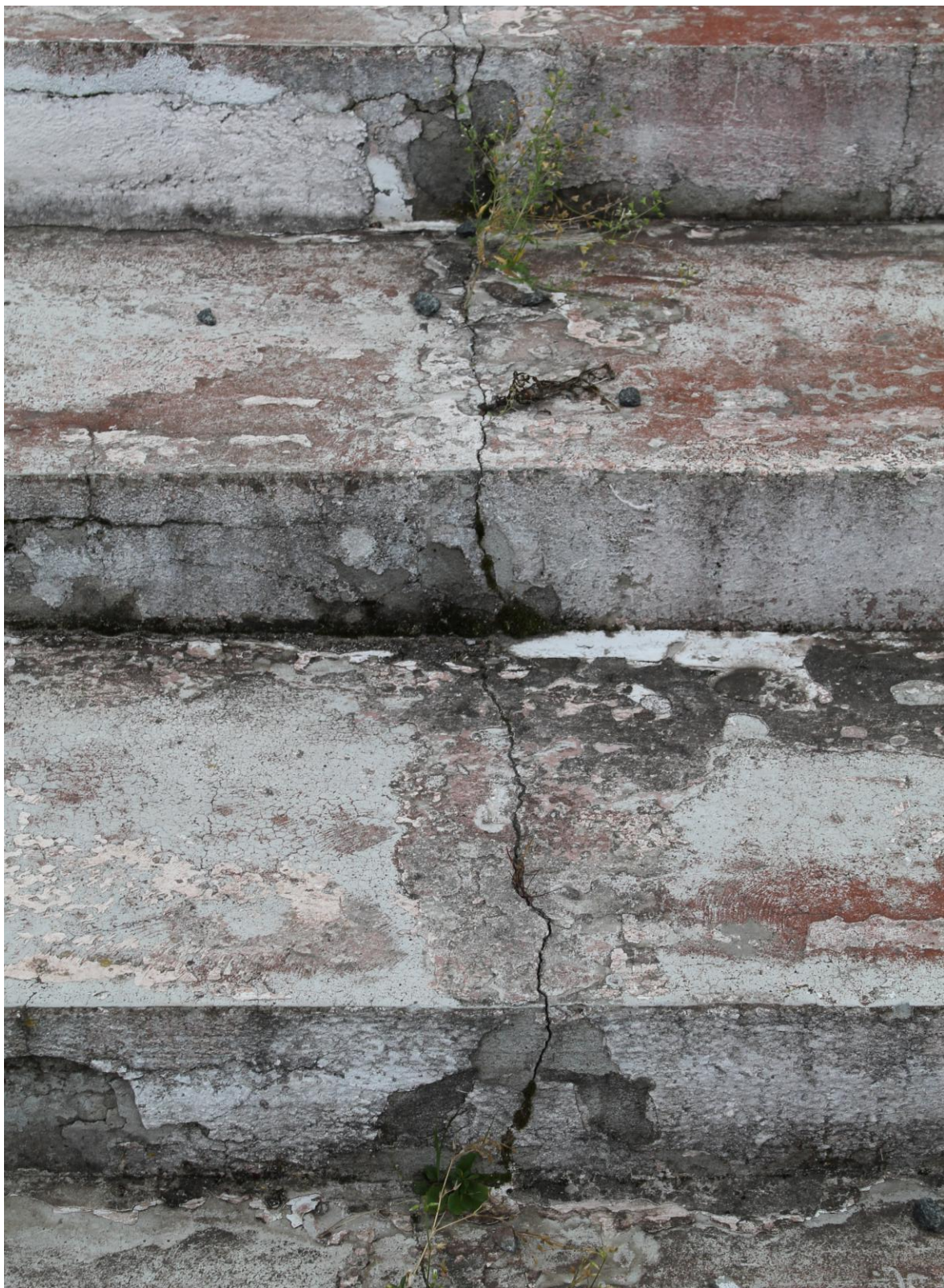
Фото 34. Вид на ступени северо-восточного лестничного марша с северо-восточной стороны. Наблюдаются утраты штукатурного слоя, утраты красочного слоя, трещины в бетонном основании ступеней, каверны и сколы. Дата съемки: июнь 2025. Автор: Шатунова Л.А.
