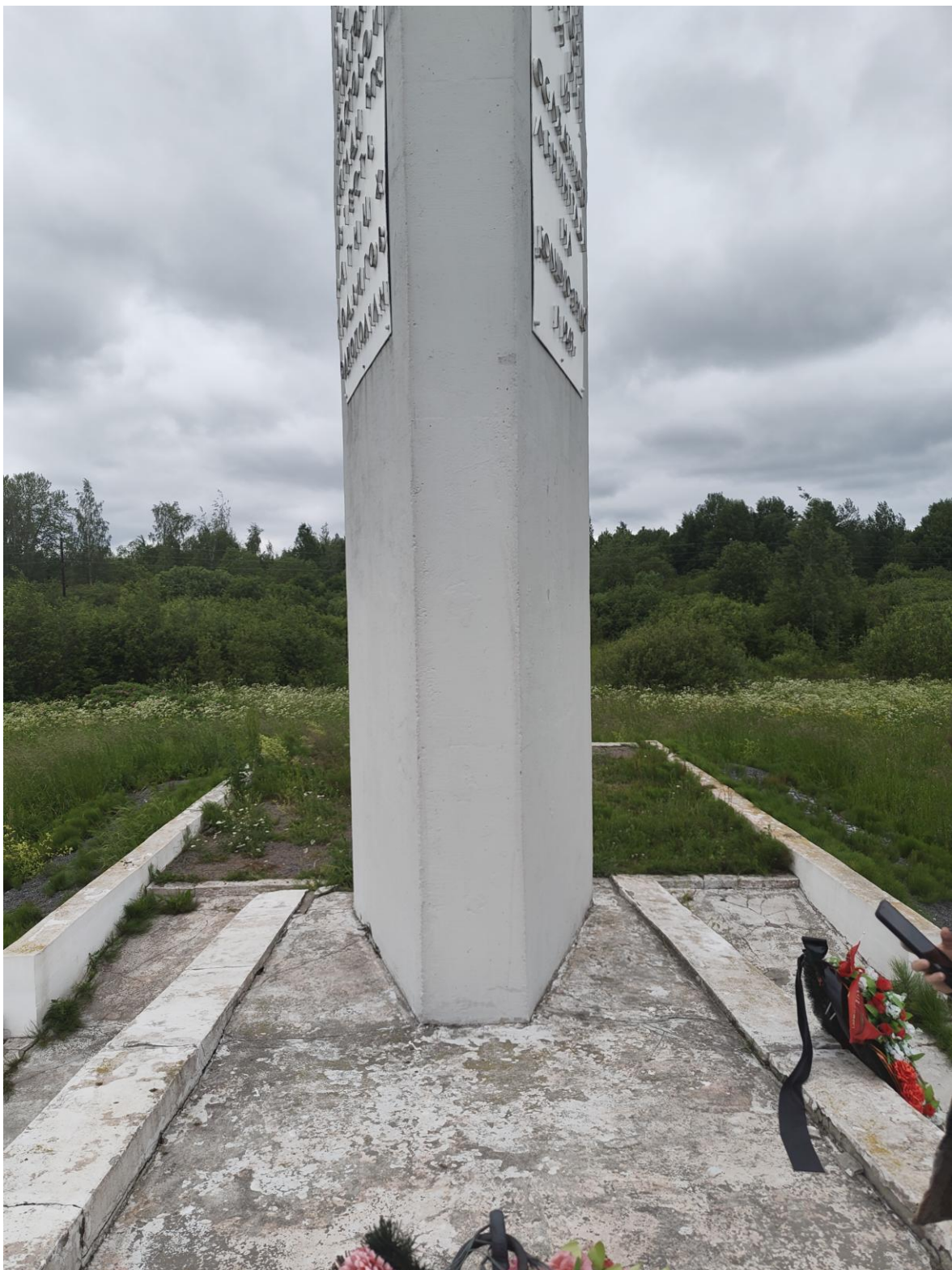
Фото 13. Фронтальный вид на основание стелы с юго-восточной стороны. На поверхности стелы у основания наблюдаются деструкция цементной штукатурки, незначительные утраты красочного слоя, на поверхности площадки наблюдаются многочисленные следы биопоражений, трещины у основания стелы, утраты красочного слоя, следы антропогенных загрязнений. Дата съемки: июнь 2025. Автор: Шатунова Л.А.
