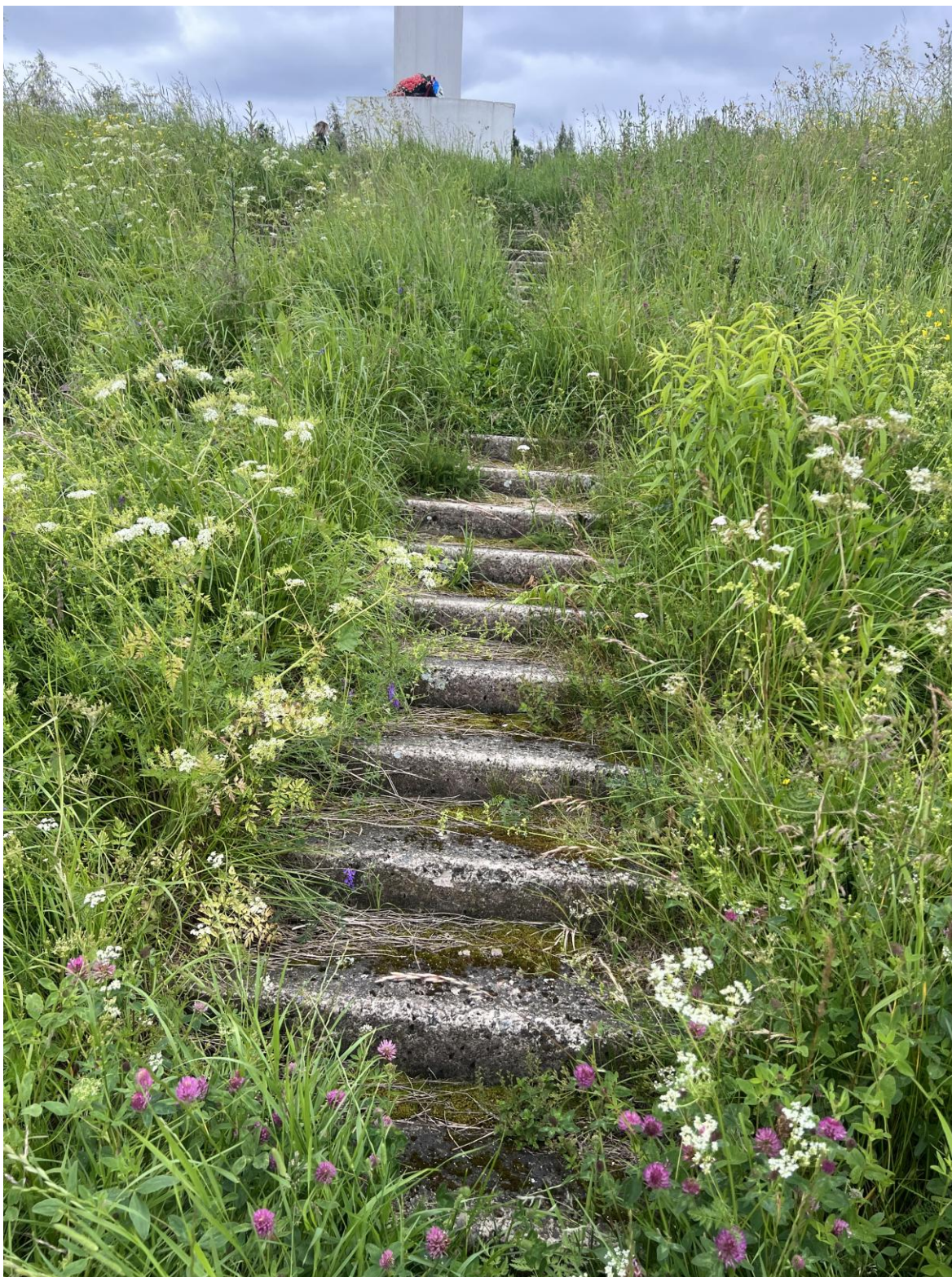
Фото 42. Вид на нижний восточный марш с юго-восточной стороны. Наблюдаются трещины, сколы, каверны, деструкция бетона, следы биопоражений и самосевная растительность. Дата съемки: июнь 2025. Автор: Шатунова Л.А.
