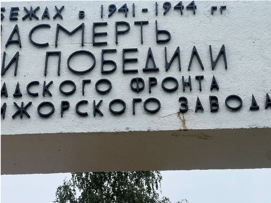
Фото 8. Фрагмент памятника. Шелушение красочного слоя, множественные окрасы, деструкция и трещины штукатурного слоя, следы поздних докомпановок, загрязнение элементов текста красочными наслоениями. Дата съемки: июнь 2025. Автор: Козлова Е.М.
