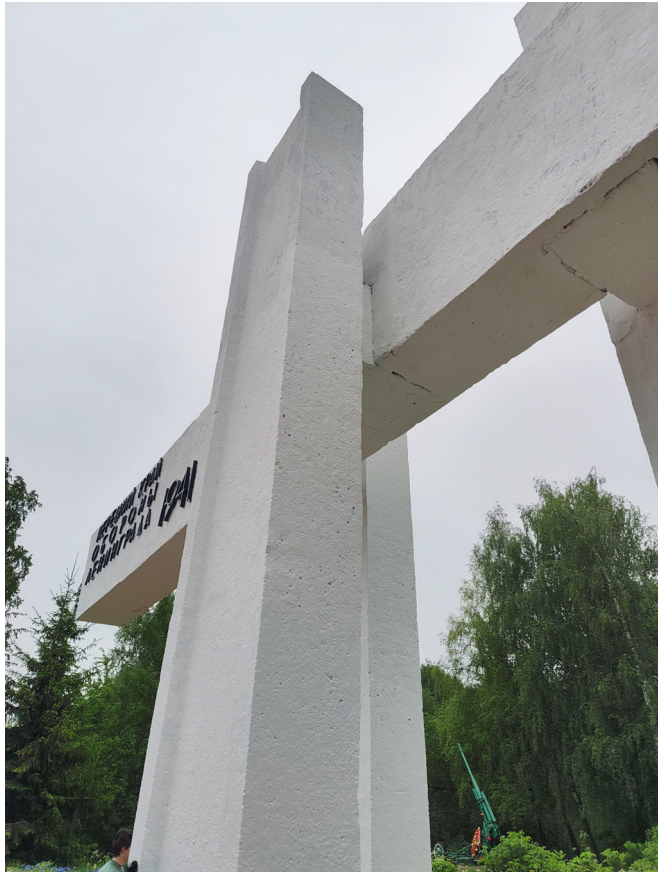
Фото 22. Фрагмент памятника. Шелушение красочного слоя, множественные окрасы, деструкция и трещины штукатурного слоя, нарушение герметичности мест примыкания конструкций, следы поздних докомпановок. Дата съемки: июнь 2025. Автор: Козлова Е.М.
