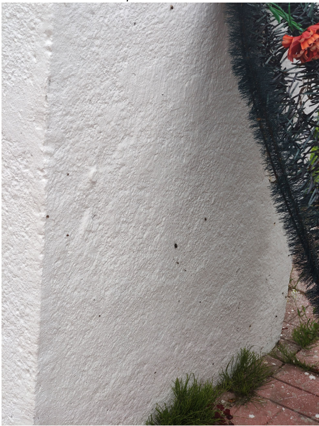
Фото 18. Фрагмент памятника. Шелушение красочного слоя, множественные окрасы, деструкция штукатурного слоя, следы поздних докомпановок, биопоражения мест примыкания. Дата съемки: июнь 2025. Автор: Козлова Е.М.
