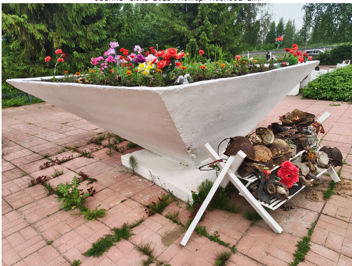
Фото 24. Ваза с клумбой. Шелушение красочного слоя, множественные окрасы, деструкция и трещины штукатурного слоя, следы поздних докомпановок, биопоражение мощения. Дата съемки: июнь 2025. Автор: Козлова Е.М.
