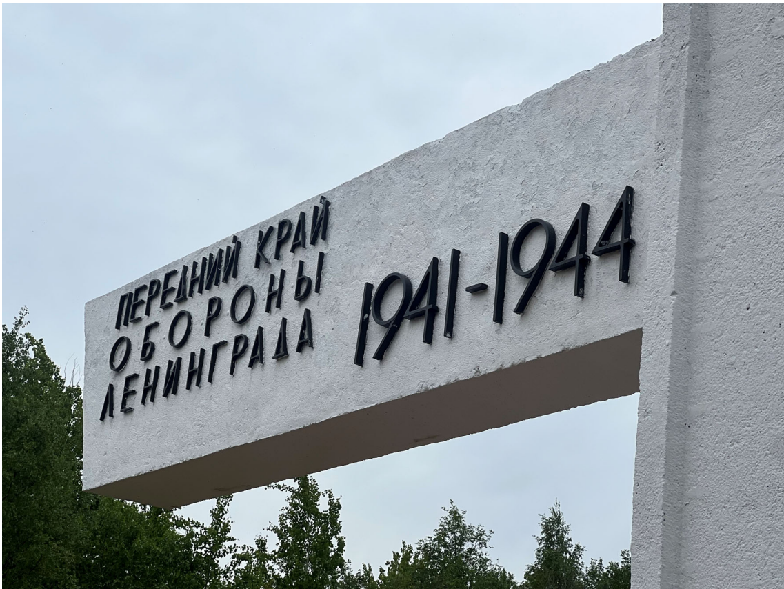
Фото 7. Фрагмент памятника. Шелушение красочного слоя, множественные окрасы, деструкция штукатурного слоя, следы поздних докомпановок, загрязнение элементов текста красочными наслоениями. Дата съемки: июнь 2025. Автор: Козлова Е.М.
