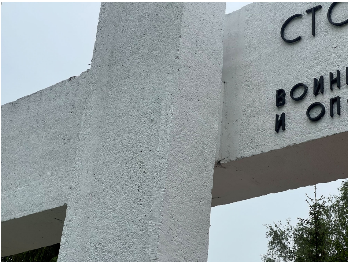
Фото 9. Фрагмент памятника. Шелушение красочного слоя, множественные окрасы, деструкция штукатурного слоя, следы поздних докомпановок, загрязнение элементов текста красочными наслоениями. Дата съемки: июнь 2025. Автор: Козлова Е.М.
