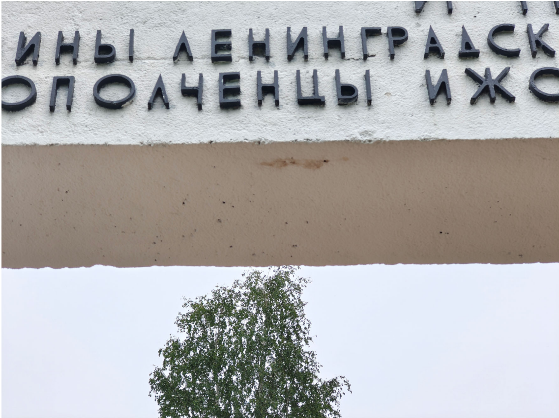
Фото 14. Фрагмент памятника. Шелушение красочного слоя, множественные окрасы, деградация штукатурного слоя, следы поздних докомпановок, загрязнение элементов текста красочными наслоениями. Дата съемки: июнь 2025. Автор: Козлова Е.М.
