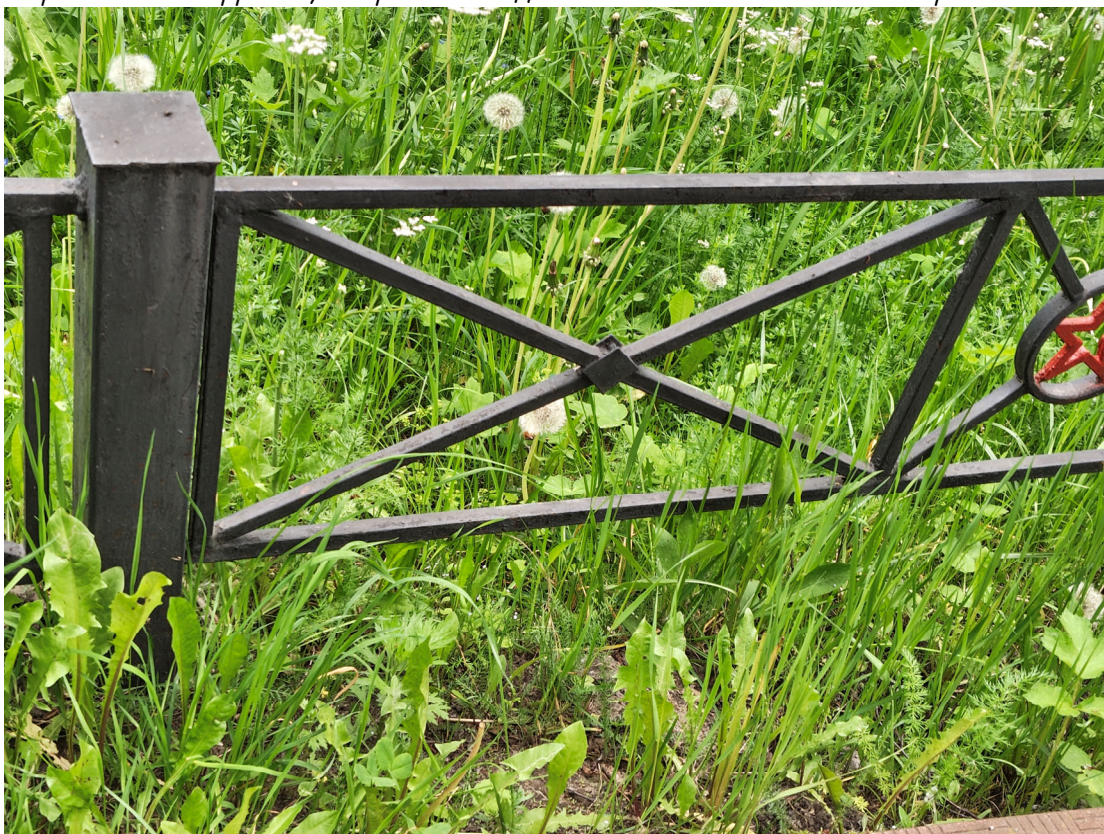
Фото 38. Металлическая ограда. Шелушение красочного слоя, множественные окрасы, следы поверхностной коррозии, загрязнения. Дата съемки: июнь 2025. Автор: Козлова Е.М.
