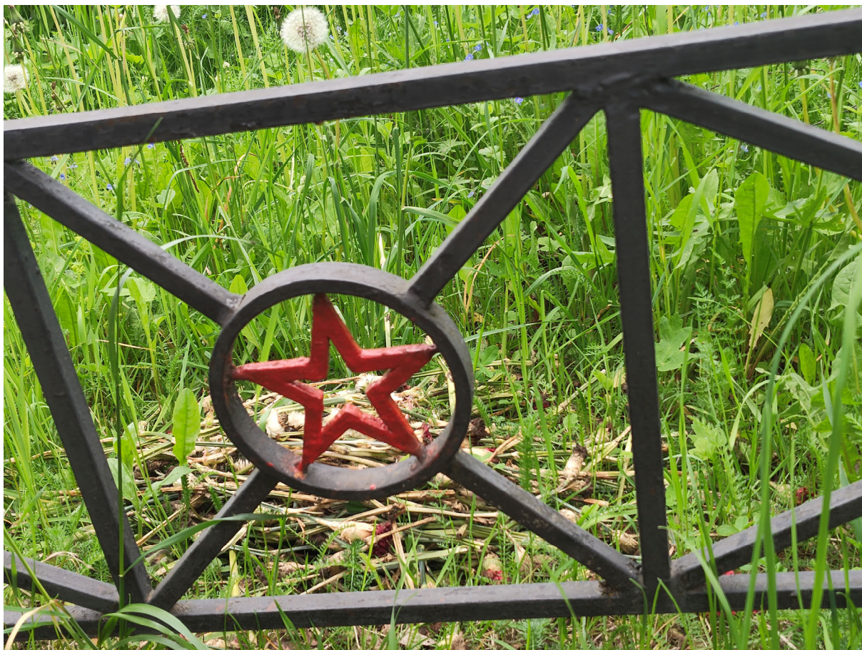
Фото 39. Металлическая ограда. Шелушение красочного слоя, множественные окрасы, следы поверхностной коррозии, загрязнения. Дата съемки: июнь 2025. Автор: Козлова Е.М.
