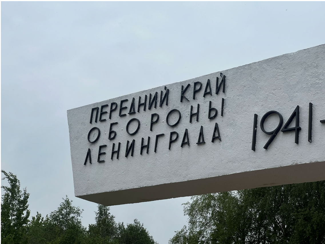
Фото 13. Фрагмент памятника. Шелушение красочного слоя, множественные окрасы, деградация штукатурного слоя, следы поздних докомпановок, загрязнение элементов текста красочными наслоениями. Дата съемки: июнь 2025. Автор: Козлова Е.М.
