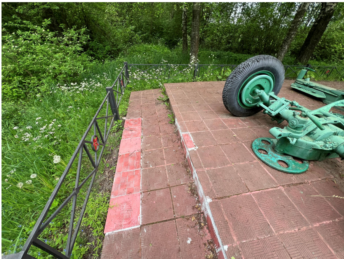
Фото 45. Зенитное орудие, мощение площадки. Следы поздних ремонтов, биопоражения мхом, деструкция шовного заполнения, загрязнения. Дата съемки: июнь 2025. Автор: Козлова Е.М.
