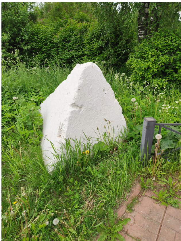
Фото 31. Противотанковые надолбы. Шелушение красочного слоя, множественные окрасы, деструкция наружного слоя бетона, следы поздних докомпановок. Дата съемки: июнь 2025. Автор: Козлова Е.М.
