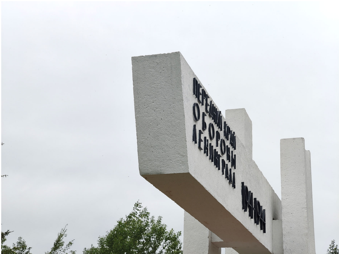
Фото 17. Фрагмент памятника. Шелушение красочного слоя, множественные окрасы, деструкция штукатурного слоя, следы поздних докомпановок. Дата съемки: июнь 2025. Автор: Козлова Е.М.
