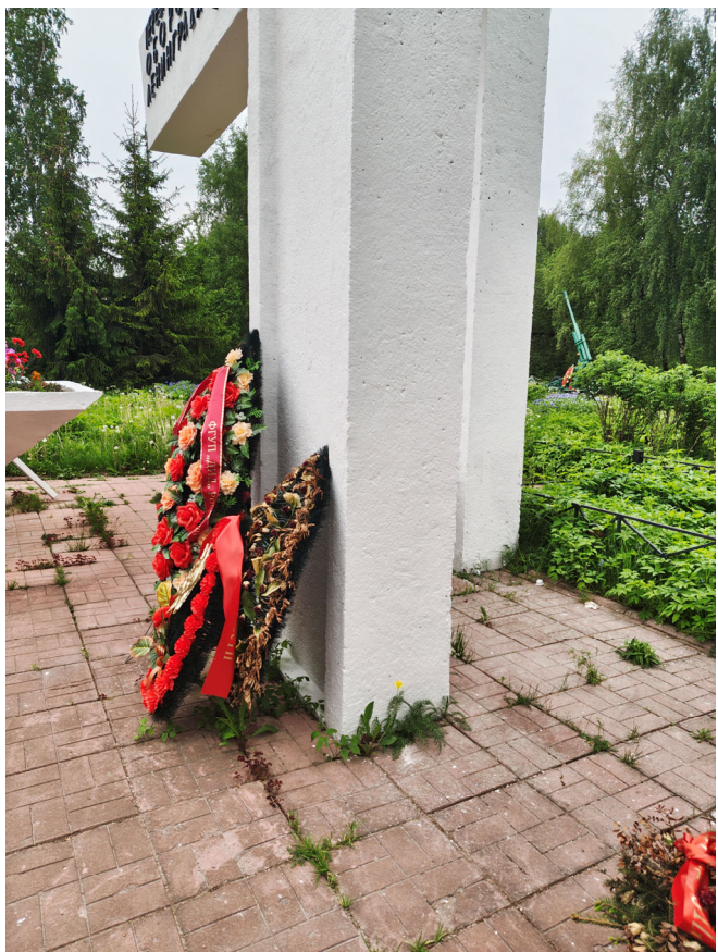
Фото 19. Фрагмент памятника. Шелушение красочного слоя, множественные окрасы, деструкция штукатурного слоя, следы поздних докомпановок, биопоражения мест примыкания. Дата съемки: июнь 2025. Автор: Козлова Е.М.
