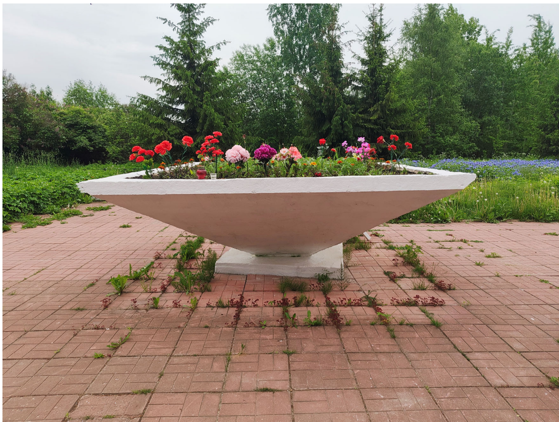
Фото 25. Ваза с клумбой. Шелушение красочного слоя, множественные окрасы, деструкция и трещины штукатурного слоя, следы поздних докомпановок, биопоражение мощения. Дата съемки: июнь 2025. Автор: Козлова Е.М.
