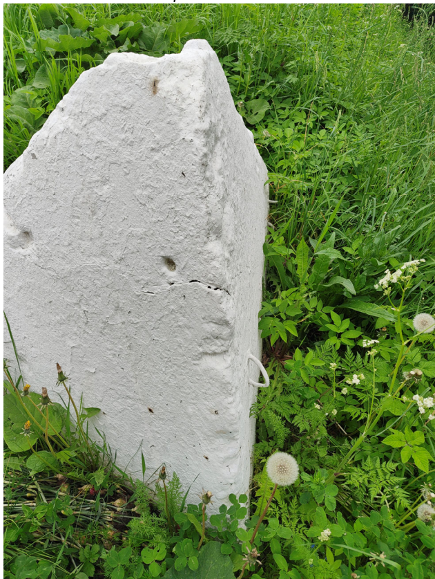
Фото 32. Противотанковые надолбы. Шелушение красочного слоя, множественные окрасы, деструкция наружного слоя бетона, следы поздних докомпановок. Дата съемки: июнь 2025. Автор: Козлова Е.М.
