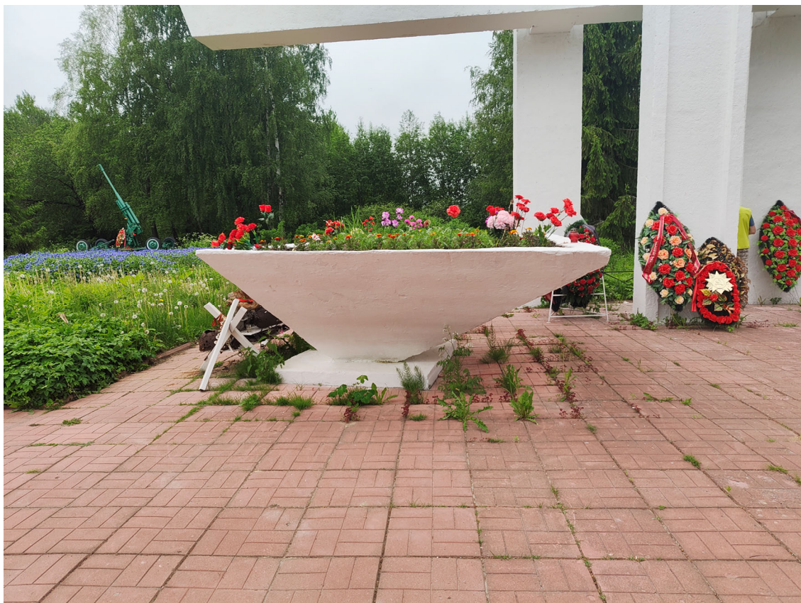
Фото 23. Ваза с клумбой. Шелушение красочного слоя, множественные окрасы, деструкция и трещины штукатурного слоя, следы поздних докомпановок, биопоражение мощения. Дата съемки: июнь 2025. Автор: Козлова Е.М.
