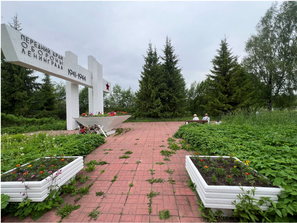
Фото 4. Вид на территорию объекта. Зарастание газонов самосевными растениями, биопоражения мощения, деструкция шовного заполнения. Дата съемки: июнь 2025. Автор: Козлова Е.М.
