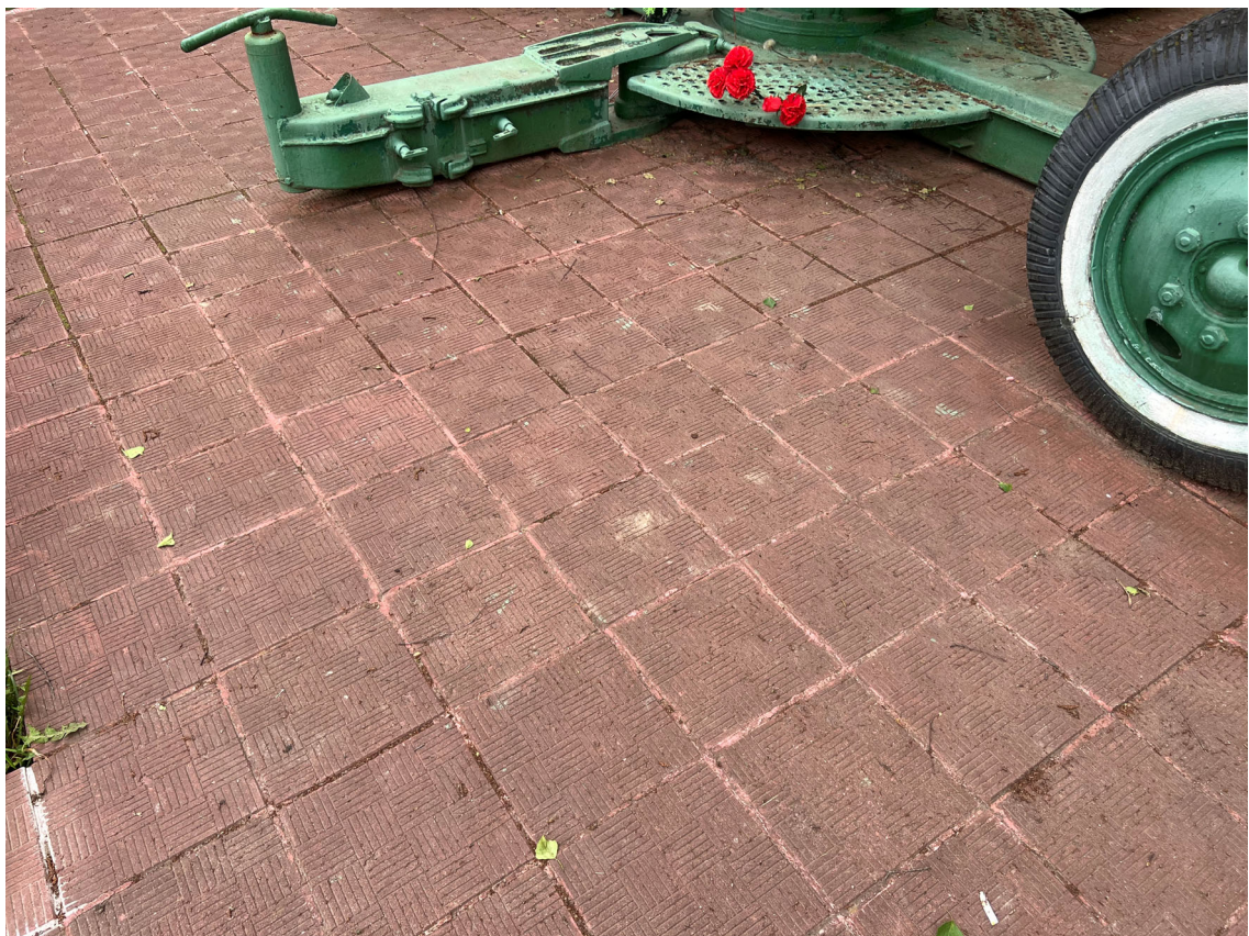
Фото 41. Зенитное орудие, мощение площадки. Биопоражения мхом, деструкция шовного заполнения. Дата съемки: июнь 2025. Автор: Козлова Е.М.
