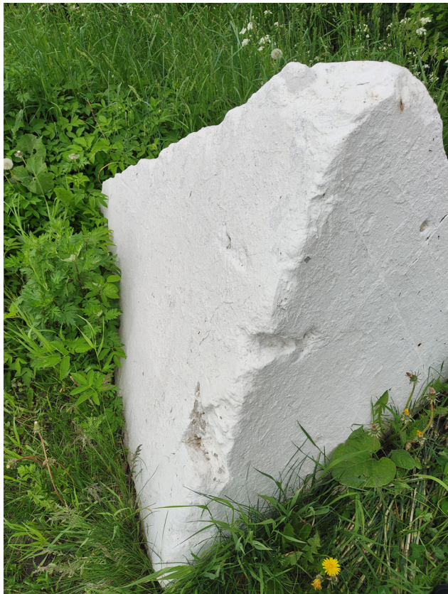
Фото 33. Противотанковые надолбы. Шелушение красочного слоя, множественные окрасы, деструкция наружного слоя бетона, следы поздних докомпановок. Дата съемки: июнь 2025. Автор: Козлова Е.М.
