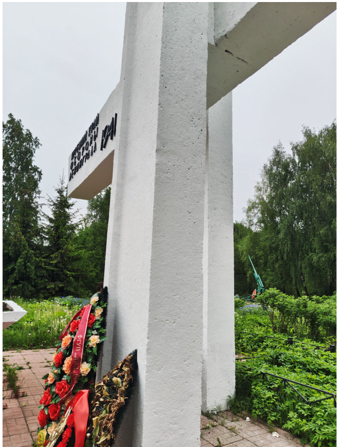
Фото 21. Фрагмент памятника. Шелушение красочного слоя, множественные окрасы, деструкция штукатурного слоя, следы поздних докомпановок, биопоражения мест примыкания. Дата съемки: июнь 2025. Автор: Козлова Е.М.
