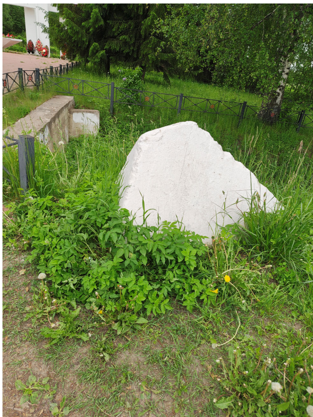
Фото 27. Противотанковые надолбы. Шелушение красочного слоя, множественные окрасы, деструкция наружного слоя бетона, следы поздних докомпановок. Дата съемки: июнь 2025. Автор: Козлова Е.М.
