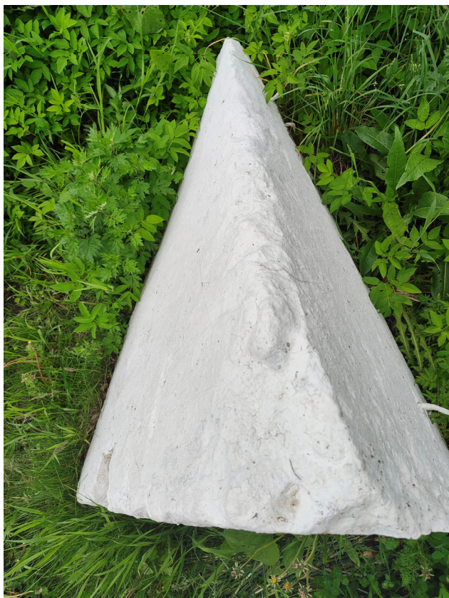
Фото 35. Противотанковые надолбы. Шелушение красочного слоя, множественные окрасы, деградация наружного слоя бетона, следы поздних докомпановок. Дата съемки: июнь 2025. Автор: Козлова Е.М.
