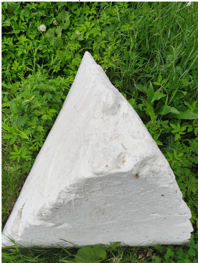
Фото 34. Противотанковые надолбы. Шелушение красочного слоя, множественные окрасы, деструкция наружного слоя бетона, следы поздних докомпановок. Дата съемки: июнь 2025. Автор: Козлова Е.М.
