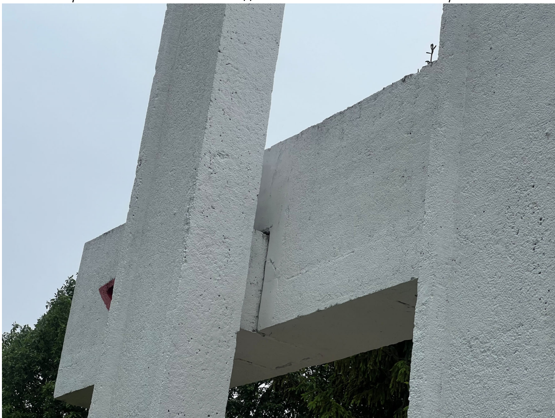
Фото 10. Фрагмент памятника. Шелушение красочного слоя, множественные окрасы, деструкция штукатурного слоя, следы поздних докомпановок. Дата съемки: июнь 2025. Автор: Козлова Е.М.
