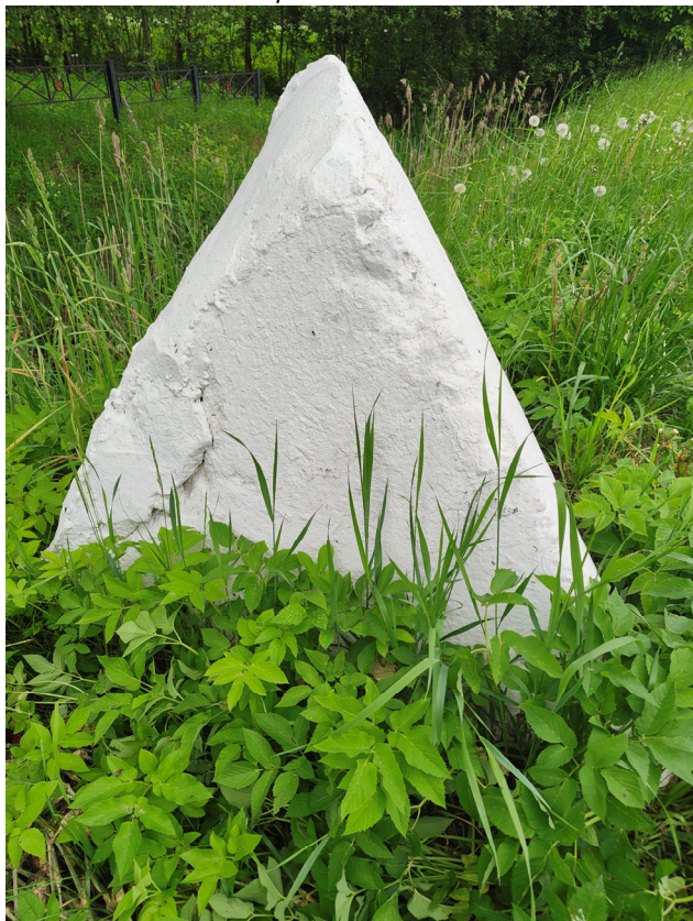
Фото 28. Противотанковые надолбы. Шелушение красочного слоя, множественные окрасы, деструкция наружного слоя бетона, следы поздних докомпановок. Дата съемки: июнь 2025. Автор: Козлова Е.М.
