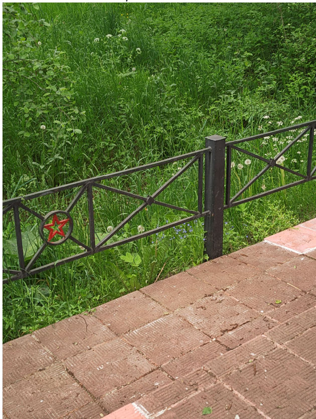
Фото 36. Металлическая ограда. Шелушение красочного слоя, множественные окрасы, следы поверхностной коррозии, загрязнения. Дата съемки: июнь 2025. Автор: Козлова Е.М.
