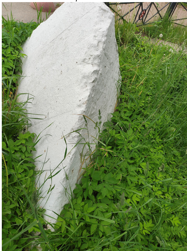
Фото 30. Противотанковые надолбы. Шелушение красочного слоя, множественные окрасы, деструкция наружного слоя бетона, следы поздних докомпановок. Дата съемки: июнь 2025. Автор: Козлова Е.М.
