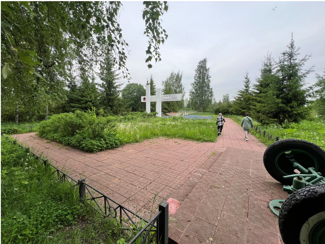
Фото 5. Вид на территорию объекта. Зарастание газонов самосевными растениями, биопоражения мощения, деструкция шовного заполнения. Дата съемки: июнь 2025. Автор: Козлова Е.М.
