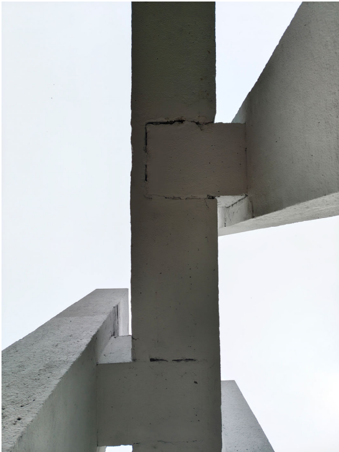
Фото 16. Фрагмент памятника. Шелушение красочного слоя, множественные окрасы, деструкция и трещины штукатурного слоя, нарушение герметичности мест примыкания конструкций, следы поздних докомпановок. Дата съемки: июнь 2025. Автор: Козлова Е.М.
