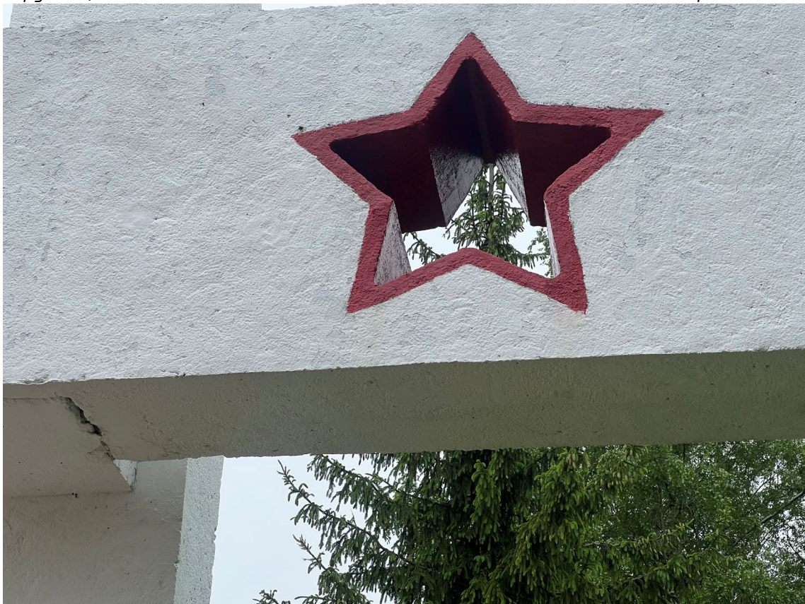
Фото 12. Фрагмент памятника. Шелушение красочного слоя, множественные окрасы, деструкция и трещины штукатурного слоя, нарушение герметичности мест примыкания конструкций, следы поздних докомпановок. Дата съемки: июнь 2025. Автор: Козлова Е.М.
