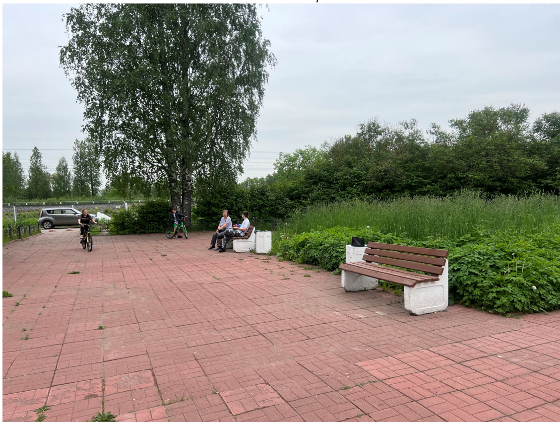
Фото 26. Вид на территорию объекта. Заращение газонов самосевными растениями, биопоражения мощения, деструкция шовного заполнения. Дата съемки: июнь 2025. Автор: Козлова Е.М.
