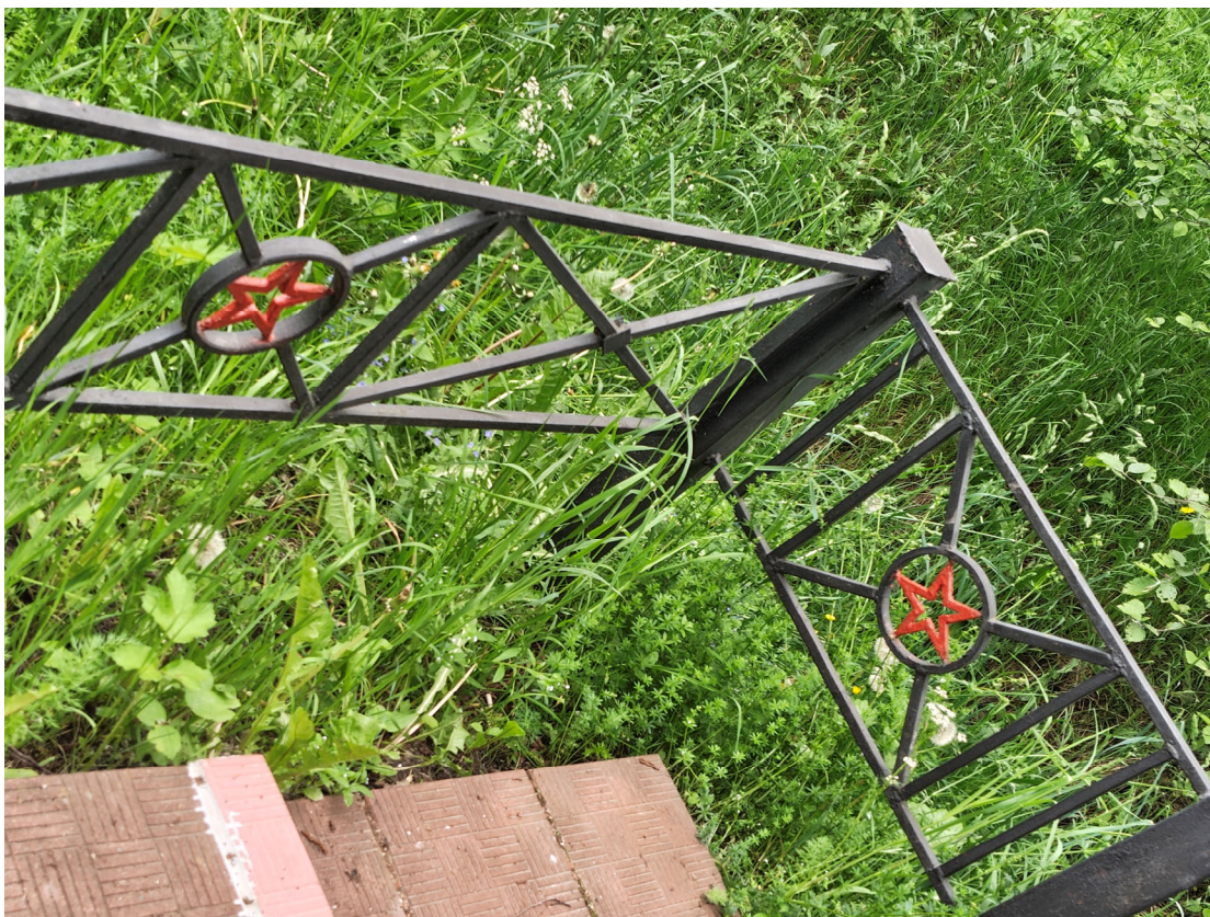
Фото 37. Металлическая ограда. Шелушение красочного слоя, множественные окрасы, следы поверхностной коррозии, загрязнения. Дата съемки: июнь 2025. Автор: Козлова Е.М.
