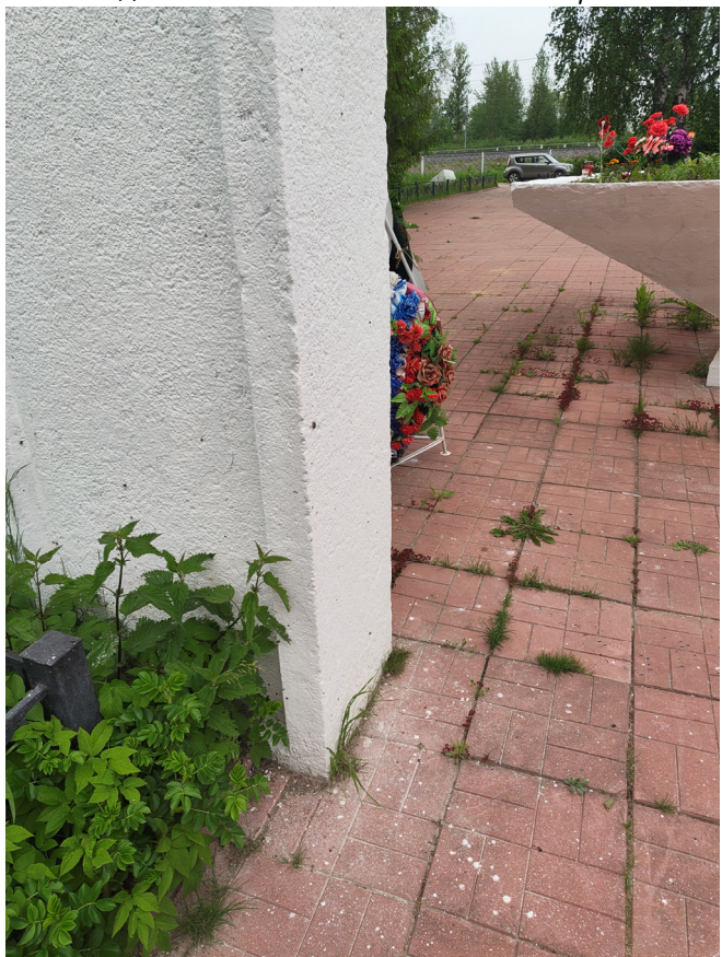
Фото 20. Фрагмент памятника. Шелушение красочного слоя, множественные окрасы, деструкция штукатурного слоя, следы поздних докомпановок, биопоражения мест примыкания. Дата съемки: июнь 2025. Автор: Козлова Е.М.
