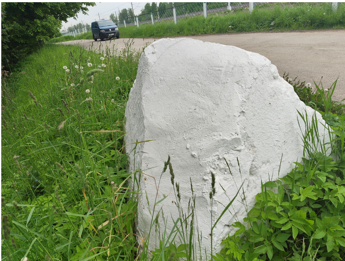
Фото 29. Противотанковые надолбы. Шелушение красочного слоя, множественные окрасы, деструкция наружного слоя бетона, следы поздних докомпановок. Дата съемки: июнь 2025. Автор: Козлова Е.М.
