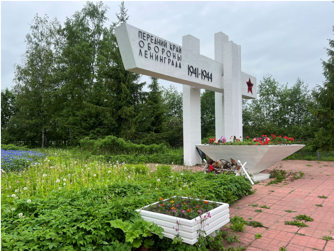
Фото 3. Вид на территорию объекта. Зарастание газонов самосевными растениями, биопоражения мощения, деструкция шовного заполнения. Дата съемки: июнь 2025. Автор: Козлова Е.М.
