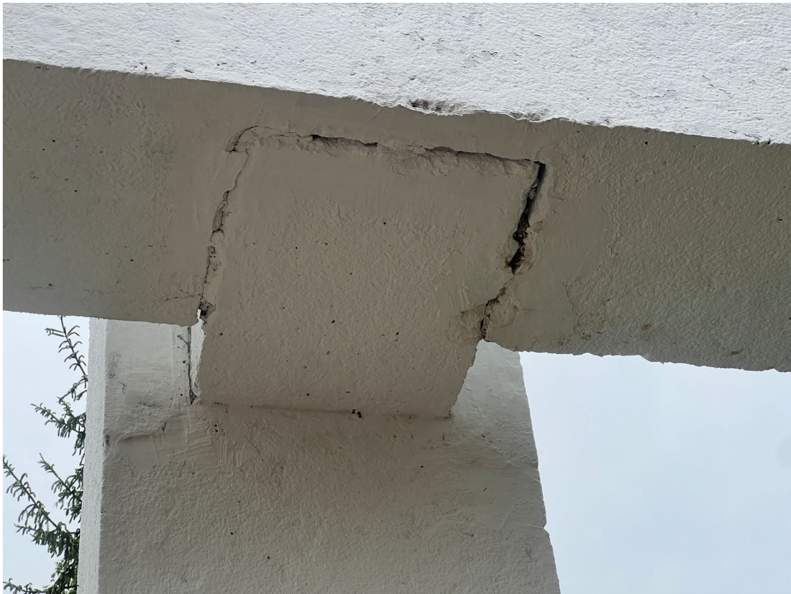
Фото 11. Фрагмент памятника. Шелушение красочного слоя, множественные окрасы, деструкция и трещины штукатурного слоя, нарушение герметичности мест примыкания конструкций, следы поздних докомпановок. Дата съемки: июнь 2025. Автор: Козлова Е.М.
