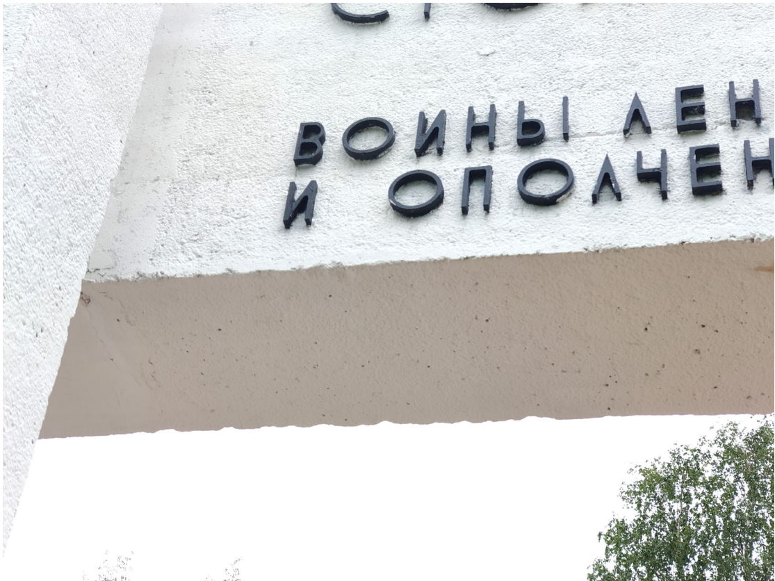
Фото 15. Фрагмент памятника. Шелушение красочного слоя, множественные окрасы, деструкция штукатурного слоя, следы поздних докомпановок, загрязнение элементов текста красочными наслоениями. Дата съемки: июнь 2025. Автор: Козлова Е.М.
