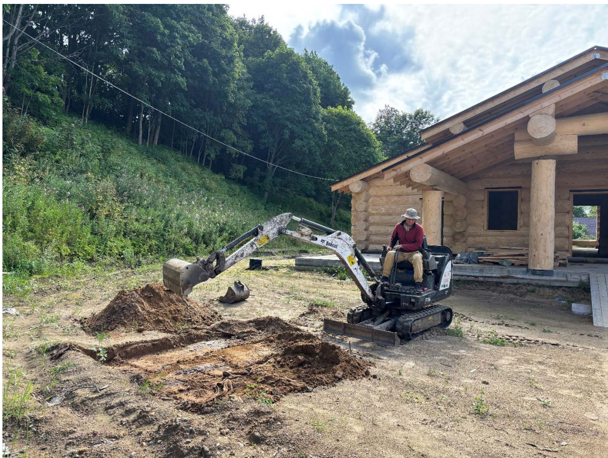
Рис. 37. САЭ-2025. Ленинградская обл., Волховский р-н, Староладожское сельское поселение, дер. Чернавино, д. 36, ЗУ 47:10:0328002:34. Шурф 2. Процесс выемки антропогенных нивелировочных и геологических слоев техникой.
