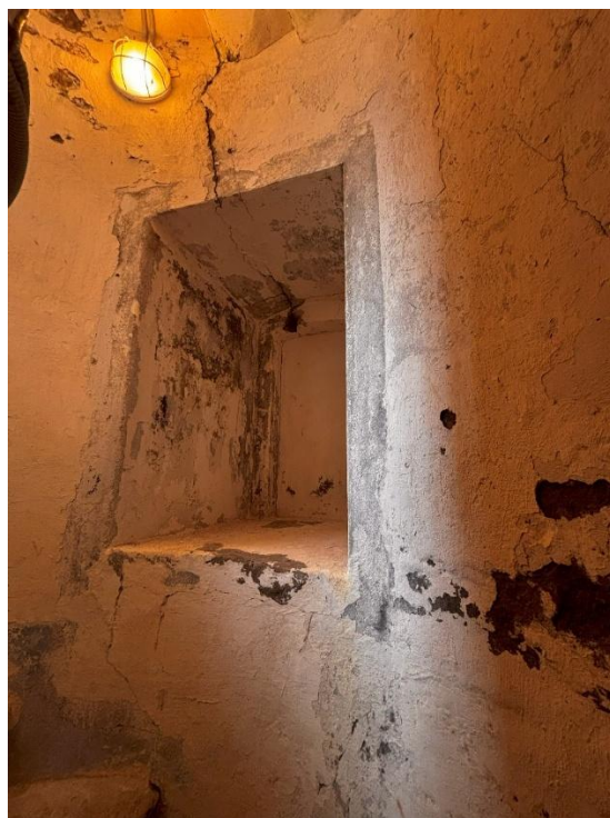
Фото 12. Заложенный оконный проем в основной части маяка.
