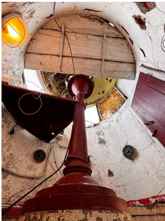
Фото 41. Опорный столб для фонаря в верхней части башни.
