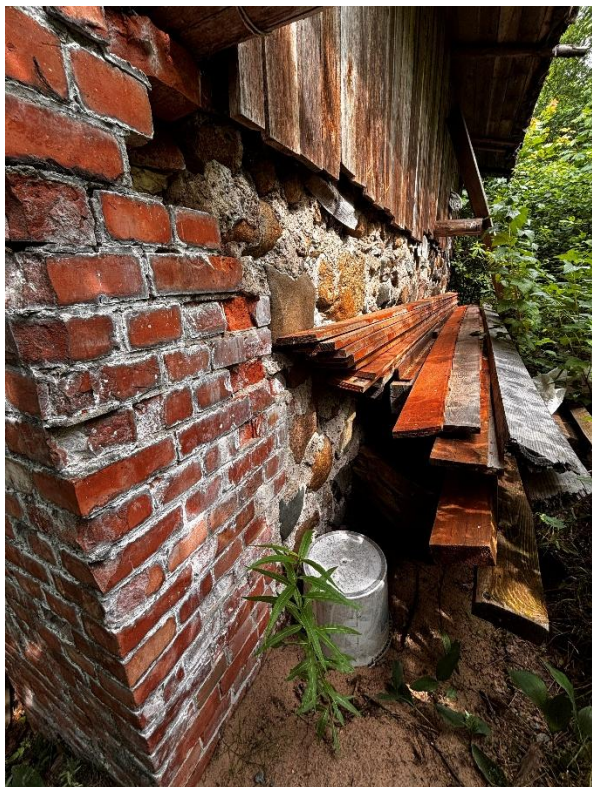
Фото 69. Ледник. Южный фасад с бутовой кладкой.
