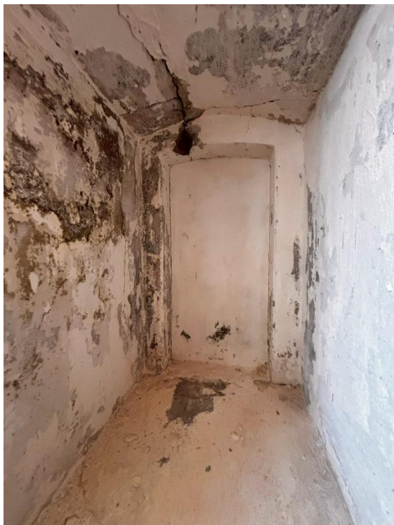
Фото 13. Заложенный оконный проем в основной части маяка.
