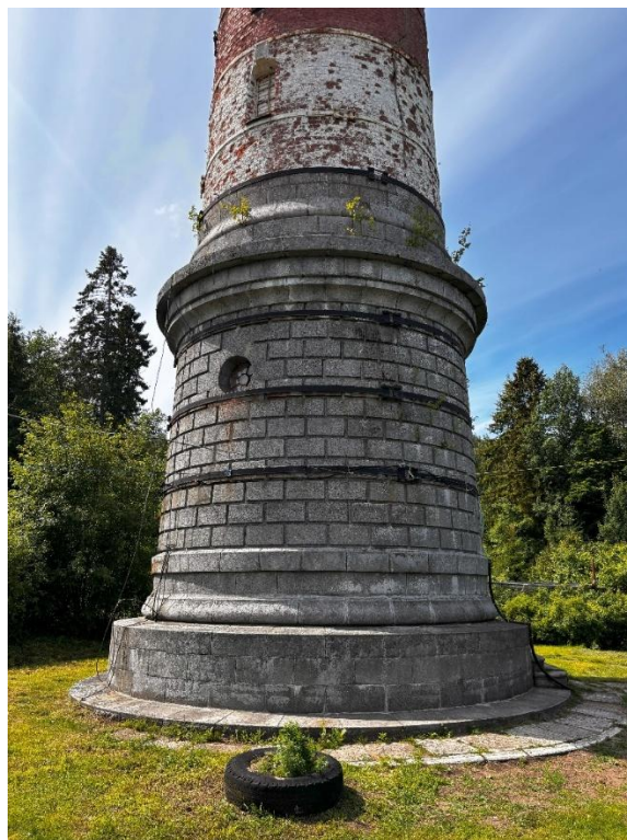
Фото 2. Нижняя часть маяка, облицована гранитом
