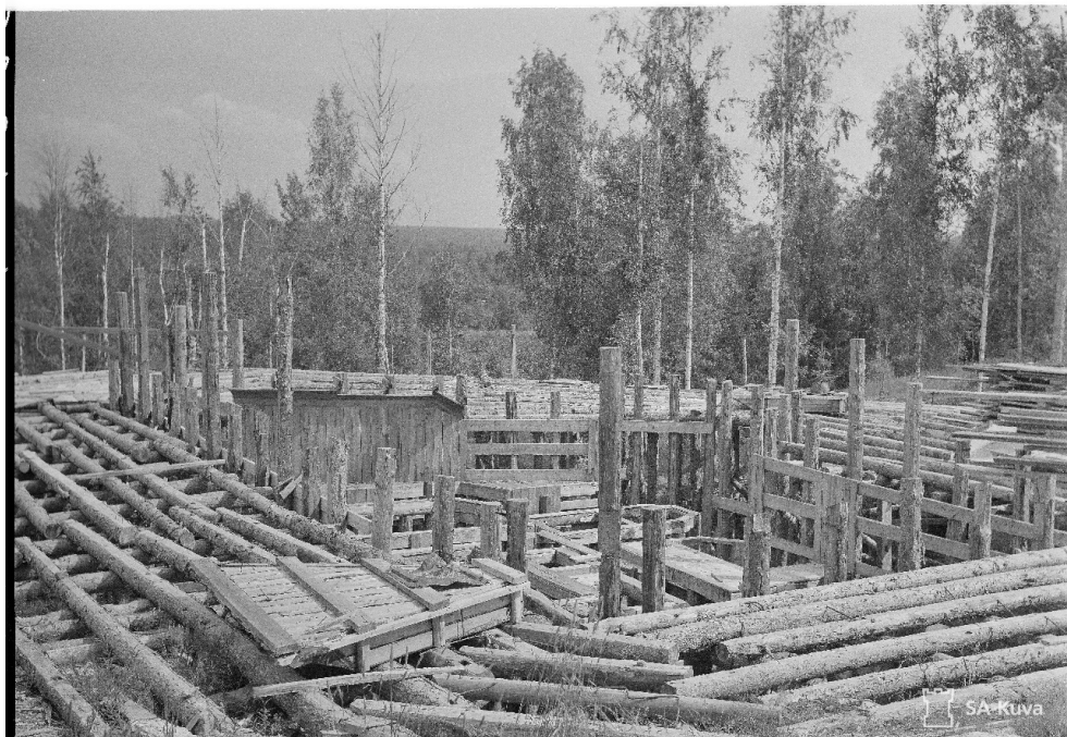
Опалубка советского ДОТа, так и оставшегося недостроенным. Высота Кумури под Сортавалой. Фотография сделана финским военным корреспондентом в 1943 году. sa-kuva.fi архив фотографий финских оборонительных сил
