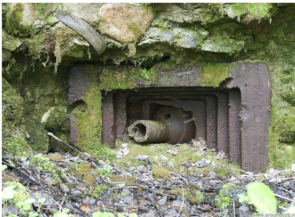
Амбразура ДОТа №07 с боевыми повреждениями. Источник: www.aroundspb.ru
