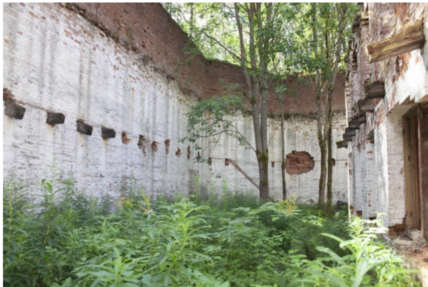
Пространство между внешней и внутренней стенами.
