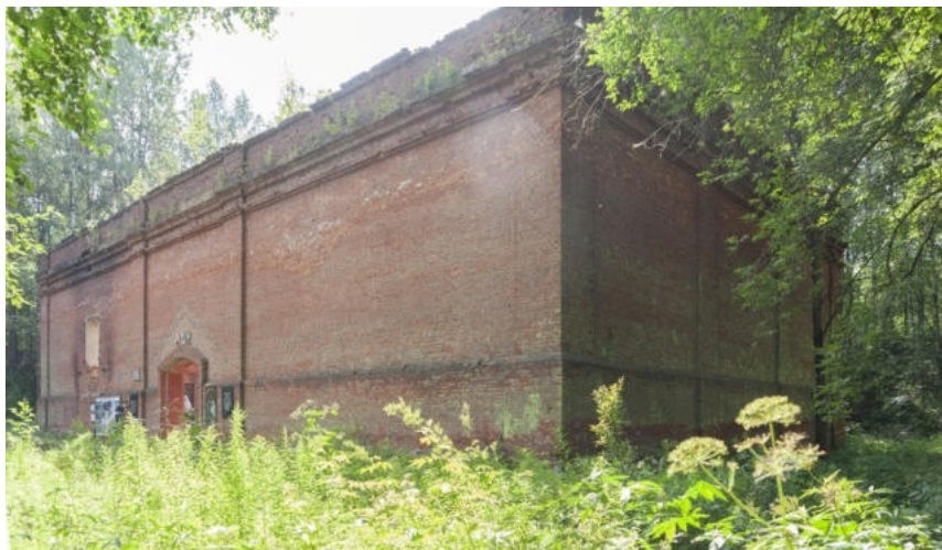
Общий вид Объекта. Июль 2025 г.
