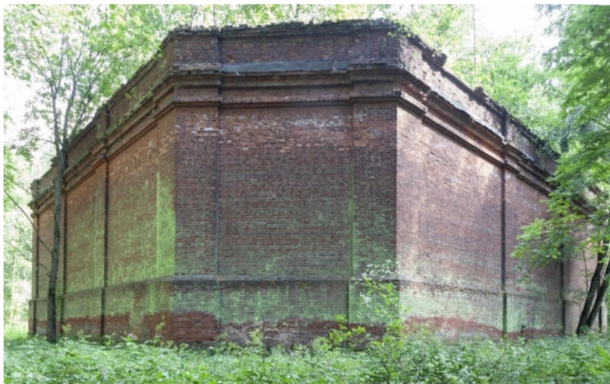
Внешние стены Объекта. Июль 2025 г.
