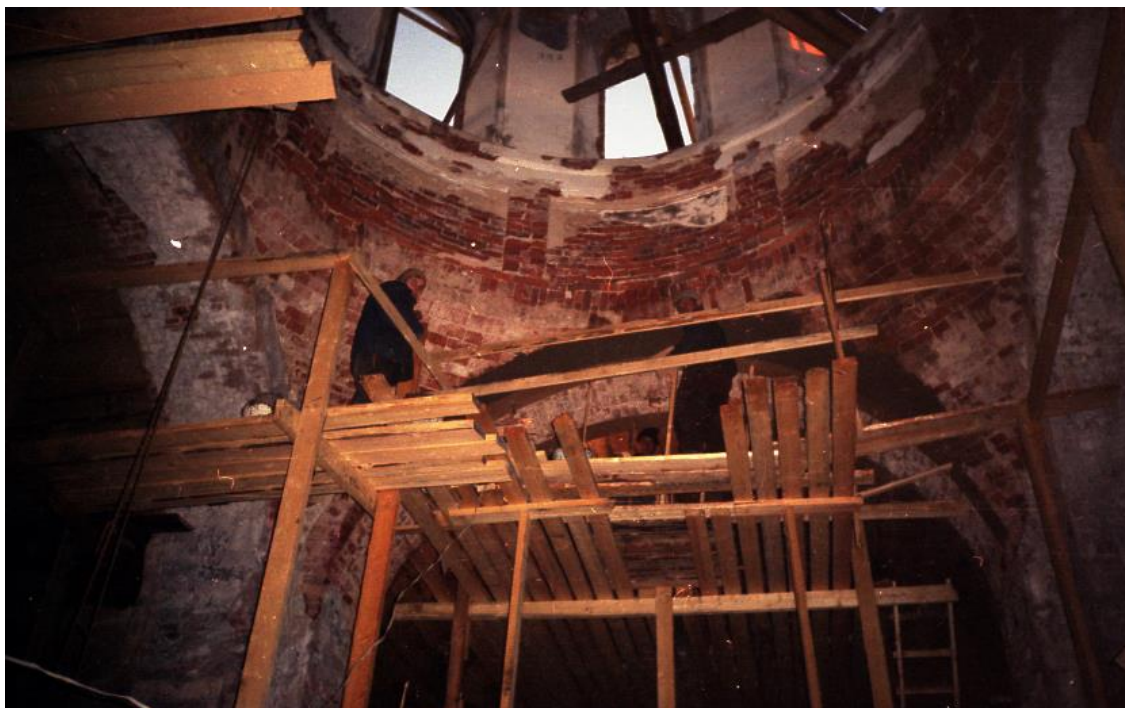
18. Процесс восстановления кирпичной кладки внутри здания. Фотография конца 1990-х гг. Архив фотографий, предоставленный Игуменей Лукианой – настоятельницей монастыря.
