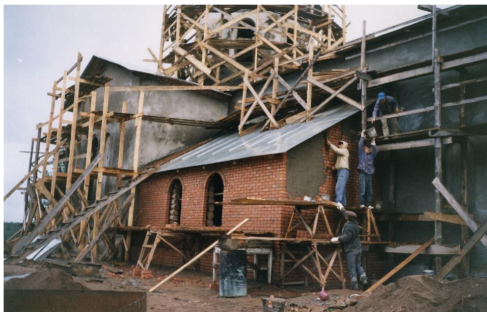
14. Процесс восстановления стен северного и южного придела, устройство кирпичной кладки снаружи здания. Фотография конца 1990-х гг. Архив фотографий, предоставленный Игуменьей Лукианой – настоятельницей монастыря.
