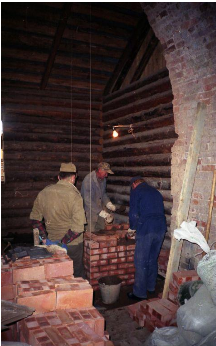
15. Процесс восстановления стен северного и южного придела, устройство кирпичной кладки внутри здания. Фотография. конца 1990-х гг. Архив фотографий, предоставленный Игуменьей Лукианой – настоятельницей монастыря.
