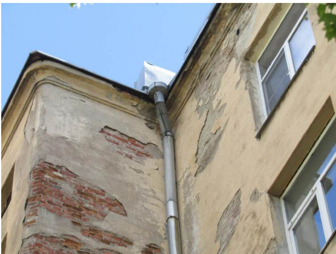
Фото 36. Фрагмент юго-западного фасада северо-западного ризалита лестничной клетки юго-восточного крыла здания. Повреждение карнизов. Фото с запада. Дата съемки: 17.09.2025 г. Автор Глинская Н.Б.
