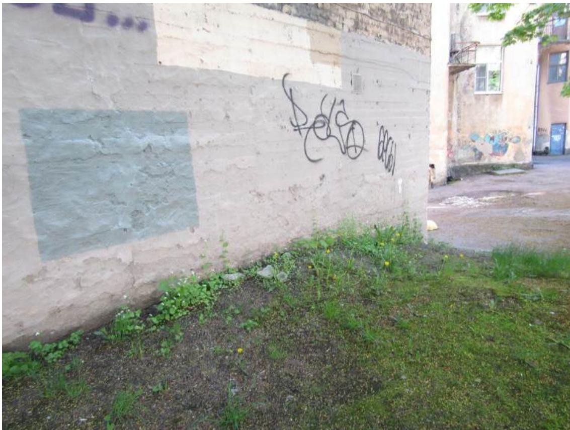
Фото 24. Фрагмент правой нижней части западной брандмауэрной стены уличного объема. Отсутствие отмостки. Дата съемки: 17.09.2025 г. Автор Глинская Н.Б.
