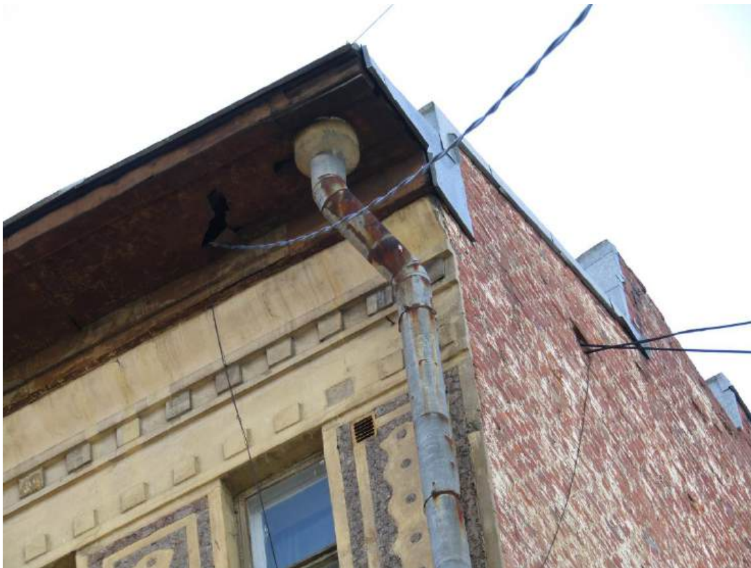
Фото 21. Фрагмент северо-западного угла северо-восточного крыла здания. Вынос венчающего карниза. Повреждение и коррозия металлической обшивки. Нарушение системы водостока. Дата съемки: 17.09.2025 г. Автор Глинская Н.Б.
