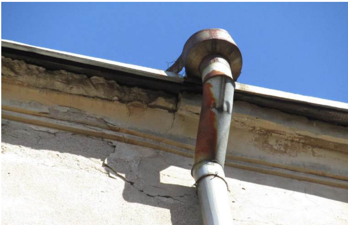
Фото 27. Фрагмент южного фасада дворового ризалита северо-восточного крыла здания. Венчающий карниз. Разрушение штукатурной отделки. Фото с юга. Дата съемки: 17.09.2025 г. Автор Глинская Н.Б.
