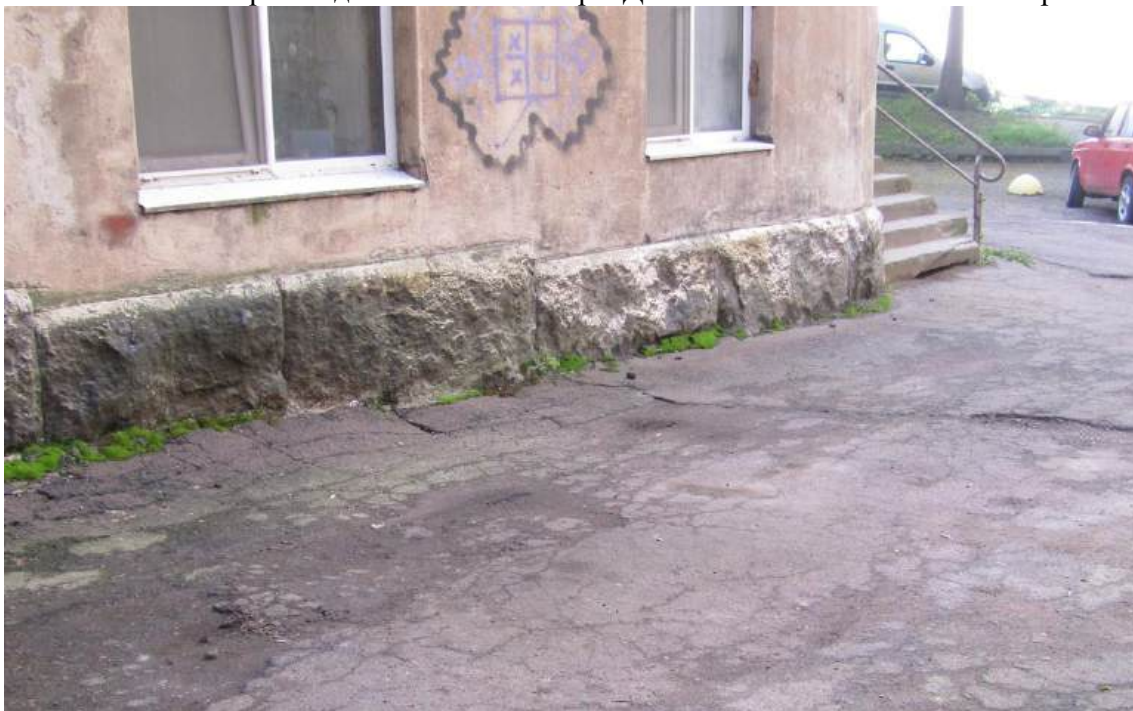
Фото 38. Фрагмент северо-восточного фасада дворового центрального ризалита юго-восточного крыла здания. Нарушение отмостки. Фото с востока. Дата съемки: 17.09.2025 г. Автор Глинская Н.Б.
