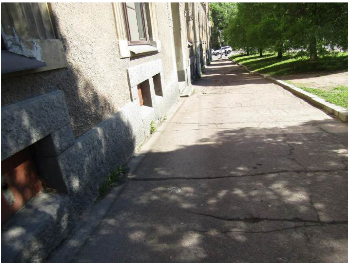
Фото 5. Фрагмент юго-восточного фасада здания. Повреждение асфальтового покрытия и отмостки. Фото с юга. Дата съемки: 17.09.2025 г. Автор Глинская Н.Б.
