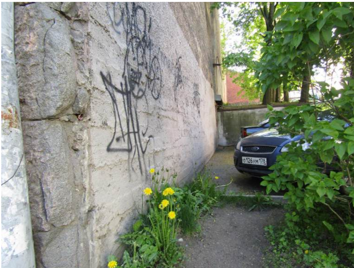
Фото 23. Фрагмент нижней части западной брандмауэрной стены уличного объема. Отмостка. Дата съемки: 17.09.2025 г. Автор Глинская Н.Б.
