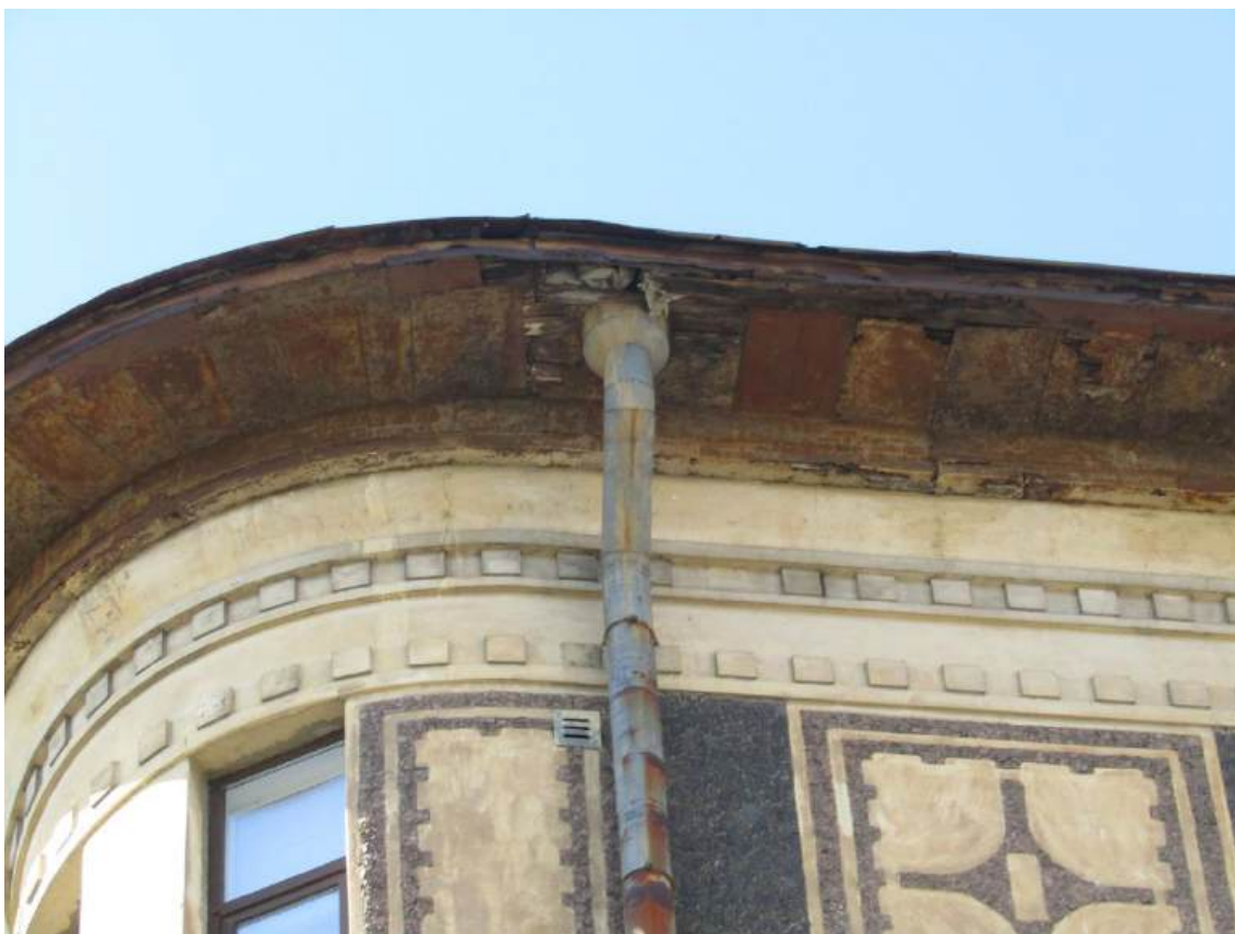
Фото 15. Фрагмент левой части северо-восточного уличного фасада. Вынос венчающего карниза. Повреждение и коррозия металлической обшивки, гниение и разрушение деревянной обшивки. Фото с северо-востока. Дата съемки: 17.09.2025 г. Автор Глинская Н.Б.
