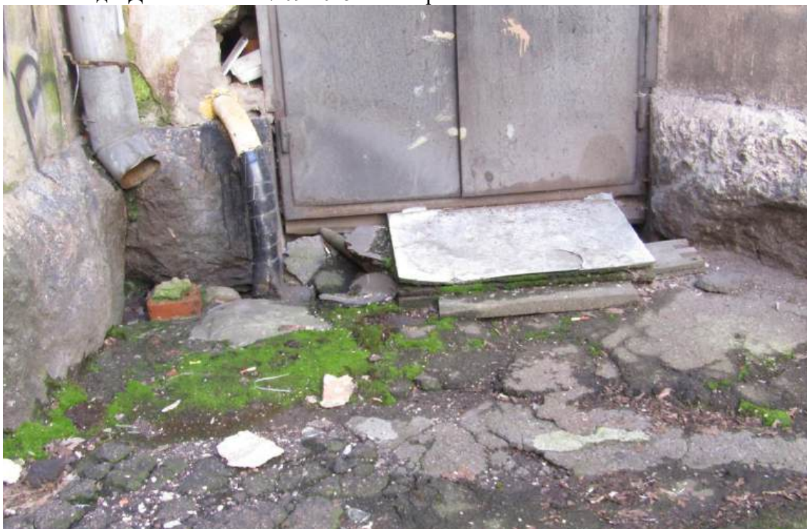
Фото 34. Внутренний западный угол здания. Фрагмент. Нарушение отсыпки. Дата съемки: 17.09.2025 г. Автор Глинская Н.Б.
