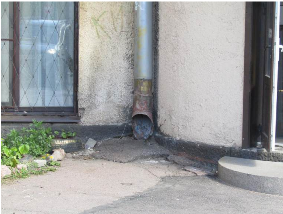
Фото 3. Фрагмент южного уличного фасада. Нарушение отмостки. Фото с юга. Дата съемки: 17.09.2025 г. Автор Глинская Н.Б.
