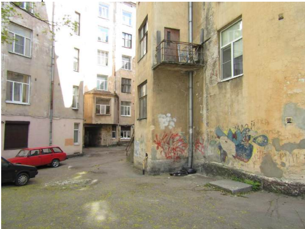
Фото 42. Фрагмент северо-западного фасада центрального дворового ризалита юго-восточного крыла здания. Нарушение отмостки. Дата съемки: 17.09.2025 г. Автор Глинская Н.Б.
