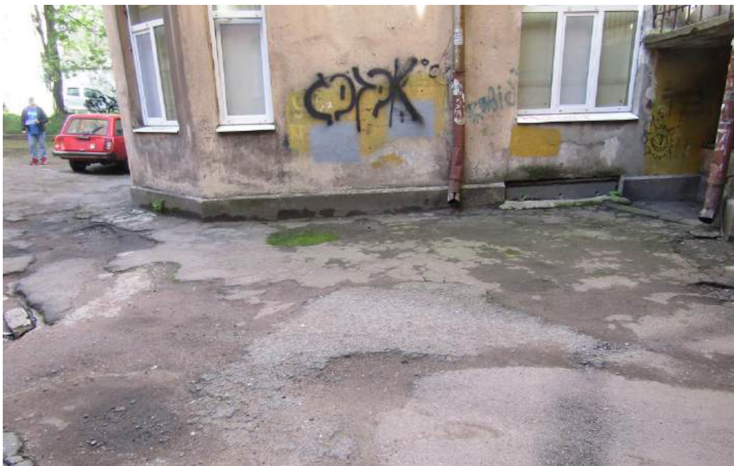
Фото 29. Фрагмент восточного фасада дворового ризалита северо-восточного крыла. Повреждения асфальтового покрытия и отмостки. Фото с востока. Дата съемки: 17.09.2025 г. г. Автор Глинская Н.Б.
