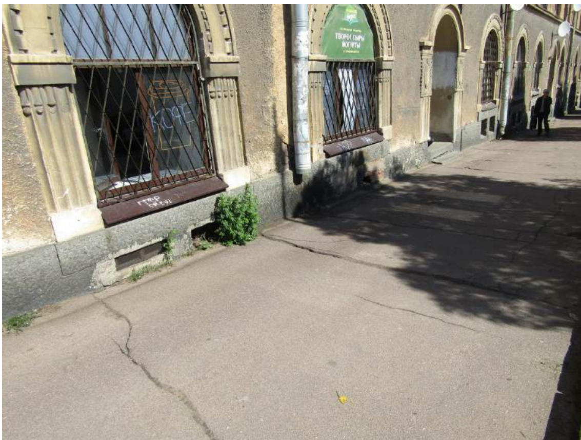
Фото 4. Фрагмент юго-восточного фасада здания. Повреждение асфальтового покрытия и отмостки. Фото с юго-востока. Дата съемки: 17.09.2025 г. Автор Глинская Н.Б.
