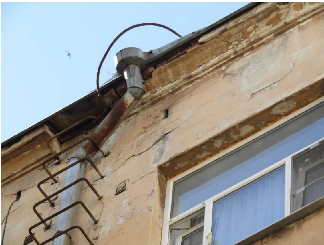
Фото 39. Фрагмент северо-восточного фасада дворового центрального ризалита юго-восточного крыла здания. Разрушение венчающего карниза. Фото с севера. Дата съемки: 17.09.2025 г. Автор Глинская Н.Б.
