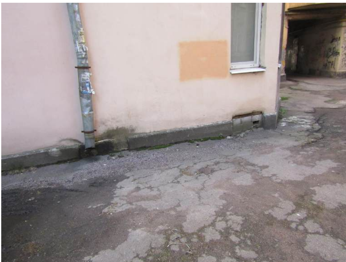
Фото 26. Фрагмент южного фасада дворового ризалита северо-восточного крыла здания. Нарушение асфальтового покрытия и отмостки. Фото с юга. Дата съемки: 17.09.2025 г. Автор Глинская Н.Б.
