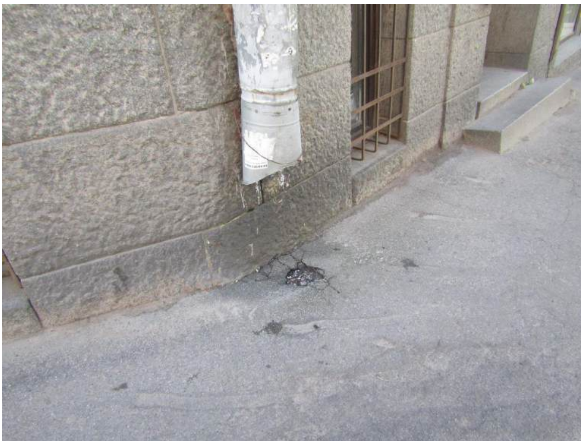
Фото 18. Фрагмент изгиба северо-восточного – северного фасада здания. Нарушение отмостки и системы водостока. Фото с северо-востока. Дата съемки: 17.09.2025 г. Автор Глинская Н.Б.
