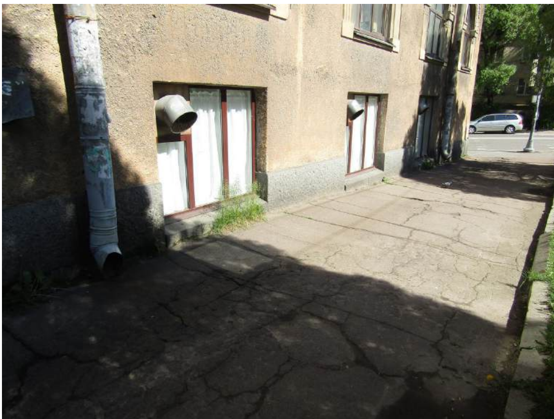
Фото 6. Фрагмент юго-восточного фасада здания. Повреждение асфальтового покрытия и отмостки. Фото с юга. Дата съемки: 17.09.2025 г. Автор Глинская Н.Б.
