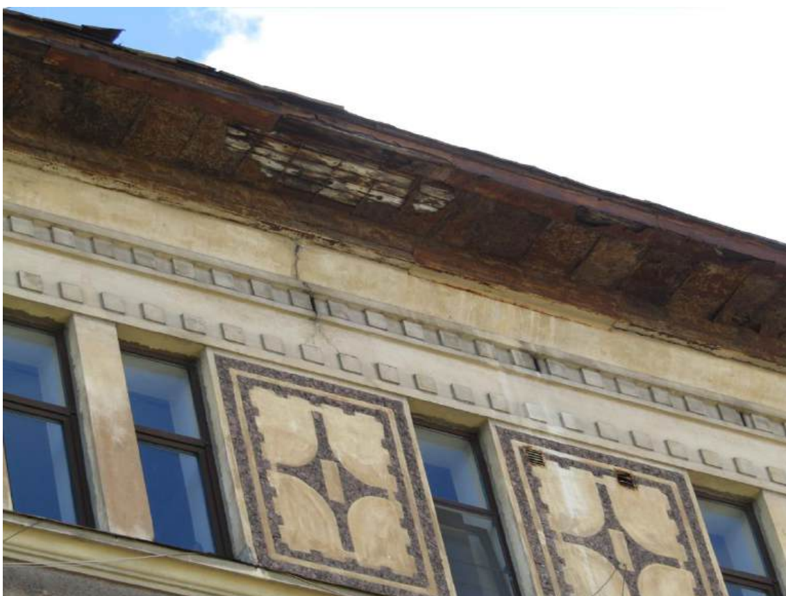
Фото 16. Фрагмент северо-восточного уличного фасада. Вынос венчающего карниза. Повреждение и коррозия металлической обшивки, гниение и разрушение деревянной обшивки. Фото с востока. Дата съемки: 17.09.2025 г. Автор Глинская Н.Б.
