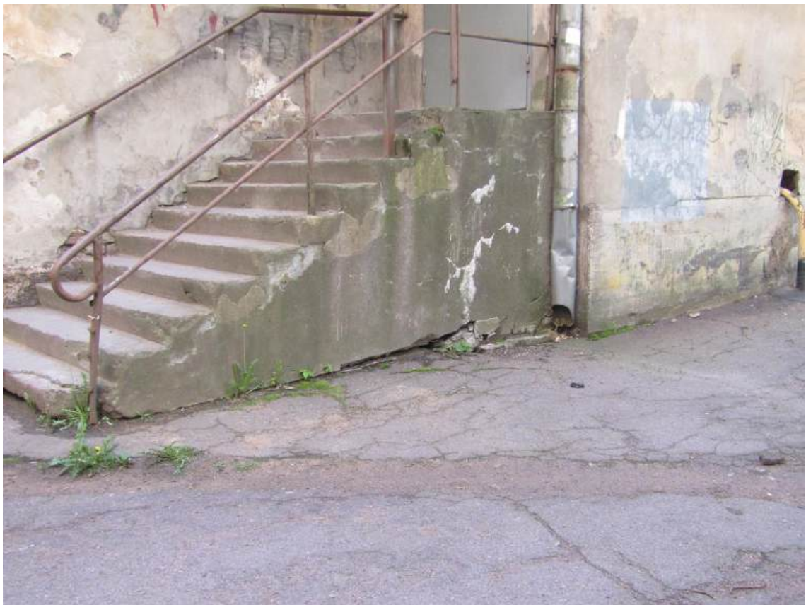
Фото 41. Фрагмент северо-западного фасада центрального дворового ризалита юго-восточного крыла здания. Крыльцо. Нарушение отмостки. Дата съемки: 17.09.2025 г. Автор Глинская Н.Б.
