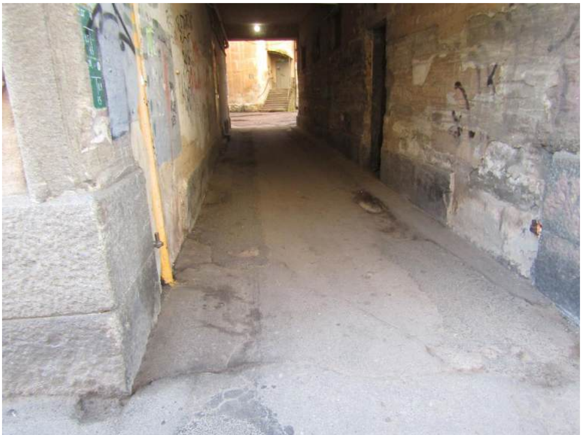
Фото 14. Сквозной арочный проезд. Нарушение отмостки. Фото с северо-востока. Дата съемки: 17.09.2025 г. Автор Глинская Н.Б.
