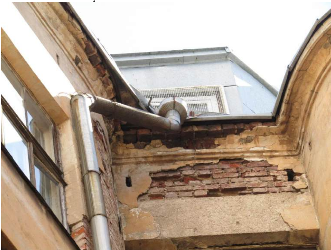
Фото 40. Северный дворовый угол здания. Фрагмент фасада. Разрушение венчающего карниза и нарушение системы водостока. Дата съемки: 17.09.2025 г. Автор Глинская Н.Б.
