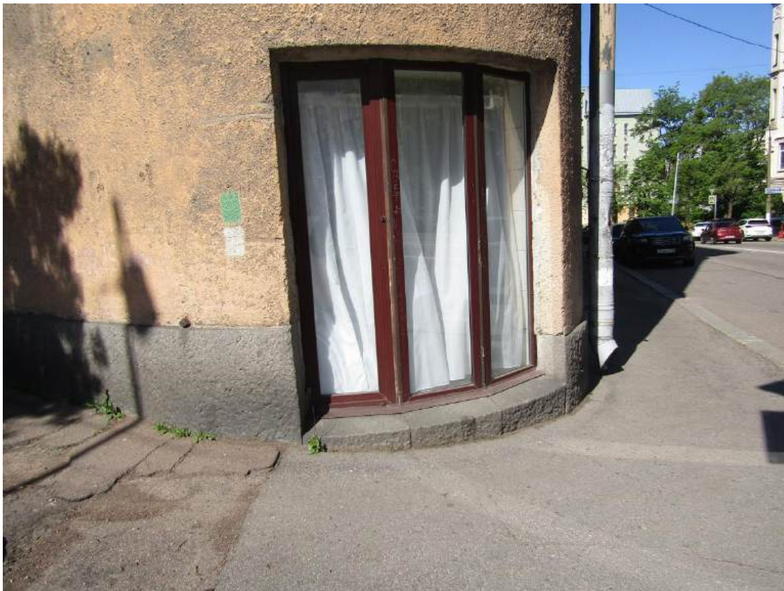
Фото 7. Фрагмент восточного угла здания. Повреждения асфальтового покрытия и отмостки. Фото с востока. Дата съемки: 17.09.2025 г. Автор Глинская Н.Б.
