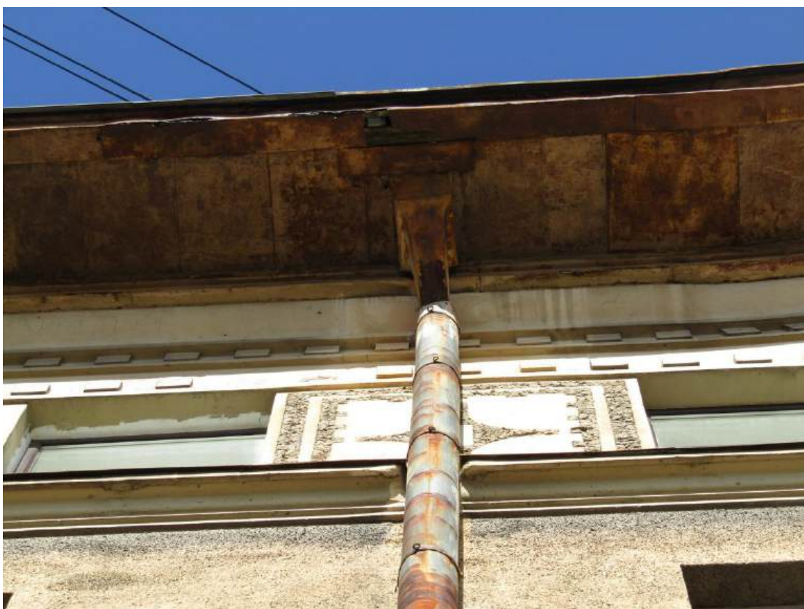
Фото 8. Фрагмент юго-восточного уличного фасада здания. Вынос венчающего карниза. Коррозия металлической обшивки. Дата съемки: 17.09.2025 г. Автор Глинская Н.Б.
