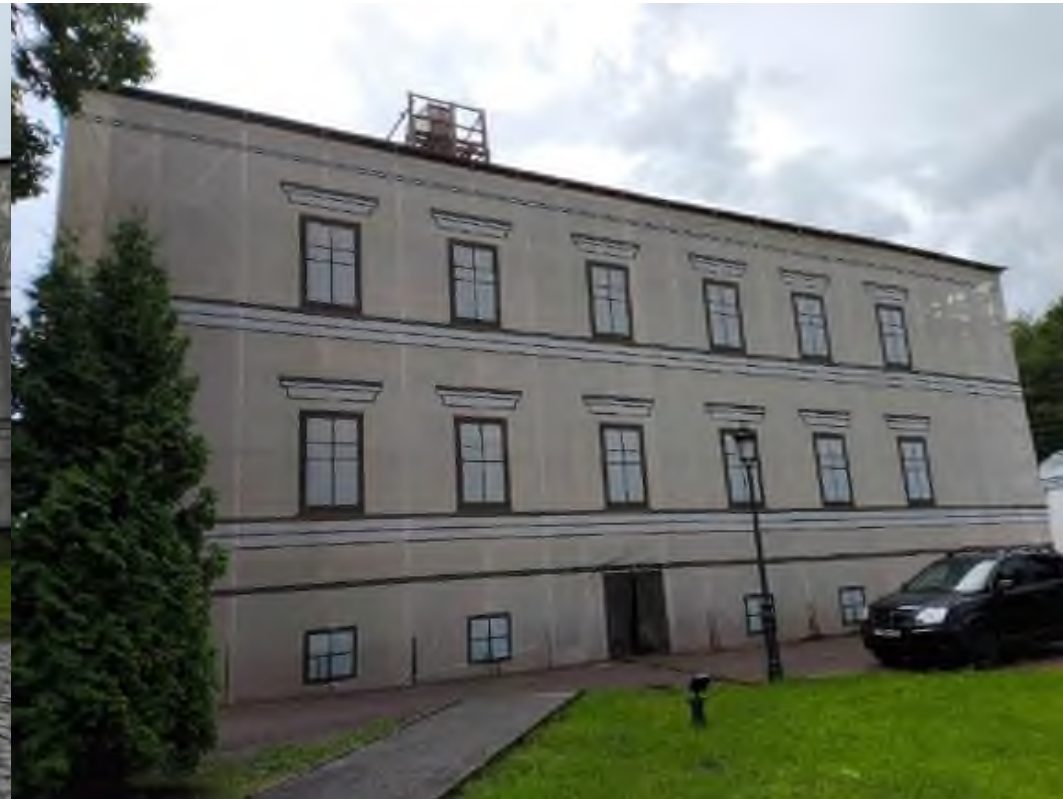
Фото 2. Вид с севера. Фасадные леса с баннером.
