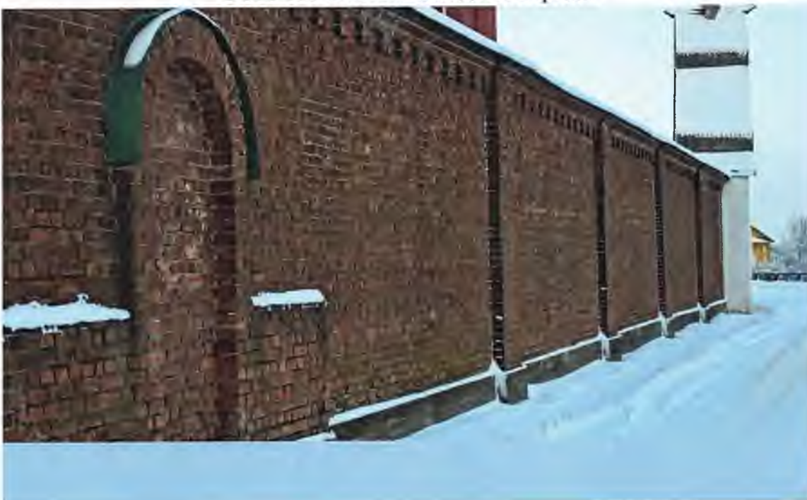
Фото 14. Стены. Восточная ограда.
