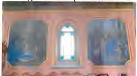
фрагмент южной стены
