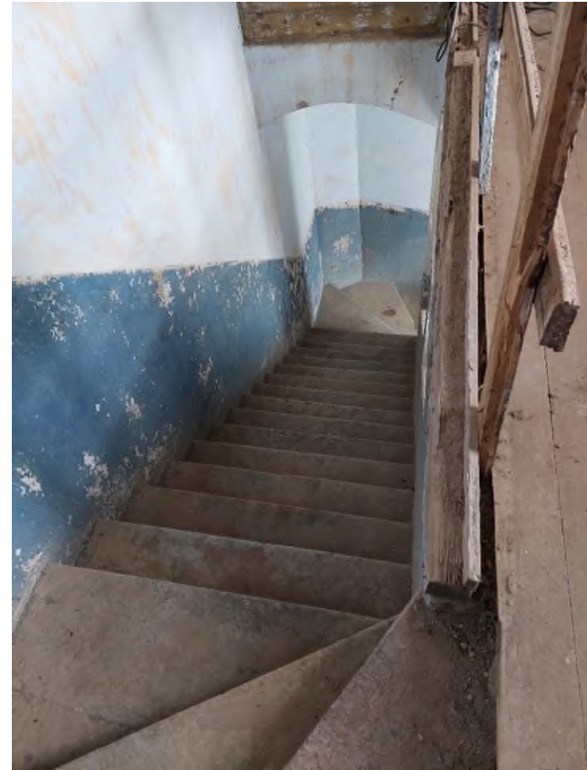
Фото12. Первый этаж. Состояние оштукатуренных стен, каменных ступеней лестницы
