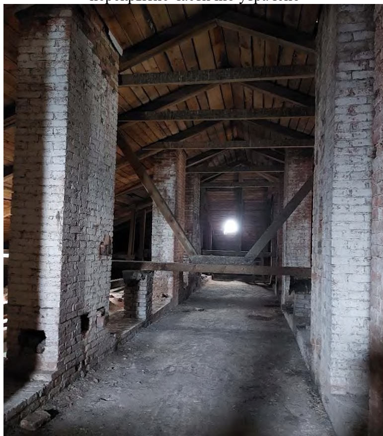
Фото 25. Чердак. Состояние стропильной системы, обрешетки, слухового окна, сохранены кирпичные дымоходы и вентканалы.
