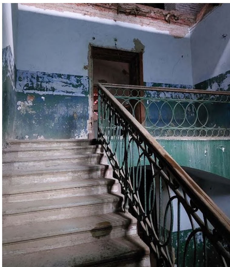
Фото 20. Второй этаж. Состояние оштукатуренных стен, каменной лестницы с кованным ограждением, дверного проема и его заполнения.
