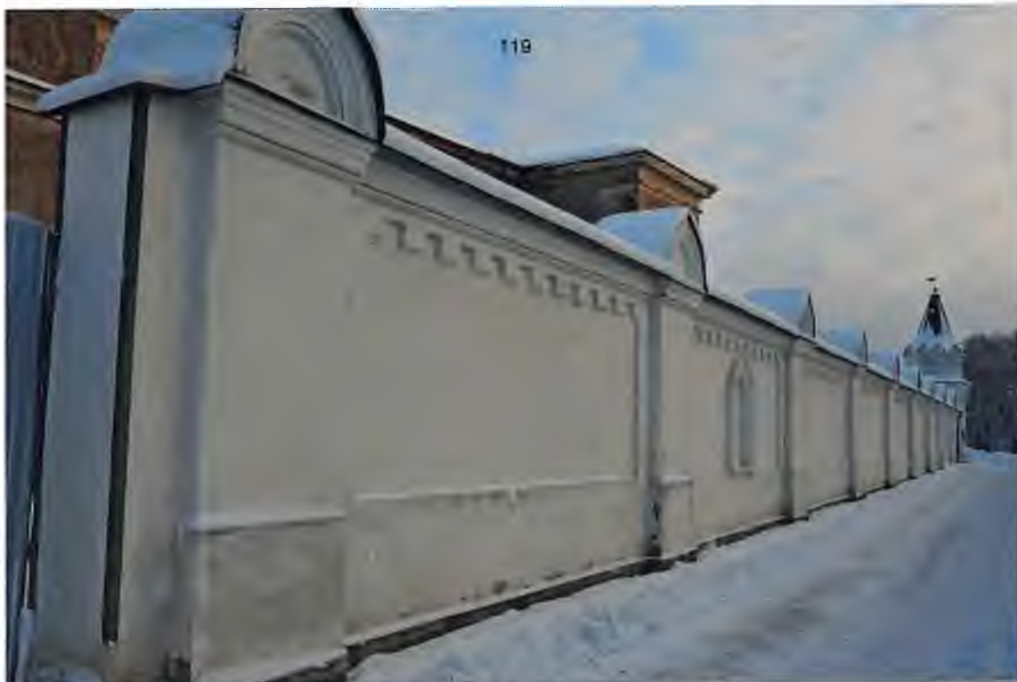
Фото 13. Стены. Западная ограда.
