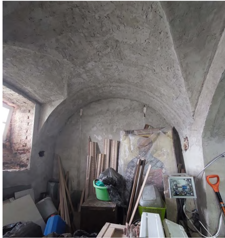
Фото 8 Цокольный этаж. Состояние стен, сводов.
