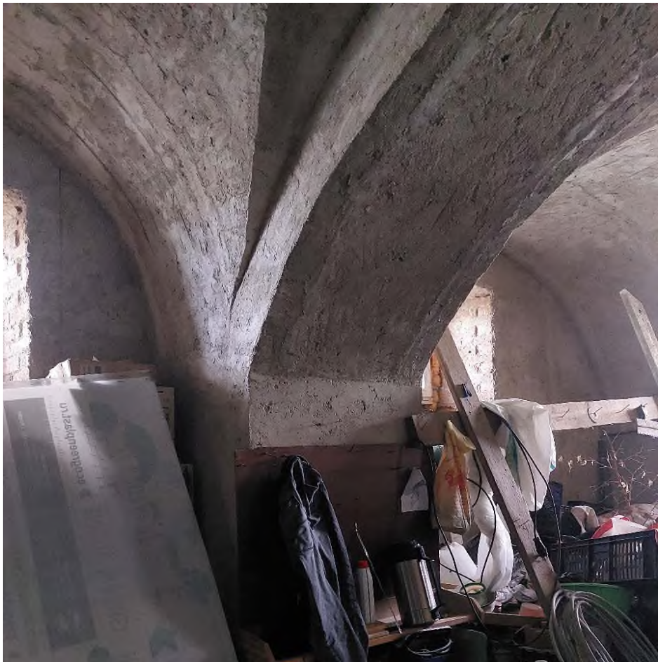
Фото 7. Цокольный этаж. Состояние стен, сводов..
