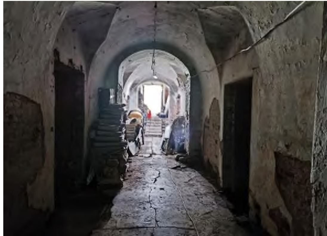
Фото 4. Цокольный этаж. Состояние стен, сводов и полов из лещадных плит.
