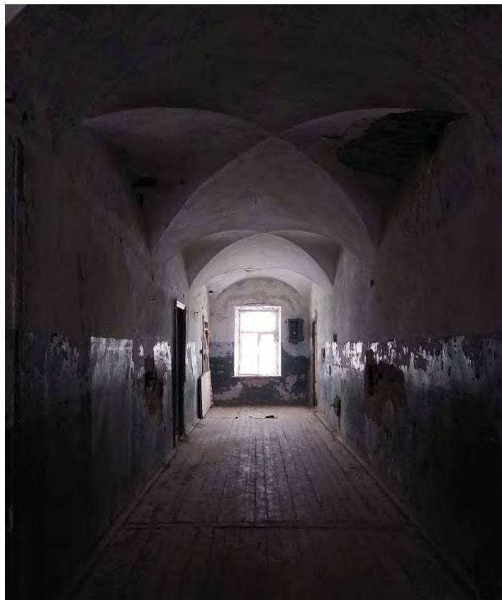
Фото 21. Второй этаж. Состояние оштукатуренных стен, сводов, дощатых полов, оконного, дверных проемов и их заполнений.
