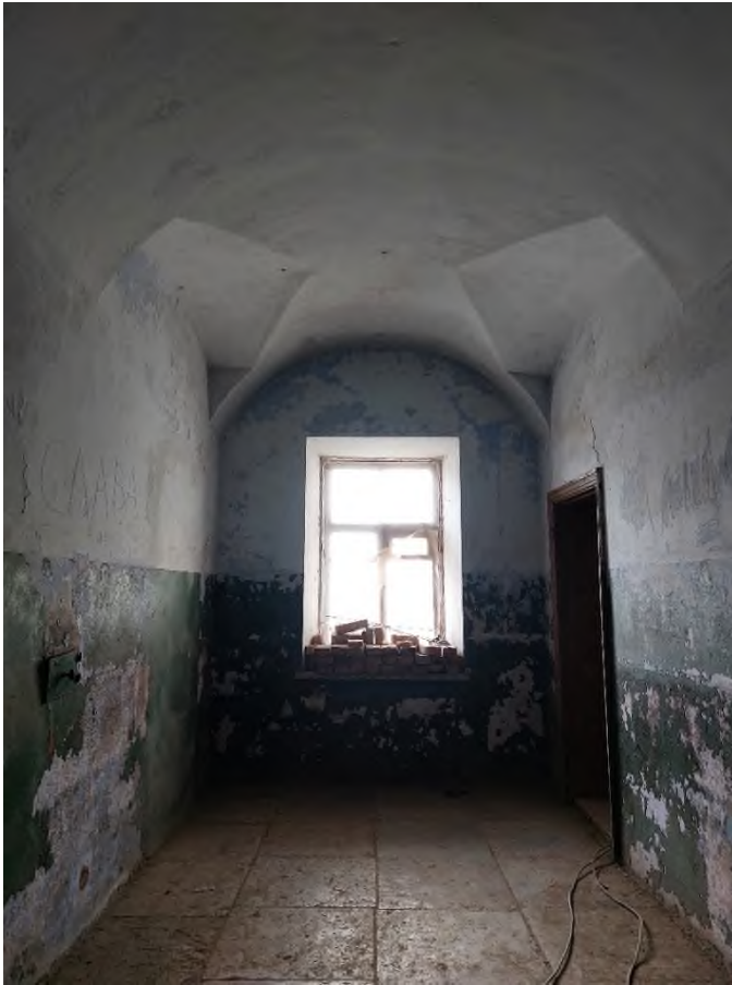
Фото 13. Первый этаж. Состояние оштукатуренных стен, сводов, полов из лещадных плит, оконного, дверного проемов и их заполнений.
