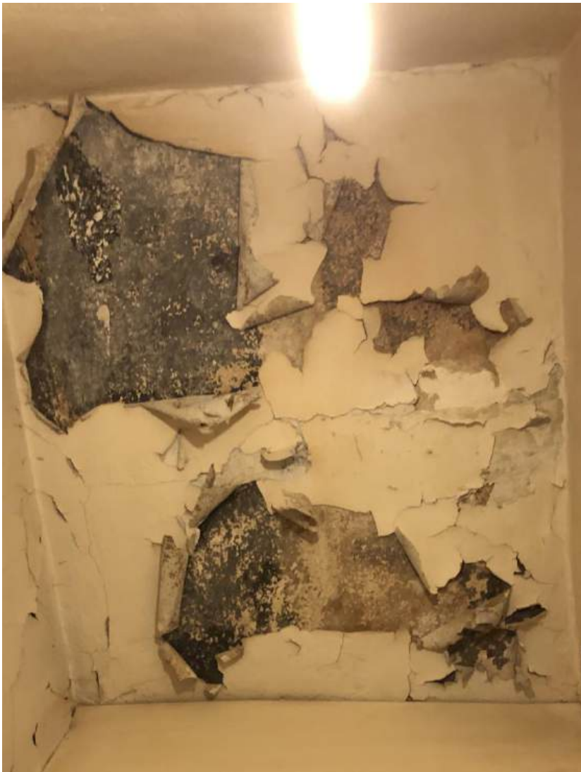
Фото 12. Пом. 7. Потолок и перекрытия в помещении. Дата съемки: 19.11.2025 г. Автор съемки: Хватова Ж.А.
