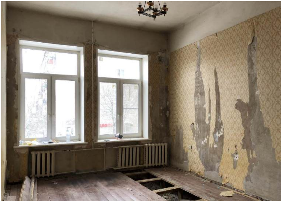
Фото 6. Пом. 1. Общий вид помещения с запада. Дата съемки: 19.11.2025 г. Автор съемки: Хватова Ж.А.
