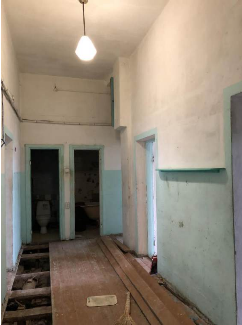
Фото 11. Пом. 6. Общий вид помещения с северо-запада. Дата съемки: 19.11.2025 г. Автор съемки: Хватова Ж.А.
