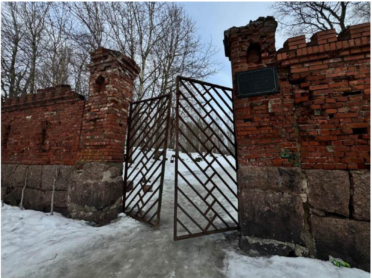
Фот.6. Фрагмент каменной стены с западными воротами
