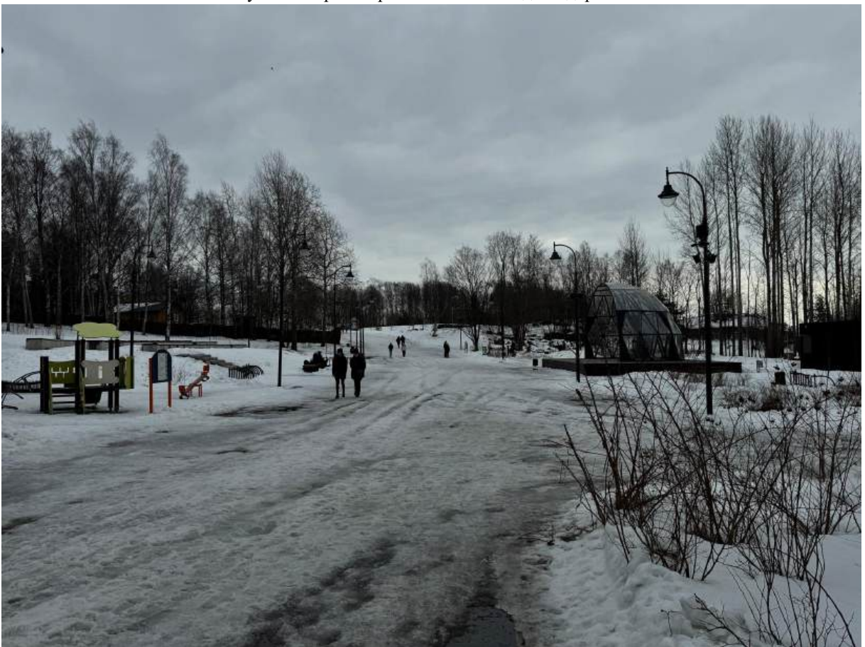
Фот.13. Вид на центральную часть территории Ансамбля, на которой проведены работы по благоустройству территории с установкой МАФ, а также на участок уже построенной части велодорожки на территории Ансамбля
