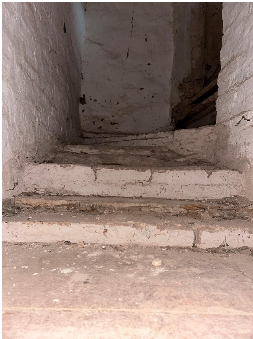
35. Объект культурного наследия федерального значения «Башня Введенская с Передними воротами, церковью Тихвинской Божией матери и часовней «Крылечко», входящий в состав объекта культурного наследия федерального значения «Ансамбль Большого Тихвинского монастыря» по адресу: Ленинградская область, Тихвинский муниципальный район, Тихвинское городское поселение, г. Тихвин, ул. Тихвинская, д. 1. Южная лестница. Фрагмент.
