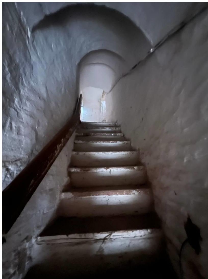
34. Объект культурного наследия федерального значения «Башня Введенская с Передними воротами, церковью Тихвинской Божией матери и часовней «Крылечко», входящий в состав объекта культурного наследия федерального значения «Ансамбль Большого Тихвинского монастыря» по адресу: Ленинградская область, Тихвинский муниципальный район, Тихвинское городское поселение, г. Тихвин, ул. Тихвинская, д. 1. Южная лестница. Общий вид.
