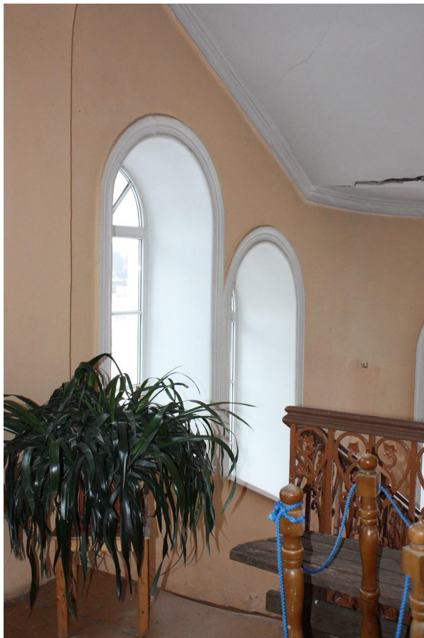
39. Объект культурного наследия федерального значения «Башня Введенская с Передними воротами, церковью Тихвинской Божией матери и часовней «Крылечко», входящий в состав объекта культурного наследия федерального значения «Ансамбль Большого Тихвинского монастыря» по адресу: Ленинградская область, Тихвинский муниципальный район, Тихвинское городское поселение, г. Тихвин, ул. Тихвинская, д. 1. Центральная лестница. Второй этаж. Фрагмент интерьера.
