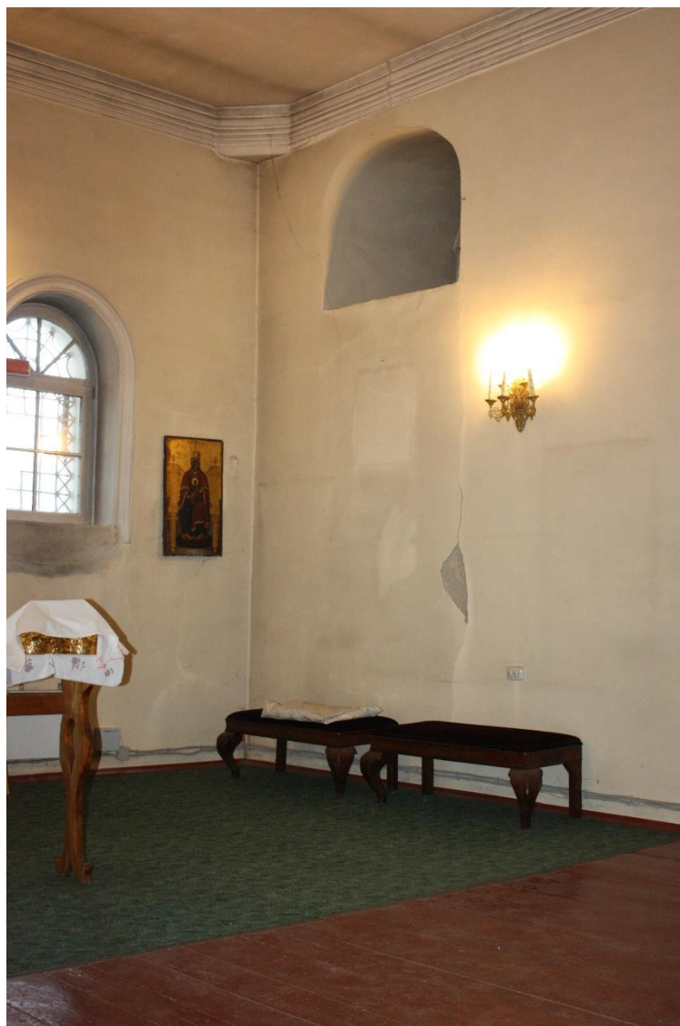
50. Объект культурного наследия федерального значения «Башня Введенская с Передними воротами, церковью Тихвинской Божией матери и часовней «Крылечко», входящий в состав объекта культурного наследия федерального значения «Ансамбль Большого Тихвинского монастыря» по адресу: Ленинградская область, Тихвинский муниципальный район, Тихвинское городское поселение, г. Тихвин, ул. Тихвинская, д. 1. Второй этаж. Храм. Алтарная часть. Фрагмент интерьера.
