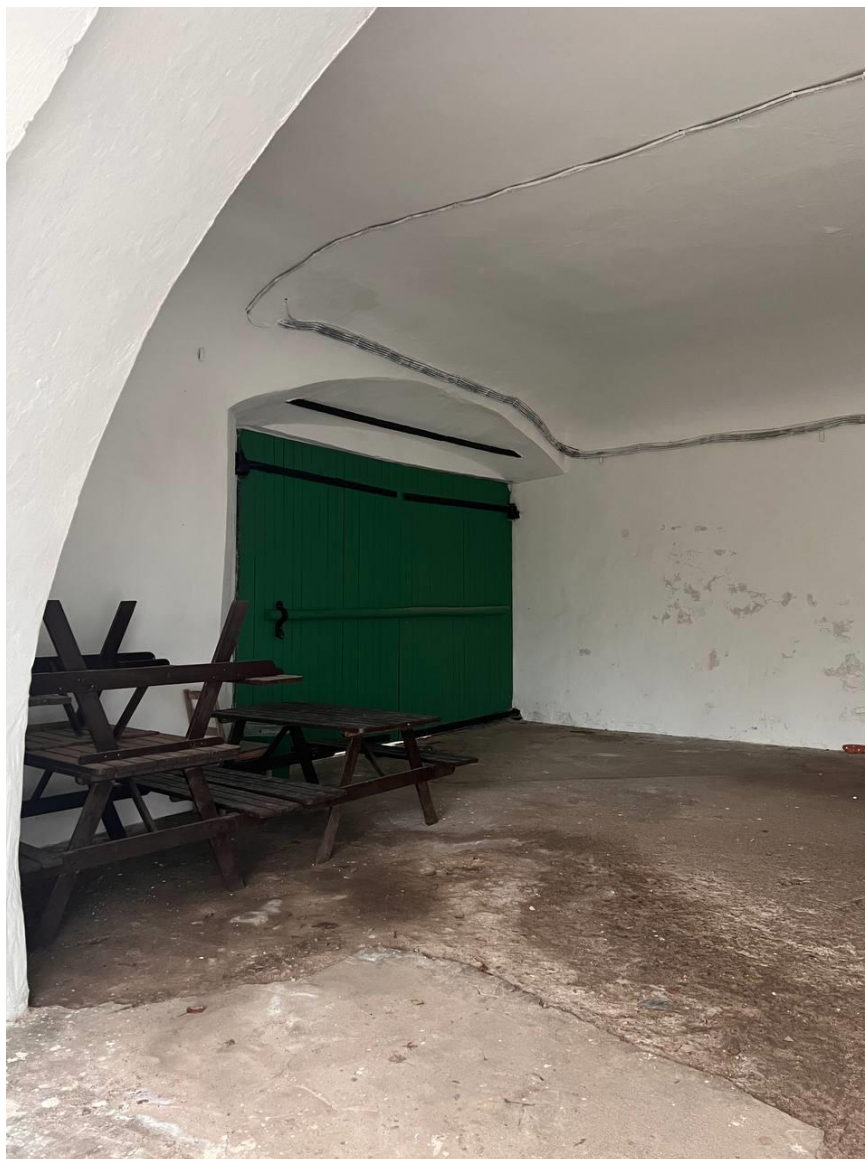
21. Объект культурного наследия федерального значения «Башня Введенская с Передними воротами, церковью Тихвинской Божией матери и часовней «Крылечко», входящий в состав объекта культурного наследия федерального значения «Ансамбль Большого Тихвинского монастыря» по адресу: Ленинградская область, Тихвинский муниципальный район, Тихвинское городское поселение, г. Тихвин, ул. Тихвинская, д. 1. Восточный арочный проезд. Фрагмент.
