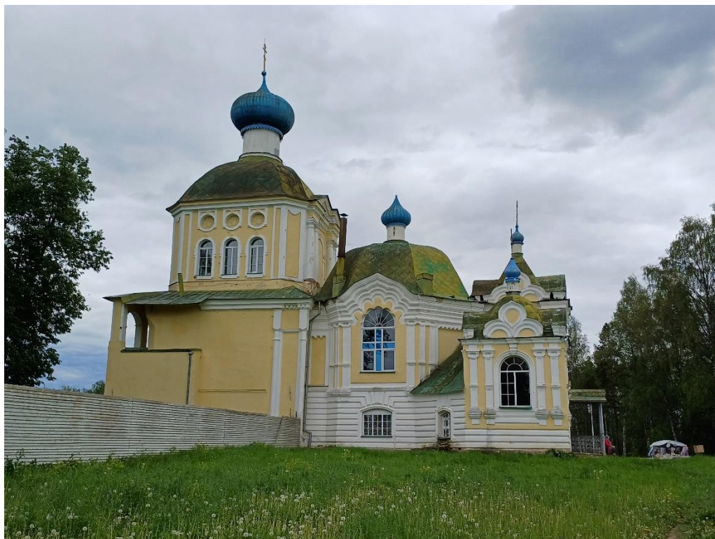
11. Объект культурного наследия федерального значения «Башня Введенская с Передними воротами, церковью Тихвинской Божией матери и часовней «Крылечко», входящий в состав объекта культурного наследия федерального значения «Ансамбль Большого Тихвинского монастыря» по адресу: Ленинградская область, Тихвинский муниципальный район, Тихвинское городское поселение, г. Тихвин, ул. Тихвинская, д. 1. Северный фасад. Общий вид.
