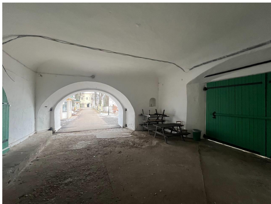
19. Объект культурного наследия федерального значения «Башня Введенская с Передними воротами, церковью Тихвинской Божией матери и часовней «Крылечко», входящий в состав объекта культурного наследия федерального значения «Ансамбль Большого Тихвинского монастыря» по адресу: Ленинградская область, Тихвинский муниципальный район, Тихвинское городское поселение, г. Тихвин, ул. Тихвинская, д. 1. Восточный арочный проезд. Общий вид.
