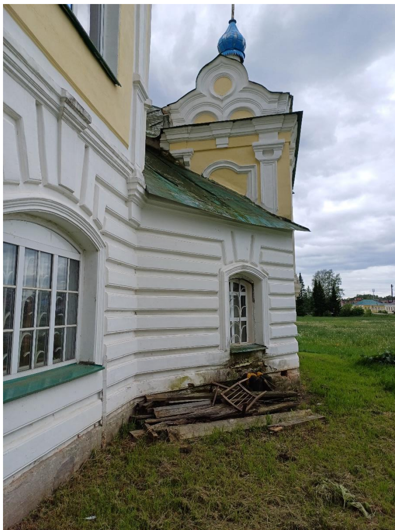
12. Объект культурного наследия федерального значения «Башня Введенская с Передними воротами, церковью Тихвинской Божией матери и часовней «Крылечко», входящий в состав объекта культурного наследия федерального значения «Ансамбль Большого Тихвинского монастыря» по адресу: Ленинградская область, Тихвинский муниципальный район, Тихвинское городское поселение, г. Тихвин, ул. Тихвинская, д. 1. Северный фасад. Фрагмент.
