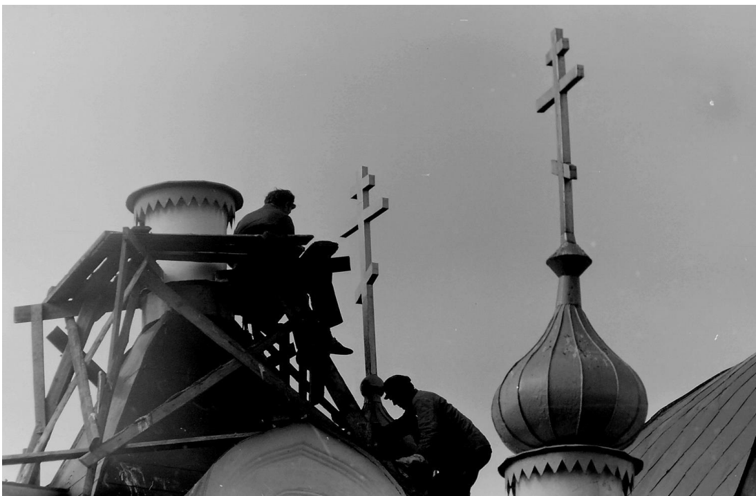
54. Церковь «Крылечко». Установка главки. Фотография. 1990 г. Из частного архива.
