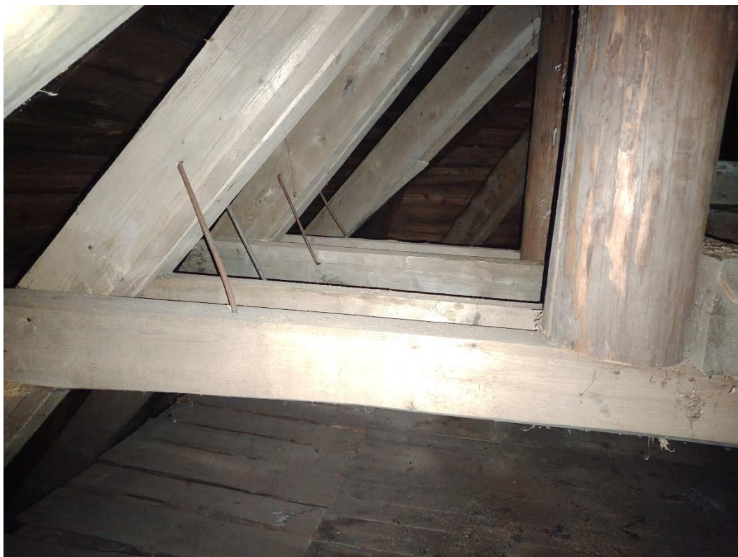
57. Объект культурного наследия федерального значения «Башня Введенская с Передними воротами, церковью Тихвинской Божией матери и часовней «Крылечко», входящий в состав объекта культурного наследия федерального значения «Ансамбль Большого Тихвинского монастыря» по адресу: Ленинградская область, Тихвинский муниципальный район, Тихвинское городское поселение, г. Тихвин, ул. Тихвинская, д. 1. Чердак (в объеме башни). Фрагмент интерьера.
