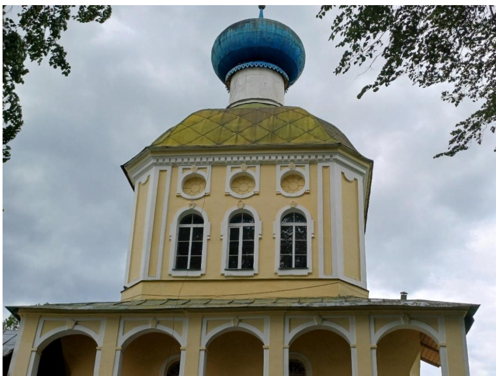
15. Объект культурного наследия федерального значения «Башня Введенская с Передними воротами, церковью Тихвинской Божией матери и часовней «Крылечко», входящий в состав объекта культурного наследия федерального значения «Ансамбль Большого Тихвинского монастыря» по адресу: Ленинградская область, Тихвинский муниципальный район, Тихвинское городское поселение, г. Тихвин, ул. Тихвинская, д. 1. Восточный фасад. Фрагмент. Вид на башню и галерею.
