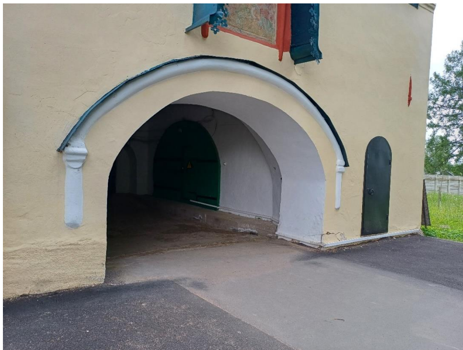
18. Объект культурного наследия федерального значения «Башня Введенская с Передними воротами, церковью Тихвинской Божией матери и часовней «Крылечко», входящий в состав объекта культурного наследия федерального значения «Ансамбль Большого Тихвинского монастыря» по адресу: Ленинградская область, Тихвинский муниципальный район, Тихвинское городское поселение, г. Тихвин, ул. Тихвинская, д. 1. Северо-восточный фасад. Фрагмент. Вид на арочный проезд.
