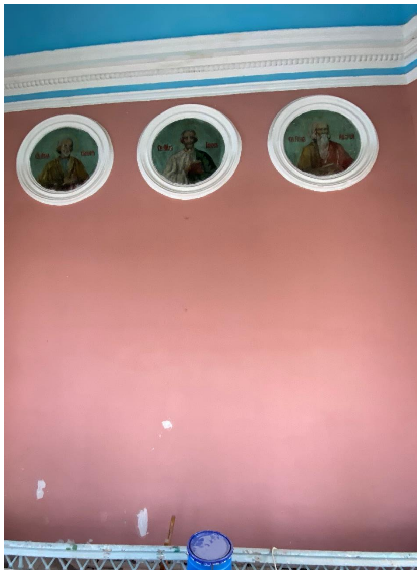
53. Объект культурного наследия федерального значения «Башня Введенская с Передними воротами, церковью Тихвинской Божией матери и часовней «Крылечко», входящий в состав объекта культурного наследия федерального значения «Ансамбль Большого Тихвинского монастыря» по адресу: Ленинградская область, Тихвинский муниципальный район, Тихвинское городское поселение, г. Тихвин, ул. Тихвинская, д. 1. Хоры. Фрагмент интерьера.
