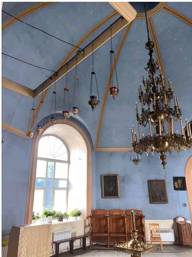
45. Объект культурного наследия федерального значения «Башня Введенская с Передними воротами, церковью Тихвинской Божией матери и часовней «Крылечко», входящий в состав объекта культурного наследия федерального значения «Ансамбль Большого Тихвинского монастыря» по адресу: Ленинградская область, Тихвинский муниципальный район, Тихвинское городское поселение, г. Тихвин, ул. Тихвинская, д. 1. Второй этаж. Церковь Тихвинской Божией Матери. Фрагмент интерьера.
