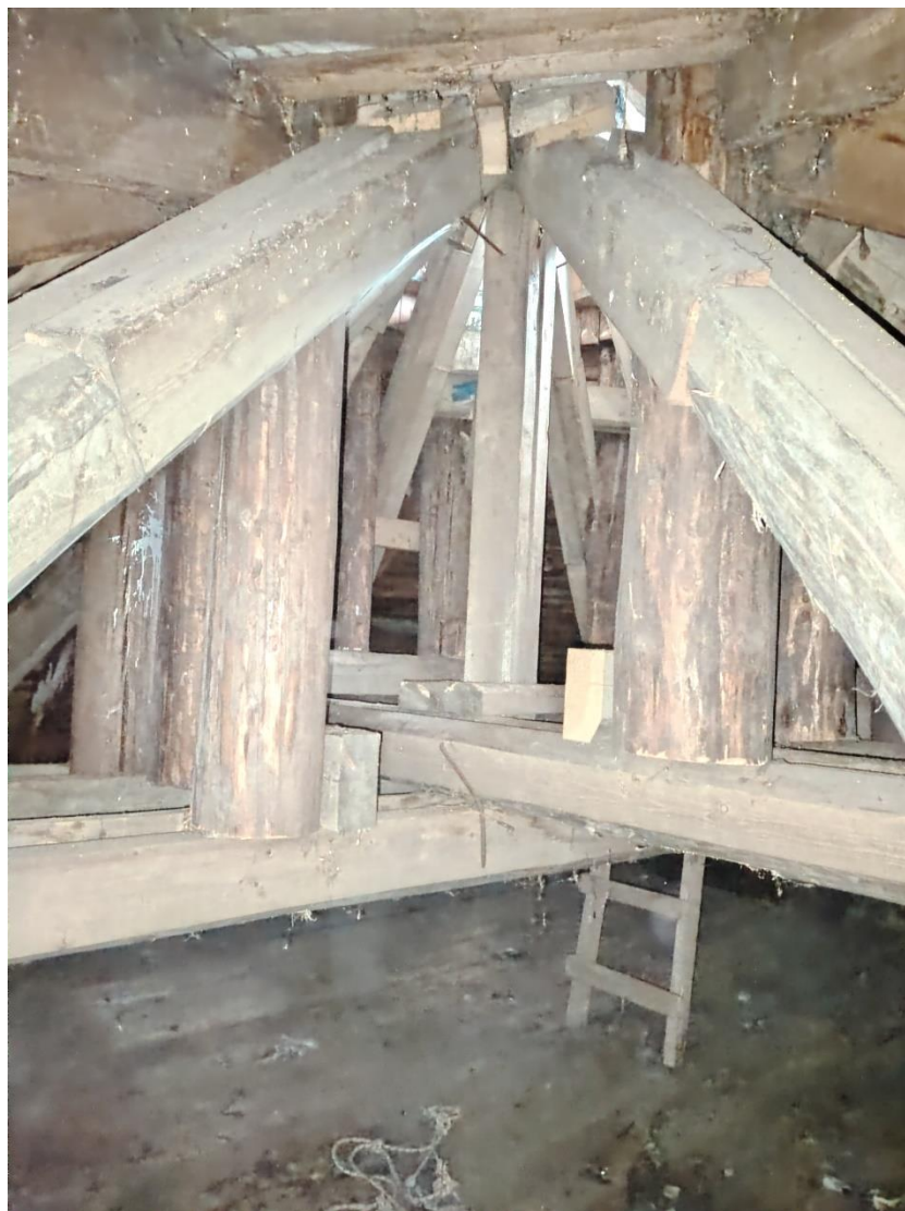
55. Объект культурного наследия федерального значения «Башня Введенская с Передними воротами, церковью Тихвинской Божией матери и часовней «Крылечко», входящий в состав объекта культурного наследия федерального значения «Ансамбль Большого Тихвинского монастыря» по адресу: Ленинградская область, Тихвинский муниципальный район, Тихвинское городское поселение, г. Тихвин, ул. Тихвинская, д. 1. Чердак (в объеме башни). Фрагмент интерьера.
