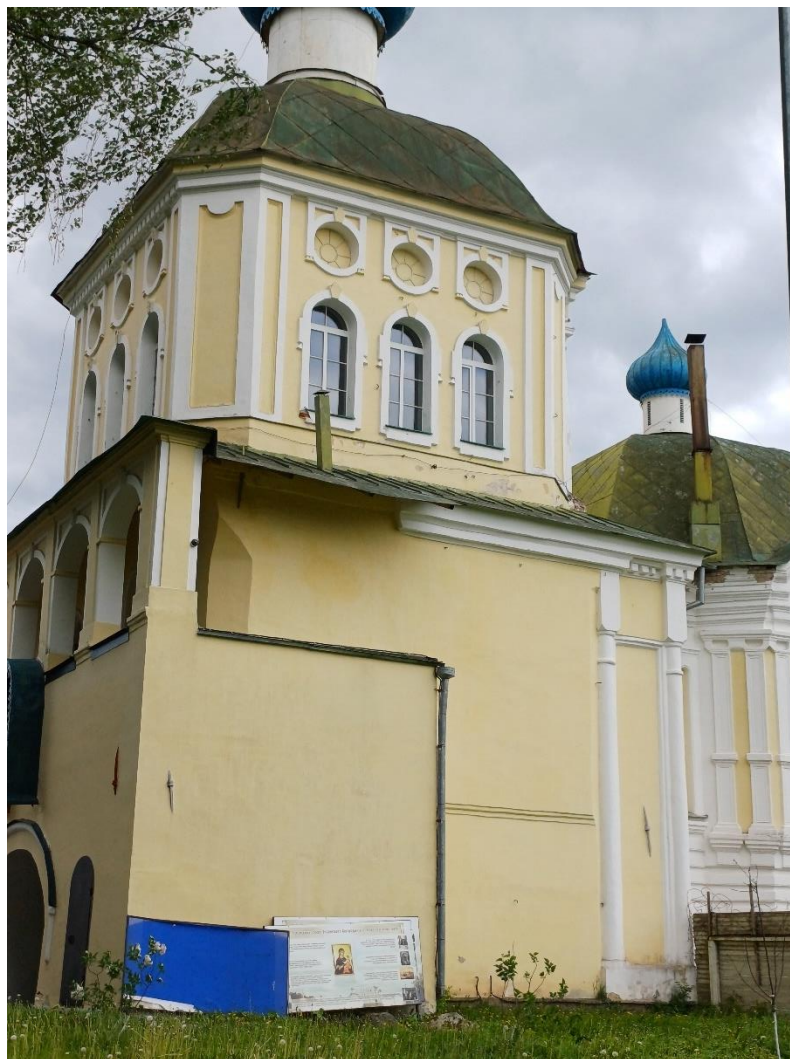
13. Объект культурного наследия федерального значения «Башня Введенская с Передними воротами, церковью Тихвинской Божией матери и часовней «Крылечко», входящий в состав объекта культурного наследия федерального значения «Ансамбль Большого Тихвинского монастыря» по адресу: Ленинградская область, Тихвинский муниципальный район, Тихвинское городское поселение, г. Тихвин, ул. Тихвинская, д. 1. Северный фасад. Фрагмент.
