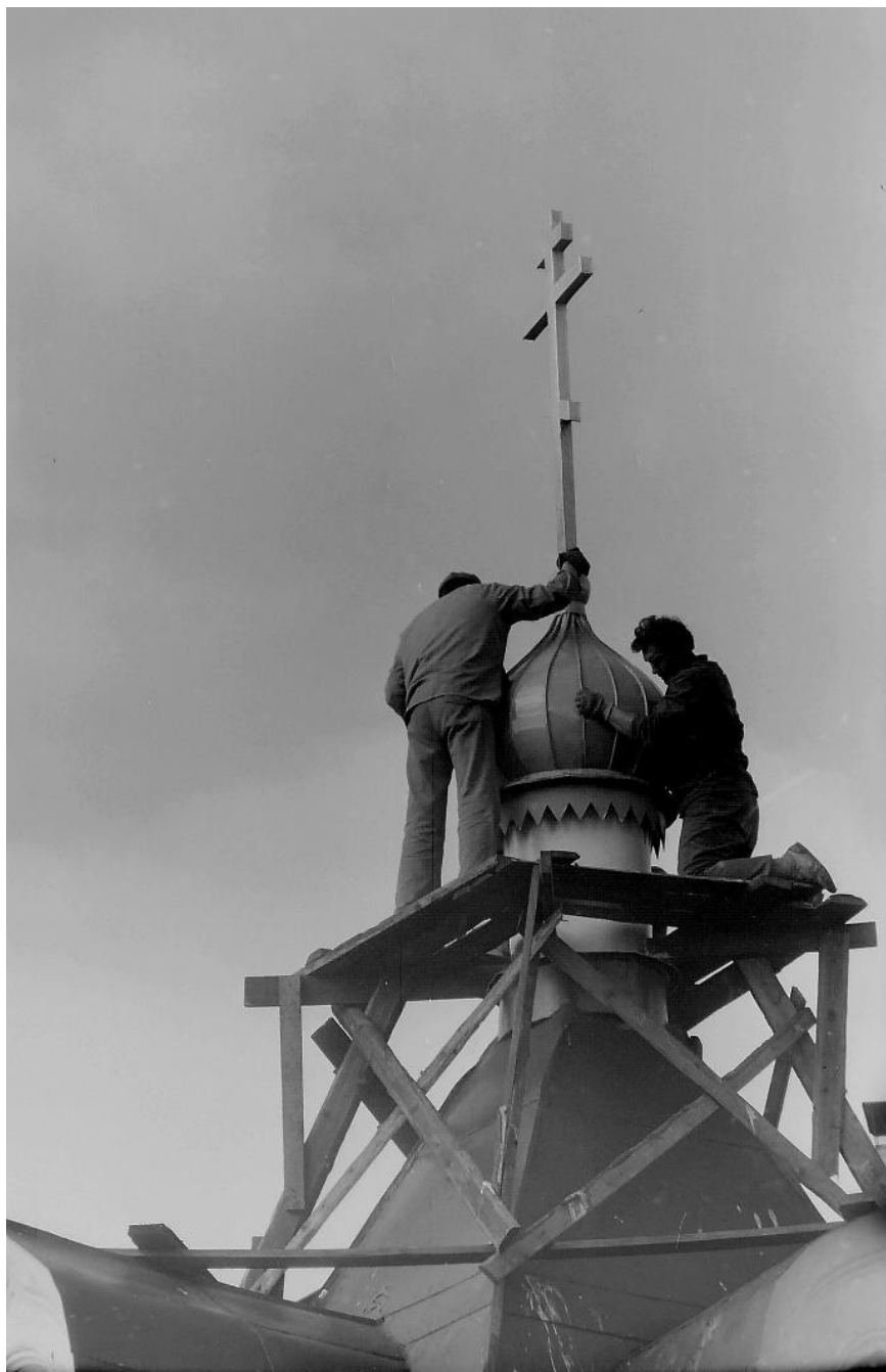
53. Церковь «Крылечко». Установка главки. Фотография. 1990 г. Из частного архива.
