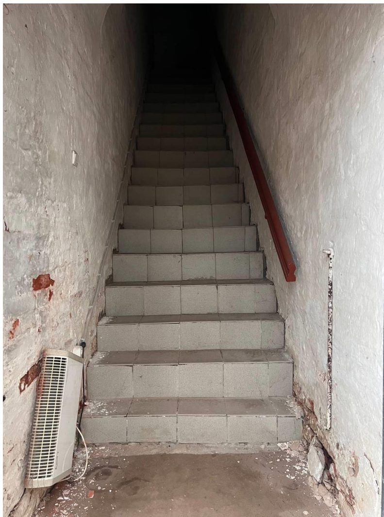
31. Объект культурного наследия федерального значения «Башня Введенская с Передними воротами, церковью Тихвинской Божией матери и часовней «Крылечко», входящий в состав объекта культурного наследия федерального значения «Ансамбль Большого Тихвинского монастыря» по адресу: Ленинградская область, Тихвинский муниципальный район, Тихвинское городское поселение, г. Тихвин, ул. Тихвинская, д. 1. Северная лестница на второй этаж (в алтарь). Общий вид.
