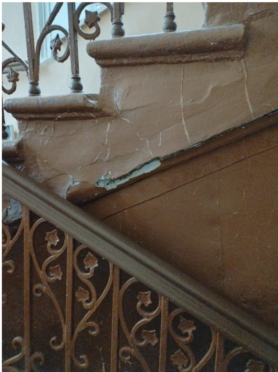
41. Объект культурного наследия федерального значения «Башня Введенская с Передними воротами, церковью Тихвинской Божией матери и часовней «Крылечко», входящий в состав объекта культурного наследия федерального значения «Ансамбль Большого Тихвинского монастыря» по адресу: Ленинградская область, Тихвинский муниципальный район, Тихвинское городское поселение, г. Тихвин, ул. Тихвинская, д. 1. Центральная лестница. Ограждение. Фрагмент.
