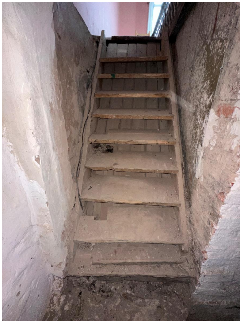
36. Объект культурного наследия федерального значения «Башня Введенская с Передними воротами, церковью Тихвинской Божией матери и часовней «Крылечко», входящий в состав объекта культурного наследия федерального значения «Ансамбль Большого Тихвинского монастыря» по адресу: Ленинградская область, Тихвинский муниципальный район, Тихвинское городское поселение, г. Тихвин, ул. Тихвинская, д. 1. Южная лестница. Фрагмент.
