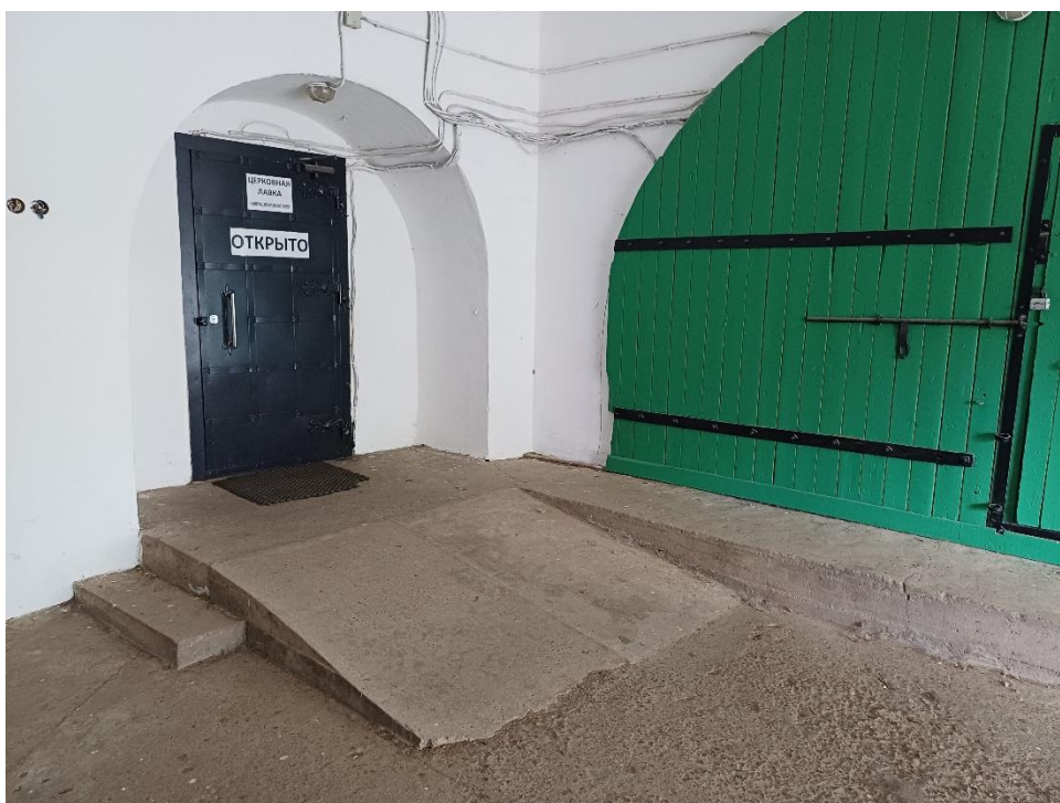
20. Объект культурного наследия федерального значения «Башня Введенская с Передними воротами, церковью Тихвинской Божией матери и часовней «Крылечко», входящий в состав объекта культурного наследия федерального значения «Ансамбль Большого Тихвинского монастыря» по адресу: Ленинградская область, Тихвинский муниципальный район, Тихвинское городское поселение, г. Тихвин, ул. Тихвинская, д. 1. Восточный арочный проезд. Фрагмент.
