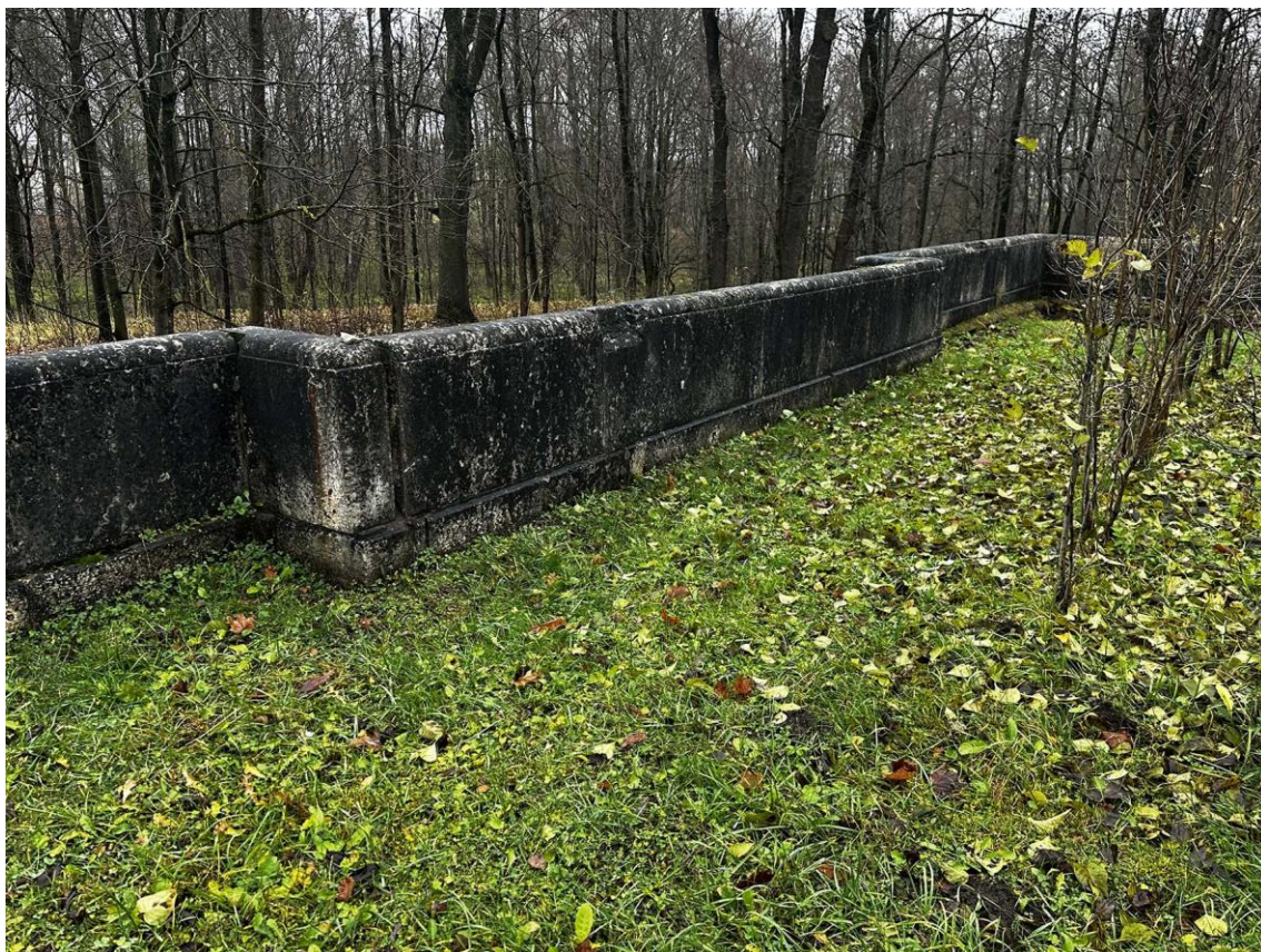
Фото 83. Юго-восточная часть подпорных (парапетных) стен. Средняя часть внутренней стороны стены на участке 15-16. Фото с запада. Дата съемки: 15.11.2025 г. Автор съемки: Куваева Ю.П.
