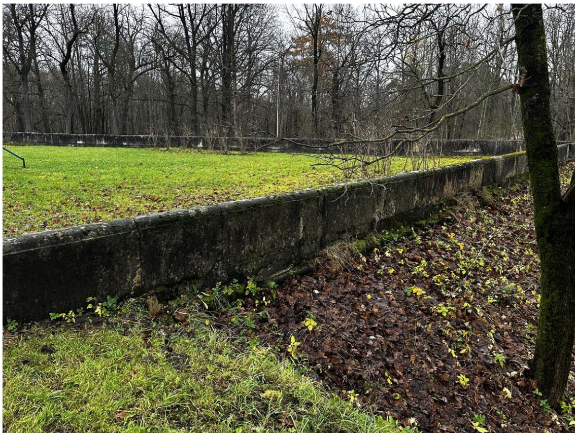
Фото 101. Юго-восточная часть подпорных (парапетных) стен. Общий вид наружной стороны стены на участке 19-18. Фото с запада. Дата съемки: 15.11.2025 г. Автор съемки: Куваева Ю.П.
