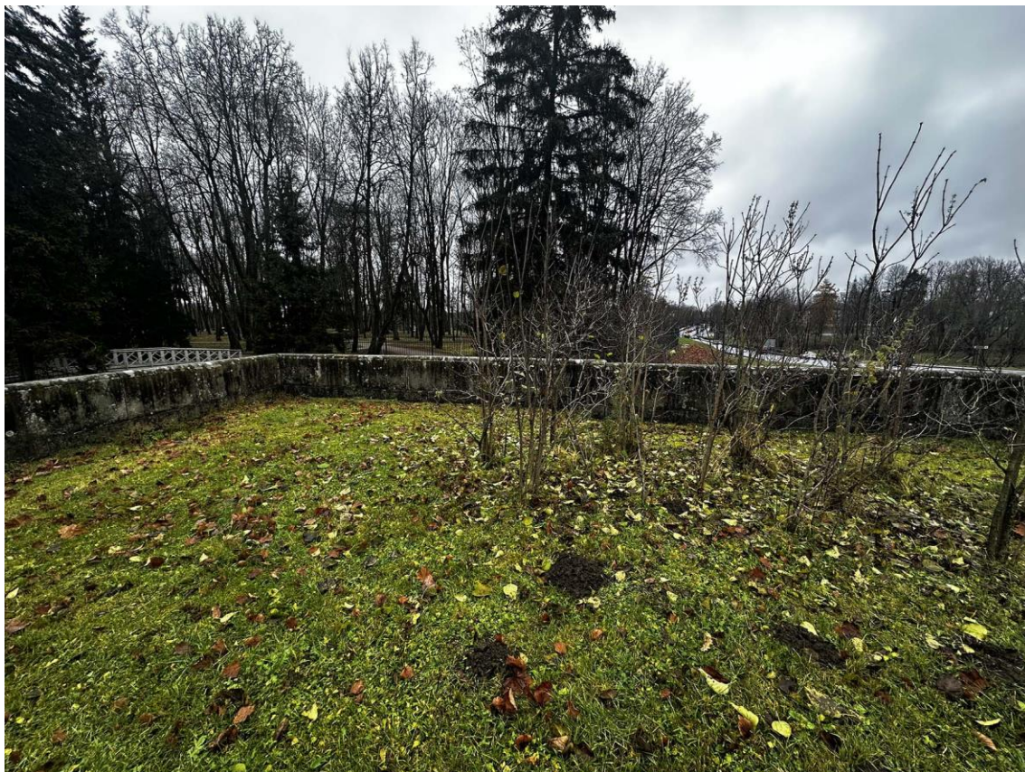
Фото 37. Северная часть подпорных (парапетных) стен. Общий вид левой части внутренней стороны стены на участке 5-6. Фото с юга. Дата съемки: 15.11.2025 г. Автор съемки: Куваева Ю.П.
