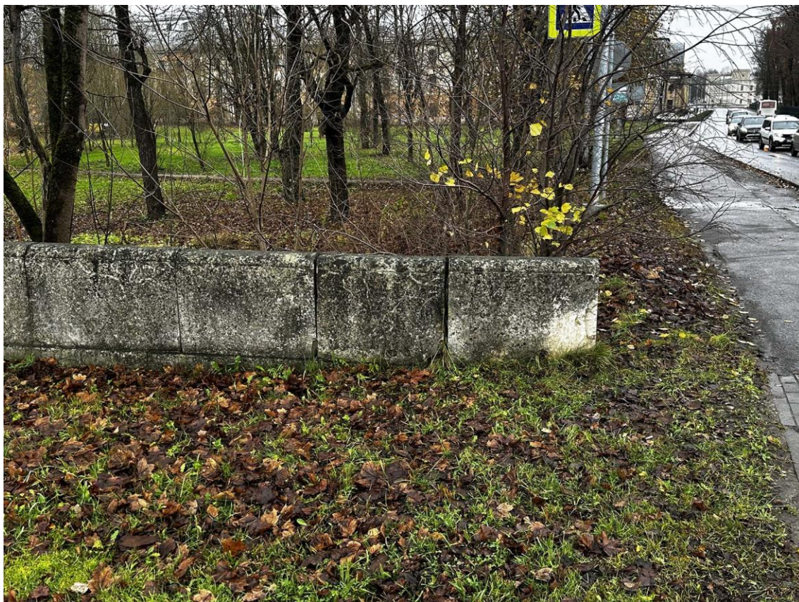
Фото 15. Западная часть подпорных (парапетных) стен. Фрагмент внутренней стороны крайней правой части стены на участке 2-3. Фото с юго-востока. Дата съемки: 15.11.2025 г. Автор съемки: Куваева Ю.П.
