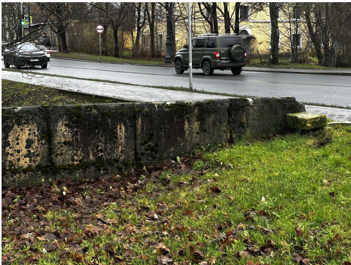
Фото 97. Юго-восточная часть подпорных (парапетных) стен. Правая часть внутренней стороны стены на участке 18-19. Фото с северо-востока. Фрагмент. Дата съемки: 15.11.2025 г. Автор съемки: Куваева Ю.П.
