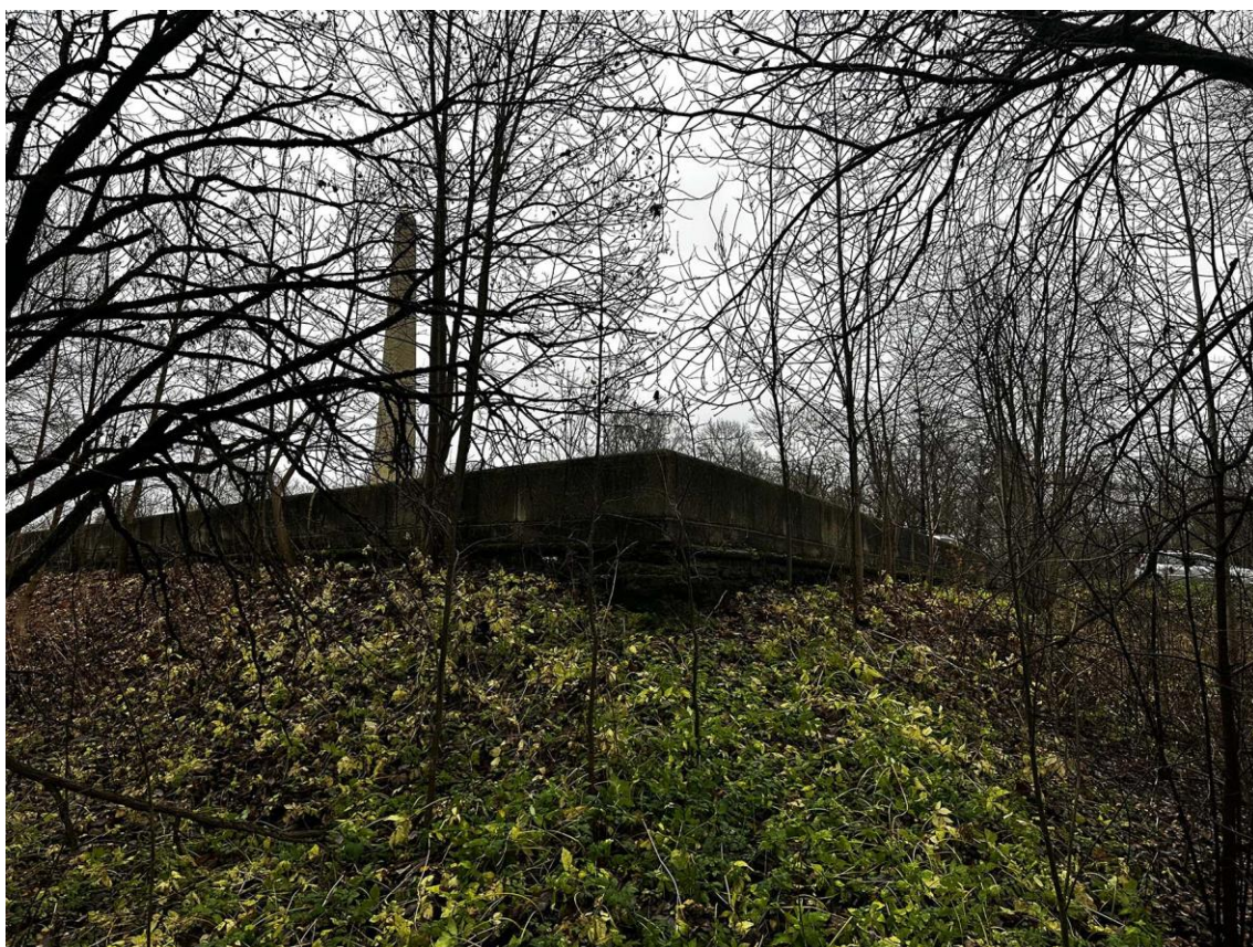
Фото 22. Западная часть подпорных (парапетных) стен. Наружный угол стены (точка 2). Фото с запада. Общий вид. Дата съемки: 15.11.2025 г. Автор съемки: Куваева Ю.П.
