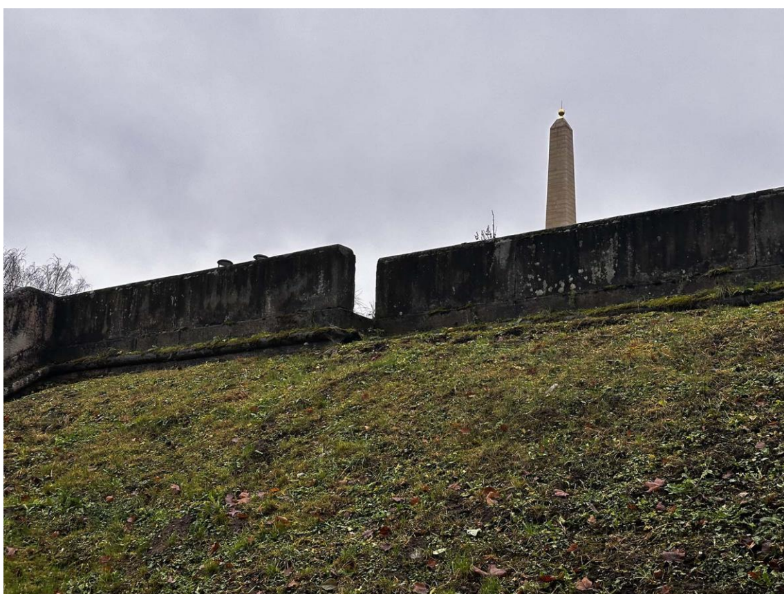
Фото 58. Северная часть подпорных (парапетных) стен. Фрагмент средней части наружной стороны стены на участке 9-5. Фото с севера. Дата съемки: 15.11.2025 г. Автор съемки: Куваева Ю.П.
