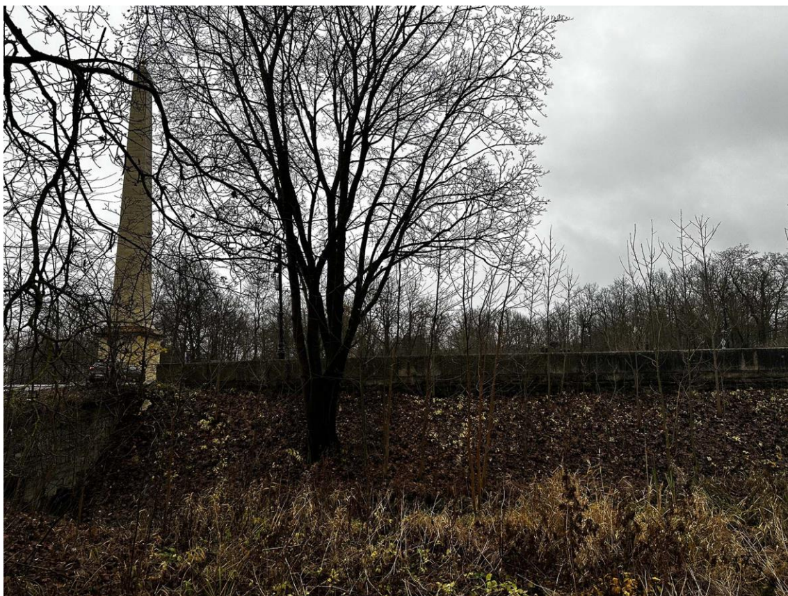
Фото 18. Западная часть подпорных (парапетных) стен. Общий вид наружной стороны стены на участке 3-2. Фото с северо-запада. Дата съемки: 15.11.2025 г. Автор съемки: Куваева Ю.П.
