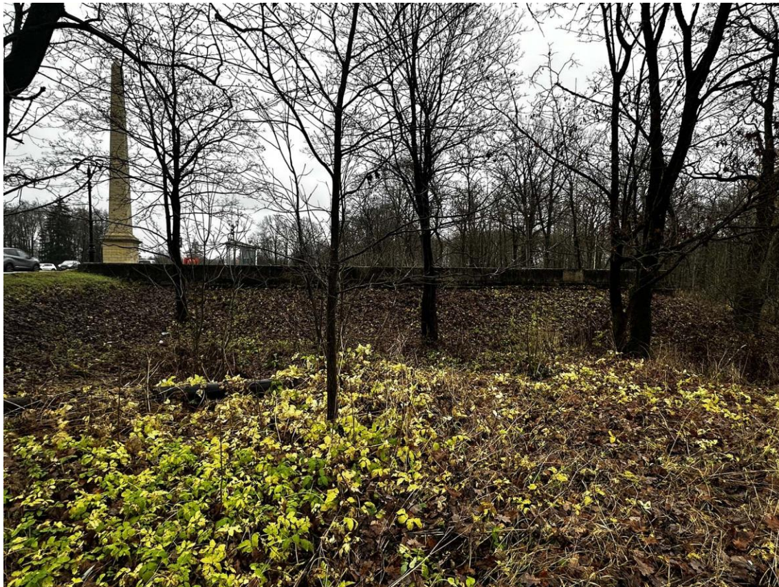
Фото 102. Юго-восточная часть подпорных (парапетных) стен. Общий вид наружной стороны стены на участке 19-18. Фото с юго-запада. Дата съемки: 15.11.2025 г. Автор съемки: Куваева Ю.П.
