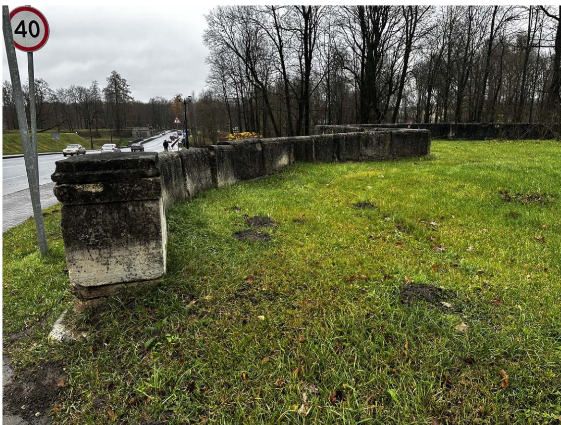
Фото 78. Юго-восточная часть подпорных (парапетных) стен. Общий вид стены с завершающей тумбой на участке 13-14. Фото с юго-запада. Дата съемки: 15.11.2025 г. Автор съемки: Куваева Ю.П.
