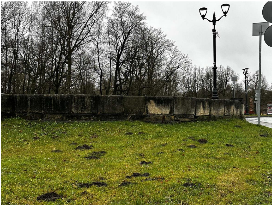
Фото 75. Юго-восточная часть подпорных (парапетных) стен. Фото с севера. Дата съемки: 15.11.2025 г. Автор съемки: Куваева Ю.П.
