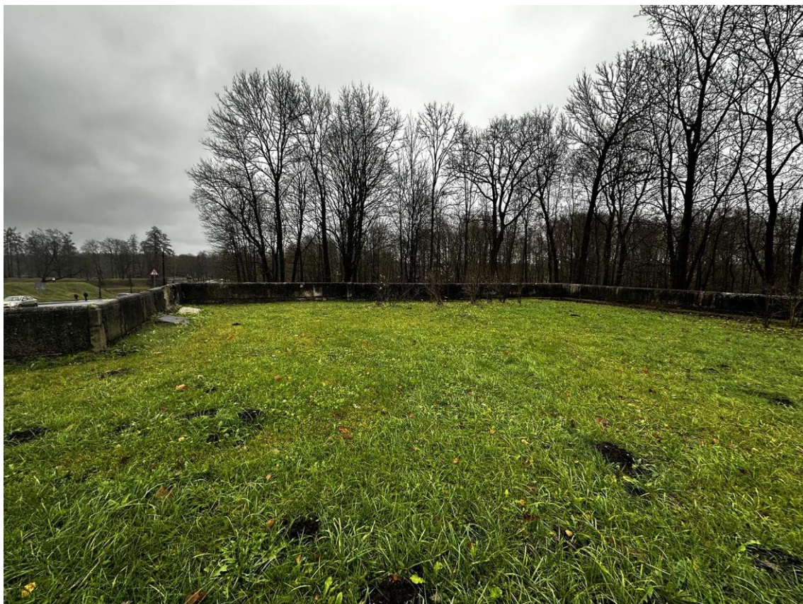
Фото 81. Юго-восточная часть подпорных (парапетных) стен. Общий вид внутренней стороны стен на участках 14-15-16. Фото с юго-запада. Дата съемки: 15.11.2025 г. Автор съемки: Куваева Ю.П.
