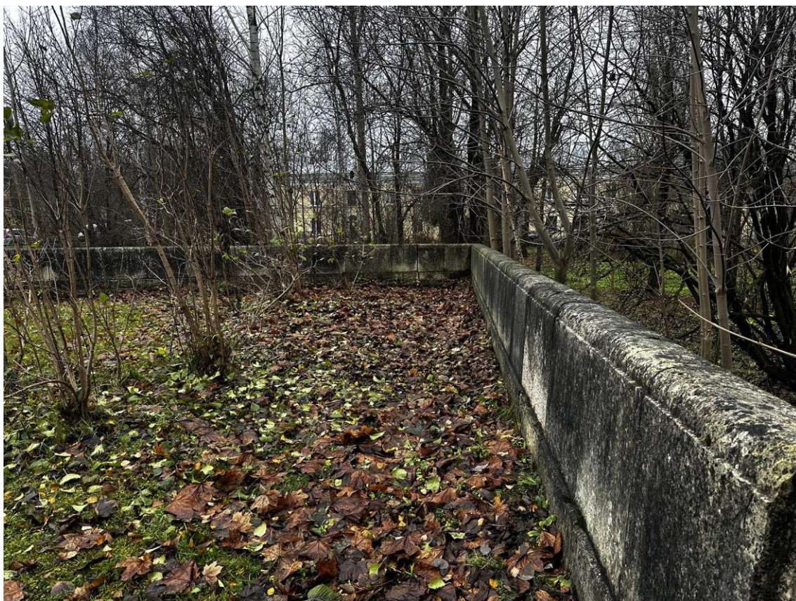
Фото 12. Западная часть подпорных (парапетных) стен. Общий вид внутренней стороны стены на участке 2-3. Фото с северо-востока. Дата съемки: 15.11.2025 г. Автор съемки: Куваева Ю.П.
