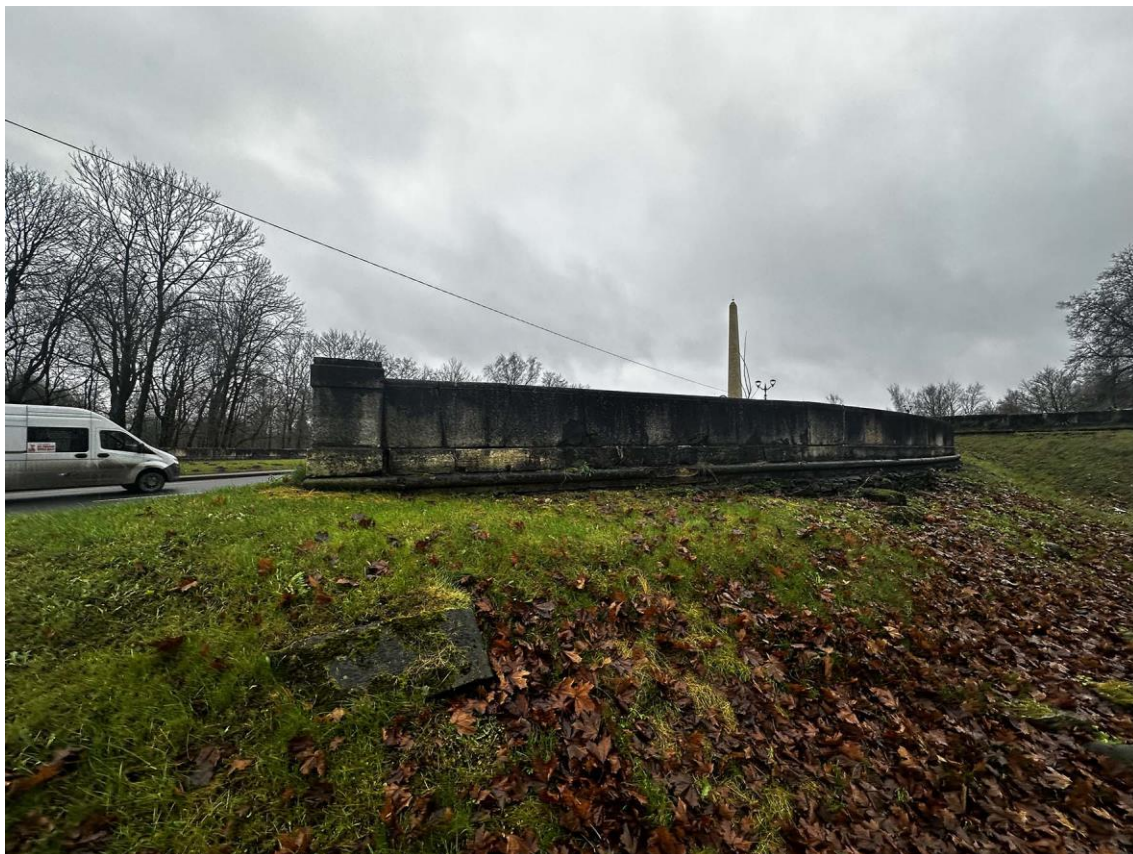
Фото 53. Северная часть подпорных (парапетных) стен. Общий вид наружной стороны стены с завершающей тумбой на участке 10-9. Фото с севера. Дата съемки: 15.11.2025 г. Автор съемки: Куваева Ю.П.
