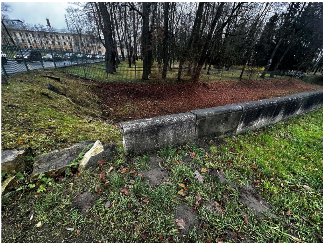
Фото 31. Северная часть подпорных (парапетных) стен. Фрагмент левой части внутренней стороны стены на участке 4-5. Фото с юго-востока. Дата съемки: 15.11.2025 г. Автор съемки: Куваева Ю.П.
