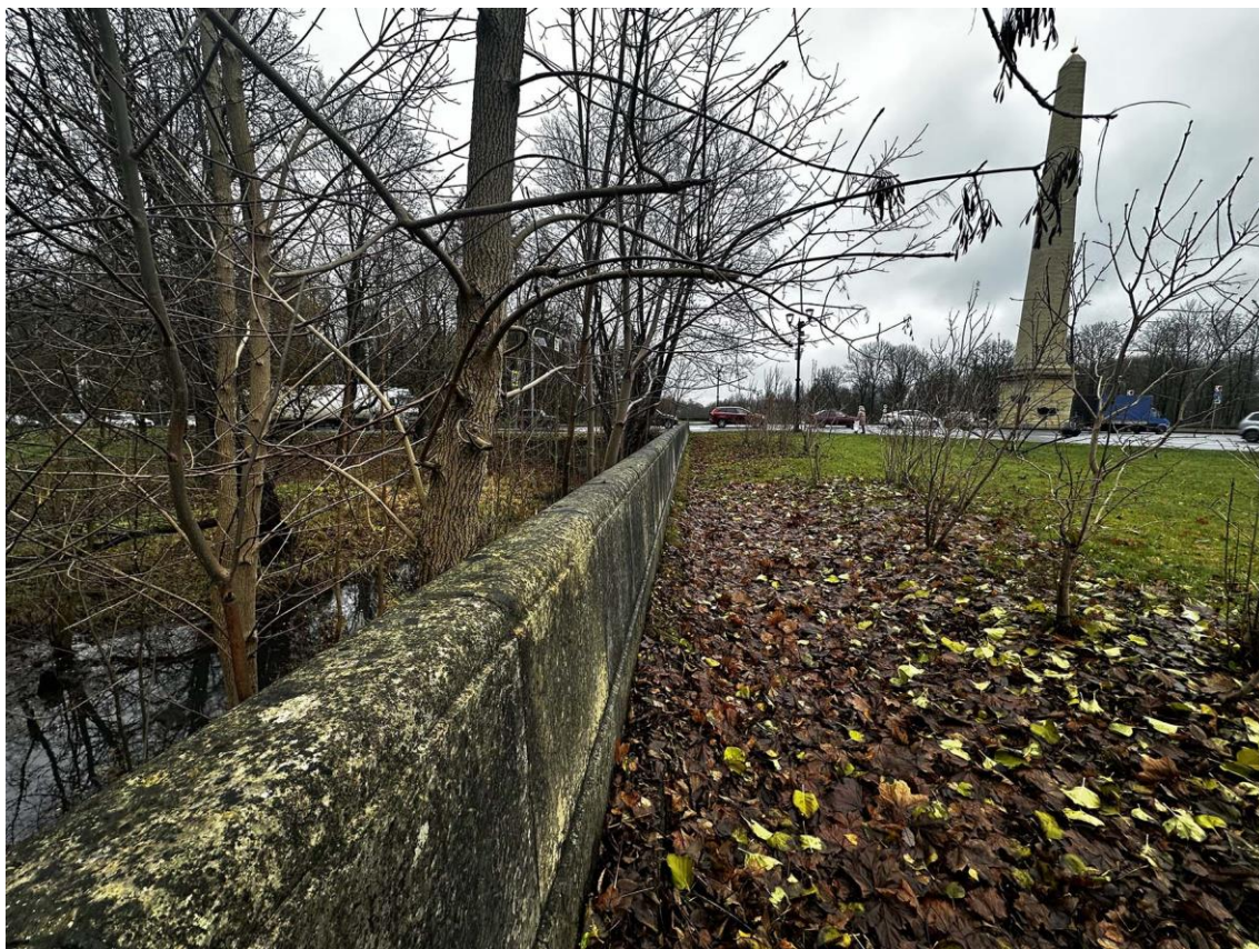
Фото 13. Западная часть подпорных (парапетных) стен. Общий вид внутренней стороны стены на участке 2-3. Фото с юго-запада. Дата съемки: 15.11.2025 г. Автор съемки: Куваева Ю.П.
