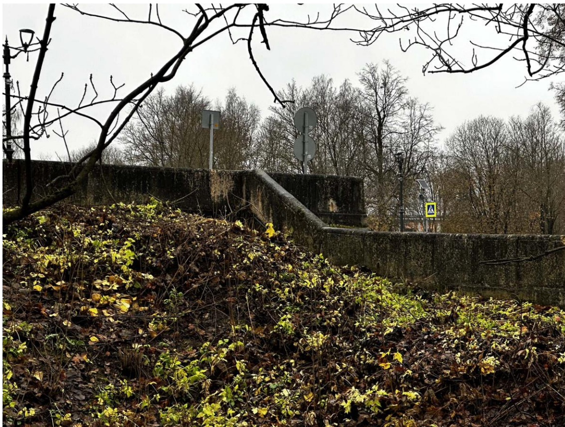
Фото 119. Юго-восточная часть подпорных (парапетных) стен. Фрагменты стен в точке соединения 12. Фото наружной стороны стен с северо-востока. Дата съемки: 15.11.2025 г. Автор съемки: Куваева Ю.П.
