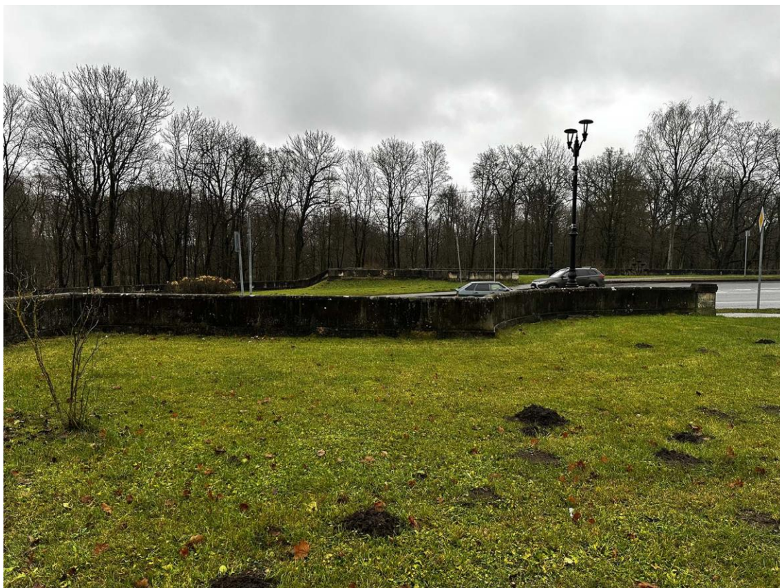
Фото 39. Северная часть подпорных (парапетных) стен. Общий вид внутренней стороны стены на участке 6-8. Фото с запада. Дата съемки: 15.11.2025 г. Автор съемки: Куваева Ю.П.
