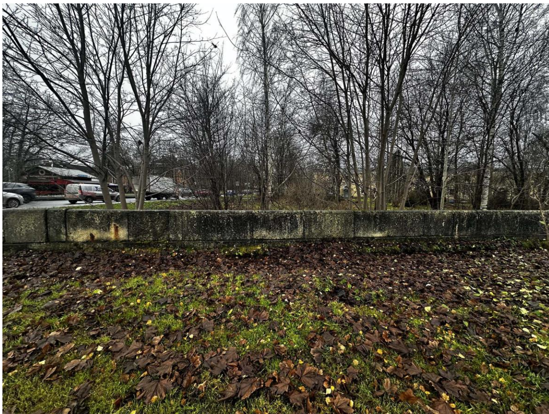
Фото 7. Западная часть подпорных (парапетных) стен. Участок 1-2. Общий вид стены с внутренней стороны, с севера. Дата съемки: 15.11.2025 г. Автор съемки: Куваева Ю.П.
