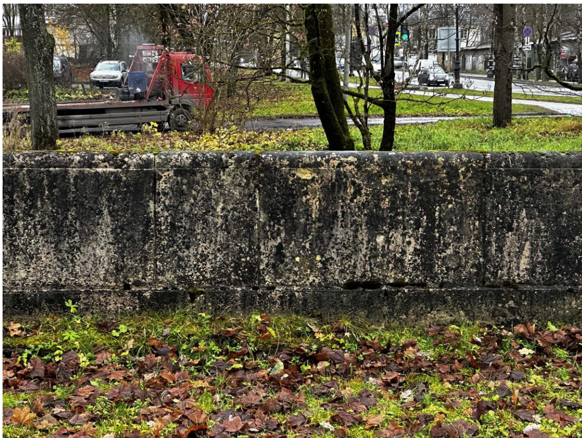
Фото 95. Юго-восточная часть подпорных (парапетных) стен. Фрагмент левой части внутренней стороны стены на участке 18-19. Фото с северо-востока. Дата съемки: 15.11.2025 г. Автор съемки: Куваева Ю.П.
