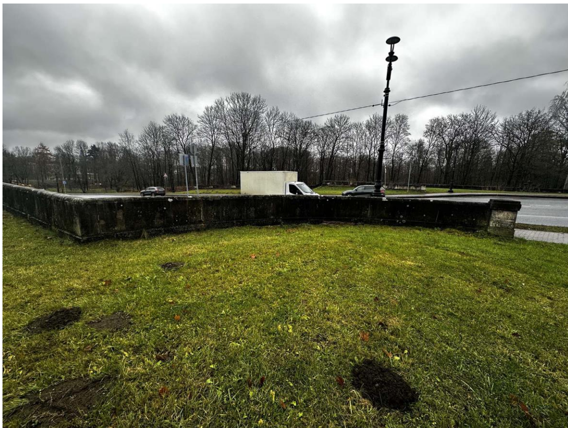
Фото 43. Северная часть подпорных (парапетных) стен. Общий вид внутренней стороны стены на участке 7-8. Фото с юго-запада. Дата съемки: 15.11.2025 г. Автор съемки: Куваева Ю.П.
