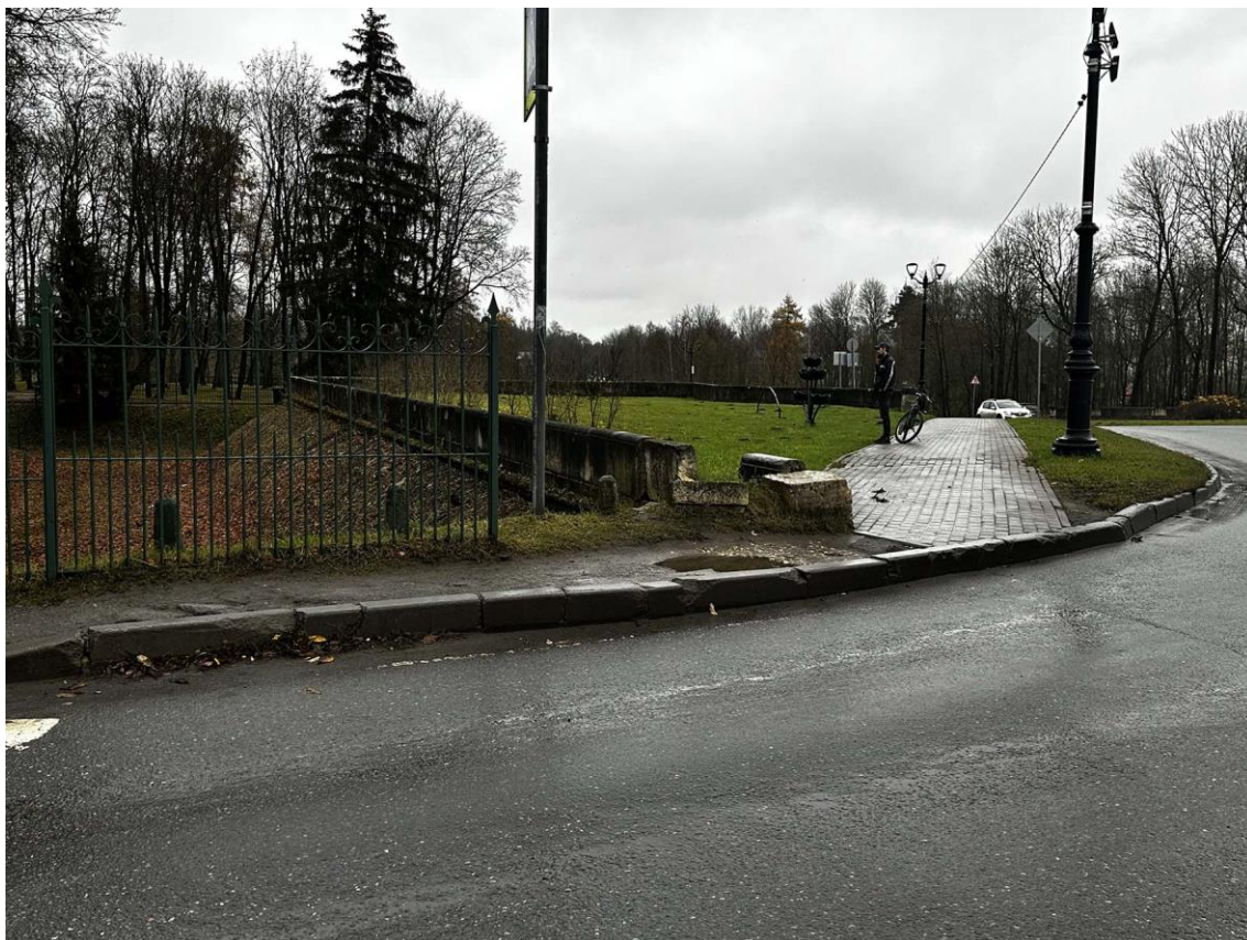
Фото 27. Северная часть подпорных (парапетных) стен. Общий вид с юго-запада, со стороны пр. Красноармейского. Дата съемки: 15.11.2025 г. Автор съемки: Куваева Ю.П.
