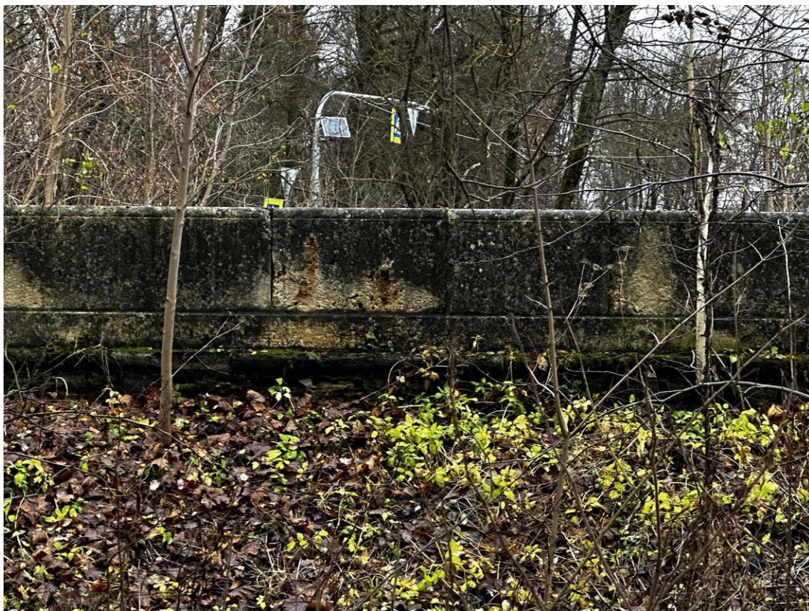
Фото 25. Западная часть подпорных (парапетных) стен. Фрагмент средней части наружной стороны стены на участке 2-1. Фото с юга. Дата съемки: 15.11.2025 г. Автор съемки: Куваева Ю.П.
