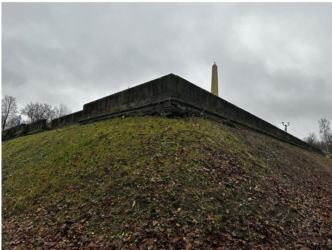
Фото 59. Северная часть подпорных (парапетных) стен. Угол в точке 5 соединения стен на участках 9-5 и 5-4. Фото с севера. Дата съемки: 15.11.2025 г. Автор съемки: Куваева Ю.П.
