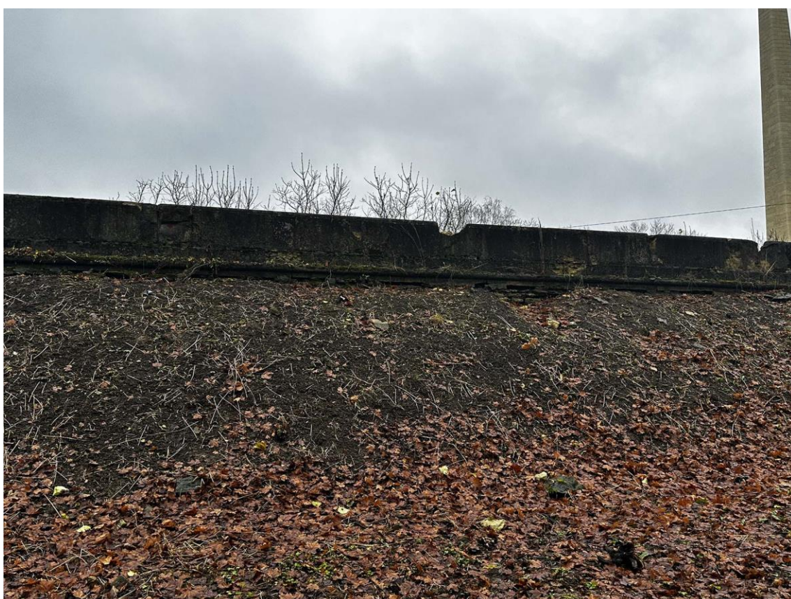
Фото 62. Северная часть подпорных (парапетных) стен. Фрагмент средней части наружной стороны стены на участке 5-4. Фото с запада. Дата съемки: 15.11.2025 г. Автор съемки: Куваева Ю.П.
