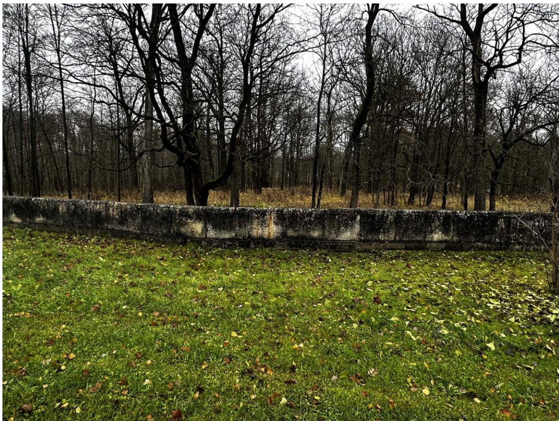
Фото 89. Юго-восточная часть подпорных (парапетных) стен. Угол перелома стен в точке 17. Фото внутренней стороны стен с запада. Дата съемки: 15.11.2025 г. Автор съемки: Куваева Ю.П.
