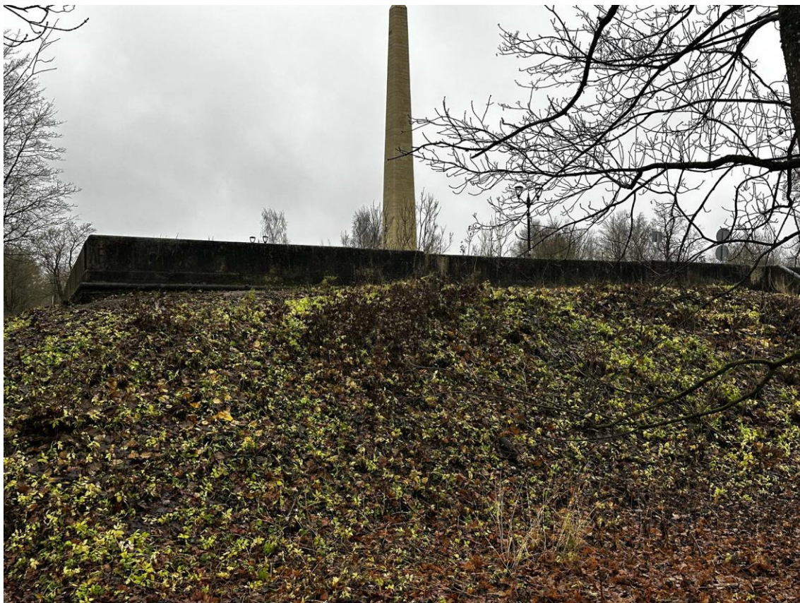
Фото 117. Юго-восточная часть подпорных (парапетных) стен. Общий вид наружной стороны стены на участке 16-15. Фото с северо-востока. Дата съемки: 15.11.2025 г. Автор съемки: Куваева Ю.П.
