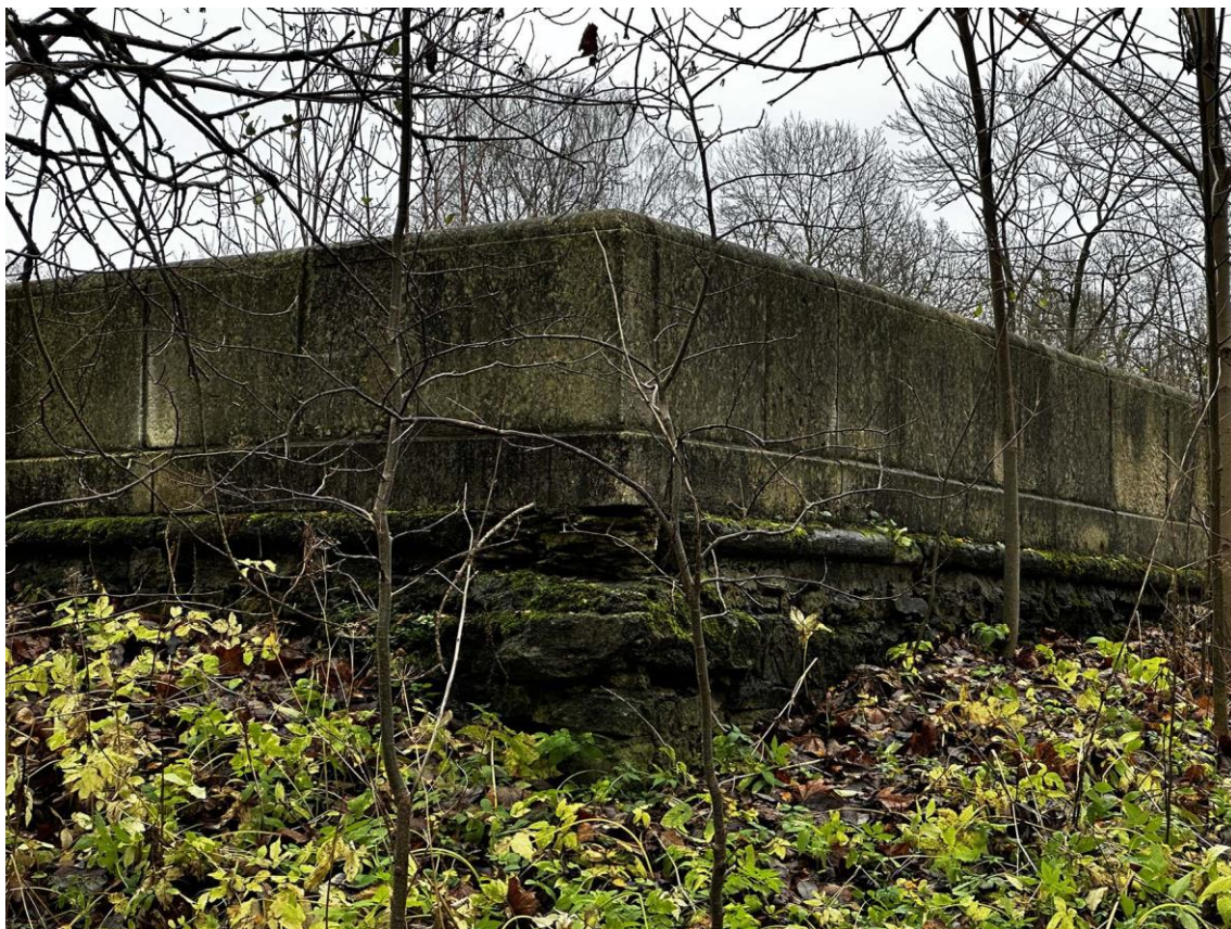
Фото 23. Западная часть подпорных (парапетных) стен. Наружный угол стены (точка 2). Фото с запада. Дата съемки: 15.11.2025 г. Автор съемки: Куваева Ю.П.
