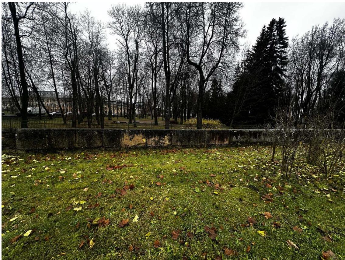
Фото 35. Северная часть подпорных (парапетных) стен. Общий вид внутренней стороны стены на участке 4-5. Фото с юго-востока. Дата съемки: 15.11.2025 г. Автор съемки: Куваева Ю.П.
