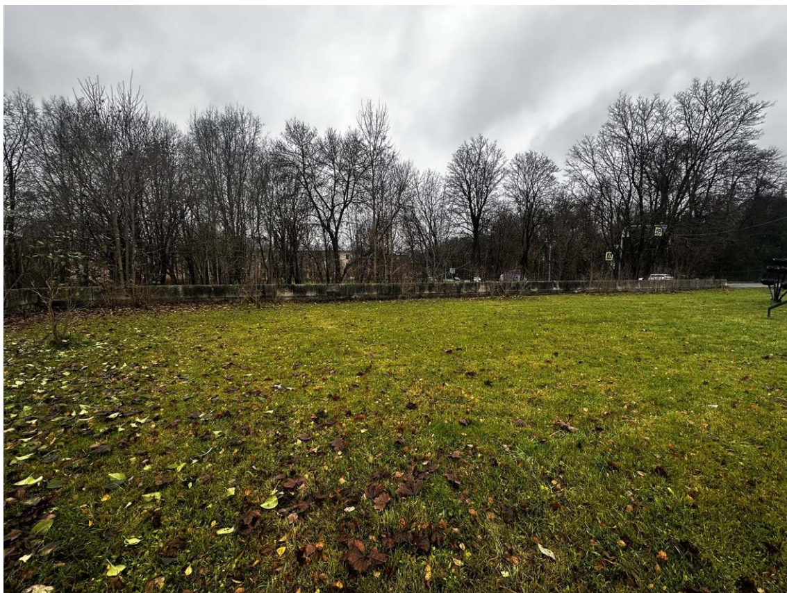
Фото 9. Западная часть подпорных (парапетных) стен. Общий вид внутренней стороны стены на участке 2-3. Фото с юго-востока. Дата съемки: 15.11.2025 г. Автор съемки: Куваева Ю.П.
