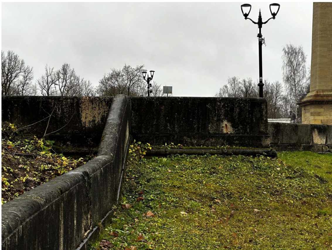
Фото 71. Юго-восточная часть подпорных (парапетных) стен. Фрагменты стен в точке соединения 12. Фото с северо-востока. Дата съемки: 15.11.2025 г. Автор съемки: Куваева Ю.П.
