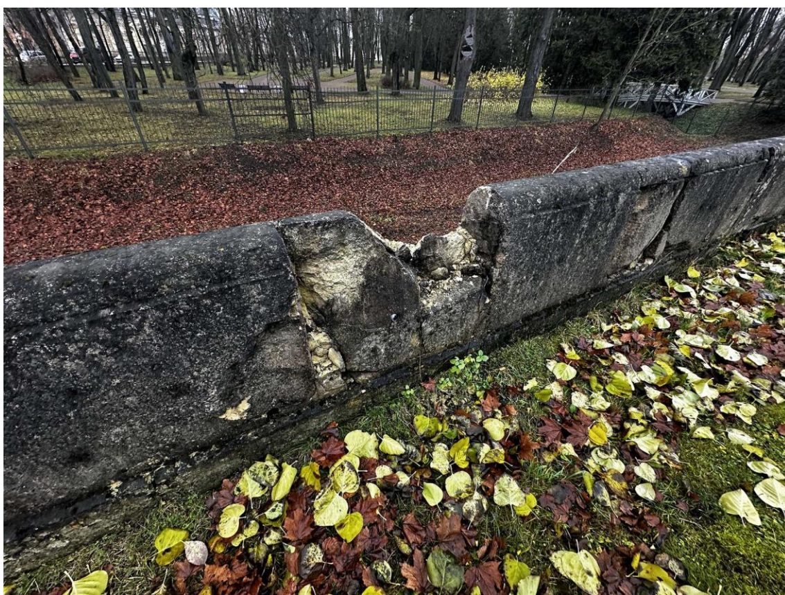
Фото 34. Северная часть подпорных (парапетных) стен. Фрагмент правой части внутренней стороны стены на участке 4-5. Фото с юга. Дата съемки: 15.11.2025 г. Автор съемки: Куваева Ю.П.
