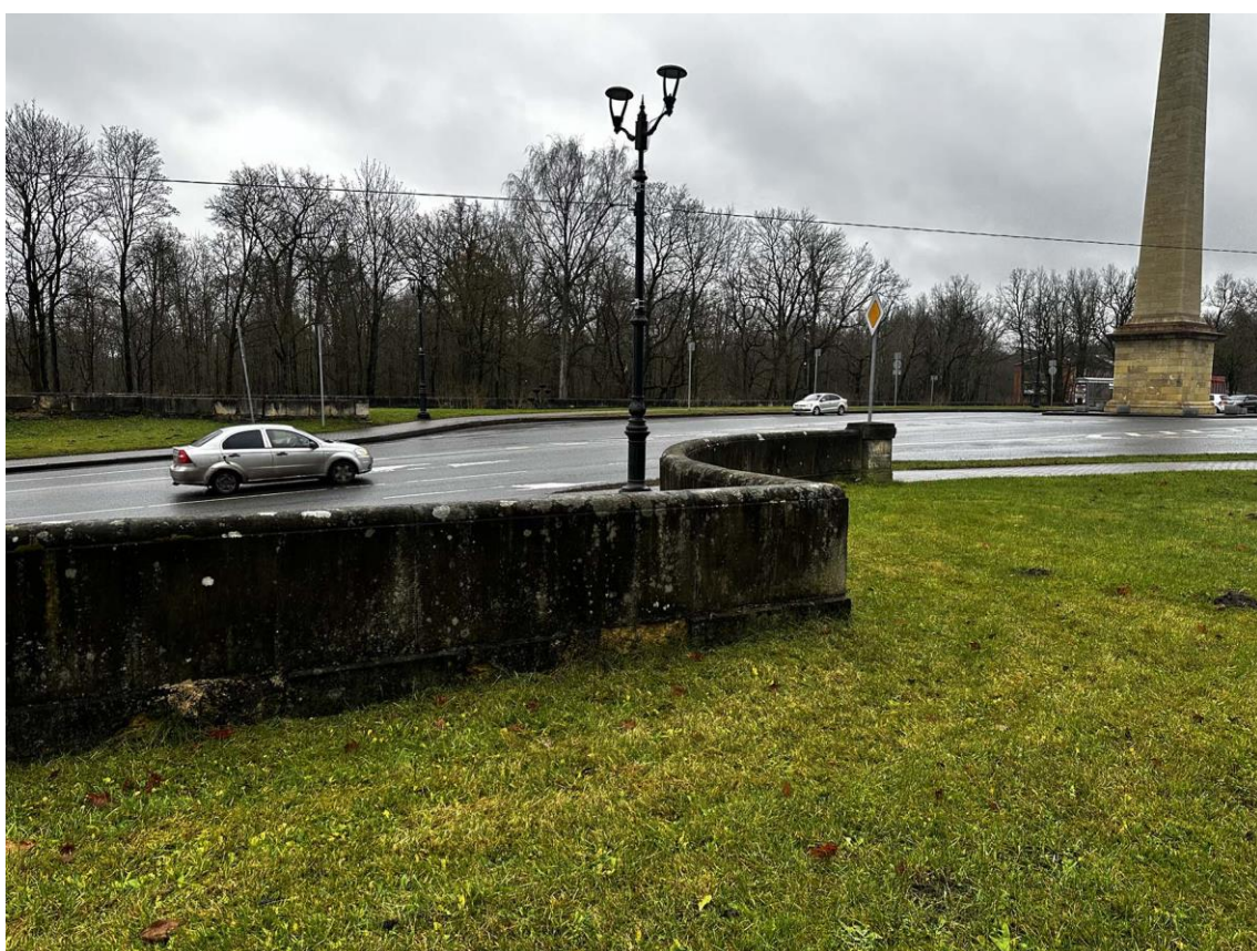
Фото 42. Северная часть подпорных (парапетных) стен. Общий вид внутренней стороны стены на участке 7-8. Фото с севера. Дата съемки: 15.11.2025 г. Автор съемки: Куваева Ю.П.
