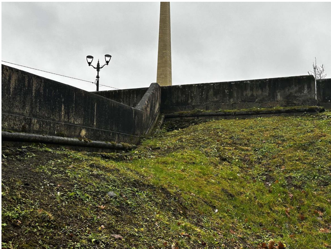
Фото 55. Северная часть подпорных (парапетных) стен. Вид на соединения стен с наружной стороны в точке 9. Фото с севера. Дата съемки: 15.11.2025 г. Автор съемки: Куваева Ю.П.
