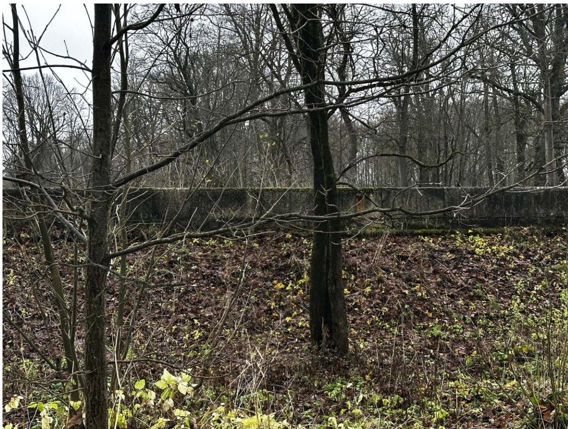
Фото 103. Юго-восточная часть подпорных (парапетных) стен. Фрагмент наружной стороны стены на участке 19-18. Фото с юго-запада. Дата съемки: 15.11.2025 г. Автор съемки: Куваева Ю.П.
