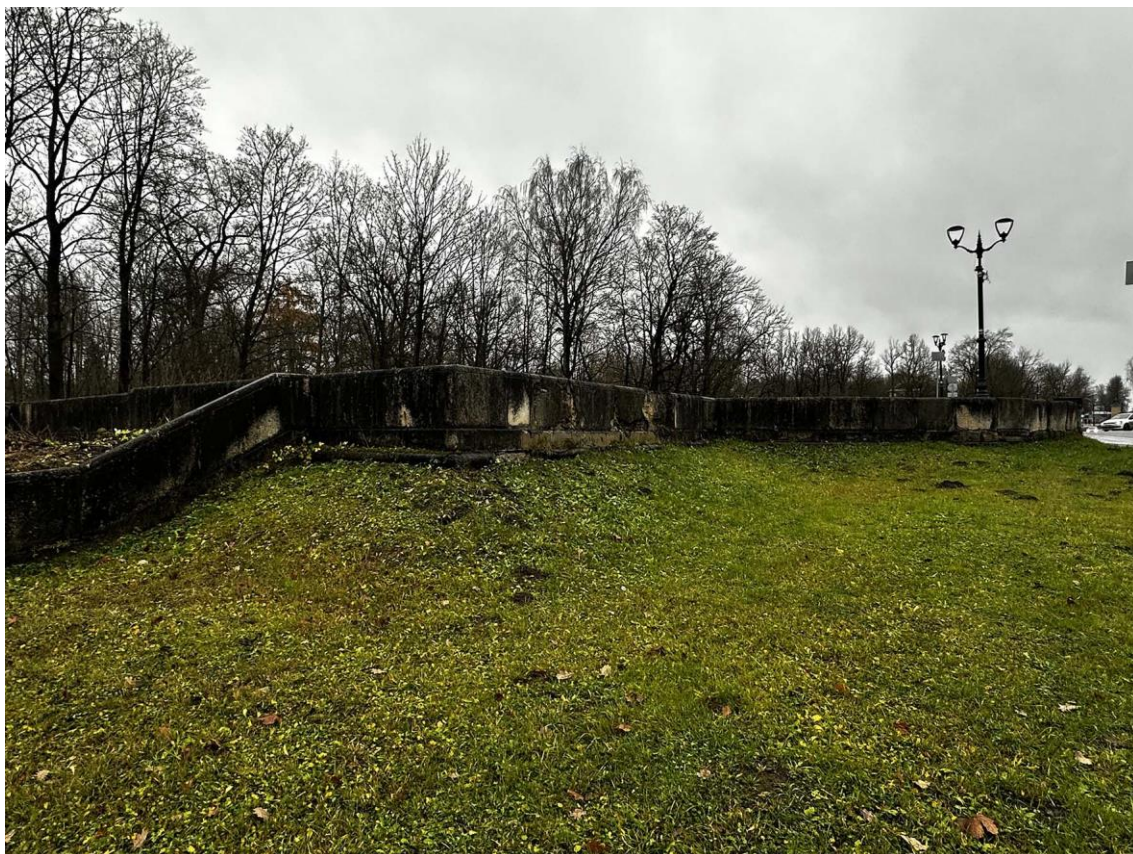
Фото 73. Юго-восточная часть подпорных (парапетных) стен. Общий вид внутренней стороны стен на участках 12-15-14-13. Фото с севера. Дата съемки: 15.11.2025 г. Автор съемки: Куваева Ю.П.
