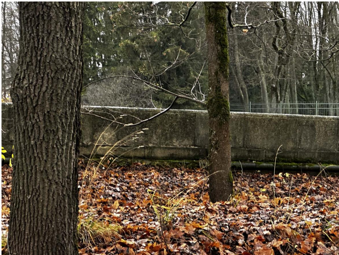
Фото 121. Юго-восточная часть подпорных (парапетных) стен. Средняя часть наружной стороны стены на участке 12-11. Фото с юго-востока. Дата съемки: 15.11.2025 г. Автор съемки: Куваева Ю.П.
