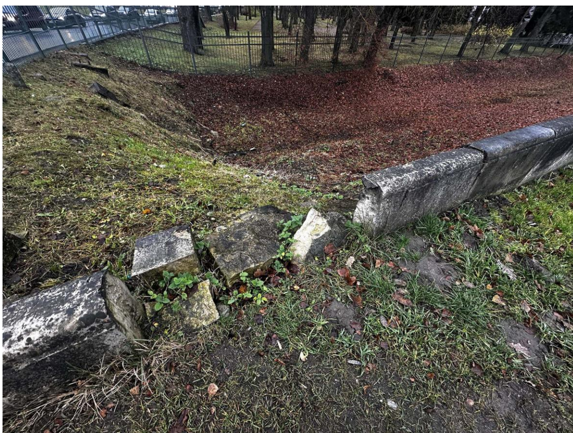
Фото 30. Северная часть подпорных (парапетных) стен. Фрагмент левой части внутренней стороны стены на участке 4-5. Фото с юга. Дата съемки: 15.11.2025 г. Автор съемки: Куваева Ю.П.
