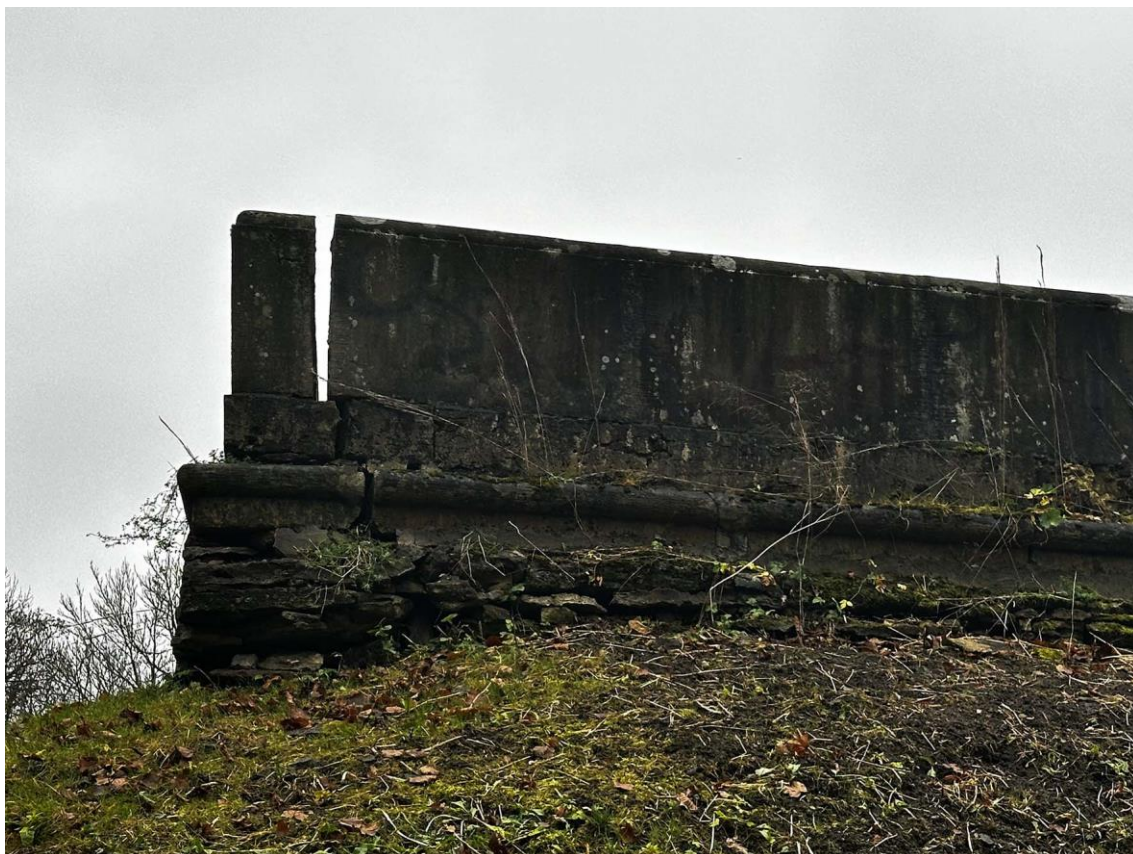
Фото 61. Северная часть подпорных (парапетных) стен. Левая часть наружной стороны стены на участке 5-4. Фото с запада. Дата съемки: 15.11.2025 г. Автор съемки: Куваева Ю.П.
