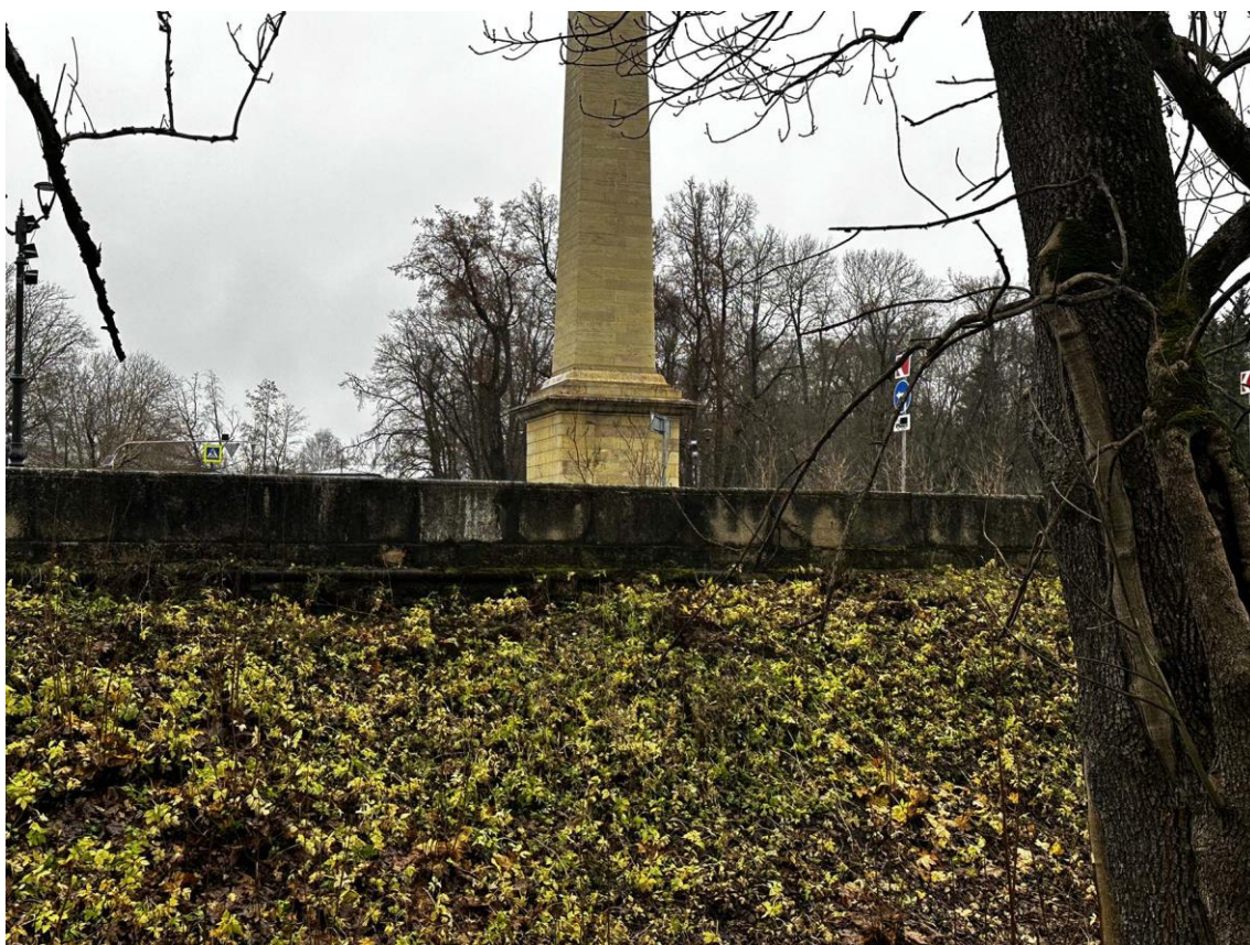
Фото 110. Юго-восточная часть подпорных (парапетных) стен. Угол поворота стен в точке 17. Фото с юго-востока. Дата съемки: 15.11.2025 г. Автор съемки: Куваева Ю.П.
