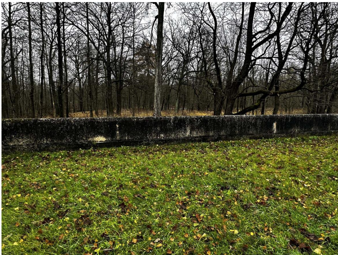
Фото 87. Юго-восточная часть подпорных (парапетных) стен. Средняя часть внутренней стороны стены на участке 16-17. Фото с запада. Дата съемки: 15.11.2025 г. Автор съемки: Куваева Ю.П.
