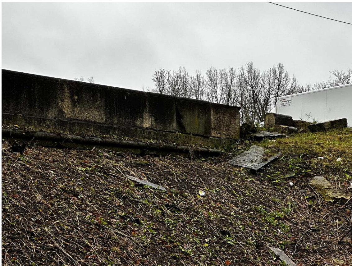
Фото 65. Северная часть подпорных (парапетных) стен. Правая часть наружной стороны стены на участке 5-4. Фото с севера. Дата съемки: 15.11.2025 г. Автор съемки: Куваева Ю.П.
