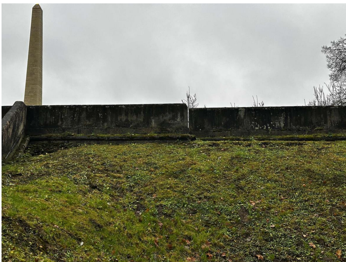
Фото 56. Северная часть подпорных (парапетных) стен. Левая часть наружной стороны стены на участке 9-5. Фото с северо-востока. Дата съемки: 15.11.2025 г. Автор съемки: Куваева Ю.П.
