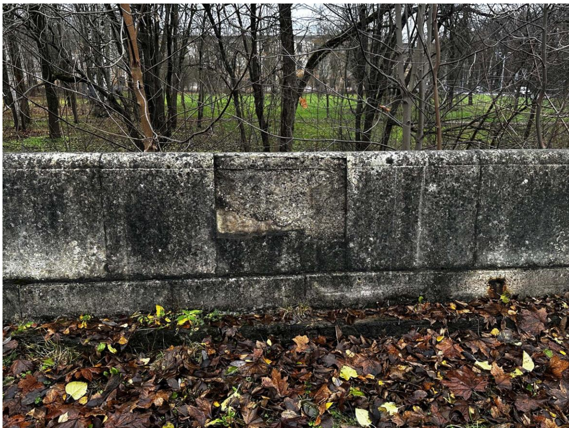
Фото 11. Западная часть подпорных (парапетных) стен. Фрагмент внутренней стороны в средней части стены на участке 2-3. Фото с юго-востока. Дата съемки: 15.11.2025 г. Автор съемки: Куваева Ю.П.
