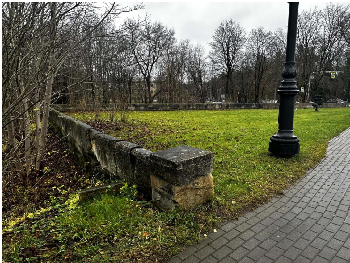
Фото 5. Западная часть подпорных (парапетных) стен. Участок 1-2. Завершающая тумба в исходной точке 1 стены. Фото с юга. Дата съемки: 15.11.2025 г. Автор съемки: Куваева Ю.П.
