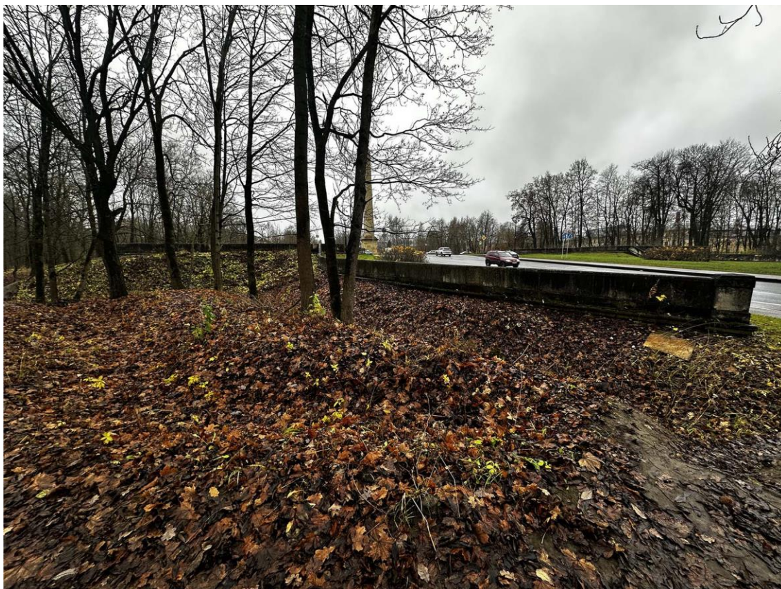
Фото 123. Юго-восточная часть подпорных (парапетных) стен. Общий вид наружной стороны стены на участке 12-11. Фото с северо-востока. Дата съемки: 15.11.2025 г. Автор съемки: Куваева Ю.П.
