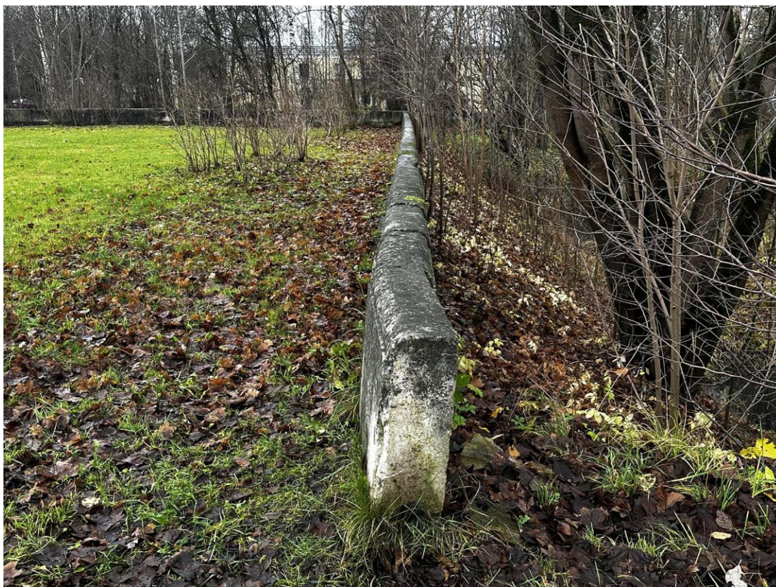
Фото 16. Западная часть подпорных (парапетных) стен. Общий вид стены на участке 2-3. Фото с северо-востока. Дата съемки: 15.11.2025 г. Автор съемки: Куваева Ю.П.
