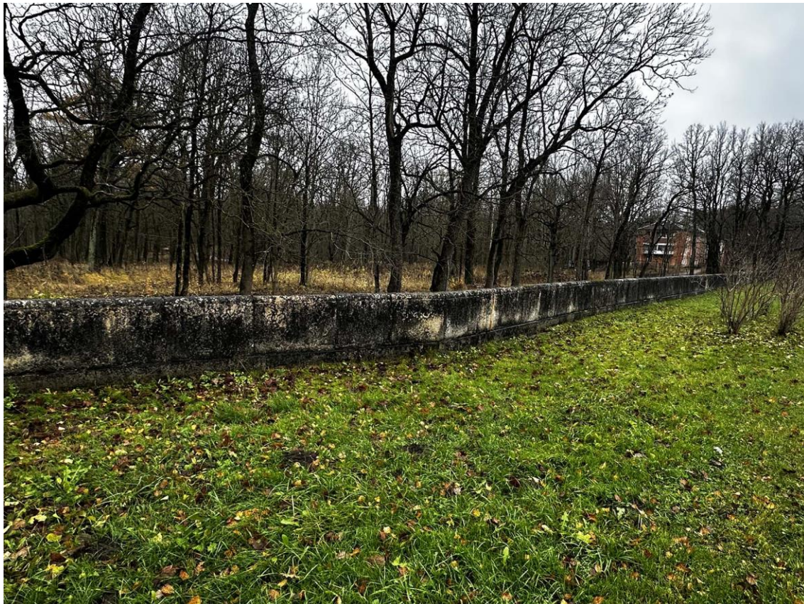
Фото 88. Юго-восточная часть подпорных (парапетных) стен. Угол перелома стен в точке 17. Фото внутренней стороны стен с северо-запада. Дата съемки: 15.11.2025 г. Автор съемки: Куваева Ю.П.
