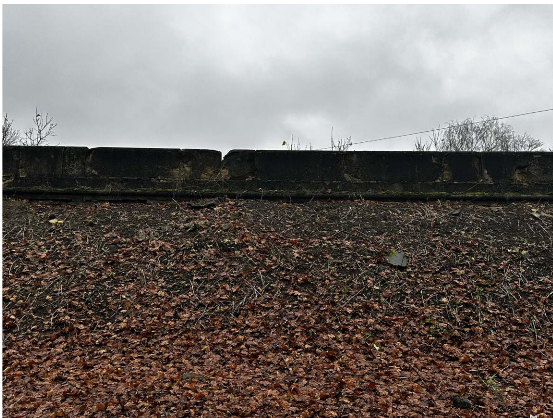
Фото 64. Северная часть подпорных (парапетных) стен. Фрагмент средней части наружной стороны стены на участке 5-4. Фото с запада. Дата съемки: 15.11.2025 г. Автор съемки: Куваева Ю.П.
