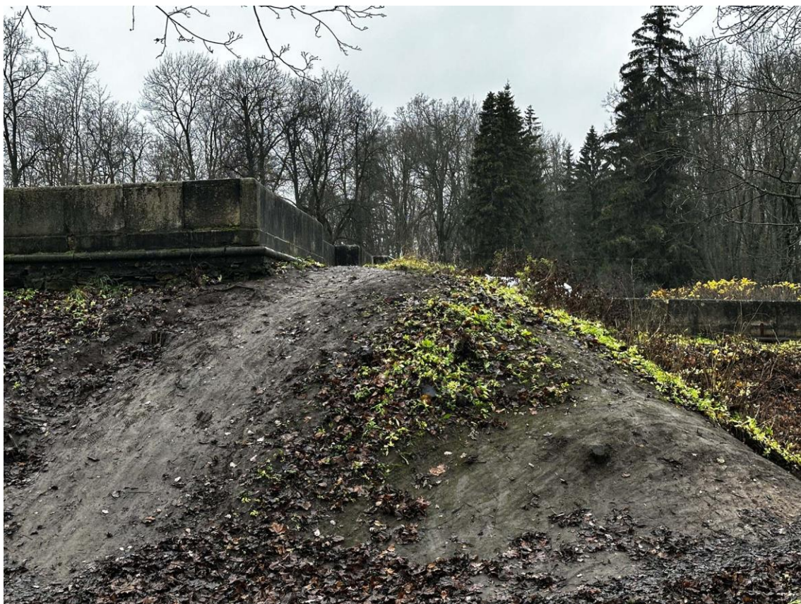
Фото 115. Юго-восточная часть подпорных (парапетных) стен. Угол поворота стен в точке 16. Фото с востока. Дата съемки: 15.11.2025 г. Автор съемки: Куваева Ю.П.
