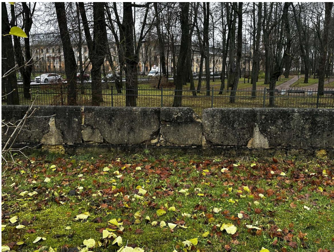
Фото 33. Северная часть подпорных (парапетных) стен. Фрагмент средней части внутренней стороны стены на участке 4-5. Фото с востока. Дата съемки: 15.11.2025 г. Автор съемки: Куваева Ю.П.
