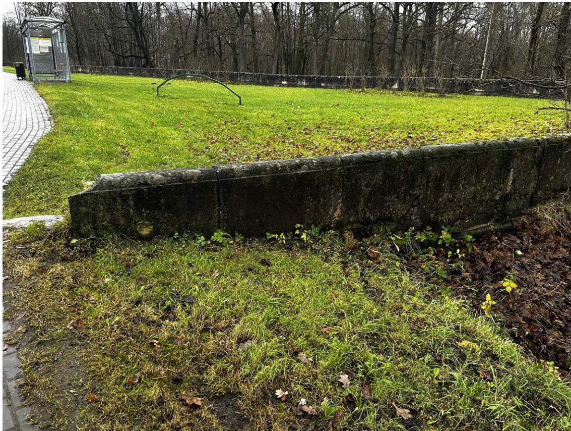
Фото 100. Юго-восточная часть подпорных (парапетных) стен. Левая часть наружной стороны стены на участке 19-18. Фото с юго-запада. Дата съемки: 15.11.2025 г. Автор съемки: Куваева Ю.П.
