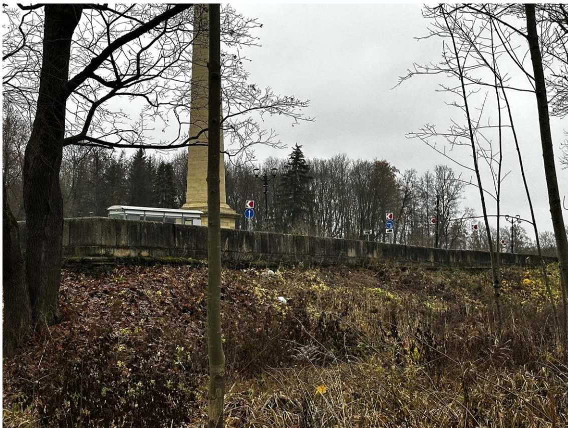
Фото 105. Юго-восточная часть подпорных (парапетных) стен. Угол поворота в точке 18 и левая часть наружной стороны стены на участке 18-17. Фото с юга. Дата съемки: 15.11.2025 г. Автор съемки: Куваева Ю.П.
