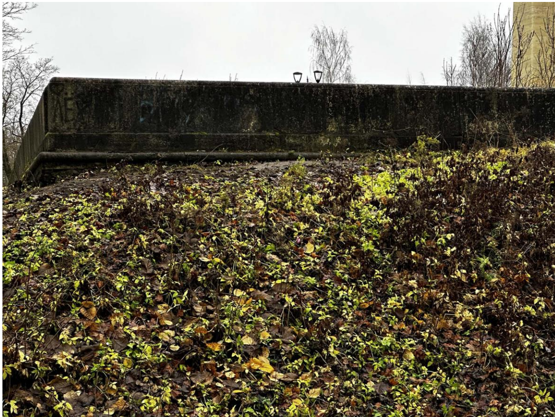
Фото 118. Юго-восточная часть подпорных (парапетных) стен. Угол поворота стен в точке 16. Фото с северо-востока. Дата съемки: 15.11.2025 г. Автор съемки: Куваева Ю.П.
