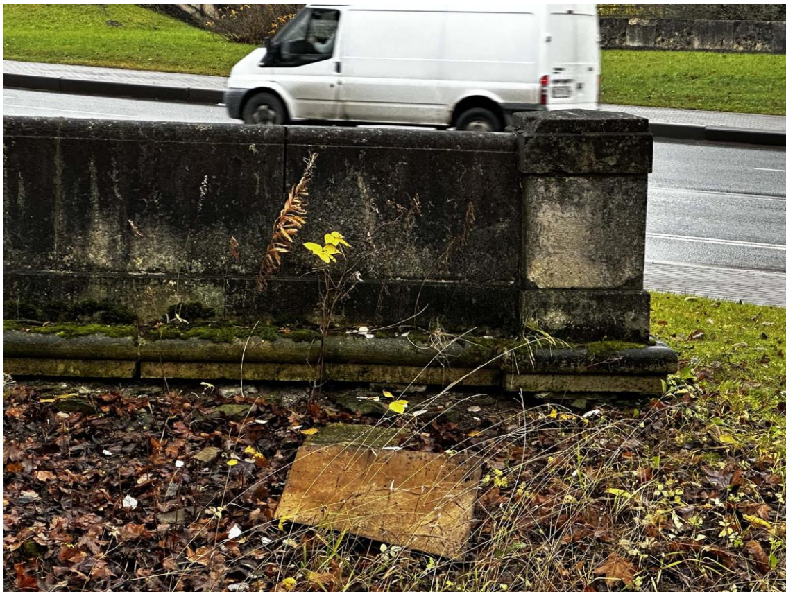
Фото 125. Юго-восточная часть подпорных (парапетных) стен. Завершающая тумба стены на участке 12-11. Дата съемки: 15.11.2025 г. Автор съемки: Куваева Ю.П.
