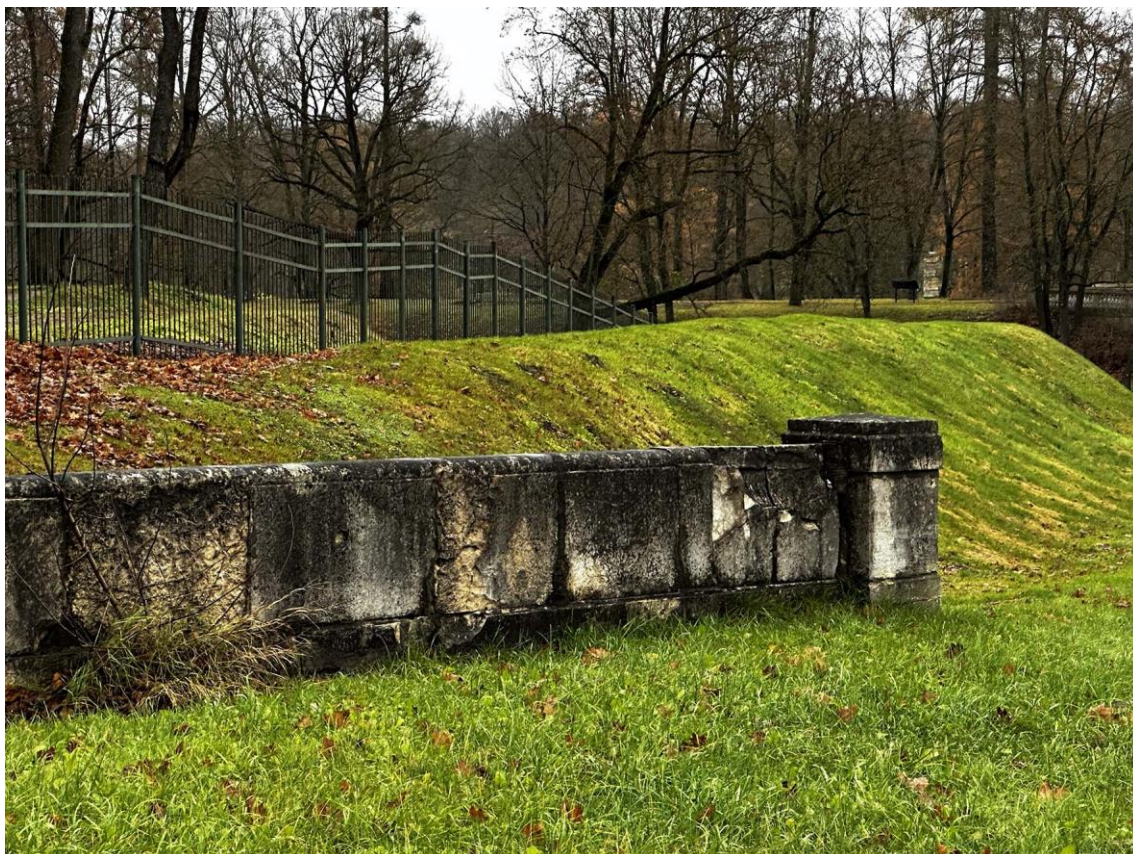
Фото 51. Северная часть подпорных (парапетных) стен. Фрагмент правой части стены с завершающей тумбой на участке 9-10. Фото с юга. Дата съемки: 15.11.2025 г. Автор съемки: Куваева Ю.П.
