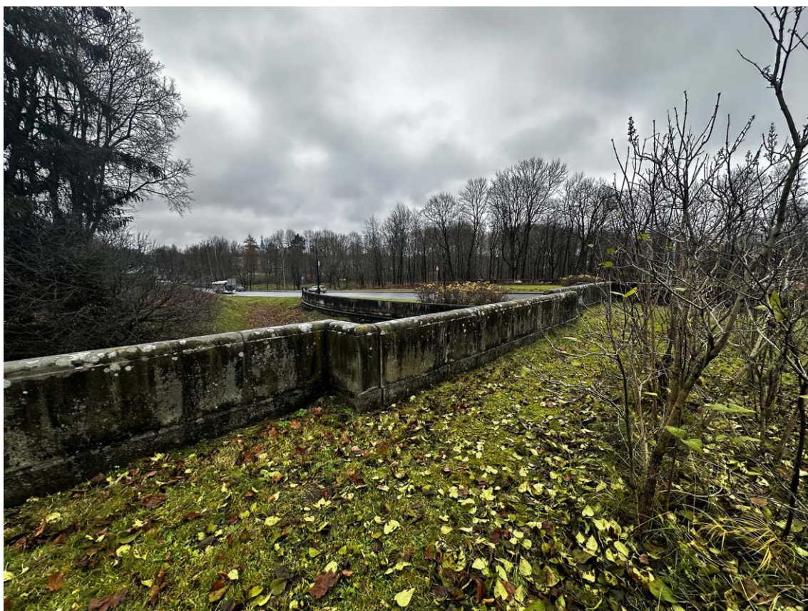
Фото 38. Северная часть подпорных (парапетных) стен. Общий вид внутренней стороны стены на участке 5-6. Фото с запада. Дата съемки: 15.11.2025 г. Автор съемки: Куваева Ю.П.
