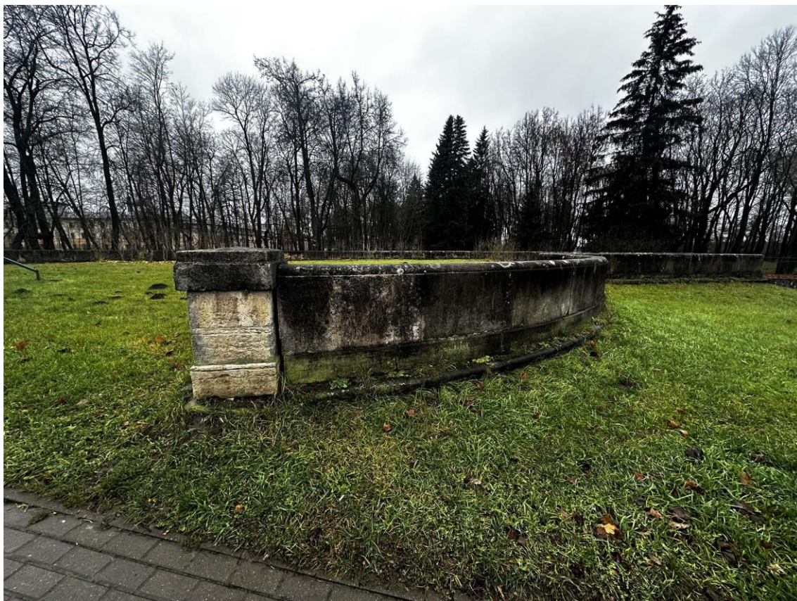
Фото 45. Северная часть подпорных (парапетных) стен. Общий вид стены на участке 7-8 с завершающей тумбой. Фото с юго-востока. Дата съемки: 15.11.2025 г. Автор съемки: Куваева Ю.П.
