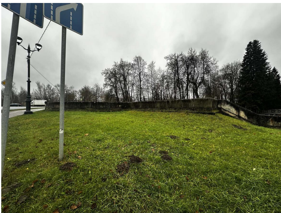
Фото 48. Северная часть подпорных (парапетных) стен. Общий вид стены на участке 8-6. Фото с северо-востока. Дата съемки: 15.11.2025 г. Автор съемки: Куваева Ю.П.
