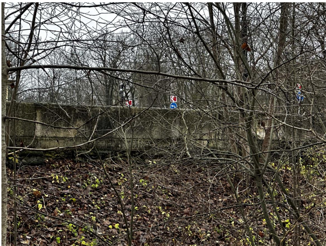
Фото 26. Западная часть подпорных (парапетных) парапетной стен. Правая часть наружной стороны стены на участке 2-1. Фото с юга. Дата съемки: 15.11.2025 г. Автор съемки: Куваева Ю.П.
