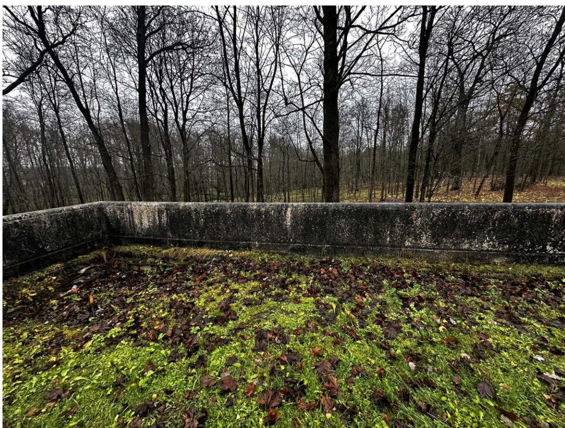
Фото 86. Юго-восточная часть подпорных (парапетных) стен. Угол соединения стены на участке 15-16 со стеной на участке 16-17. Фото внутренней стороны стен с запада. Дата съемки: 15.11.2025 г. Автор съемки: Куваева Ю.П.
