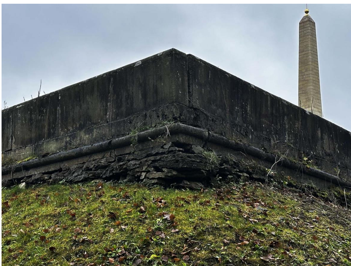
Фото 60. Северная часть подпорных (парапетных) стен. Угол в точке 5 соединения стен на участках 9-5 и 5-4. Фрагмент. Фото с севера. Дата съемки: 15.11.2025 г. Автор съемки: Куваева Ю.П.
