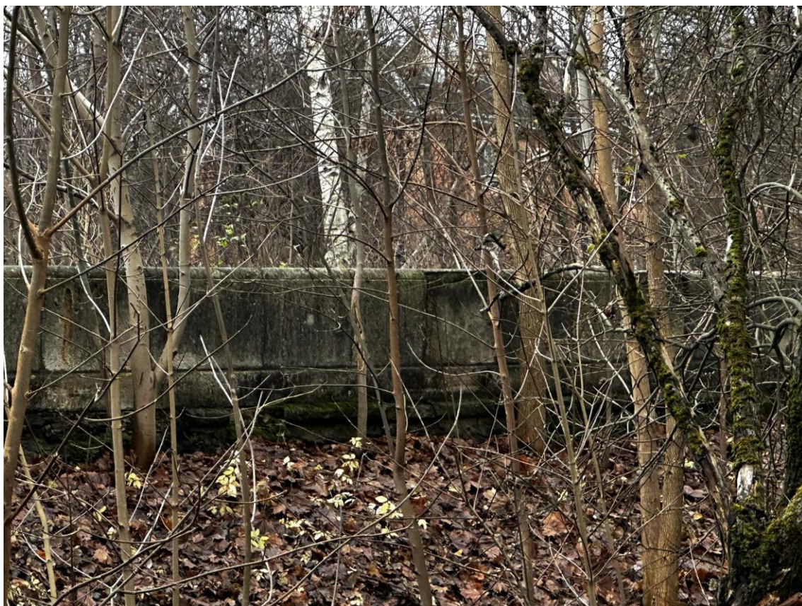
Фото 20. Западная часть подпорных (парапетных) стен. Фрагмент средней части наружной стороны стены на участке 3-2. Фото с северо-востока Дата съемки: 15.11.2025 г. Автор съемки: Куваева Ю.П.
