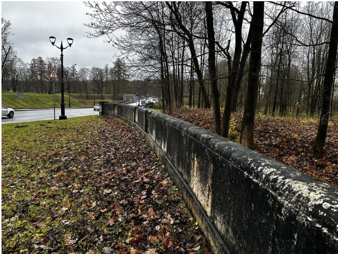
Фото 72. Юго-восточная часть подпорных (парапетных) стен. Общий вид внутренней стороны стены на участке 11-12. Фото с юга. Дата съемки: 15.11.2025 г. Автор съемки: Куваева Ю.П.
