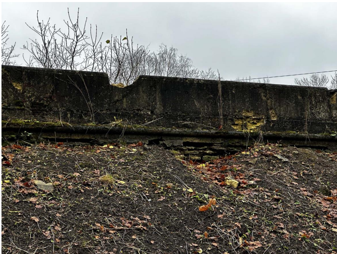
Фото 63. Северная часть подпорных (парапетных) стен. Фрагмент средней части наружной стороны стены на участке 5-4. Фото с запада. Дата съемки: 15.11.2025 г. Автор съемки: Куваева Ю.П.
