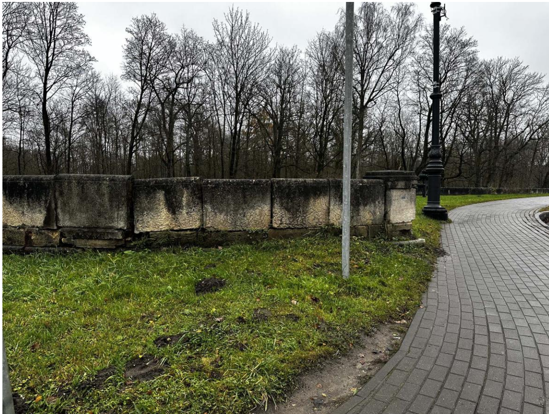
Фото 76. Юго-восточная часть подпорных (парапетных) стен. Правая часть стены на участке 14-13. Фото с севера. Дата съемки: 15.11.2025 г. Автор съемки: Куваева Ю.П.
