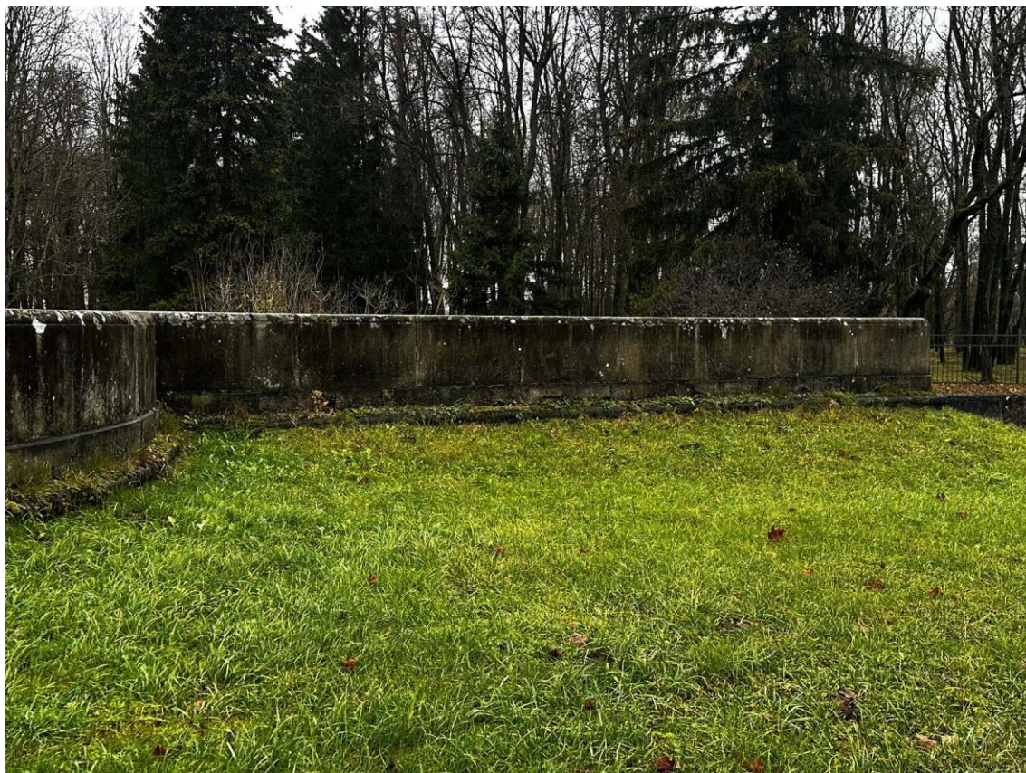
Фото 47. Северная часть подпорных (парапетных) стен. Общий вид стены на участке 7-6. Фото с юго-востока. Дата съемки: 15.11.2025 г. Автор съемки: Куваева Ю.П.
