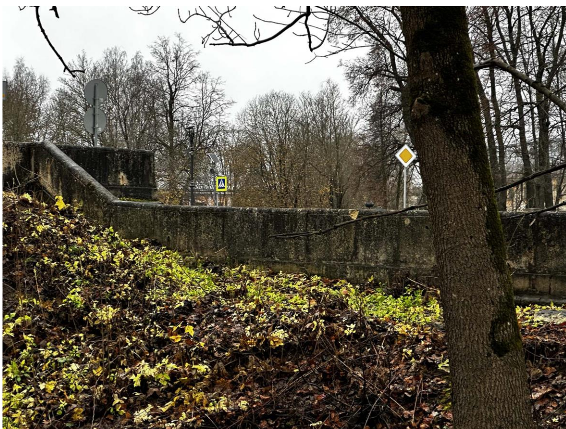
Фото 120. Юго-восточная часть подпорных (парапетных) стен. Левая часть наружной стороны стены на участке 12-11. Фото с востока. Дата съемки: 15.11.2025 г. Автор съемки: Куваева Ю.П.
