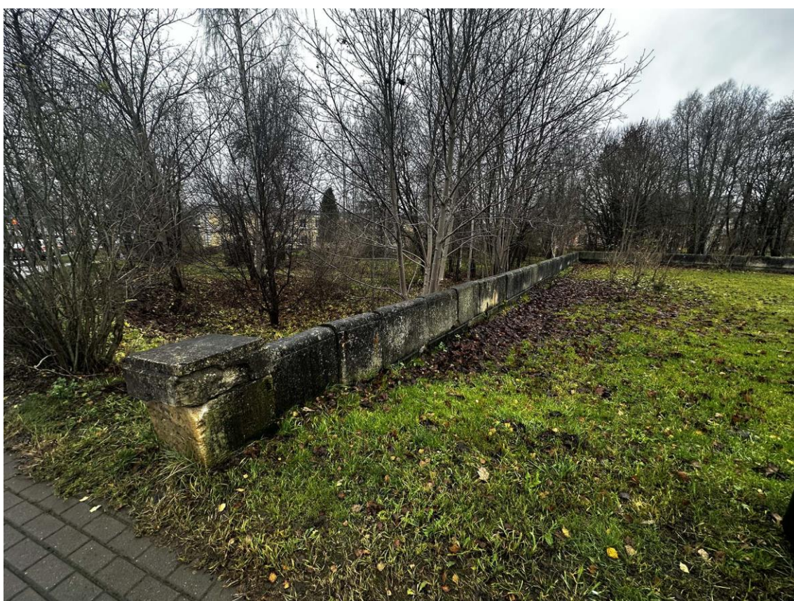
Фото 6. Западная часть подпорных (парапетных) стен. Общий вид внутренней стороны стены участка 1-2 с востока. Дата съемки: 15.11.2025 г. Автор съемки: Куваева Ю.П.
