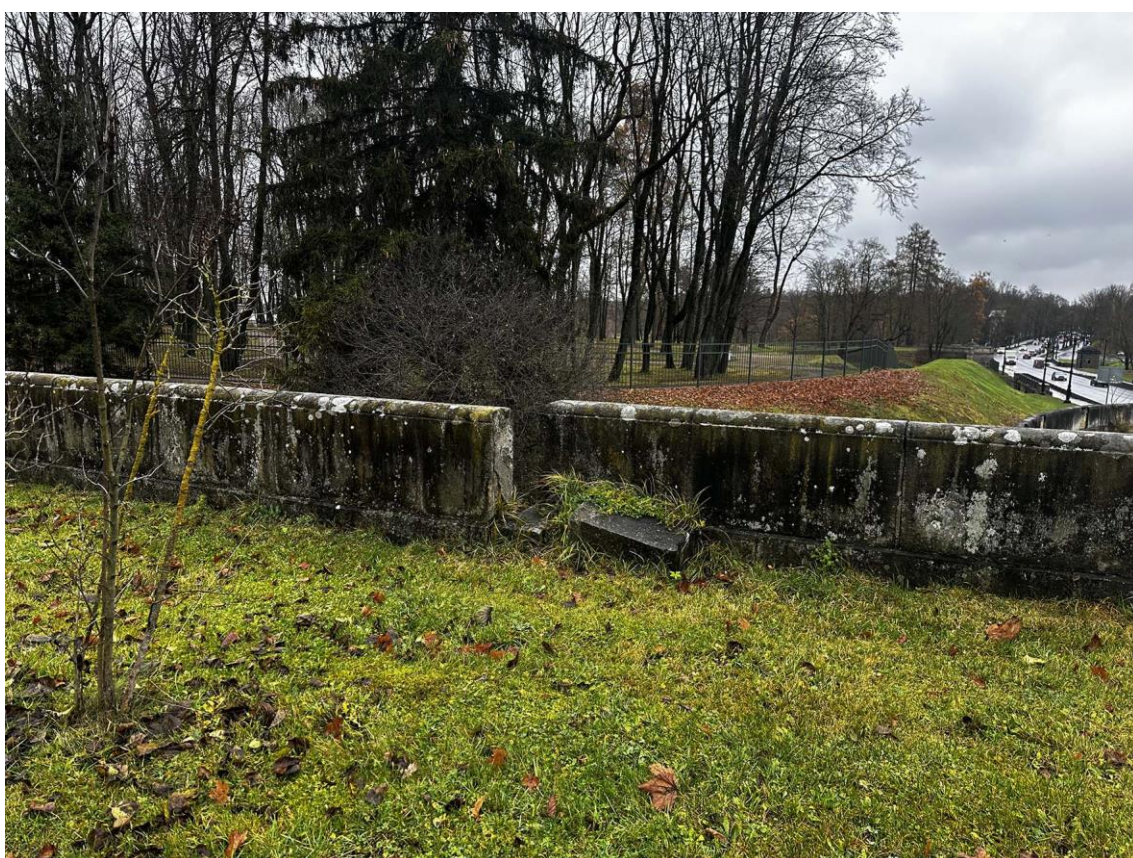
Фото 40. Северная часть подпорных (парапетных) стен. Фрагмент правой части внутренней стороны стены на участке 5-6. Фото с юга. Дата съемки: 15.11.2025 г. Автор съемки: Куваева Ю.П.
