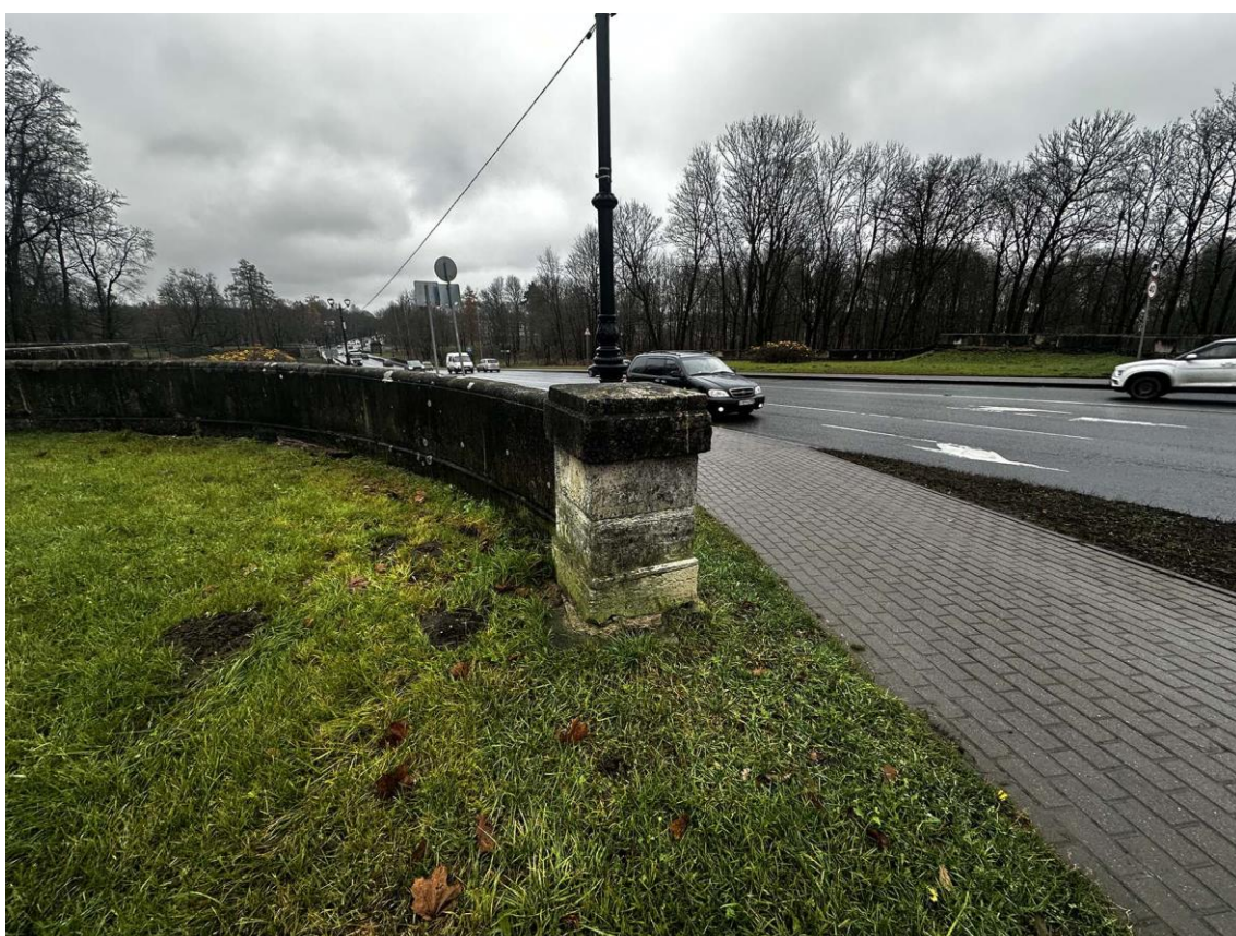
Фото 44. Северная часть подпорных (парапетных) стен. Завершающая тумба стены на участке 7-8 (точка 8). Фото с юго-запада. Дата съемки: 15.11.2025 г. Автор съемки: Куваева Ю.П.
