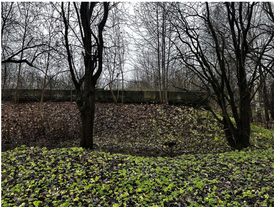
Фото 21. Западная часть подпорных (парапетных) стен. Общий вид наружной стороны стены на участке 3-2. Фото с северо-запада. Дата съемки: 15.11.2025 г. Автор съемки: Куваева Ю.П.
