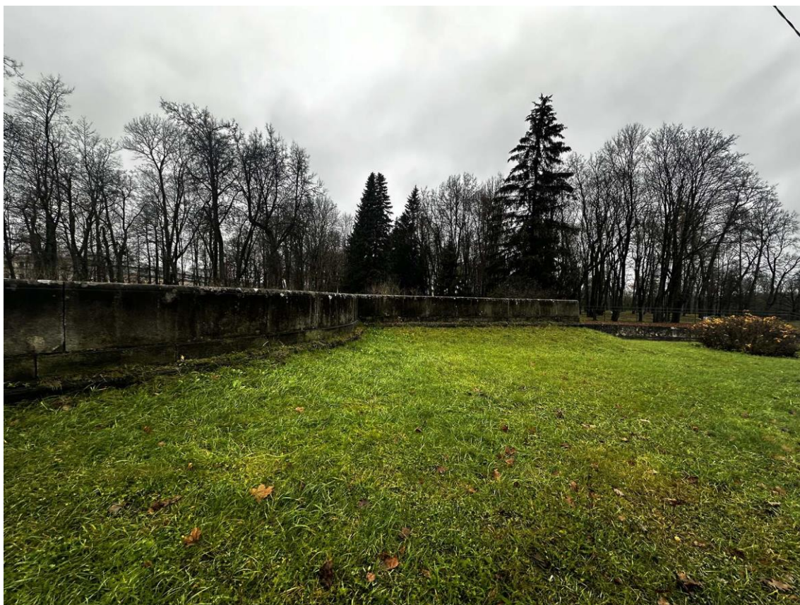
Фото 46. Северная часть подпорных (парапетных) стен. Общий вид стены на участке 8-6. Фото с востока. Дата съемки: 15.11.2025 г. Автор съемки: Куваева Ю.П.
