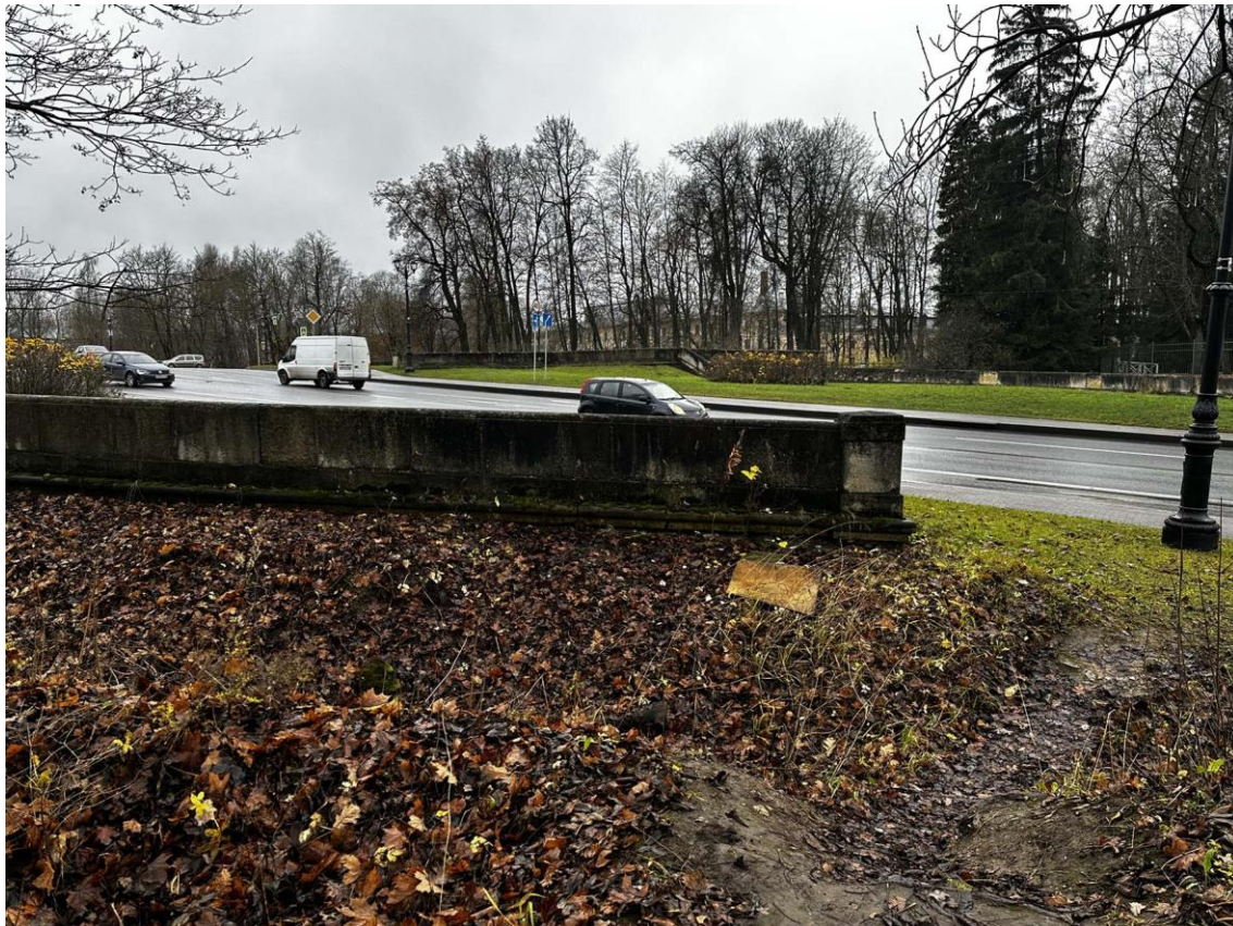
Фото 124. Юго-восточная часть подпорных (парапетных) стен. Правая часть наружной стороны стены на участке 12-11. Фото с востока. Дата съемки: 15.11.2025 г. Автор съемки: Куваева Ю.П.
