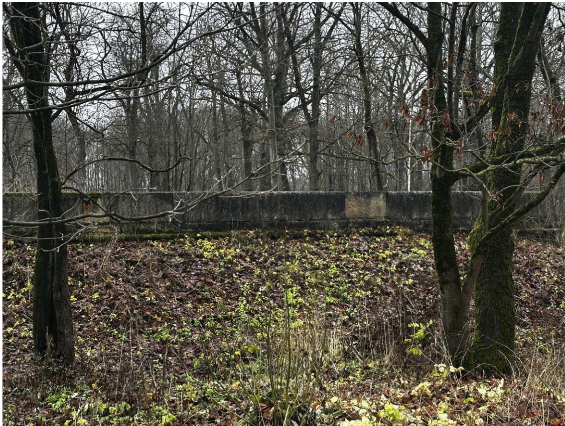
Фото 104. Юго-восточная часть подпорных (парапетных) стен. Фрагмент наружной стороны стены на участке 19-18. Фото с юго-запада. Дата съемки: 15.11.2025 г. Автор съемки: Куваева Ю.П.
