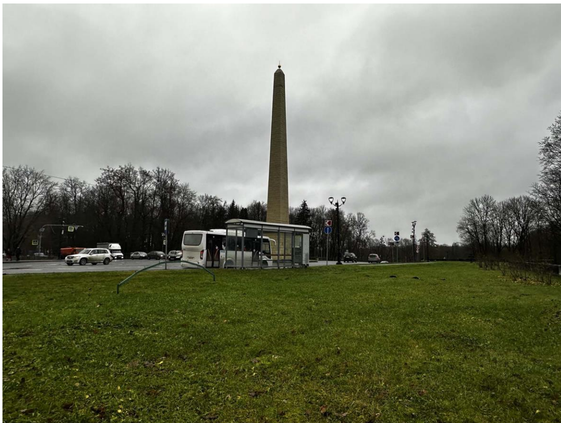
Фото 3. Общий вид площади Коннетабля с обелиском и подпорными (парапетными) стенами. Фото с юга. Дата съемки: 15.11.2025 г. Автор съемки: Куваева Ю.П.
