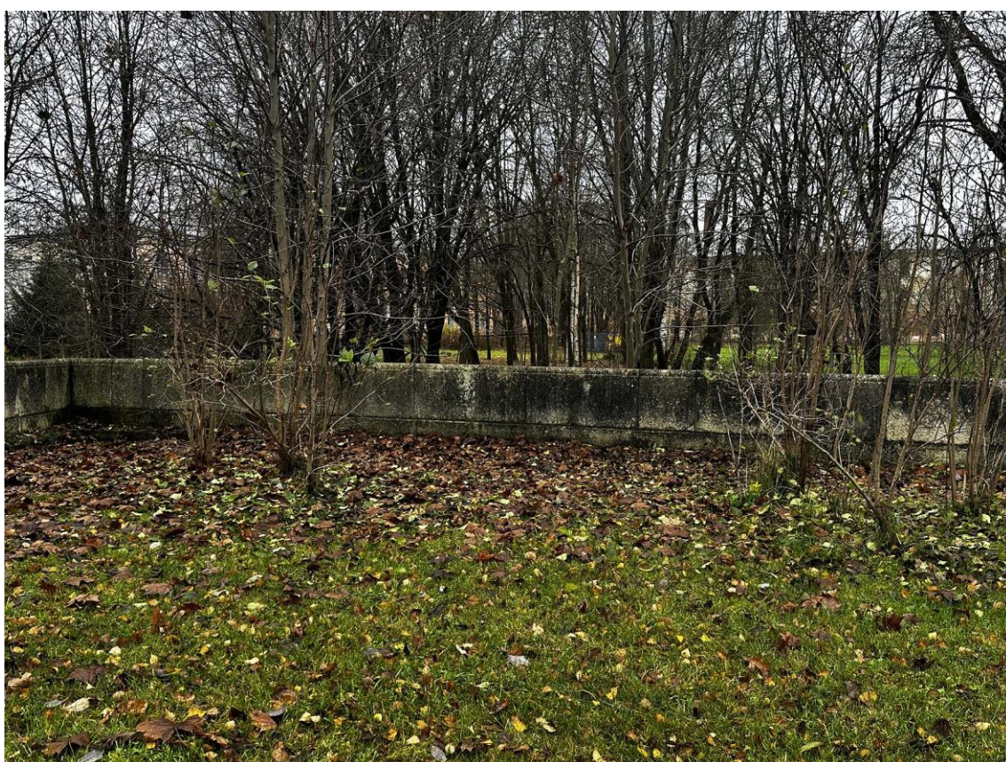
Фото 10. Западная часть подпорных (парапетных) стен. Фрагмент (левая часть) внутренней стороны стены на участке 2-3. Фото с юго-востока. Дата съемки: 15.11.2025 г. Автор съемки: Куваева Ю.П.
