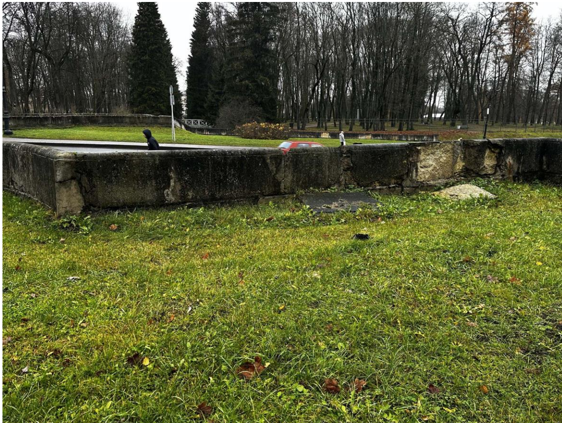
Фото 82. Юго-восточная часть подпорных (парапетных) стен. Общий вид внутренней стороны стены на участке 14-15. Фото с юга. Дата съемки: 15.11.2025 г. Автор съемки: Куваева Ю.П.
