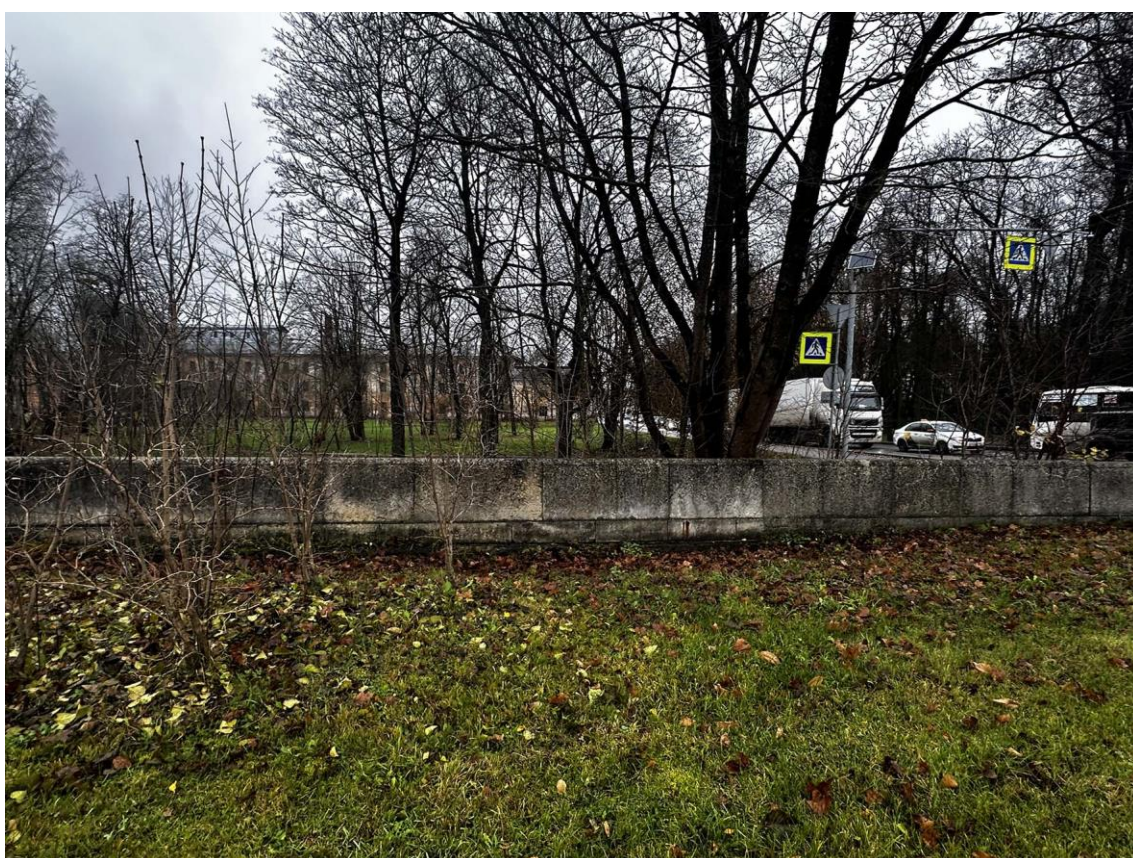
Фото 14. Западная часть подпорных (парапетных) стен. Общий вид правой части внутренней стороны стены на участке 2-3. Фото с юго-востока. Дата съемки: 15.11.2025 г. Автор съемки: Куваева Ю.П.
