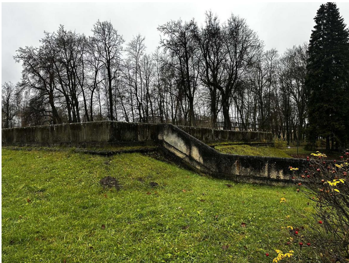
Фото 49. Северная часть подпорных (парапетных) стен. Общий вид стен на участке 6-9-10. Фото с северо-востока. Дата съемки: 15.11.2025 г. Автор съемки: Куваева Ю.П.
