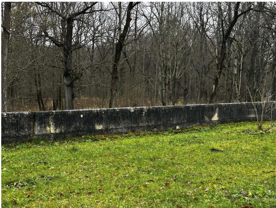
Фото 91. Юго-восточная часть подпорных (парапетных) стен. Правая часть внутренней стороны стены на участке 17-18. Фото с северо-запада. Дата съемки: 15.11.2025 г. Автор съемки: Куваева Ю.П.
