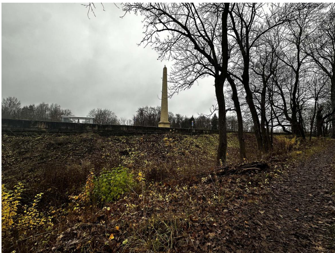
Фото 109. Юго-восточная часть подпорных (парапетных) стен. Общий вид стен на участках 18-17-16. Фото с юго-востока. Дата съемки: 15.11.2025 г. Автор съемки: Куваева Ю.П.
