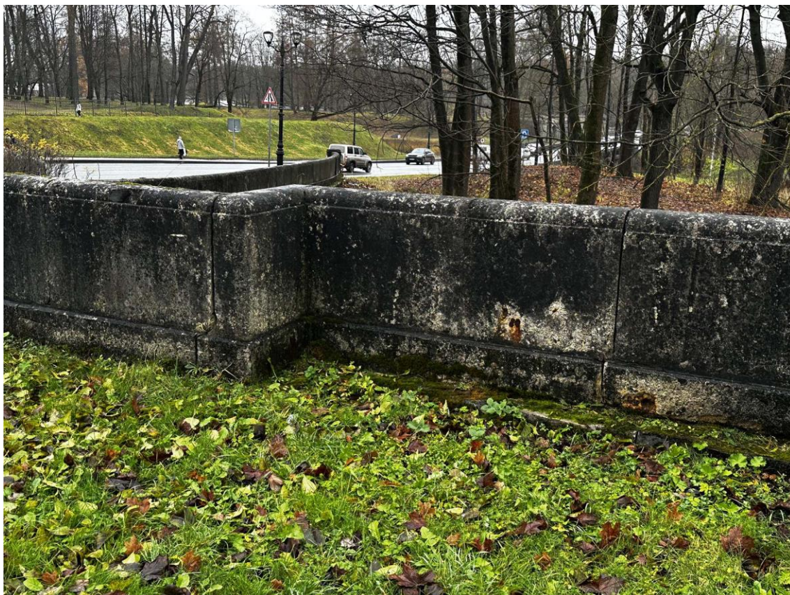
Фото 85. Юго-восточная часть подпорных (парапетных) стен. Правый угол перелома стены на участке 15-16. Фото с юга. Дата съемки: 15.11.2025 г. Автор съемки: Куваева Ю.П.
