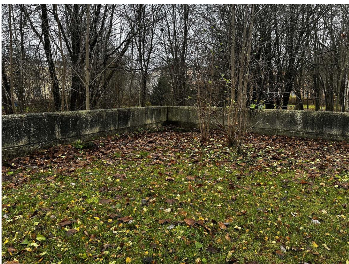
Фото 8. Западная часть подпорных (парапетных) стен. Внутренний угол стены в точке 2 на участке 1-3. Фото с востока. Дата съемки: 15.11.2025 г. Автор съемки: Куваева Ю.П.
