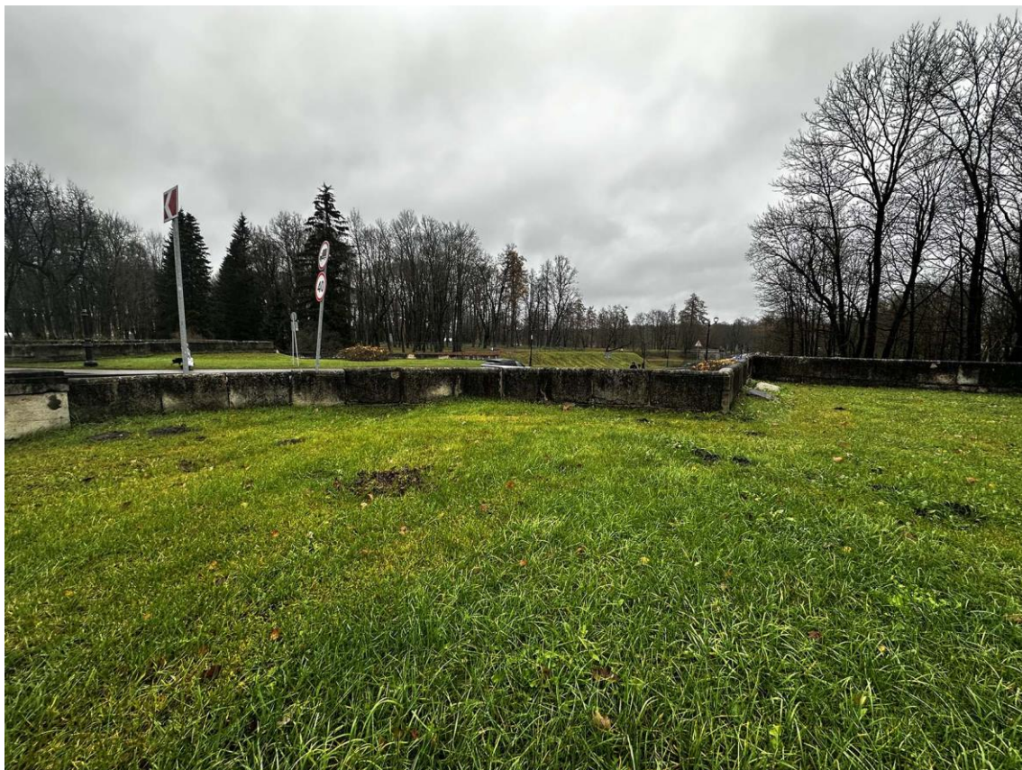
Фото 79. Юго-восточная часть подпорных (парапетных) стен. Общий вид стены на участках 13-14-15-16. Фото с юга. Дата съемки: 15.11.2025 г. Автор съемки: Куваева Ю.П.
