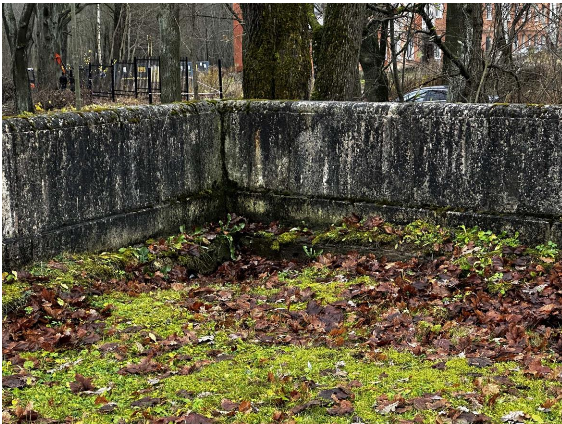
Фото 94. Юго-восточная часть подпорных (парапетных) стен. Угол поворота стен в точке 18. Фото с севера. Дата съемки: 15.11.2025 г. Автор съемки: Куваева Ю.П.
