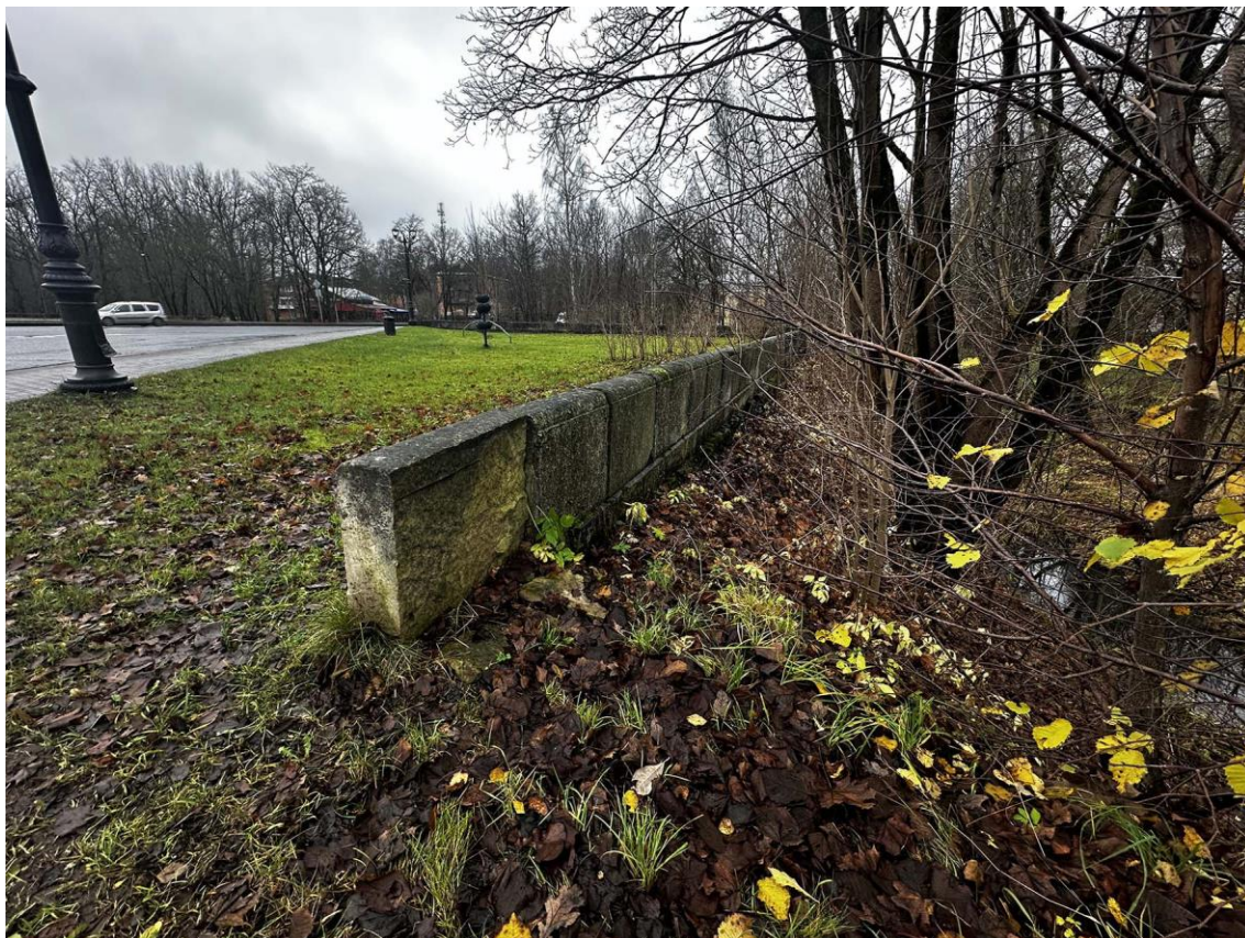
Фото 17. Западная часть подпорных (парапетных) стен. Общий вид наружной стороны стены на участке 3-2. Фото с севера. Дата съемки: 15.11.2025 г. Автор съемки: Куваева Ю.П.
