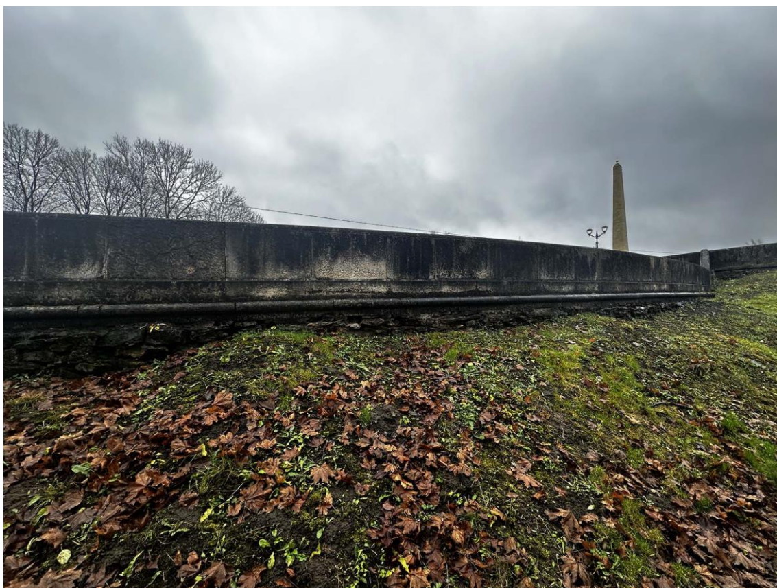
Фото 54. Северная часть подпорных (парапетных) стен. Общий вид правой части наружной стороны стены на участке 10-9. Фото с севера. Дата съемки: 15.11.2025 г. Автор съемки: Куваева Ю.П.
