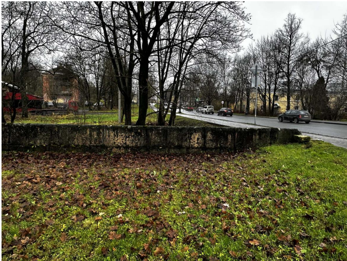
Фото 96. Юго-восточная часть подпорных (парапетных) стен. Правая часть внутренней стороны стены на участке 18-19. Фото с северо-востока. Дата съемки: 15.11.2025 г. Автор съемки: Куваева Ю.П.
