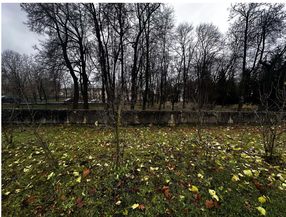
Фото 32. Северная часть подпорных (парапетных) стен. Общий вид средней части внутренней стороны стены на участке 4-5. Фото с востока. Дата съемки: 15.11.2025 г. Автор съемки: Куваева Ю.П.
