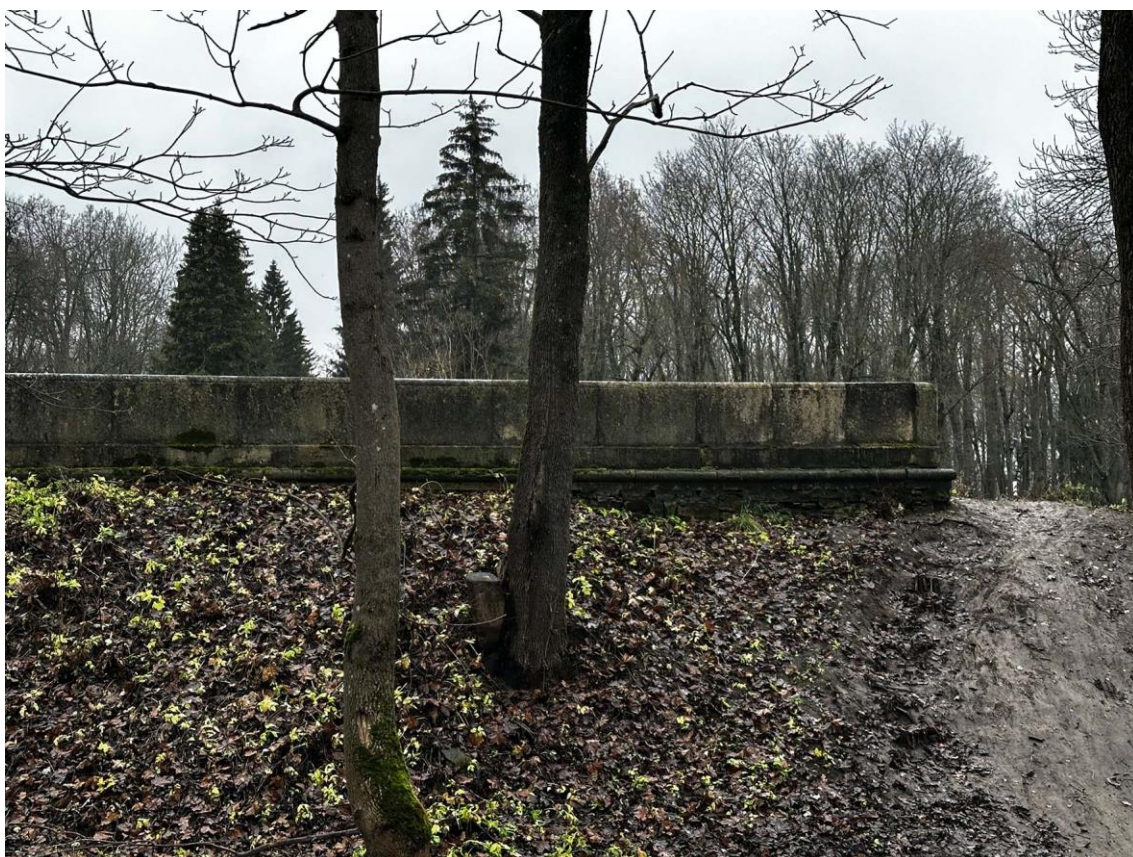
Фото 114. Юго-восточная часть подпорных (парапетных) стен. Правая часть наружной стороны стены на участке 17-1. Фото с юго-востока. Дата съемки: 15.11.2025 г. Автор съемки: Куваева Ю.П.
