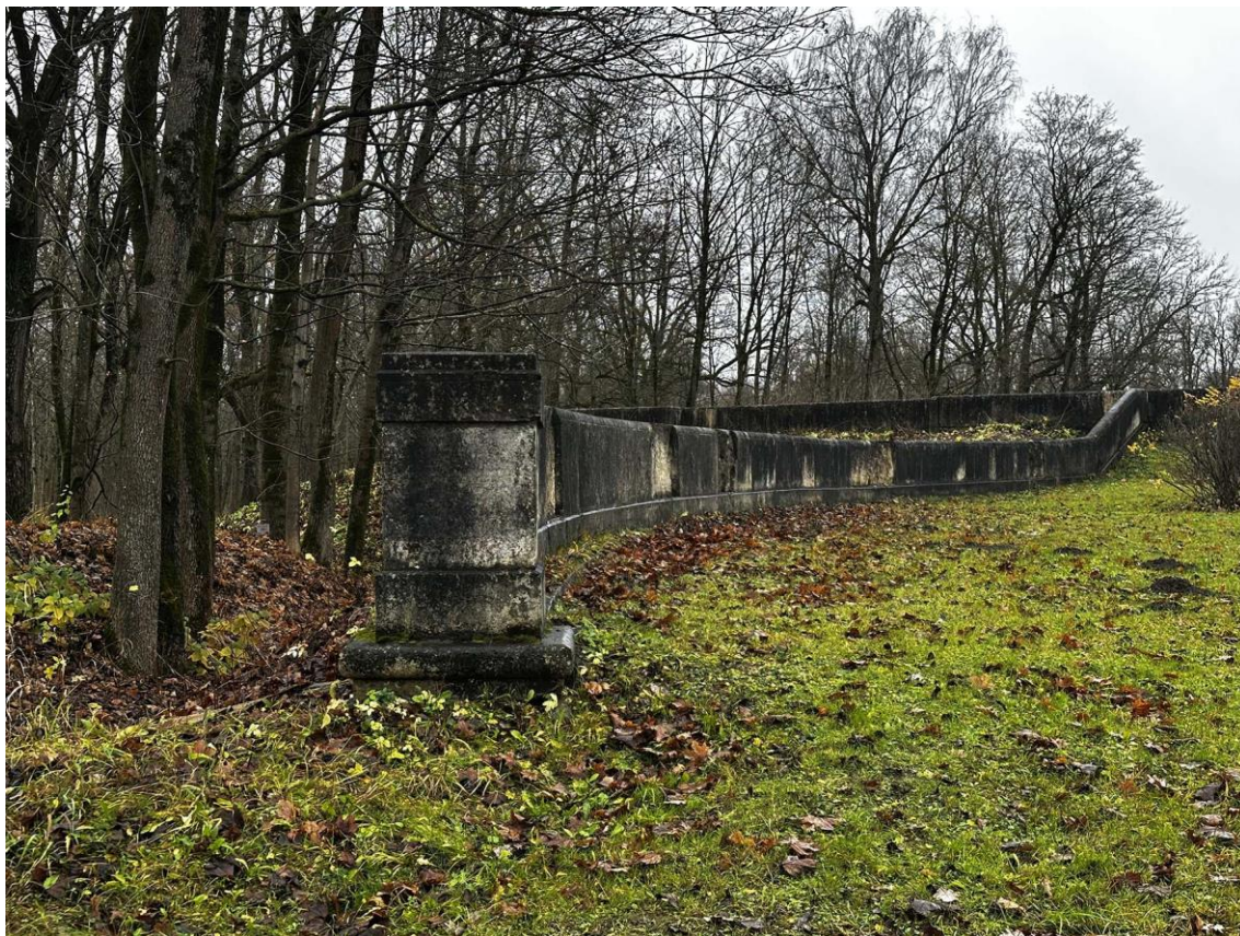
Фото 67. Юго-восточная часть подпорных (парапетных) стен с завершающей тумбой. Фото с севера. Дата съемки: 15.11.2025 г. Автор съемки: Куваева Ю.П.
