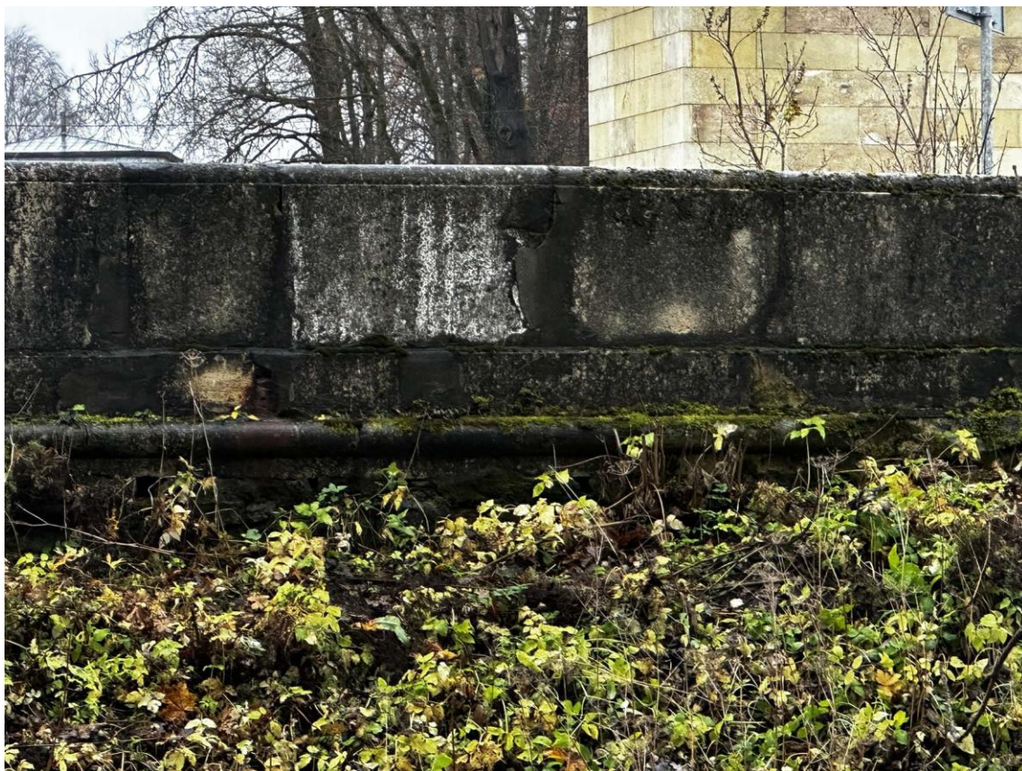
Фото 111. Юго-восточная часть подпорных (парапетных) стен. Угол поворота стен в точке 17. Фото с юго-востока. Дата съемки: 15.11.2025 г. Автор съемки: Куваева Ю.П.
