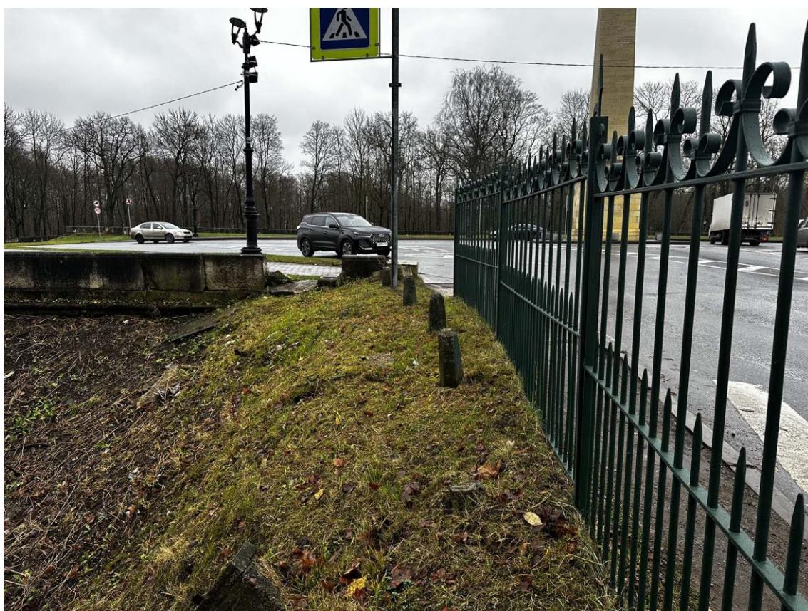
Фото 66. Северная часть подпорных (парапетных) стен. Фрагмент правой части наружной стороны стены на участке 5-4. Фото с запада. Дата съемки: 15.11.2025 г. Автор съемки: Куваева Ю.П.
