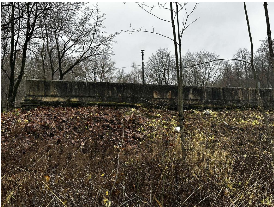
Фото 107. Юго-восточная часть подпорных (парапетных) стен. Левая часть наружной стороны стены на участке 18-17. Фото с востока. Дата съемки: 15.11.2025 г. Автор съемки: Куваева Ю.П.
