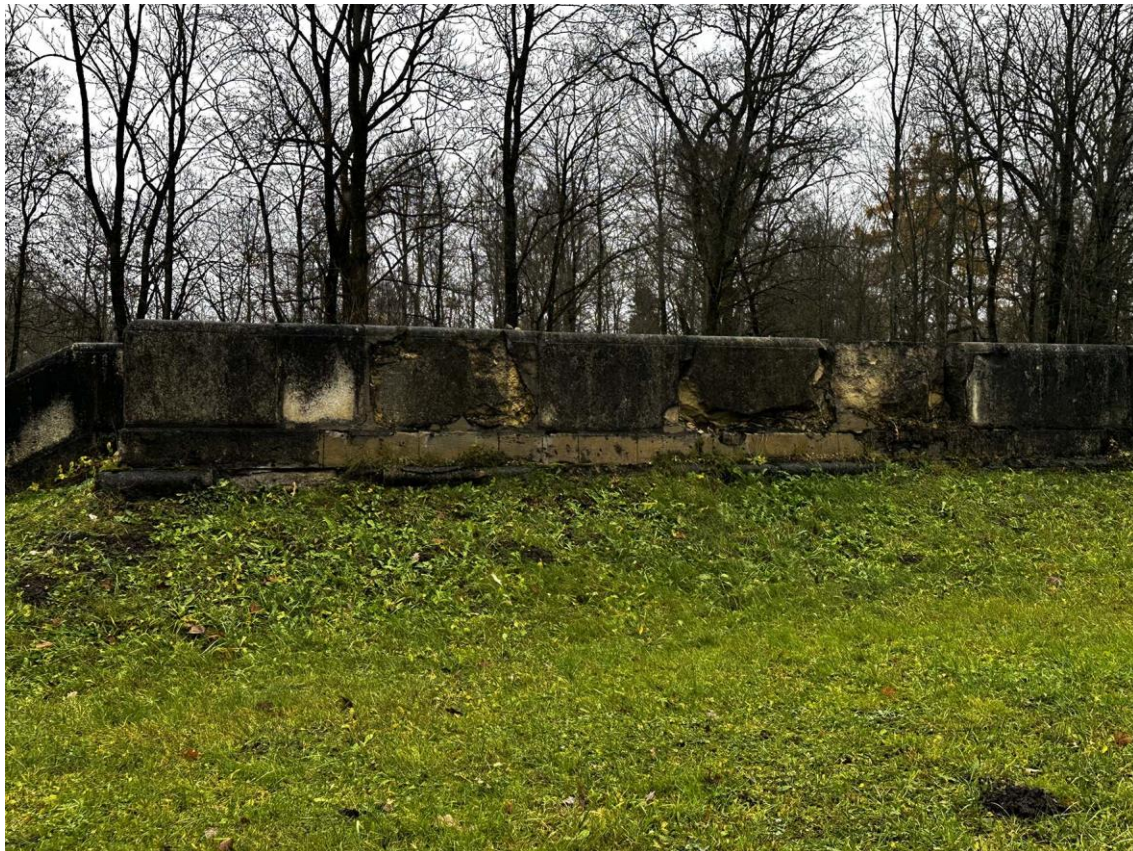
Фото 74. Юго-восточная часть подпорных (парапетных) стен. Левая часть внутренней стороны стены на участке 15-14. Фото с северо-запада. Дата съемки: 15.11.2025 г. Автор съемки: Куваева Ю.П.
