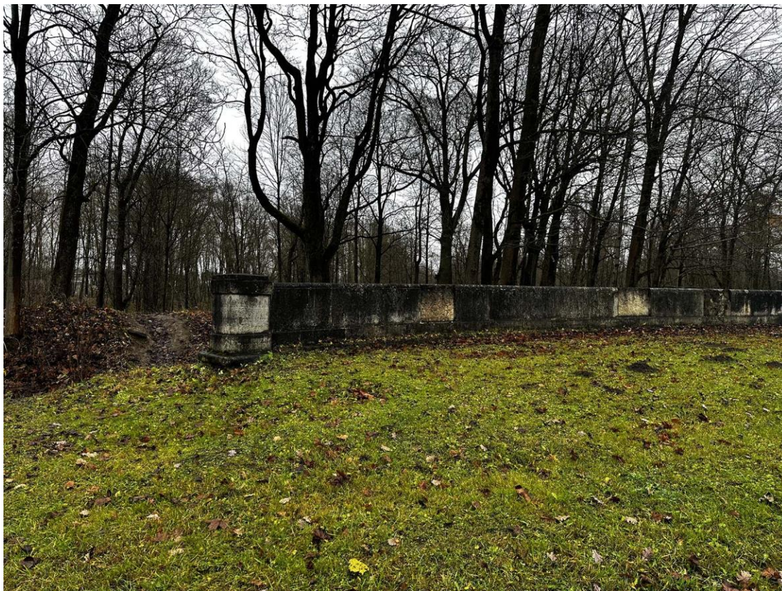
Фото 68. Юго-восточная часть подпорных (парапетных) стен. Общий вид внутренней стороны стены с завершающей тумбой участка 11-12. Фото с северо-запада. Дата съемки: 15.11.2025 г. Автор съемки: Куваева Ю.П.
