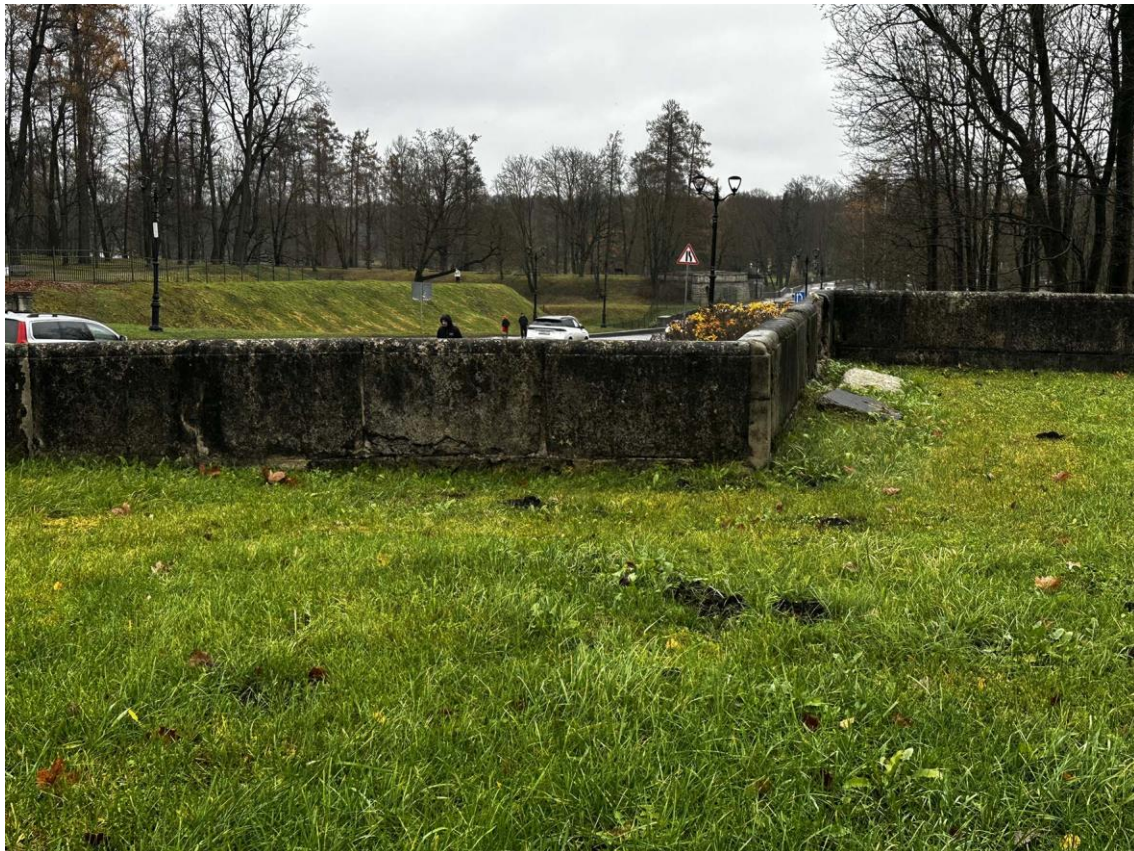
Фото 80. Юго-восточная часть подпорных (парапетных) стен. Правая часть внутренней стороны стены на участке 13-14. Фото с юга. Дата съемки: 15.11.2025 г. Автор съемки: Куваева Ю.П.
