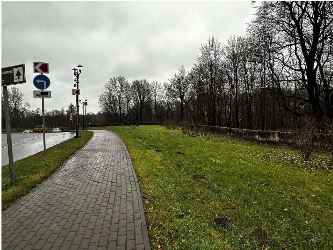
Фото 90. Юго-восточная часть подпорных (парапетных) стен. Общий вид внутренней стороны стен на участках 16-18. Фото с юго-запада. Дата съемки: 15.11.2025 г. Автор съемки: Куваева Ю.П.
