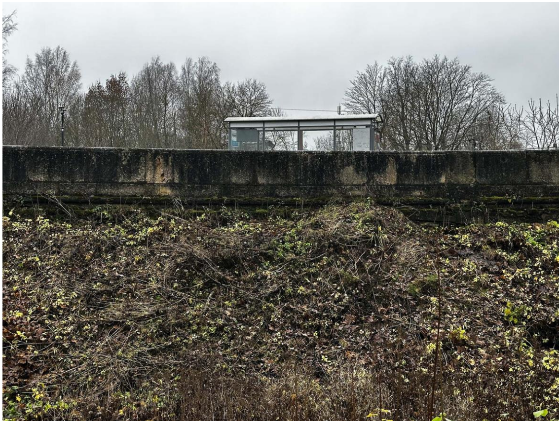
Фото 108. Юго-восточная часть подпорных (парапетных) стен. Фрагмент наружной стороны стены на участке 18-17. Фото с юго-востока. Дата съемки: 15.11.2025 г. Автор съемки: Куваева Ю.П.
