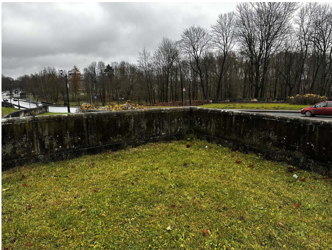
Фото 41. Северная часть подпорных (парапетных) стен. Внутренний угол поворота стены в точке 6. Фото с запада. Дата съемки: 15.11.2025 г. Автор съемки: Куваева Ю.П.
