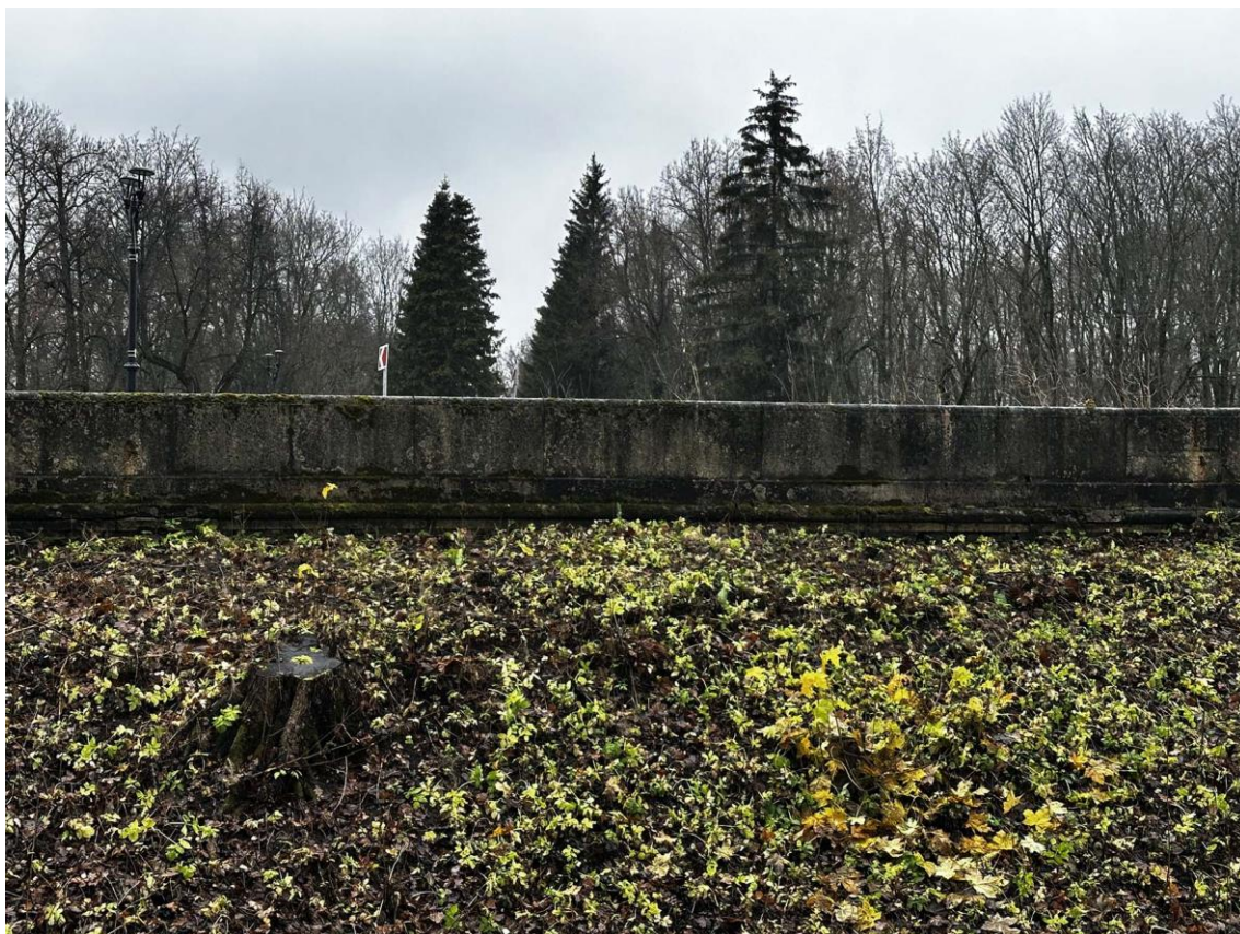
Фото 113. Юго-восточная часть подпорных (парапетных) стен. Средняя часть наружной стороны стены на участке 17-1. Фото с юго-востока. Дата съемки: 15.11.2025 г. Автор съемки: Куваева Ю.П.
