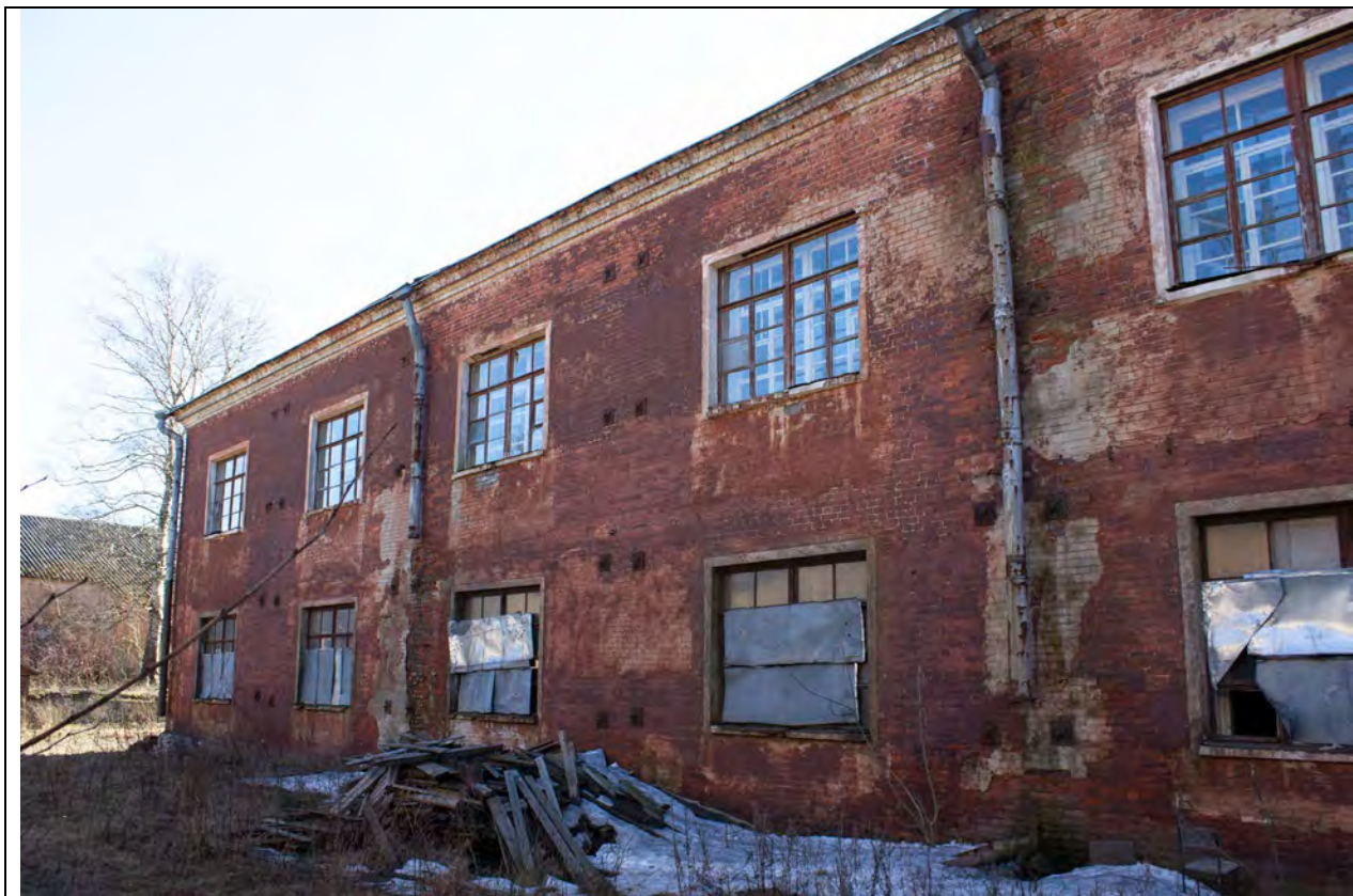
5. Северо-восточный фасад казармы № 30 (левая часть). Дата съемки: 20.03.2026.
