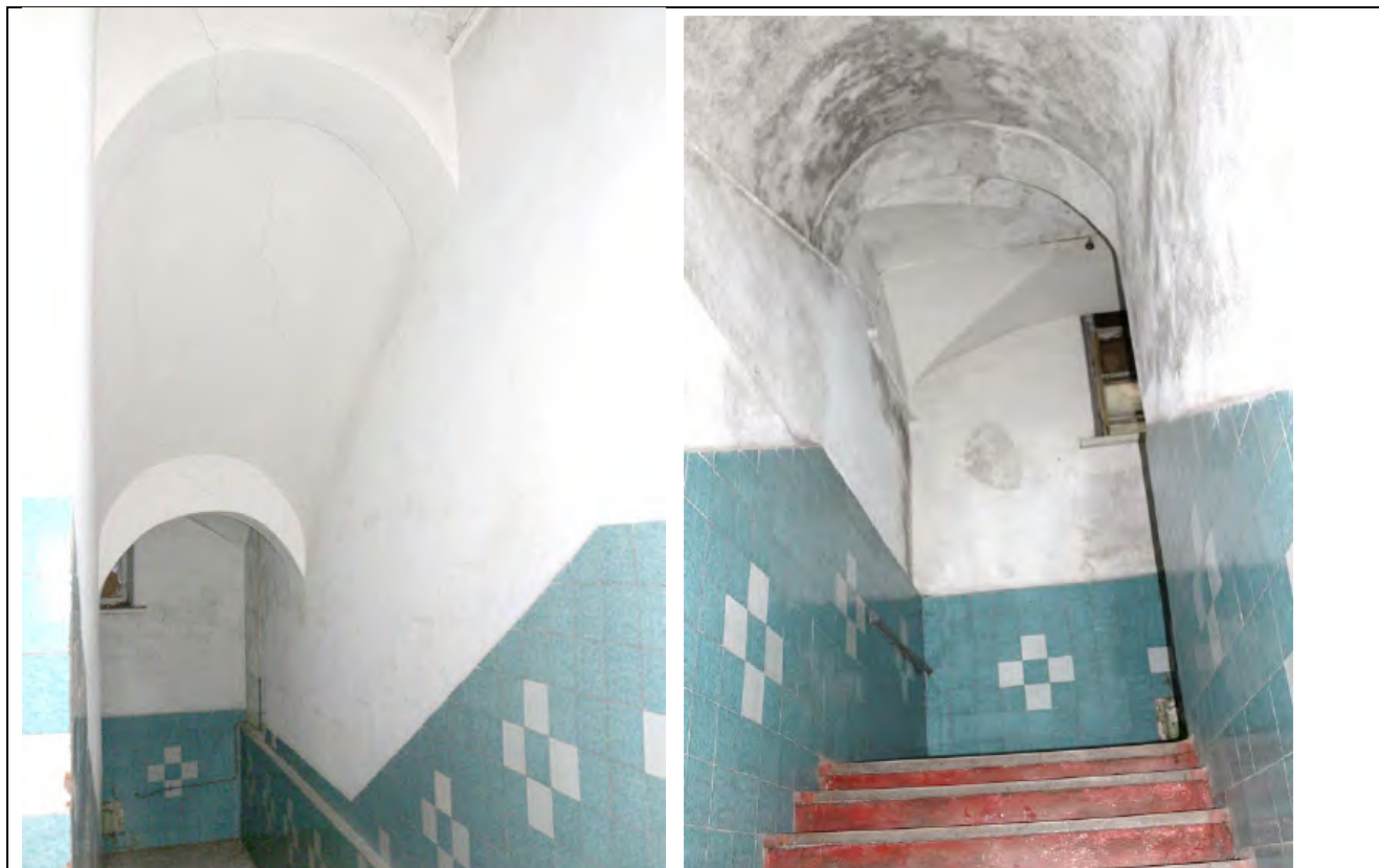
7. Вид сводов лестницы Л-1 в северо-западном крыле казармы.
