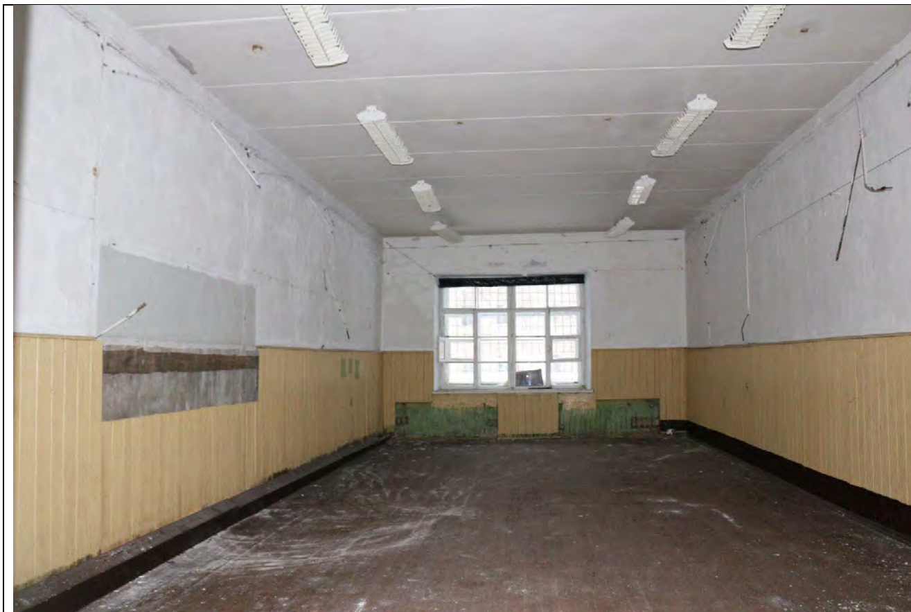
13. Общий вид помещения на 1 этаже средней части здания казармы.
