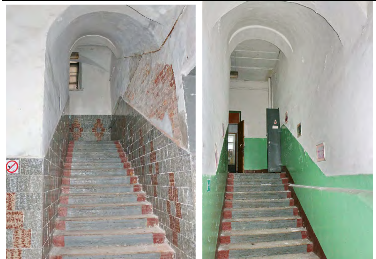
8. Вид сводов лестницы Л-2 в юго-восточном крыле казармы.
