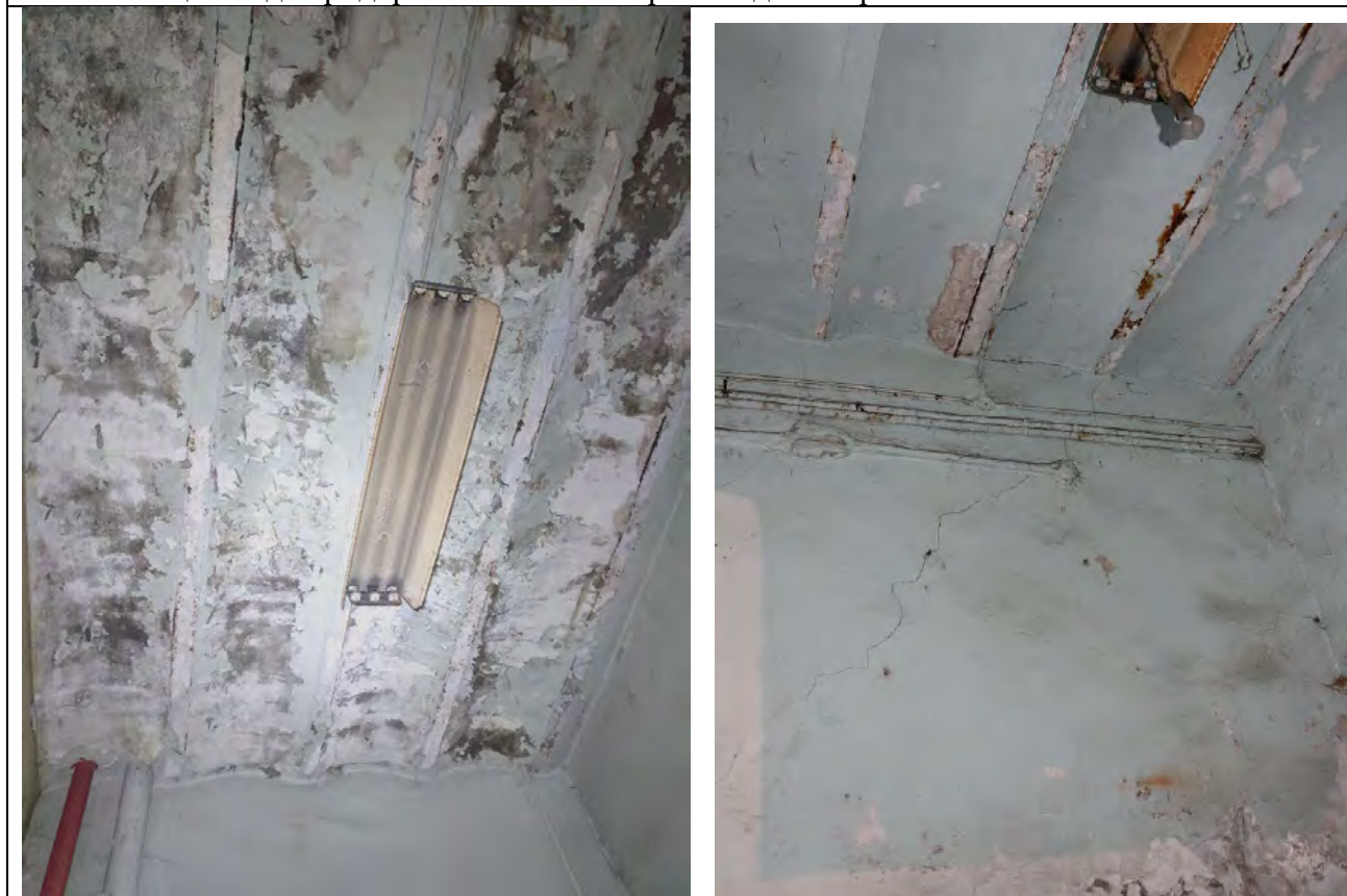
4. Своды монье в помещении тамбура 1 этажа северо-западного крыла.
