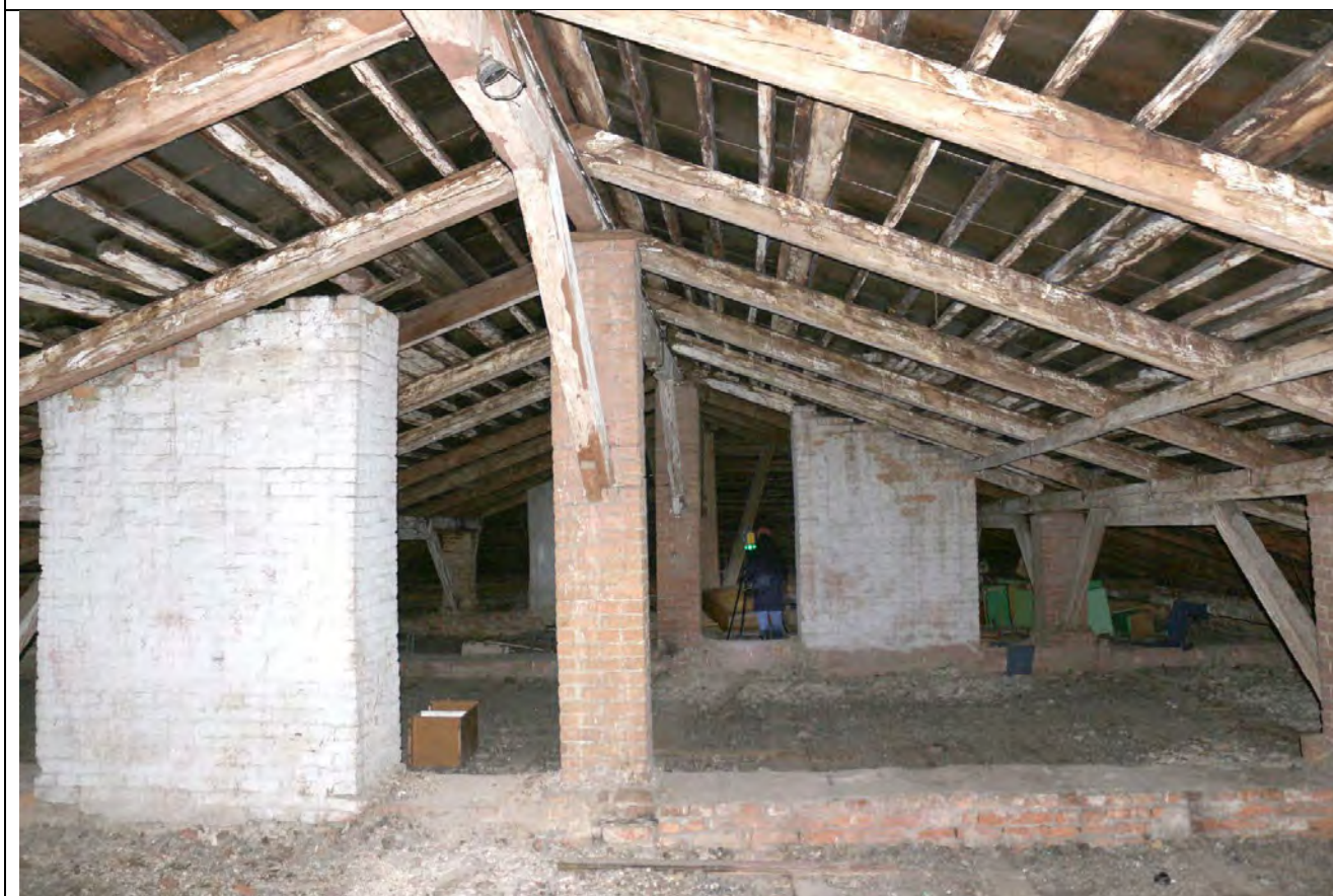
14. Общий вид чердака над северо-западным крылом здания.
