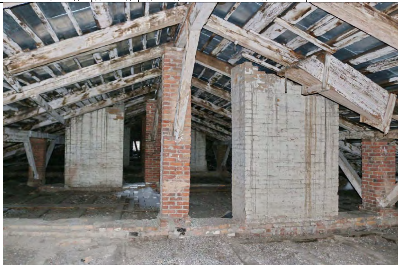
16. Общий вид чердака над юго-восточным крылом здания.
