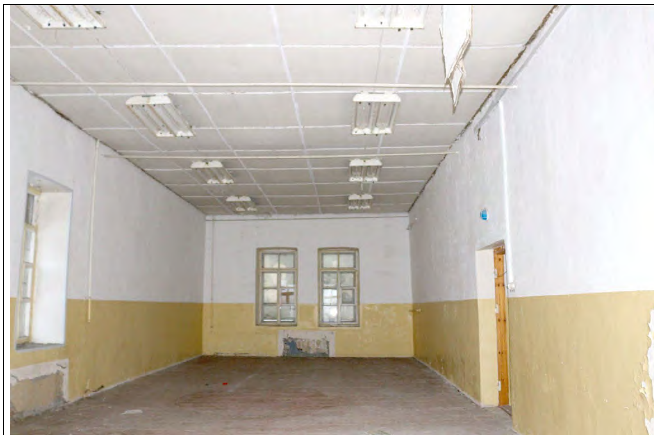
11. Вид помещения на 2 этаже северо-западного крыла.
