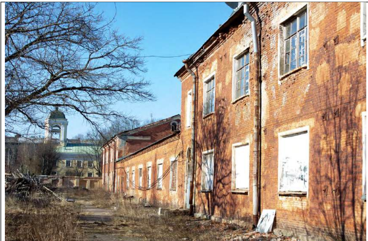
1. Юго-западный фасад казармы № 30. Дата съемки: 20.03.2026.
