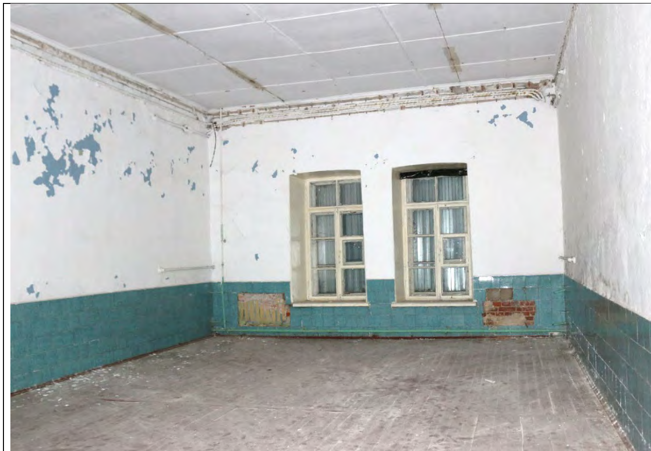
5. Общий вид помещения на 1 этаже северо-западного крыла.
