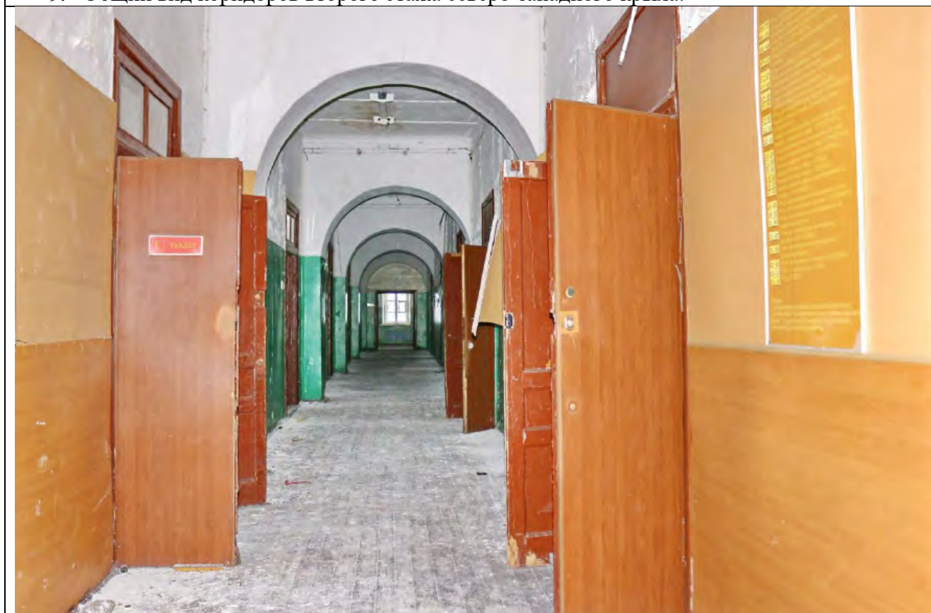
10. Общий вид коридоров второго этажа юго-восточного крыла.
