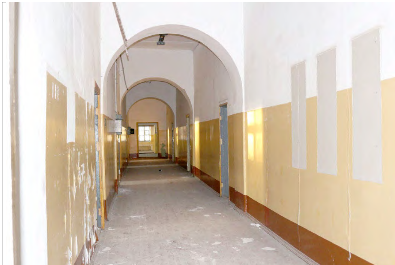
9. Общий вид коридоров второго этажа северо-западного крыла.
