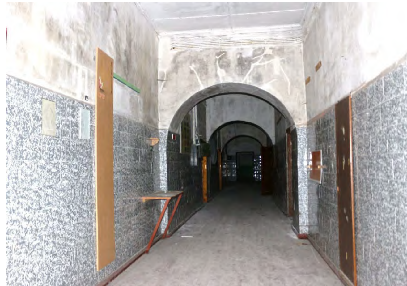
3. Общий вид коридора на 1 этаже северо-западного крыла.
