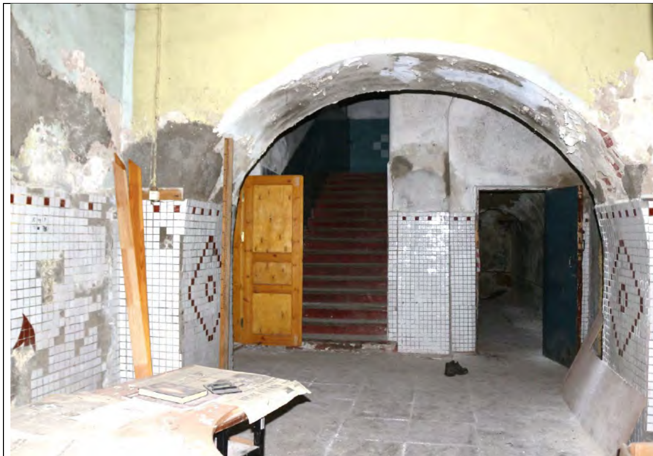
1. Лестничная клетка Л-1 на 1 этаже северо-западного крыла.
