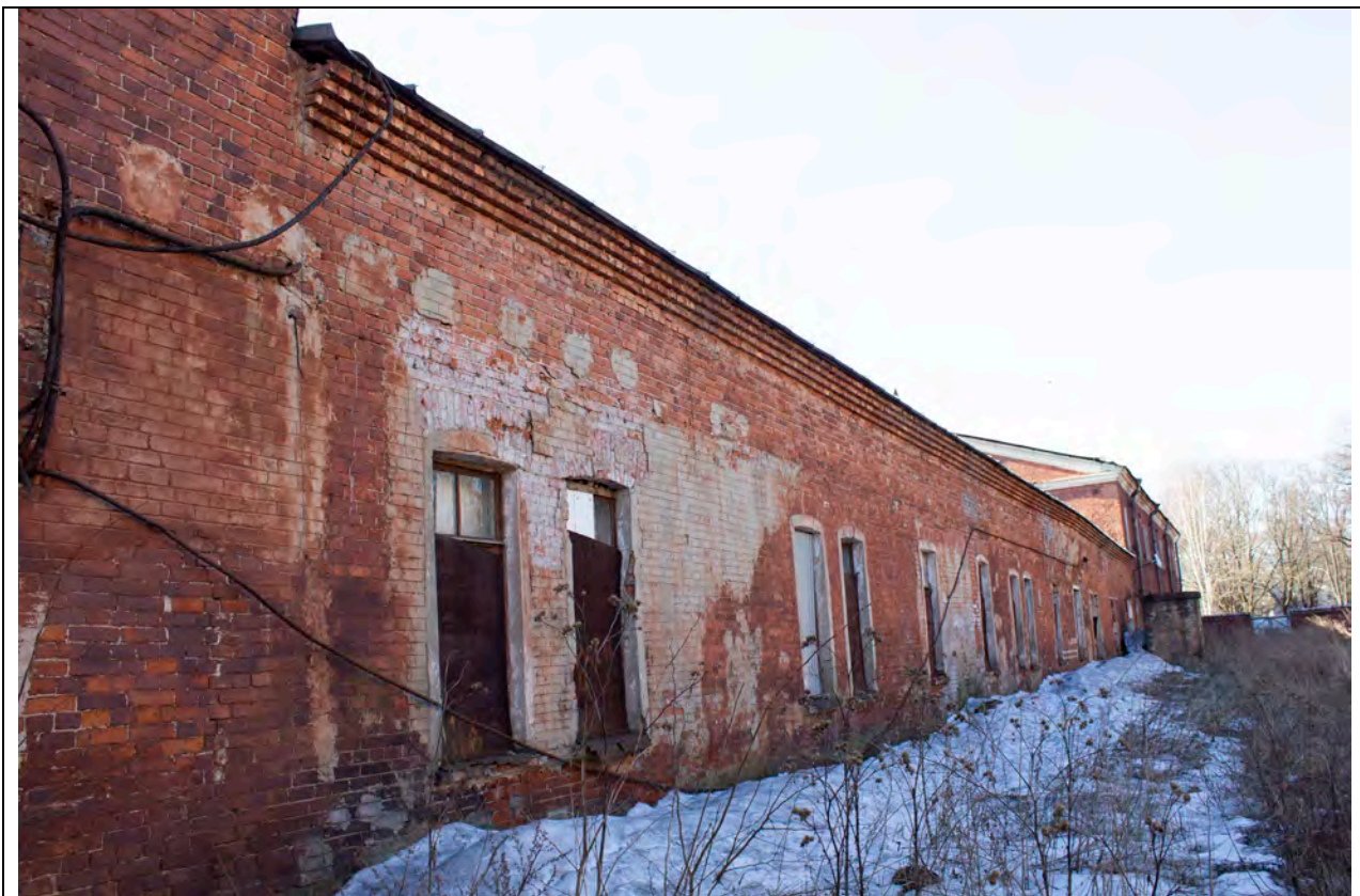
7. Северо-восточный фасад казармы № 30 (средняя часть). Дата съемки: 20.03.2026.
