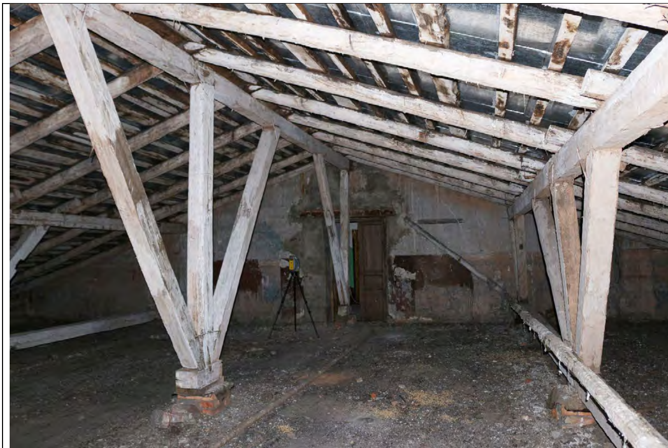
15. Общий вид чердака над средней одноэтажной частью здания казармы.
