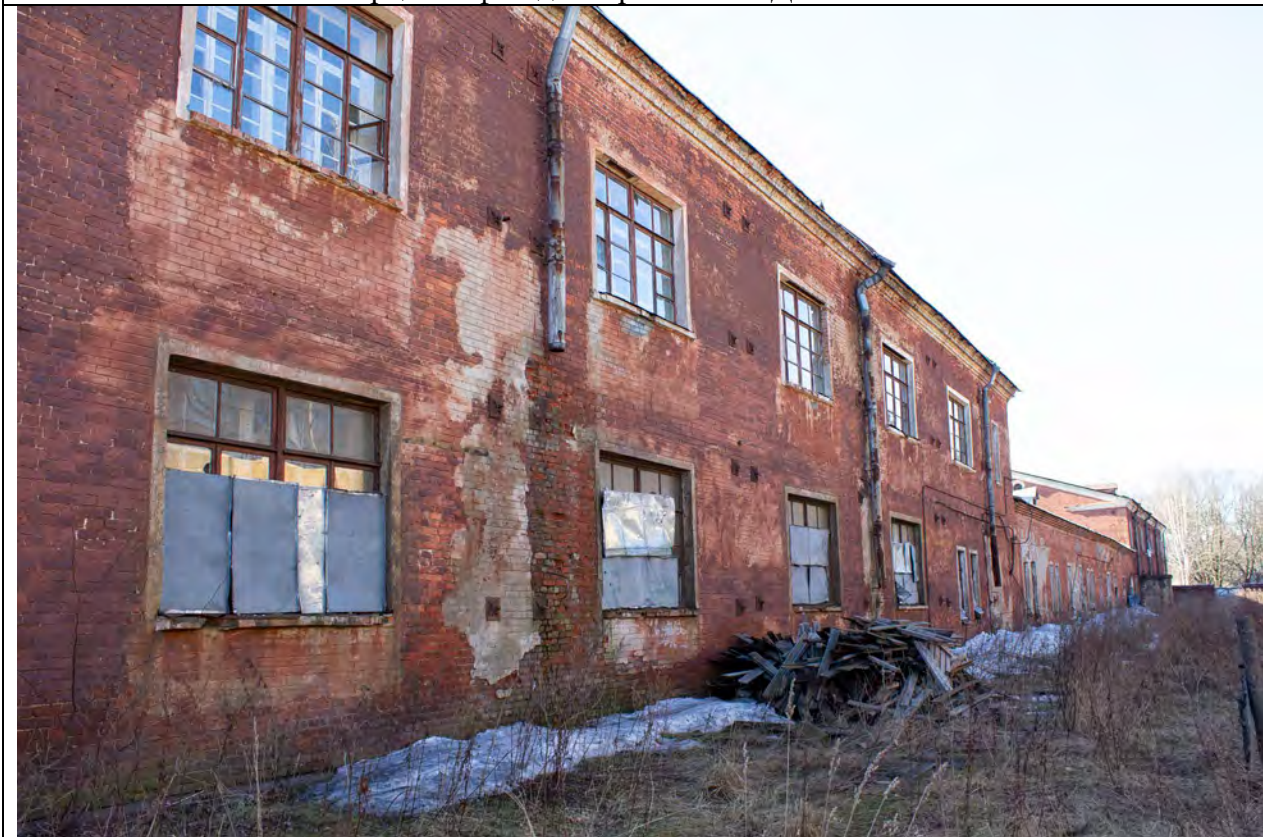
4. Северо-восточный фасад казармы № 30. Дата съемки: 20.03.2026.
