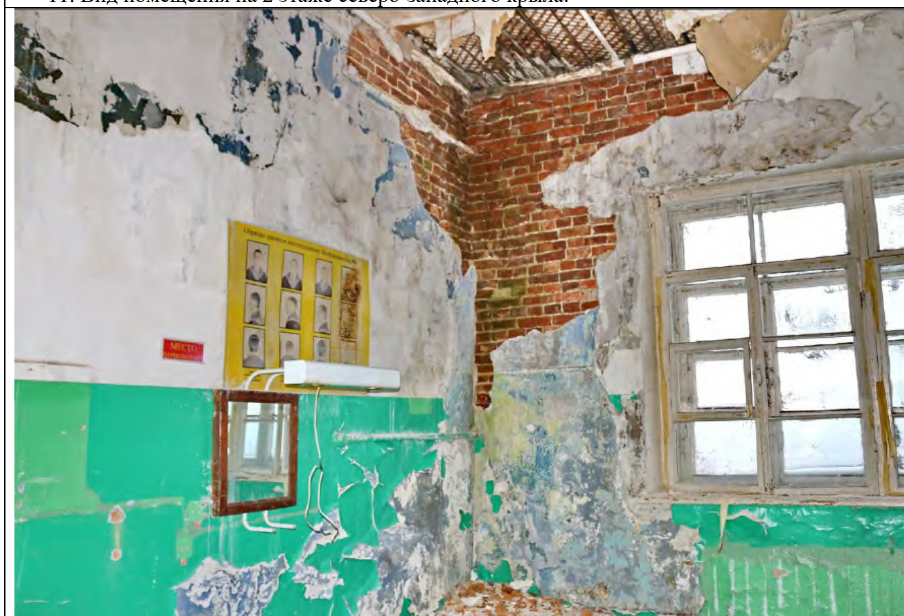
12. Вид помещения на 2 этаже юго-восточного крыла.
