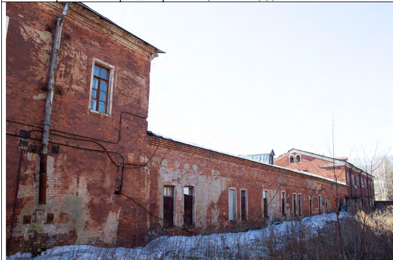
6. Северо-восточный фасад казармы № 30 (средняя часть). Дата съемки: 20.03.2026.
