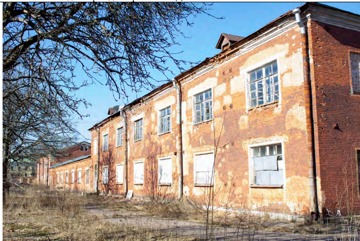
2. Юго-западный фасад казармы № 30. Дата съемки: 20.03.2026.
