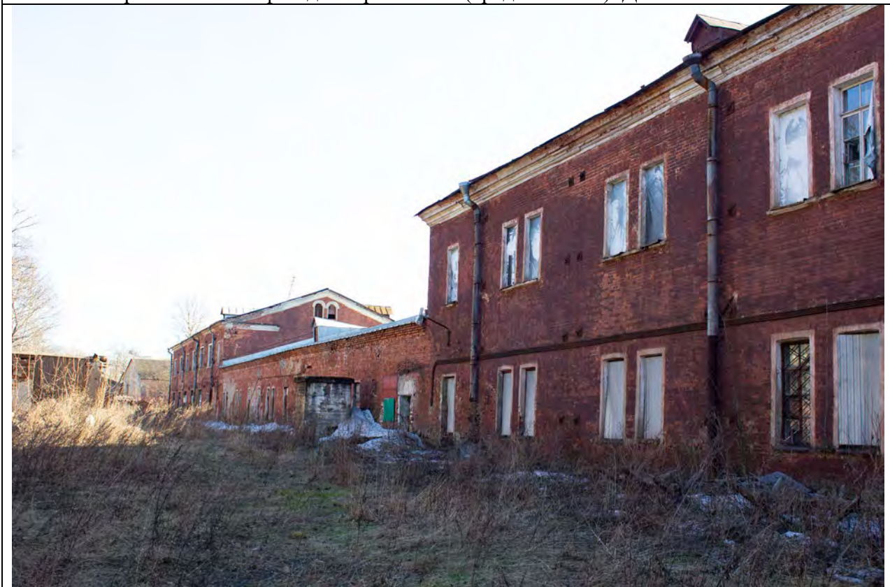
8. Северо-восточный фасад казармы № 30 (правая часть). Дата съемки: 20.03.2026.
