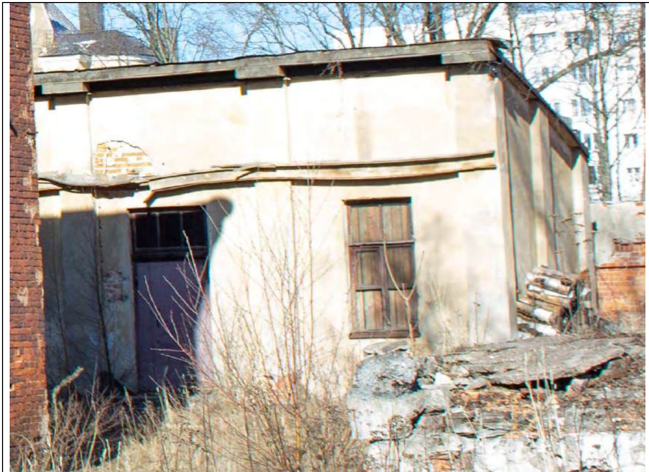
11. Юго-западный фасад склада (лит. О). Дата съемки: 20.03.2026.
