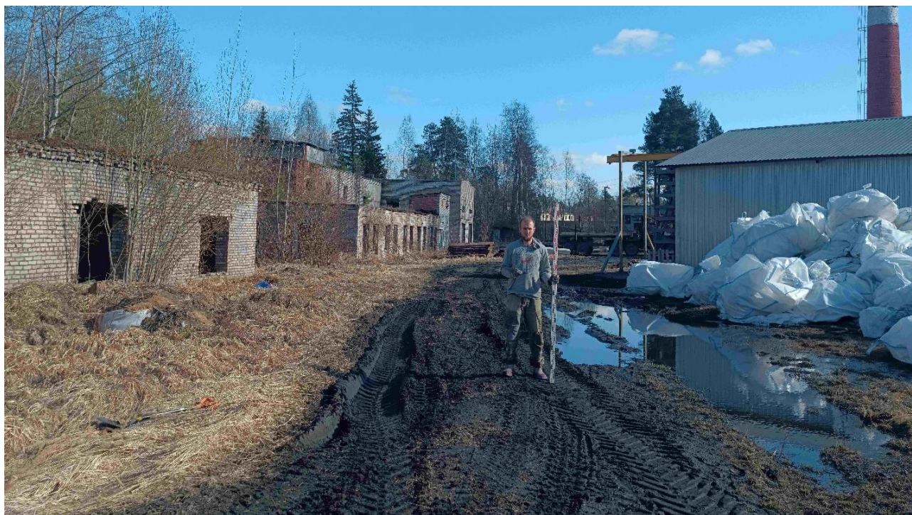
Рис. 26. Тихвин-2026. пос. Красава, Заводской проезд, 18Б. Точка фотофиксации 6, вид с запада.
