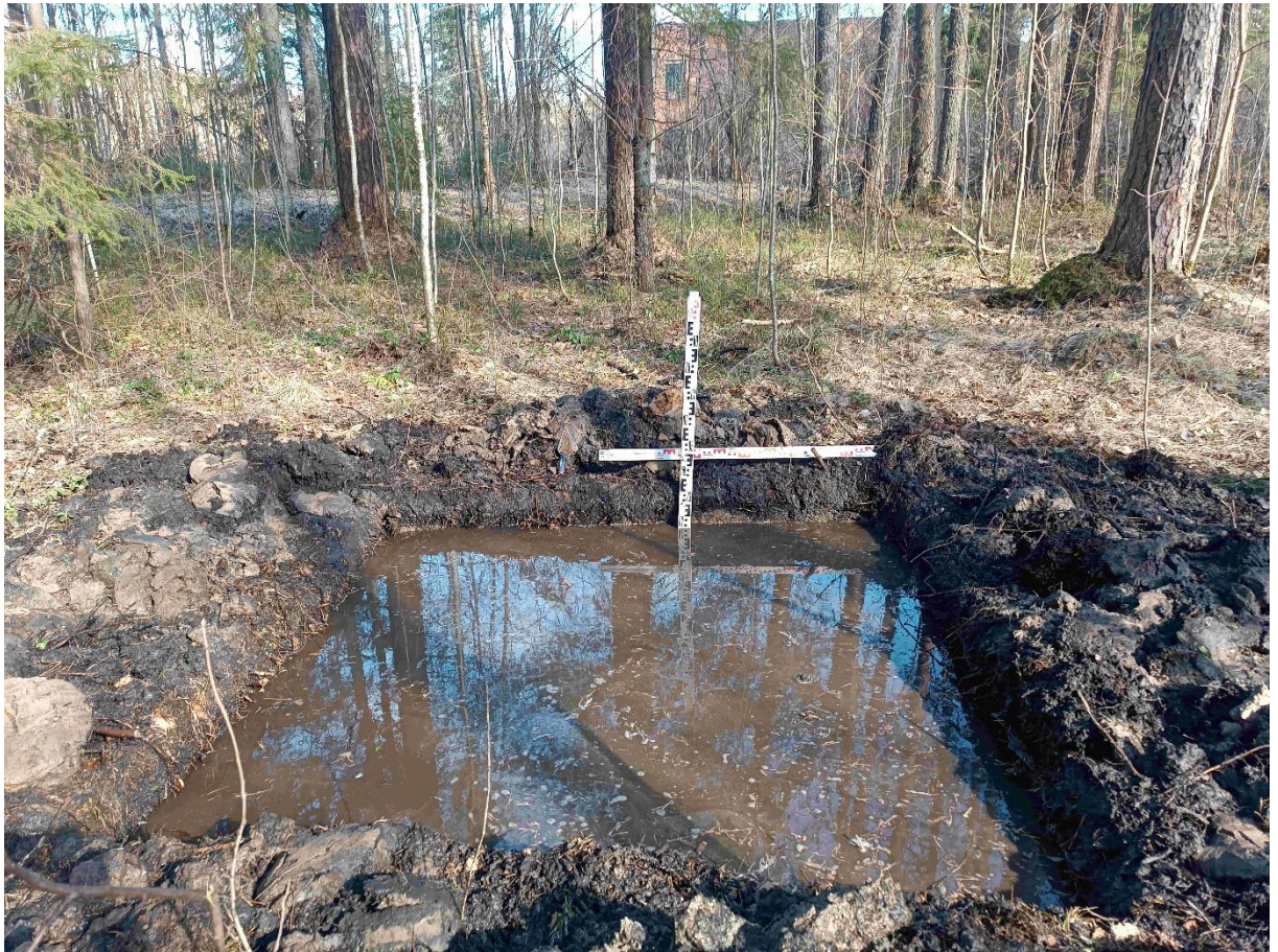
Рис. 45. Тихвин-2026. пос. Красава, Заводской проезд, 18Б. Шурф 2, фиксация по уровню прекращения работ, вид с юга.
