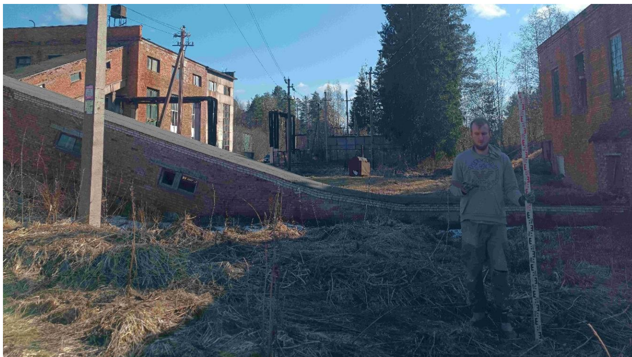
Рис. 24. Тихвин-2026. пос. Красава, Заводской проезд, 18Б. Точка фотофиксации 5, вид с запада.
