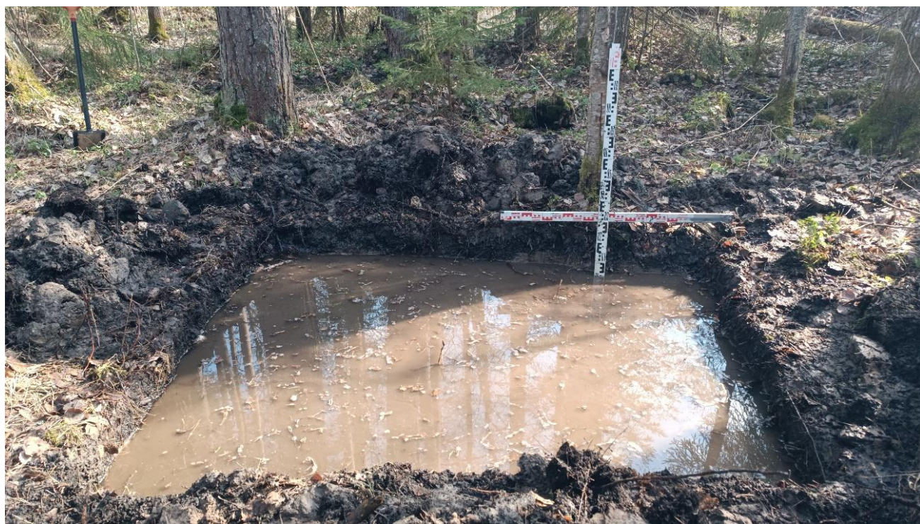
Рис. 40. Тихвин-2026. пос. Красава, Заводской проезд, 18Б. Шурф 1, фиксация по уровню прекращения работ, вид с запада.
