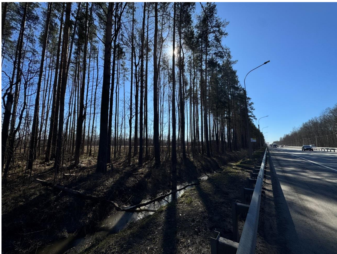
Фот. 2 Вид на шосе «Дорога Жизни» в направлении Санкт-Петербурга у участка проектирования
