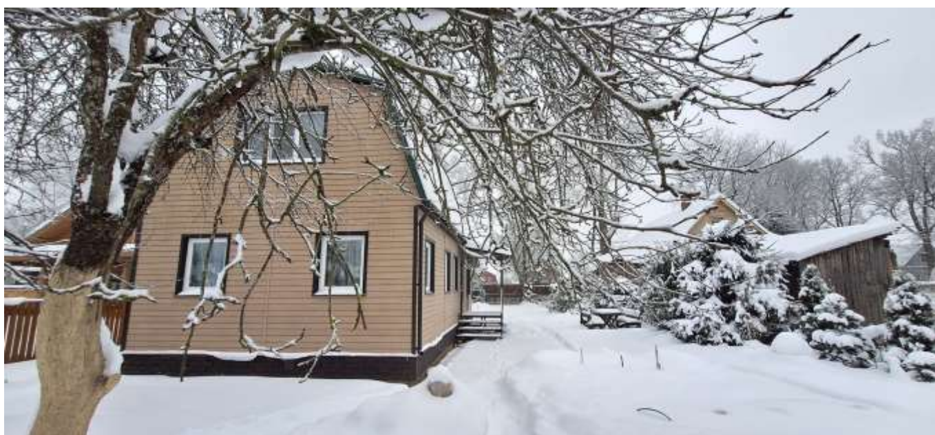
Фото 16. Общий вид на северо-западный фасад двухэтажного здания с кадастровым номером 47:23:0912002:249, расположенного по адресу: д. Лампово, ул. Центральная, д. 28 и земельный участок с кадастровым номером 47:23:0912002:92.
