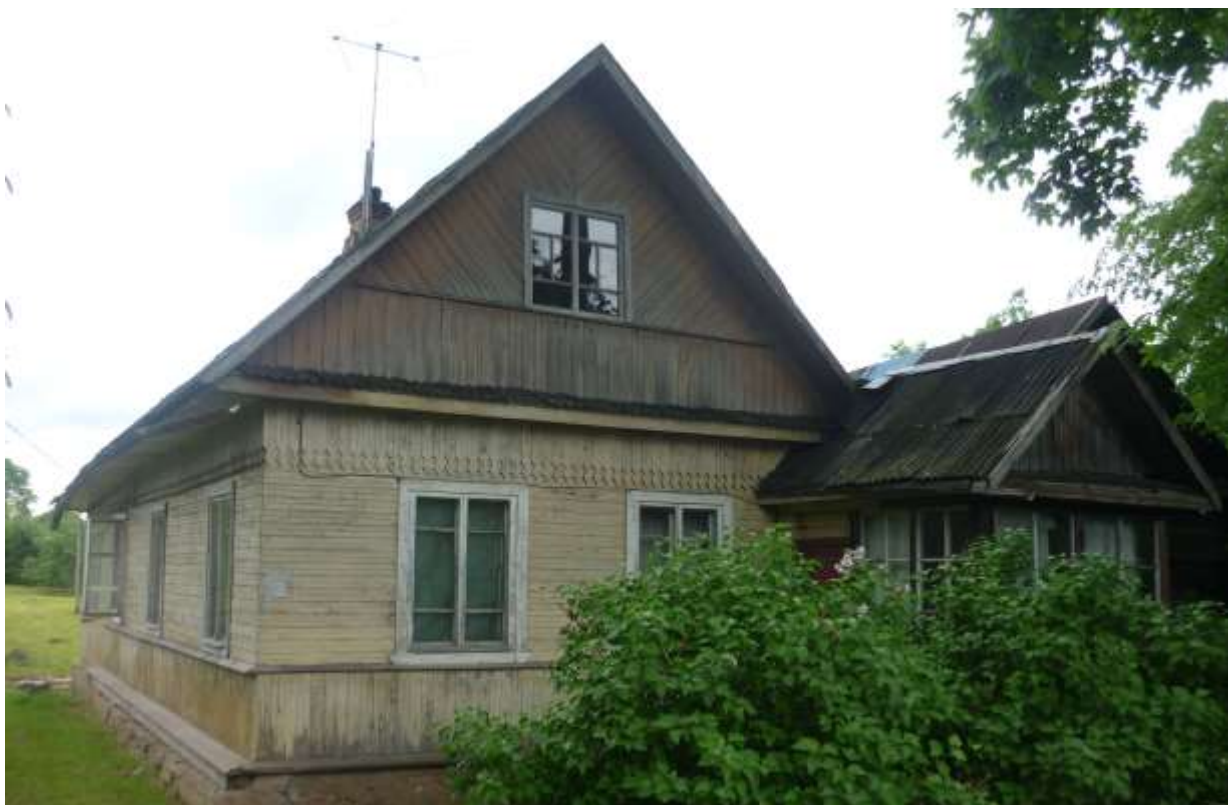
Рис. 27. Лицевой фасад левой части дома по адресу ул. Центральная, 28. Фото Мильчика М.И. 2017 г.
