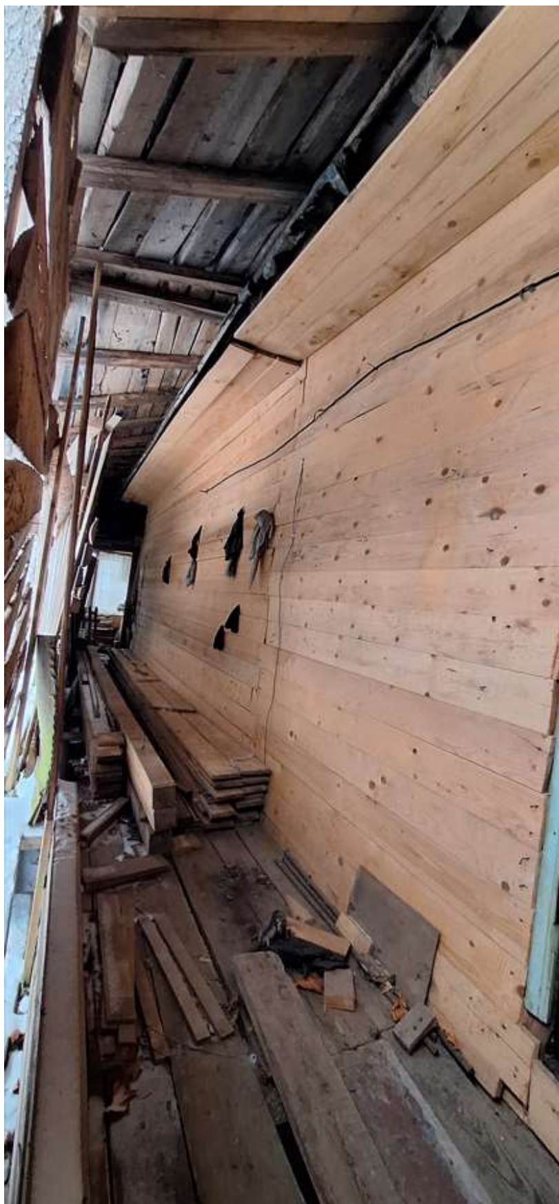
Фото 18. Вид на фрагмент северо-восточного фасада одноэтажного здания по адресу: д. Лампово, ул. Центральная, д. 28а, примыкавшего к юго-западному фасаду Объекта культурного наследия, в юго-восточном направлении.
