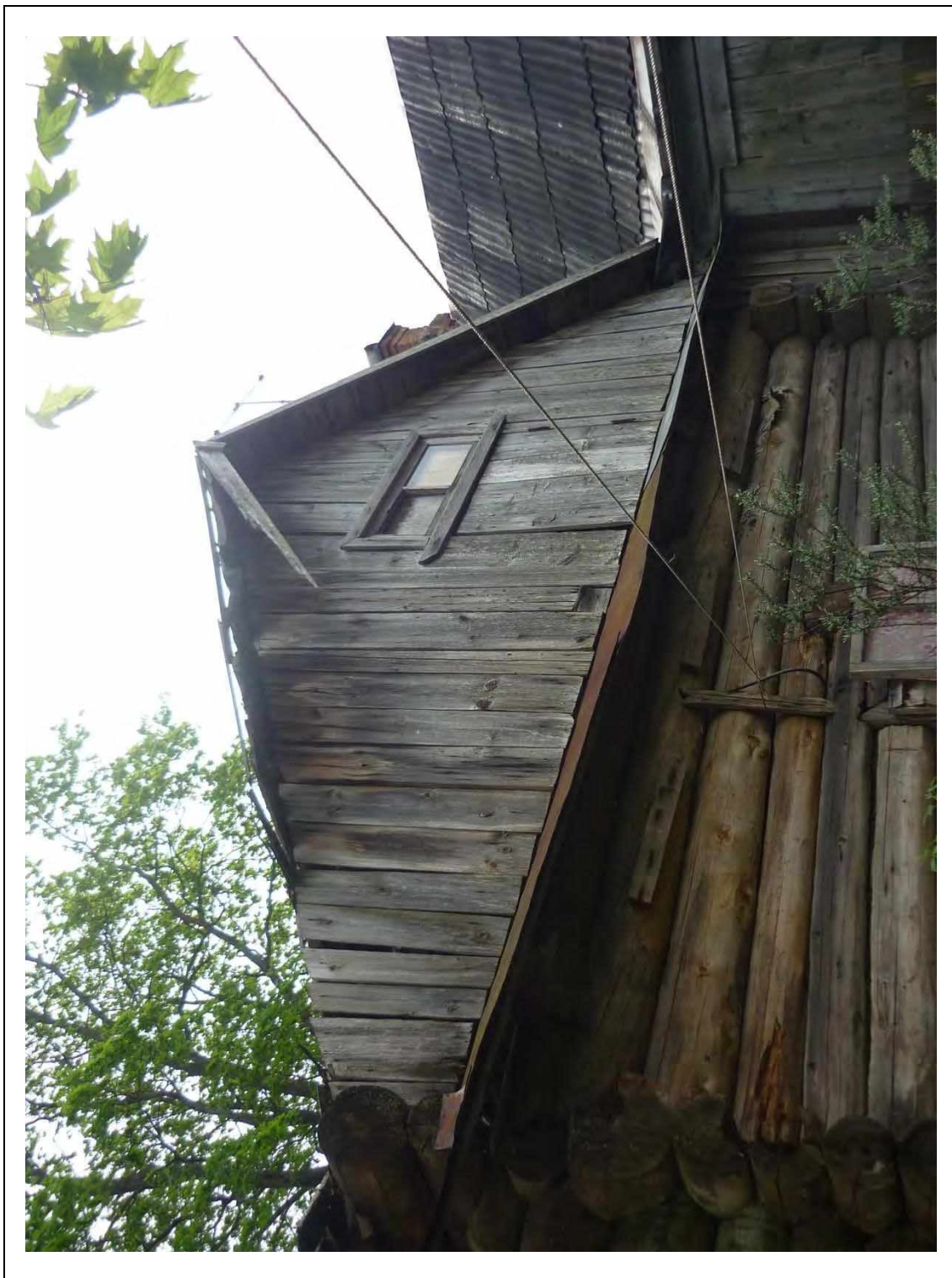
12. Чердак северо-западного фасада правой части дома по адресу ул. Центральная, 28.
