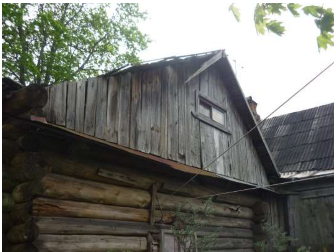
Рис. 22. Чердак северо-западного фасада правой части дома по адресу ул. Центральная, 28. Фото Мильчика М.И. 2017 г.
