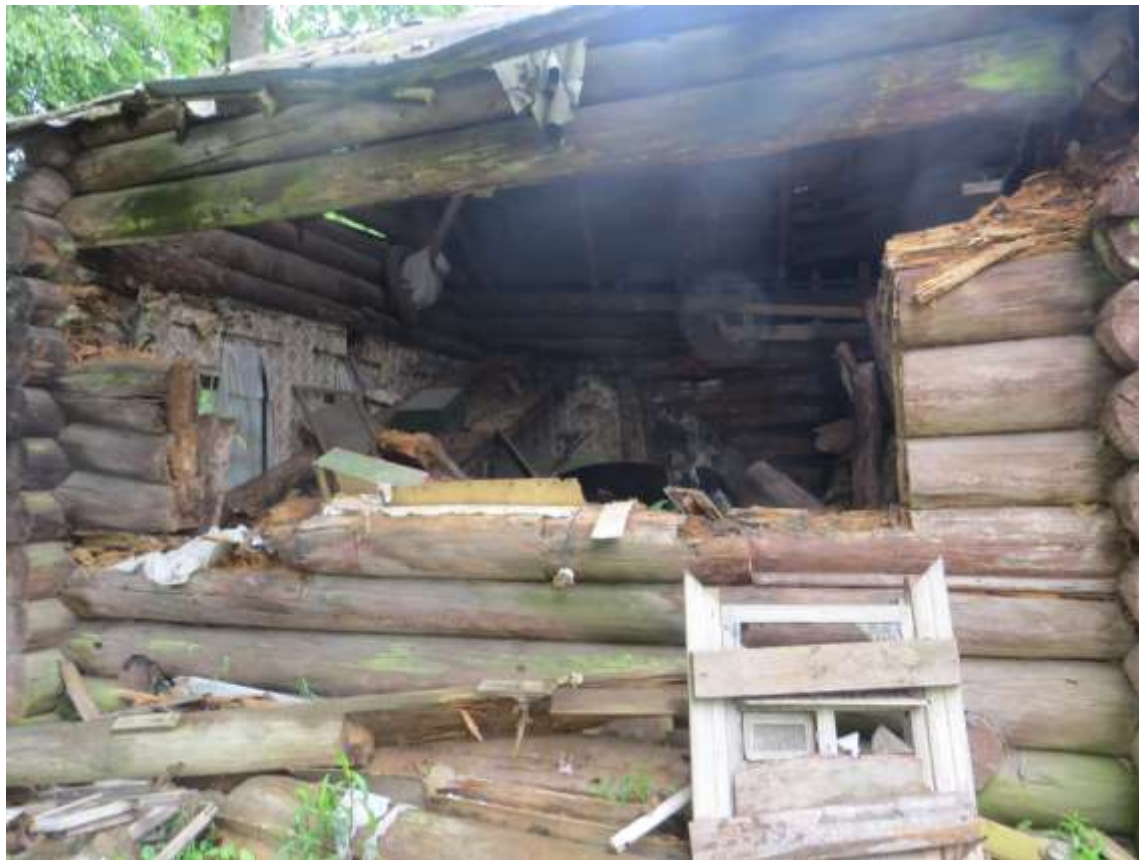
Рис. 20. Северо-восточный фасад (фрагмент) правой части дома по адресу ул. Центральная, 28. Фото Мильчика М.И. 2017 г.
