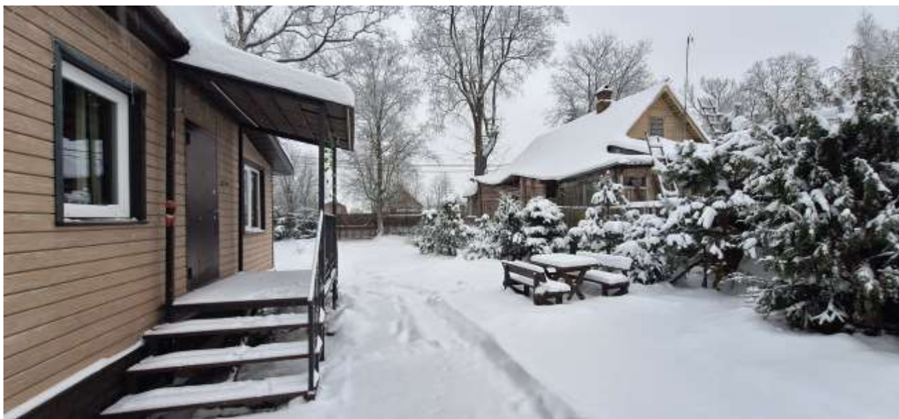
Фото 15. Фрагмент юго-западного фасада двухэтажного здания с кадастровым номером 47:23:0912002:249, расположенного по адресу: д. Лампово, ул. Центральная, д. 28 и северо-восточный и северо-западные фасады одноэтажного здания по адресу: д. Лампово, ул. Центральная, д. 28а, примыкавшего к юго-западному фасаду Объекта культурного наследия.
