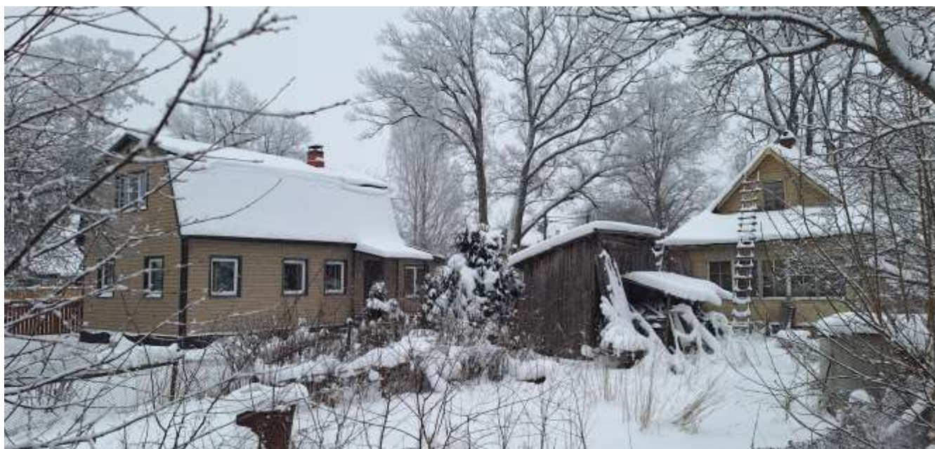
Фото 10. Общий вид на и северо-западный и юго-западный фасады двухэтажного здания с кадастровым номером 47:23:0912002:249, расположенного по адресу: д. Лампово, ул. Центральная, д. 28 и северо-западный фасад одноэтажного здания по адресу: д. Лампово, ул. Центральная, д. 28а, примыкавшего к юго-западному фасаду Объекта культурного наследия.
