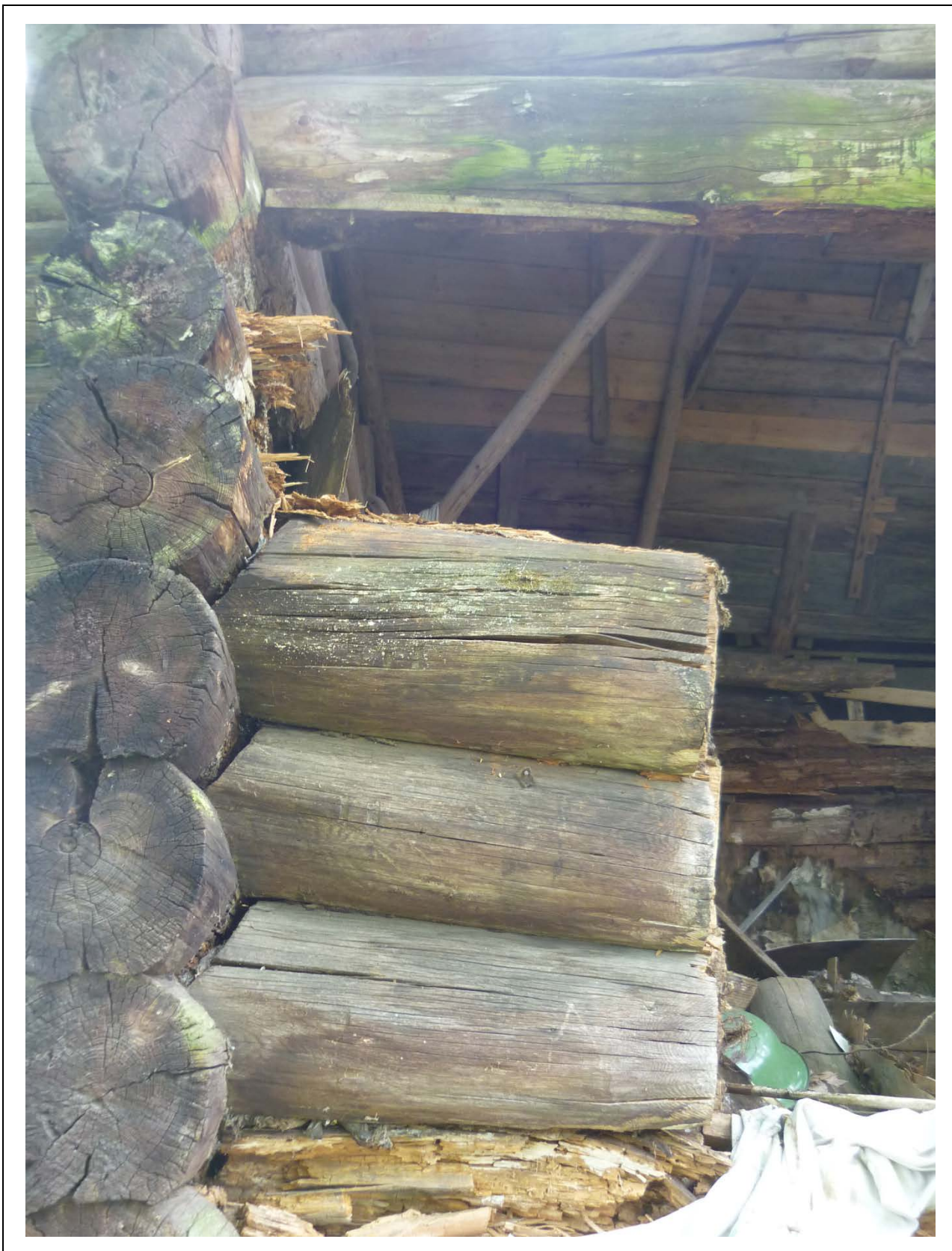
16. Часть бревен стены северо-восточного фасада правой части дома по адресу ул. Центральная, 28.
