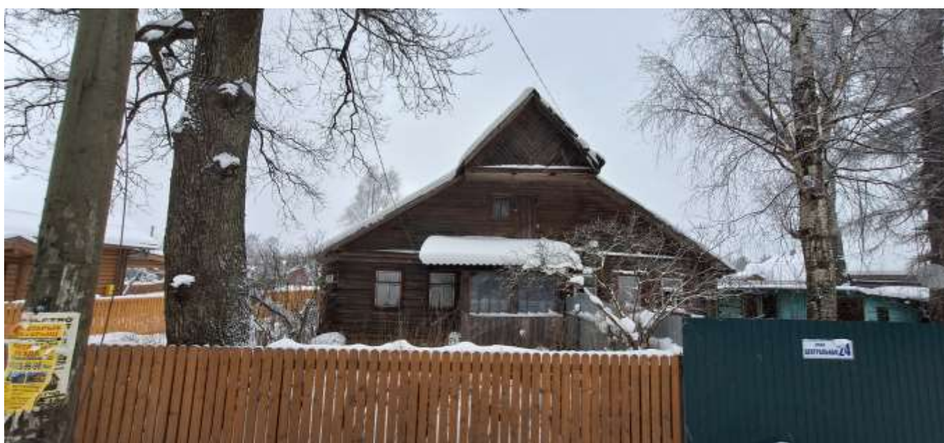
Фото 2. Общий вид на юго-восточный фасад жилого дома - объекта культурного наследия регионального значения «Дом Т.С. Егоровой, Т.Н. Прохоровой, А.М. Раскатовой, Л.Н. Родионовой», расположенного по адресу: д. Лампово, ул. Центральная, д. 24.
