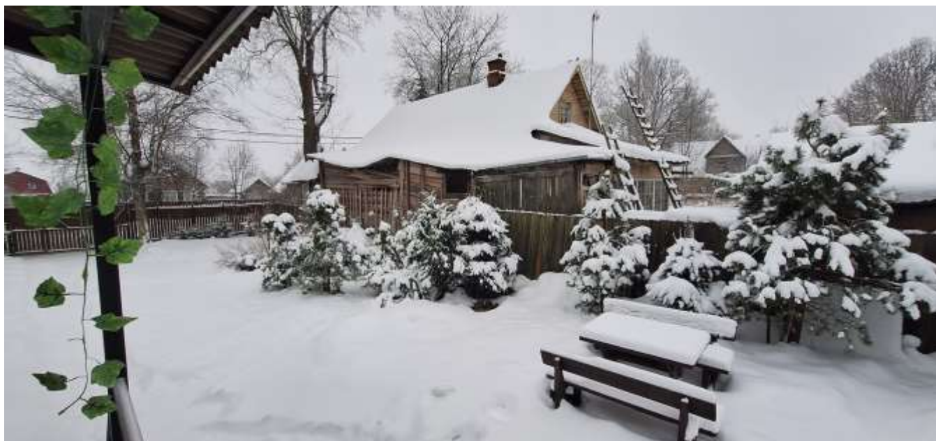
Фото 14. Общий вид на северо-восточный и северо-западные фасады одноэтажного здания по адресу: д. Лампово, ул. Центральная, д. 28а, примыкавшего к юго-западному фасаду Объекта культурного наследия, кустарники и хвойные деревья, посаженные на месте расположения Объекта культурного наследия.
