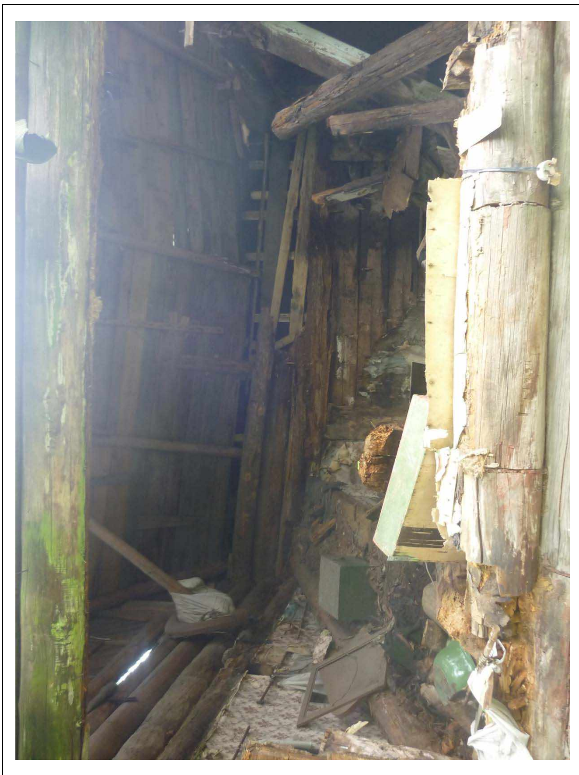
17. Интерьер правой части дома по адресу ул. Центральная, 28.
