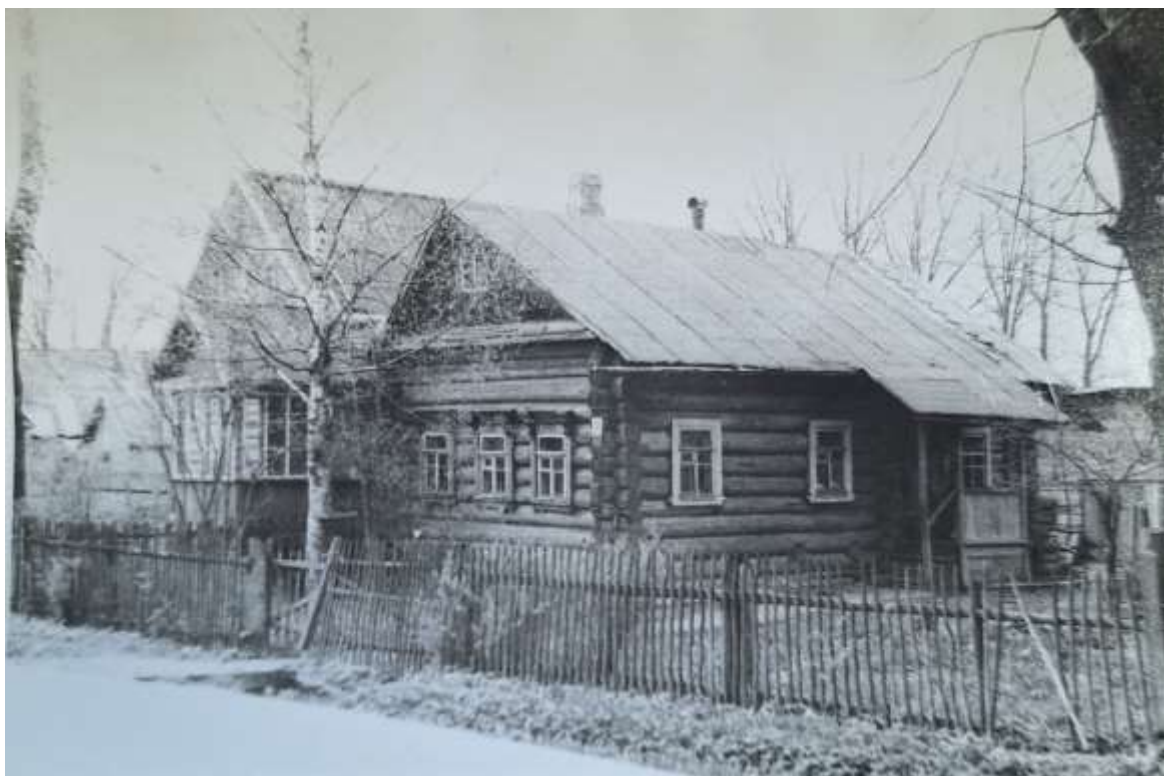
Рис. 9. Гатчинский р-н, д. Лампово, Жилой дом, ул. Центральная, 28. Общий вид. Фото Чуружаева С.И. 1983 г. 9
