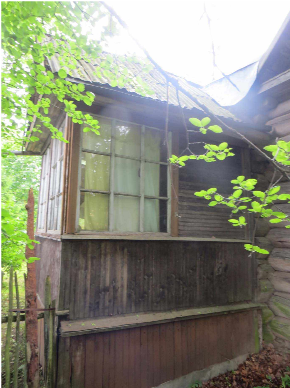
9. Крытое крыльцо (фрагмент) с северо-восточной стороны левой части дома по адресу ул. Центральная, 28.
