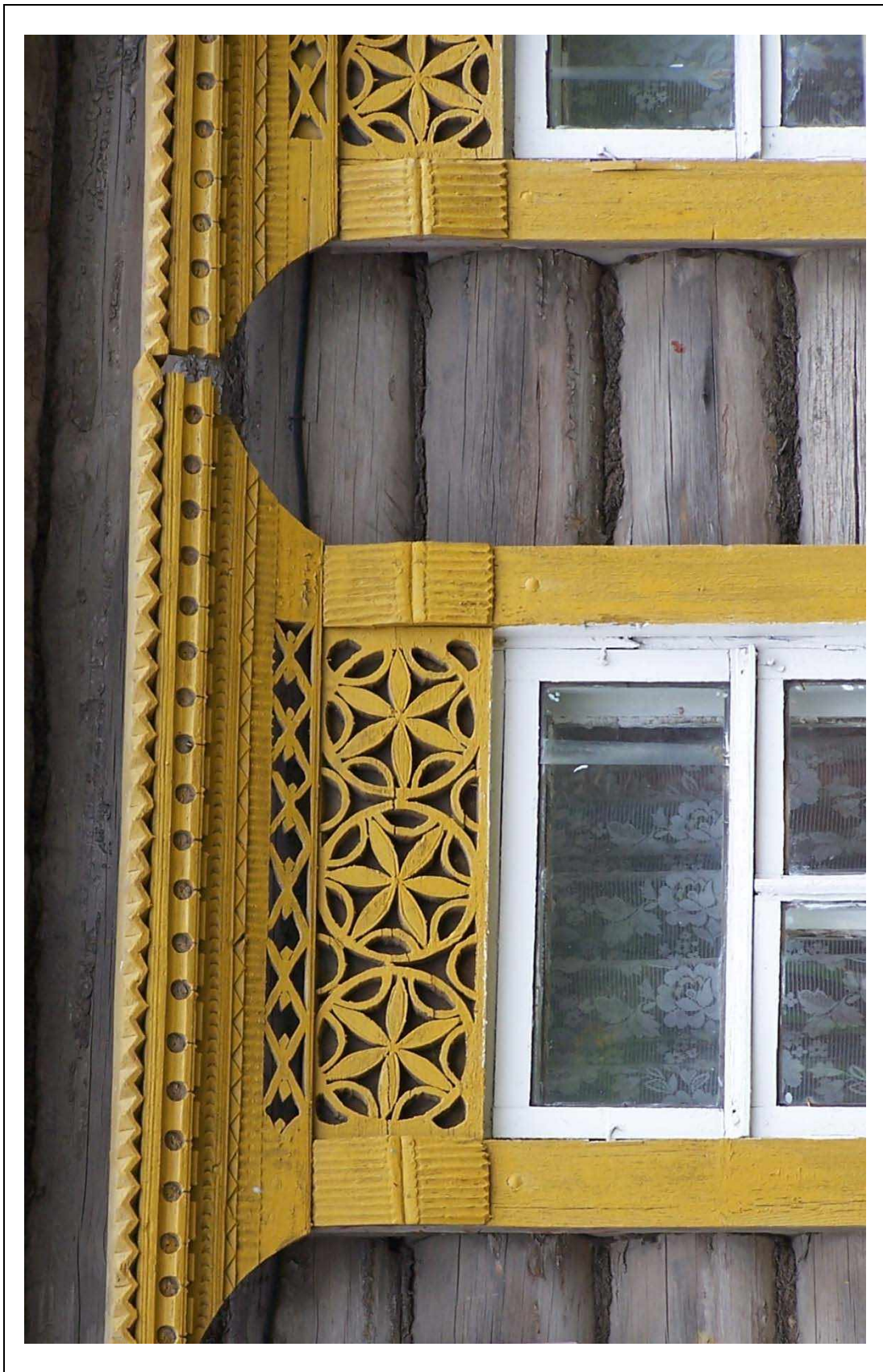
20. Историческая среда. Резной декор окна в доме по адресу ул. Центральная, 79. Фото Л.В. Корольковой, 2009.
