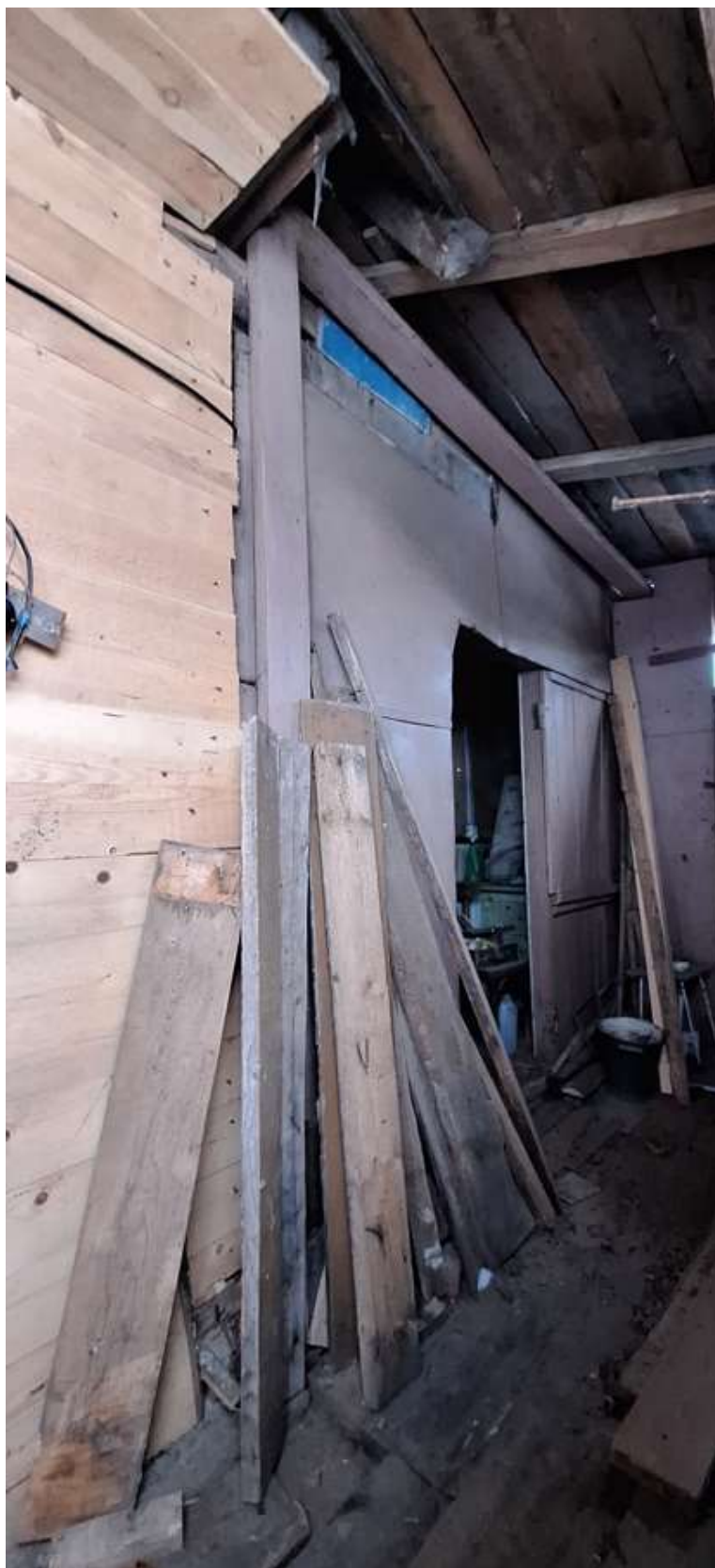
Фото 19. Вид на фрагмент северо-восточного фасада одноэтажного здания по адресу: д. Лампово, ул. Центральная, д. 28а, примыкавшего к юго-западному фасаду Объекта культурного наследия, в северо-западном направлении.
