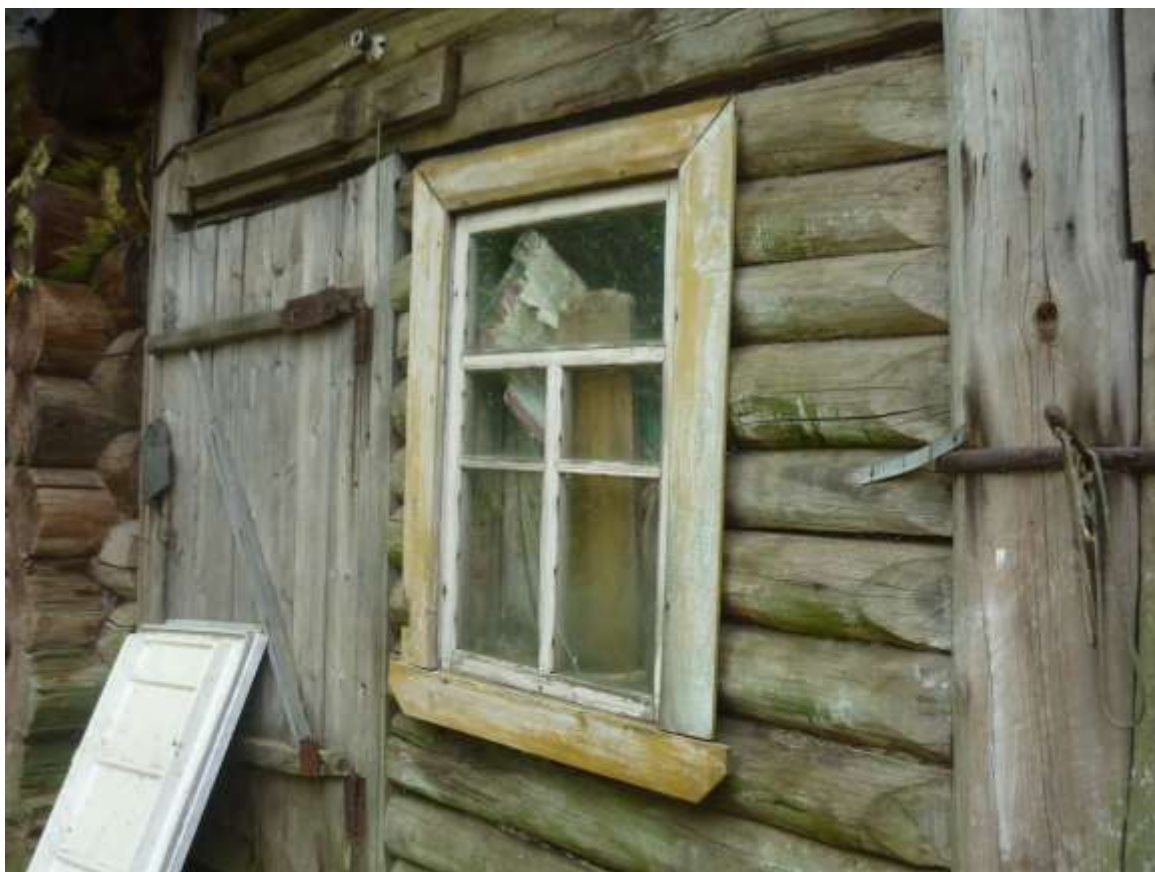
Рис. 21. Северо-восточный фасад (фрагмент) правой части дома по адресу ул. Центральная, 28. Фото Мильчика М.И. 2017 г.
