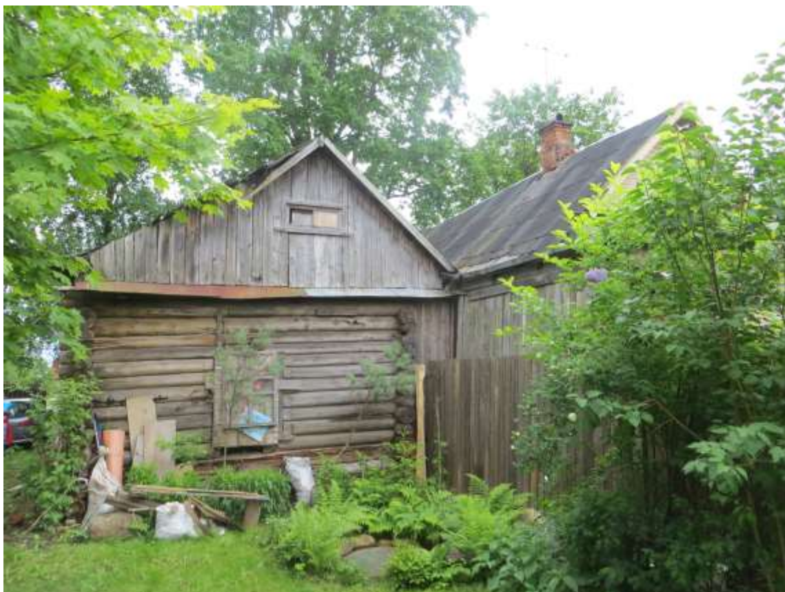
Рис. 19. Северо-западный фасад правой части дома по адресу ул. Центральная, 28. Фото Мильчика М.И. 2017 г.
