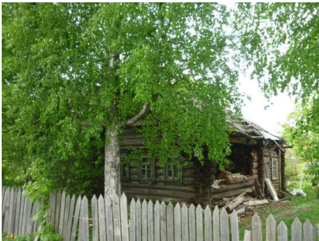
Рис. 17. Северо-восточный фасад правой части дома по адресу ул. Центральная, 28. Фото Мильчика М.И. 2017 г.
