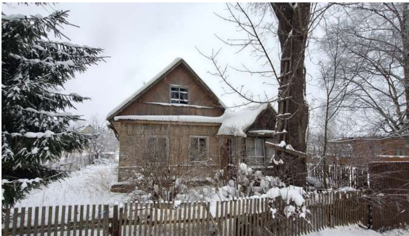
Фото 7. Общий вид на юго-восточный фасад одноэтажного здания по адресу: д. Лампово, ул. Центральная, д. 28а, примыкавшего к юго-западному фасаду Объекта культурного наследия.
