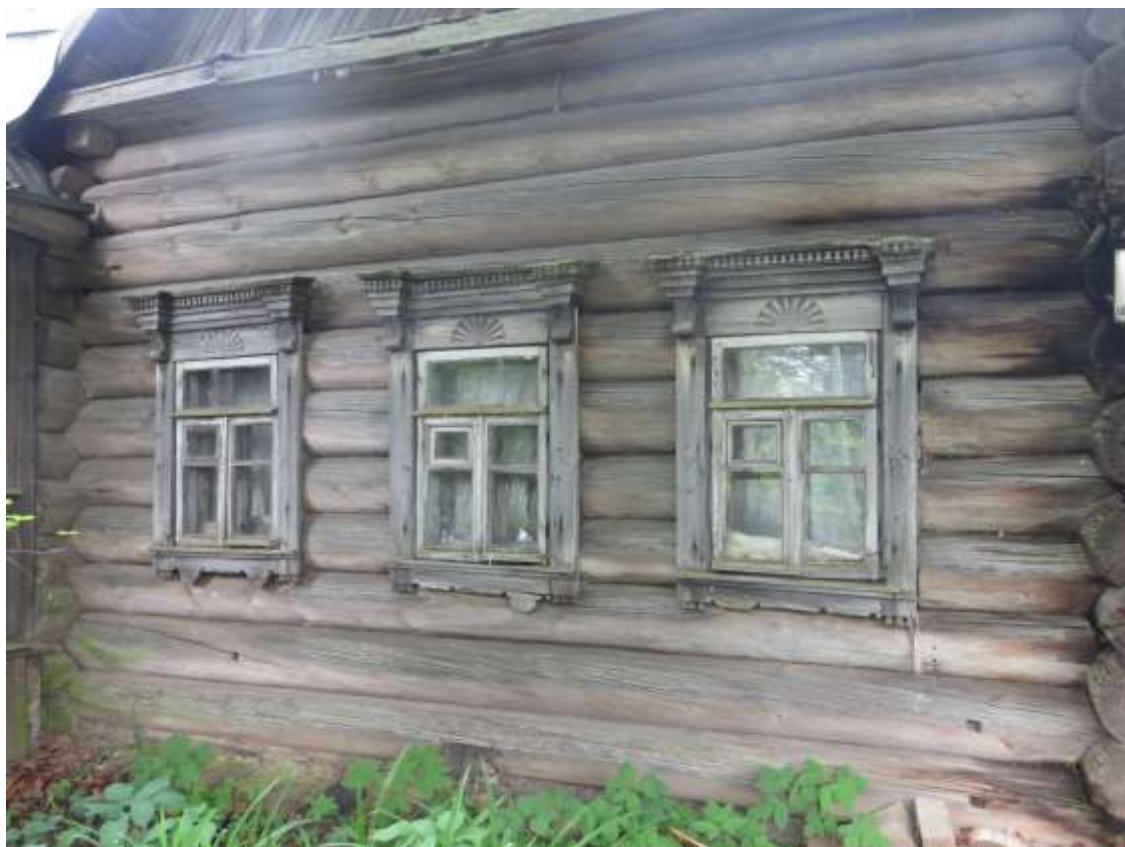
Рис. 23. Резной декор окон на лицевом фасаде в правой части дома по адресу ул. Центральная, 28. Фото Мильчика М.И. 2017 г.
