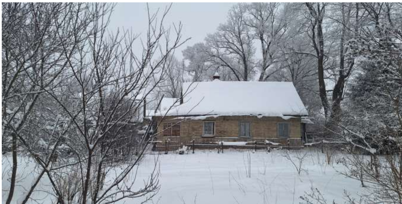
Фото 9. Общий вид на юго-западный фасад одноэтажного здания по адресу: д. Лампово, ул. Центральная, д. 28а, примыкавшего к юго-западному фасаду Объекта культурного наследия.
