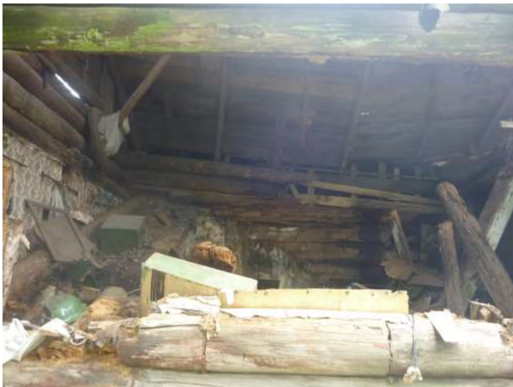
Рис. 26. Интерьер правой части дома по адресу ул. Центральная, 28. Фото Мильчика М.И. 2017 г.
