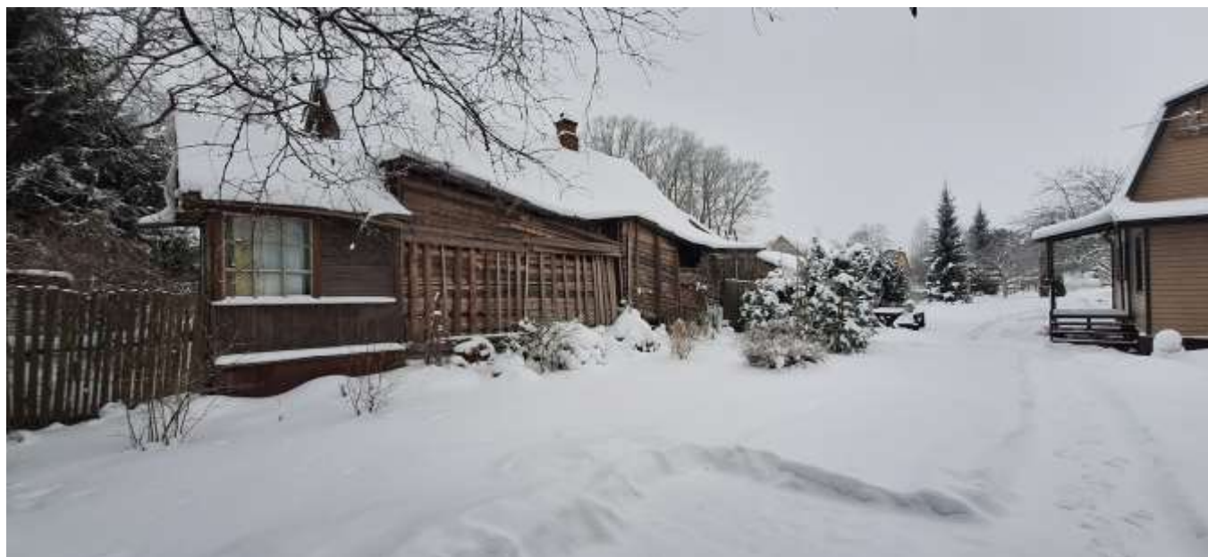
Фото 13. Общий вид на земельный участок с кадастровым номером 47:23:0912002:92 в северо-западном направлении, северо-восточный фасад одноэтажного здания по адресу: д. Лампово, ул. Центральная, д. 28а, примыкавшего к юго-западному фасаду Объекта культурного наследия и юго-западный и фрагмент юго-восточного фасадов двухэтажного здания с кадастровым номером 47:23:0912002:249, расположенного по адресу: д. Лампово, ул. Центральная, д. 28.
