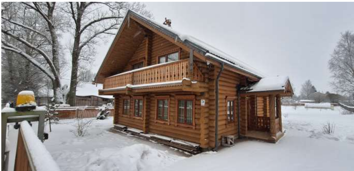
Фото 3. Общий вид на юго-восточный и северо-восточный фасады жилого дома, расположенного по адресу: д. Лампово, ул. Центральная, д. 26.
