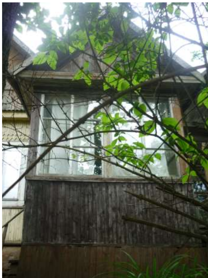
Рис. 29. Крытое крыльцо на лицевом фасаде дома по адресу ул. Центральная, 28. Фото Мильчика М.И. 2017 г.
