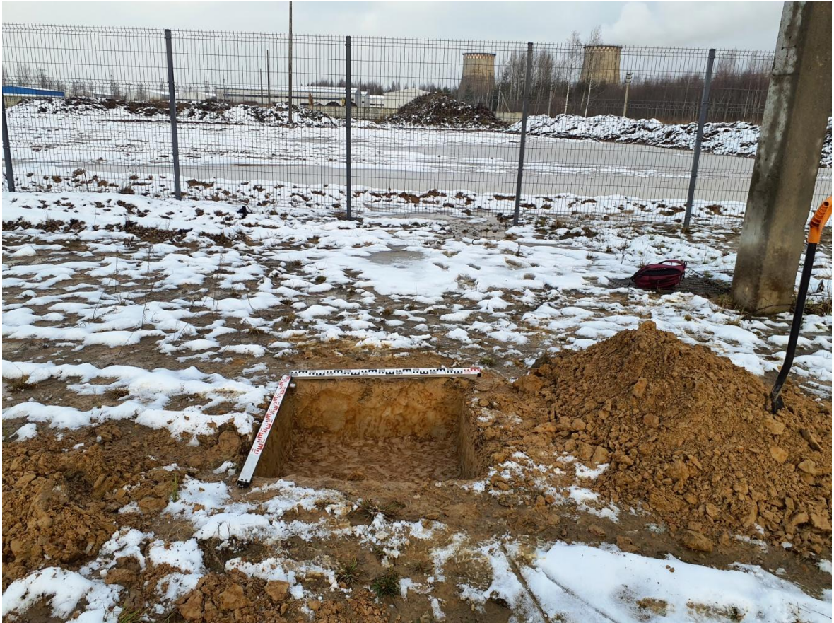
Рис. 34. Ленинградская обл., Новое Девяткино – 2025. Шурф 1 после зачистки материка. Вид с юга
