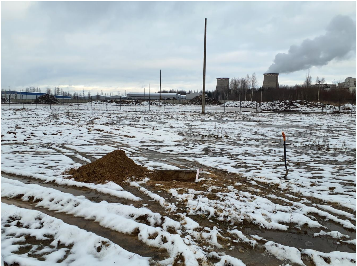
Рис. 39. Ленинградская обл., Новое Девяткино – 2025. Шурф 2 после зачистки материка. Вид с юга
