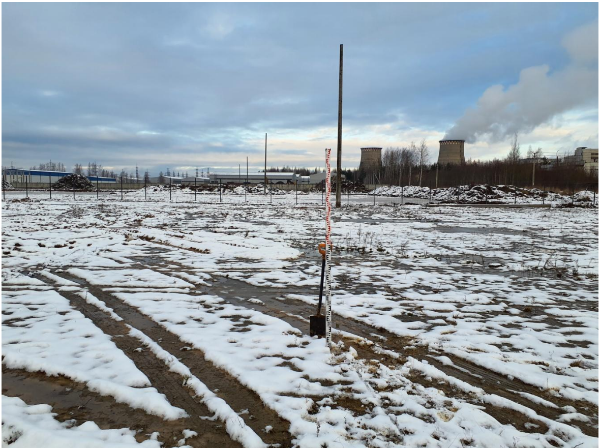
Рис. 37. Ленинградская обл., Новое Девяткино – 2025. Шурф 2. Место закладки. Вид с юга
