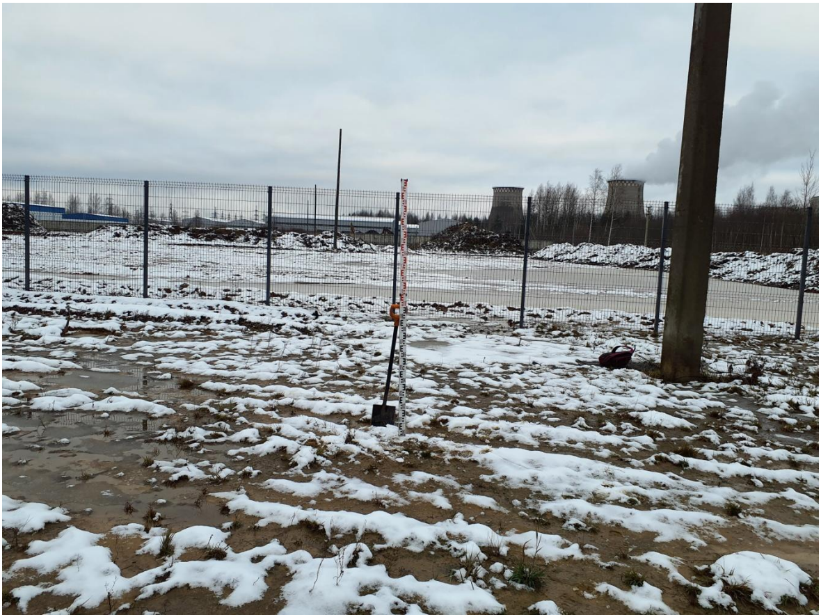
Рис. 32. Ленинградская обл., Новое Девяткино – 2025. Шурф 1. Место закладки. Вид с юга
