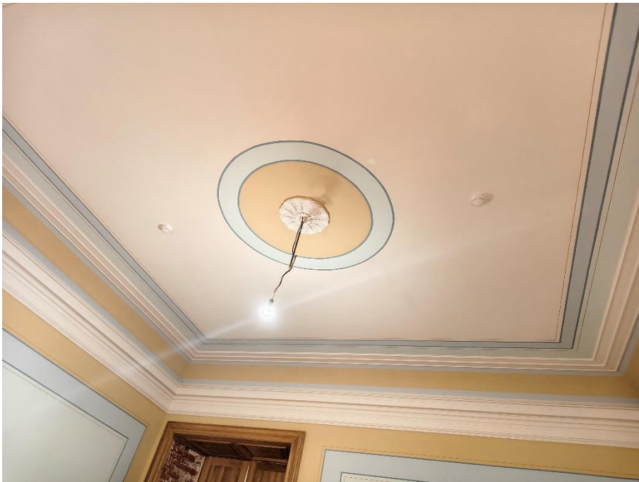
21. «Гатчинский дворец (с Арсенальным и Кухонным каре)», 1766-1781 г.г., 1793-1797 г.г. (перестроен), 1844-1851 г.г., Ленинградская область, Гатчинский муниципальный район, Гатчинское городское поселение город Гатчина, Красноармейский пр., д.1. Первый этаж. Секретарская (помещение №68 по ПИБ). Фрагмент. Фото 20.02.2026г.
