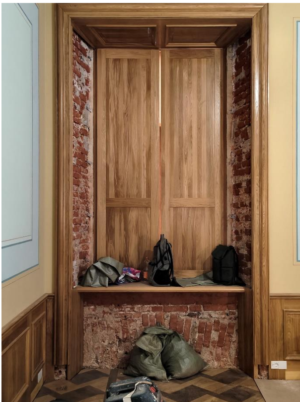
22. «Гатчинский дворец (с Арсенальным и Кухонным каре)», 1766-1781 г.г., 1793-1797 г.г. (перестроен), 1844-1851 г.г., Ленинградская область, Гатчинский муниципальный район, Гатчинское городское поселение город Гатчина, Красноармейский пр., д.1. Первый этаж. Секретарская (помещение №68 по ПИБ). Фрагмент. Фото 20.02.2026г.
