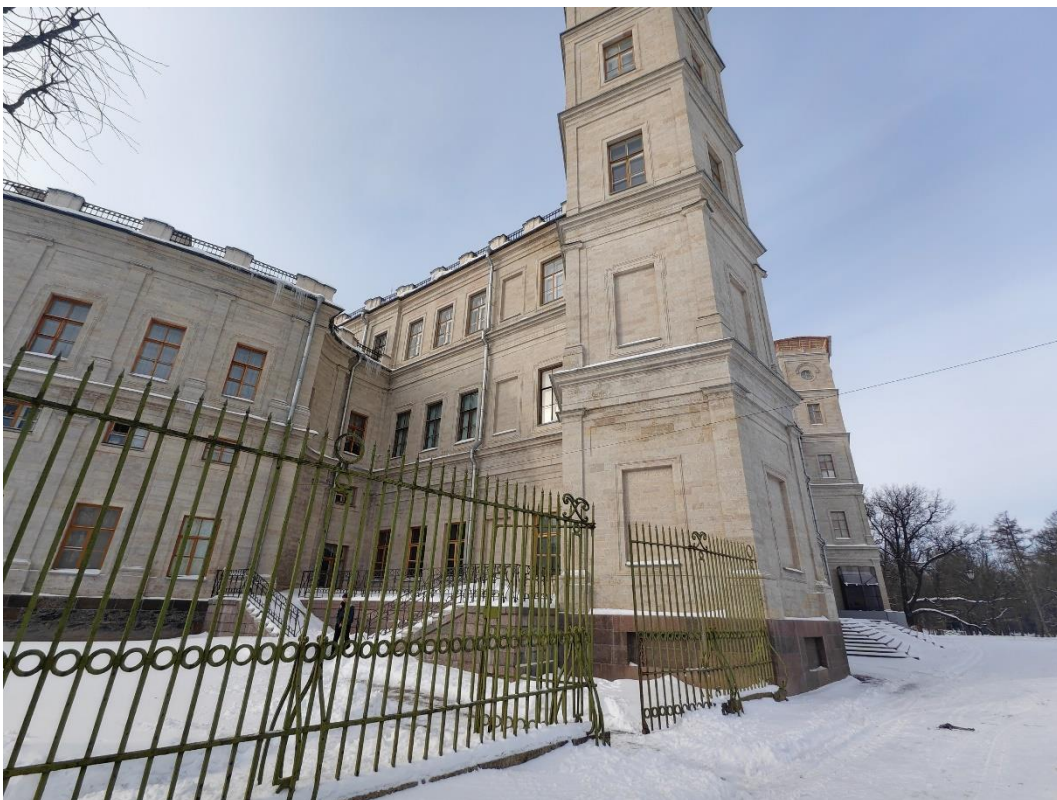
2. «Гатчинский дворец (с Арсенальным и Кухонным каре)», 1766-1781 г.г., 1793-1797 г.г. (перестроен), 1844-1851 г.г., Ленинградская область, Гатчинский муниципальный район, Гатчинское городское поселение город Гатчина, Красноармейский пр., д.1. Северный фасад. Общий вид. Фото 20.02.2026г.
