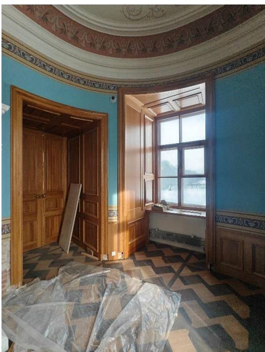
8. «Гатчинский дворец (с Арсенальным и Кухонным каре)», 1766-1781 г.г., 1793-1797 г.г. (перестроен), 1844-1851 г.г., Ленинградская область, Гатчинский муниципальный район, Гатчинское городское поселение город Гатчина, Красноармейский пр., д.1. Первый этаж. Овальный кабинет (помещение №69 по ПИБ). Общий вид. Фото 20.02.2026г.
