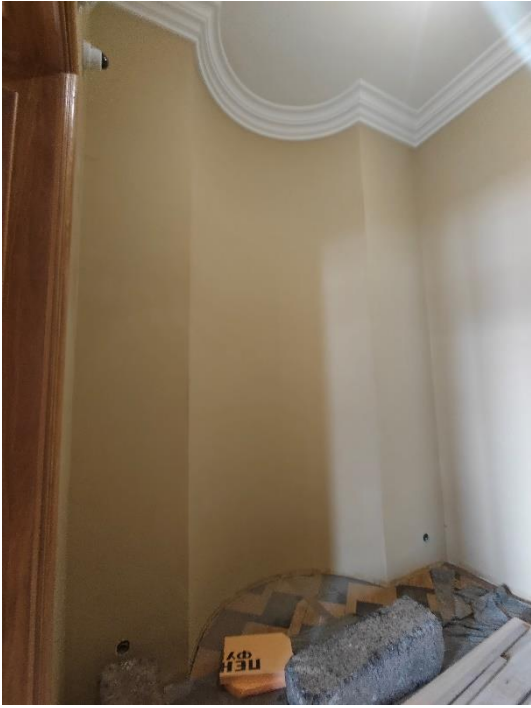
31. «Гатчинский дворец (с Арсенальным и Кухонным каре)», 1766-1781 г.г., 1793-1797 г.г. (перестроен), 1844-1851 г.г., Ленинградская область, Гатчинский муниципальный район, Гатчинское городское поселение город Гатчина, Красноармейский пр., д.1. Первый этаж. Проходная на винтовую лестницу (помещение №66 по ПИБ). Фрагмент. Фото 20.02.2026г.
