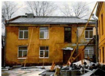
Ю-3 фасад С-В дворового флигеля
