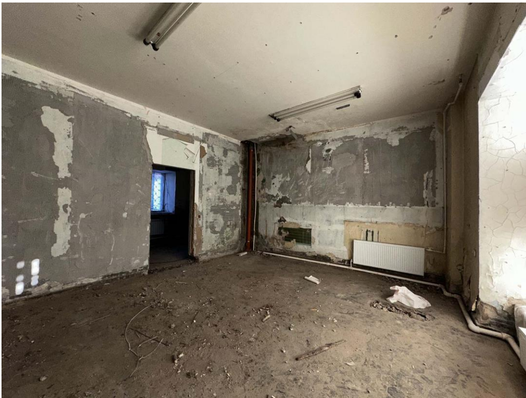
Фото 14. Пом. 1.3. Общий вид помещения с запада. Дата съемки: 16.02.2026 г. Автор съемки: Глинская Н.Б.
