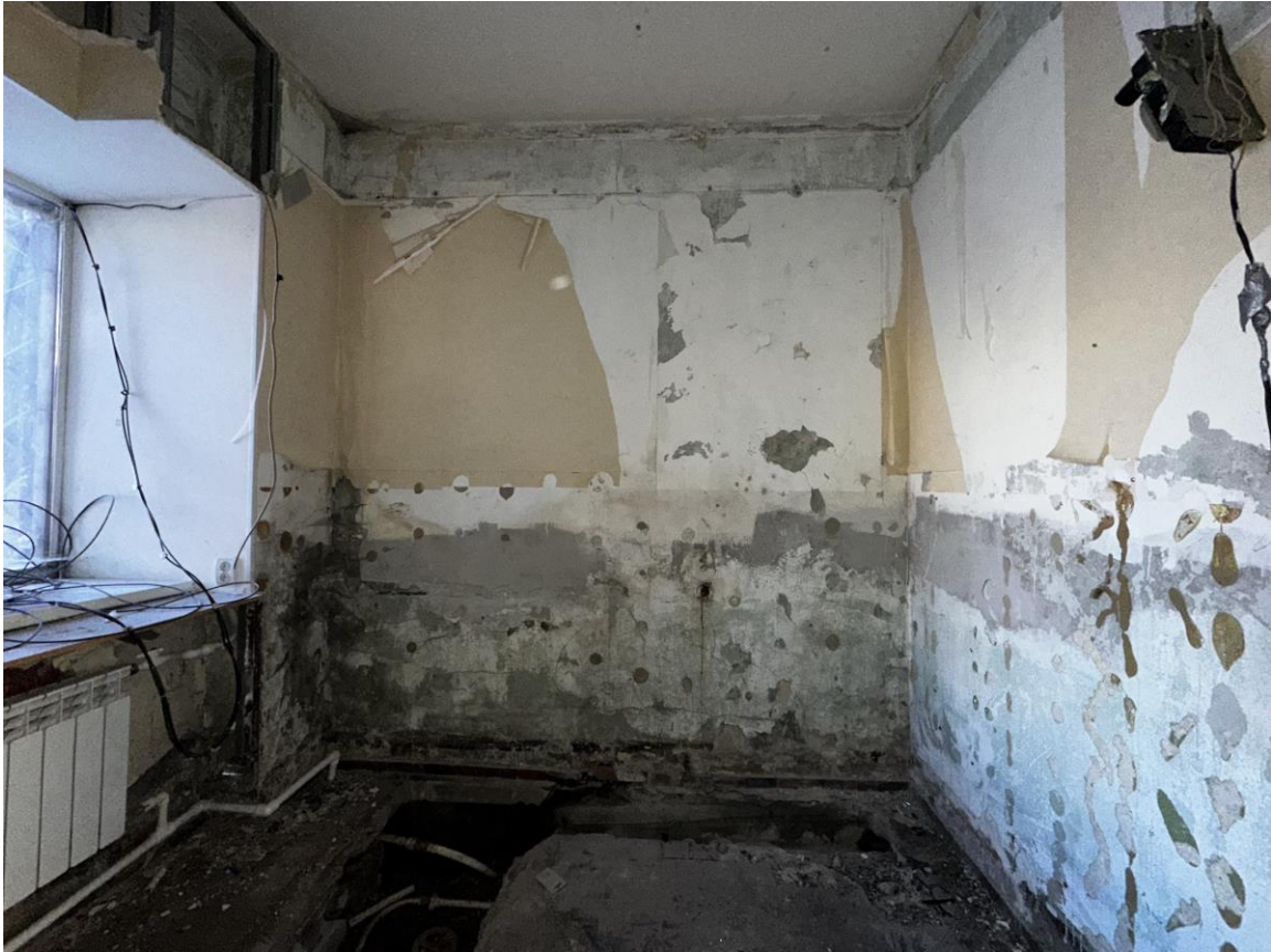
Фото 17. Пом. 1.4. Вид на юго-восточную стену помещения. Дата съемки: 16.02.2026 г. Автор съемки: Глинская Н.Б.
