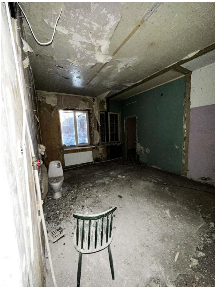
Фото 9. Пом. 1.1. Общий вид помещения с запада. Дата съемки: 16.02.2026 г. Автор съемки: Глинская Н.Б.
