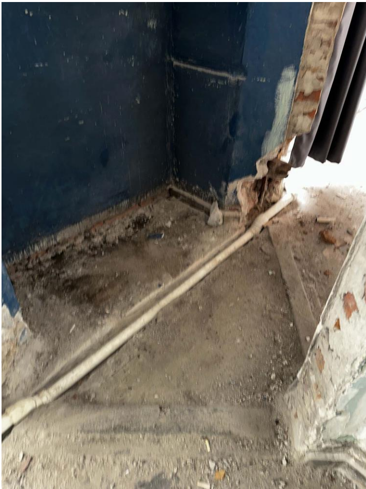
Фото 13. Пом. 1.2'. Тамбур. Дата съемки: 16.02.2026 г. Автор съемки: Глинская Н.Б.
