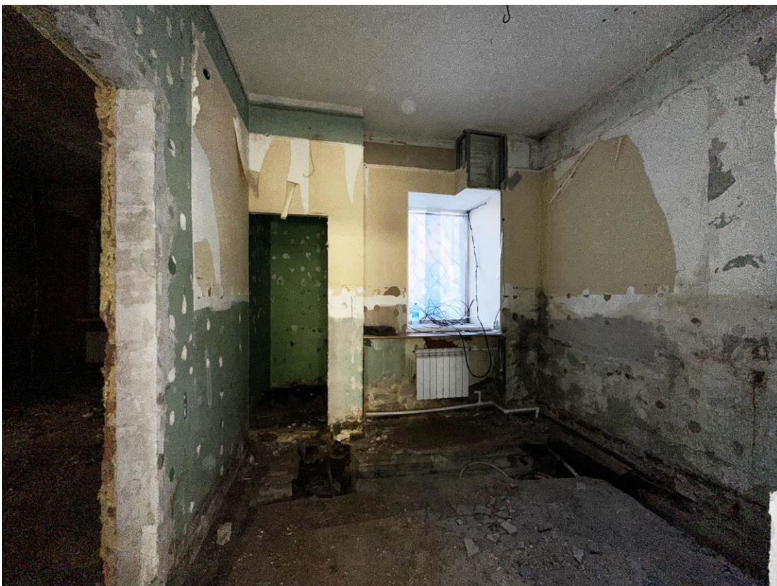
Фото 16. Пом. 1.4. Общий вид помещения с юго-запада. Дата съемки: 16.02.2026 г. Автор съемки: Глинская Н.Б.
