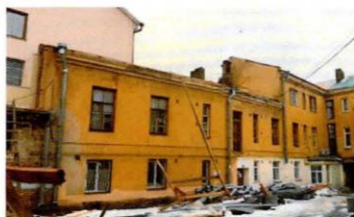
С-3 фасад дворового Ю-В крыла
