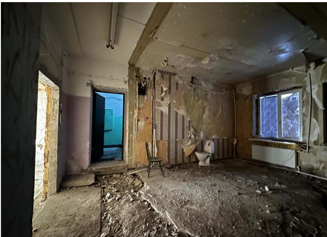
Фото 8. Пом. 1.1. Общий вид помещения с юго-востока. Дата съемки: 16.02.2026 г. Автор съемки: Глинская Н.Б.
