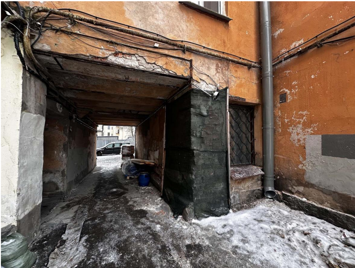
Фото 6. Общий вид сквозного арочного проема и фрагмент северо-восточного дворового фасада, соответствующего помещению. Дата съемки: 16.02.2026 г. Автор съемки: Глинская Н.Б.
