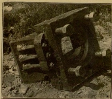
Амбразура НПС-3 изготовленная по чертежам УНИ.
