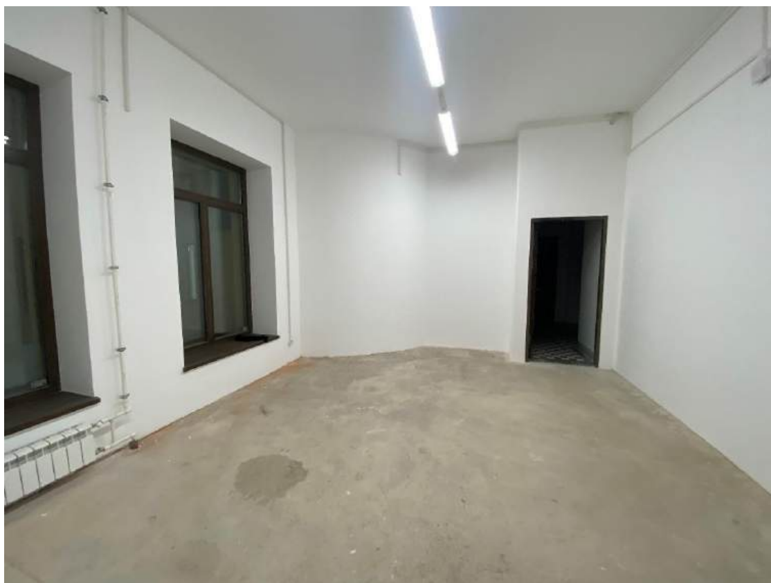
Фото 31. Помещение 1-го этажа.
