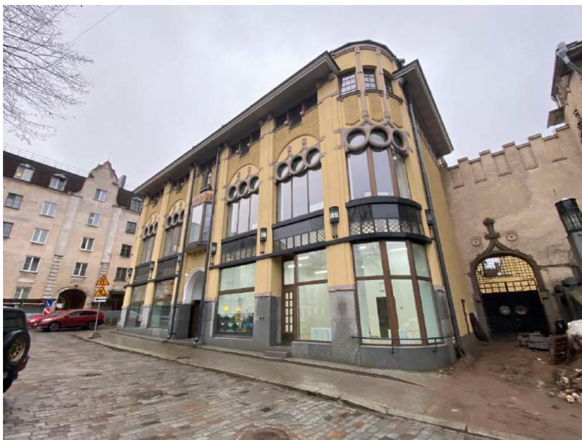
Фото 6. Вид на угол юго-восточного и северо-восточного фасадов исследуемого объекта с Пионерской улицы.
