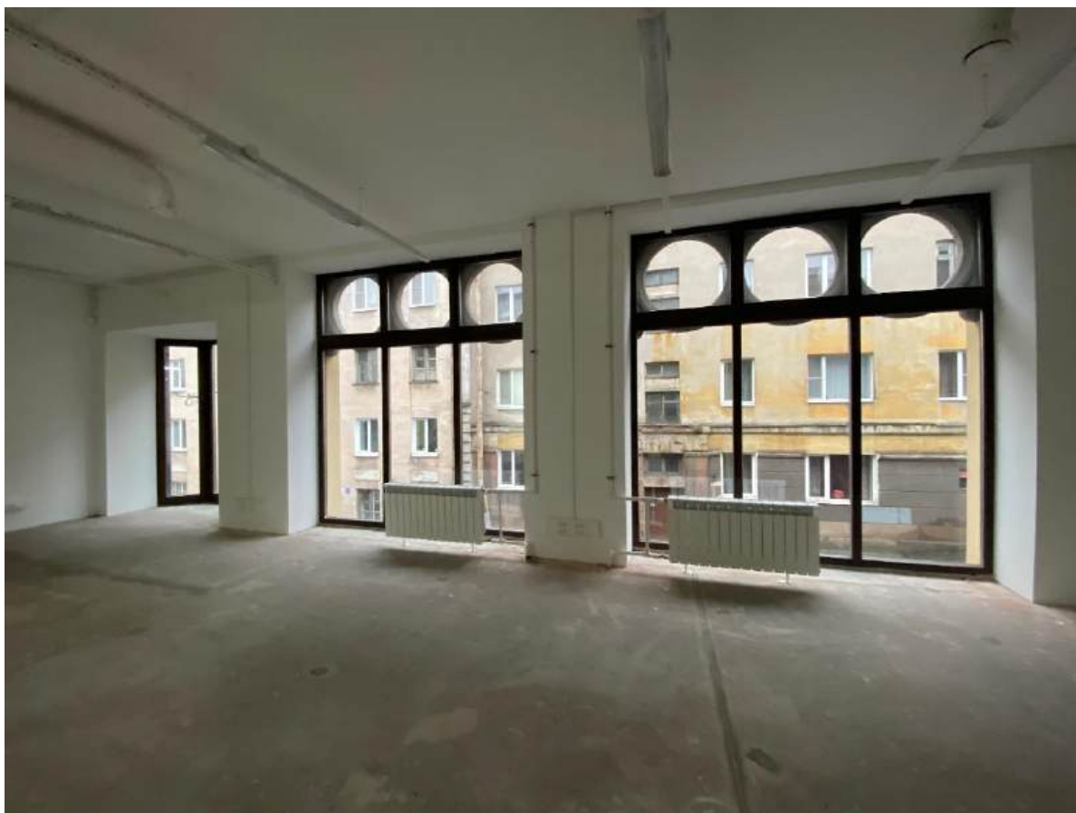
Фото 39. Помещение 2-го этажа.
