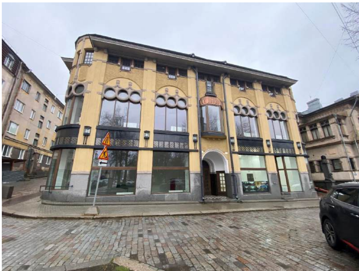
Фото 7. Вид на юго-восточный фасад исследуемого объекта.
