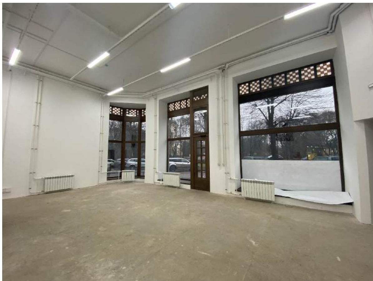
Фото 36. Помещение 1-го этажа.
