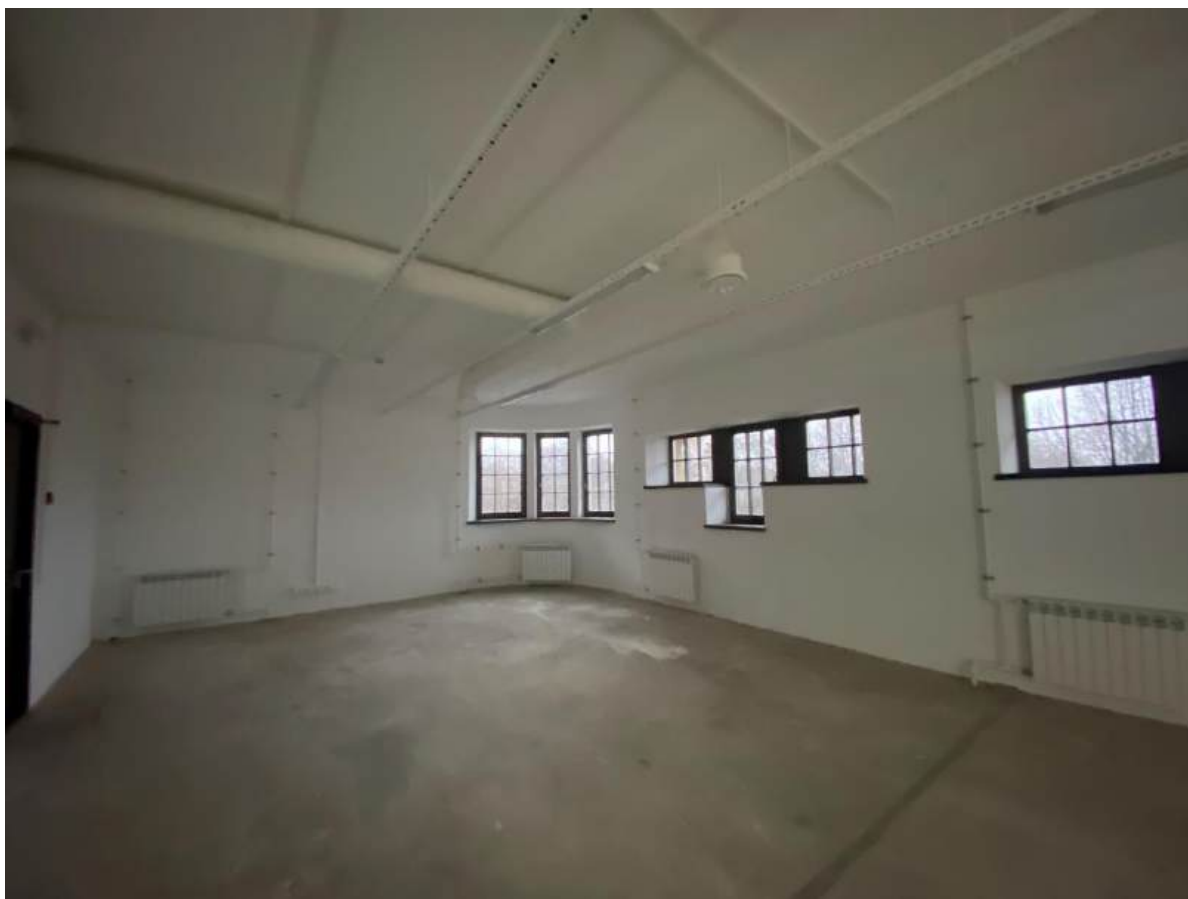
Фото 45. Помещение 3-го этажа.
