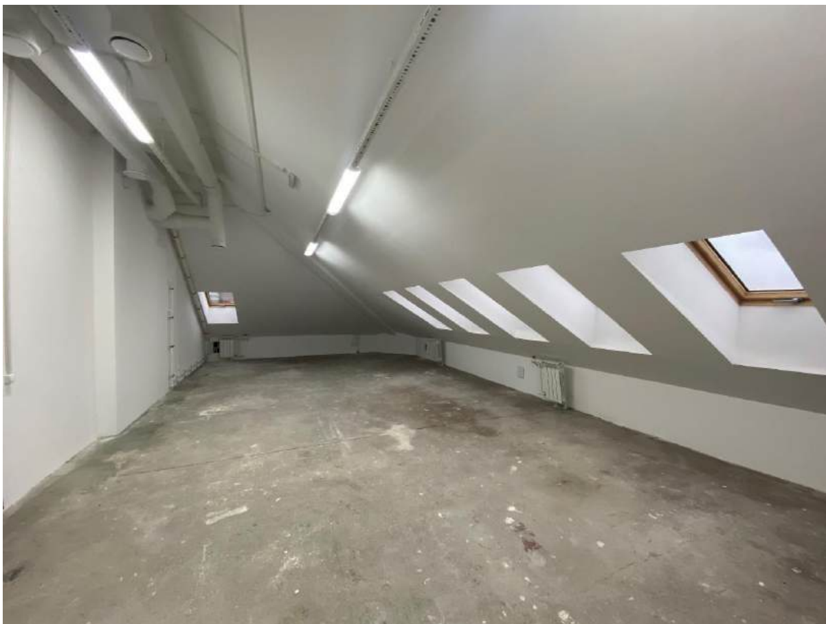
Фото 51. Помещение мансардного этажа.
