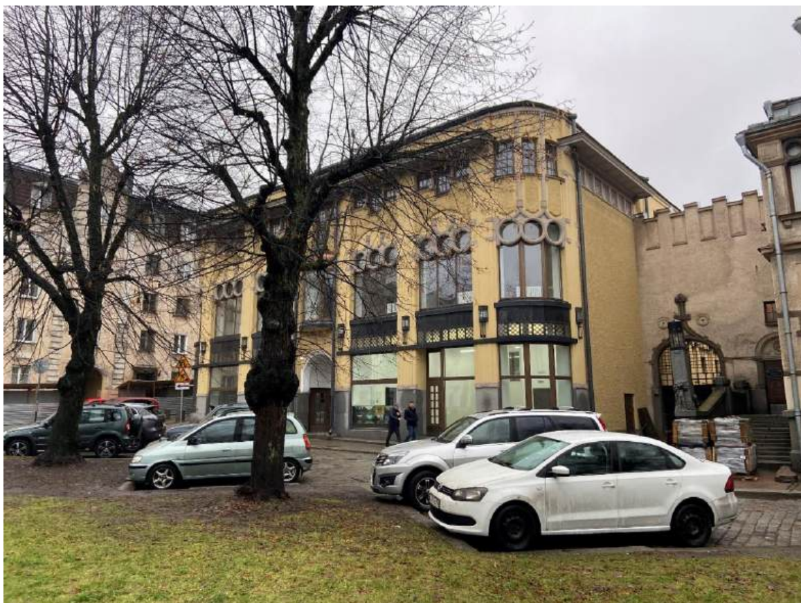
Фото 5. Вид на угол юго-восточного и северо-восточного фасадов исследуемого объекта.
