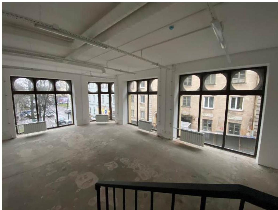
Фото 40. Помещение 2-го этажа.
