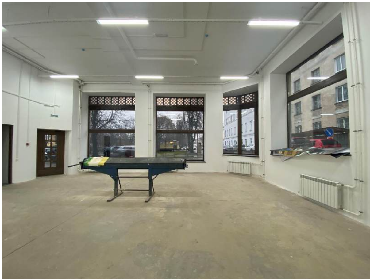
Фото 33. Помещение 1-го этажа.
