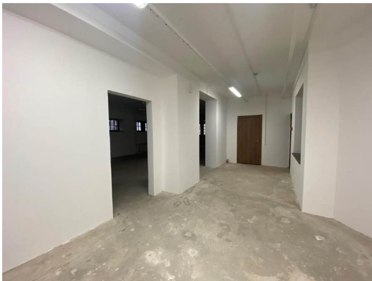
Фото 44. Помещение 3-го этажа.
