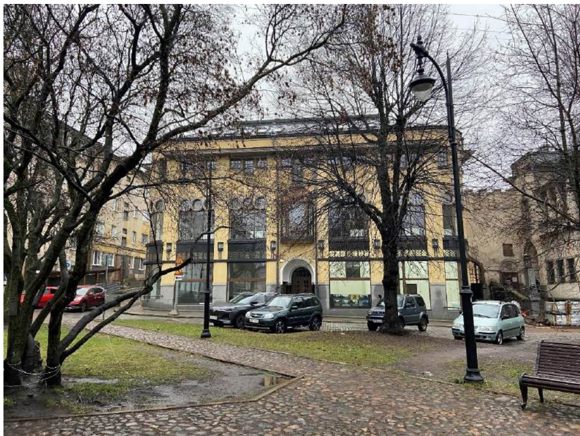
Фото 4. Вид на юго-восточный фасад исследуемого объекта.
