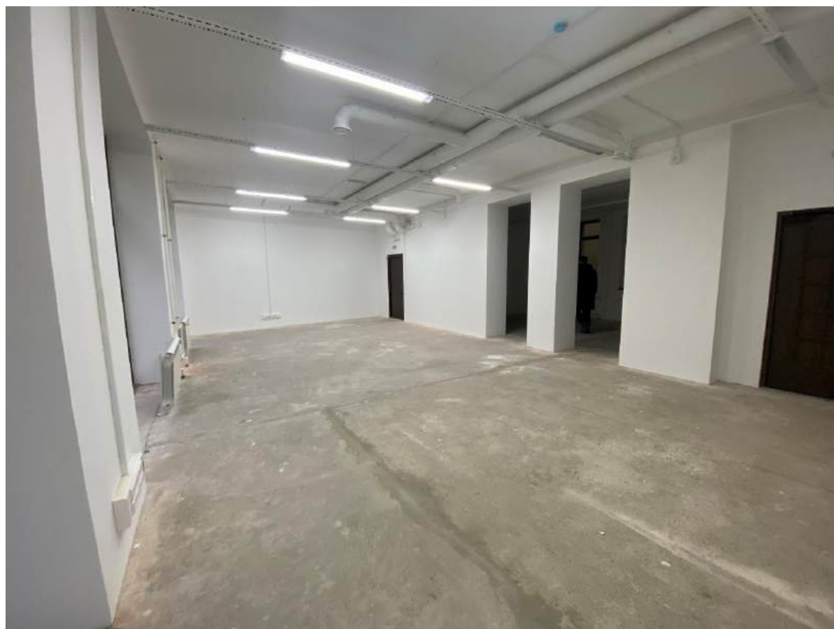
Фото 38. Помещение 2-го этажа.
