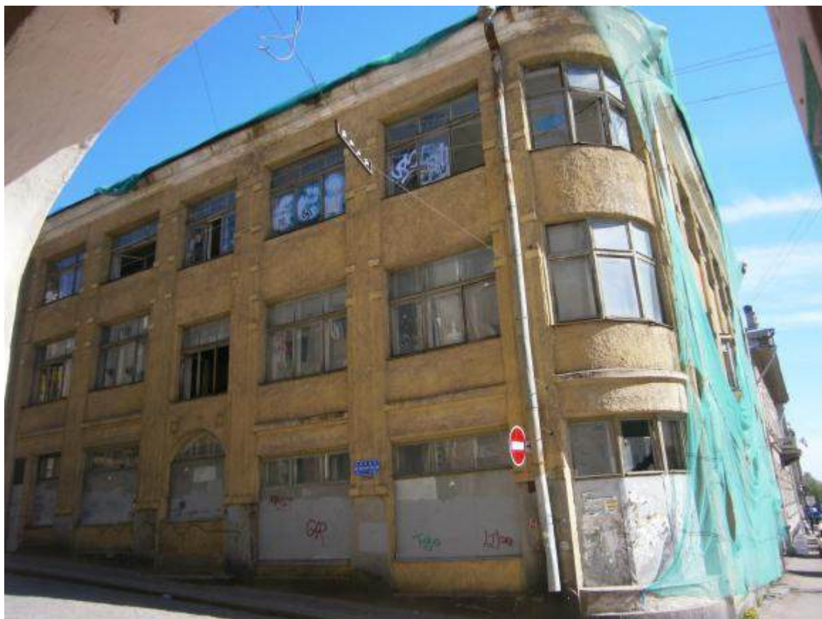
Илл. 46. Вид на фасад по Крепостной улице. Дата: 2013 г. Источник: citywalls.ru.
