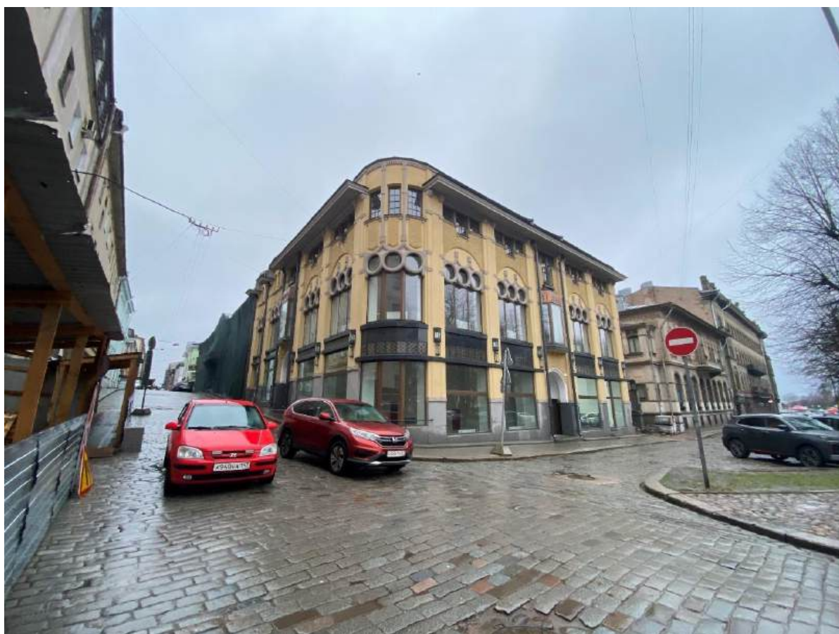
Фото 8. Вид на угол юго-восточного и юго-западного фасадов исследуемого объекта.
