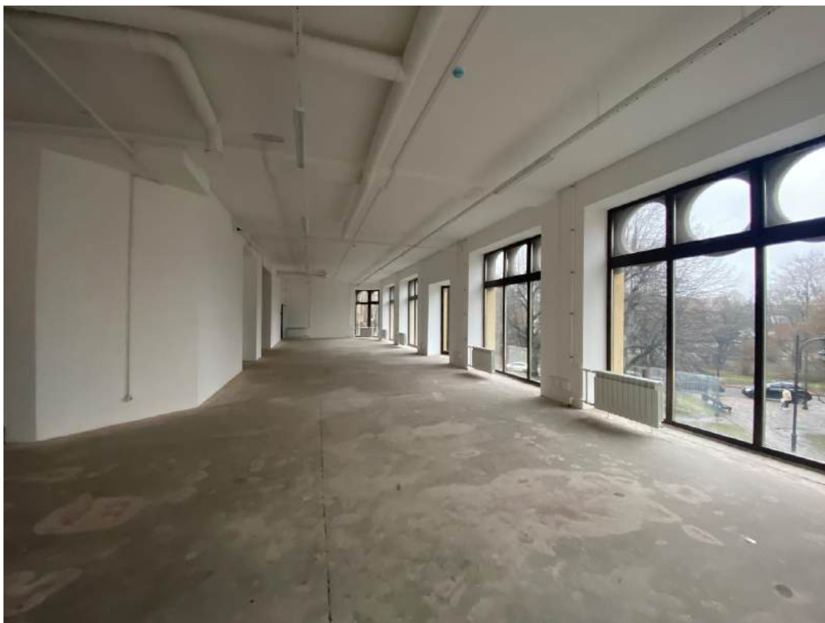
Фото 41. Помещение 2-го этажа.
