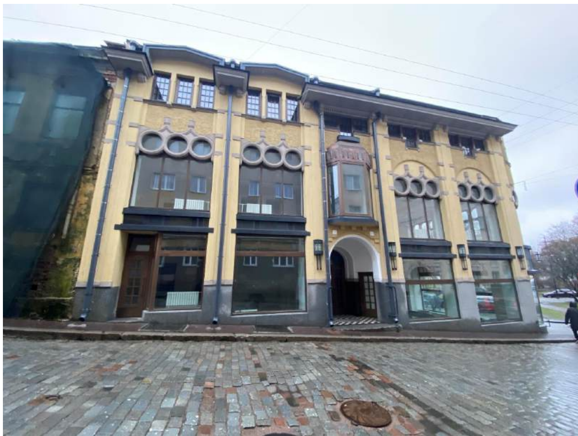
Фото 9. Вид на юго-западный фасад исследуемого объекта.
