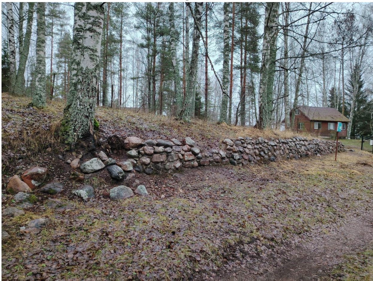
Фото 4. Вид на подпорную стенку к востоку от выявленного объекта культурного наследия «Кирха».
