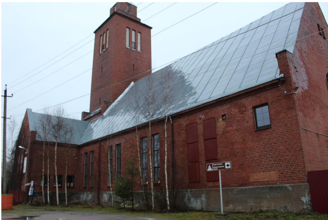
Фото 19. Вид на юго-восточный фасад выявленного объекта культурного наследия «Кирха».
