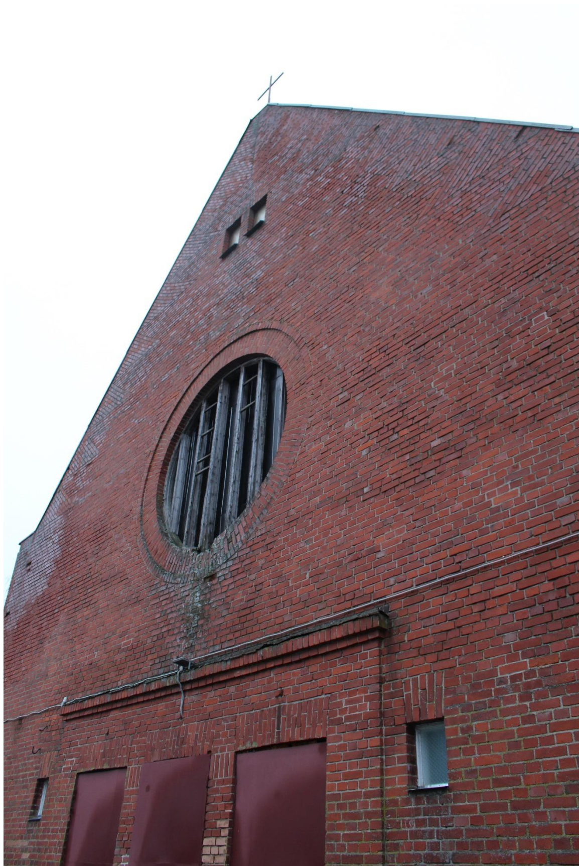
Фото 18. Вид на северо-восточный фасад выявленного объекта культурного наследия «Кирха».
