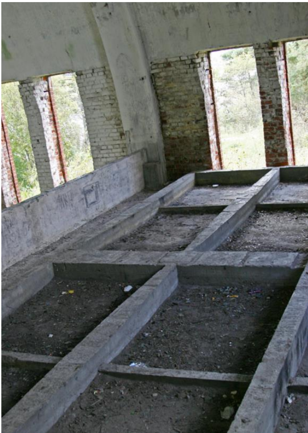
Илл. 55. Кирха Каукола. 2005 г. (источник: https://terijoki.spb.ru/trk_terra.php?item=26&p=8 ).
