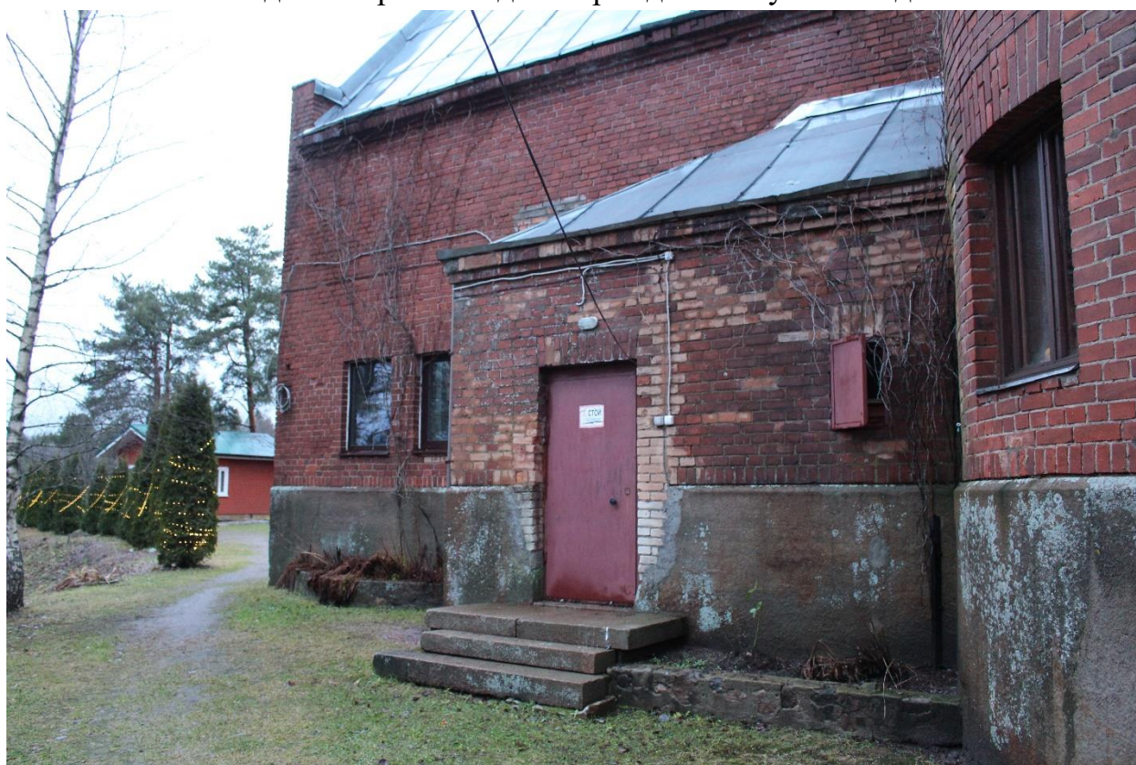
Фото 11. Вид на юго-западный фасад выявленного объекта культурного наследия «Кирха».
