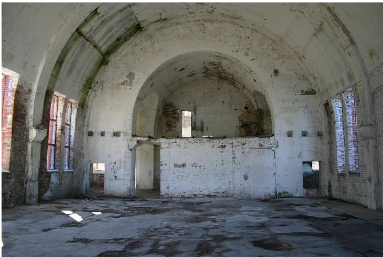
Илл. 58. Кирха Каукола. 16.04.2005 г. (источник: https://commons.wikimedia.org/wiki/Category:Kaukola_church ).
