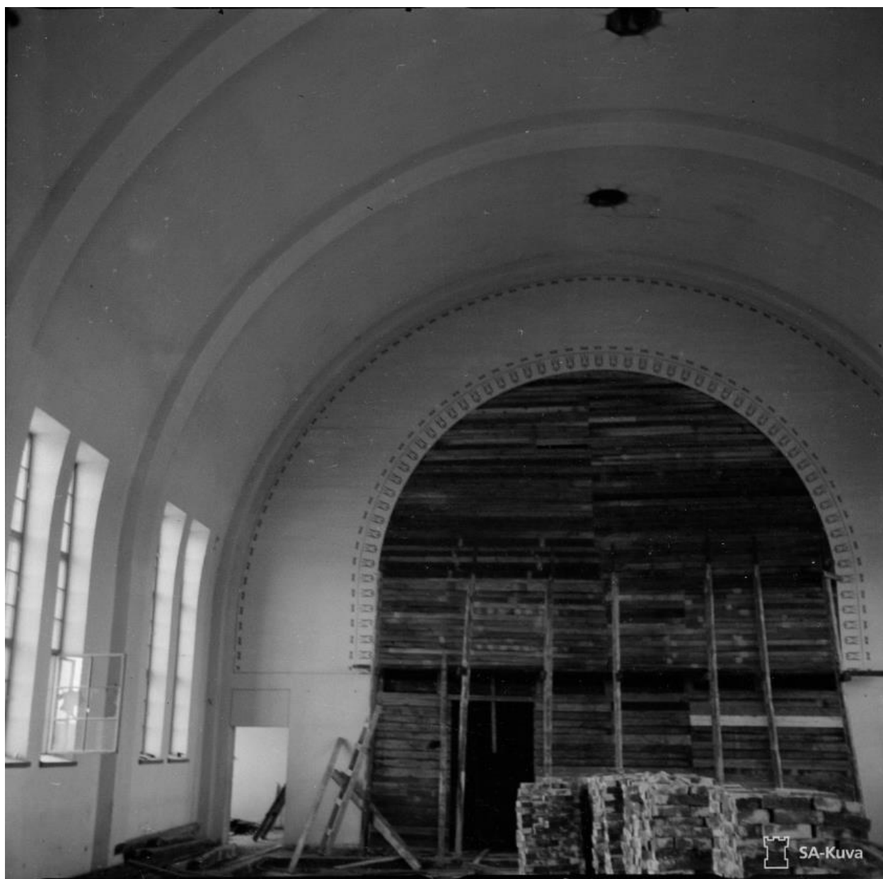
Илл. 40. Кирха Каукола. Церковный зал. 17.08.1941 г. (источник: https://www.finna.fi/Record/sa-kuva.sa-kuva-67350?sid=5292085782&imgid=1 ).
