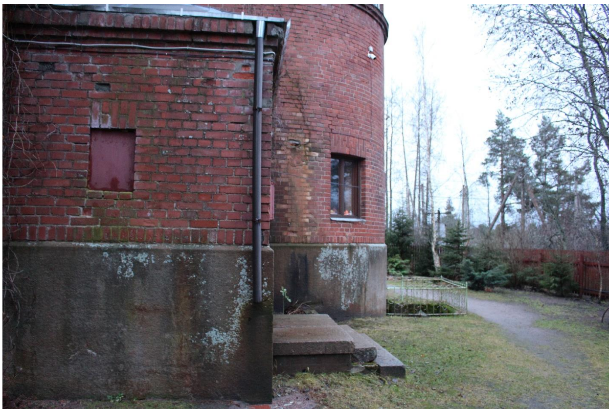
Фото 13. Вид на юго-западный фасад выявленного объекта культурного наследия «Кирха» с северо-запада.
