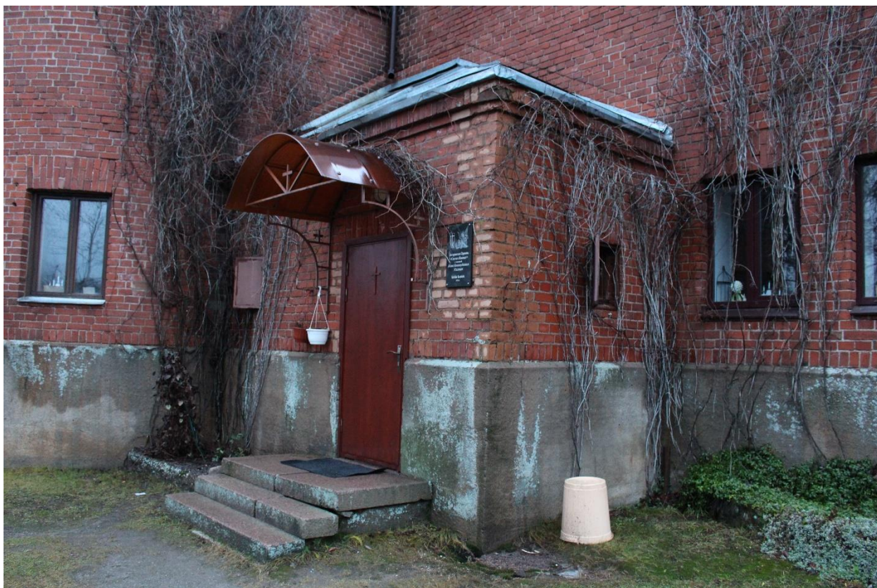
Фото 7. Вид на юго-западный фасад выявленного объекта культурного наследия «Кирха».
