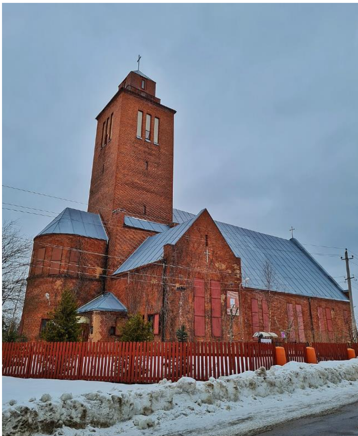
Илл. 66. Кирха Каукола. 20.03.2021 г. (источник: https://commons.wikimedia.org/wiki/Category:Kaukola_church ).
