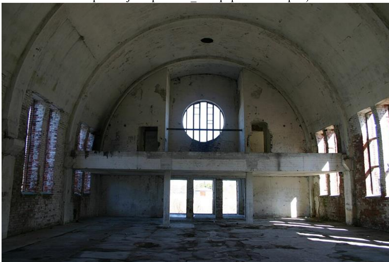
Илл. 57. Кирха Каукола. 16.04.2005 г. (источник: https://commons.wikimedia.org/wiki/Category:Kaukola_church ).
