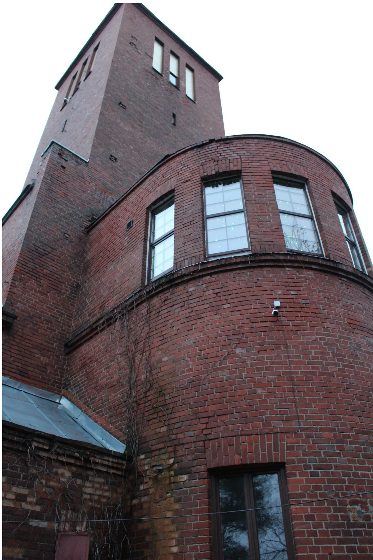
Фото 12. Вид на юго-западный фасад выявленного объекта культурного наследия «Кирха».
