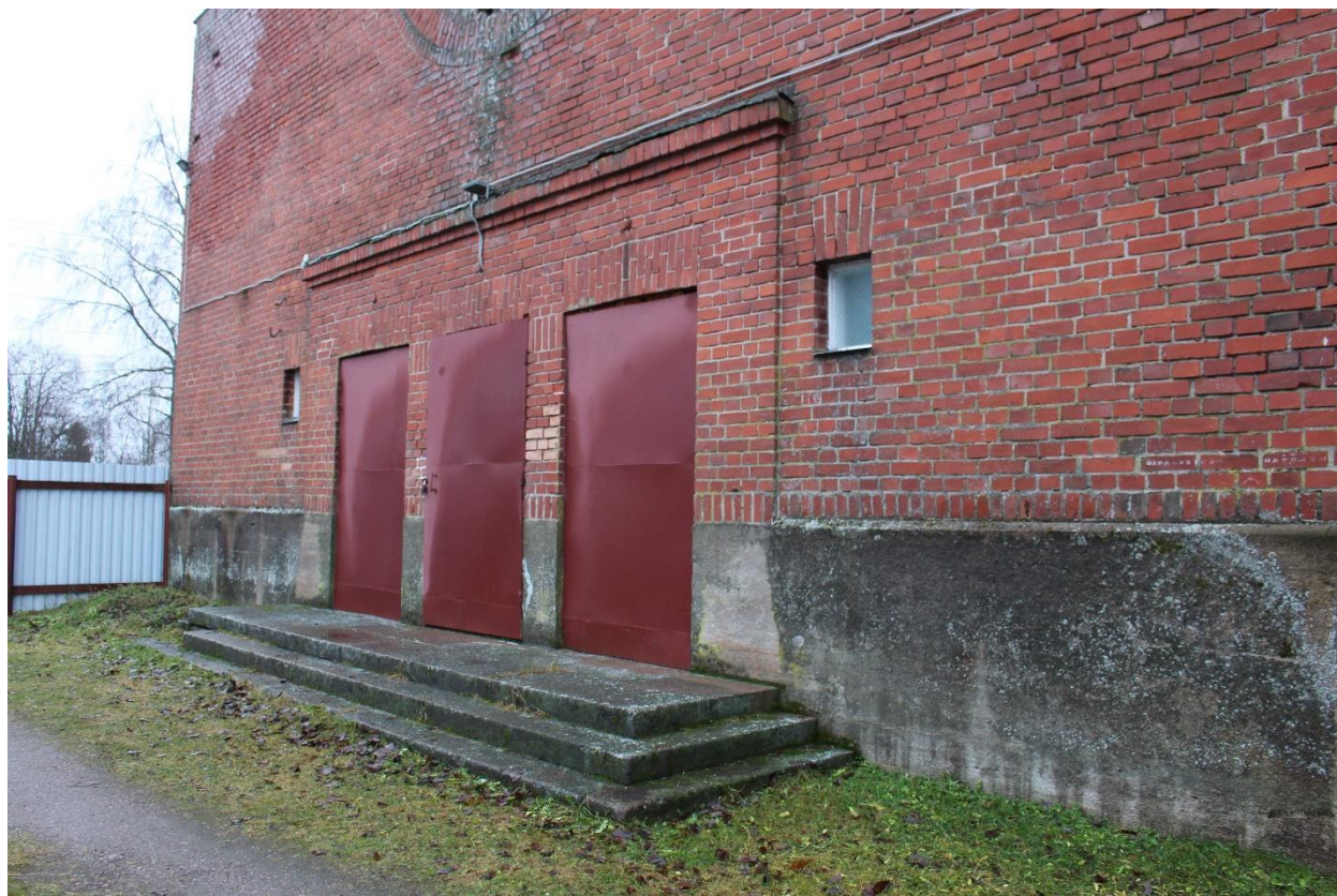
Фото 17. Вид на северо-восточный фасад выявленного объекта культурного наследия «Кирха».
