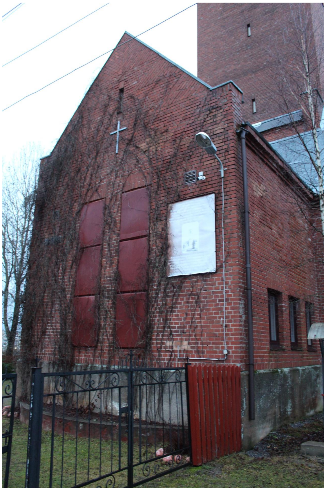
Фото 4. Вид на юго-восточный фасад выявленного объекта культурного наследия «Кирха».
