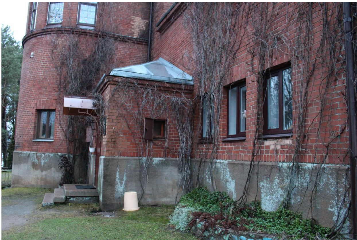
Фото 5. Вид на юго-западный фасад выявленного объекта культурного наследия «Кирха».
