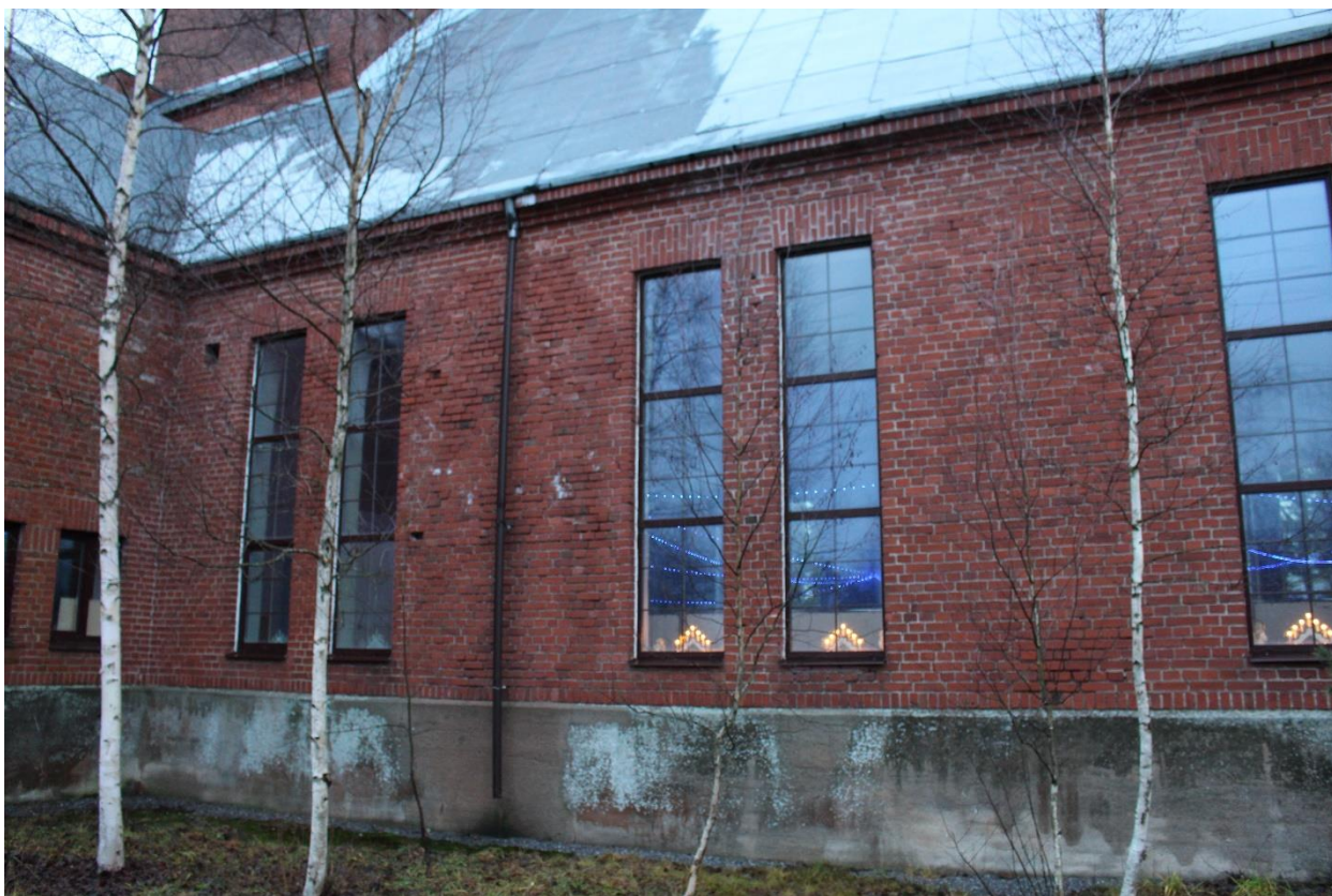
Фото 3. Вид на юго-восточный фасад выявленного объекта культурного наследия «Кирха».
