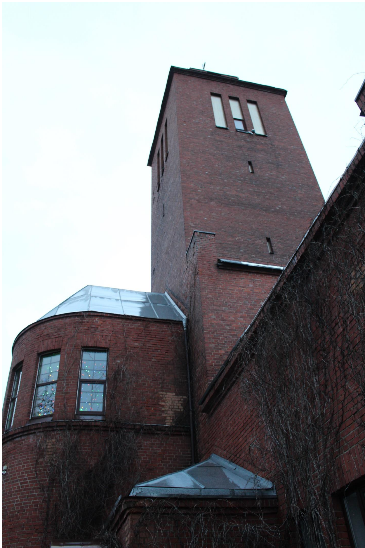
Фото 6. Вид на юго-западный фасад выявленного объекта культурного наследия «Кирха».
