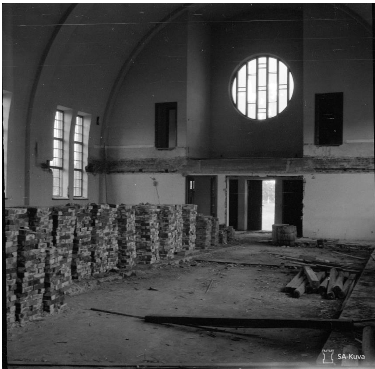
Илл. 38. Кирха Каукола. Церковный зал. 16.08.1941 г. (источник: https://www.finna.fi/Record/sa-kuva.sa-kuva-72208?sid=5292085782&imgid=1 ).
