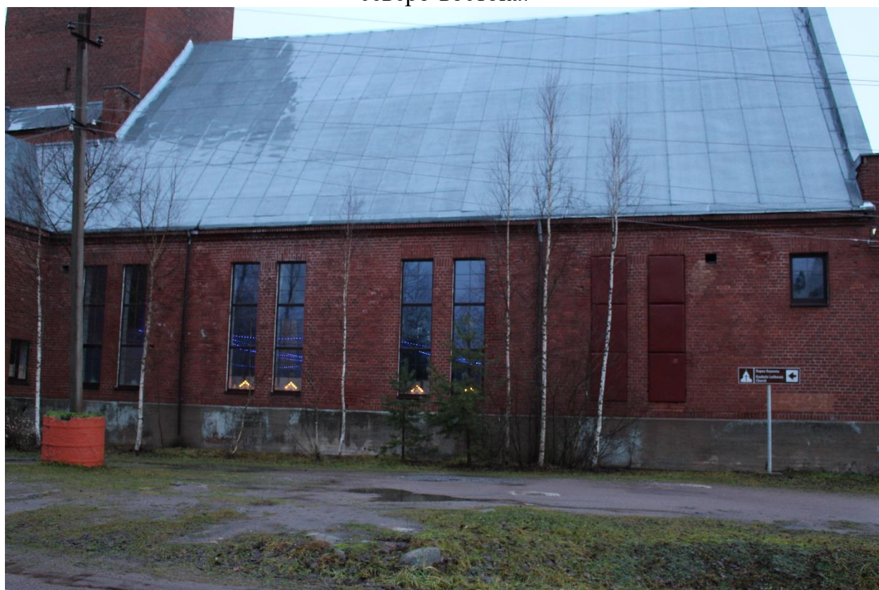
Фото 2. Вид на юго-восточный фасад выявленного объекта культурного наследия «Кирха».
