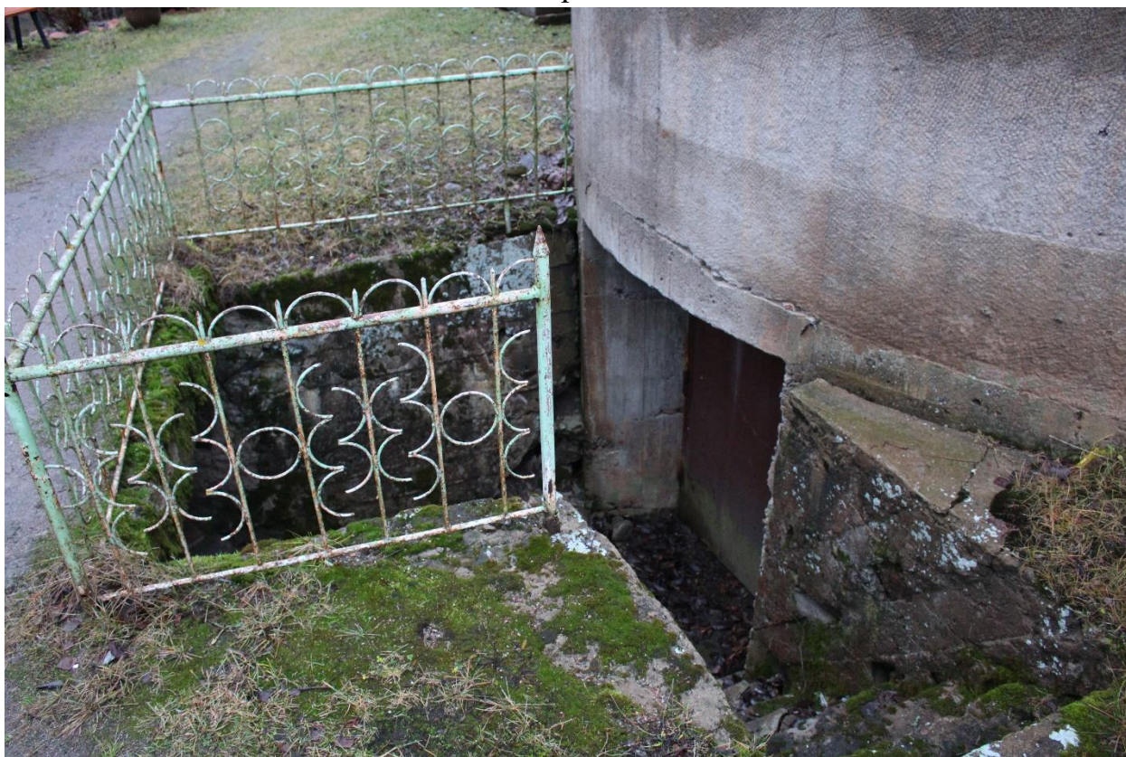
Фото 8. Вид на юго-западный фасад выявленного объекта культурного наследия «Кирха». Спуск в подвал.
