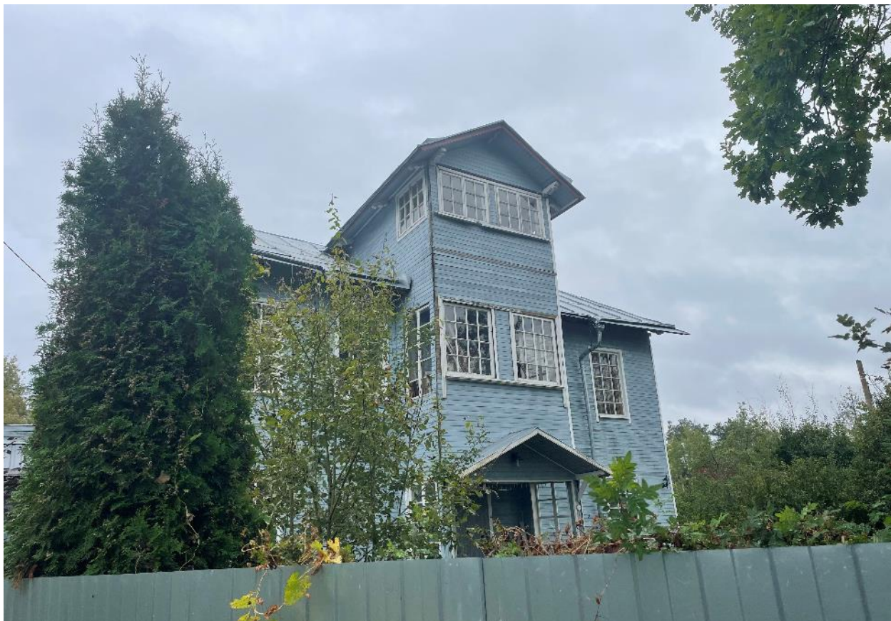
Фото 18. Общий вид с северо-запада.
