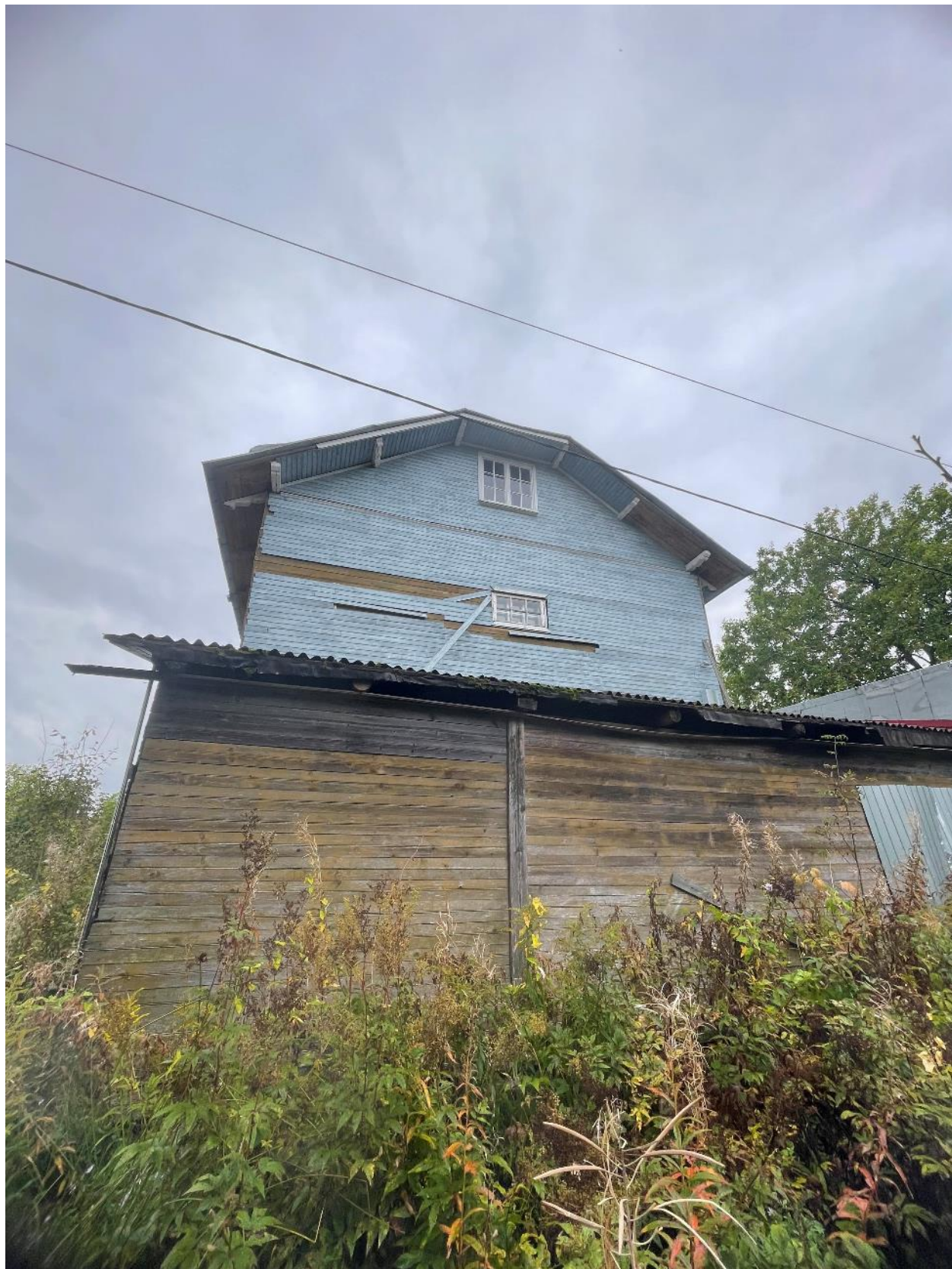
Фото 20. Северный фасад, с пристройкой.
