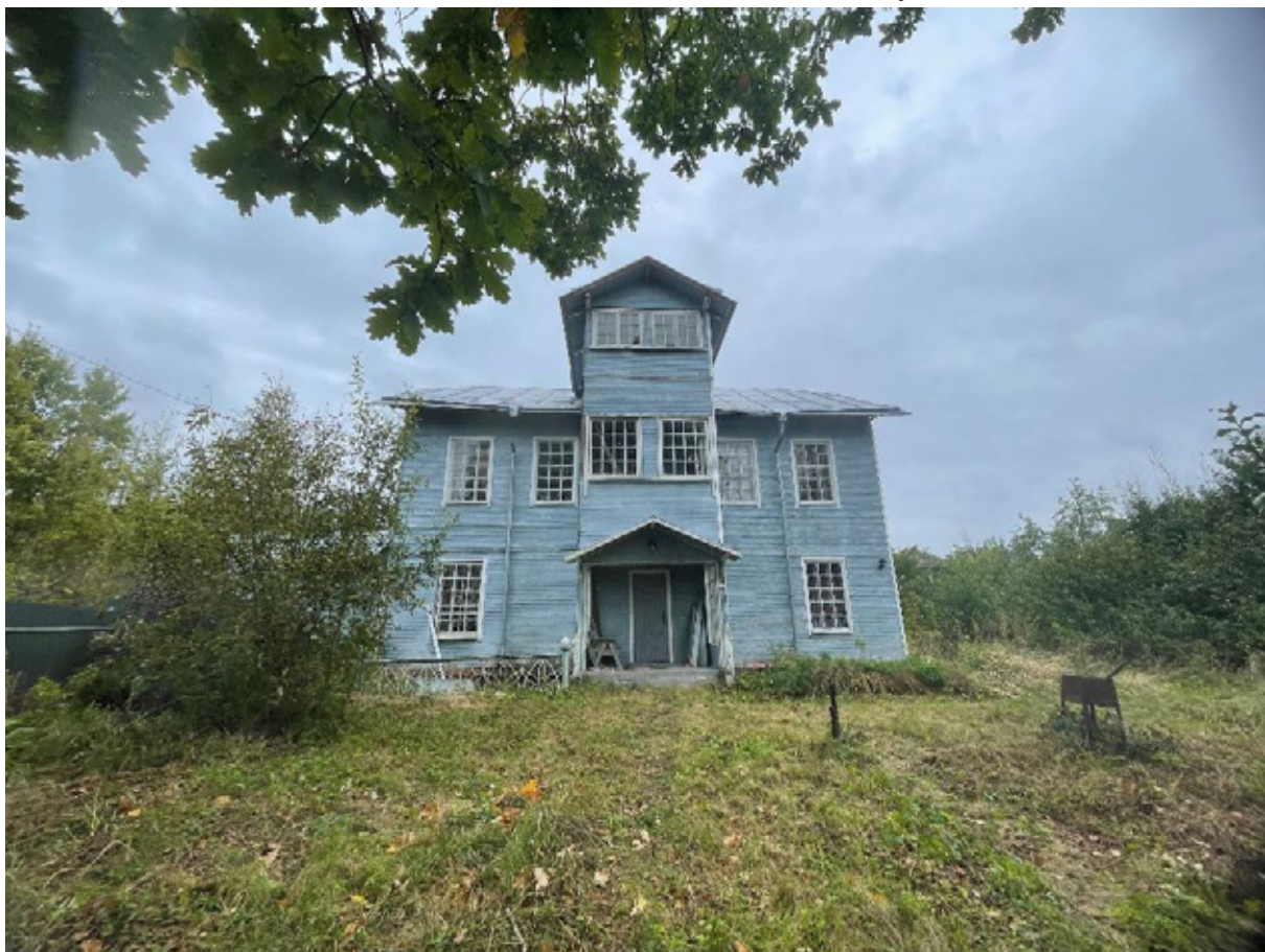
Фото 15. Общий вид с запада.
