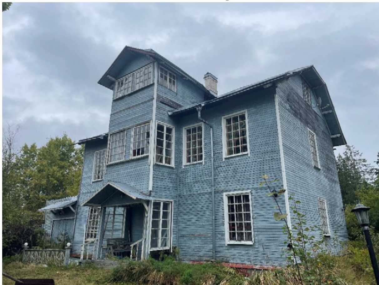
Фото 17. Общий вид с юго-запада.
