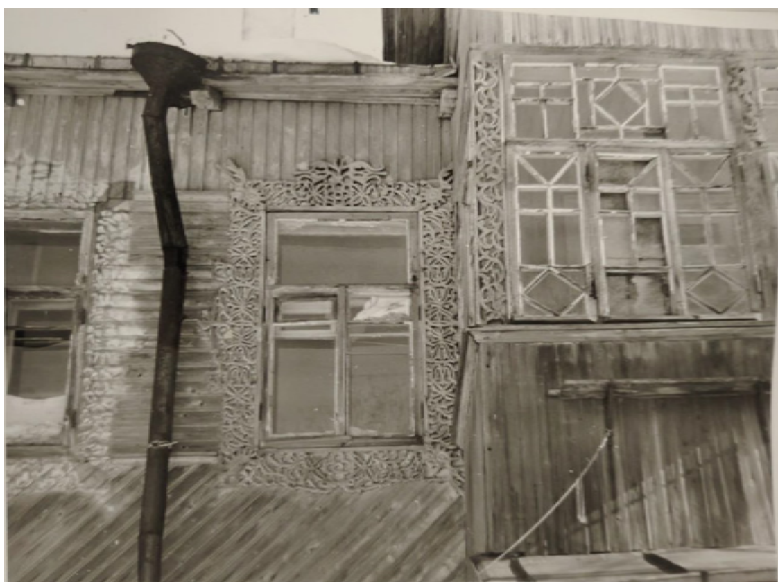
Илл. 37. Большая Ижора, Ломоносовский район, ул. Лесная, 8. Архив Комитета по сохранению культурного наследия Ленинградской области. Январь 1986 г. Ф. 1684-1. Инв. 1691.
