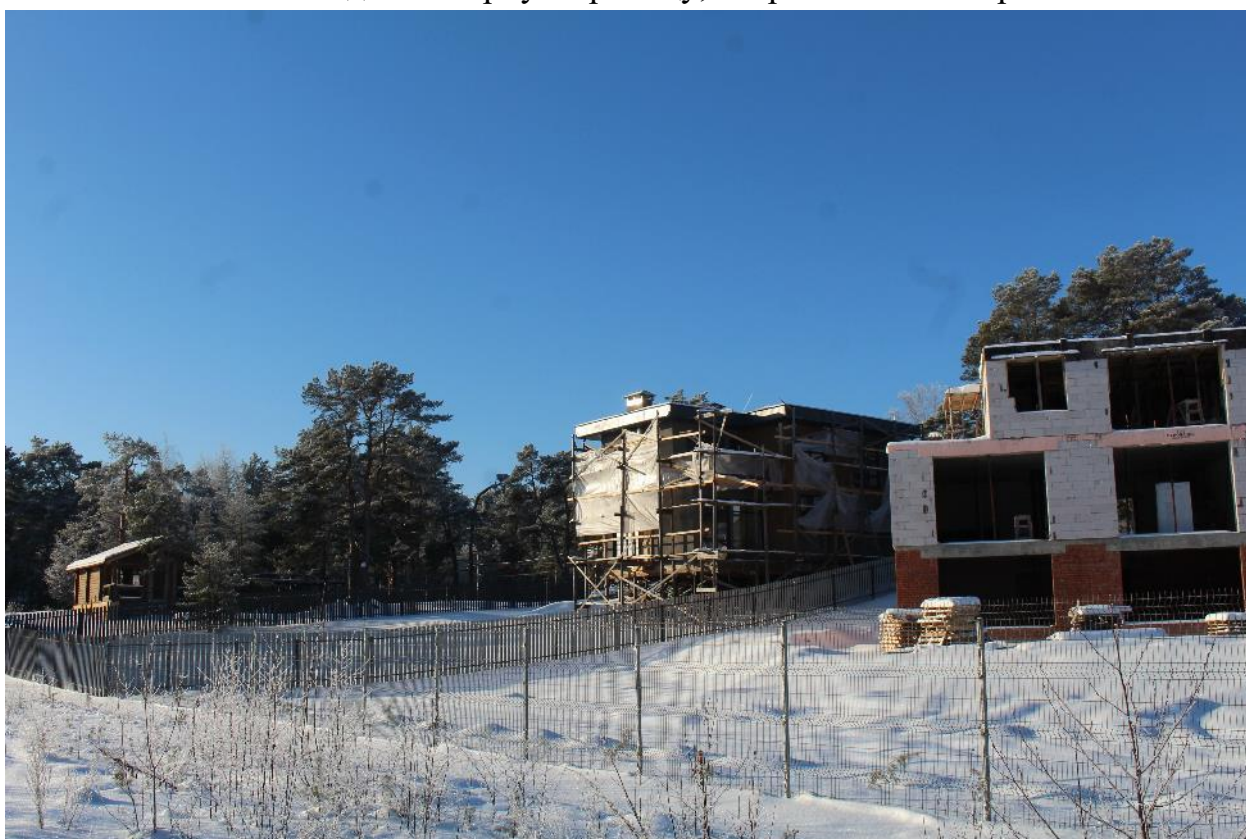
Фото 17. Вид на северо-восточную часть.
