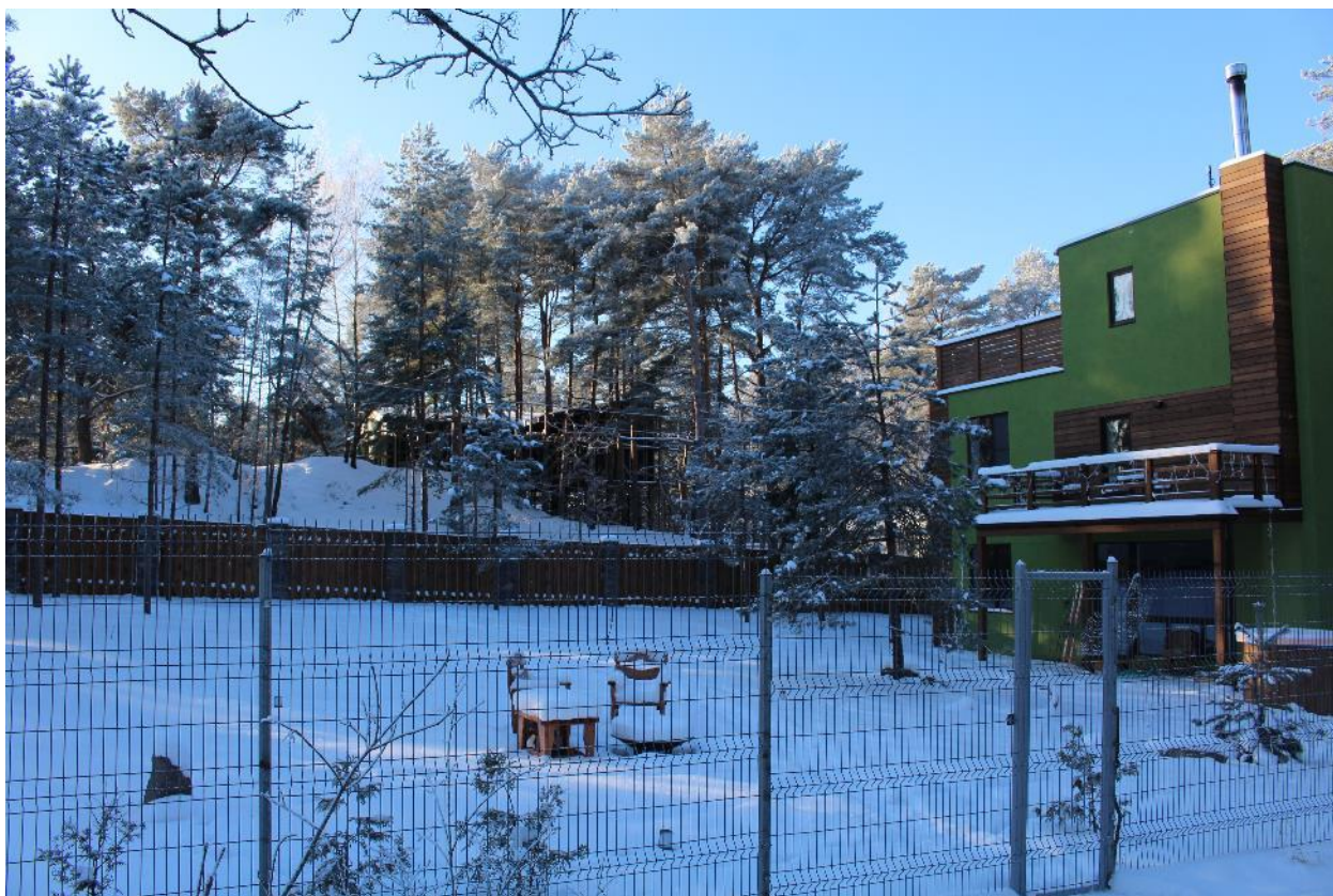
Фото 14. Вид на возвышенность с севера, строительство дома.
