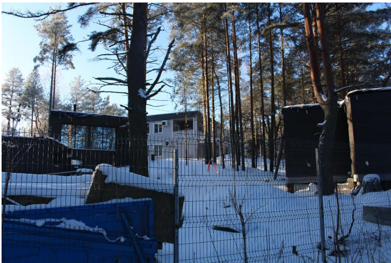
Фото 10. Вид в северо-западе.
