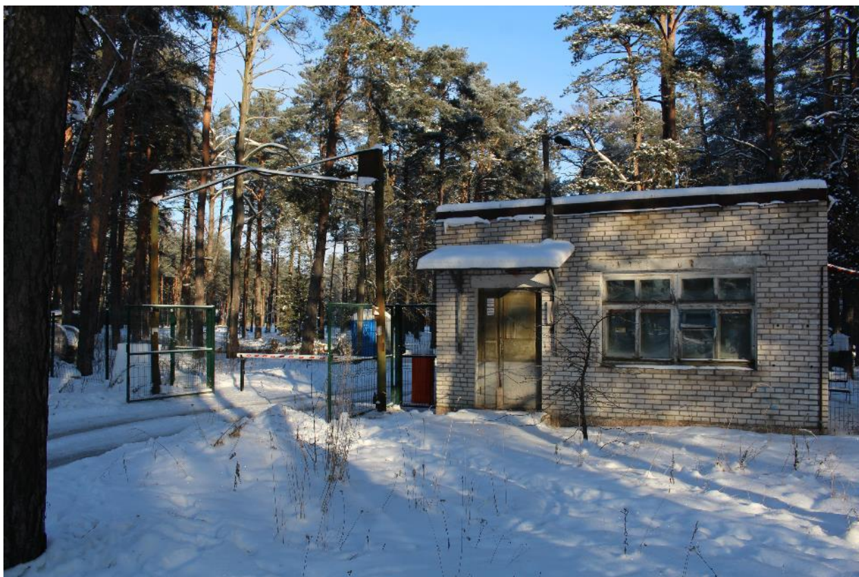
Фото 26. Главный въезд на территорию, пост охраны.
