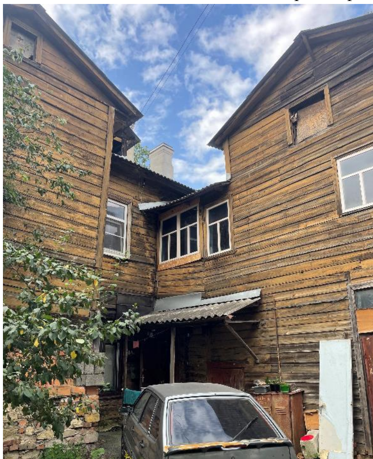
Фото 30. Угловая часть дворового фасада.
