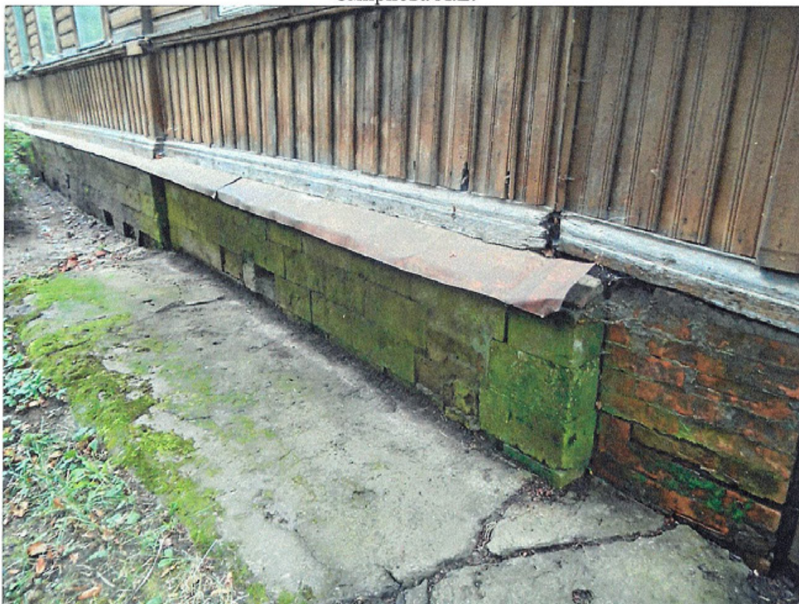
Фотография № 2. Фрагмент западного фасада, Карла Маркса улица. Смирнова А.Е.
