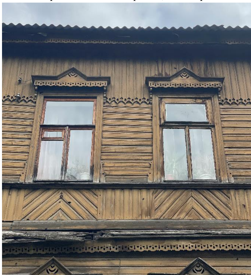
Фото 37. Фрагмент лицевого фасада, окна второго этажа.
