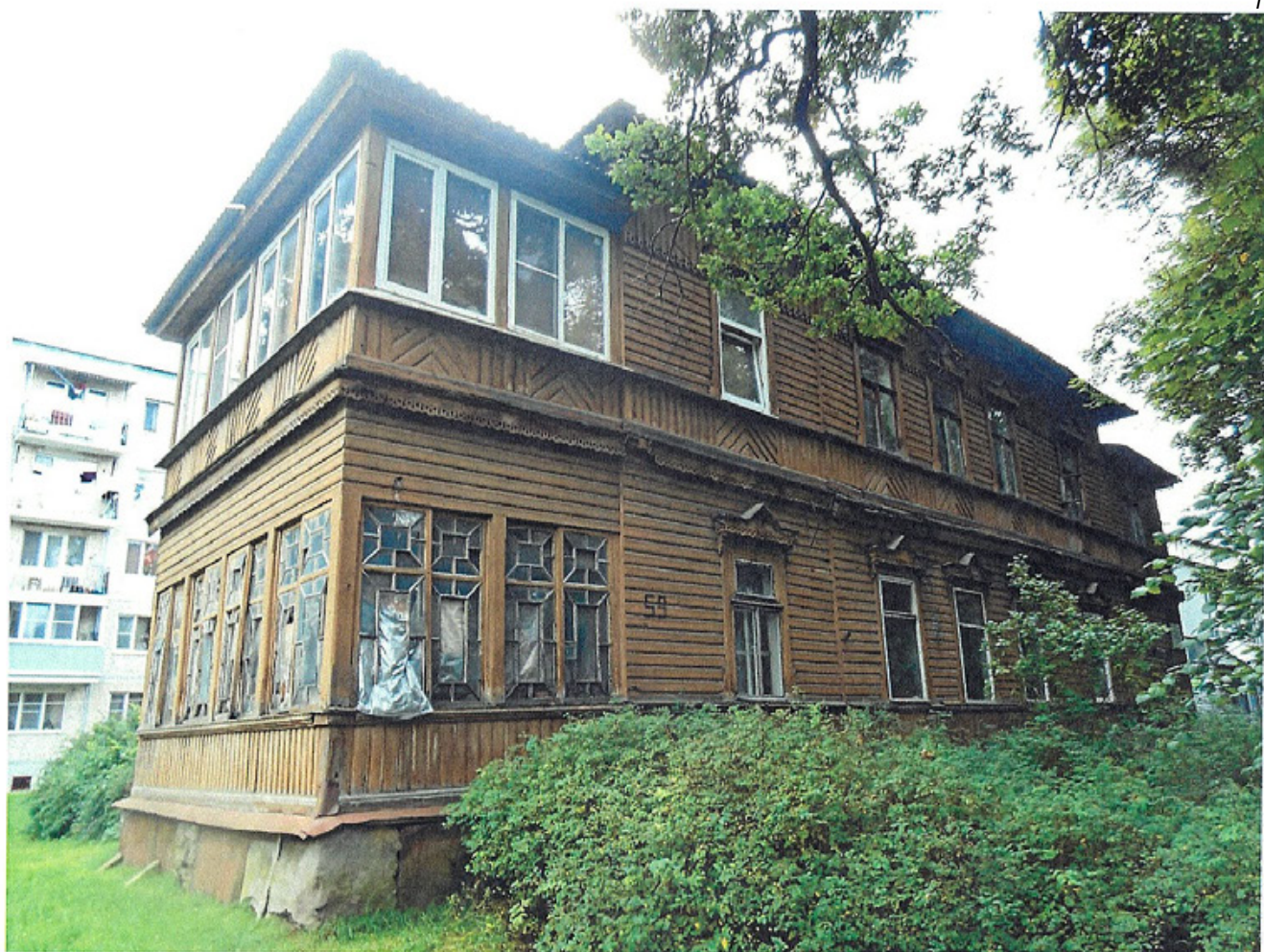
Фотография № 9. Фрагмент северного и западного фасадов, вид с северо-запада. Смирнова А.Е.
