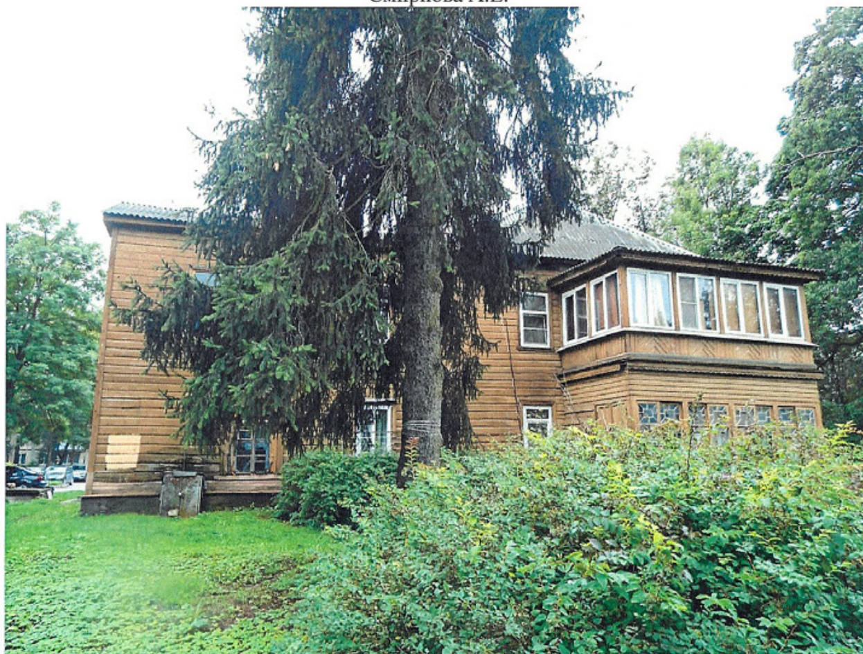
Фотография № 6. Северный фасад, вид с северо-востока. Смирнова А.Е.
