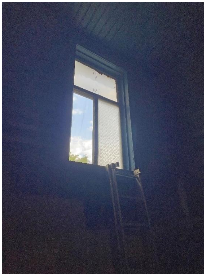
Фото 43. Междуетажное окно парадной лестницы.
