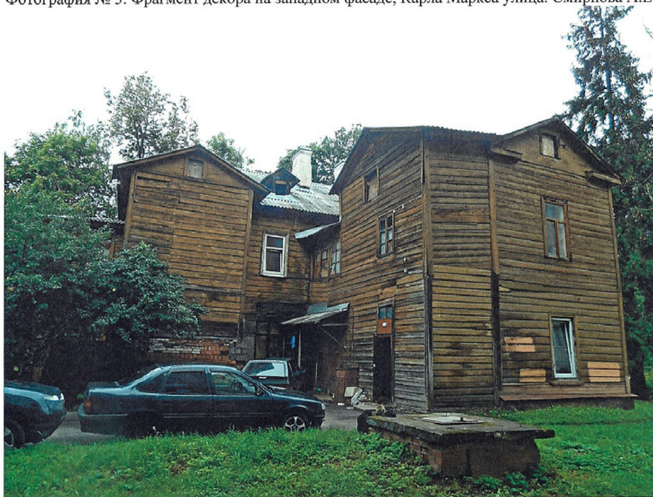
Фотография № 4. Фрагмент восточного и южного (дворовых) фасадов, вид с юго-востока. Смирнова А.Е.
