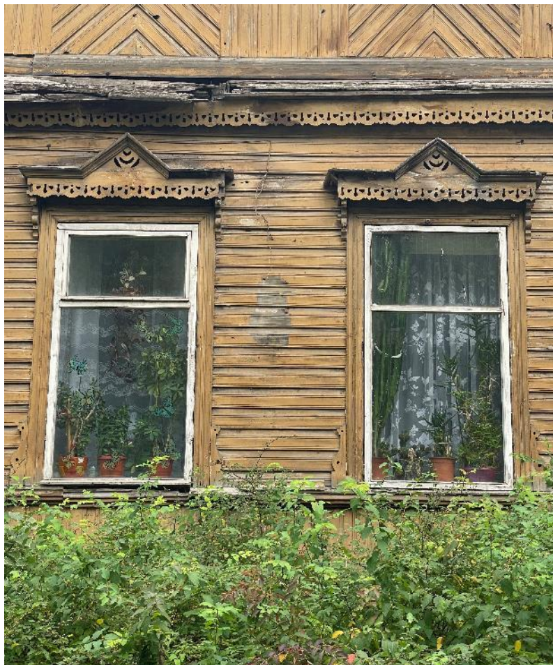
Фото 36. Фрагмент лицевого фасада, окна первого этажа.
