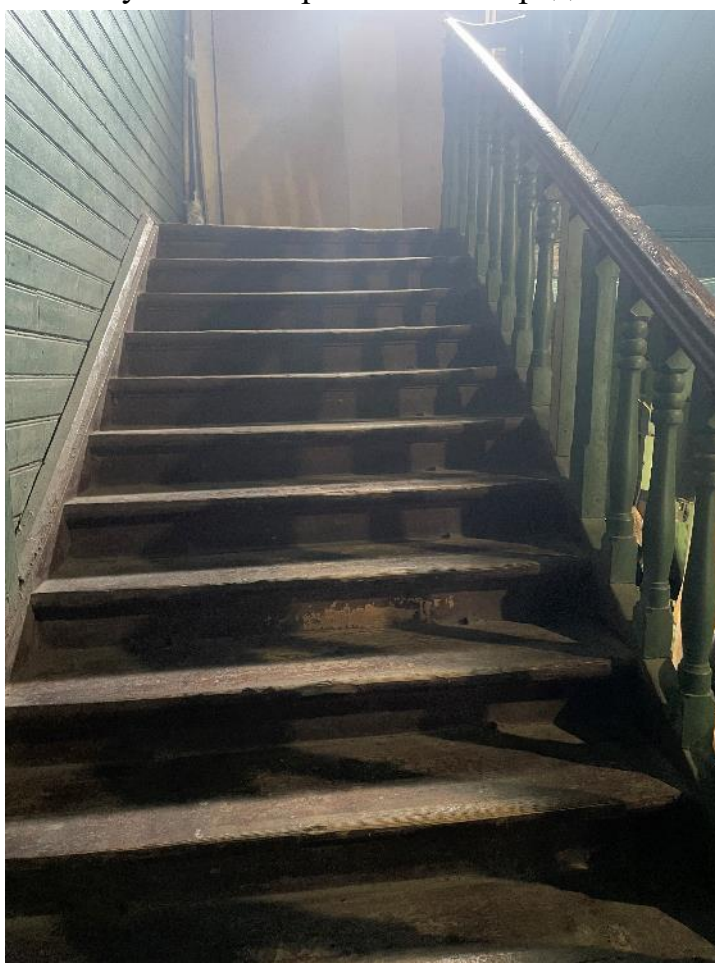
Фото 40. Марш парадной лестницы.
