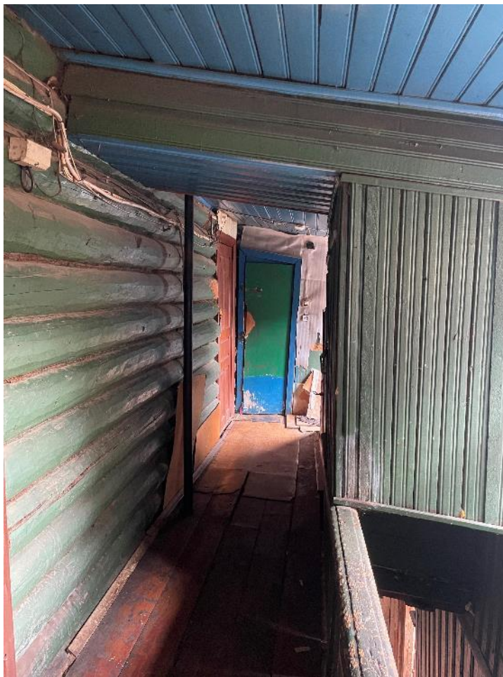
Фото 48. Коридор черной лестницы, второй этаж.
