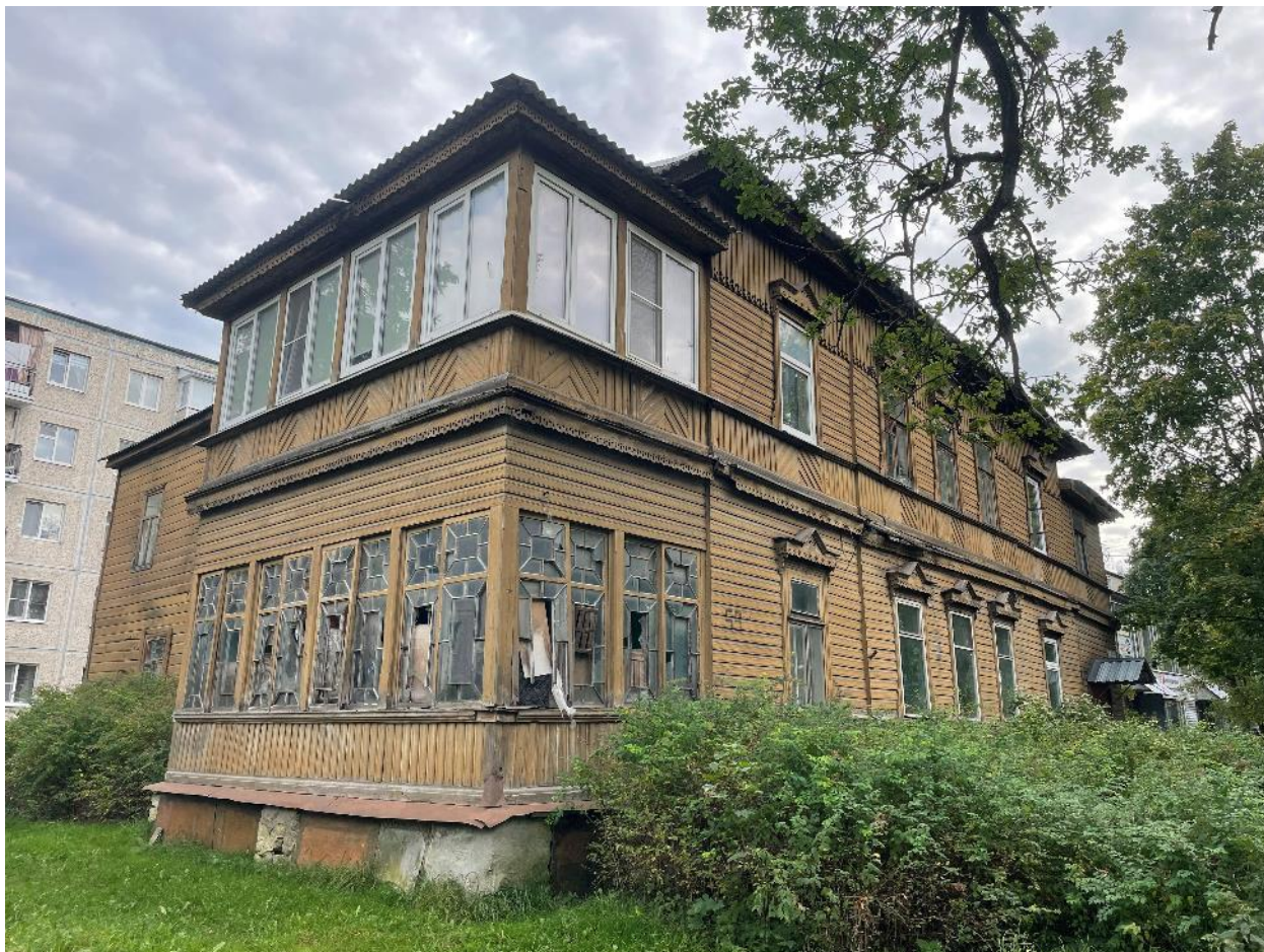
Фото 34. Вид с северо-запада.
