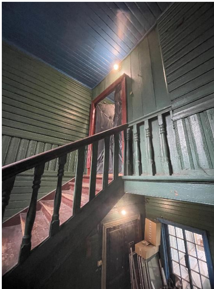
Фото 41. Вид на второй этаж парадной лестницы.
