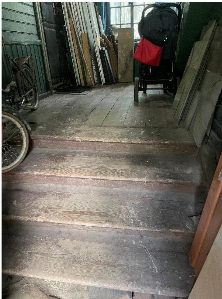
Фото 39. Ступени на первом этаже парадной лестницы.
