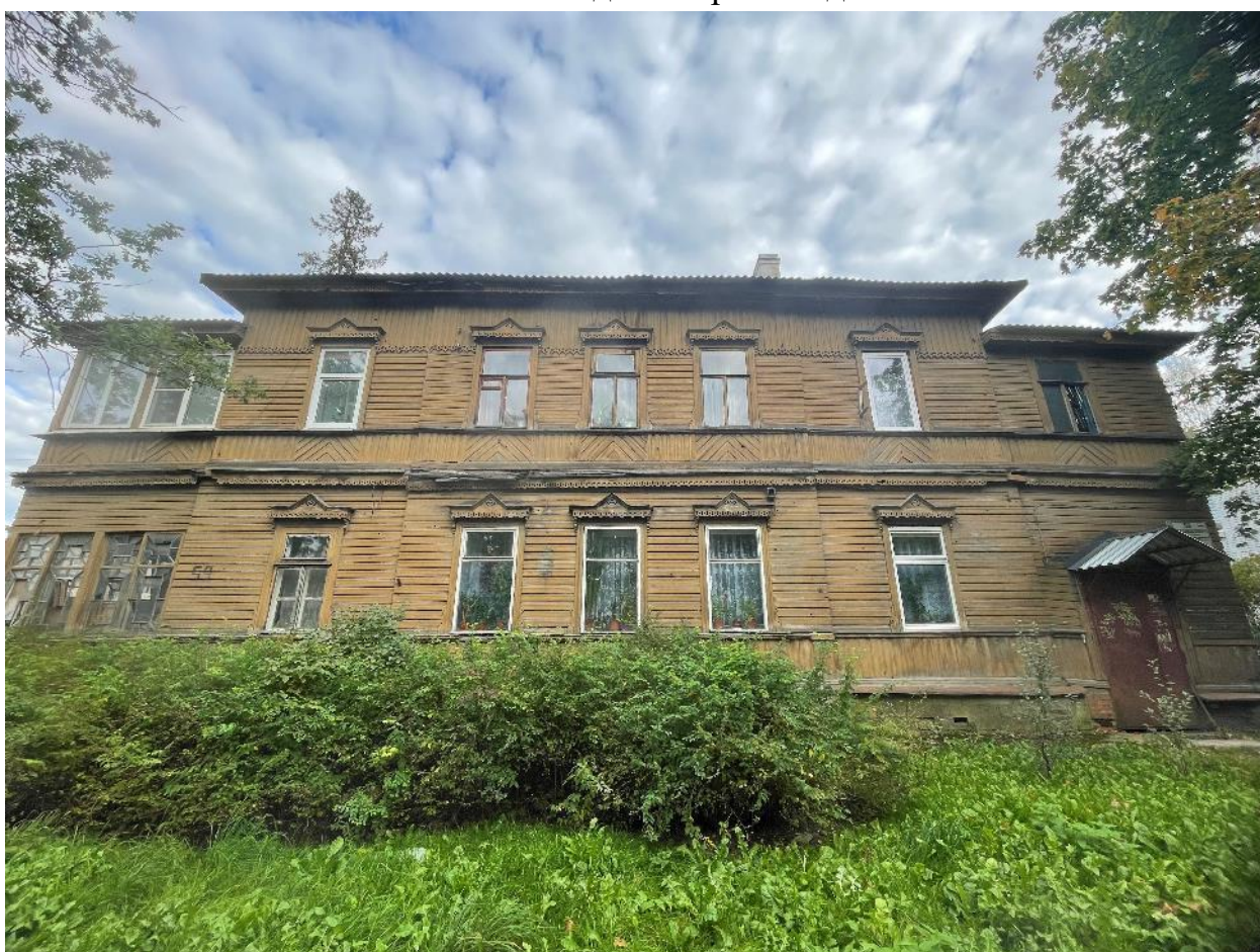
Фото 35. Лицевой фасад, вид с запада.
