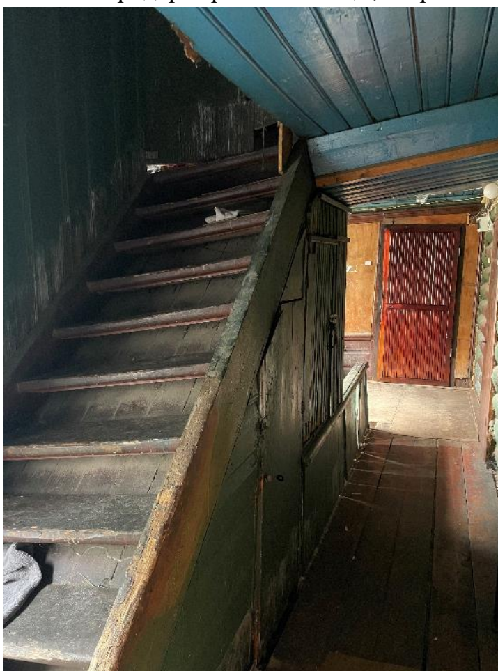
Фото 49. Коридор второго этажа черной лестницы и лестница на чердак.
