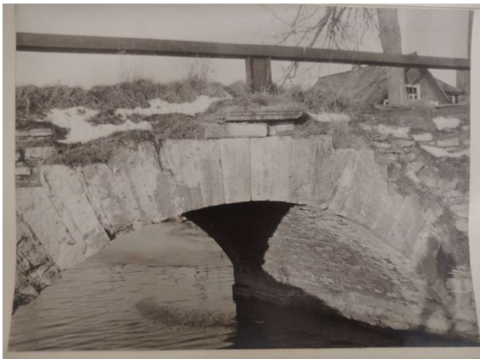
56. Арка моста. Вид с верхнего бьефа. Реконструкция водоподъемной плотины на р. Колпанка, г. Гатчина. 1991 г. Архив Комитета по сохранению культурного наследия Ленинградской области фонд 1, опись 8132, дело 2332-5
