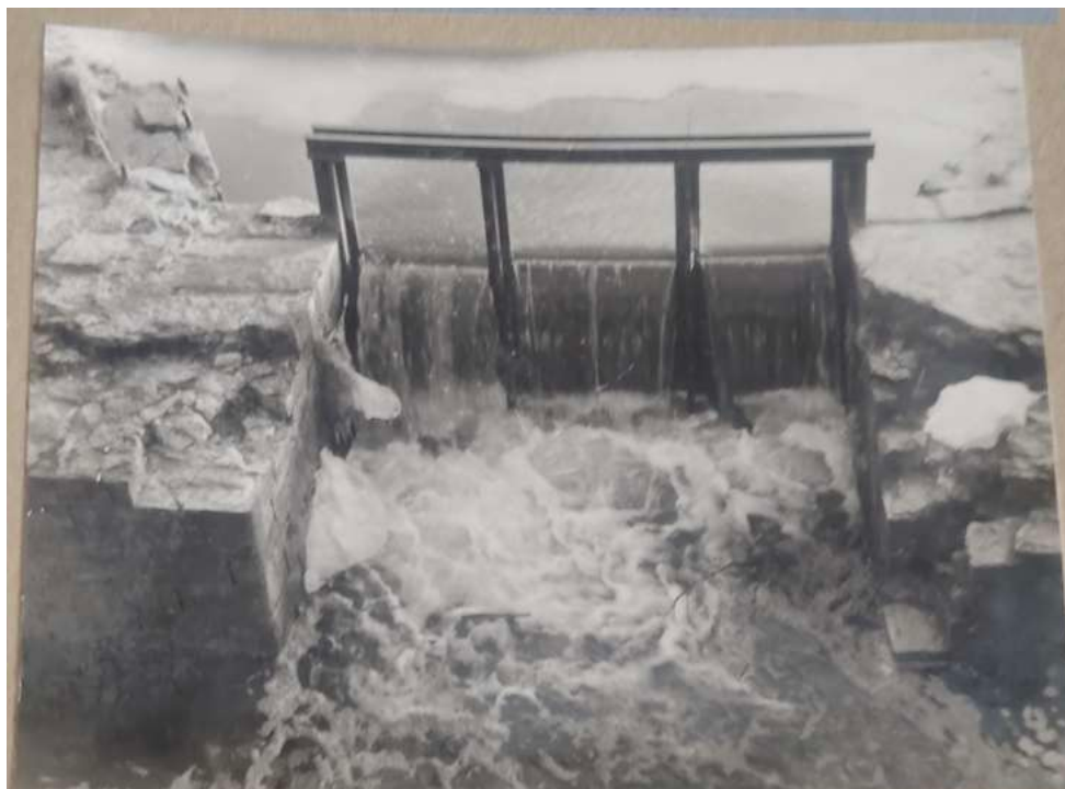
42. Реконструкция водоподъемной плотины на р. Колпанка, г. Гатчина. 1991 г. Архив Комитета по сохранению культурного наследия Ленинградской области фонд 1, опись 8132, дело 2332-5
