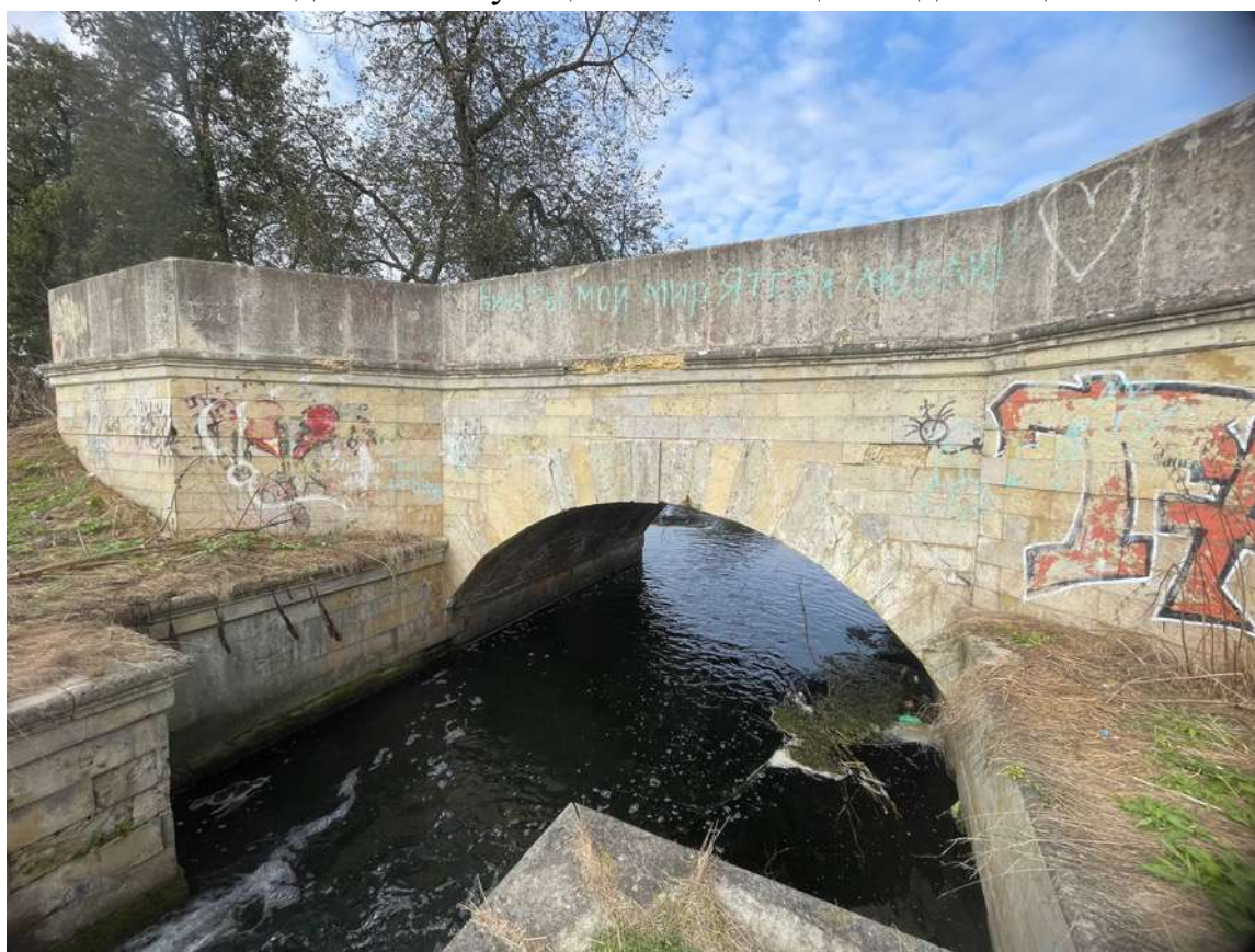
2. Вид на мост с юга
