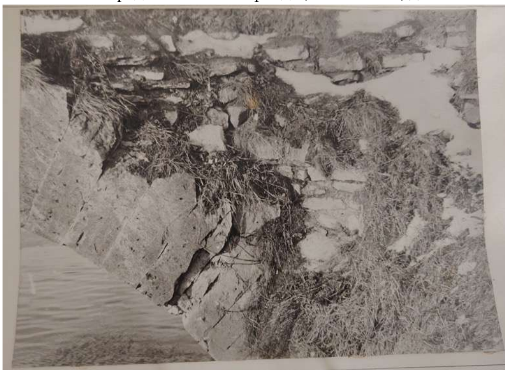
55. Правый устой моста. Вид с верхнего бьефа. Реконструкция водоподъемной плотины на р. Колпанка, г. Гатчина. 1991 г. Архив Комитета по сохранению культурного наследия Ленинградской области фонд 1, опись 8132, дело 2332-5
