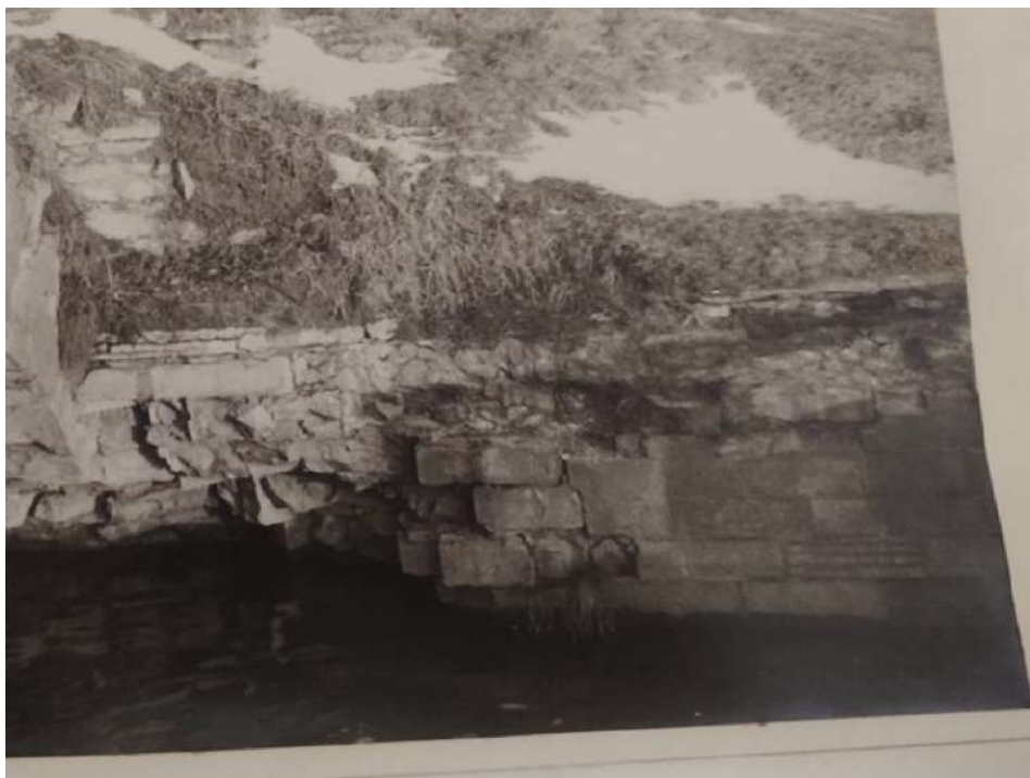
52. Правый устой отводящего канала плотины. Реконструкция водоподъемной плотины на р. Колпанка, г. Гатчина. 1991 г. Архив Комитета по сохранению культурного наследия Ленинградской области фонд 1, опись 8132, дело 2332-5
