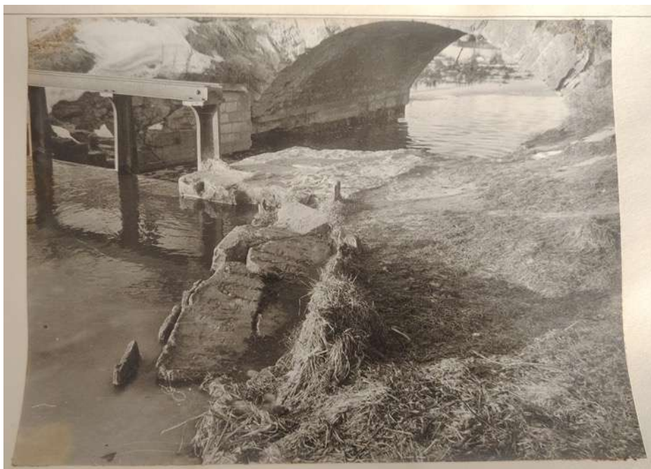
46. Правый устой подводящего канала плотины. Реконструкция водоподъемной плотины на р. Колпанка, г. Гатчина. 1991 г. Архив Комитета по сохранению культурного наследия Ленинградской области фонд 1, опись 8132, дело 2332-5
