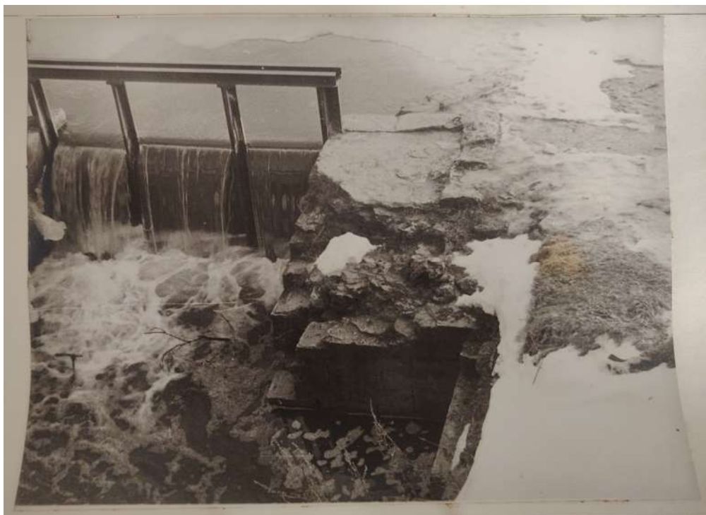
50. Левый устой плотины. Сопряжение с устоем отводящего канала. Реконструкция водоподъемной плотины на р. Колпанка, г. Гатчина. 1991 г. Архив Комитета по сохранению культурного наследия Ленинградской области фонд 1, опись 8132, дело 2332-5
