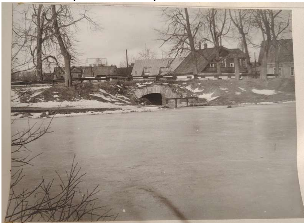
43. Вид на плотину с верхнего бьефа. Реконструкция водоподъемной плотины на р. Колпанка, г. Гатчина. 1991 г. Архив Комитета по сохранению культурного наследия Ленинградской области фонд 1, опись 8132, дело 2332-5
