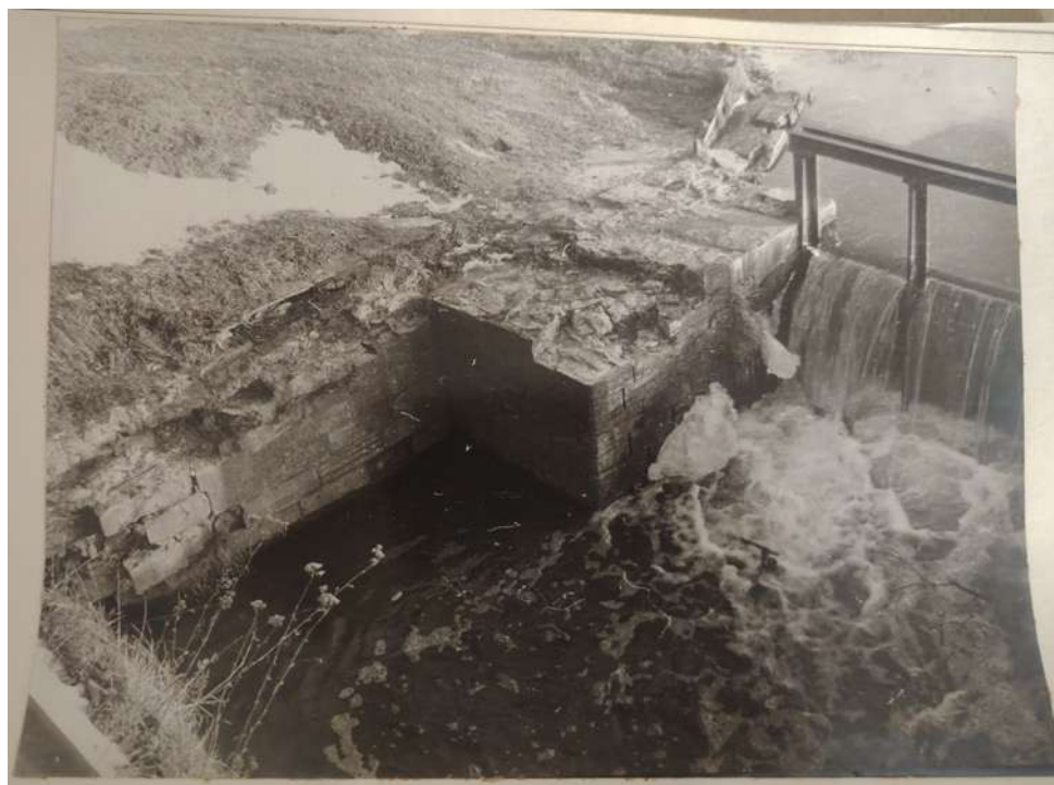
49. Сопряжение правого устоя плотины с правым устоем отводящего канала. Реконструкция водоподъемной плотины на р. Колпанка, г. Гатчина. 1991 г. Архив Комитета по сохранению культурного наследия Ленинградской области фонд 1, опись 8132, дело 2332-5
