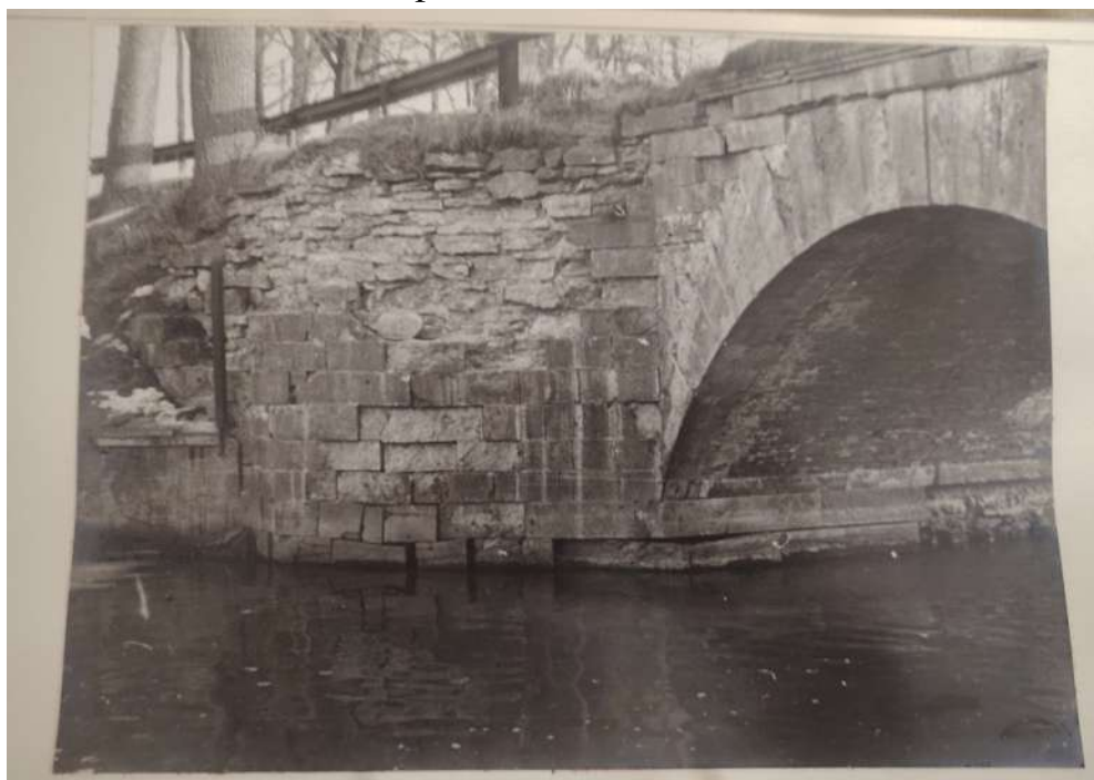
59. Левый устой моста. Вид с нижнего бьефа. Реконструкция водоподъемной плотины на р. Колпанка, г. Гатчина. 1991 г. Архив Комитета по сохранению культурного наследия Ленинградской области фонд 1, опись 8132, дело 2332-5
