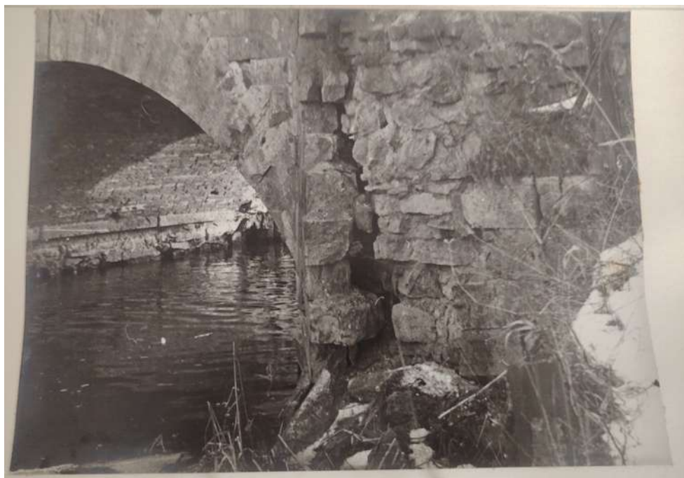
58. Правый устой моста. Вид с нижнего бьефа. Реконструкция водоподъемной плотины на р. Колпанка, г. Гатчина. 1991 г. Архив Комитета по сохранению культурного наследия Ленинградской области фонд 1, опись 8132, дело 2332-5
