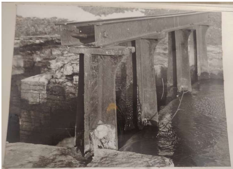
62. Верхняя балка затворной рамы плотины. Реконструкция водоподъемной плотины на р. Колпанка, г. Гатчина. 1991 г. Архив Комитета по сохранению культурного наследия Ленинградской области фонд 1, опись 8132, дело 2332-5
