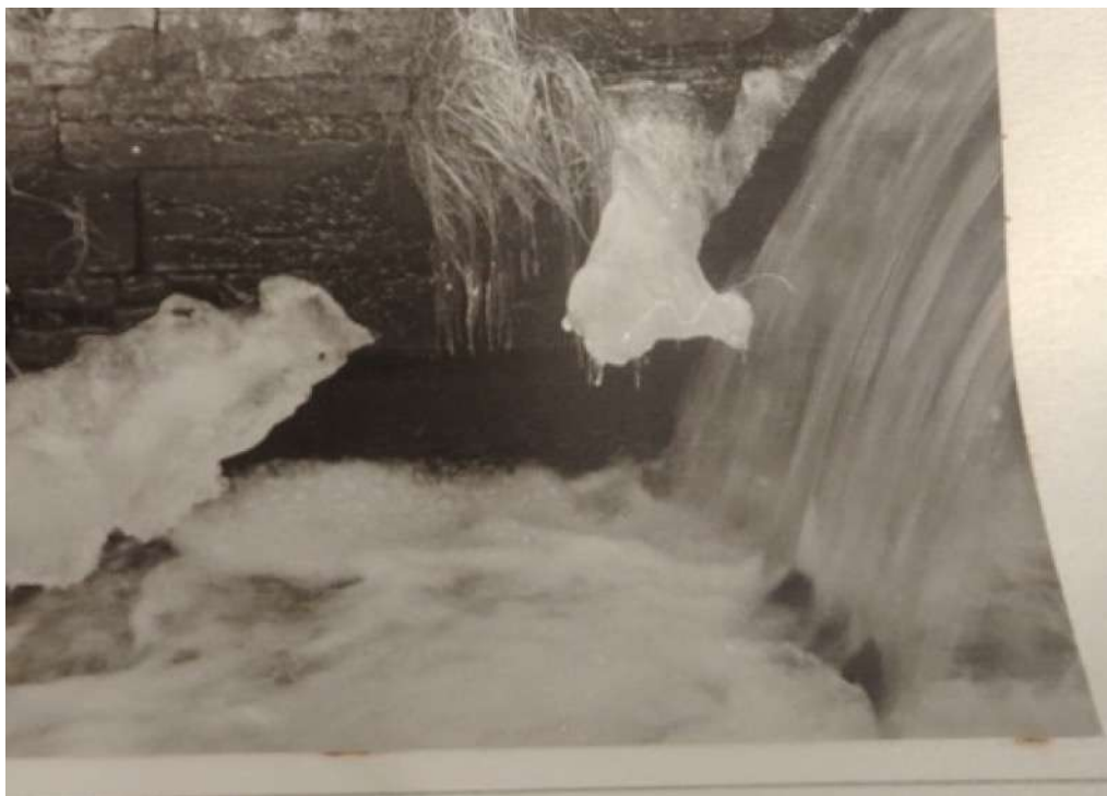
48. Правый устой плотины. Реконструкция водоподъемной плотины на р. Колпанка, г. Гатчина. 1991 г. Архив Комитета по сохранению культурного наследия Ленинградской области фонд 1, опись 8132, дело 2332-5
