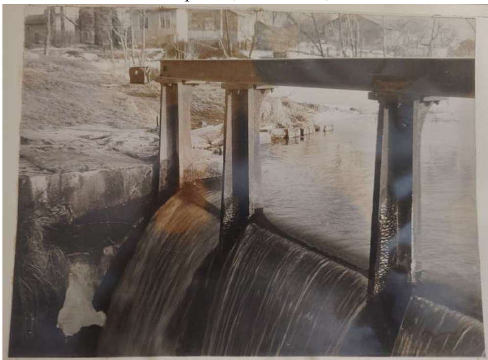
63. Современный режим работы плотины. Реконструкция водоподъемной плотины на р. Колпанка, г. Гатчина. 1991 г. Архив Комитета по сохранению культурного наследия Ленинградской области фонд 1, опись 8132, дело 2332-5
