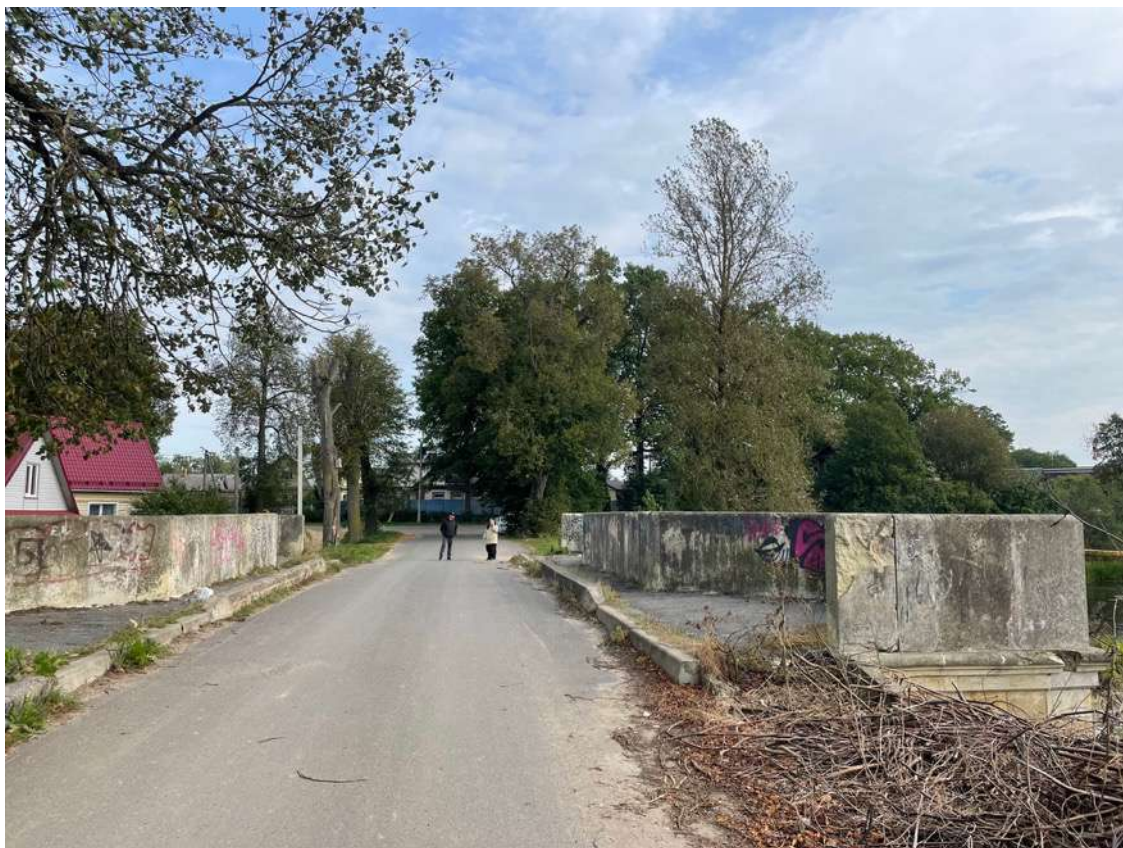
6. Вид на мост
