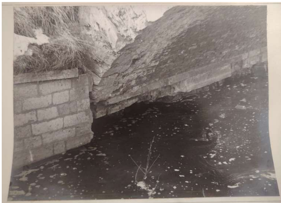
54. Сопряжение устоев отводящего канала плотины с мостом. Реконструкция водоподъемной плотины на р. Колпанка, г. Гатчина. 1991 г. Архив Комитета по сохранению культурного наследия Ленинградской области фонд 1, опись 8132, дело 2332-5
