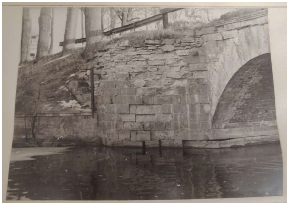
60. Сопряжение левого устоя моста с современным железобетонным ограждением. Вид с нижнего бьефа. Реконструкция водоподъемной плотины на р. Колпанка, г. Гатчина. 1991 г. Архив Комитета по сохранению культурного наследия Ленинградской области фонд 1, опись 8132, дело 2332-5
