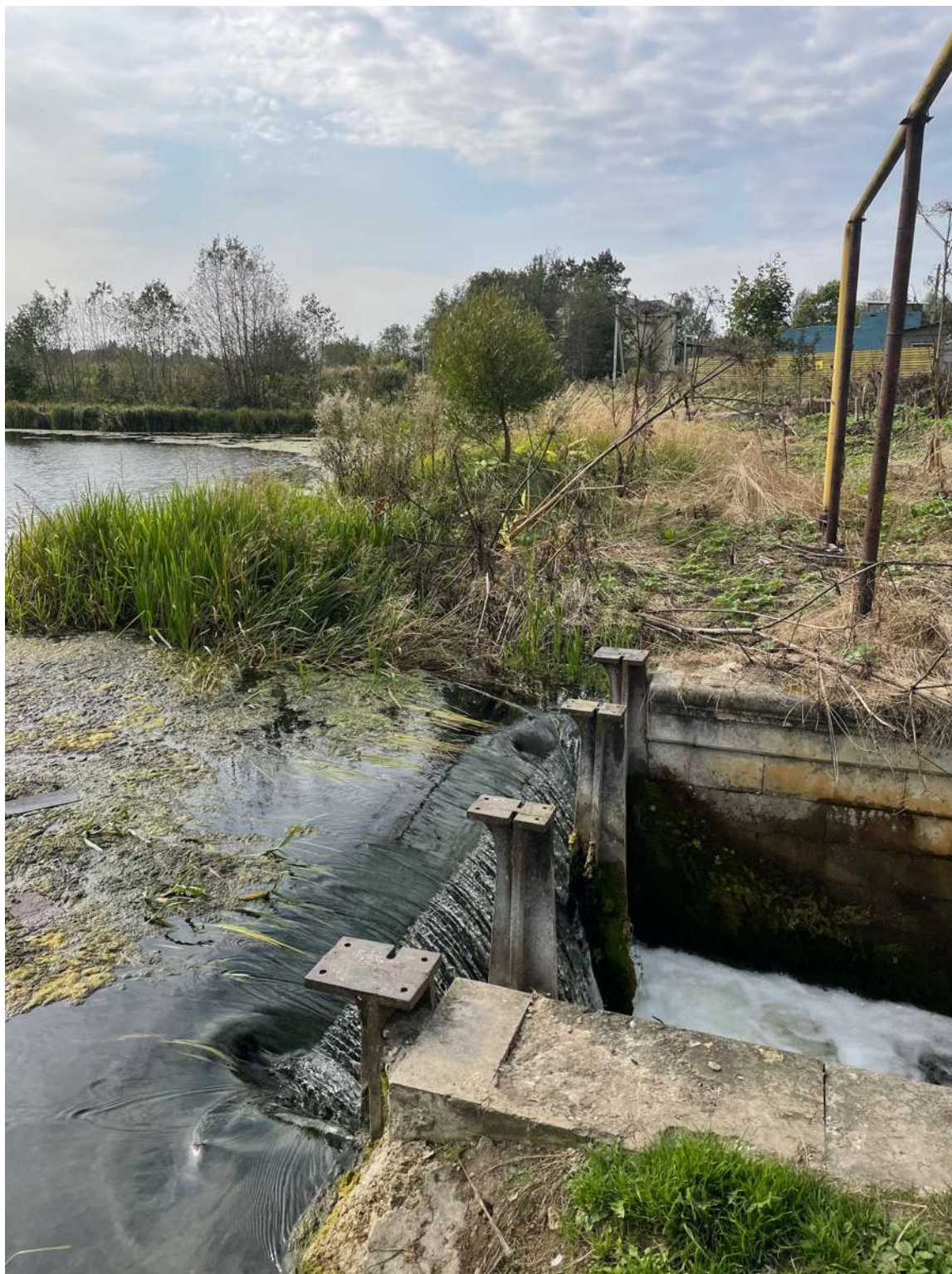
3. Вид на водосброс с затворной рамой
