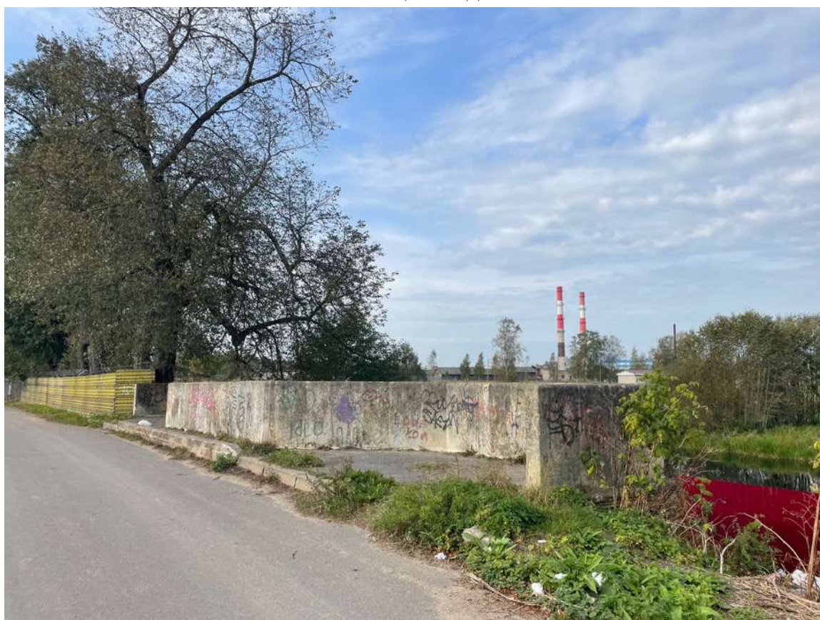
5. Вид на мост
