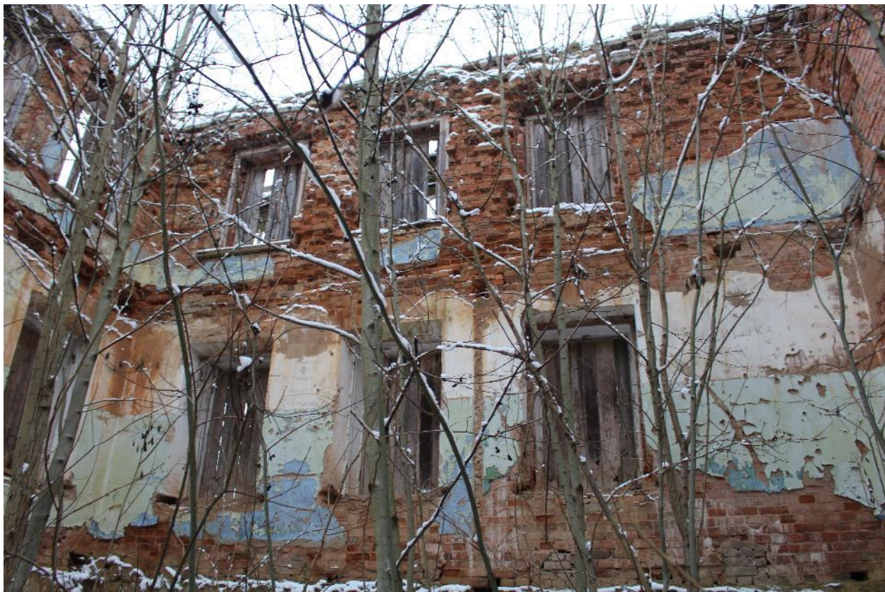
Фото 30. Вид на наружную (восточную) стену дома.
