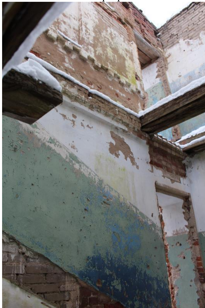
Фото 20. Вид помещения (бывшей лестницы) в западной пристройке.
