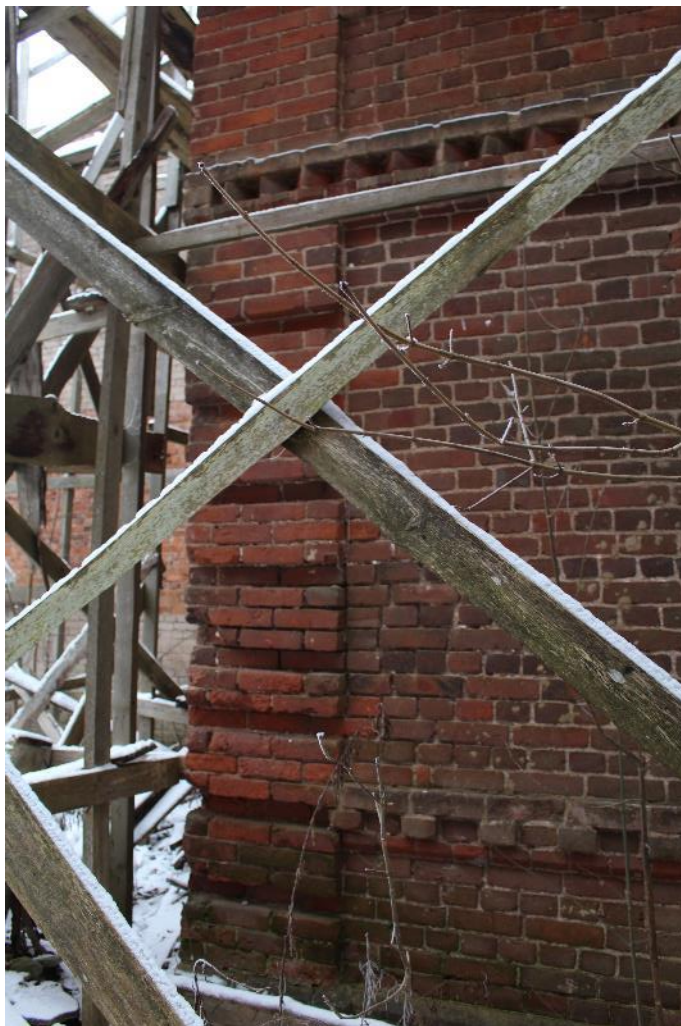
Фото 16. Фрагмент декора северо-восточного фасада.
