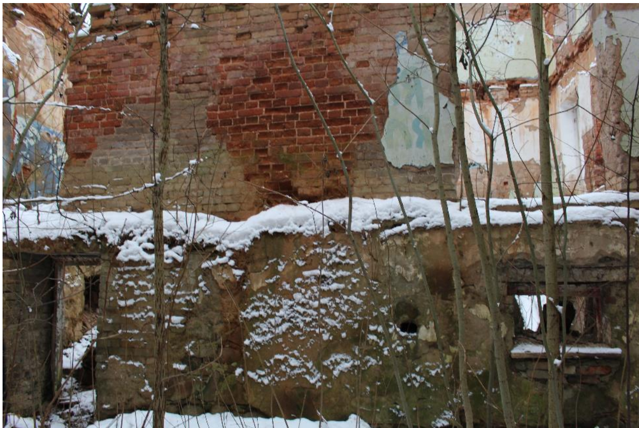
Фото 34. Вид на стену между западным и центральным помещениями.
