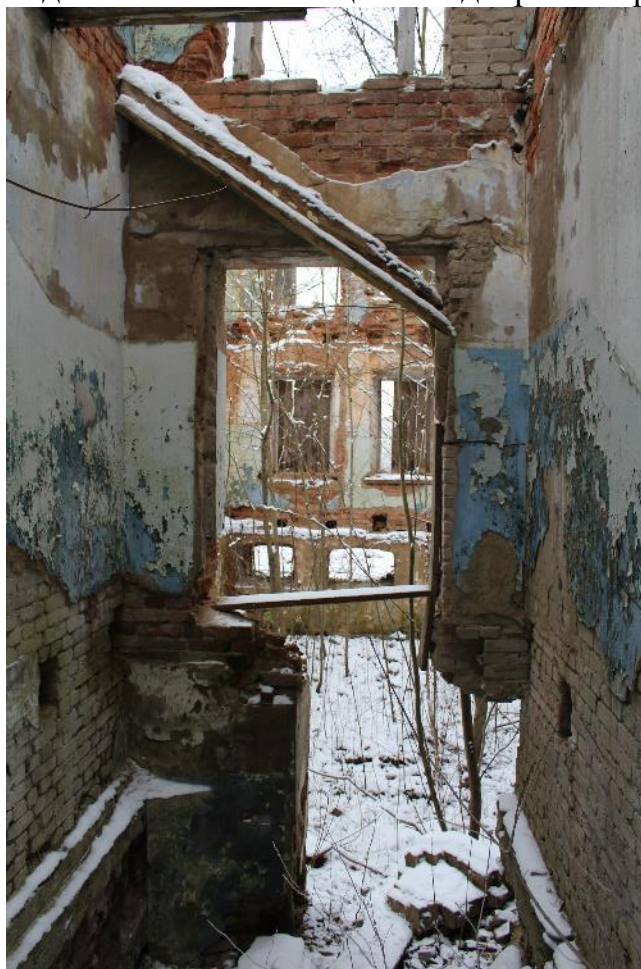
Фото 33. Вид на вход со стороны двора.
