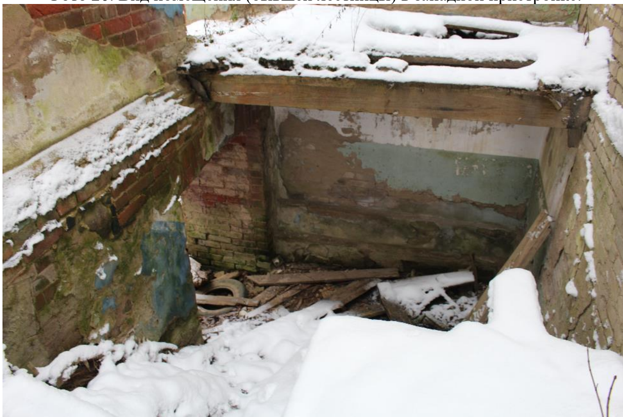
Фото 21. Помещение западной пристройки.
