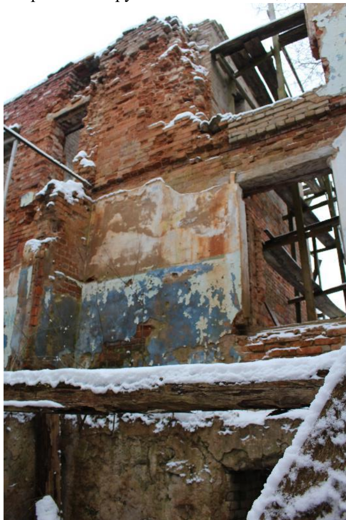
Фото 25. Фрагмент стен в южной части западного помещения.
