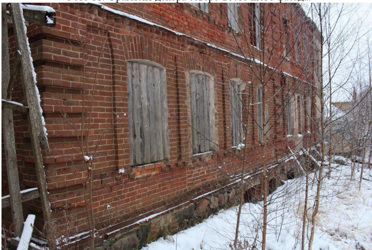
Фото 17. Вид вдоль лицевого фасада с северо-востока.
