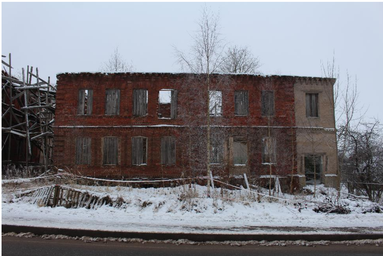
Фото 3. Лицевой северо-западный фасад.
