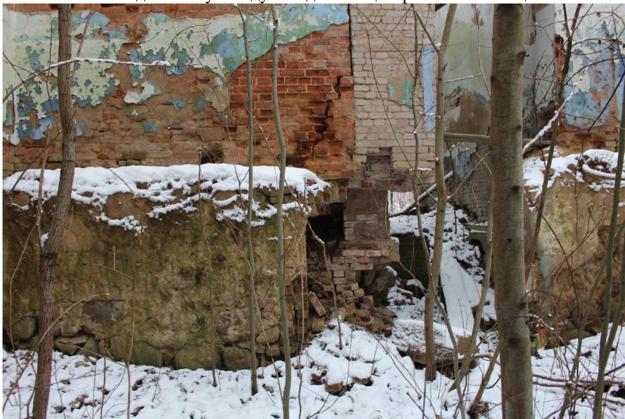
Фото 35. Фрагмент кладки южной стены (цокольная часть).
