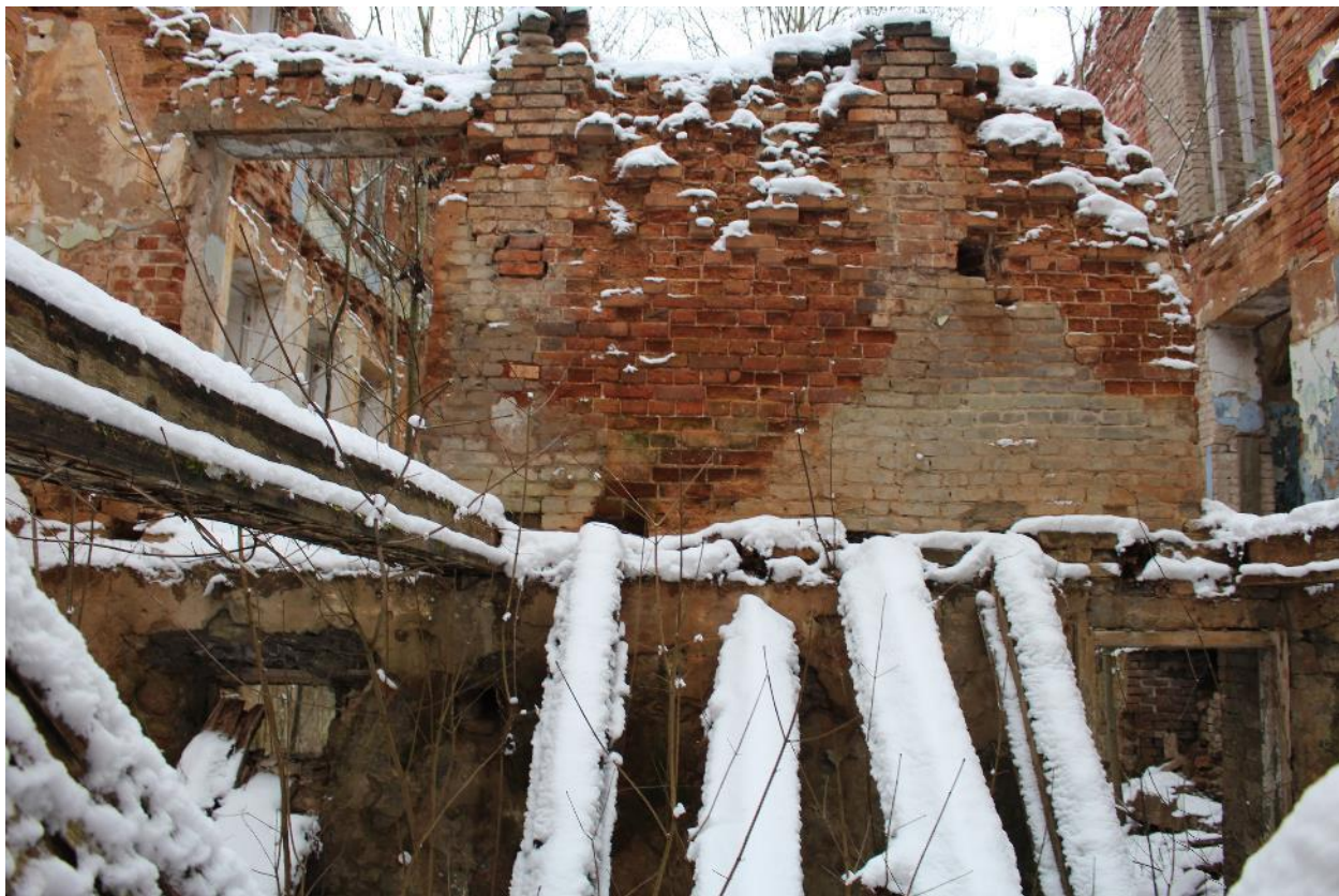
Фото 22. Поперечная стена в западной части дома.
