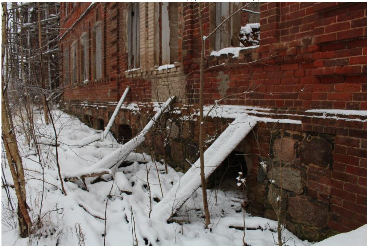
Фото 6. Вид цокольной части лицевого фасада.
