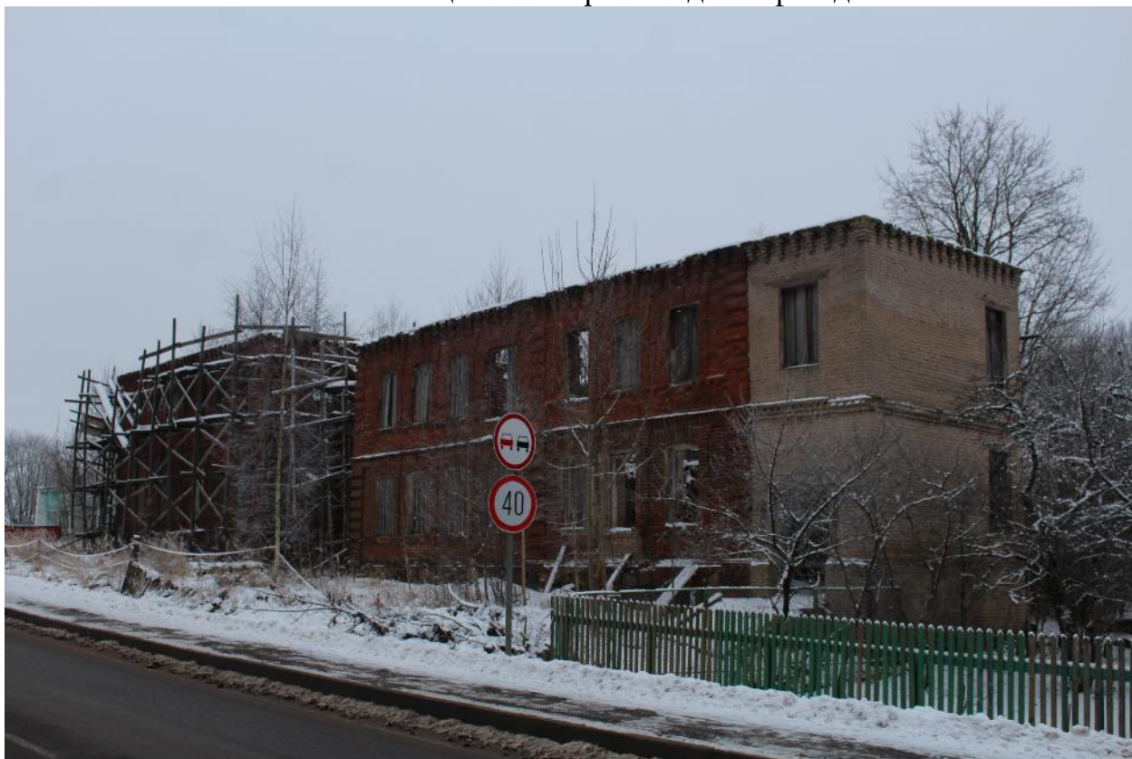
Фото 4. Общий вид с запада домов 52 в д. Старополье.
