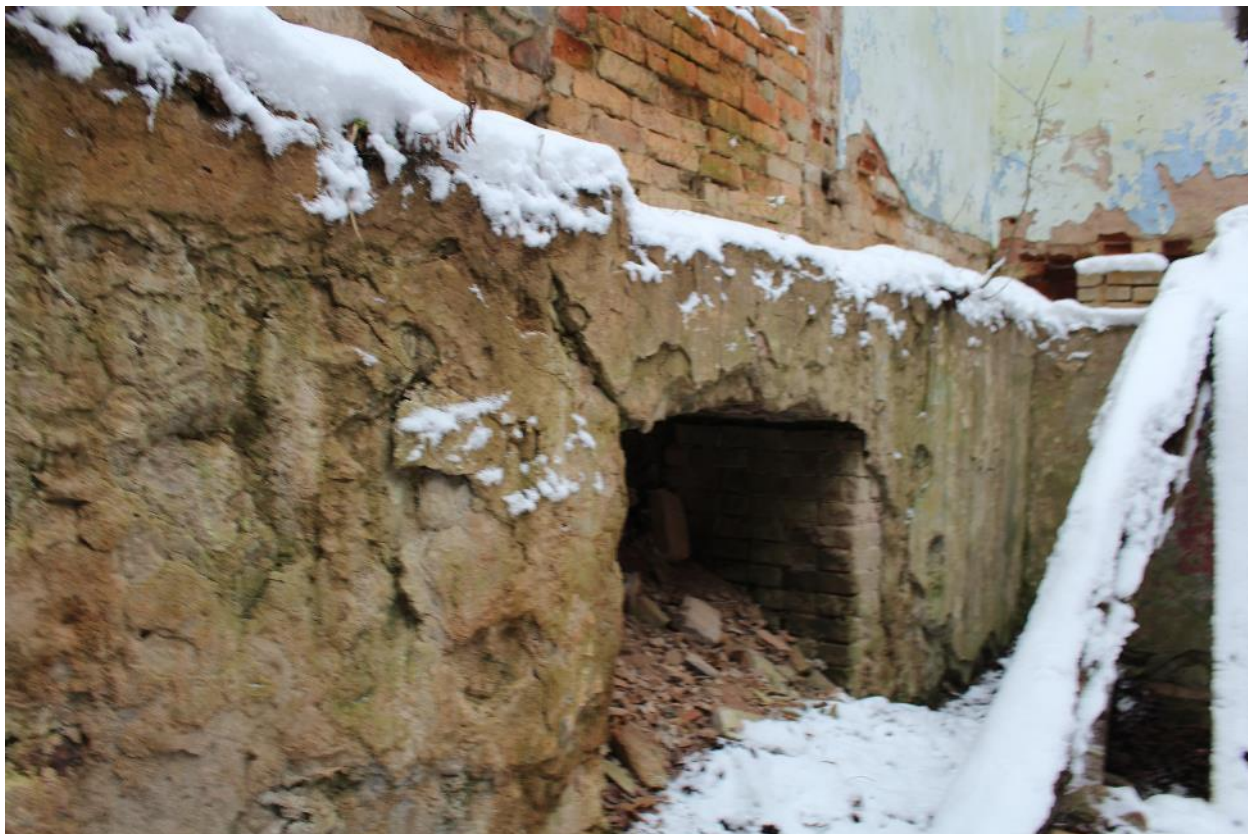
Фото 26. Фрагмент проема в цокольной части.
