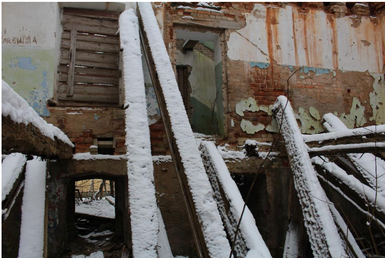
Фото 28. Вид на западную стену дома.
