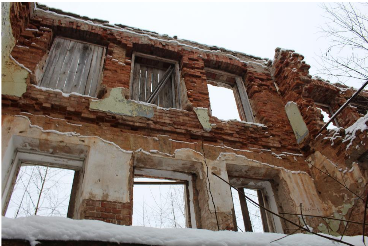
Фото 24. Фрагмент наружной стены в западной части дома.
