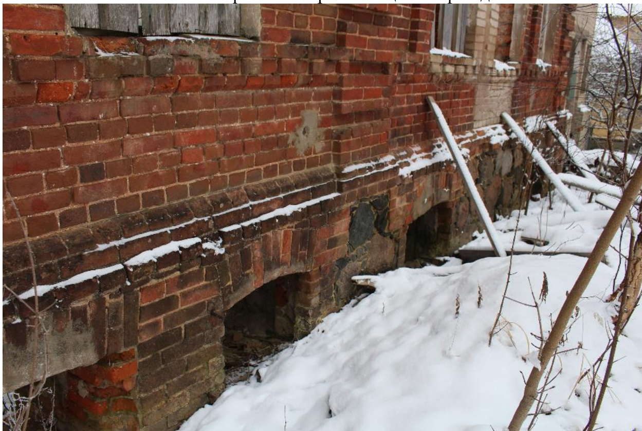
Фото 19. Цокольная часть лицевого фасада (проемы)
