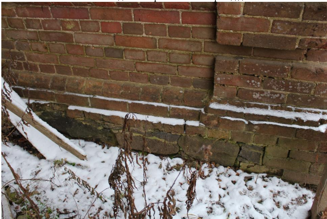
Фото 15. Фрагмент цоколя вдоль северо-восточного фасада.
