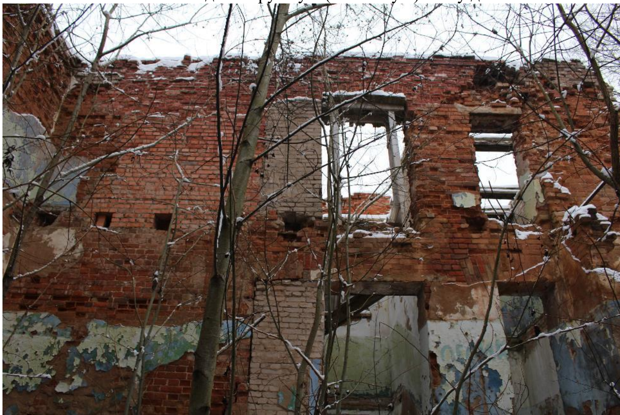
Фото 31. Вид на наружную (южную) стену дома.
