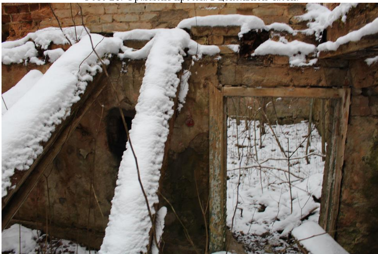
Фото 27. Проход в центральной помещении.
