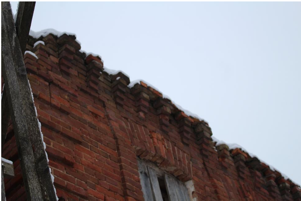
Фото 18. Фрагмент карниза лицевого фасада.
