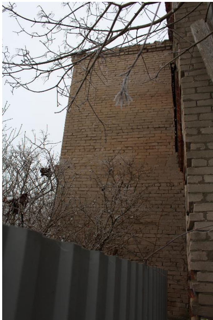
Фото 10. Дворовой фасад пристройки с запада.
