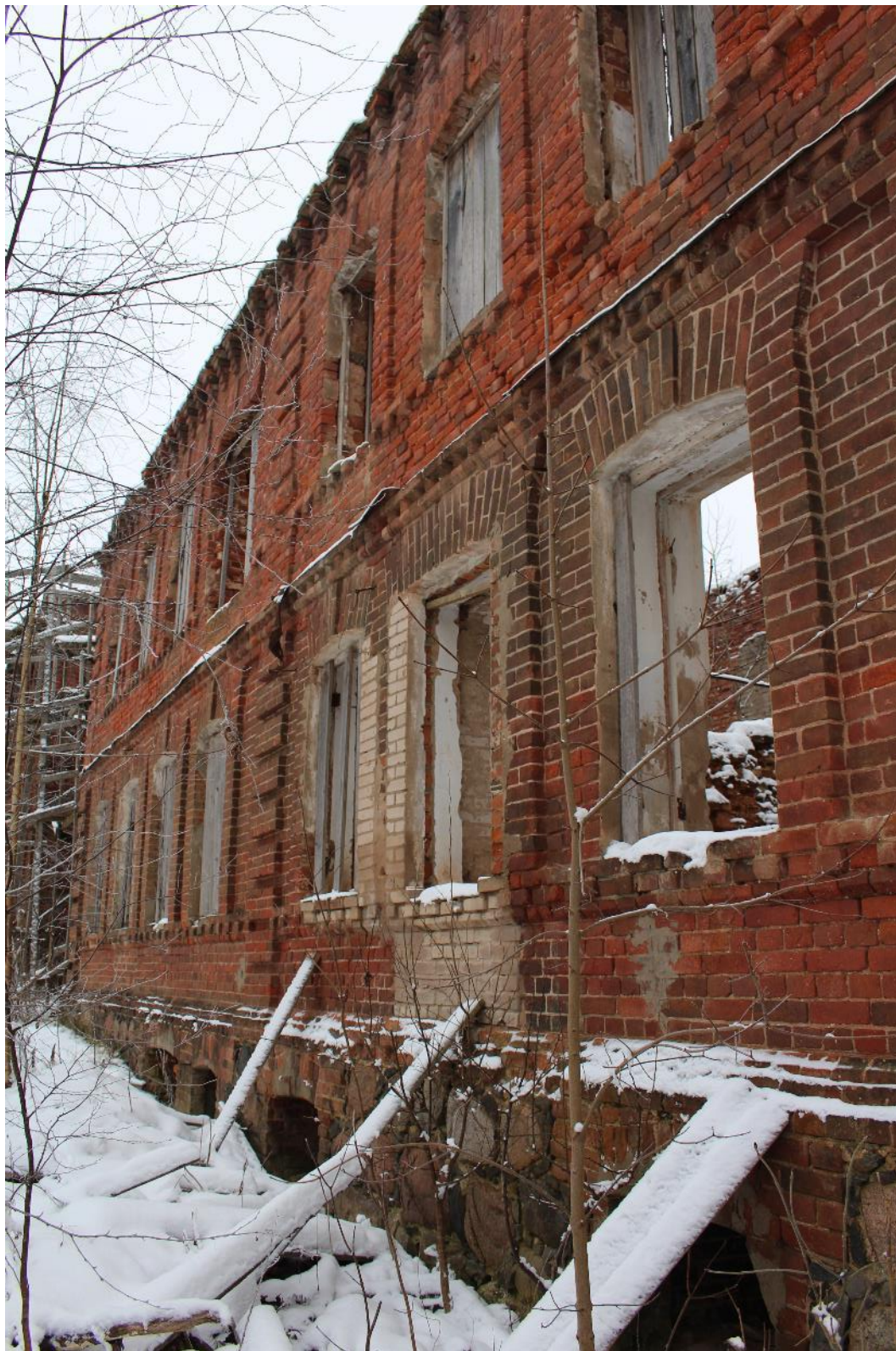
Фото 7. Вид вдоль лицевого фасада.
