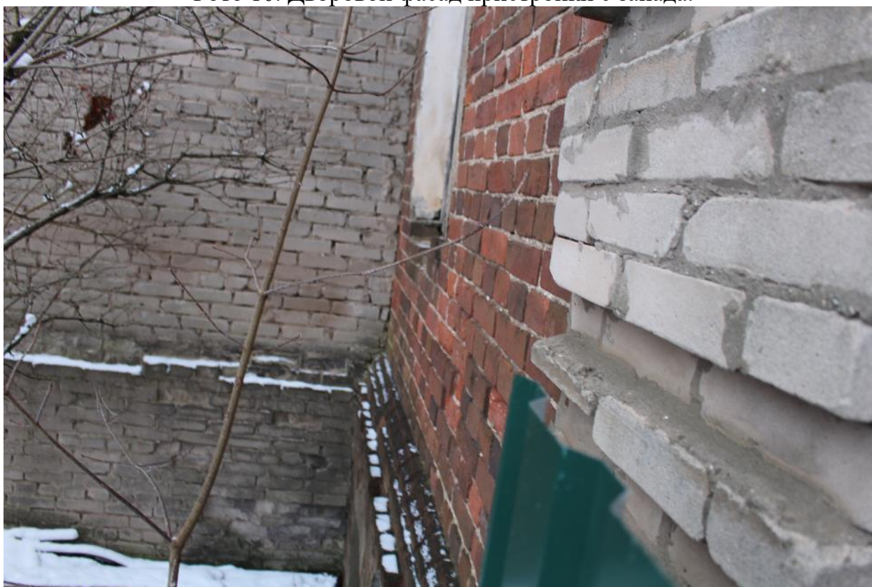
Фото 11. Фрагмент западного юго-западного фасада.
