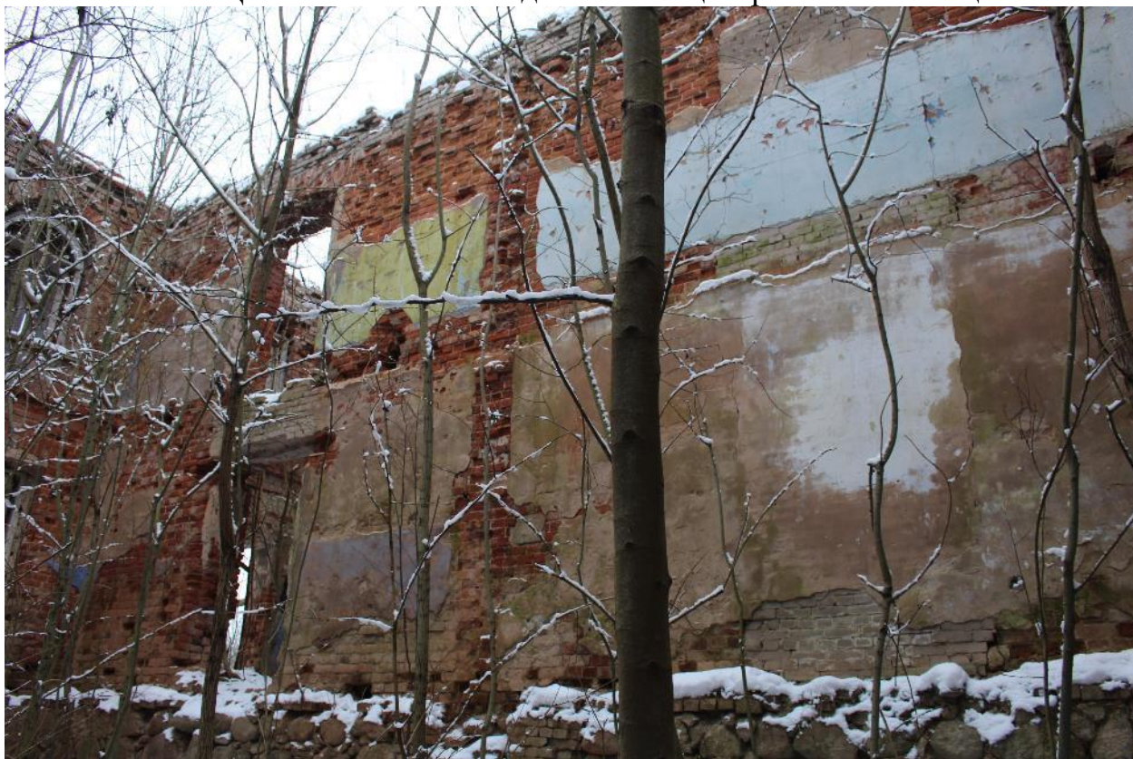
Фото 37. Южная стена центрального помещения.
