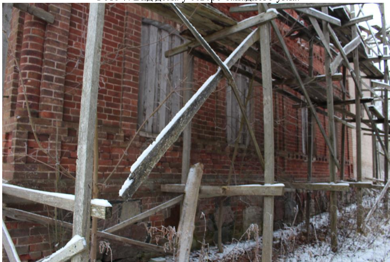
Фото 8. Вид с северо-запада вдоль юго-западного фасада.
