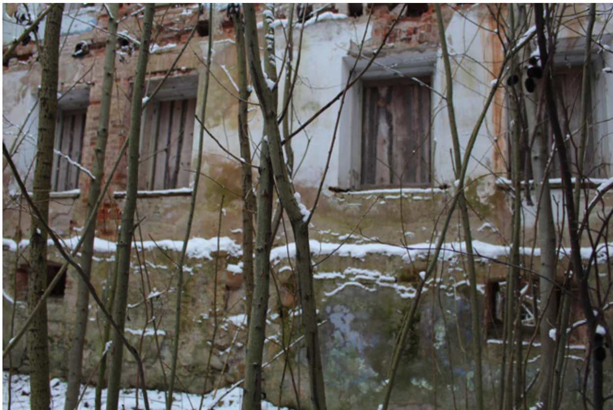
Фото 36. Цокольная часть западной стены центрального помещения.
