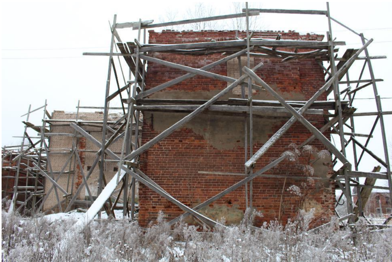
Фото 14. Юго-восточный фасад, общий вид.
