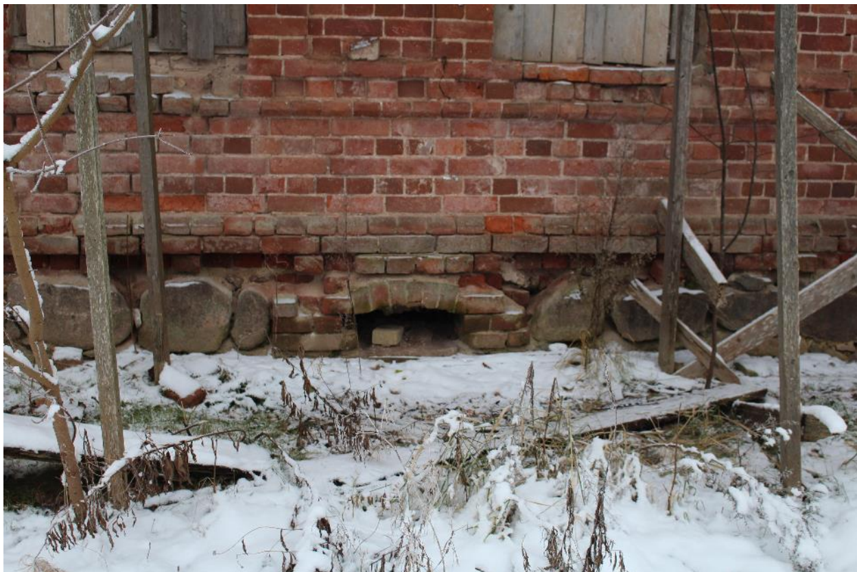
Фото 20. Фрагмент цоколя северо-восточного фасада.
