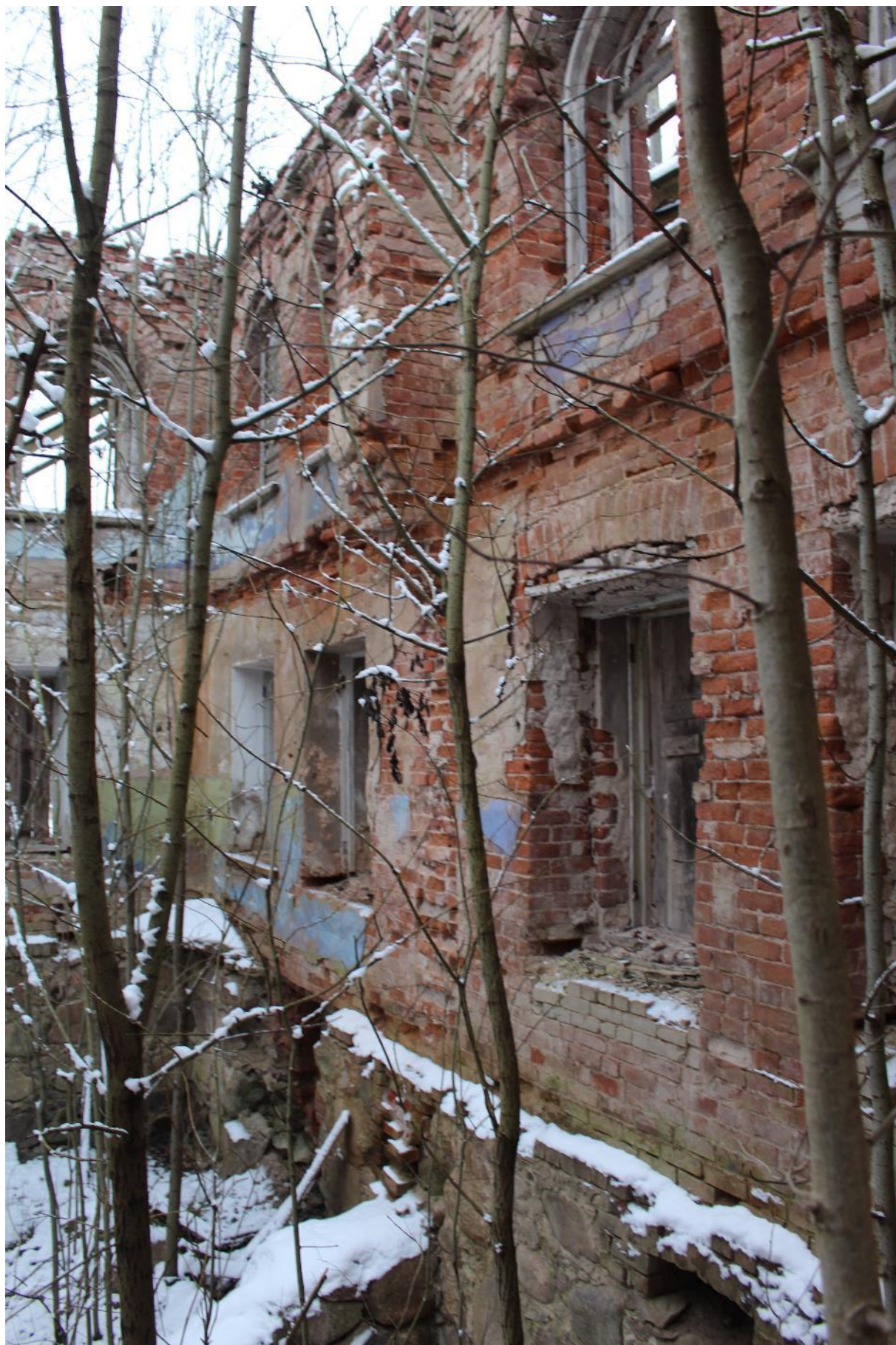
Фото 29. Вид на восточную стену центрального помещения.
