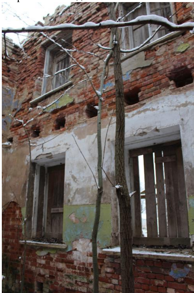
Фото 26. Фрагмент восточной стены с проемами в южном помещении.
