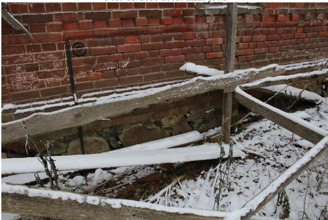
Фото 17. Фрагмент цоколя северо-восточного фасада.
