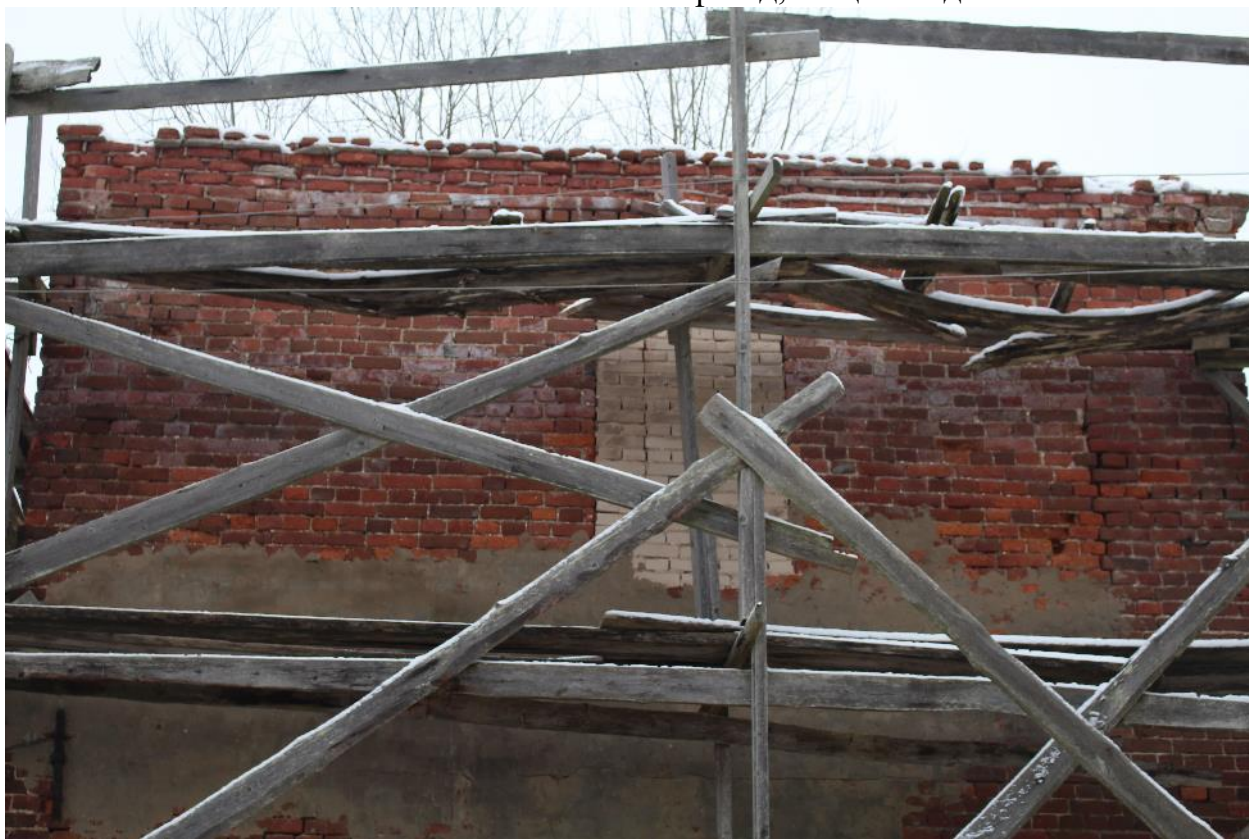
Фото 15. Фрагмент юго-восточного фасада.
