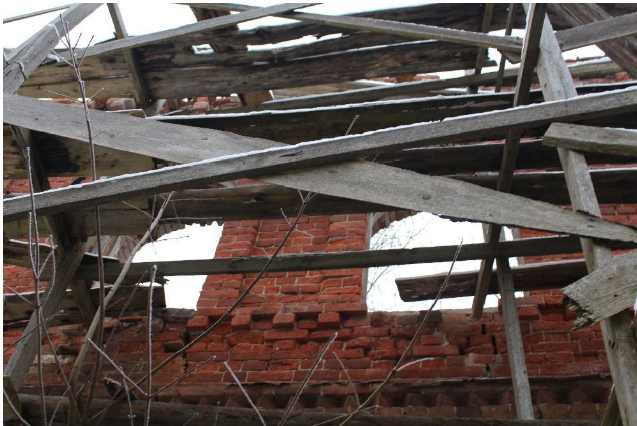
Фото 10. Фрагмент юго-западного фасада, междуэтажный декор.
