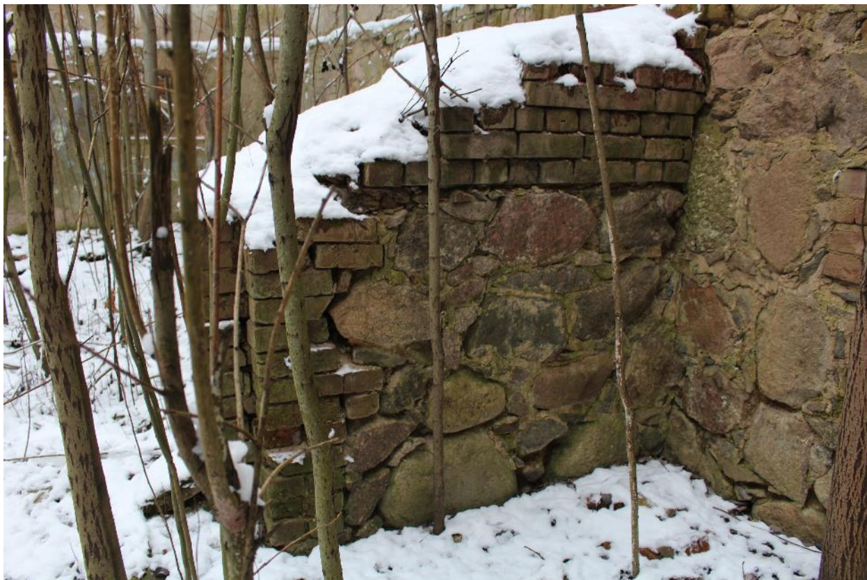
Фото 38. Цокольная часть поперечной стены в центральном помещении.
