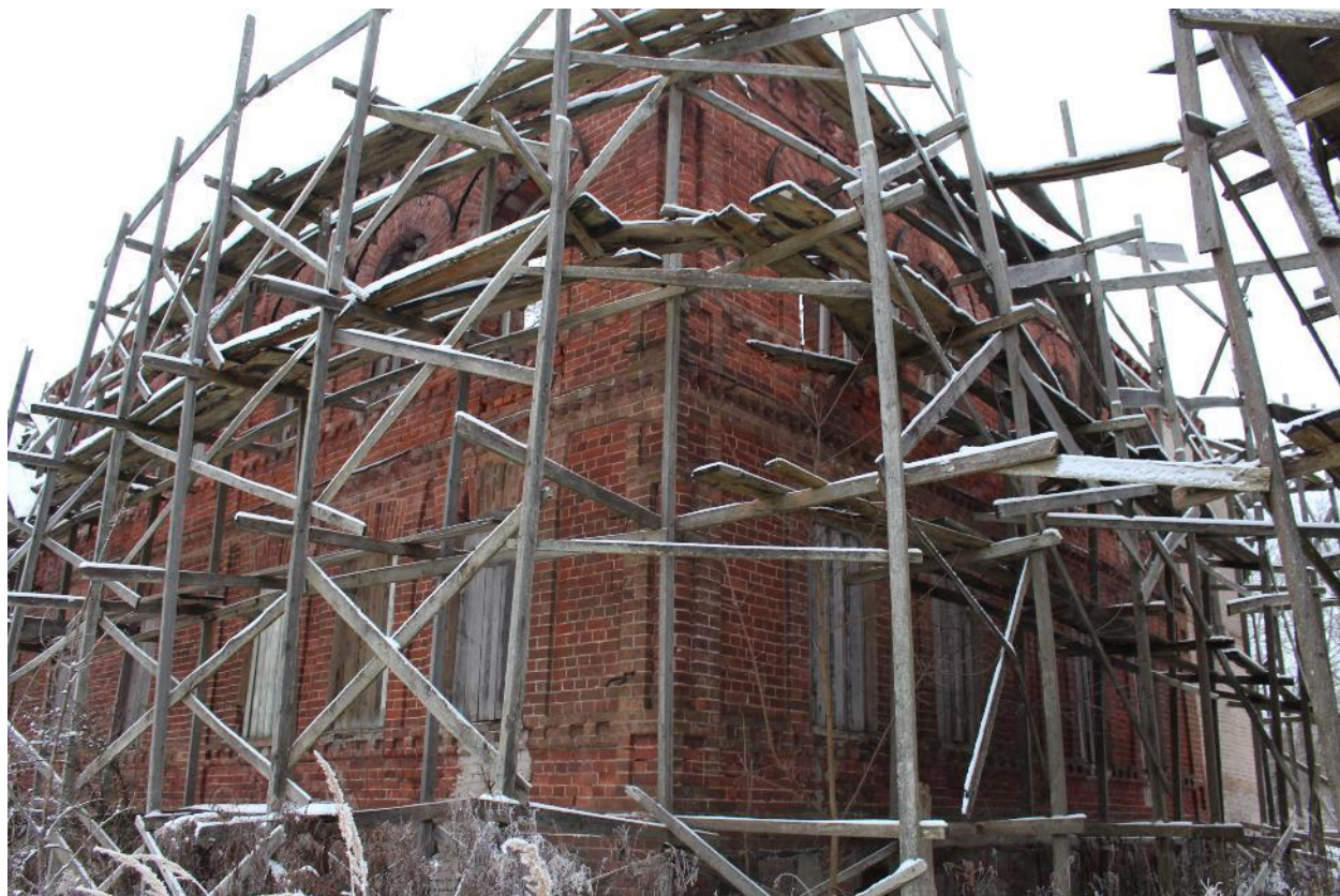
Фото 7. Вид дома у северо-западного угла.
