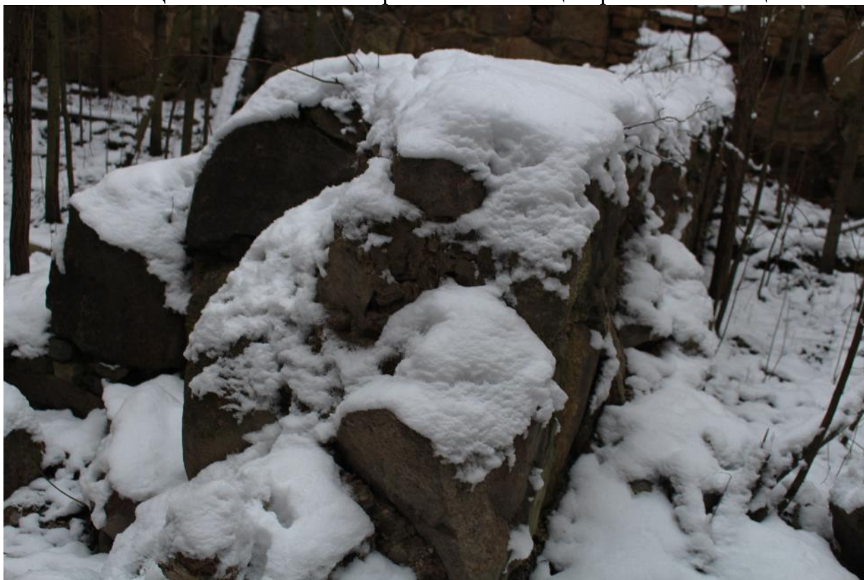
Фото 39. Кладка цокольной части поперечной стены.
