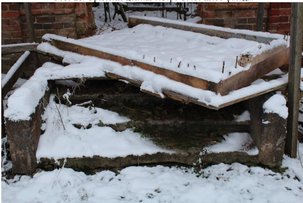
Фото 21. Крыльцо северо-восточного фасада.
