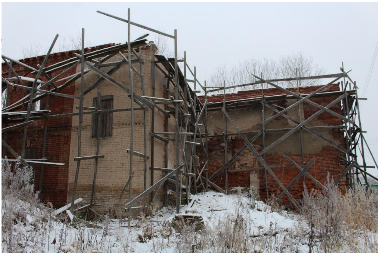
Фото 5. Юго-западный фасад, дворовой.
