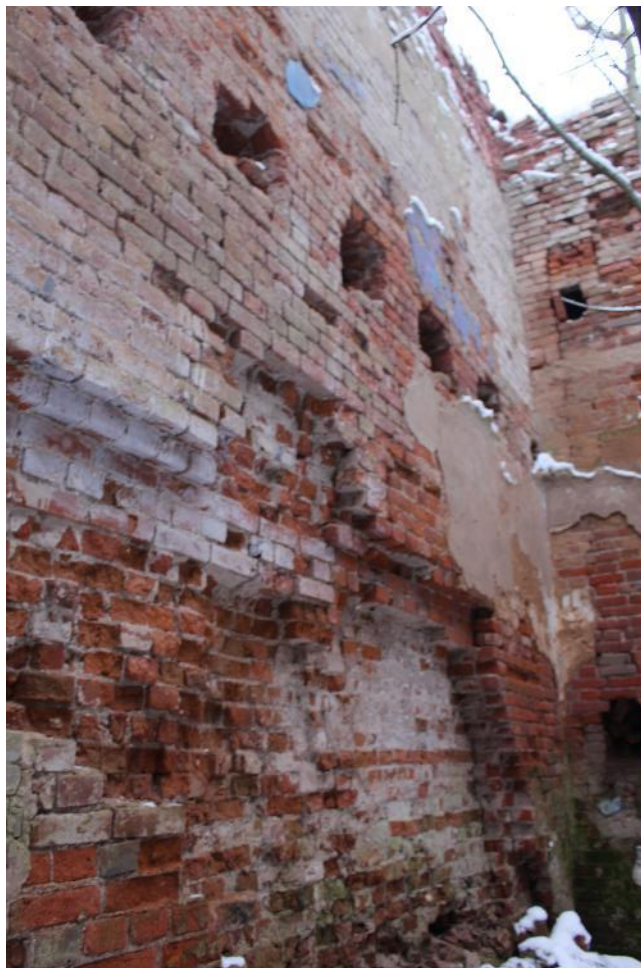
Фото 25. Фрагмент западной стены в южном помещении.
