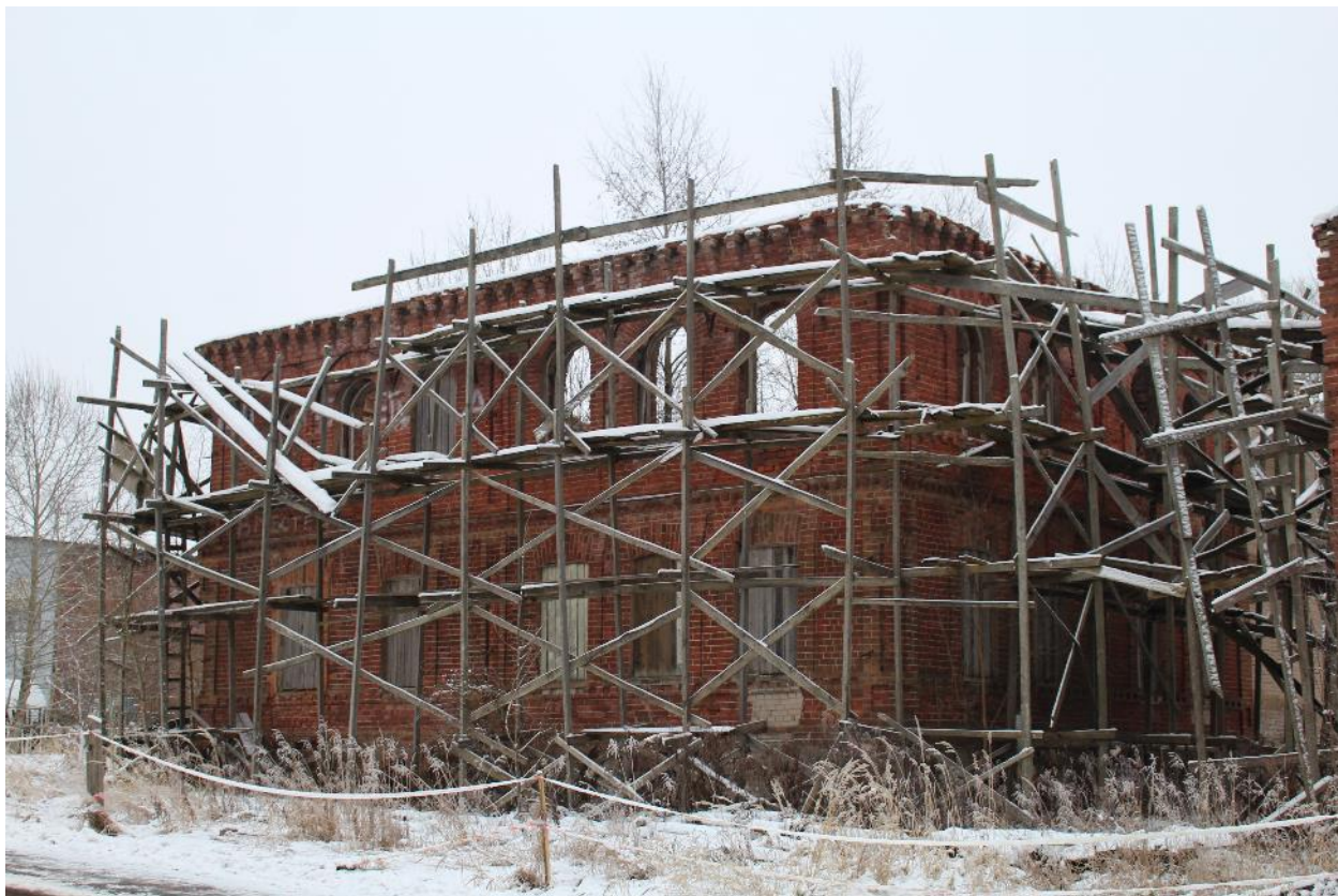
Фото 3. Общий вид дома 52Б с запада.
