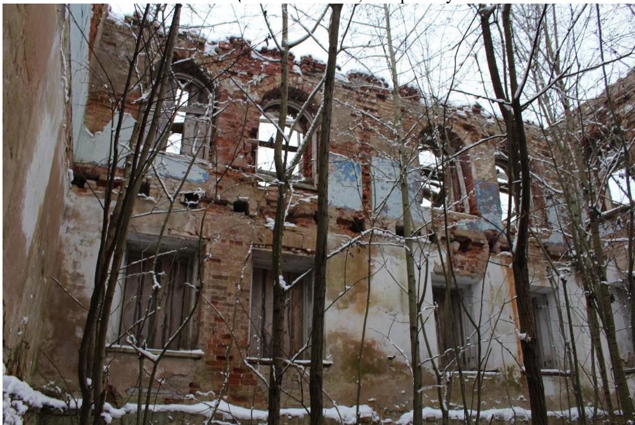
Фото 35. Западная стена центрального помещения.
