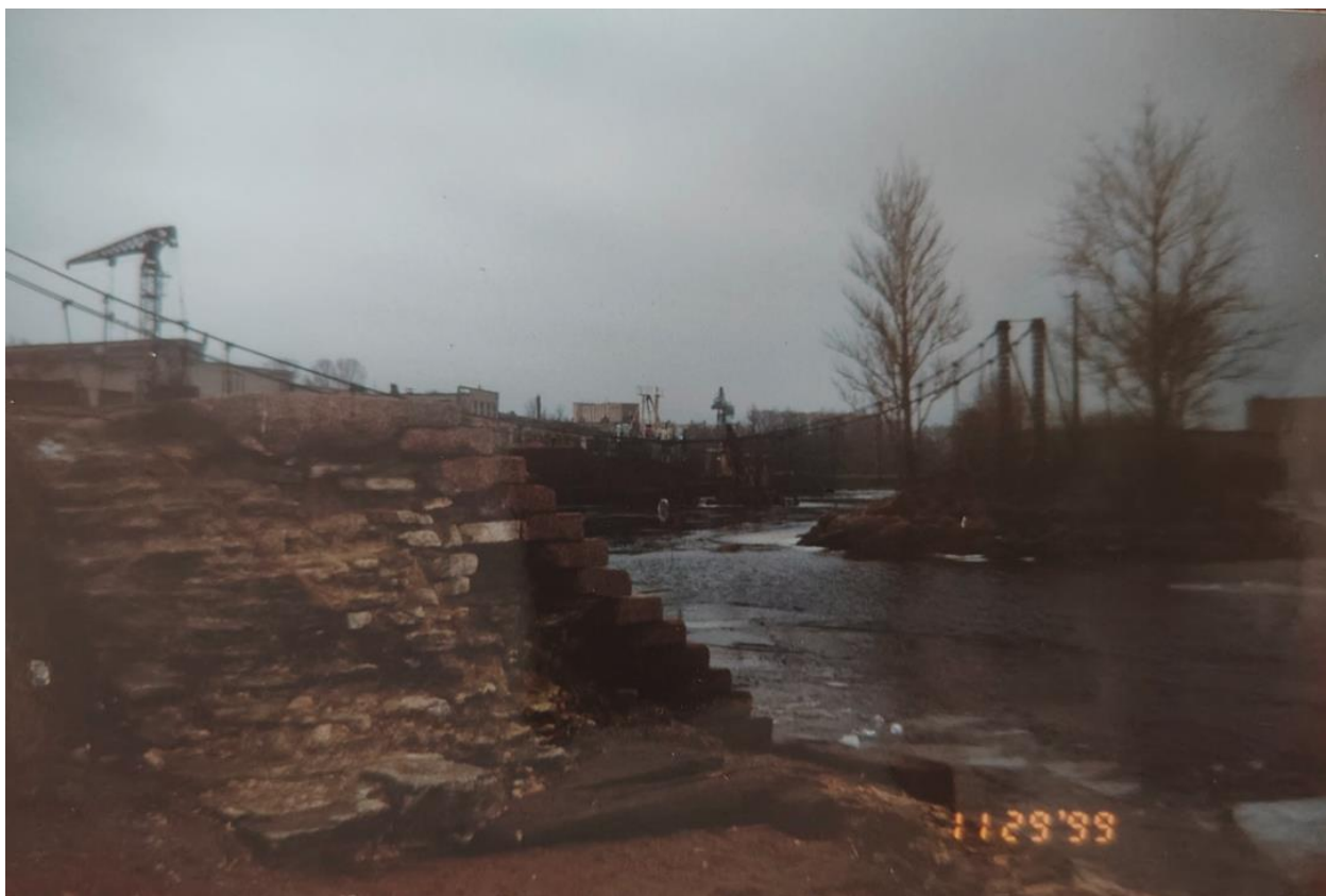
Илл. 18. Висячий (цепной) мост. Дата: 1999 г. Источник: архив Комитета по сохранению культурного наследия Ленинградской области (1614-5).
