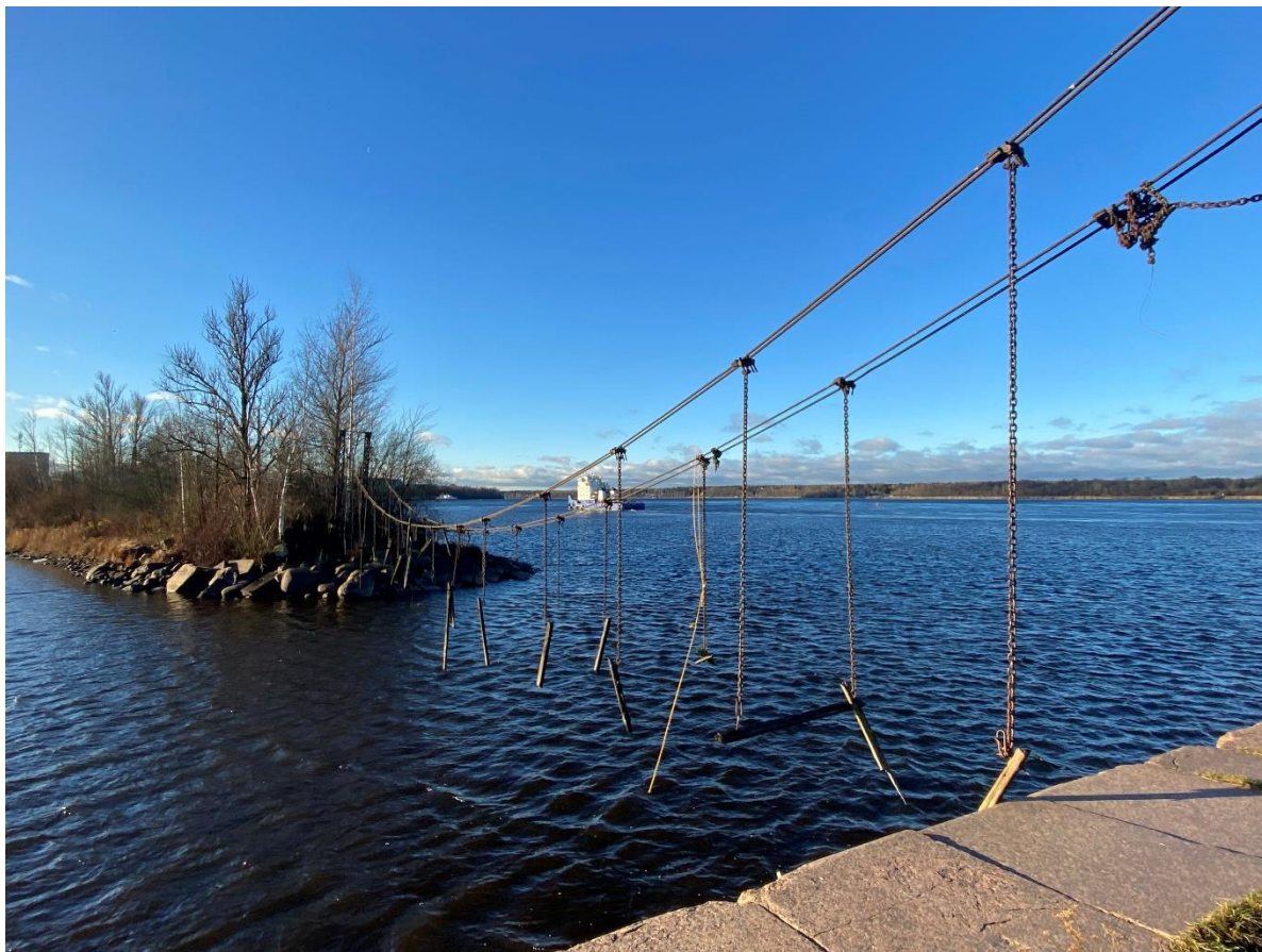
Фото 4. Вид на цепной мост с северо-востока.
