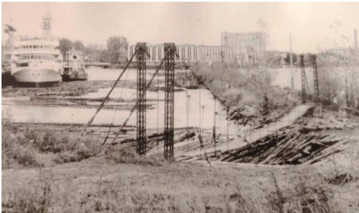
Вид на мост с материковой части. Дата: 1984 г.
