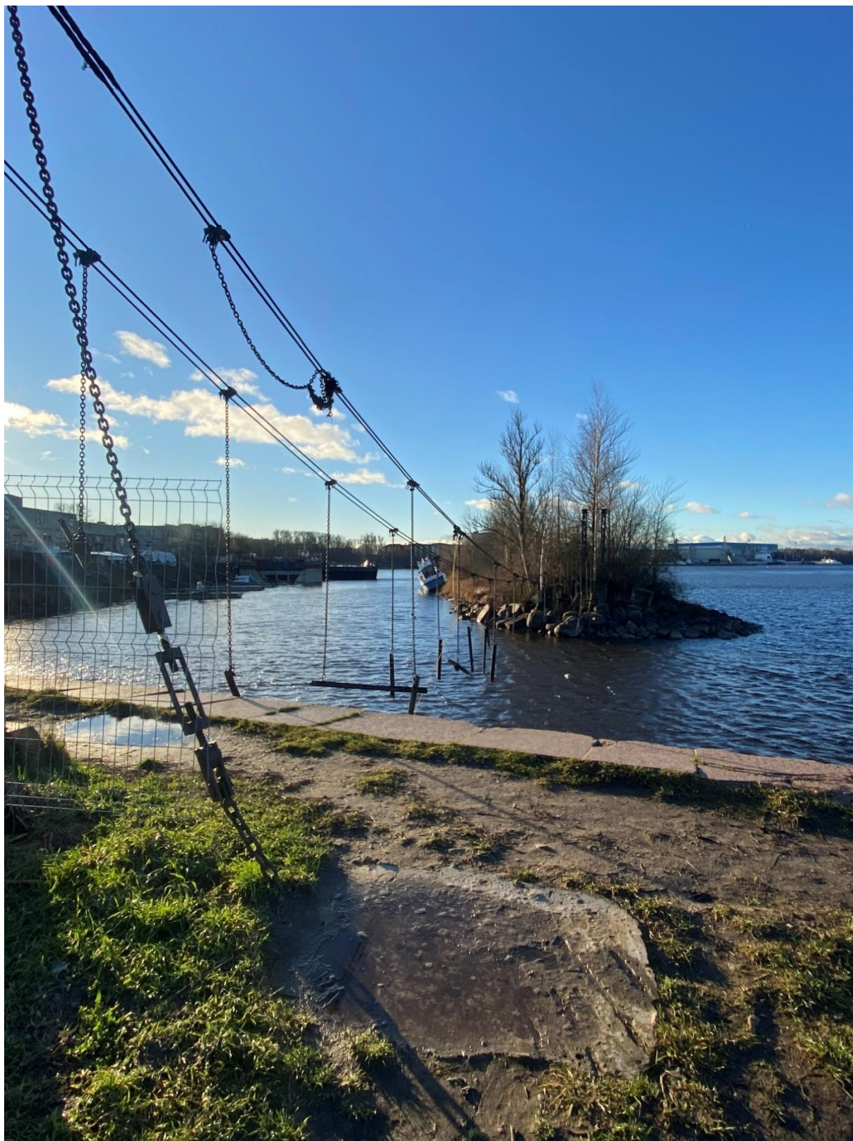
Фото 3. Вид на цепной мост и дамбу.
