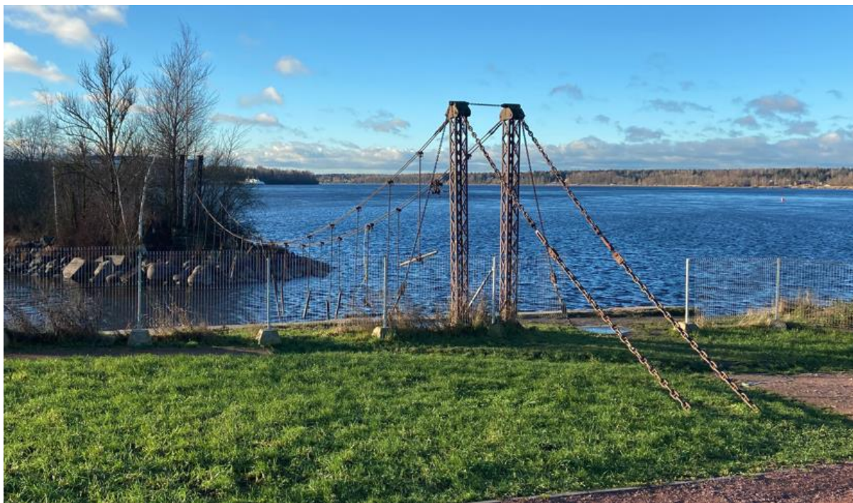
Вид на мост с материковой части. Дата: 14.11.2025.
