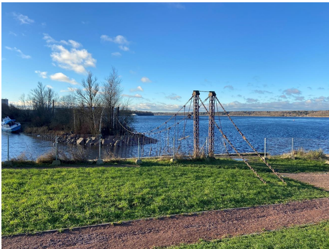
Фото 2. Вид на цепной мост с северо-востока.
