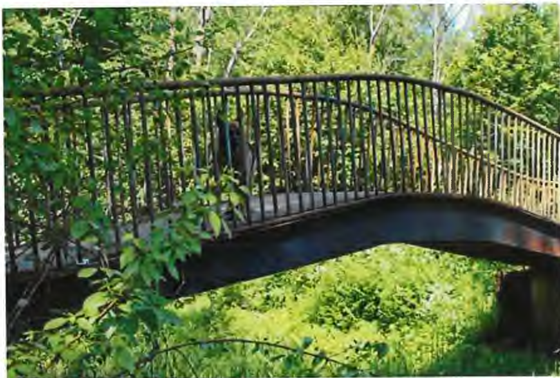
Фото 24-25. Мост "Кукольный" на круглый островок.
