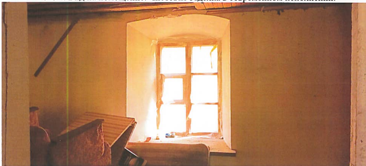
Фот 5. Вид на помещение. Чистовая отделка в современном исполнении.
