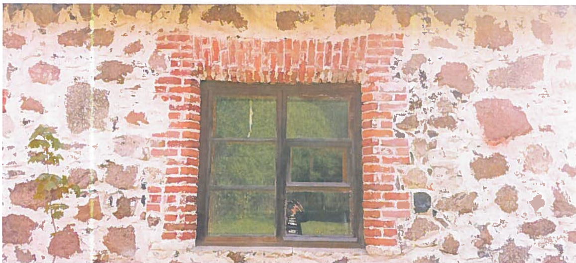
Фото 9. Вид на оконный проем западного фасада. Стены выполнены из крупных гранитных валунов, оконные проемы обрамлены кирпичной кладкой.
