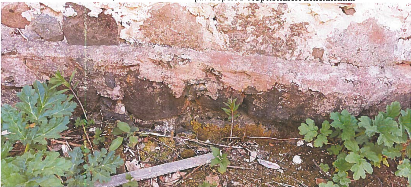
Фото 2. Вид на цоколь. Присутствуют вкрапления из гранитных валунов.
