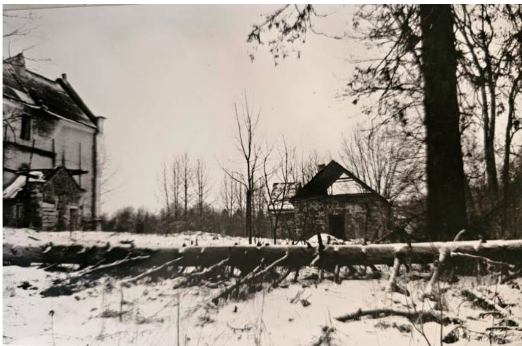
35. 614-1 ИНЭНКО РАН Проведение предварительного обследования Усадьбы Альбрехтов «Утешение» (Кингисеппского района) и составление тезисной программы для проведения комплексной реконструкции и плана первоочередных противоаварийных работ. Предварительное обследование. 1992г. То же. Господский дом со стороны главного подъезда.
