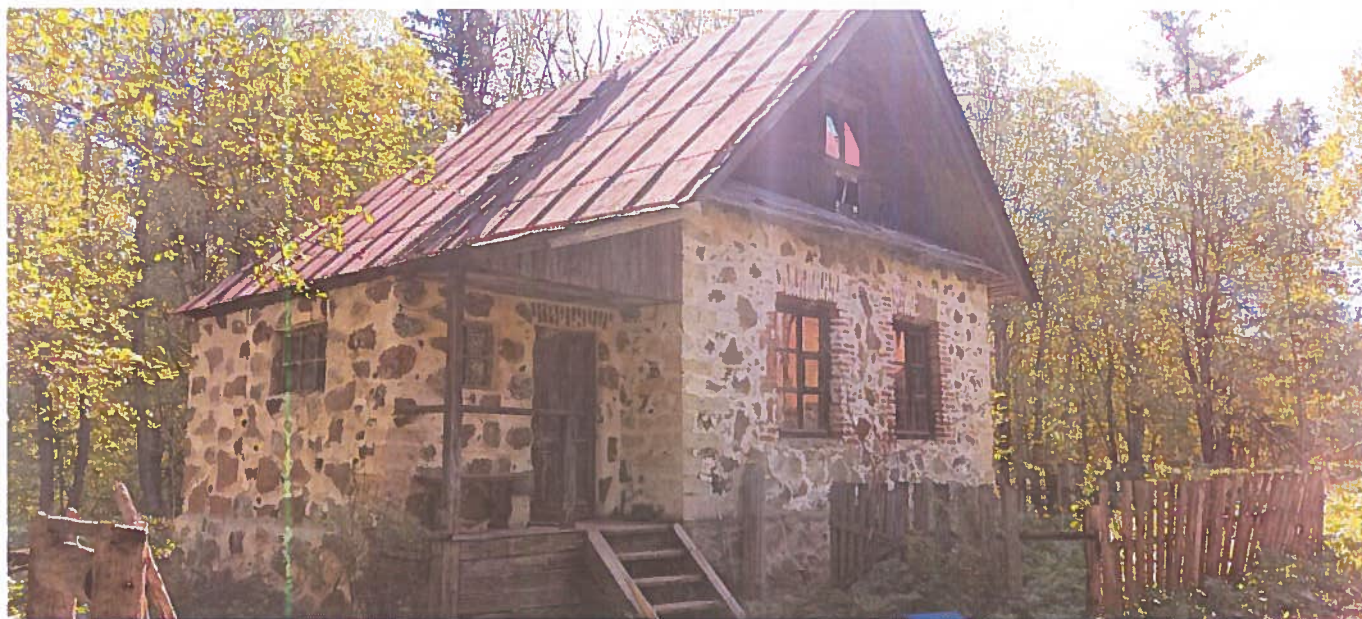
Фото 18. Общий вид с северо-запада.
