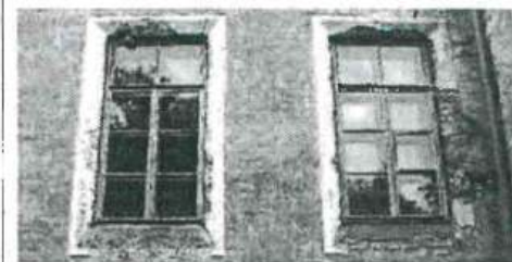
Оконные проемы 1-го этажа
