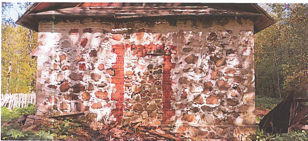
Фото 15. Фрагмент южного фасада. Стены выполнены из крупных гранитных валунов, оконные проемы обрамлены кирпичной кладкой. Углы здания выполнены из обработанных каменных блоков. Первоначальный дверной проем заложен.
