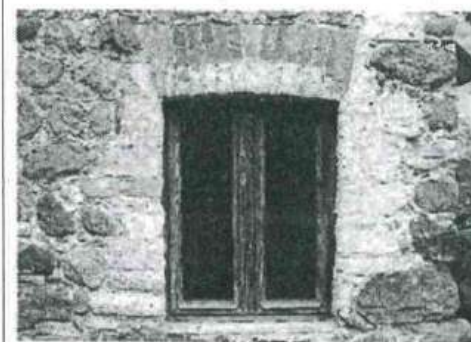
Оконный проем пристройки
