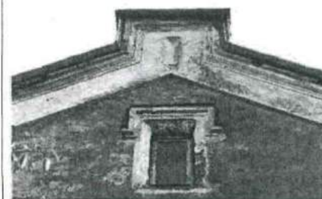
Оконный проем одноэтажного объема, северный фасад
