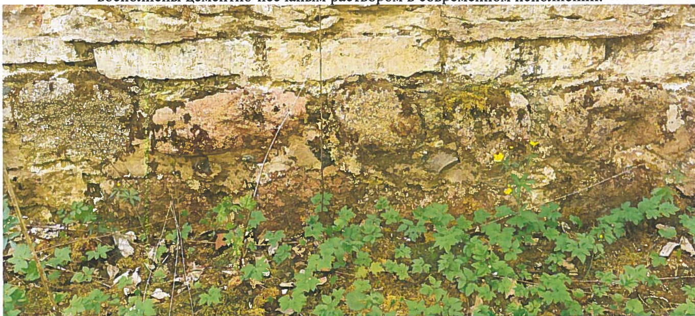
Фото 2. Вид на цоколь северного фасада. Материал цоколя – крупные каменные валуны без обработки на известково-песчаном связующем растворе, присутствуют вкрапления из гранитных валунов и каменных обработанных блоков.
