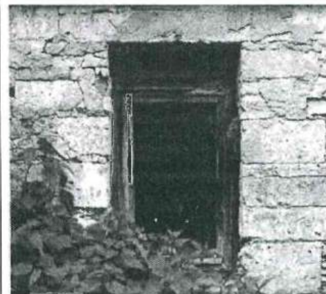
Оконные проемы цоколя террасы
