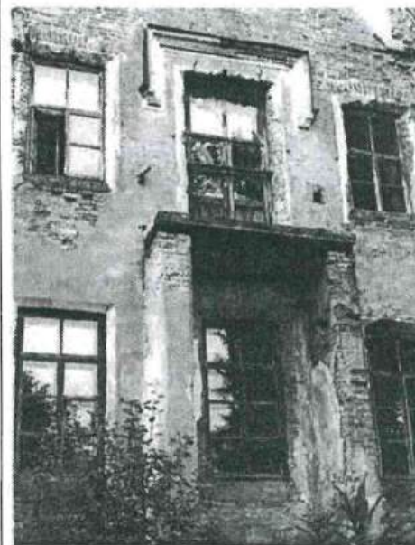
опоры для балкона
