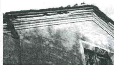
Венчающий карниз западного фасада
