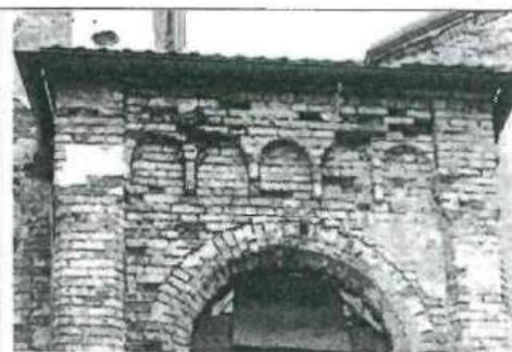
Лопатка и аркатурный пояс ризалита главного входа
