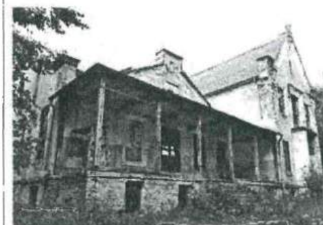
Терраса южного фасада
