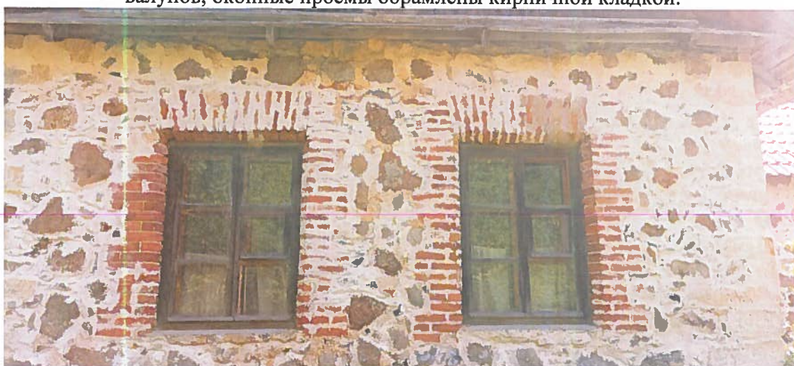
Фото 10. Вид на оконные проемы ризалита западного фасада. Стены выполнены из крупных гранитных валунов, оконные проемы обрамлены кирпичной кладкой. Углы здания выполнены из обработанных каменных блоков.
