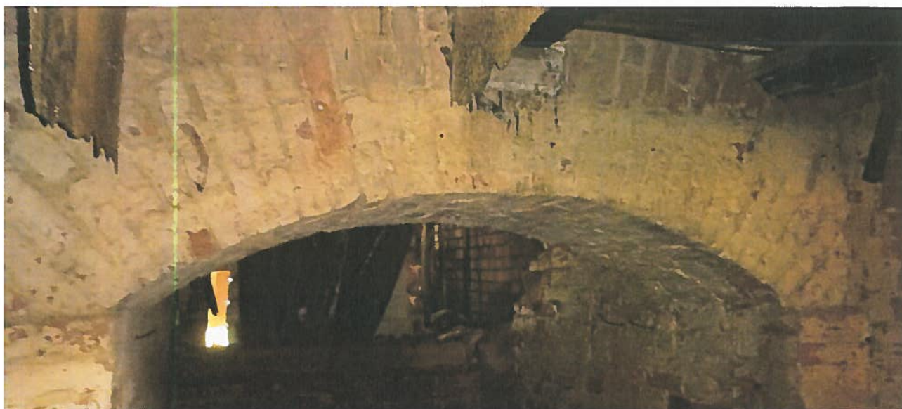
Фото 29. Арочная кирпичная перемычка проема подвального этажа.
