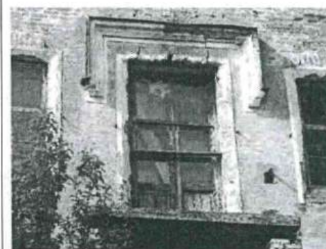
Проем выхода на балкон
