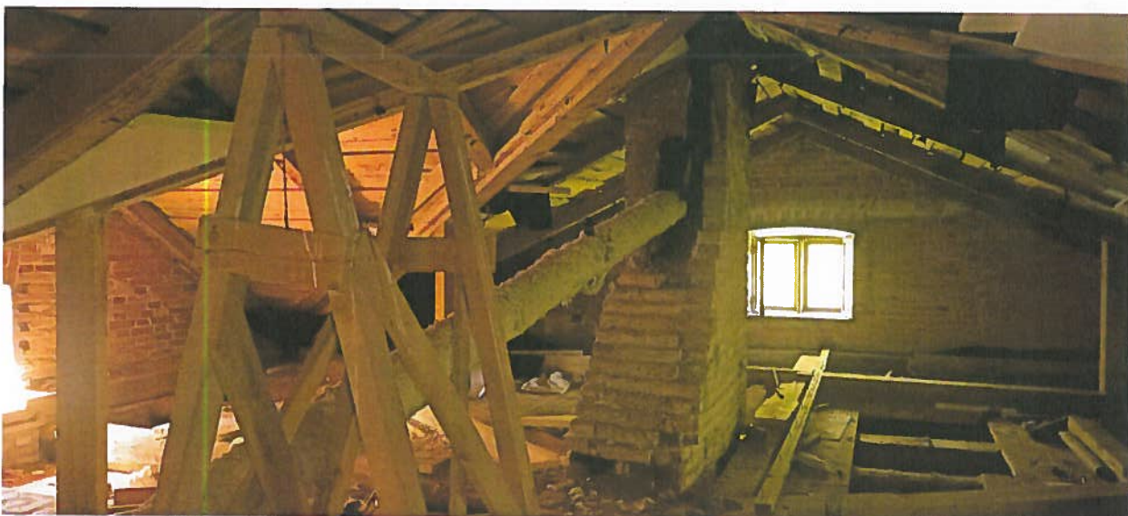
Фото 40. Вид на чердачное пространство над одноэтажной частью здания. Конструкция кровли – деревянная стропильная система.
