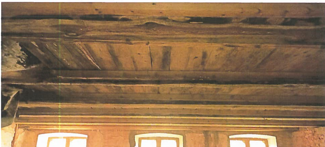
Фото 38. Вид на перекрытие между подвальным и 1 этажами со стороны подвала.
