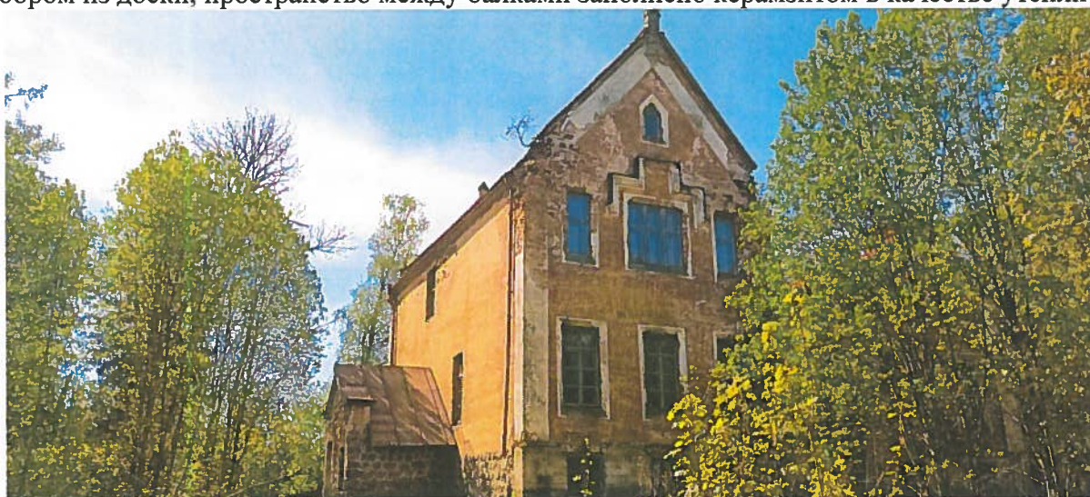
Фото 45. Общий вид на двухэтажную часть здания с северной стороны.
