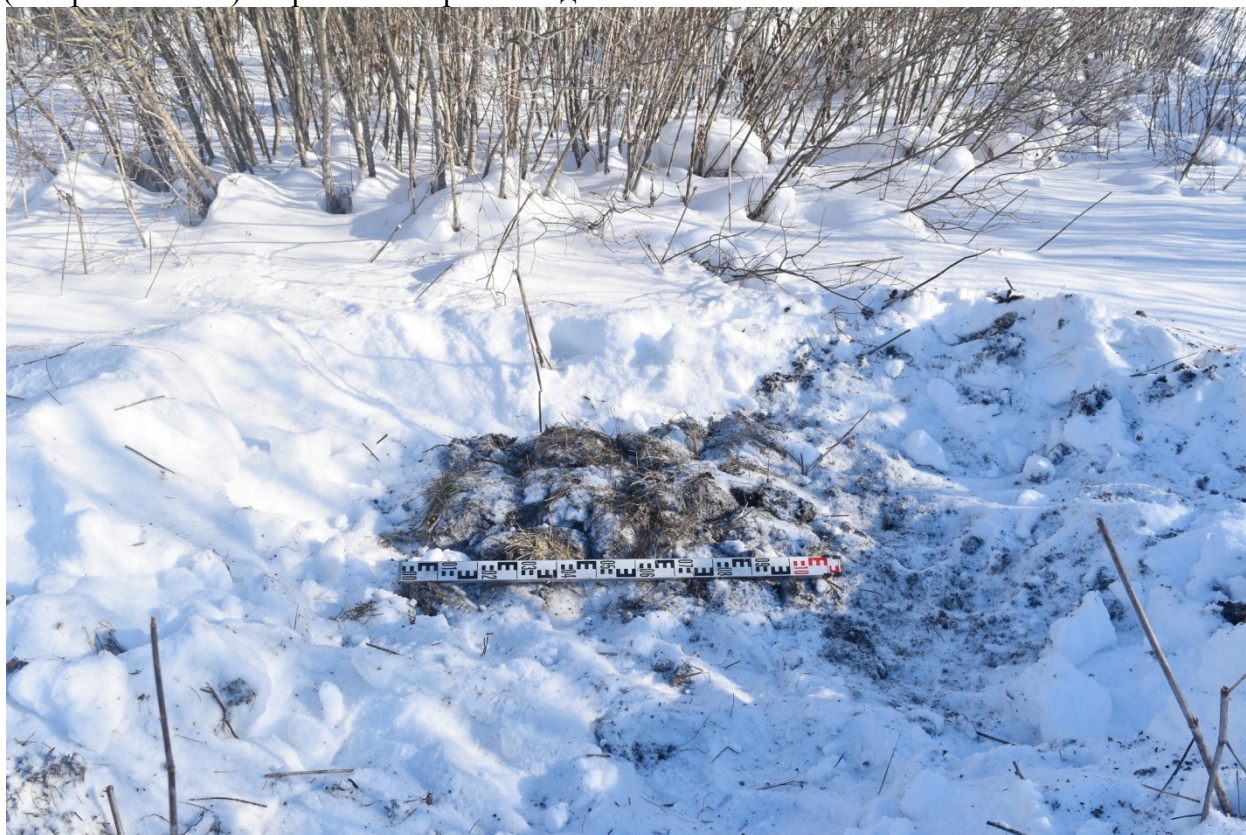
Рис. 59. Ленинградская обл., Ломоносовский р-н, Низино-2026. Шурф 2 после рекультивации. Вид с юга.
