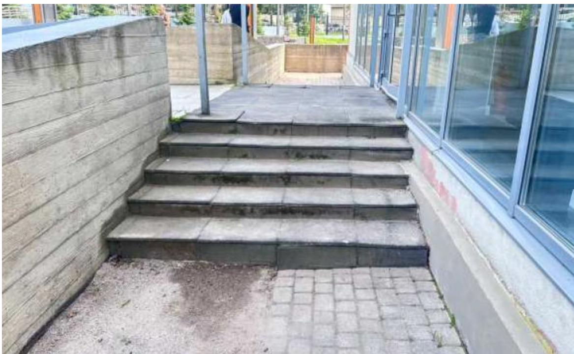
Илл 4. Общий вид входной группы здания в осях «А-В/1»
