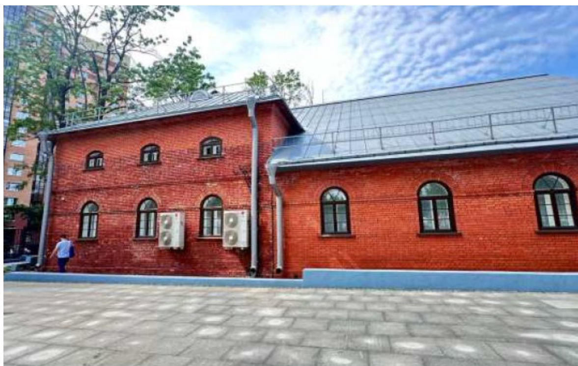
Илл 2. Общий вид здания в осях «І-9/В»
