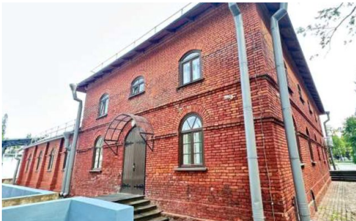
Илл 3. Общий вид здания в осях «А/6-9»
