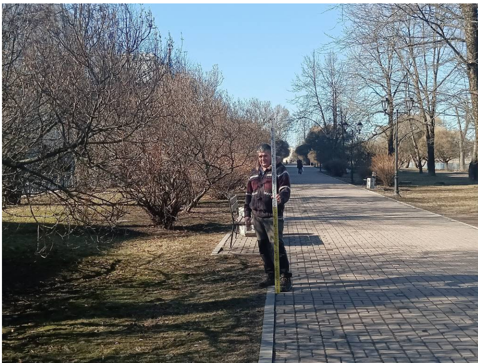
Фото 3. «Наружный газопровод до границ земельного участка, расположенного по адресу: Российская Федерация, Ленинградская область, муниципальный район Выборгский, г. Выборг, ул. Подгорная, д. 14/7 (47:01:0107001:2957). Точка фотофиксации 1. Общий вид на трассу проектируемого газопровода с ЮВ.
