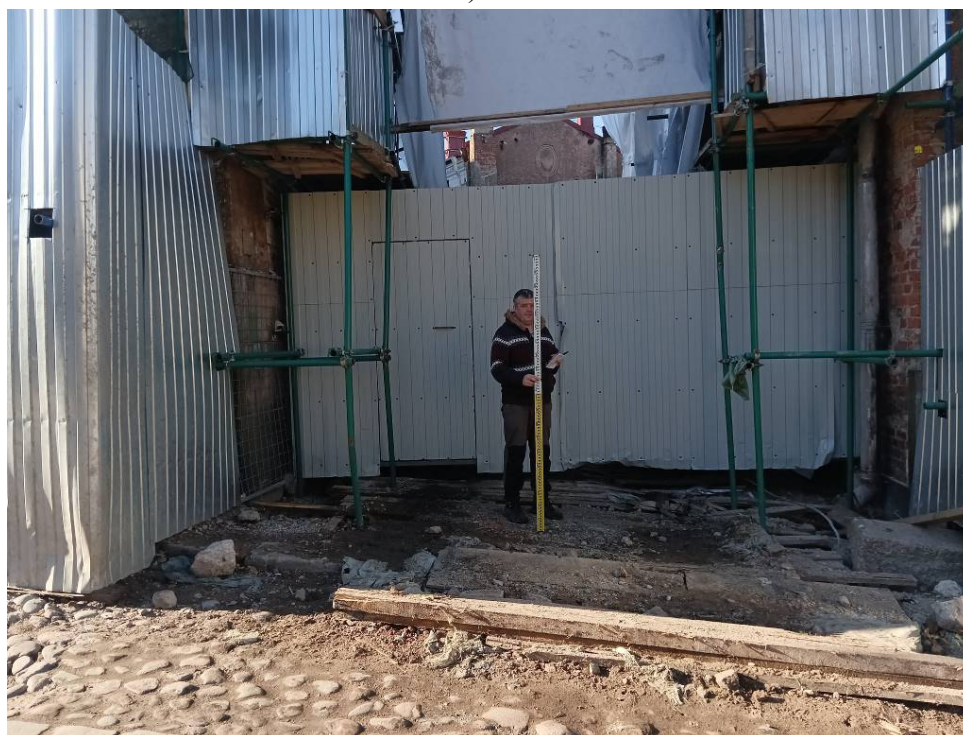
Фото 26. «Наружный газопровод до границ земельного участка, расположенного по адресу: Российская Федерация, Ленинградская область, муниципальный район Выборгский, г. Выборг, ул. Подгорная, д. 14/7 (47:01:0107001:2957). Точка фотофиксации 10. Общий вид на трассу проектируемого газопровода проходящий в воротах во двор ОКН «Здание фирмы «Хаакмен и К» (идет реставрация) с ЮВ.
