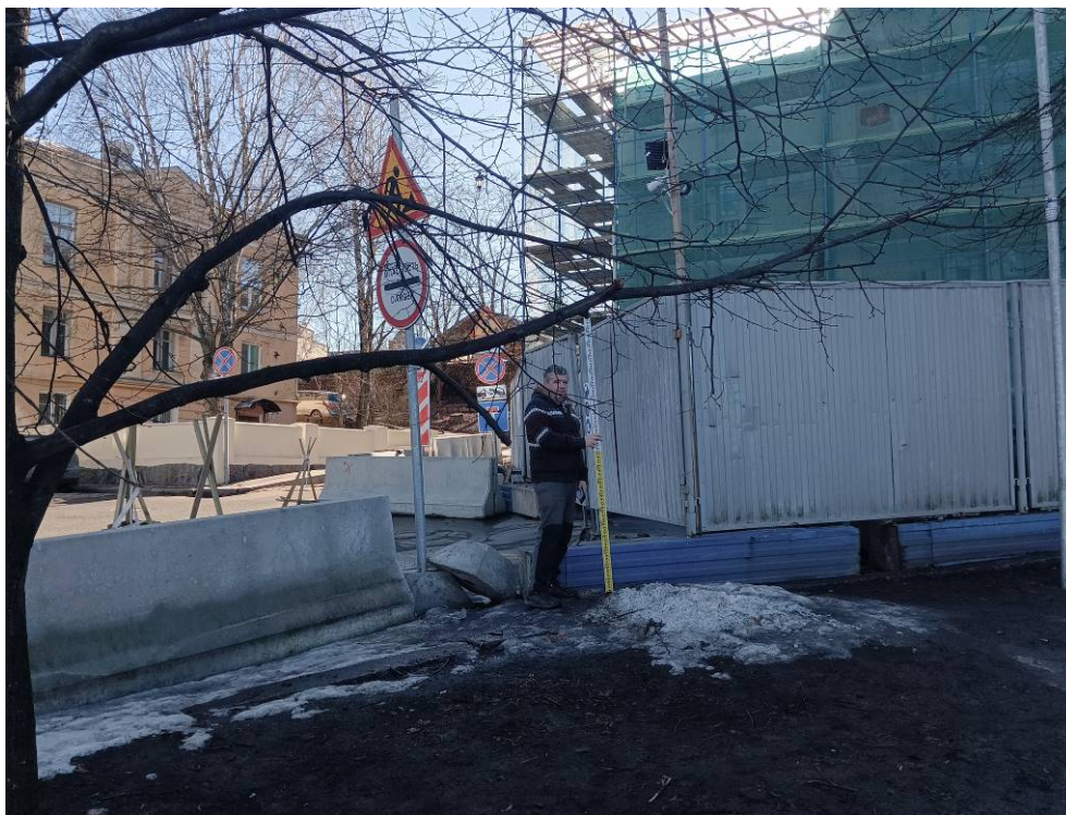
Фото 23. «Наружный газопровод до границ земельного участка, расположенного по адресу: Российская Федерация, Ленинградская область, муниципальный район Выборгский, г. Выборг, ул. Подгорная, д. 14/7 (47:01:0107001:2957). Точка фотофиксации 8. Общий вид на трассу проектируемого газопровода и ОКН «Здание фирмы «Хаакмен и К» (идет реставрация) с С.
