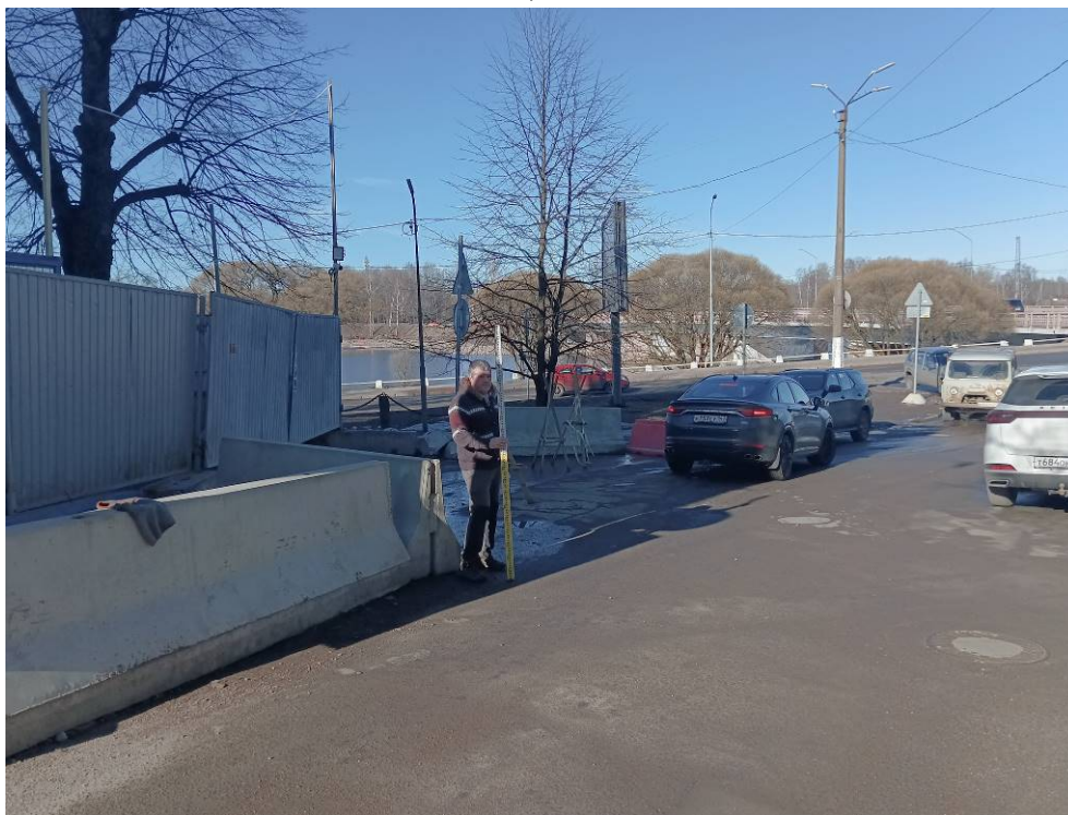
Фото 24. «Наружный газопровод до границ земельного участка, расположенного по адресу: Российская Федерация, Ленинградская область, муниципальный район Выборгский, г. Выборг, ул. Подгорная, д. 14/7 (47:01:0107001:2957). Точка фотофиксации 9. Общий вид на трассу проектируемого газопровода с Ю.
