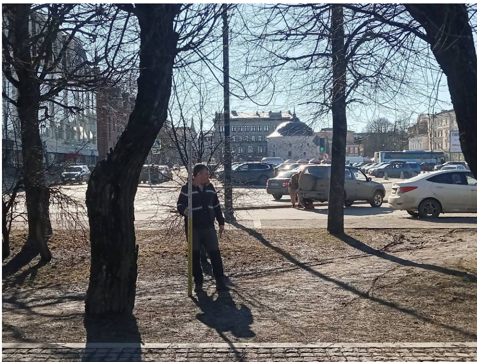
Фото 5. «Наружный газопровод до границ земельного участка, расположенного по адресу: Российская Федерация, Ленинградская область, муниципальный район Выборгский, г. Выборг, ул. Подгорная, д. 14/7 (47:01:0107001:2957). Точка фотофиксации 2. Общий вид в сторону ОК(А)Н «Культурный слой средневекового Выборга» от трассы проектируемого газопровода с СВ.
