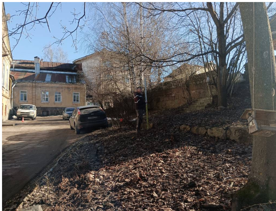
Фото 31. «Наружный газопровод до границ земельного участка, расположенного по адресу: Российская Федерация, Ленинградская область, муниципальный район Выборгский, г. Выборг, ул. Подгорная, д. 14/7 (47:01:0107001:2957). Точка фотофиксации 12. Общий вид на трассу проектируемого газопровода с ЗСЗ.
