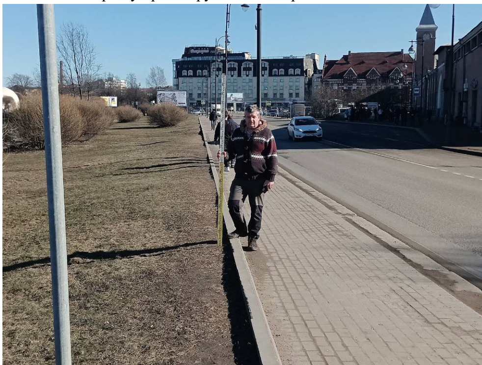
Фото 12. «Наружный газопровод до границ земельного участка, расположенного по адресу: Российская Федерация, Ленинградская область, муниципальный район Выборгский, г. Выборг, ул. Подгорная, д. 14/7 (47:01:0107001:2957). Точка фотофиксации 4. Общий вид на трассу проектируемого газопровода с ЗСЗ.
