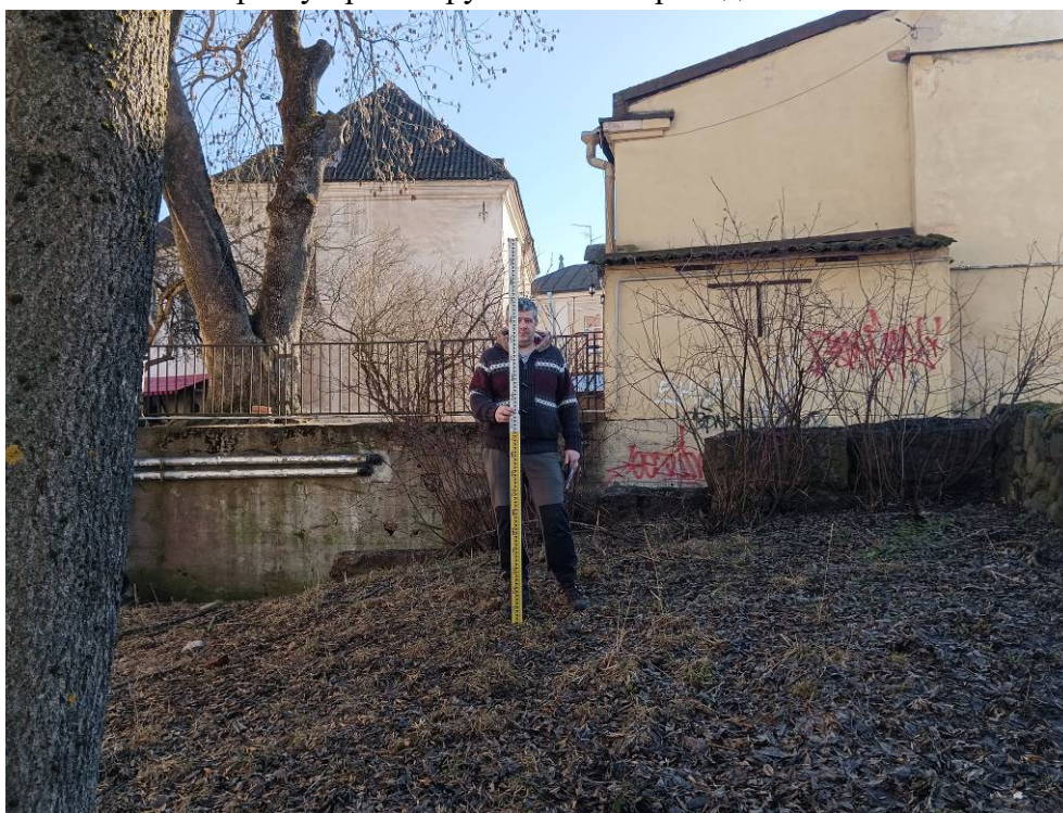
Фото 36. «Наружный газопровод до границ земельного участка, расположенного по адресу: Российская Федерация, Ленинградская область, муниципальный район Выборгский, г. Выборг, ул. Подгорная, д. 14/7 (47:01:0107001:2957). Точка фотофиксации 15. Общий вид на трассу проектируемого газопровода и место установки ПРГ с ССВ.
