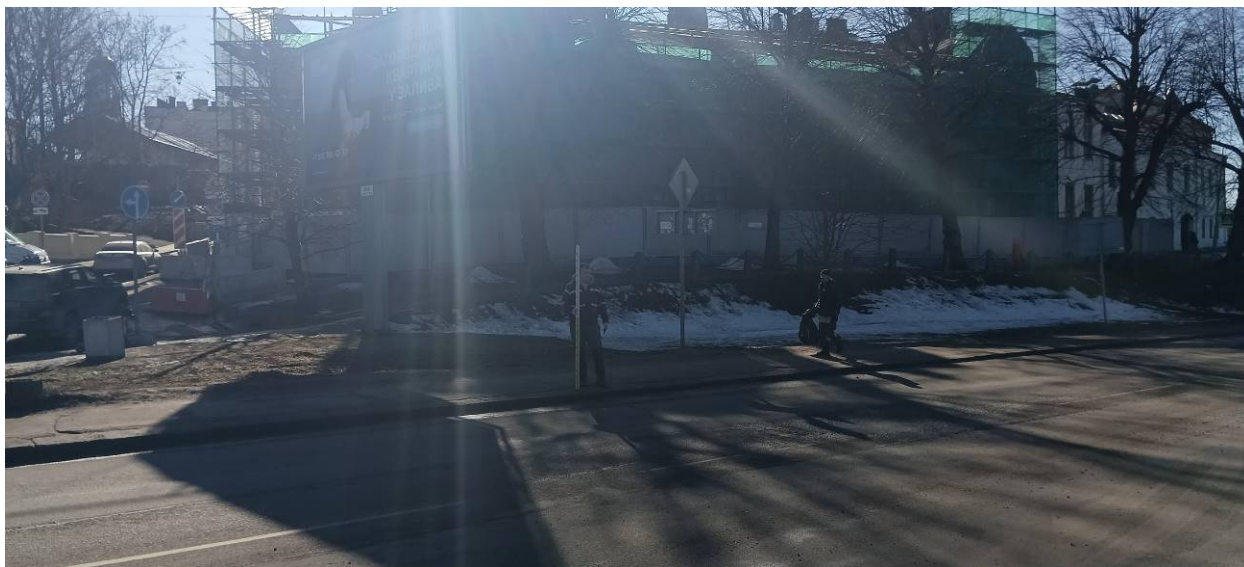
Фото 19. «Наружный газопровод до границ земельного участка, расположенного по адресу: Российская Федерация, Ленинградская область, муниципальный район Выборгский, г. Выборг, ул. Подгорная, д. 14/7 (47:01:0107001:2957). Точка фотофиксации 6. Общий вид на ОКН «Здание фирмы «Хаакмен и К» (идет реставрация) с ССВ.
