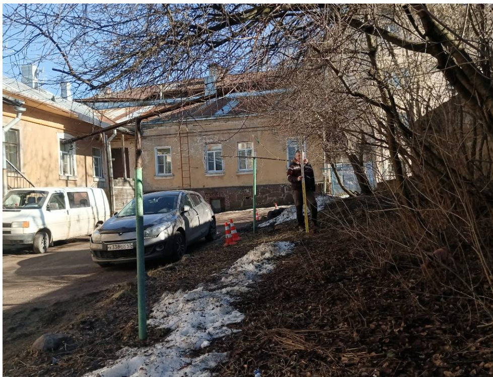
Фото 35. «Наружный газопровод до границ земельного участка, расположенного по адресу: Российская Федерация, Ленинградская область, муниципальный район Выборгский, г. Выборг, ул. Подгорная, д. 14/7 (47:01:0107001:2957). Точка фотофиксации 14. Общий вид на трассу проектируемого газопровода с ЗСЗ.
