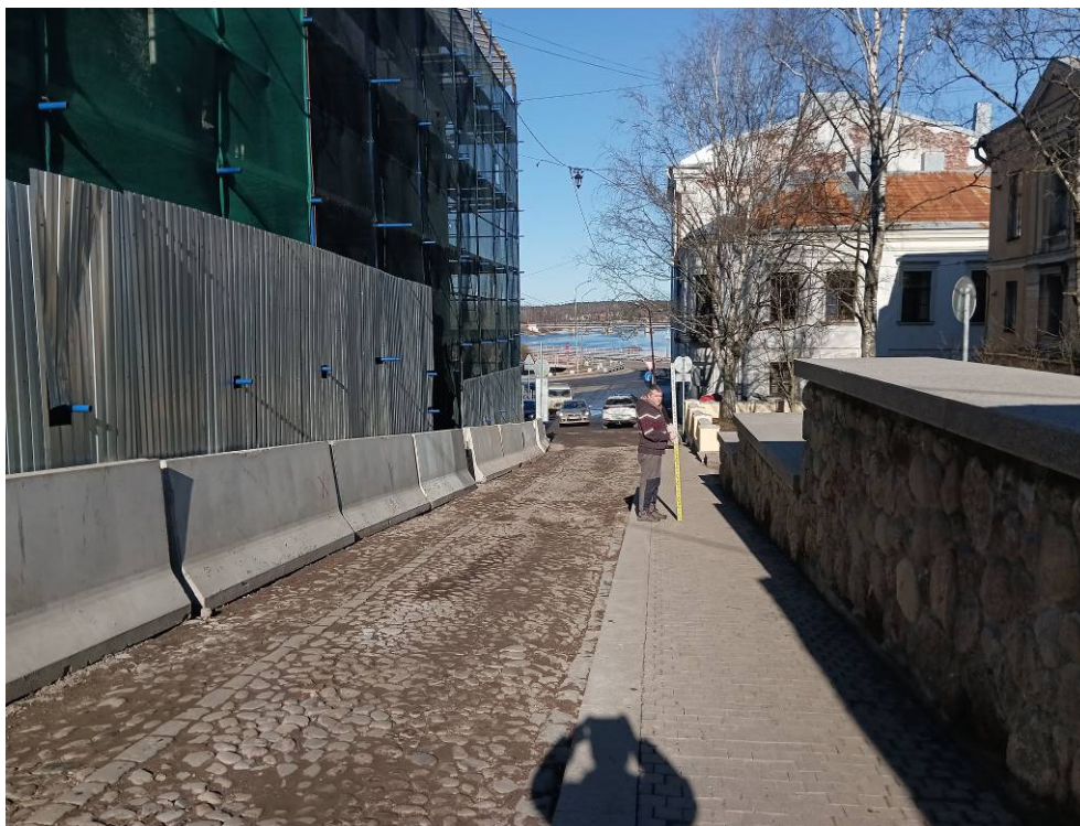
Фото 27. «Наружный газопровод до границ земельного участка, расположенного по адресу: Российская Федерация, Ленинградская область, муниципальный район Выборгский, г. Выборг, ул. Подгорная, д. 14/7 (47:01:0107001:2957). Точка фотофиксации 10. Общий вид на трассу проектируемого газопровода и ОКН «Здание фирмы «Хаакмен и К» (идет реставрация) с Ю.
