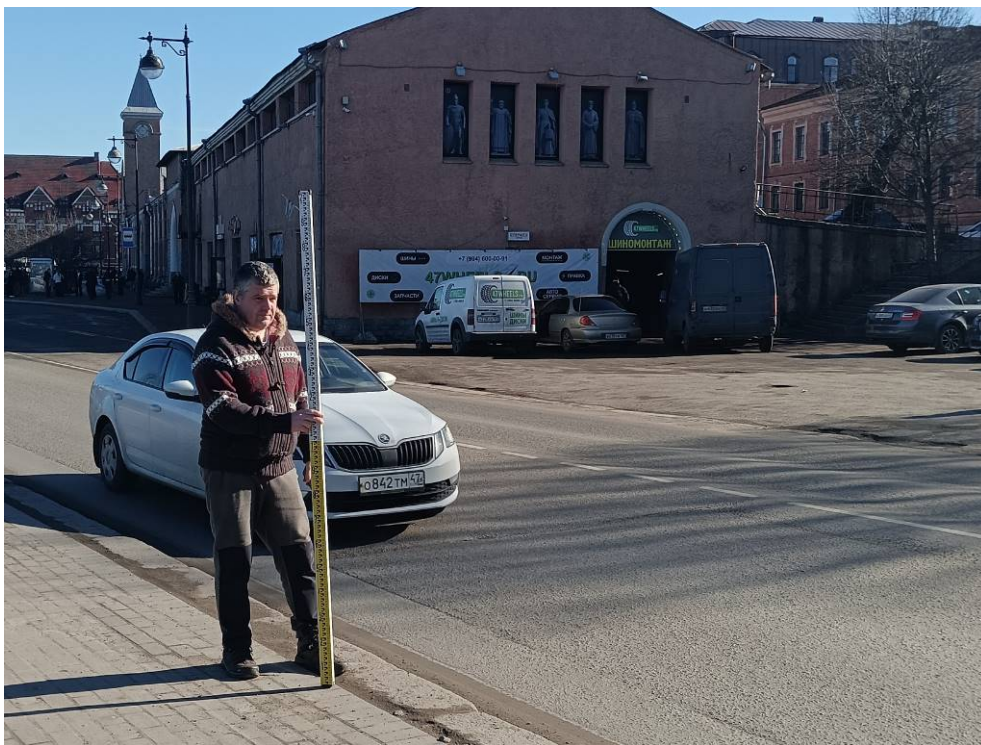
Фото 13. «Наружный газопровод до границ земельного участка, расположенного по адресу: Российская Федерация, Ленинградская область, муниципальный район Выборгский, г. Выборг, ул. Подгорная, д. 14/7 (47:01:0107001:2957). Точка фотофиксации 3. Общий вид в сторону ОК(А)Н «Культурный слой средневекового Выборга» от трассы проектируемого газопровода с ССЗ.
