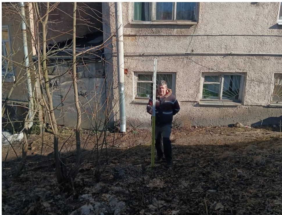
Фото 37. «Наружный газопровод до границ земельного участка, расположенного по адресу: Российская Федерация, Ленинградская область, муниципальный район Выборгский, г. Выборг, ул. Подгорная, д. 14/7 (47:01:0107001:2957). Точка фотофиксации 15. Общий вид на трассу проектируемого газопровода и место установки ПРГ с ЗСЗ.
