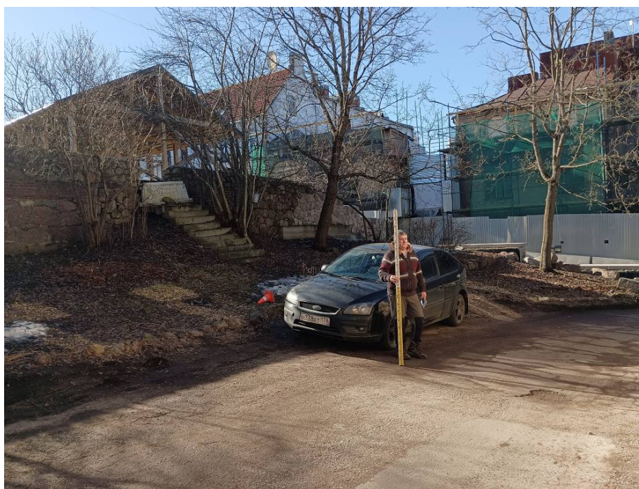
Фото 32. «Наружный газопровод до границ земельного участка, расположенного по адресу: Российская Федерация, Ленинградская область, муниципальный район Выборгский, г. Выборг, ул. Подгорная, д. 14/7 (47:01:0107001:2957). Точка фотофиксации 13. Общий вид на трассу проектируемого газопровода с В.
