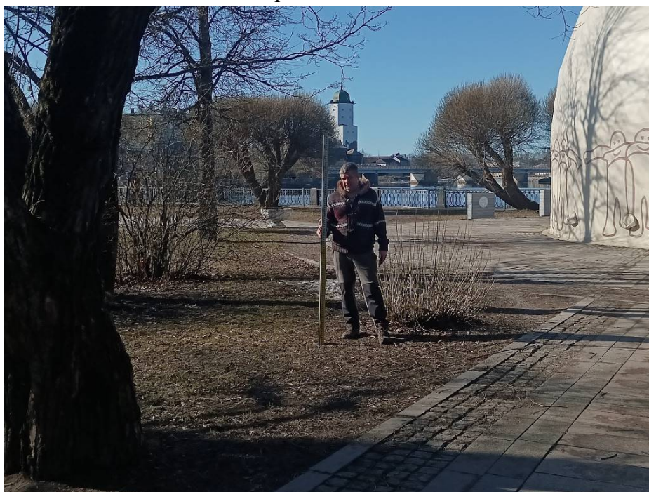
Фото 8. «Наружный газопровод до границ земельного участка, расположенного по адресу: Российская Федерация, Ленинградская область, муниципальный район Выборгский, г. Выборг, ул. Подгорная, д. 14/7 (47:01:0107001:2957). Точка фотофиксации 2. Общий вид на трассу проектируемого газопровода с В.
