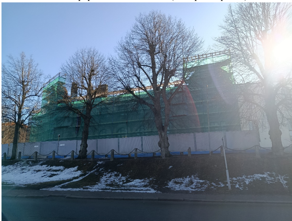
Фото 20. «Наружный газопровод до границ земельного участка, расположенного по адресу: Российская Федерация, Ленинградская область, муниципальный район Выборгский, г. Выборг, ул. Подгорная, д. 14/7 (47:01:0107001:2957). Точка фотофиксации 7. Общий вид на ОКН «Здание фирмы «Хаакмен и К» (идет реставрация) с С.
