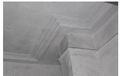
Помещение в южной части
