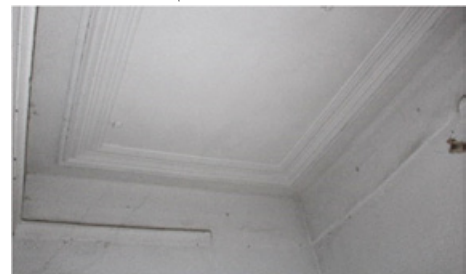
Помещение в северной части
