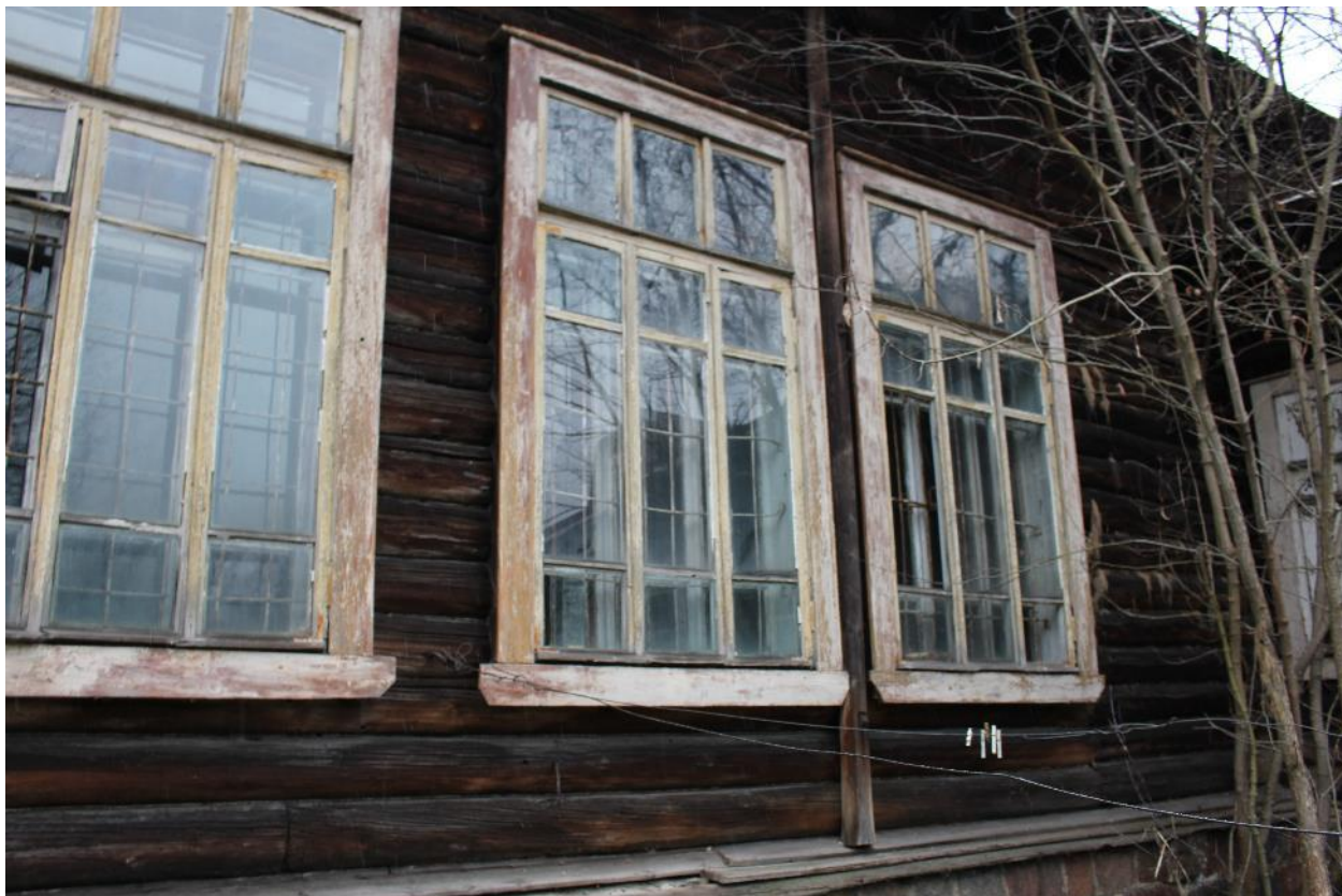
15. Фрагмент восточного фасада.
