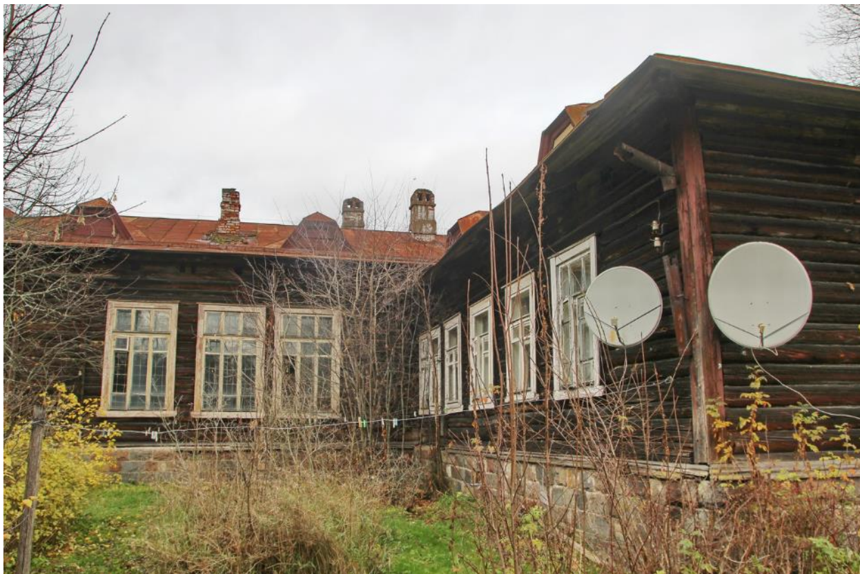
Илл. 74. Здание вокзала на станции Паша. 19.10.2021 г. Фото М. Ивановой. [Электронный ресурс] // URL: https://vk.com/photo-2701359_457268146 .
