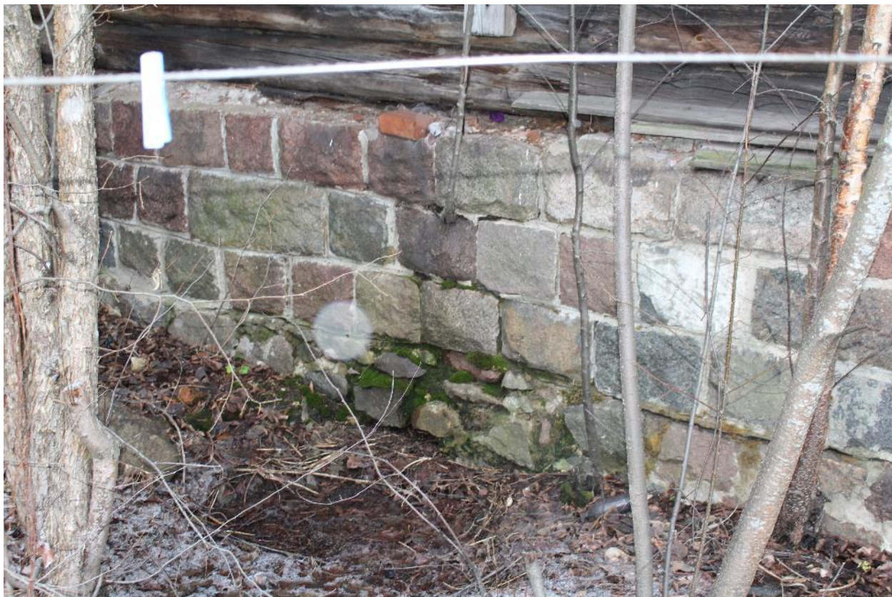
13. Фрагмент цоколя дворового фасада.
