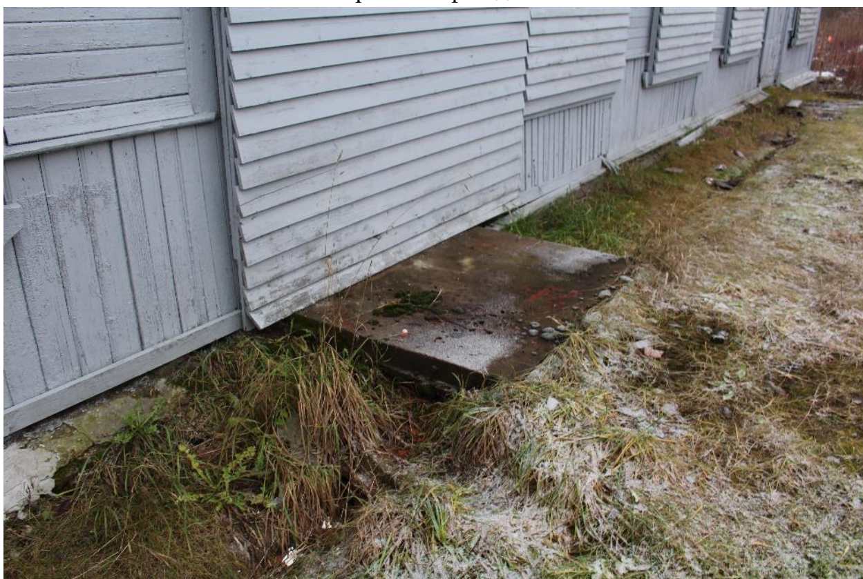
10. Цоколь и вход с западной лицевой стороны.
