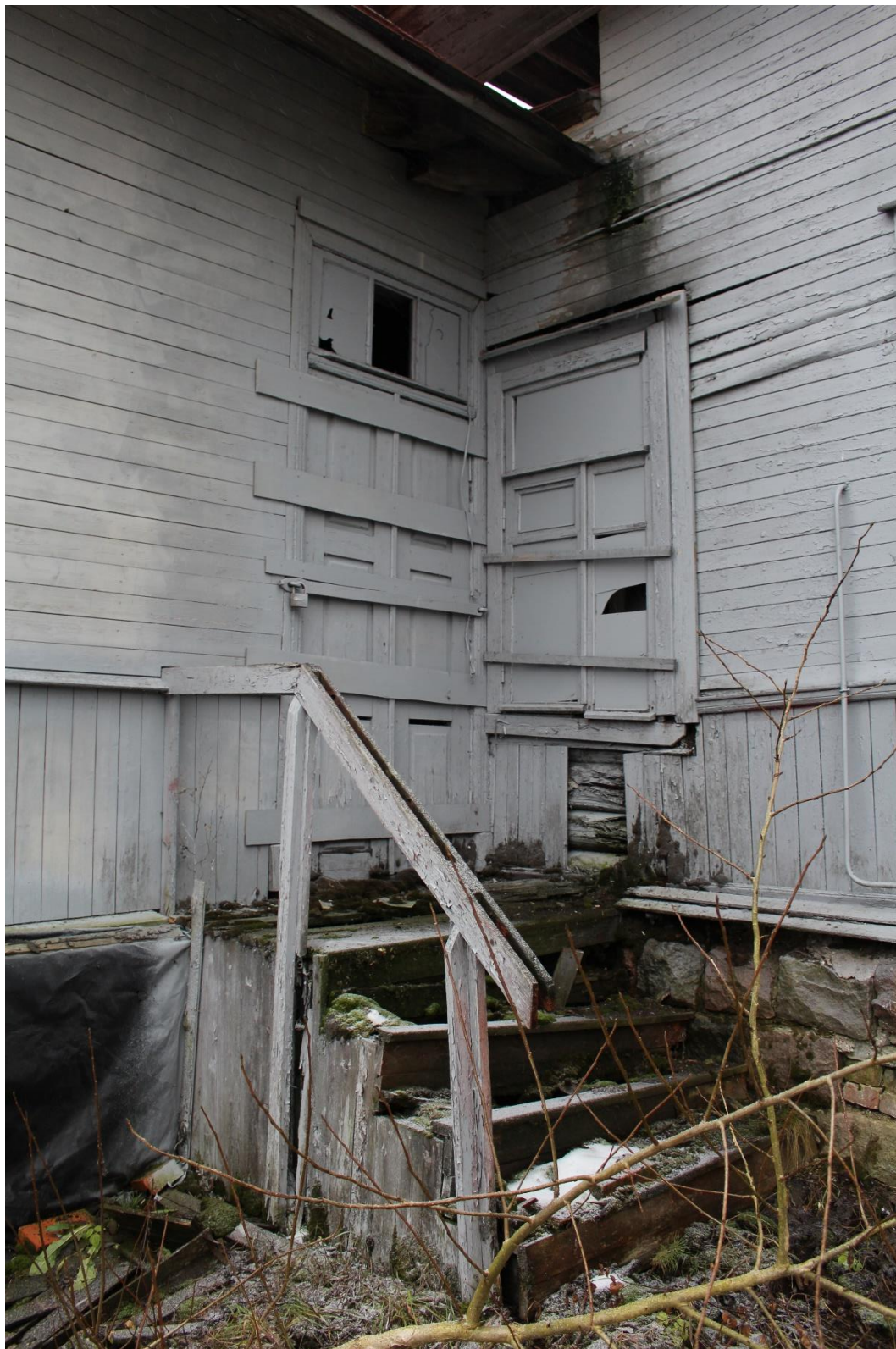
17. Крыльцо на севере.
