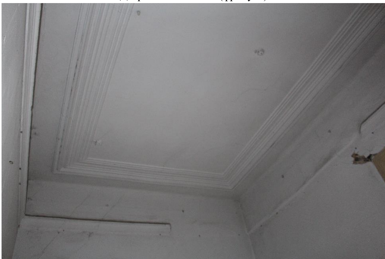
36. Фрагмент потолка помещения во дворе.
