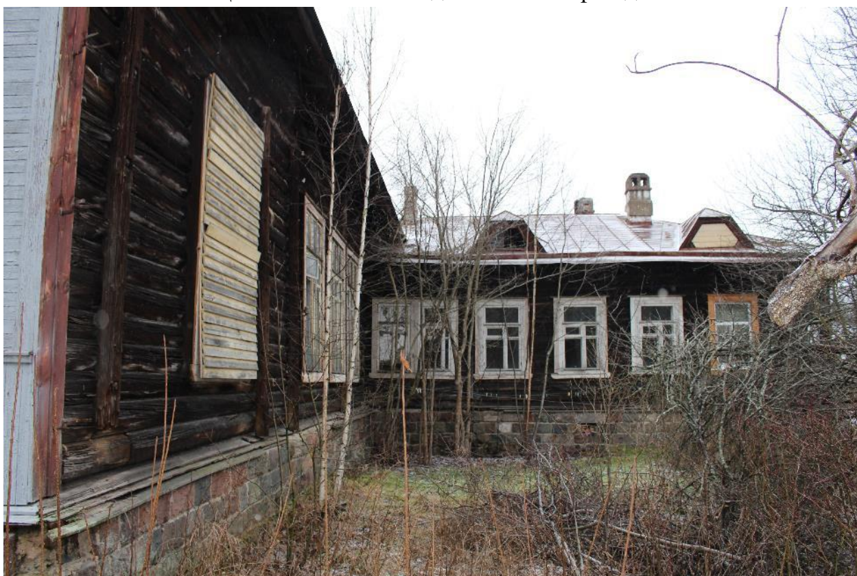
12. Вид дворовых фасадов.
