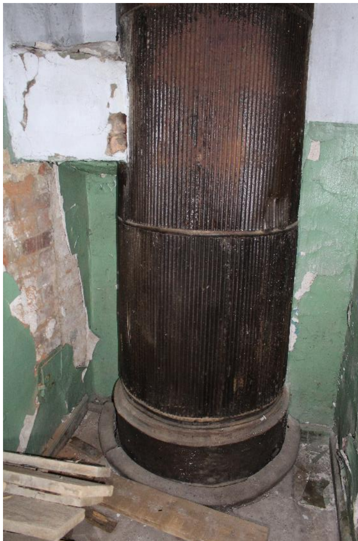
27. Фрагмент помещения на лицевом фасаде.
