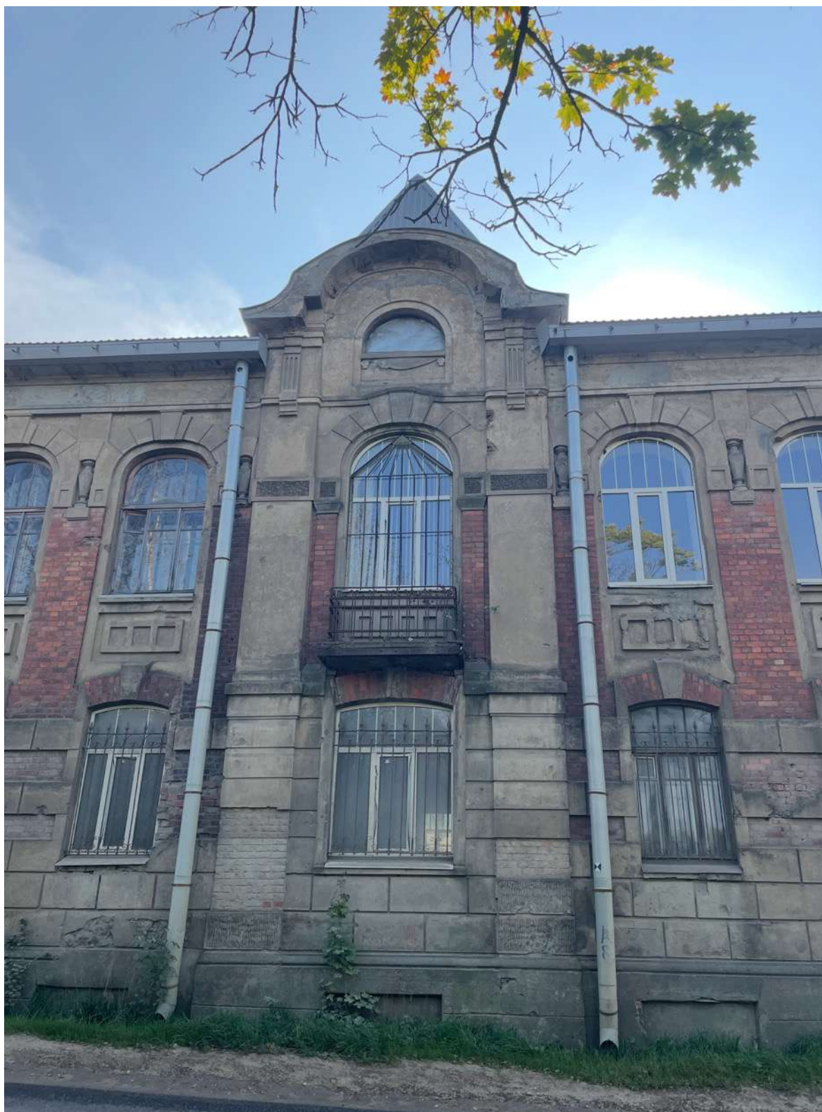
13. Фрагмент лицевого фасада
