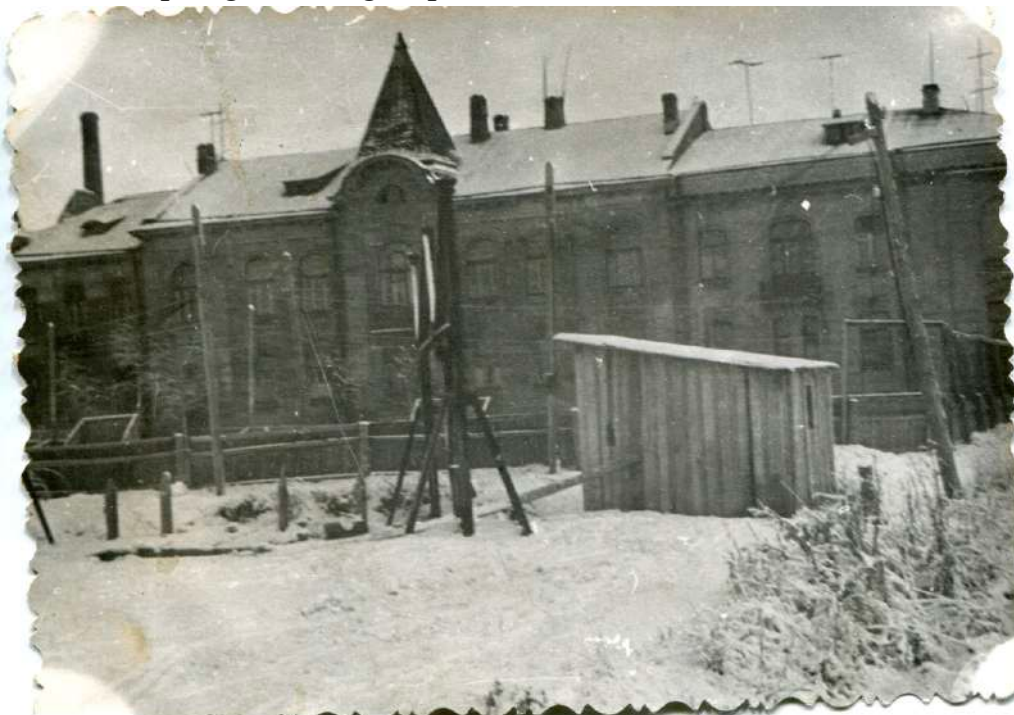
Здание завода им. Рошалья (бывш. завод Лаврова), северный фасад. Начало
