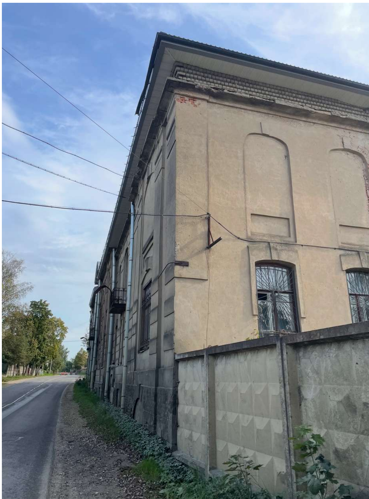
3. Вид с юго-запада
