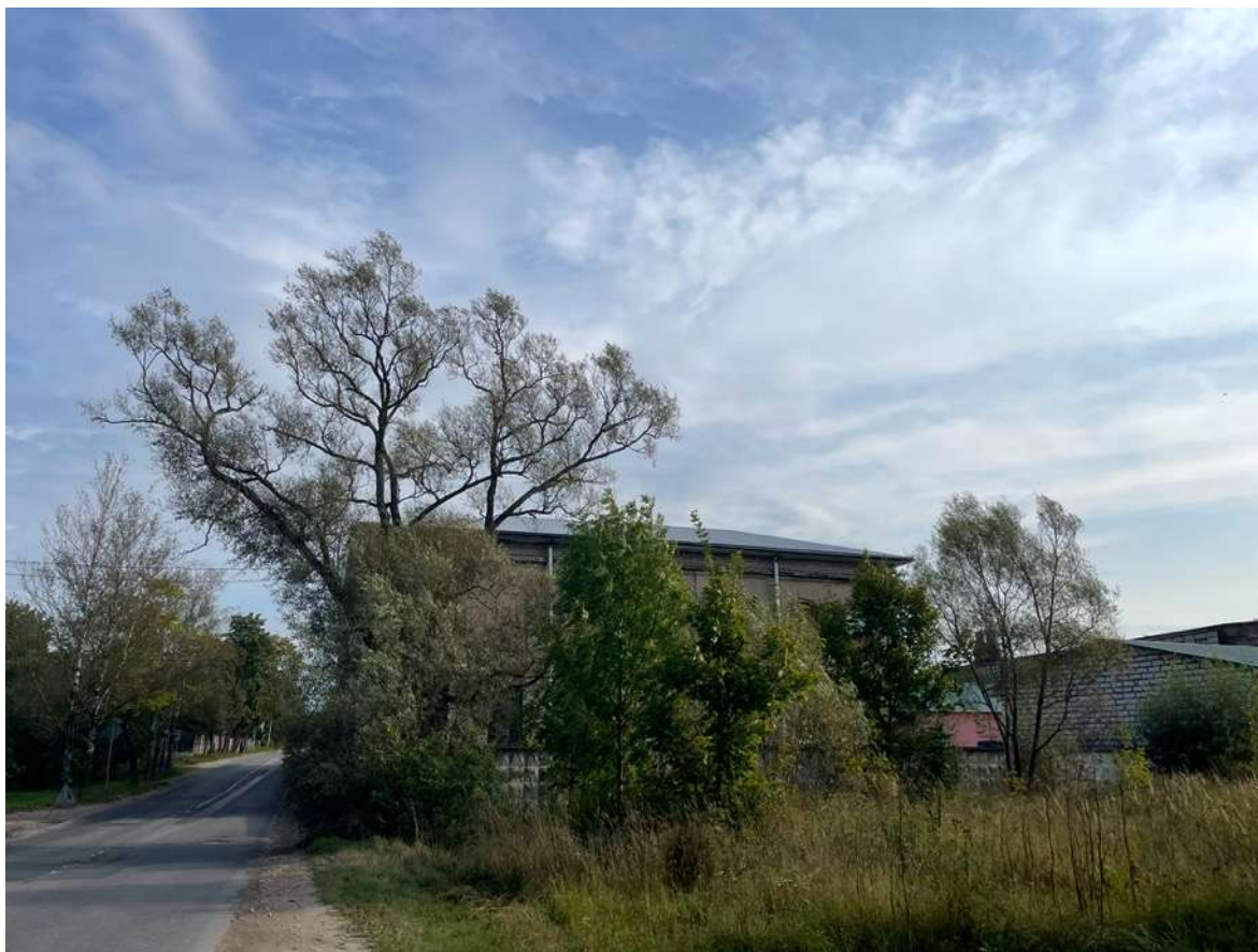
1. Вид с юго-запада
