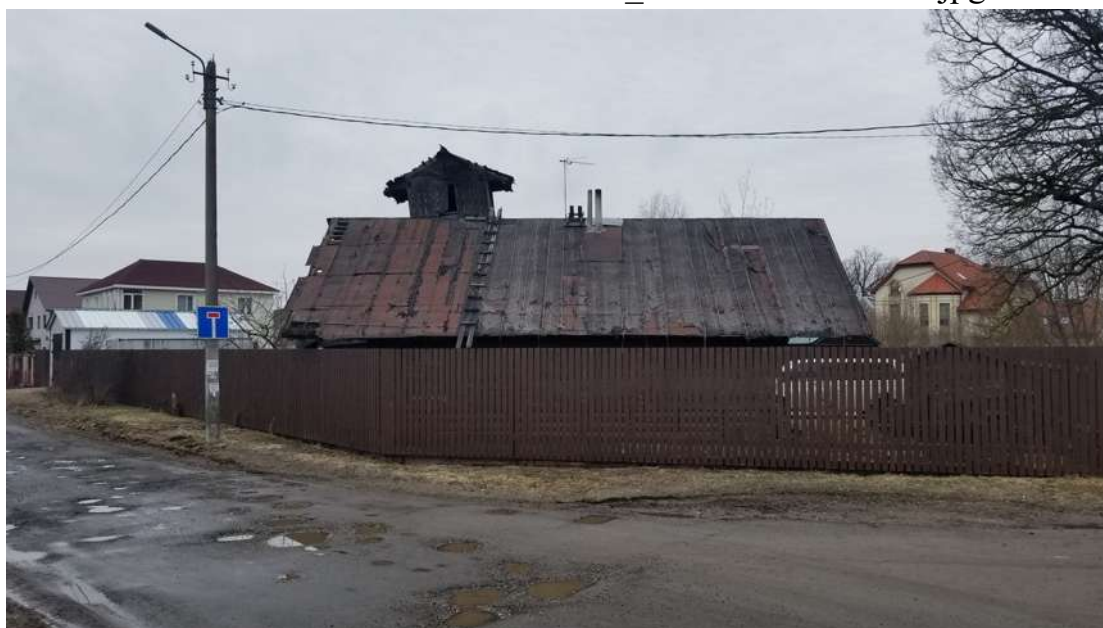
16. Караулка при въезде в Ремиз: Северная улица, 37, Гатчина, Гатчинский район, Ленинградская область. 2024 г. [Электронный ресурс] URL:
