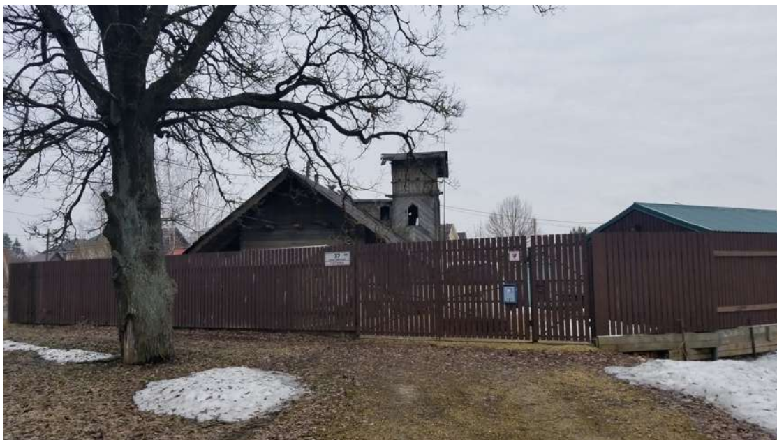
15. Караулка при въезде в Ремиз: Северная улица, 37, Гатчина, Гатчинский район, Ленинградская область. 2024 г. [Электронный ресурс] URL:
