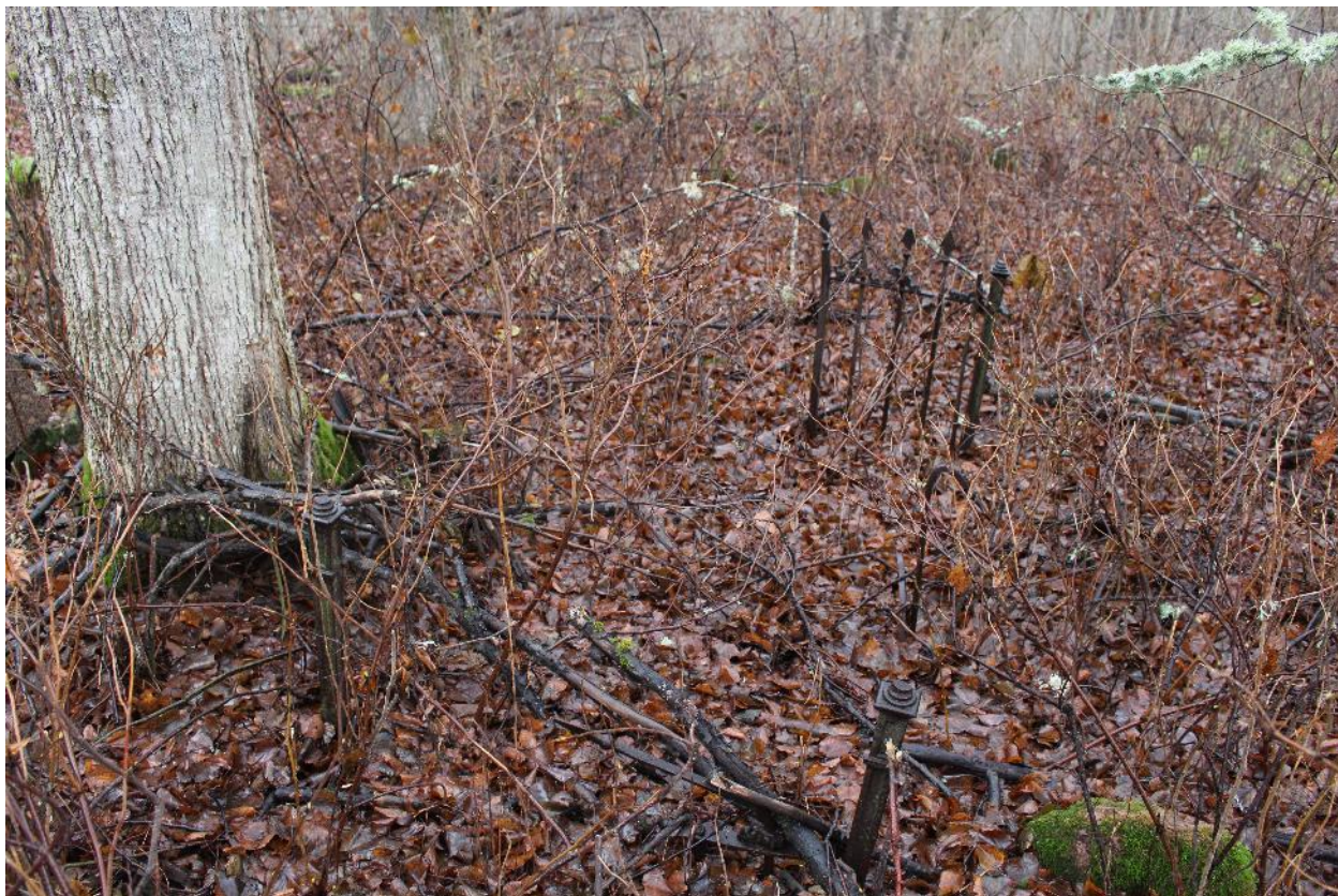
Фото 39. Фрагмент разрушенного ограждения.
