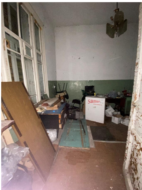
Фото 3. Вид на помещение исследуемого объекта.
