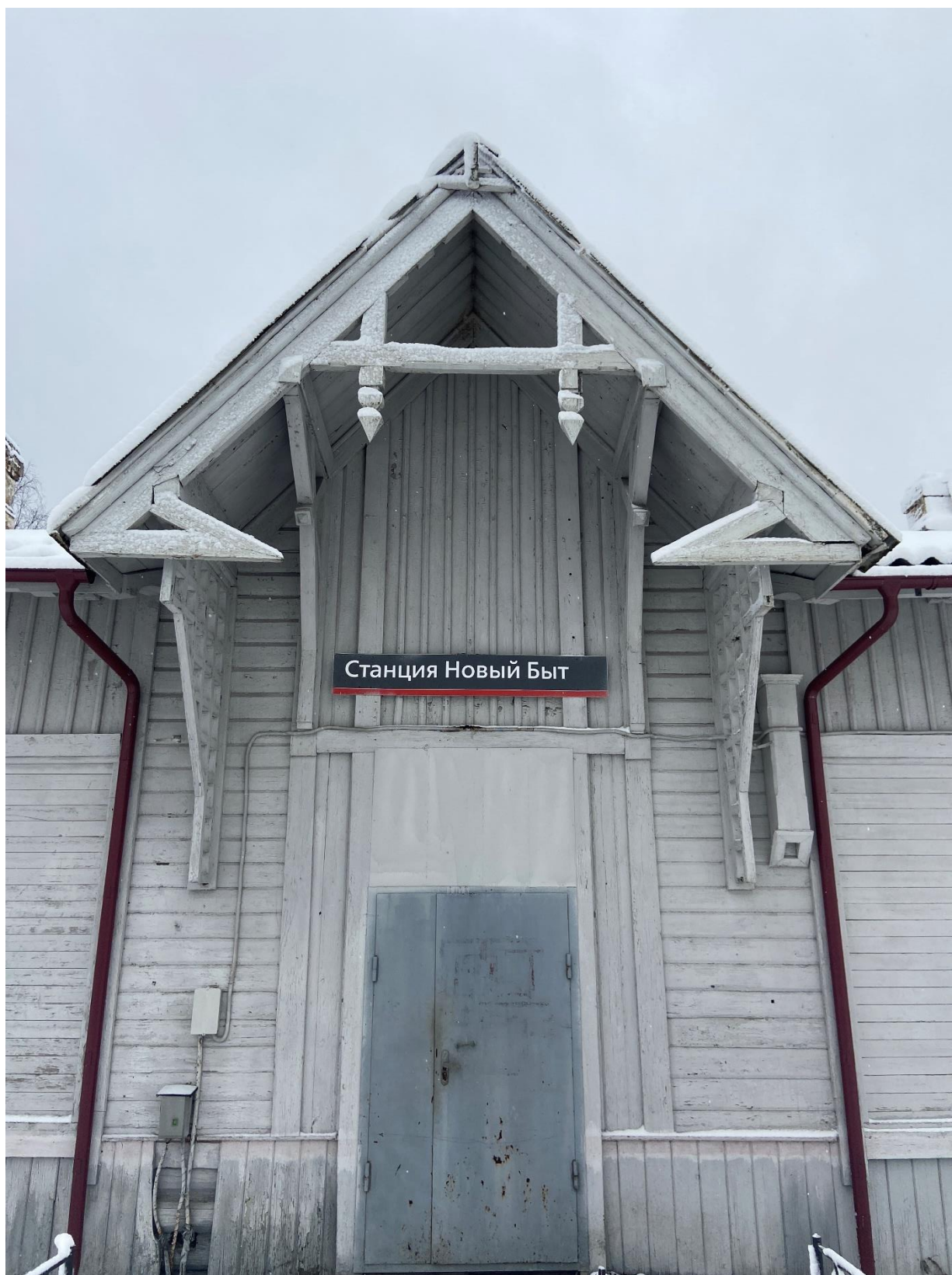
Фото 3. Вид на главный вход в здание вокзала с южной стороны.
