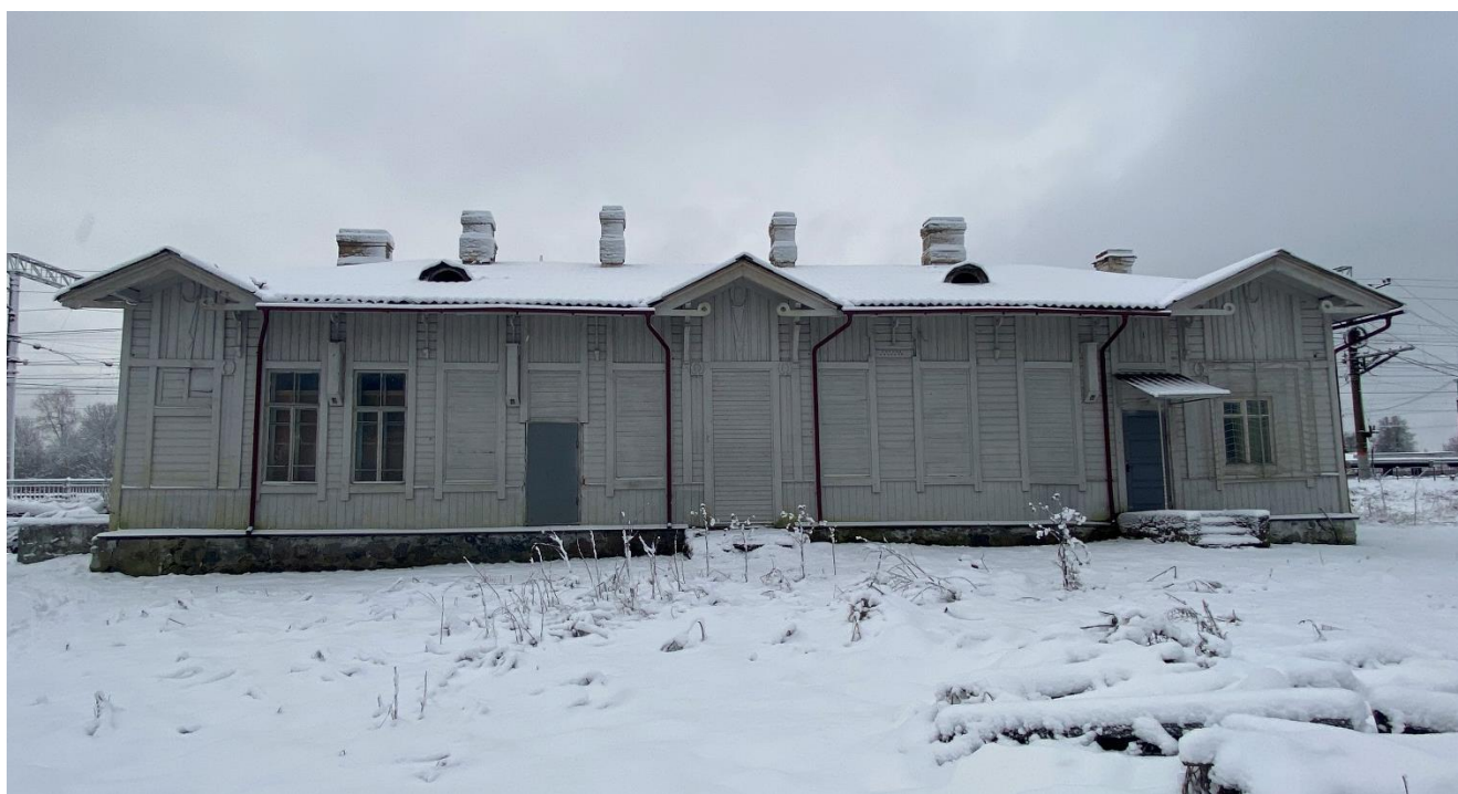
Фото 5. Северный фасад здания вокзала.
