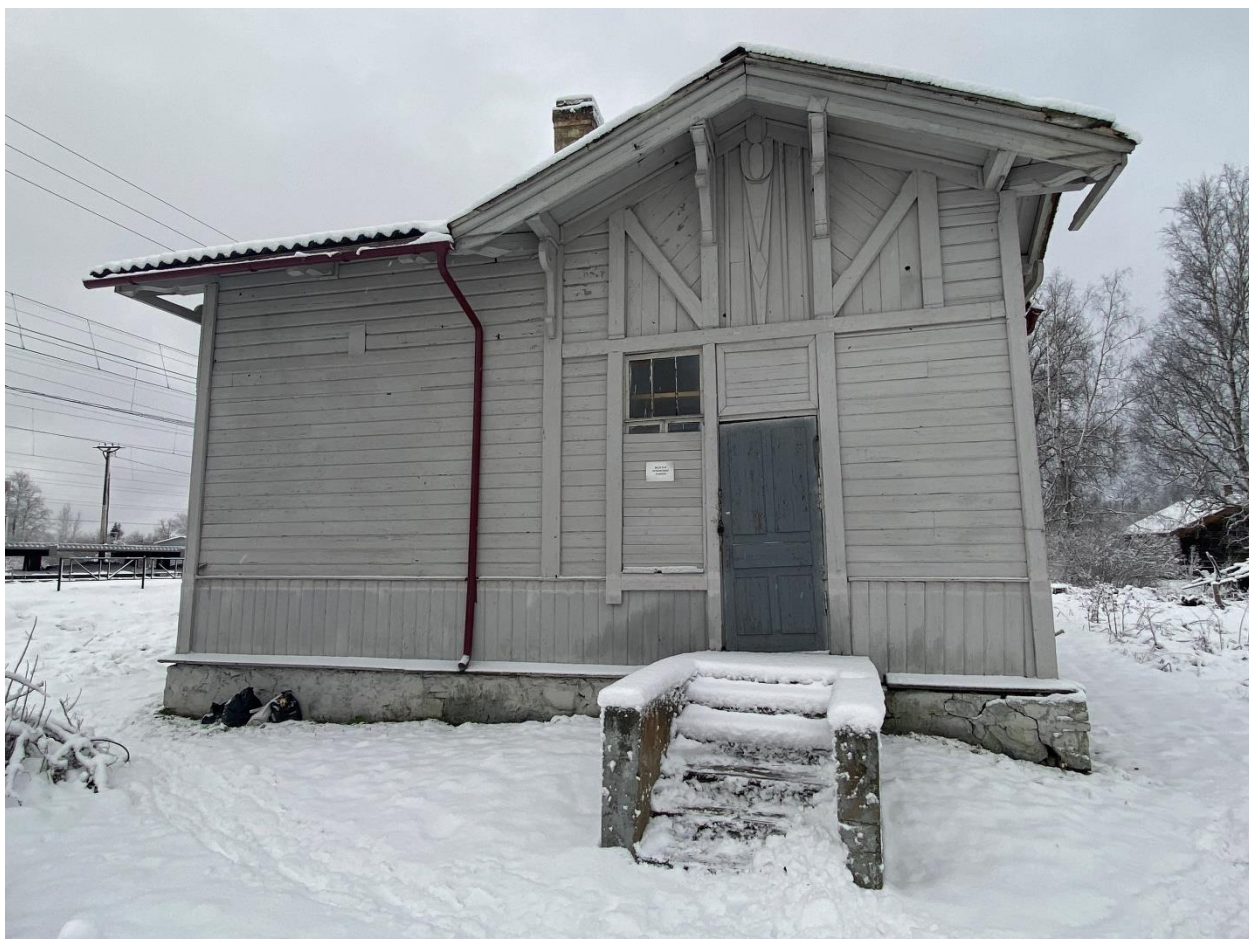
Фото 4. Восточный фасад здания вокзала.
