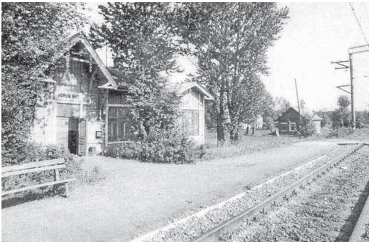
Илл. 11. Железнодорожный вокзал на станции «Новый Быт». Дата: до 1998 г. Источник: каталог станций «От Выборга до Новгорода», 1998 г.
