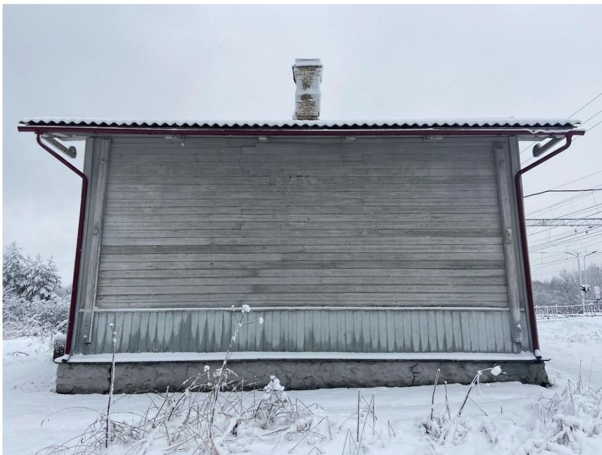
Фото 7. Западный фасад здания вокзала.
