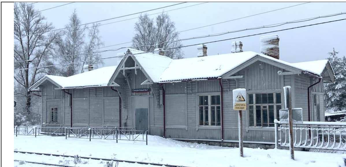
Лицевой фасад железнодорожного вокзала станции Новый Быт.
