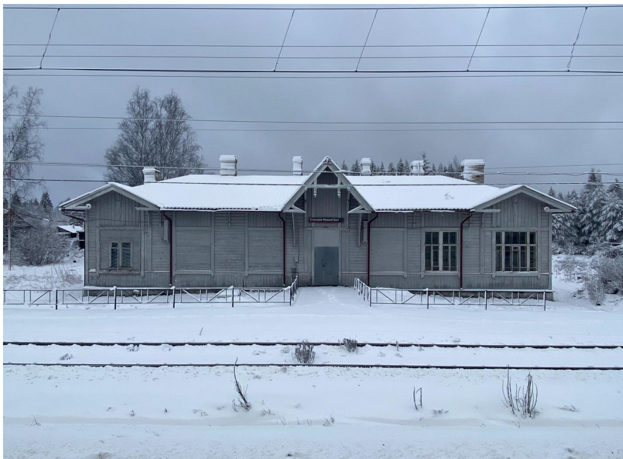
Фото 2. Южный фасад здания вокзала.
