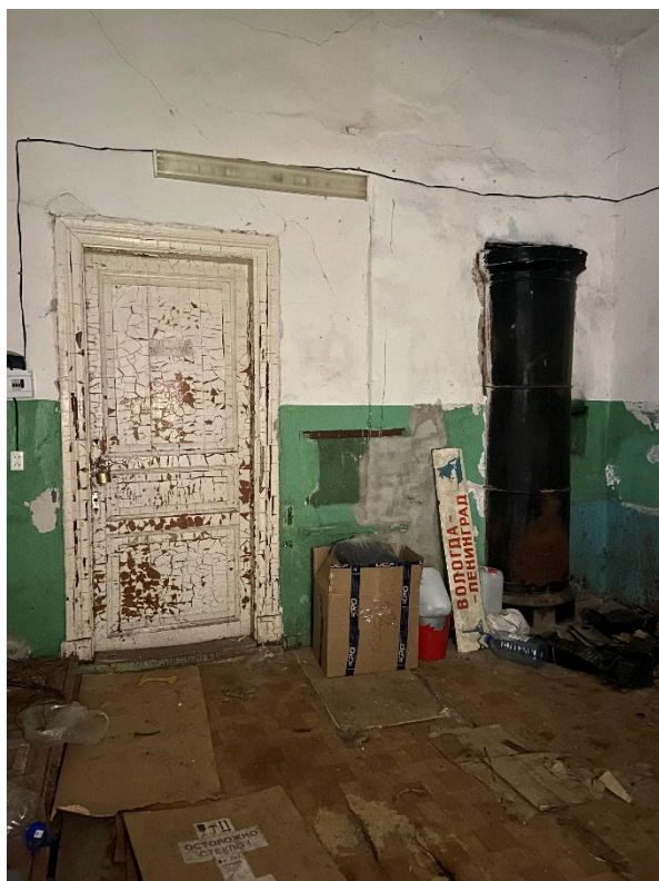
Фото 2. Вид на помещение исследуемого объекта.
