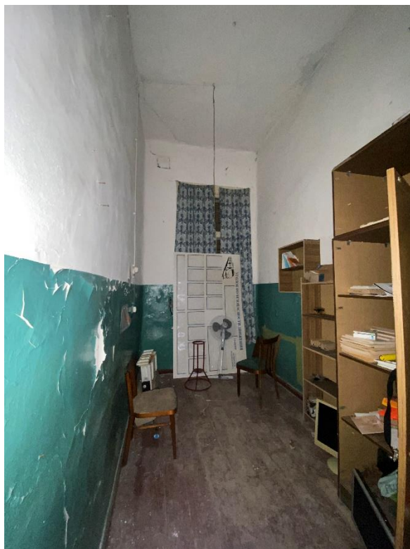
Фото 6. Вид на помещение исследуемого объекта.
