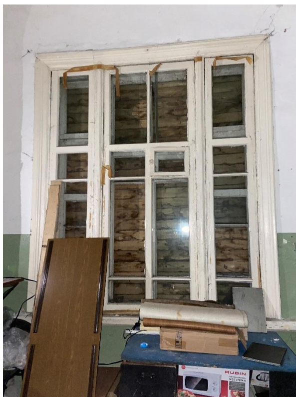
Фото 4. Вид на помещение исследуемого объекта.
