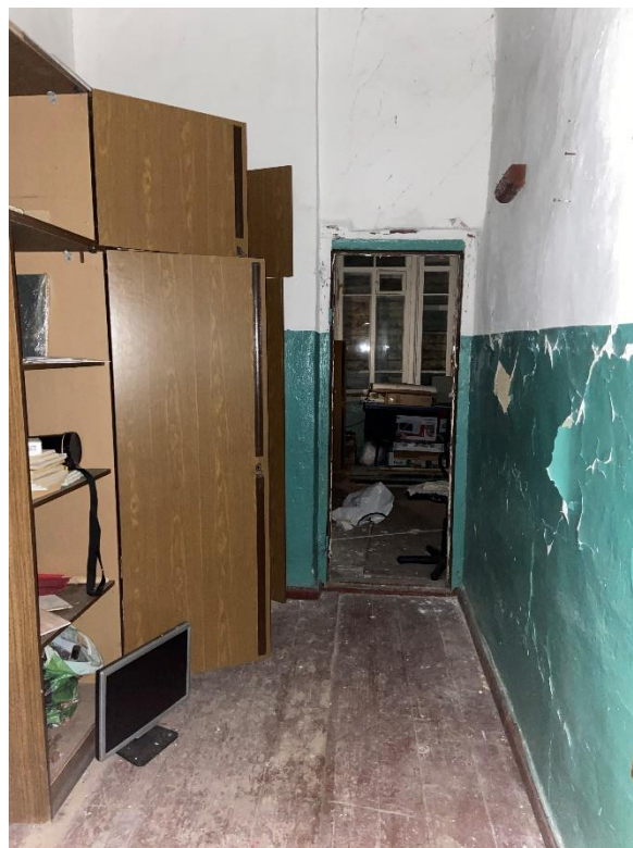
Фото 7. Вид на помещение исследуемого объекта.
