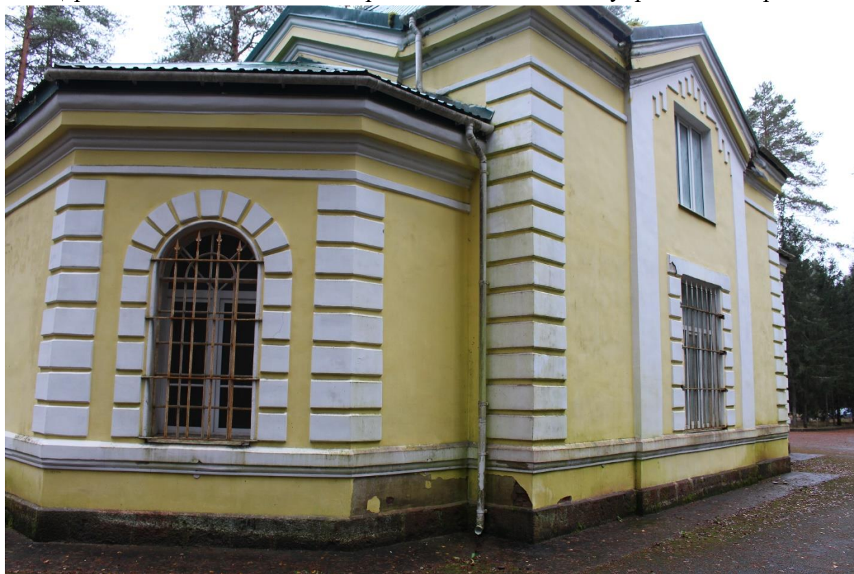
Фото 11. Вид на северный фасад выявленного объекта культурного наследия «Церковь св. Живоначальной Троицы в имении Н.Г. Кудрявцева Ведрово».
