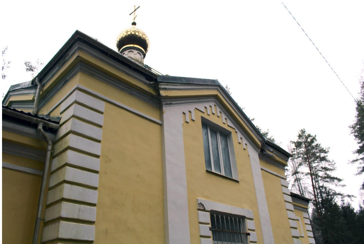
Фото 12. Вид на северный фасад выявленного объекта культурного наследия «Церковь св. Живоначальной Троицы в имении Н.Г. Кудрявцева Ведрово».
