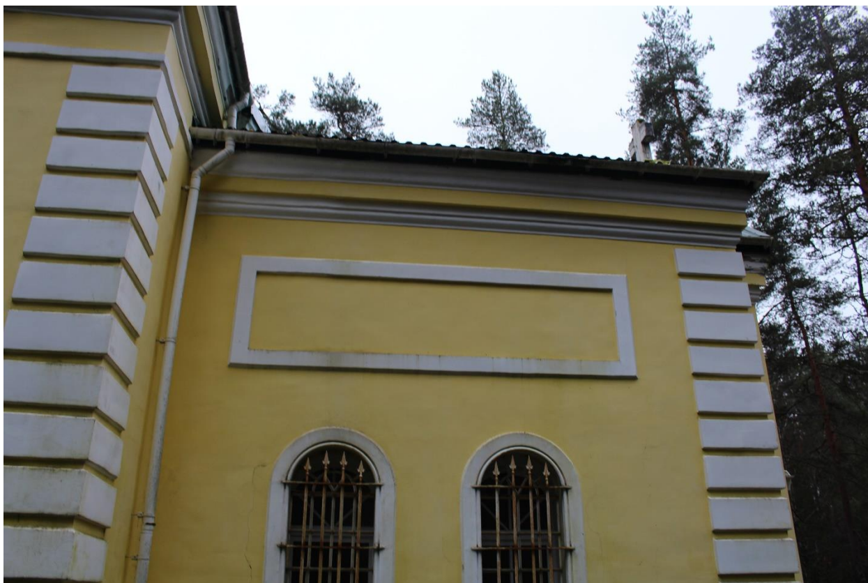
Фото 14. Вид на северный фасад выявленного объекта культурного наследия «Церковь св. Живоначальной Троицы в имени Н.Г. Кудрявцева Ведрово».
