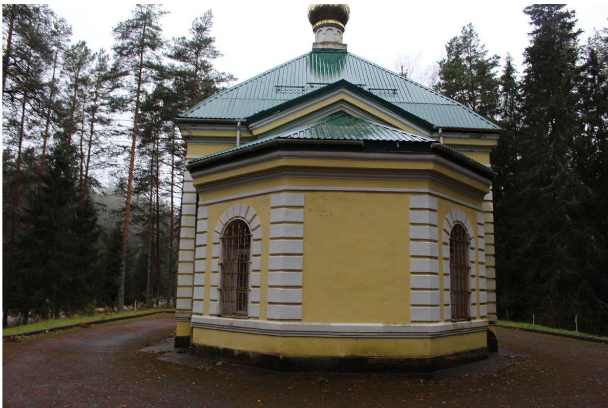
Фото 10. Вид на восточный фасад выявленного объекта культурного наследия «Церковь св. Живоначальной Троицы в имении Н.Г. Кудрявцева Ведрово».
