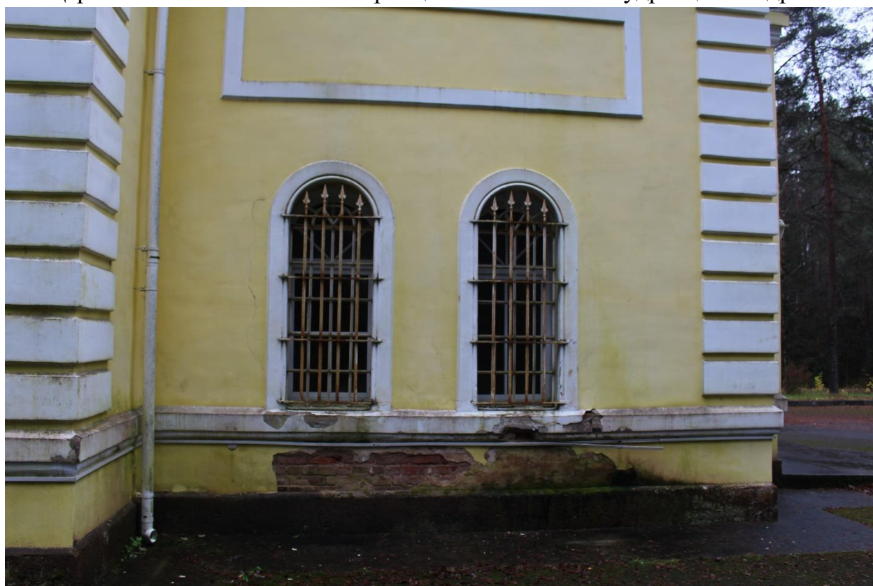
Фото 13. Вид на северный фасад выявленного объекта культурного наследия «Церковь св. Живоначальной Троицы в имении Н.Г. Кудрявцева Ведрово».
