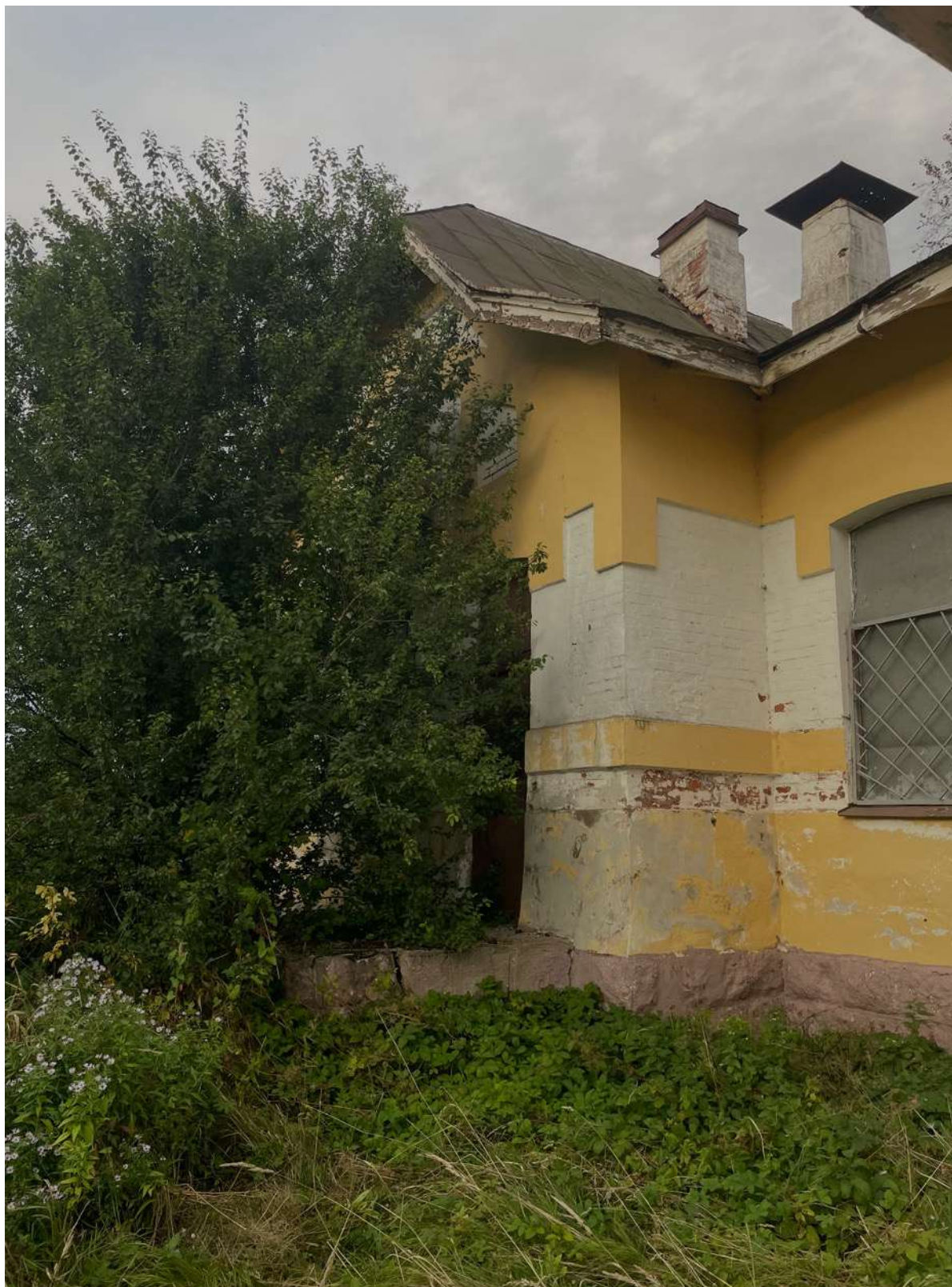
11. Фрагмент западного фасада
