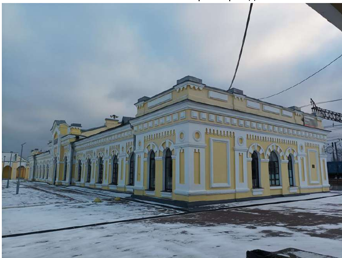
Фото 4. Фасады. Северный и западный.
