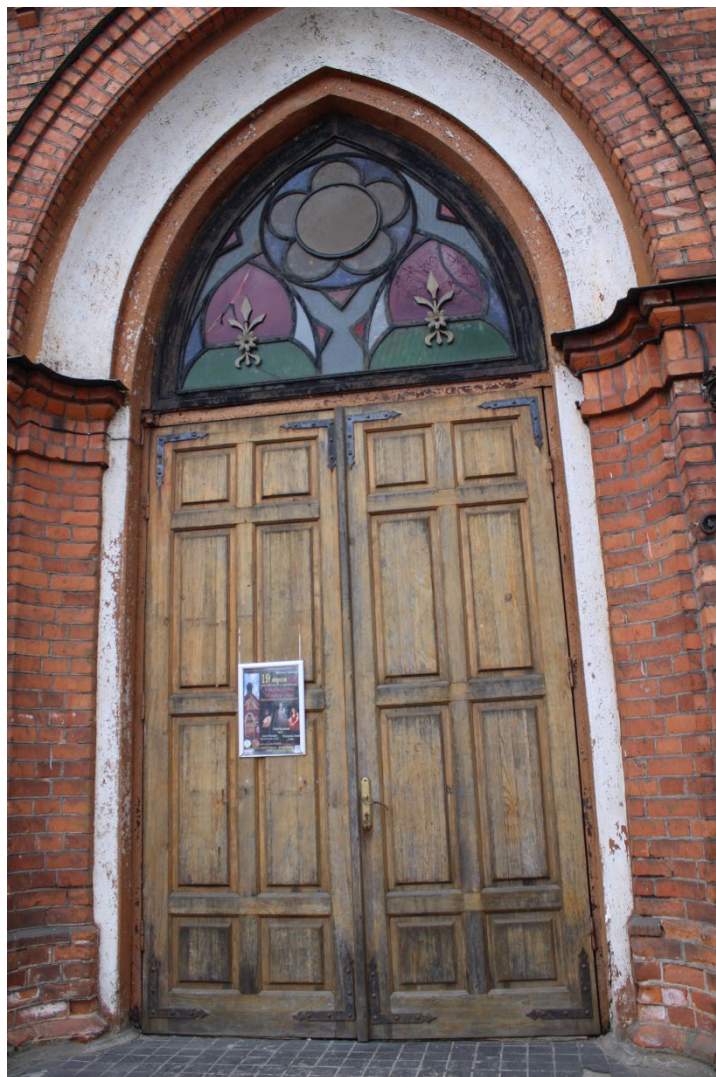
Илл. 3. Дверное заполнение главного портала. Общий вид. Дата фотофиксации: 14.04.26.
