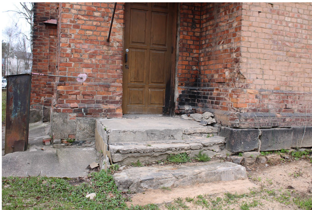
Илл. 13. Современное крыльцо юго-восточного фасада. Фрагмент. Дата фотофиксации: 14.04.26.
