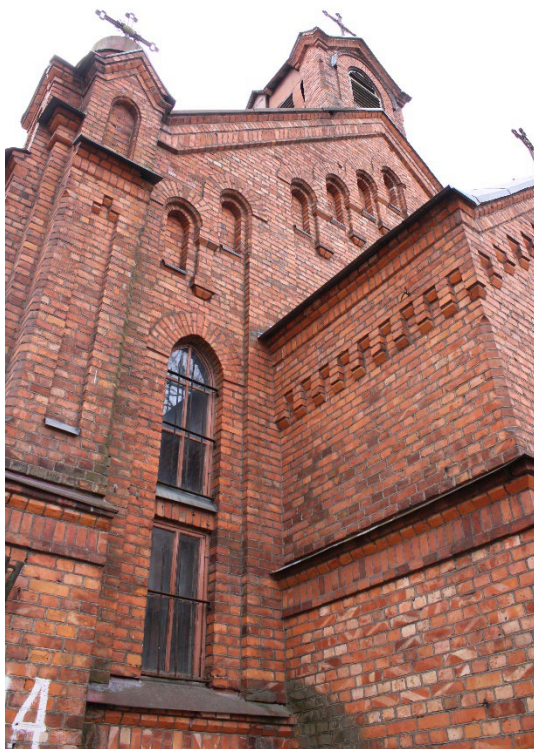
Илл. 6. Аркатурный пояс северо-западного фасада. Дата фотофиксации: 14.04.26.
