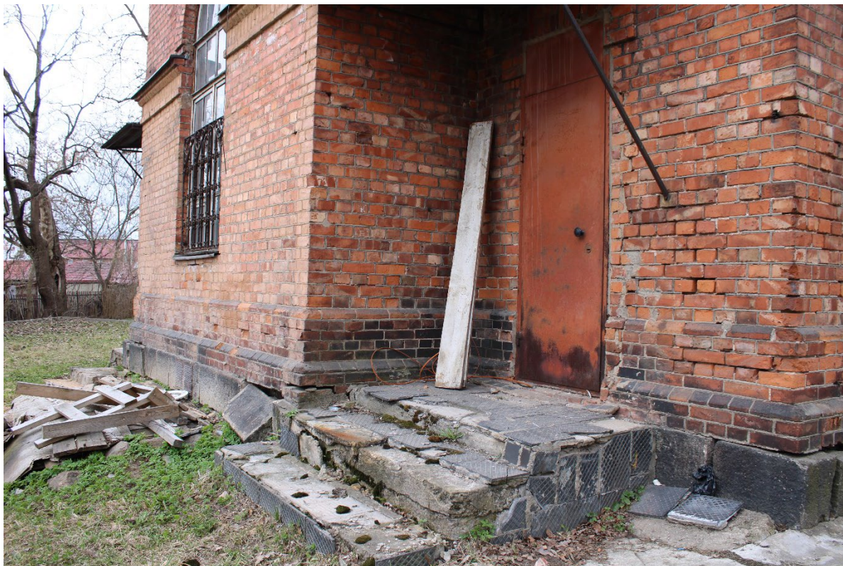
Илл. 12. Современное крыльцо юго-восточного фасада. Фрагмент. Дата фотофиксации: 14.04.26.
