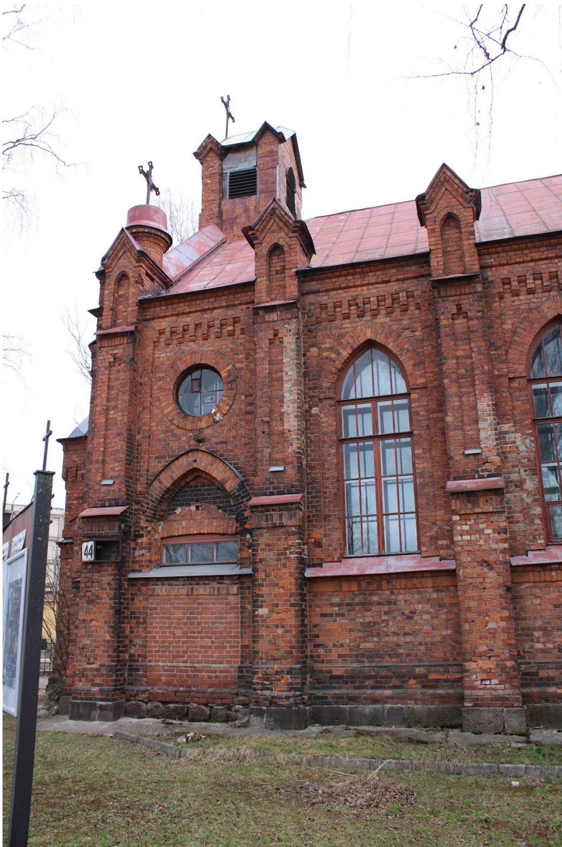
Илл. 9. Юго-западный фасад. Заложенный портал входа. Фрагмент. Дата фотофиксации: 14.04.26.
