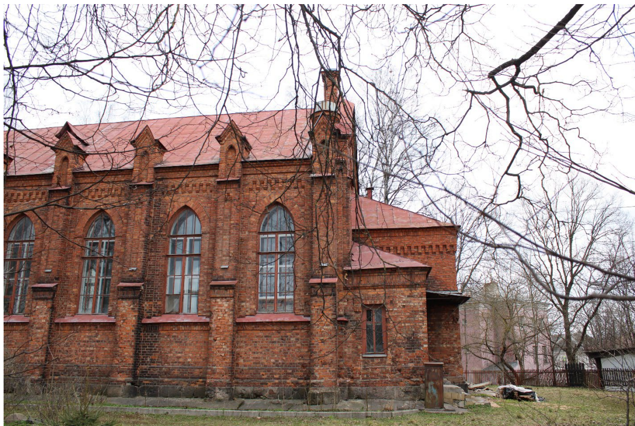
Илл. 8. Юго-западный фасад. Фрагмент. Контрфорсы, завершенные пинаклями. Дата фотофиксации: 14.04.26.
