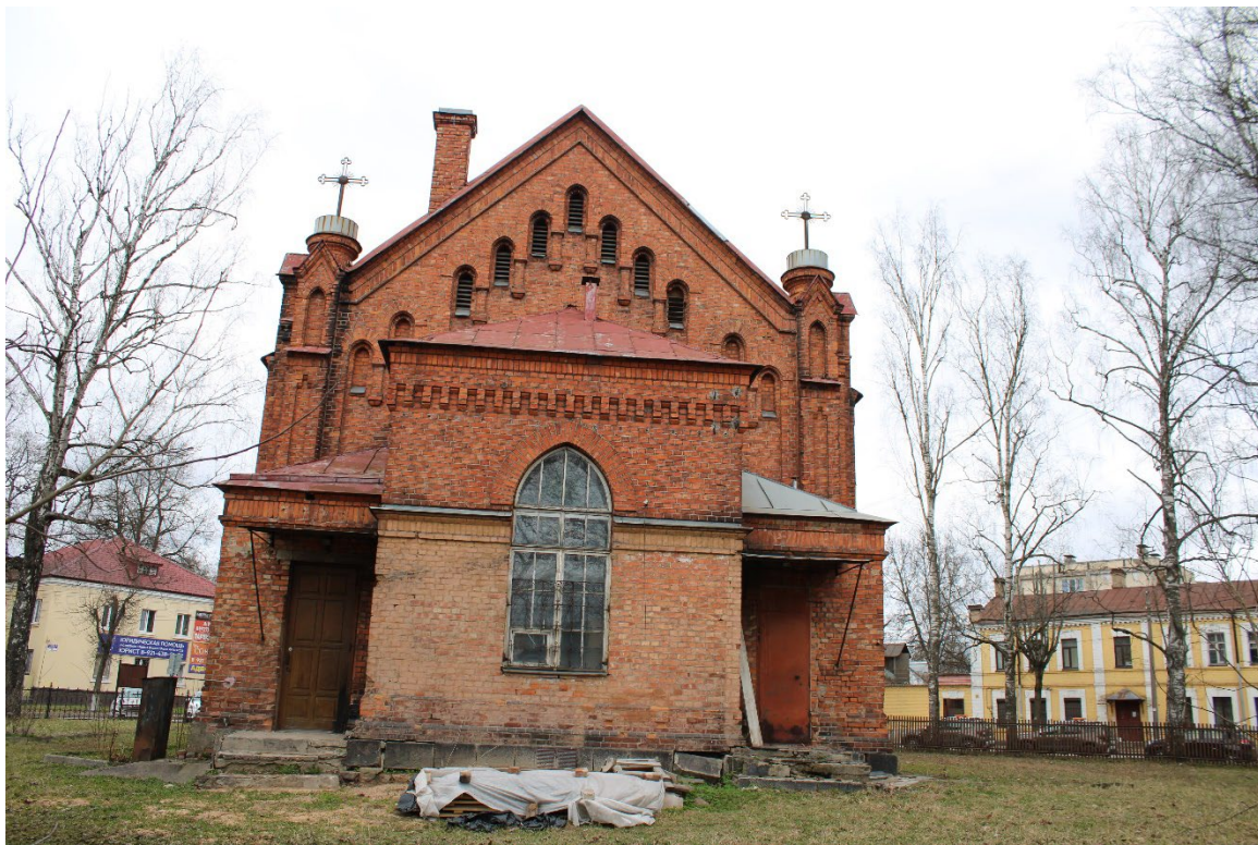
Илл. 10. Юго-восточный фасад, апсиды. Общий вид. Дата фотофиксации: 14.04.26.
